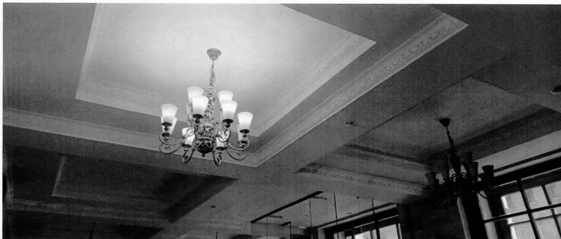
50. Оформление потолка вестибюля парадного входа
