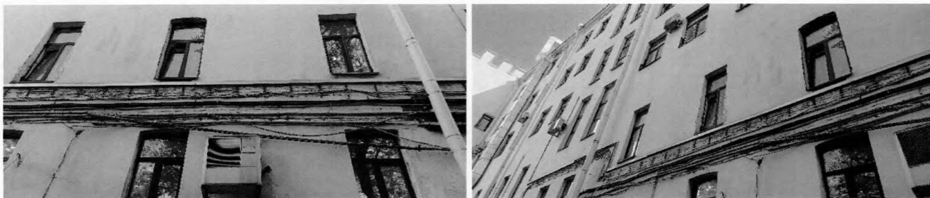
40, 41. Фрагменты дворового фасада
