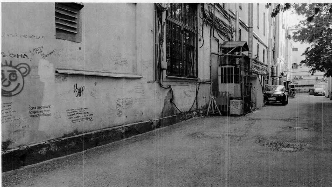
36. Фрагмент дворового фасада
