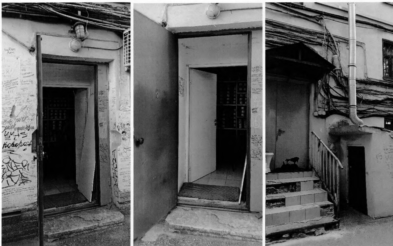
42, 43, 44. Крыльца входов со стороны дворового фасада
