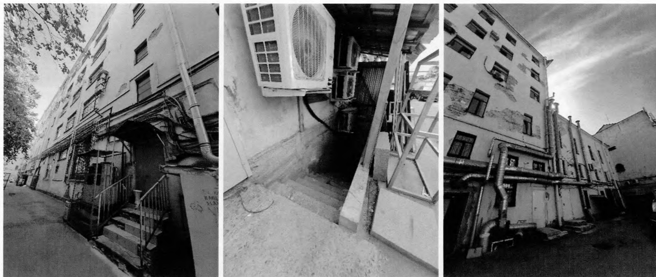
37, 38, 39. Фрагменты дворового фасада
