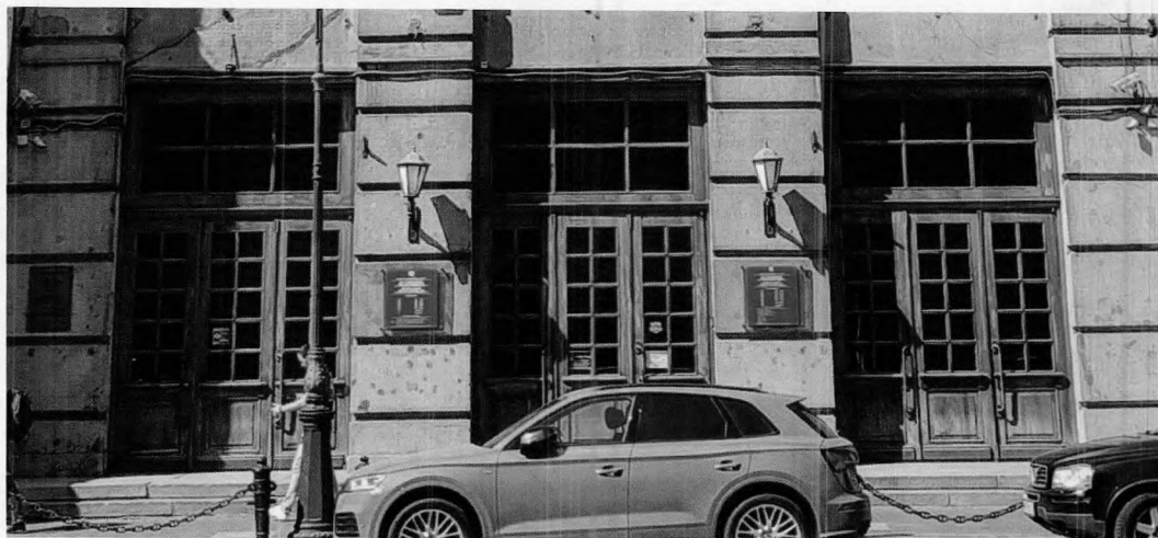
11. Дверные заполнения парадного входа
