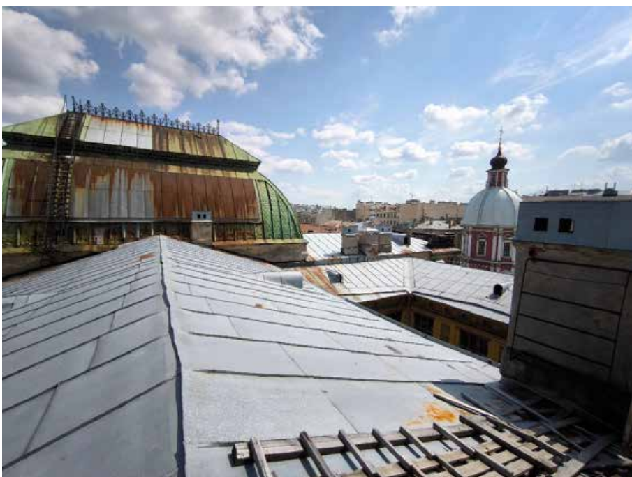
34. «Музей», в составе объекта культурного наследия федерального значения «Центральное училище технического рисования и музей Штиглица А.Л.», Санкт-Петербург, Соляной переулок, дом 13-15, литера В. Кровля. Фрагмент. Фото 14.07.2025г.
