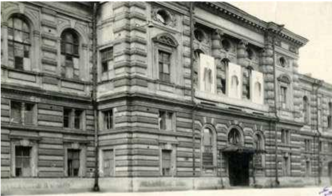
46. Главный фасад училища. 1945 г. // Источник: https://www.ghpa.ru/75-pobeda-1941-1945
