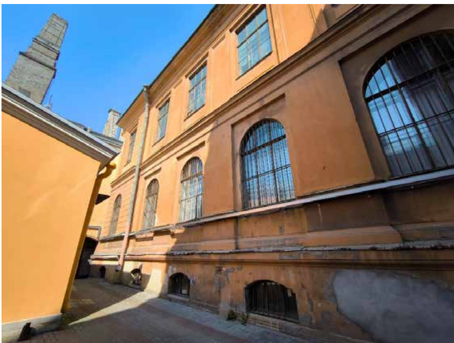
26. «Музей», в составе объекта культурного наследия федерального значения «Центральное училище технического рисования и музей Штиглица А.Л.», Санкт-Петербург, Соляной переулок, дом 13-15, литера В. Южный фасад. Фрагмент. Фото 14.07.2025г.
