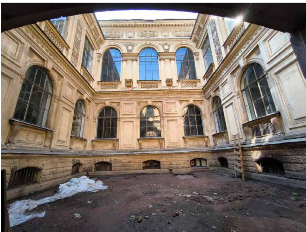
4. «Музей», в составе объекта культурного наследия федерального значения «Центральное училище технического рисования и музей Штиглица А.Л.», Санкт-Петербург, Соляной переулок, дом 13-15, литера В. Внутренний дворовый фасад. Общий вид. Фото 14.07.2025г.
