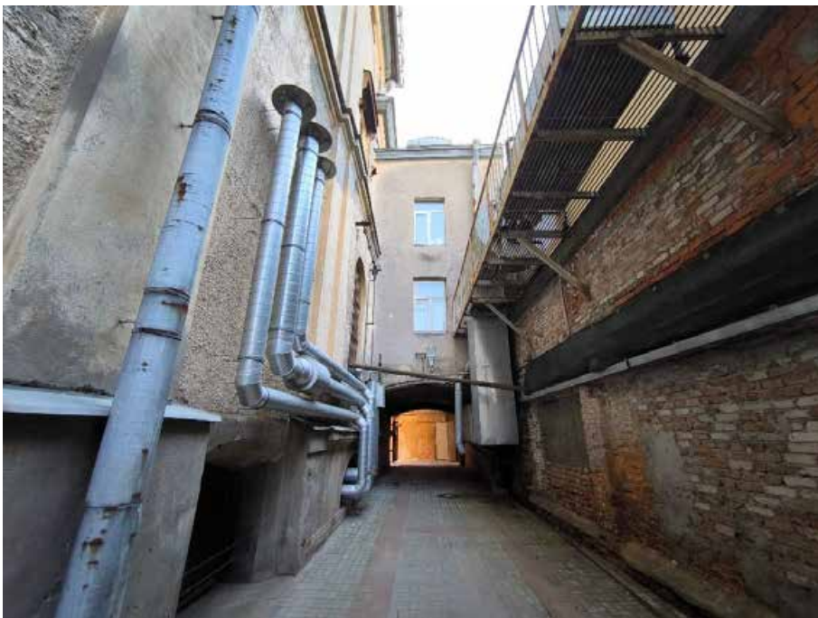
23. «Музей», в составе объекта культурного наследия федерального значения «Центральное училище технического рисования и музей Штиглица А.Л.», Санкт-Петербург, Соляной переулок, дом 13-15, литера В. Западный фасад. Фрагмент. Фото 14.07.2025г.
