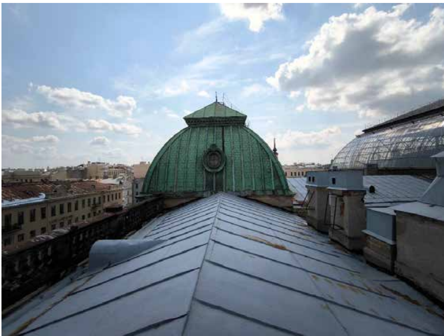
33. «Музей», в составе объекта культурного наследия федерального значения «Центральное училище технического рисования и музей Штиглица А.Л.», Санкт-Петербург, Соляной переулок, дом 13-15, литера В. Кровля. Фрагмент. Фото 14.07.2025г.
