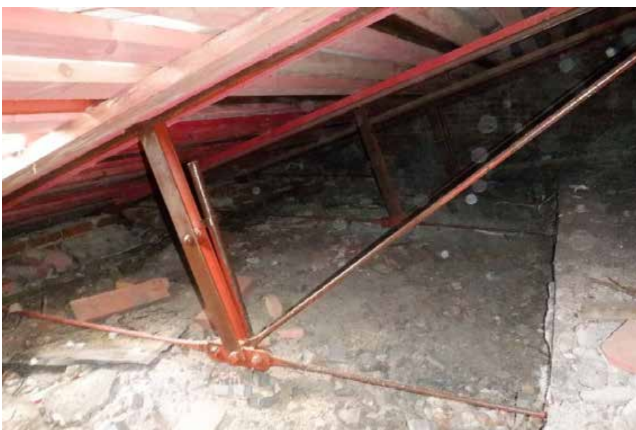
40. «Музей», в составе объекта культурного наследия федерального значения «Центральное училище технического рисования и музей Штиглица А.Л.», Санкт-Петербург, Соляной переулок, дом 13-15, литера В. Чердак. Фрагмент. Фото 14.07.2025г.
