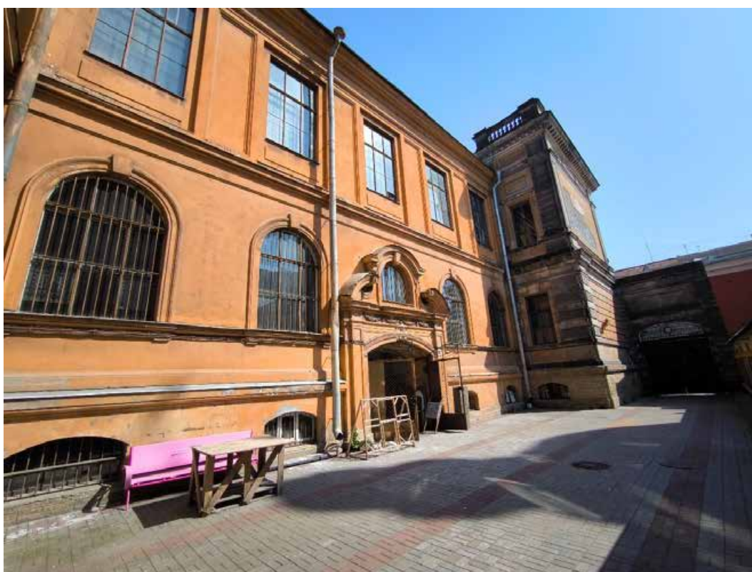
6. «Музей», в составе объекта культурного наследия федерального значения «Центральное училище технического рисования и музей Штиглица А.Л.», Санкт-Петербург, Соляной переулок, дом 13-15, литера В. Южный фасад. Общий вид. Фото 14.07.2025г.
