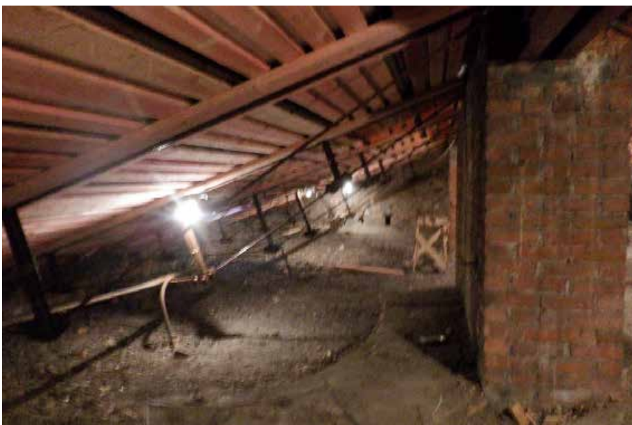
38. «Музей», в составе объекта культурного наследия федерального значения «Центральное училище технического рисования и музей Штиглица А.Л.», Санкт-Петербург, Соляной переулок, дом 13-15, литера В. Чердак. Общий вид. Фото 14.07.2025г.
