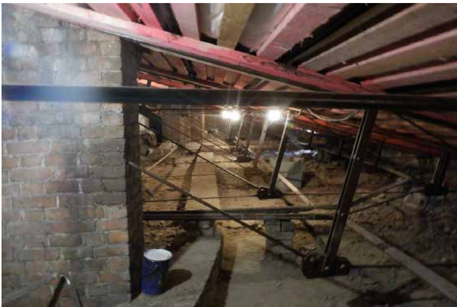
39. «Музей», в составе объекта культурного наследия федерального значения «Центральное училище технического рисования и музей Штиглица А.Л.», Санкт-Петербург, Соляной переулок, дом 13-15, литера В. Чердак. Общий вид. Фото 14.07.2025г.
