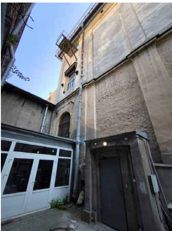
22. «Музей», в составе объекта культурного наследия федерального значения «Центральное училище технического рисования и музей Штиглица А.Л.», Санкт-Петербург, Соляной переулок, дом 13-15, литера В. Западный фасад. Фрагмент. Фото 14.07.2025г.
