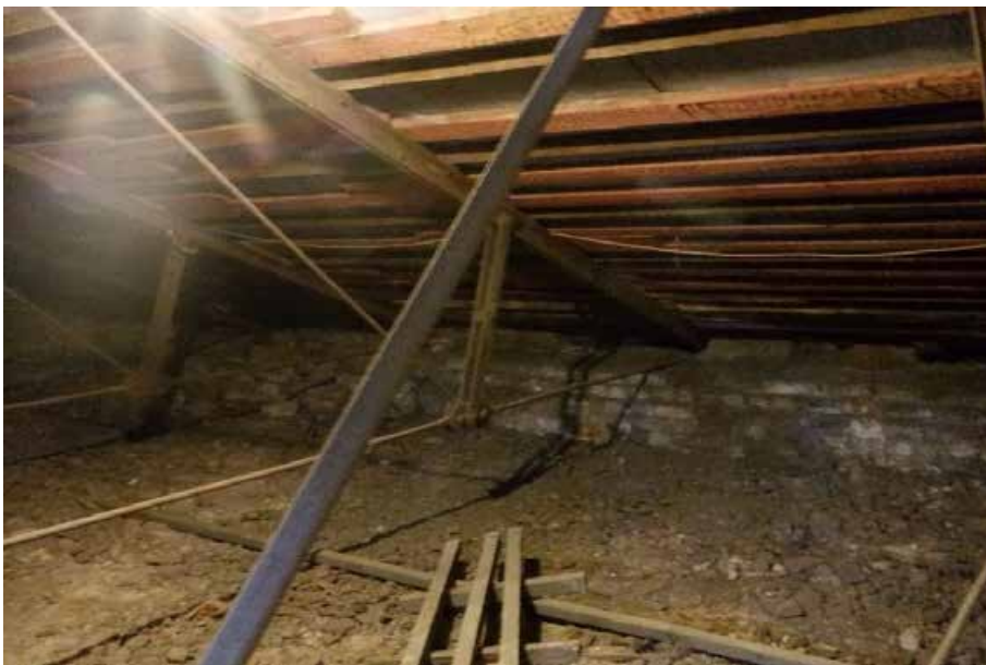
37. «Музей», в составе объекта культурного наследия федерального значения «Центральное училище технического рисования и музей Штиглица А.Л.», Санкт-Петербург, Соляной переулок, дом 13-15, литера В. Чердак. Фрагмент. Фото 14.07.2025г.
