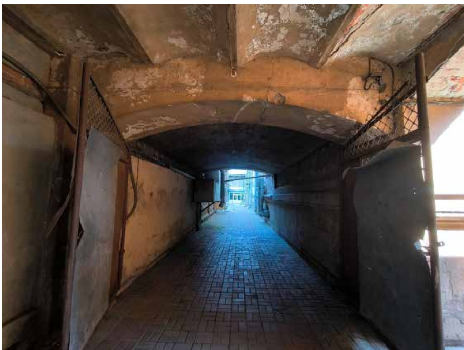
24. «Музей», в составе объекта культурного наследия федерального значения «Центральное училище технического рисования и музей Штиглица А.Л.», Санкт-Петербург, Соляной переулок, дом 13-15, литера В. Внутренний проезд. Общий вид. Фото 14.07.2025г.
