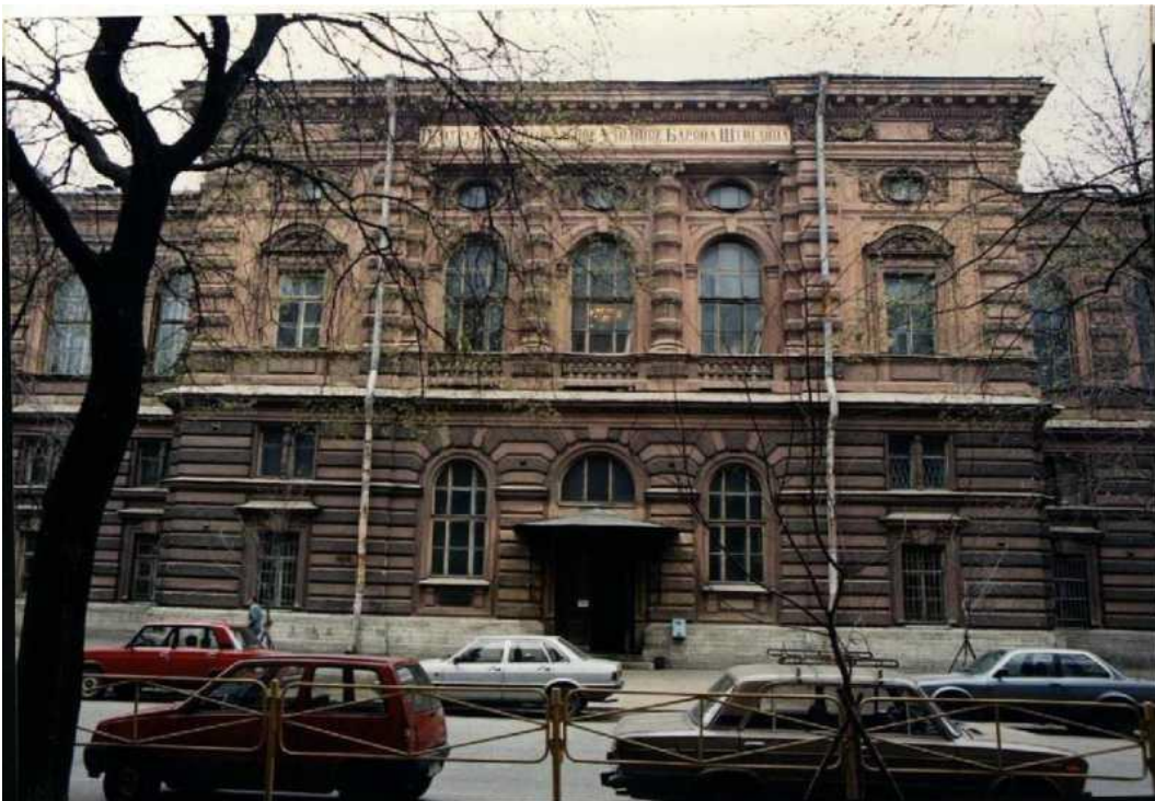
74. Центральное училище технического рисования барона Штиглица. Главный фасад. Общий вид. 1998 г. // Источник: паспорт памятника «Центральное училище технического рисования и музей А.Л. Штиглица». г. Санкт-Петербург, Центральный район, Соляной пер., 13, Составители: Матвеев Б.М., Орлов В.П. 1998 г. Архив КГИОП. Инв. № 958п.
