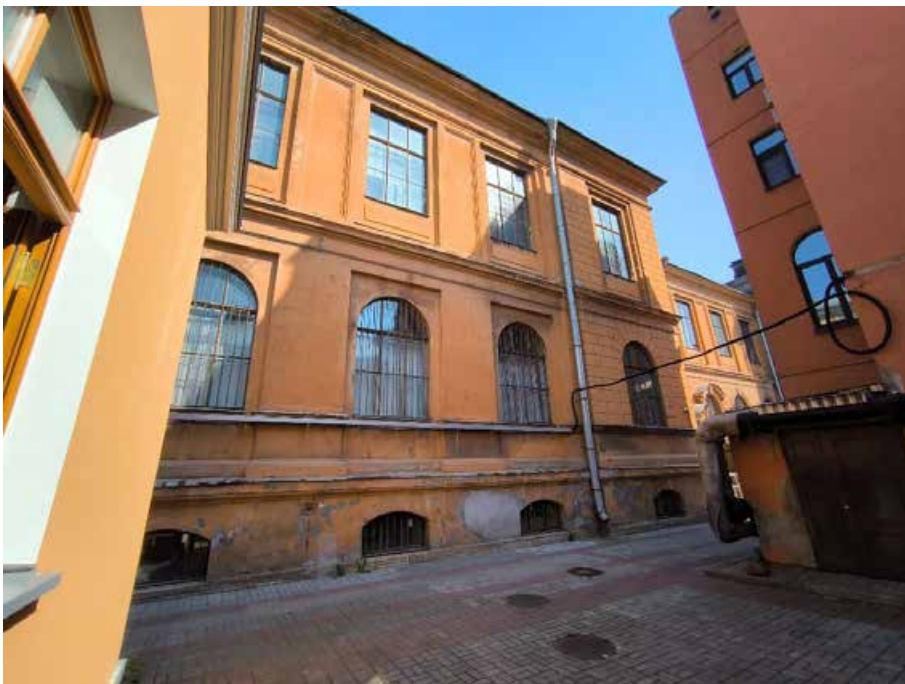
27. «Музей», в составе объекта культурного наследия федерального значения «Центральное училище технического рисования и музей Штиглица А.Л.», Санкт-Петербург, Соляной переулок, дом 13-15, литера В. Южный фасад. Фрагмент. Фото 14.07.2025г.
