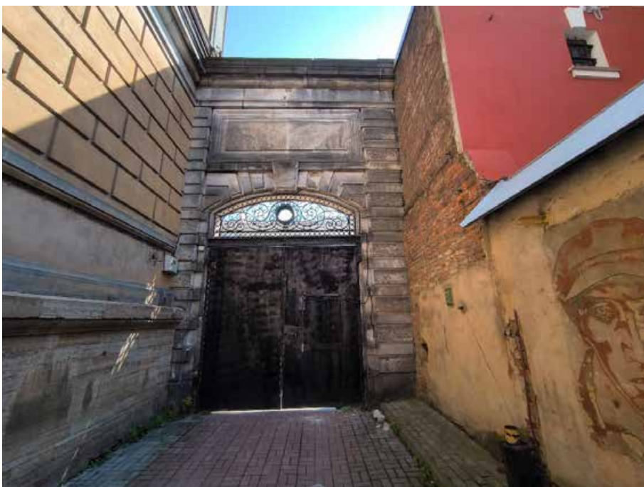
30. «Музей», в составе объекта культурного наследия федерального значения «Центральное училище технического рисования и музей Штиглица А.Л.», Санкт-Петербург, Соляной переулок, дом 13-15, литера В. Южный фасад. Фрагмент. Фото 14.07.2025г.
