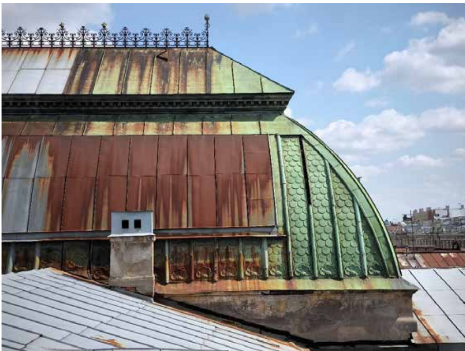
35. «Музей», в составе объекта культурного наследия федерального значения «Центральное училище технического рисования и музей Штиглица А.Л.», Санкт-Петербург, Соляной переулок, дом 13-15, литера В. Кровля. Фрагмент. Фото 14.07.2025г.
