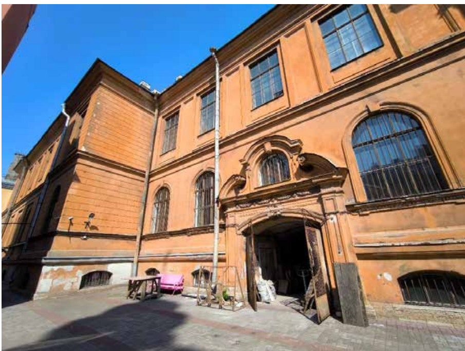
28. «Музей», в составе объекта культурного наследия федерального значения «Центральное училище технического рисования и музей Штиглица А.Л.», Санкт-Петербург, Соляной переулок, дом 13-15, литера В. Южный фасад. Фрагмент. Фото 14.07.2025г.
