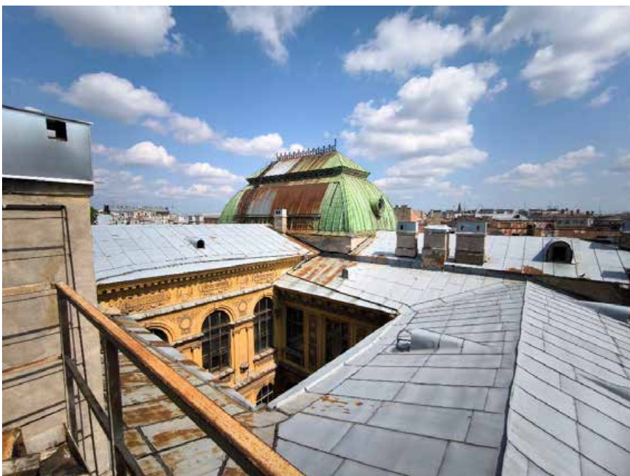
36. «Музей», в составе объекта культурного наследия федерального значения «Центральное училище технического рисования и музей Штиглица А.Л.», Санкт-Петербург, Соляной переулок, дом 13-15, литера В. Кровля. Фрагмент. Фото 14.07.2025г.
