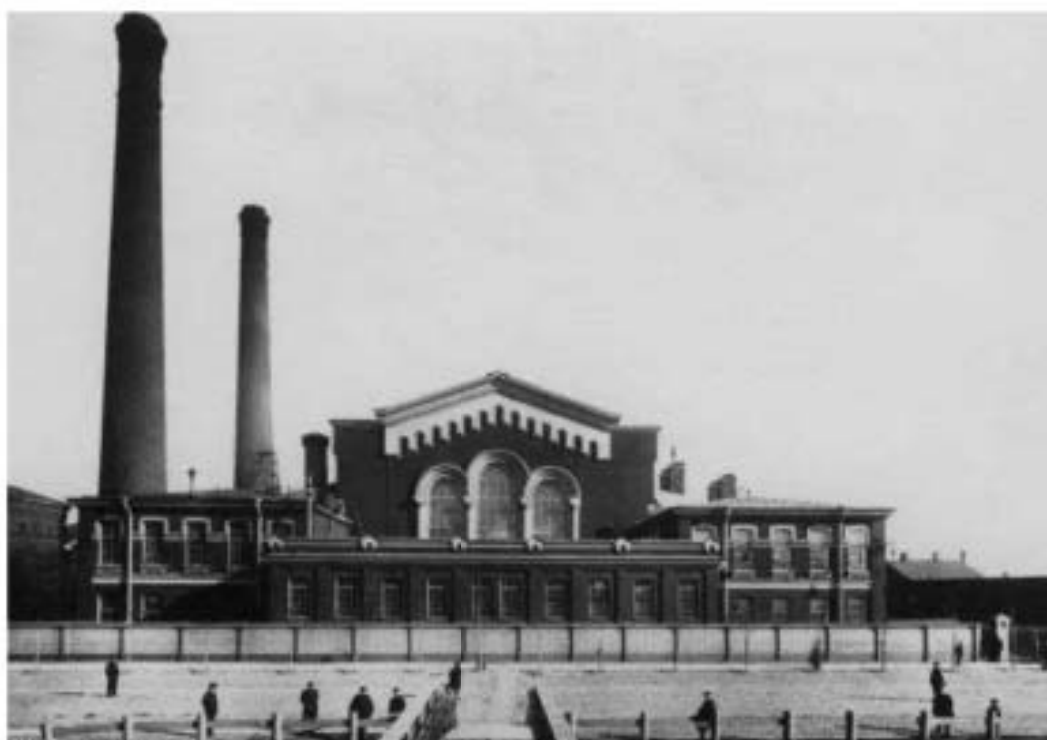
Илл. 15. Центральная станции Общества электрического освещения 1886 г. Фото ок. 1900 г. Архив https://citywalls.ru/
