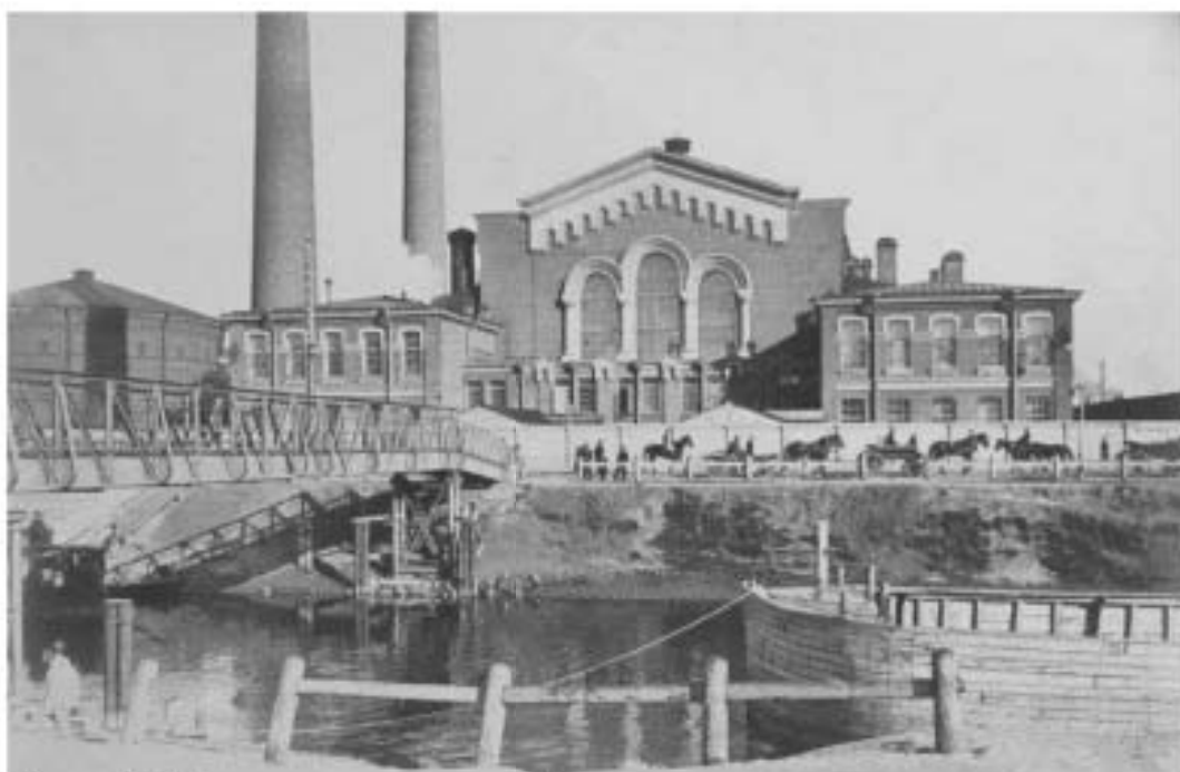
Илл. 14. Электростанция «Общества электрического освещения» на набережной Обводного канала. Вид с северо-запада, с противоположного берега Обводного канала. Фото 1898-1900 гг. https://pastvu.com/
