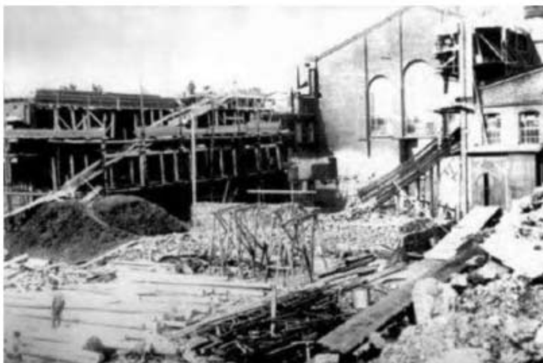
Илл. 12. Строительство электростанции. 1897–1898 гг. https://pastvu.com/
