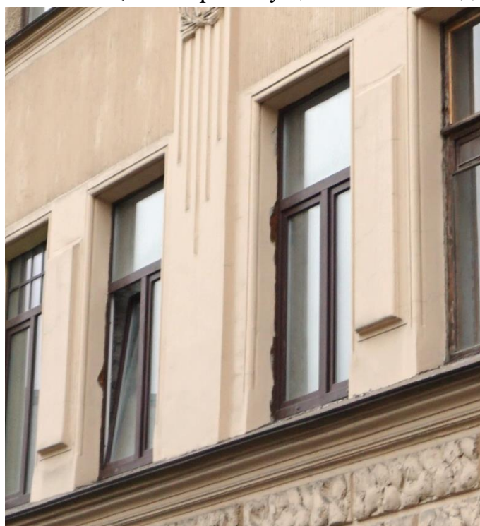
Фото 4. Оконные проемы квартиры №25 (2 шт.), выходящие на лицевой юго-восточный фасад
