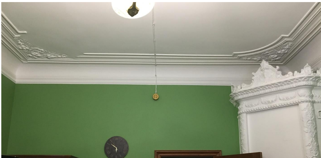
Фото 19. Угловые элементы лепного декора потолка бывшего помещения №7. Вид с юго-востока
