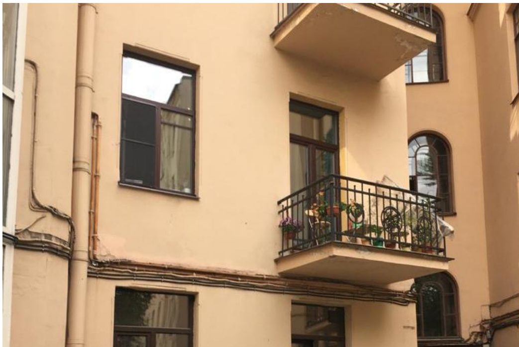
Фото 5. Оконный и дверной проем с балконом квартиры №25, выходящие на дворовой северо-западный фасад. Вид с северо-запада
