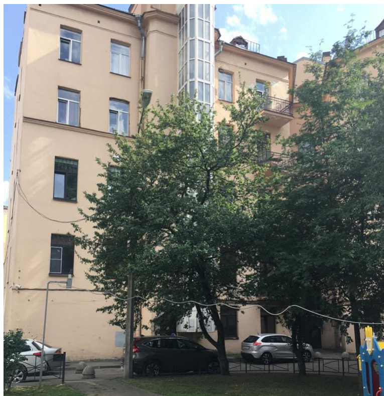
Фото 3. Вид на дворовой северо-западный фасад с северо-запада. В центре фасада лестничная клетка, с которой осуществляется вход в квартиру №25
