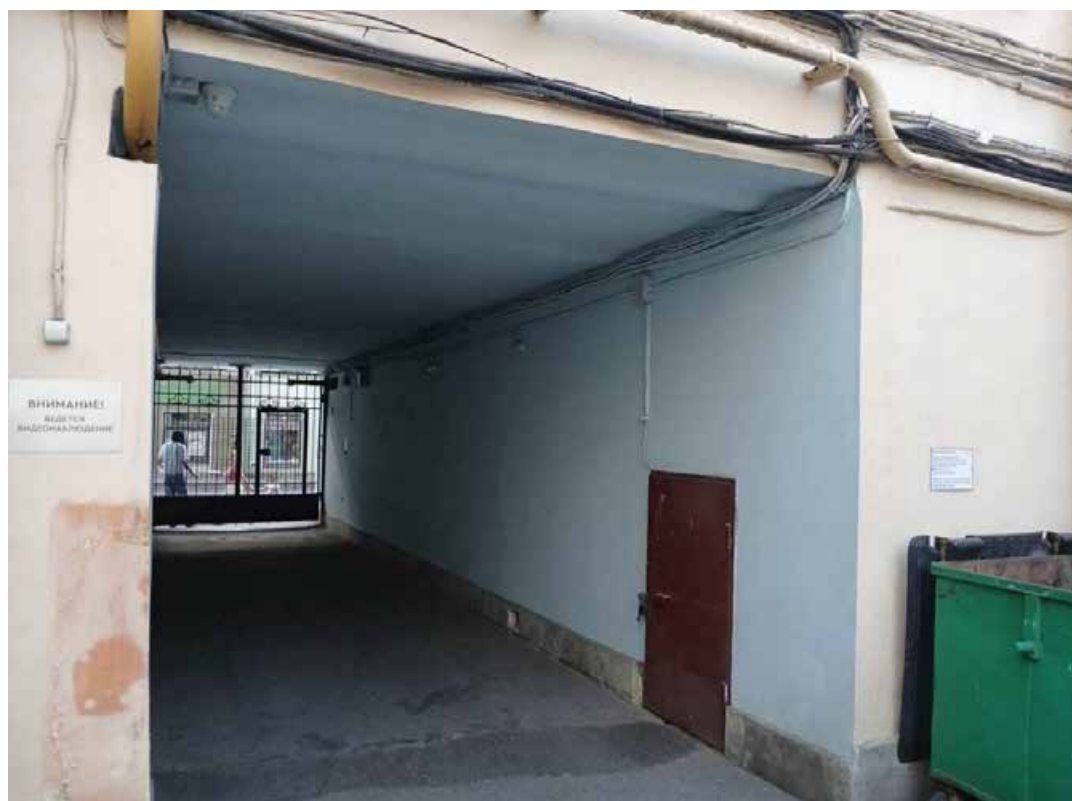
30. «Жилой дом» (Гороховая ул., д. 28, лит. А). Дворовые фасады. Фото мест установки оборудования и прокладки кабельных трасс. Штиглиц М.С. 05.08.2025.
