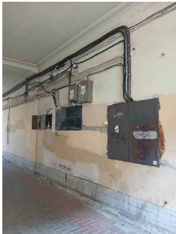
11. «Дом Санкт-Петербургского Мещанского общества» (Бородинская ул., д. 12/31, лит. А). Арочный проезд. Фото мест установки оборудования и прокладки кабельных трасс. Штиглиц М.С. 05.08.2025.
