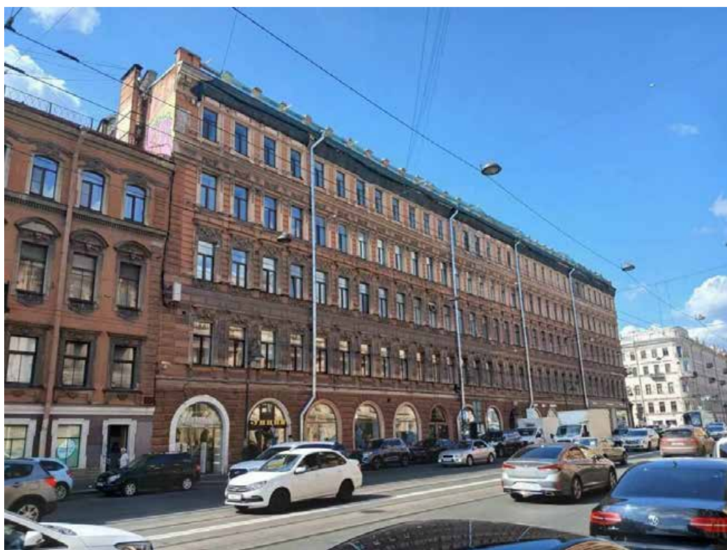
22. «Здание, где размещался ресторан "К.П.Палкин"» (Владимирский пр., д. 1/47, лит. Б). Лицевой фасад по Владимирскому пр. Штиглиц М.С. 05.08.2025.
