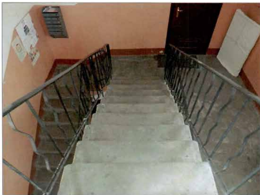
23. Двухмаршевая лестница (лицевой корпус по Гороховой улице).
