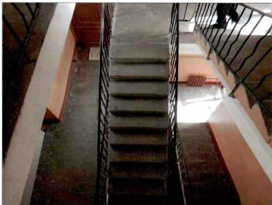
22. Двухмаршевая лестница (лицевой корпус по Гороховой улице).
