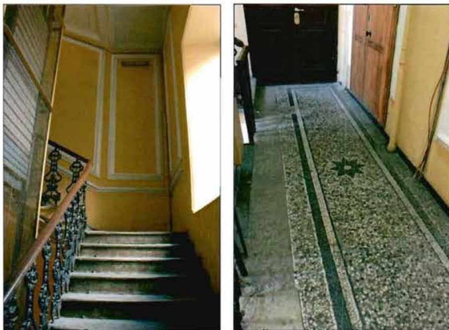
Фото №9, 10. Межэтажная трехмаршевая лестница (1ЛК).
