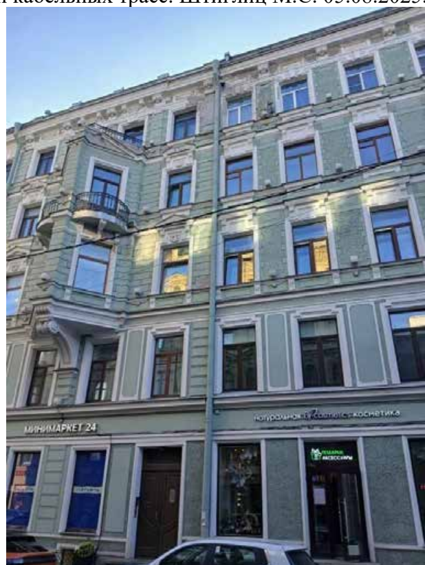
50. «Дом Меншиковых (Русско-Азиатского банка)» (Караванная ул., д. 11/64, лит. А). Лицевой фасад по ул. Караванная (фрагмент). Фото мест установки оборудования и прокладки кабельных трасс. Штиглиц М.С. 05.08.2025.
