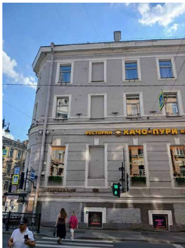
38. «Дом, в котором в 1908 -1915 гг. жил актер Варламов К.А.». (Загородный пр., д. 13, лит. А). Лицевой фасад по ул. Ломоносова (фрагмент). Фото мест установки оборудования и прокладки кабельных трасс. Штиглиц М.С. 05.08.2025.
