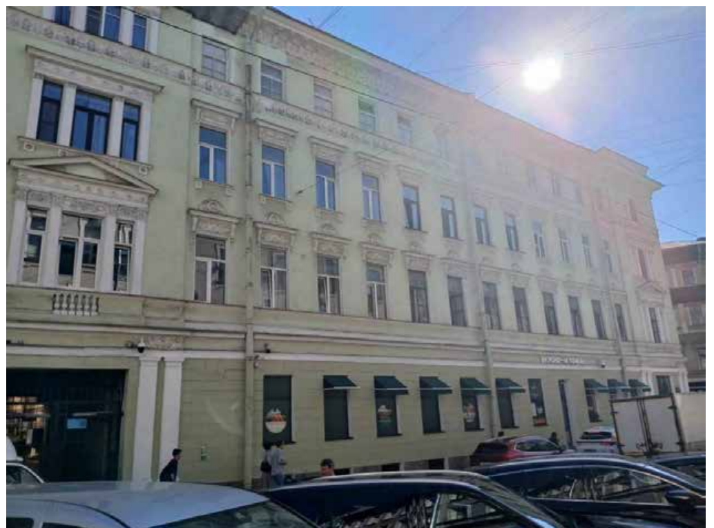
2. «Дом П.П. Жако» (Большая Морская ул., д. 11, лит. А). Лицевой фасад по Кирпичному переулку. Штиглиц М.С. 05.08.2025.
