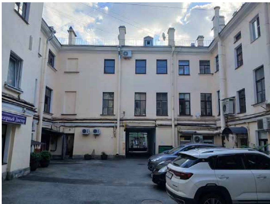
31. «Жилой дом» (Гороховая ул., д. 28, лит. А). Дворовые фасады. Фото мест установки оборудования и прокладки кабельных трасс. Штиглиц М.С. 05.08.2025.
