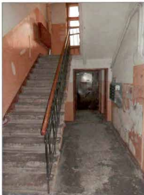
24. Двухмаршевая лестница (отдельностоящий дворовый флигель)
