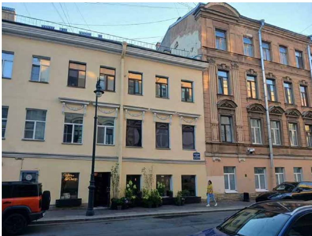
25. «Дом Капушкина» (Гагаринская ул., д. 19, лит. А). Лицевой фасад по ул. Гагаринская (фрагмент). Фото мест установки оборудования и прокладки кабельных трасс. Штиглиц М.С. 05.08.2025.
