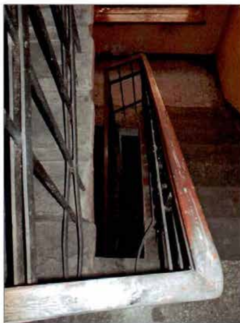
25. Двухмаршевая лестница (отдельностоящий дворовый флигель)
