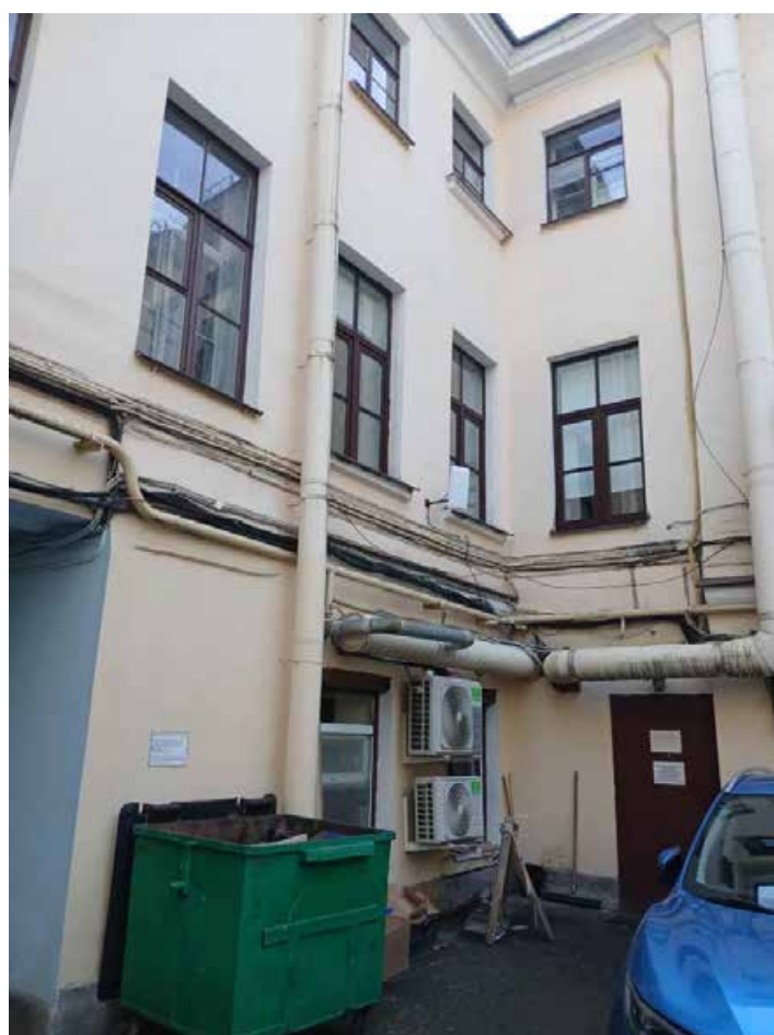
32. «Жилой дом» (Гороховая ул., д. 28, лит. А). Дворовые фасады. Фото мест установки оборудования и прокладки кабельных трасс. Штиглиц М.С. 05.08.2025.
