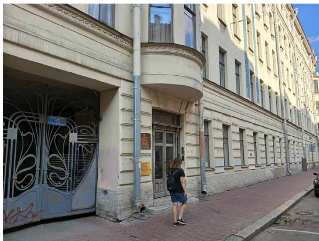
10. «Дом Санкт-Петербургского Мещанского общества» (Бородинская ул., д. 12/31, лит. А). Лицевой фасад по ул. Бородинская (фрагмент). Фото мест установки оборудования и прокладки кабельных трасс. Штиглиц М.С. 05.08.2025.
