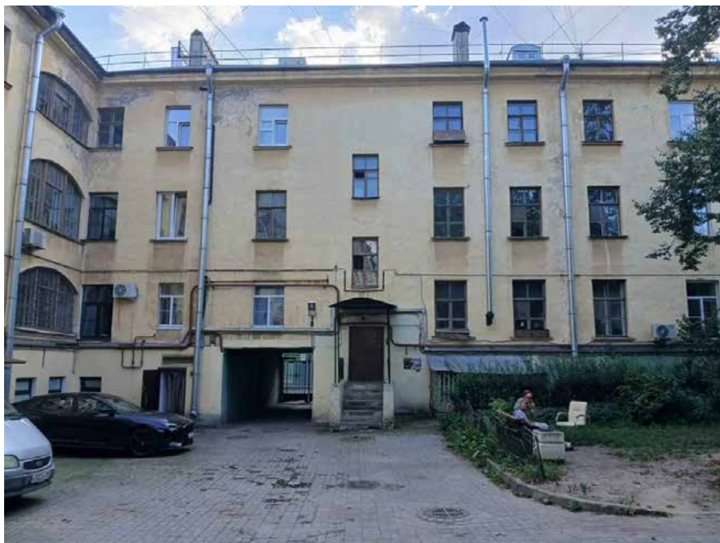
35. «Дом Кукановой А. (Кладо Л.М.)» (Гороховая ул., д. 50, лит. А). Дворовые фасады. Фото мест установки оборудования и прокладки кабельных трасс. Штиглиц М.С. 05.08.2025.
