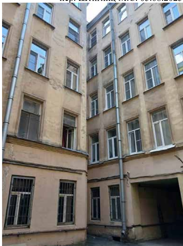
14. «Дом А.Г. Романова». (Виленский пер., д. 3, лит. А). Дворовые фасады. Фото мест установки оборудования и прокладки кабельных трасс. Штиглиц М.С. 05.08.2025.
