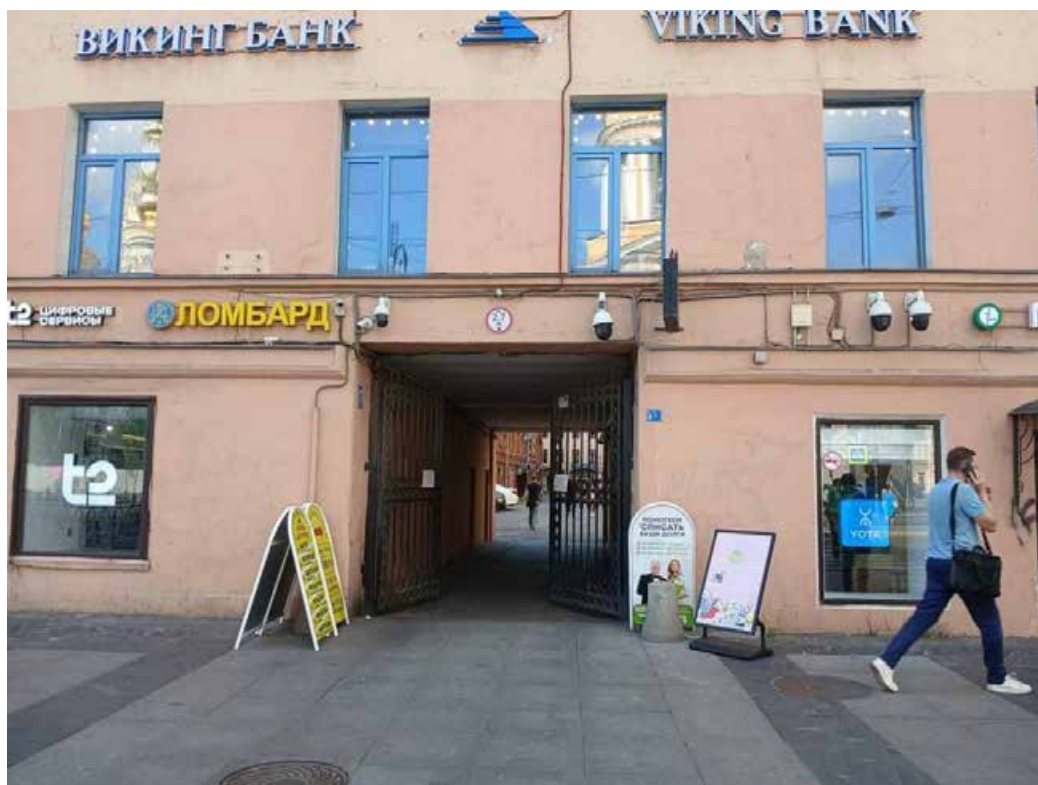
19. «Дом общества Санкт-Петербургского частного ломбарда» (Владимирский пр., д. 17, лит. А). Лицевой фасад по Владимирскому пр. (фрагмент). Фото мест установки оборудования и прокладки кабельных трасс. Штиглиц М.С. 05.08.2025.
