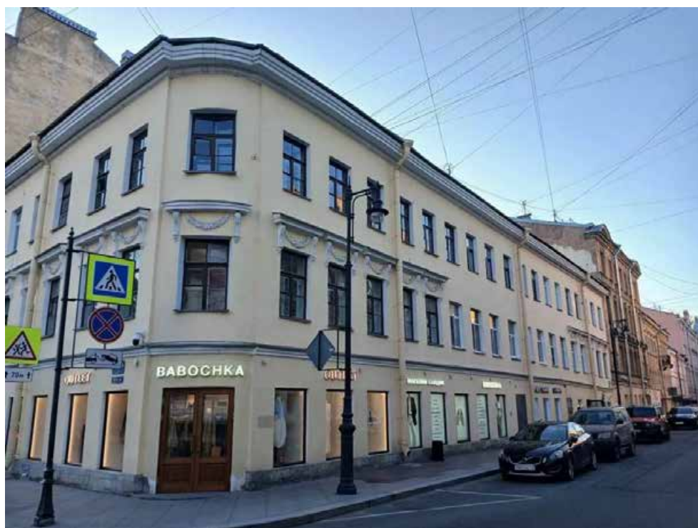
24. «Дом Капушкина» (Гагаринская ул., д. 19, лит. А). Лицевой фасад по ул. Гагаринская. Штиглиц М.С. 05.08.2025.
