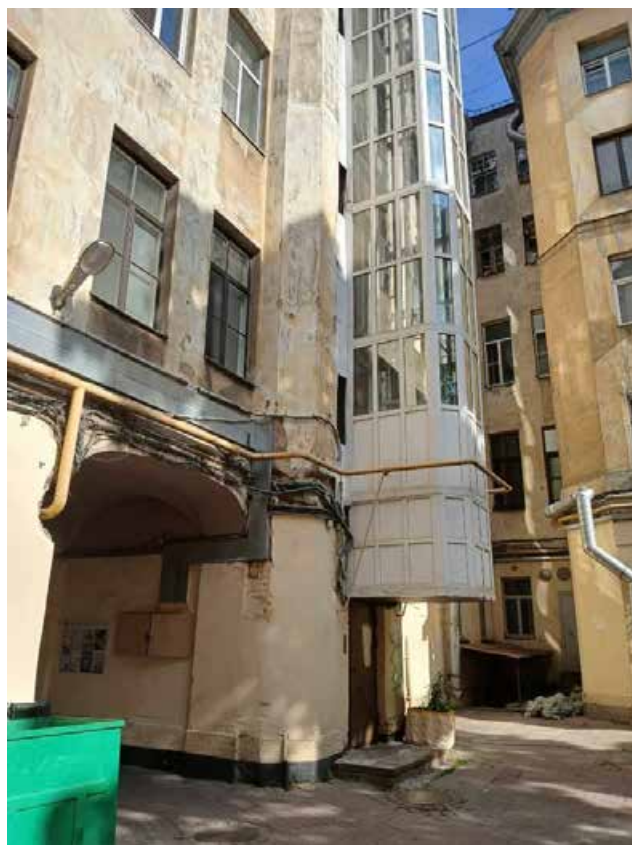
45. «Дом, где в 1865-1928 гг. жил композитор Глазунов А.К.» (Казанская ул., д. 8-10, лит. А). Дворовые фасады. Фото мест установки оборудования и прокладки кабельных трасс. Штиглиц М.С. 05.08.2025.
