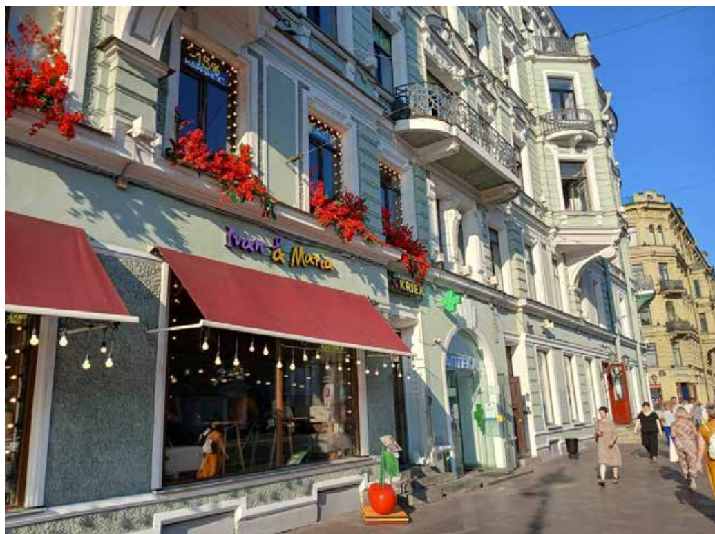
54. «Дом Меншиковых (Русско-Азиатского банка)» (Караванная ул., д. 11/64, лит. А). Лицевой фасад по Невскому пр. (фрагмент). Фото мест установки оборудования и прокладки кабельных трасс. Штиглиц М.С. 05.08.2025.
