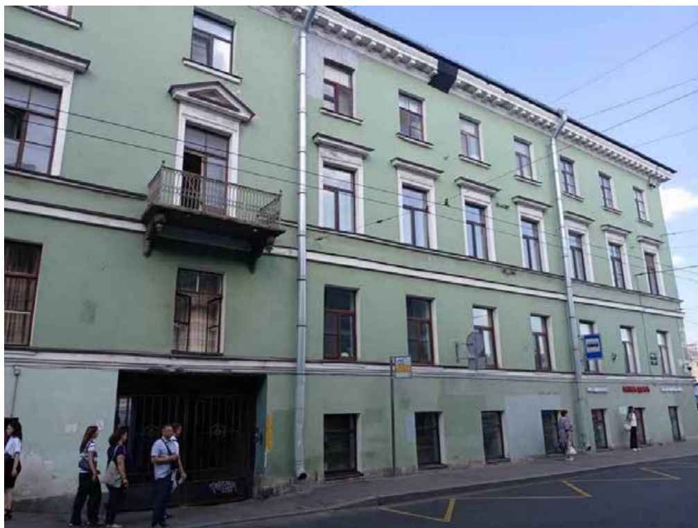
34. «Дом Кукановой А. (Кладов Л.М.)» (Гороховая ул., д. 50, лит. А). Лицевой фасад по ул. Гороховая(фрагмент). Фото мест установки оборудования и прокладки кабельных трасс. Штиглиц М.С. 05.08.2025.
