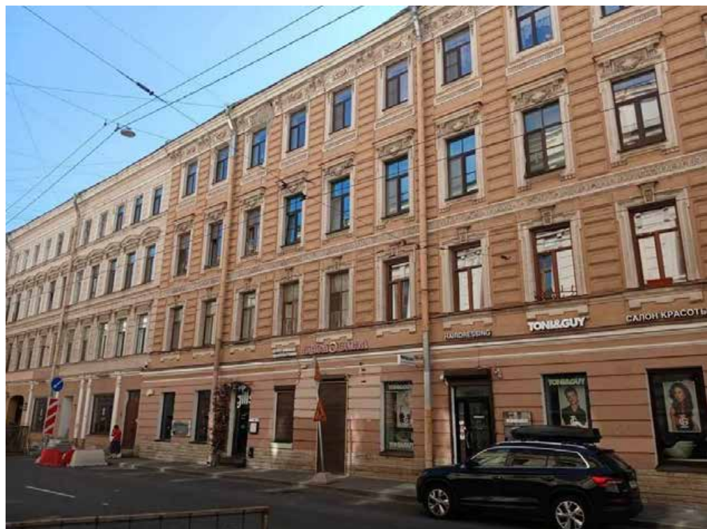
41. «Дом, где в 1865-1928 гг. жил композитор Глазунов А.К.» (Казанская ул., д. 8-10, лит. А). Лицевой фасад по ул. Казанская (фрагмент). Фото мест установки оборудования и прокладки кабельных трасс. Штиглиц М.С. 05.08.2025.
