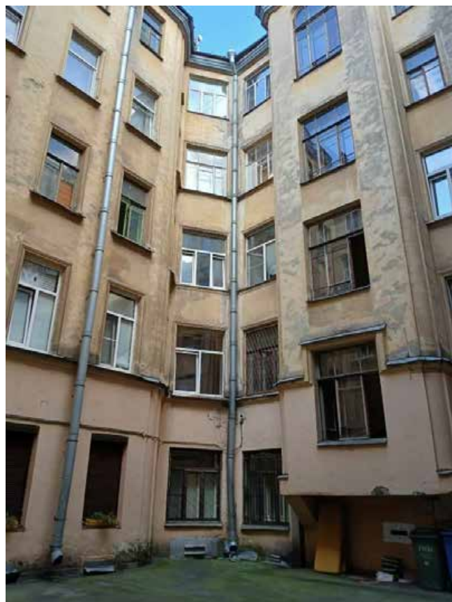
15. «Дом А.Г. Романова». (Виленский пер., д. 3, лит. А). Дворовые фасады. Фото мест установки оборудования и прокладки кабельных трасс. Штиглиц М.С. 05.08.2025.
