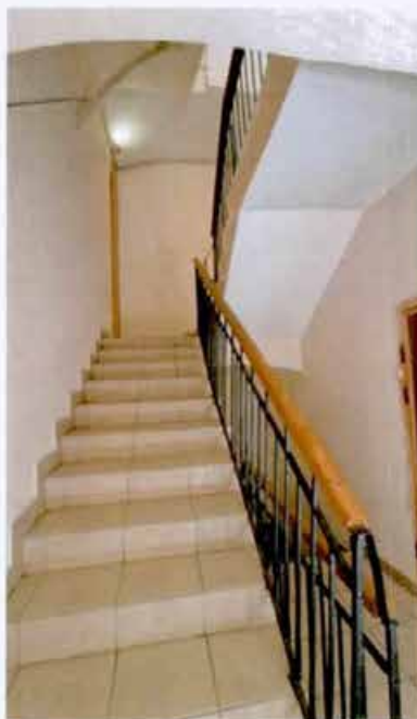
6. Лестница Л-3 (Фотография от 24.05.2024).
