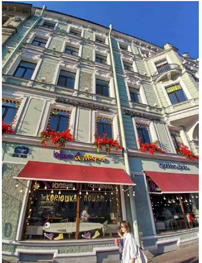
57. «Дом Меншиковых (Русско-Азиатского банка)» (Караванная ул., д. 11/64, лит. А). Лицевой фасад по Невскому пр. (фрагмент). Фото мест установки оборудования и прокладки кабельных трасс. Штиглиц М.С. 05.08.2025.
