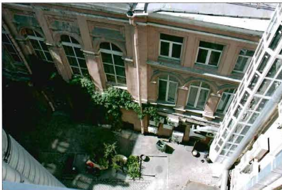
Фото №20. Северный внутренний двор.
