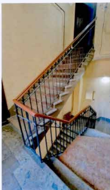
5. Лестница Л-2 (Фотография от 24.05.2024).
