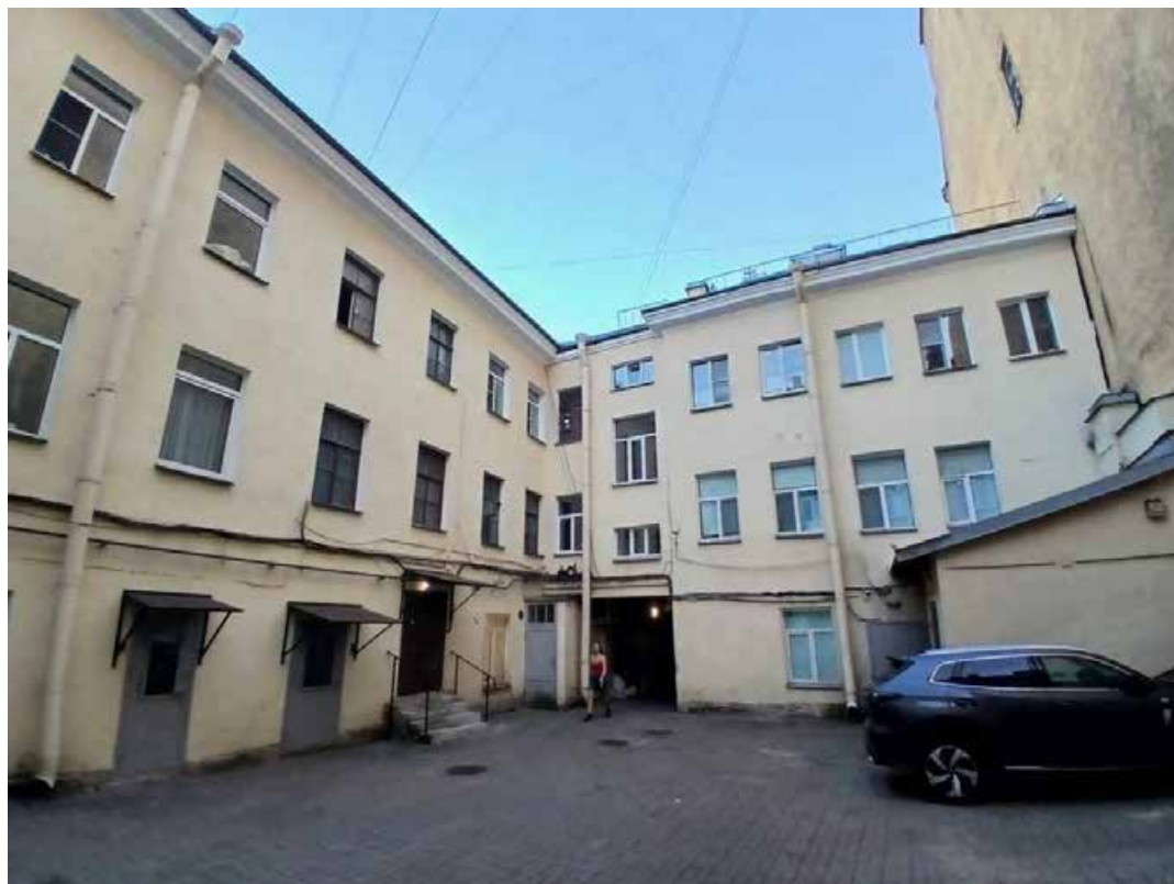
27. «Дом Капушкина» (Гагаринская ул., д. 19, лит. А). Дворовые фасады. Фото мест установки оборудования и прокладки кабельных трасс. Штиглиц М.С. 05.08.2025.
