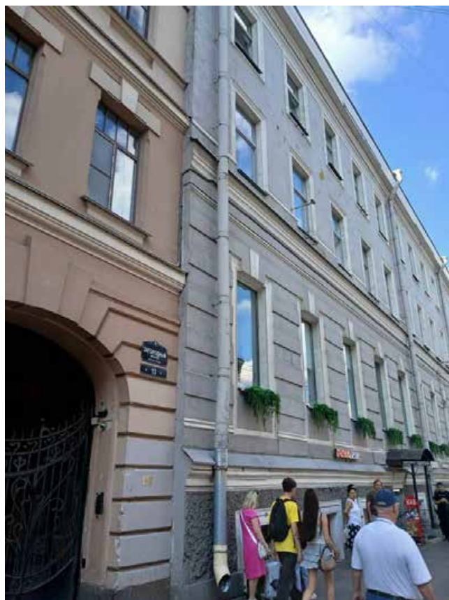
39. «Дом, в котором в 1908 -1915 гг. жил актер Варламов К.А.». (Загородный пр., д. 13, лит. А). Лицевой фасад по Загородному пр. (фрагмент). Фото мест установки оборудования и прокладки кабельных трасс. Штиглиц М.С. 05.08.2025.
