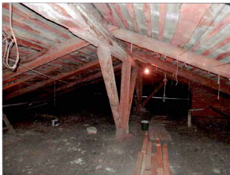
19. Отдельностоящий дворовый флигель. Стропильная система.
