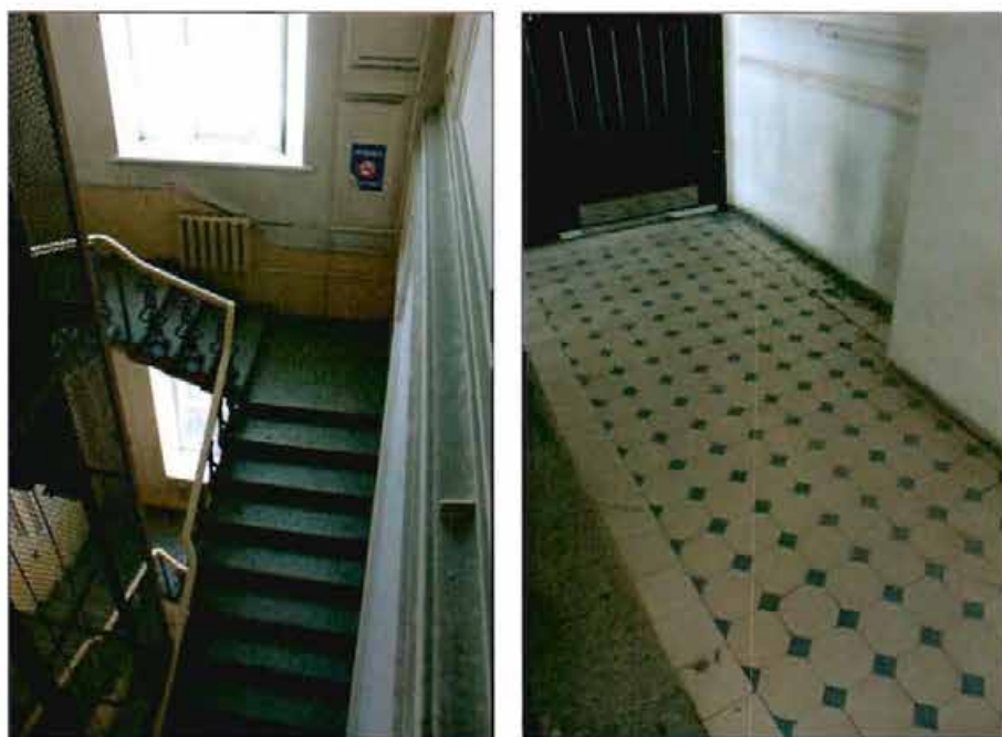
Фото №11, 12. Межэтажная трехмаршевая лестница (2ЛК).
