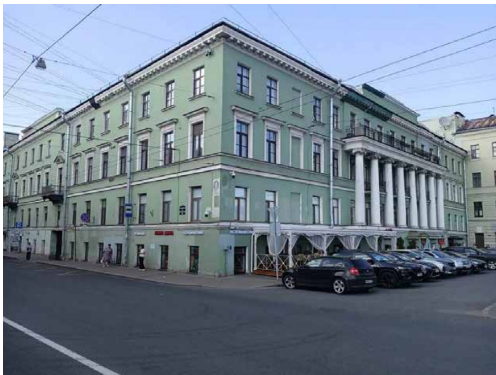
33. «Дом Кукановой А. (Кладов Л.М.)» (Гороховая ул., д. 50, лит. А). Лицевой фасад по ул. Гороховая. Штиглиц М.С. 05.08.2025.
