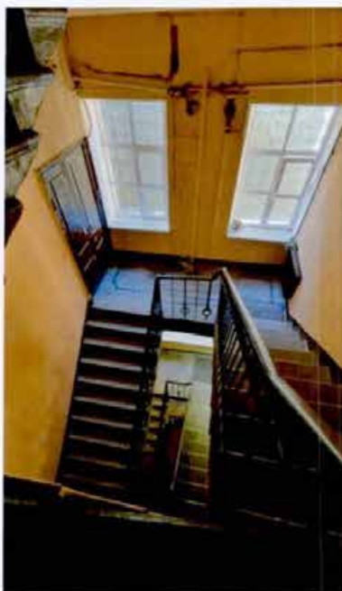
4. Лестница Л-1 (Фотография от 24.05.2024).
