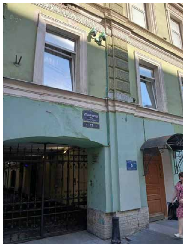
6. «Дом французского общества страхования жизни «Урбэн»» (Большая Морская ул., д. 17, лит. А). Лицевой фасад по ул. Большая Морская (фрагмент). Фото мест установки оборудования и прокладки кабельных трасс. Штиглиц М.С. 05.08.2025.
