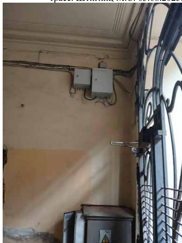
12. «Дом Санкт-Петербургского Мещанского общества» (Бородинская ул., д. 12/31, лит. А). Арочный проезд. Фото мест установки оборудования и прокладки кабельных трасс. Штиглиц М.С. 05.08.2025.
