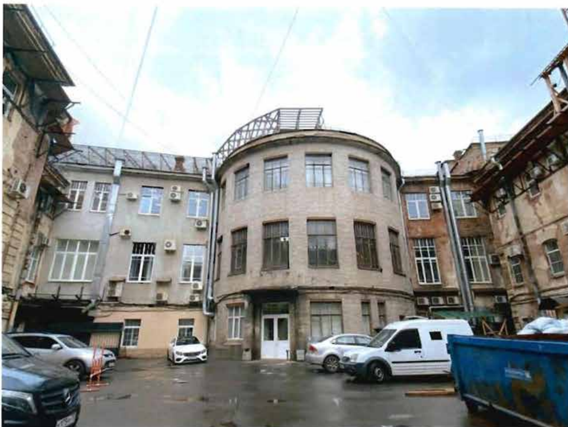
2. Общий вид на объект культурного наследия.
