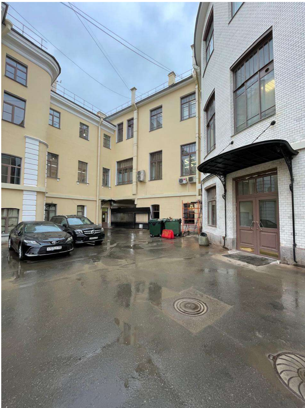
3. ОКНФЗ «Дом, где в первой половине XIX в. размещалась Российско-Американская компания. Здесь в 1820-х гг. жили декабристы Бестужев-Марлинский А.А. и Рылеев К.Ф.», расположенный по адресу: Санкт-Петербург, набережная реки Мойки, дом 72, литера А. Вид на дворовые фасады. Дата дополнительной съёмки: 24.03.2025.
