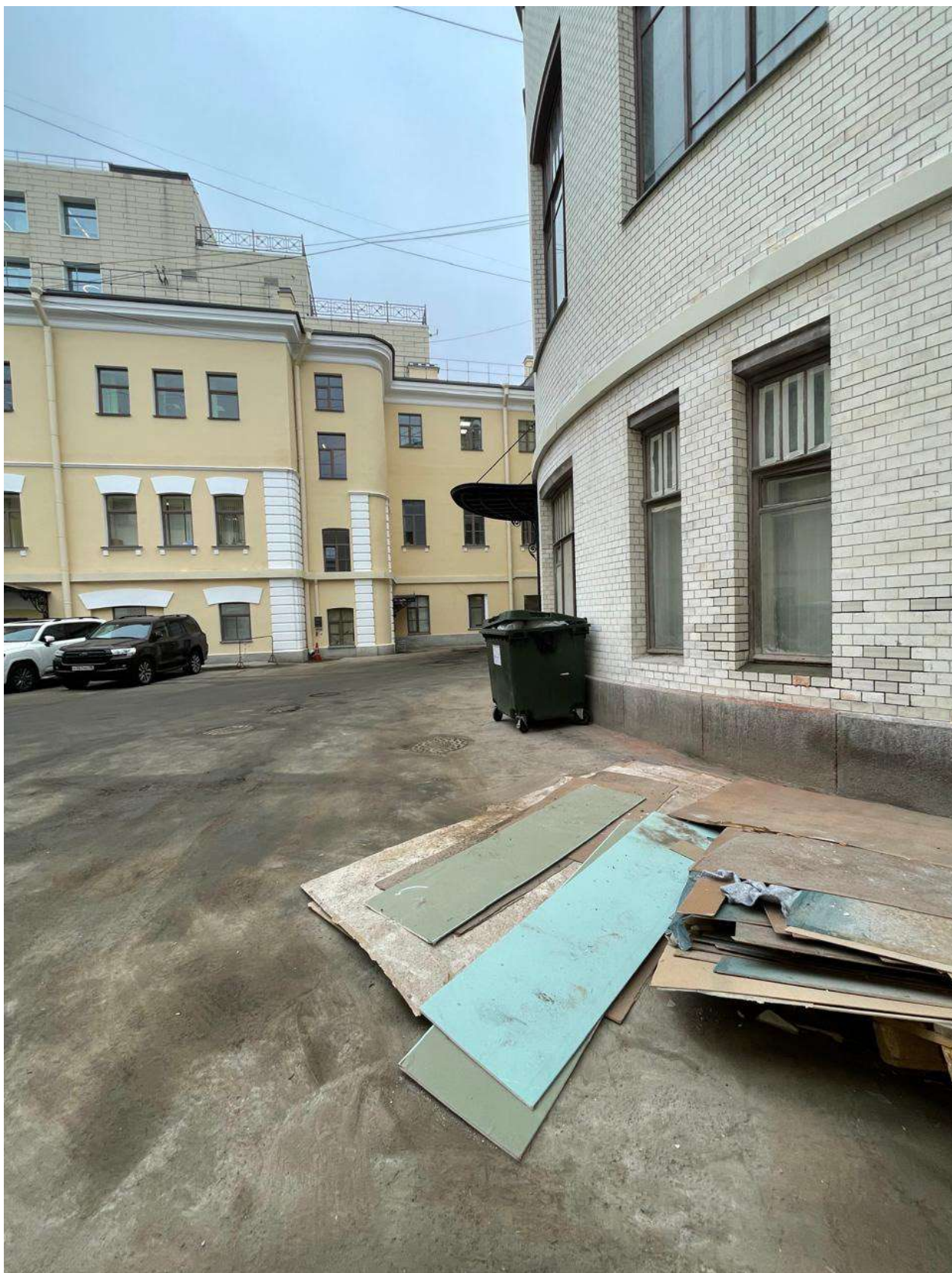
1. ОКНФЗ «Дом, где в первой половине XIX в. размещалась Российско-Американская компания. Здесь в 1820-х гг. жили декабристы Бестужев-Марлинский А.А. и Рылеев К.Ф.», расположенный по адресу: Санкт-Петербург, набережная реки Мойки, дом 72, литера А. Вид на дворовые фасады. Дата дополнительной съёмки: 24.03.2025.
