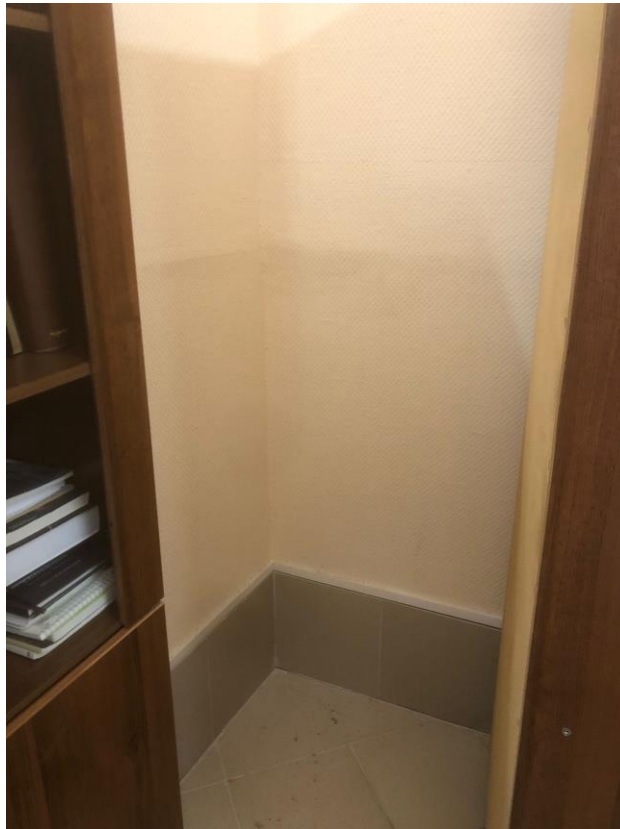
3. Здание по адресу: Санкт-Петербург, улица Профессора Попова, д. 4, Лит. В, помещение 101. Место установки камина.
