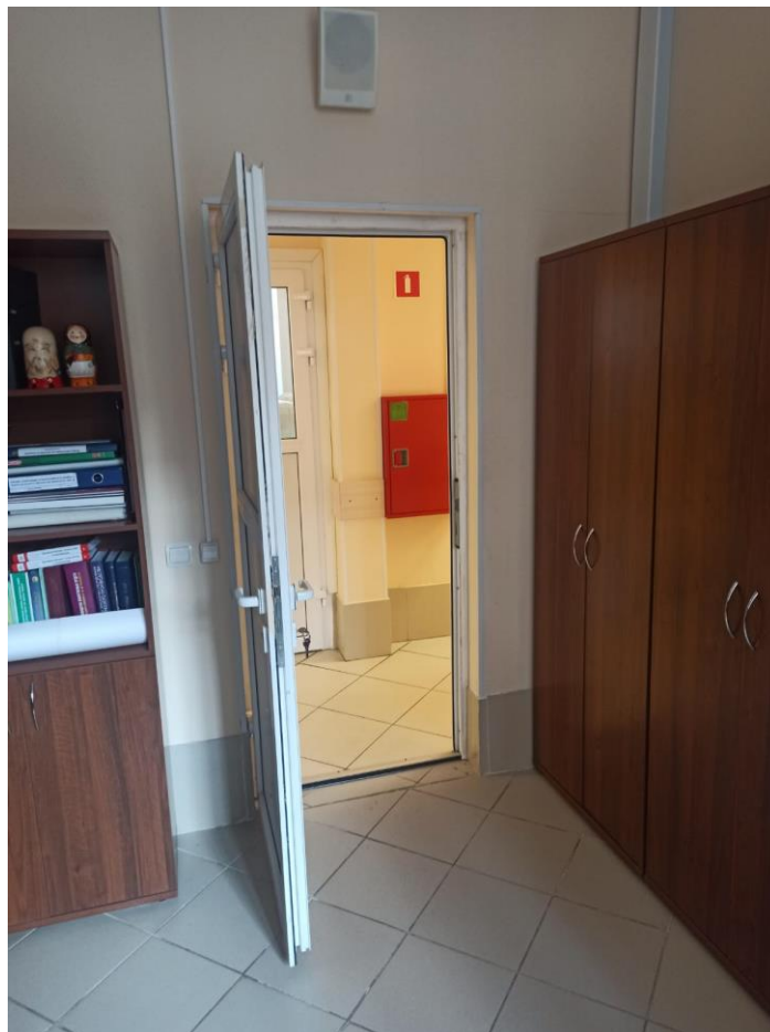
1. Здание по адресу: Санкт-Петербург, улица Профессора Попова, д. 4, Лит. В, помещение 101. Вид на входной проем в помещение №101.
