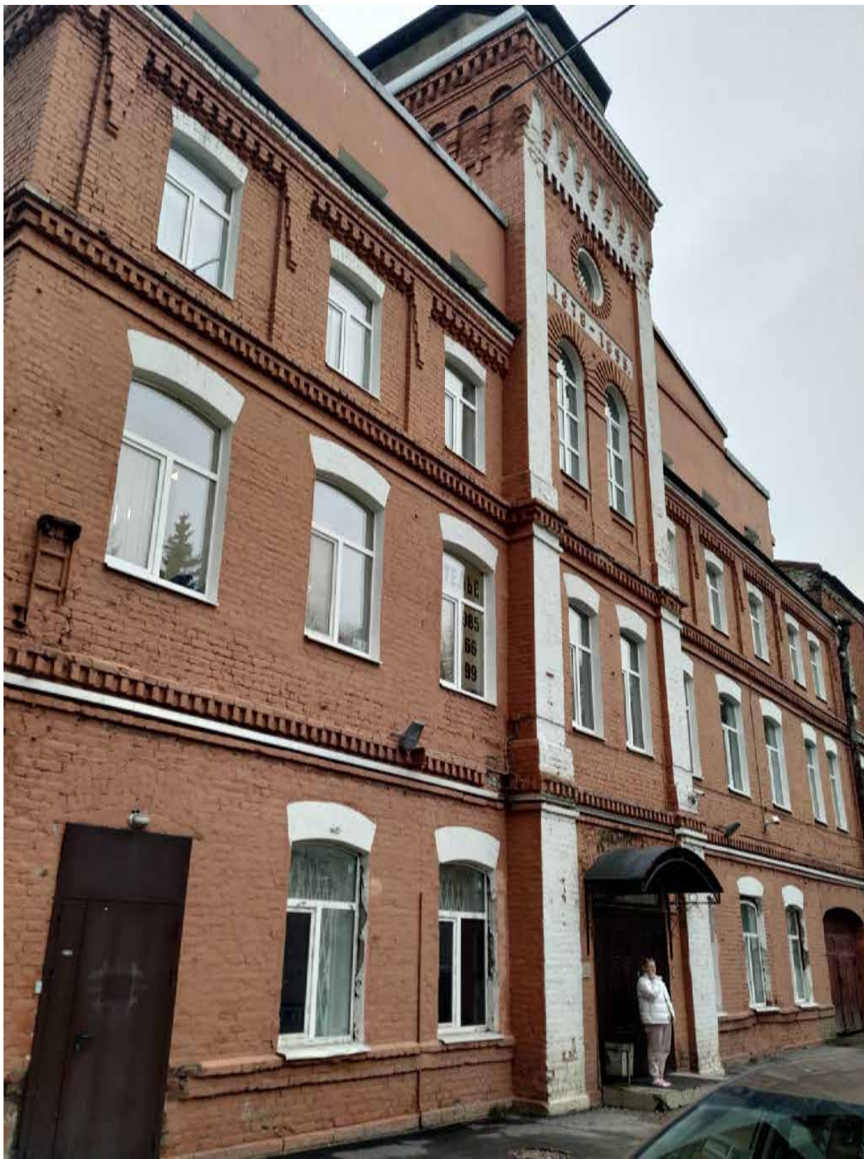
2. Фото 01 июля 2025г. Общий вид юго-западного фасада с проездной аркой. Комплекс машиностроительного завода Н.Н. Струка. Производственное здание.
