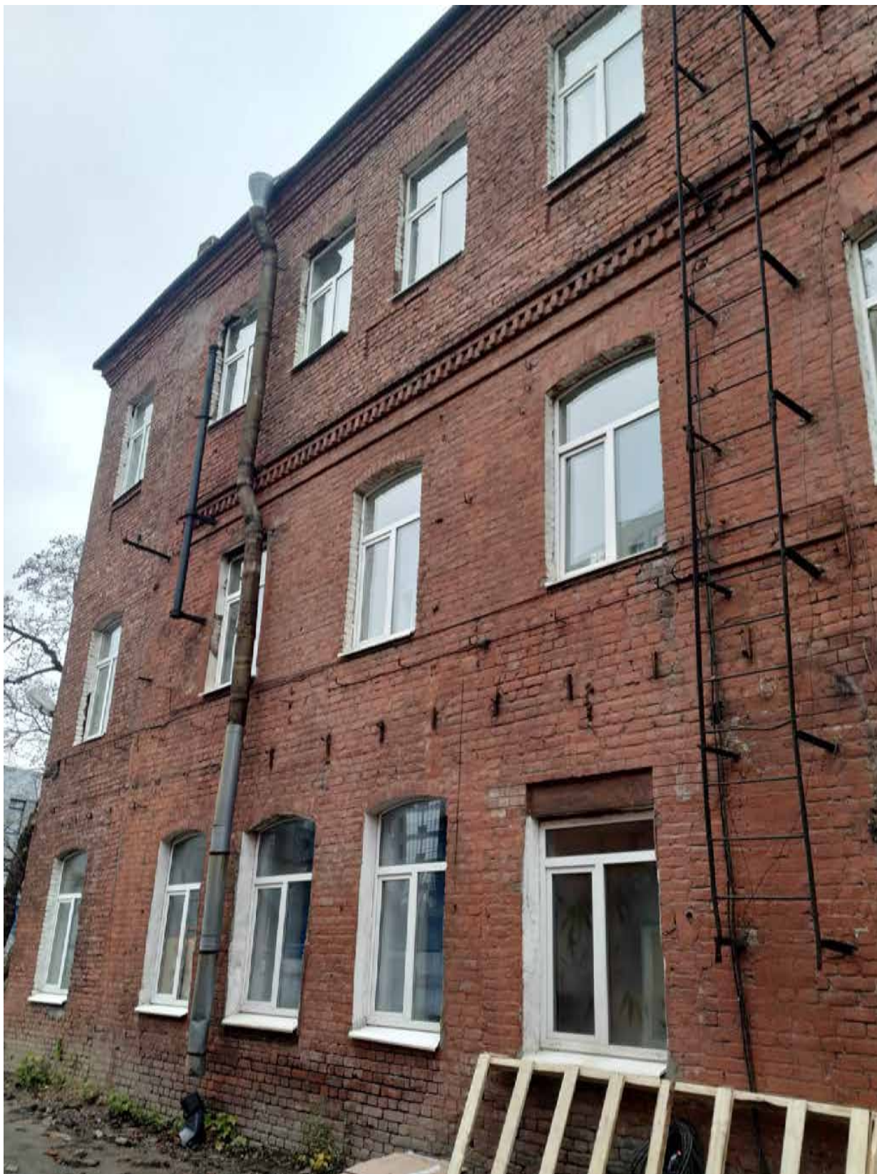
10. Фото 01 июля 2025г. Фрагмент северо-восточного фасада. Комплекс машиностроительного завода Н.Н. Струка. Административное здание абразивного завода
