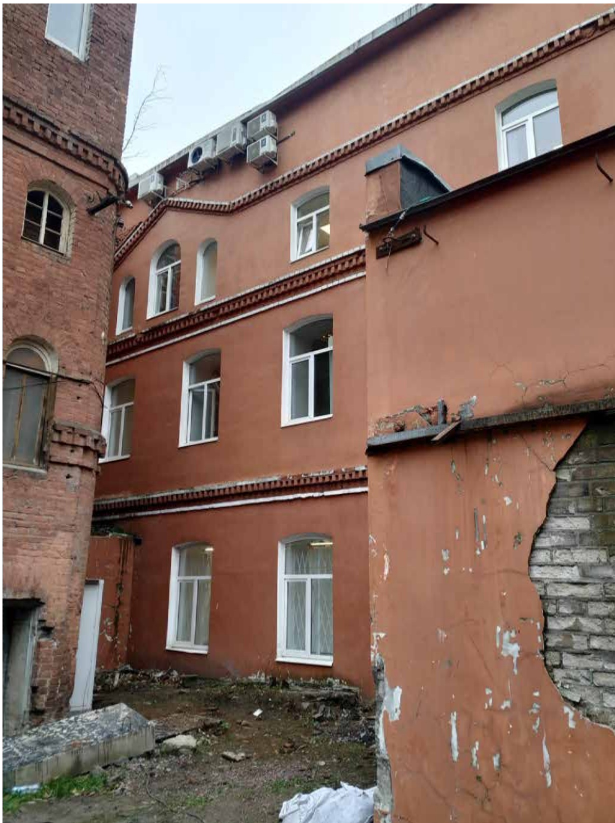
6. Фото 01 июля 2025г. Фрагмент юго-восточного фасада. Комплекс машиностроительного завода Н.Н. Струка. Производственное здание.
