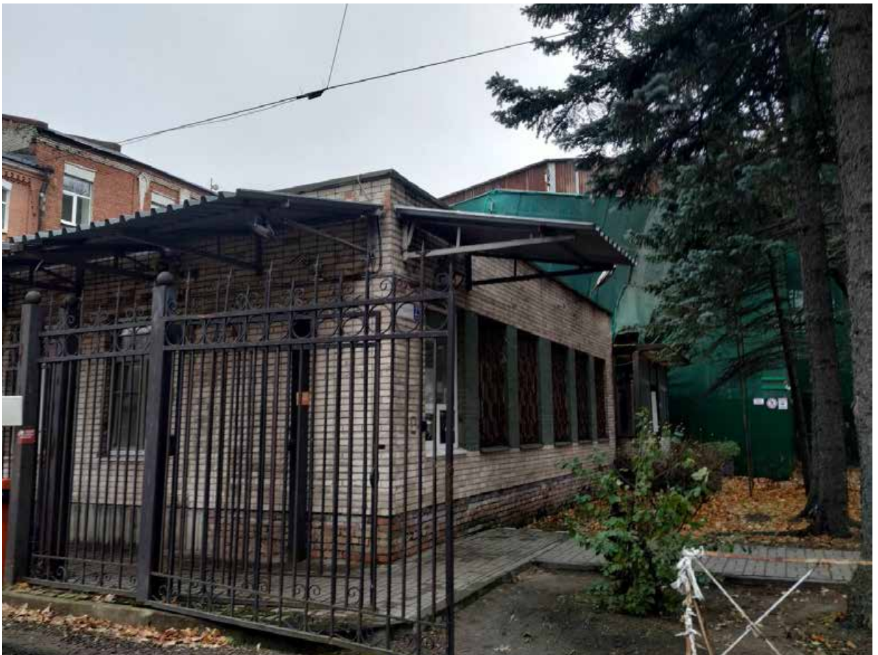
8. Фото 01 июля 2025г. Общий вид пристройки здания проходной. Дом 23, лит Ш.
