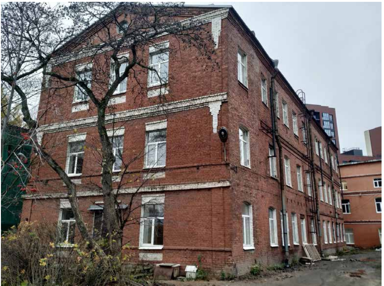
9. Фото 01 июля 2025г. Общий вид восточного фасада. Комплекс машиностроительного завода Н.Н. Струка. Административное здание абразивного завода.
