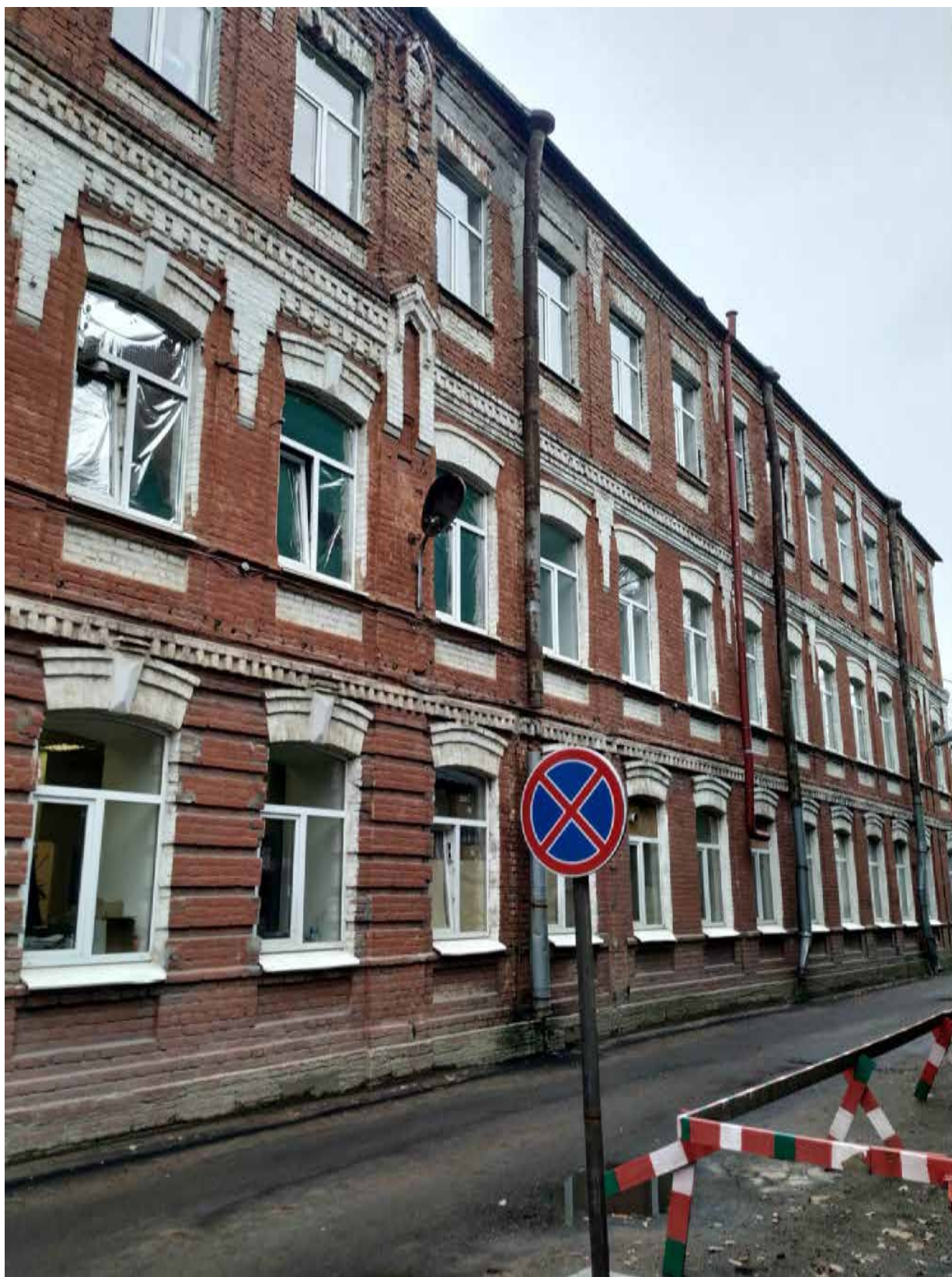
11. Фото 01 июля 2025г. Общий вид южного фасада. Комплекс машиностроительного завода Н.Н. Струка. Административное здание абразивного завода
