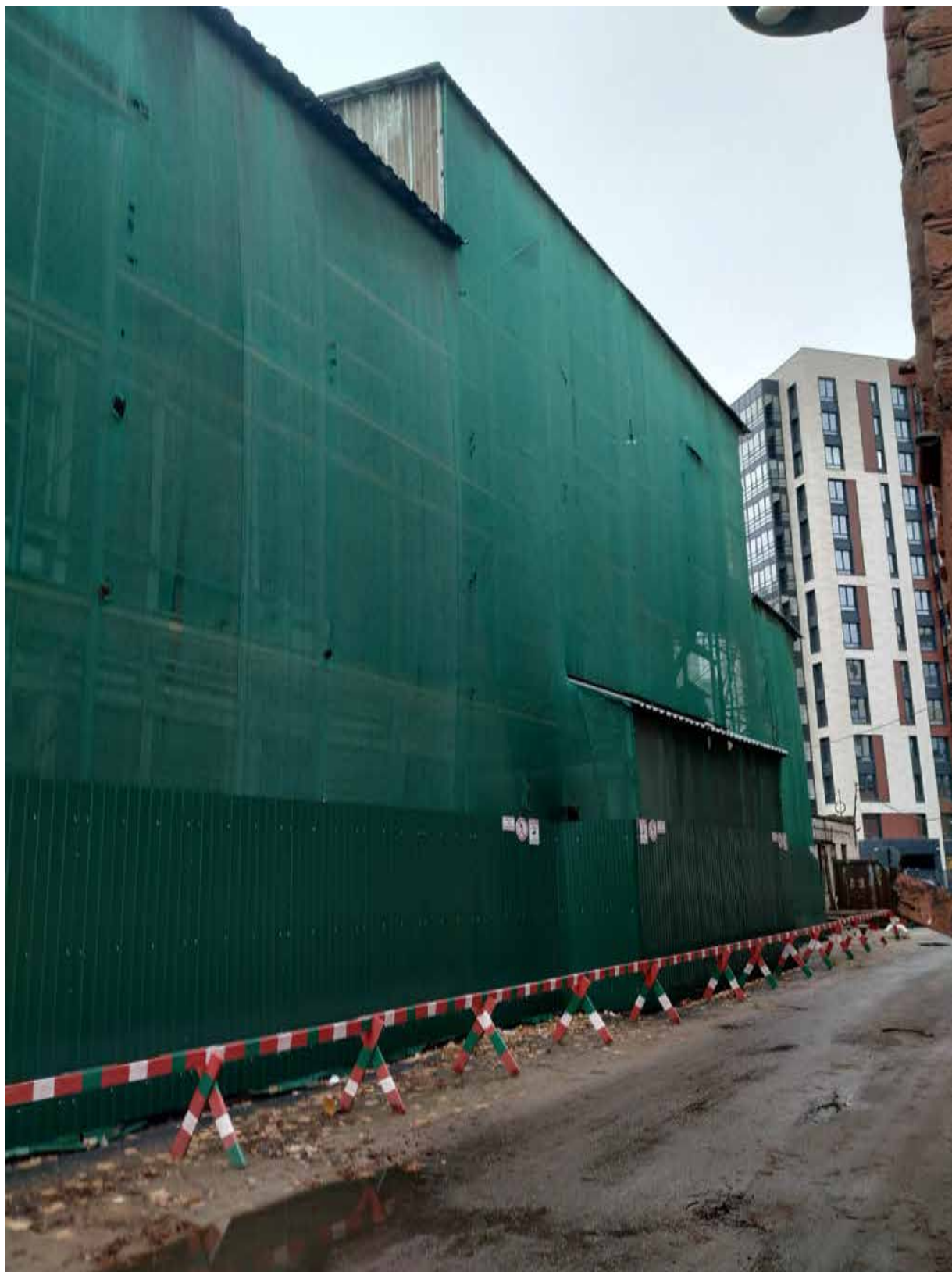
7. Фото 01 июля 2025г. Общий вид противоаварийного укрепления и временной кровли Особняка Н.Н. Струка. Комплекс машиностроительного завода.
