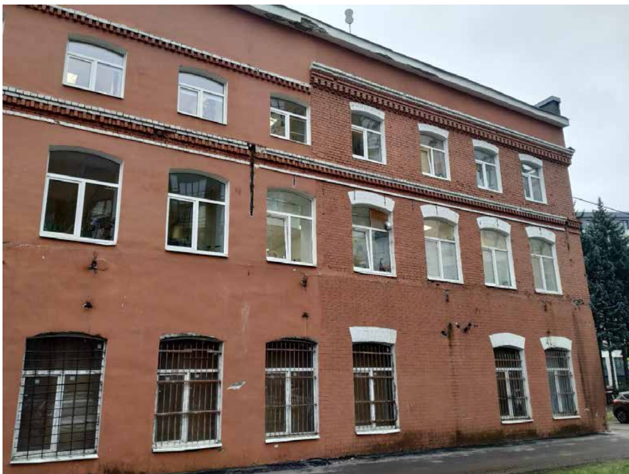
3. Фото 01 июля 2025г. Общий северо-западного фасада. Комплекс машиностроительного завода Н.Н. Струка. Производственное здание.
