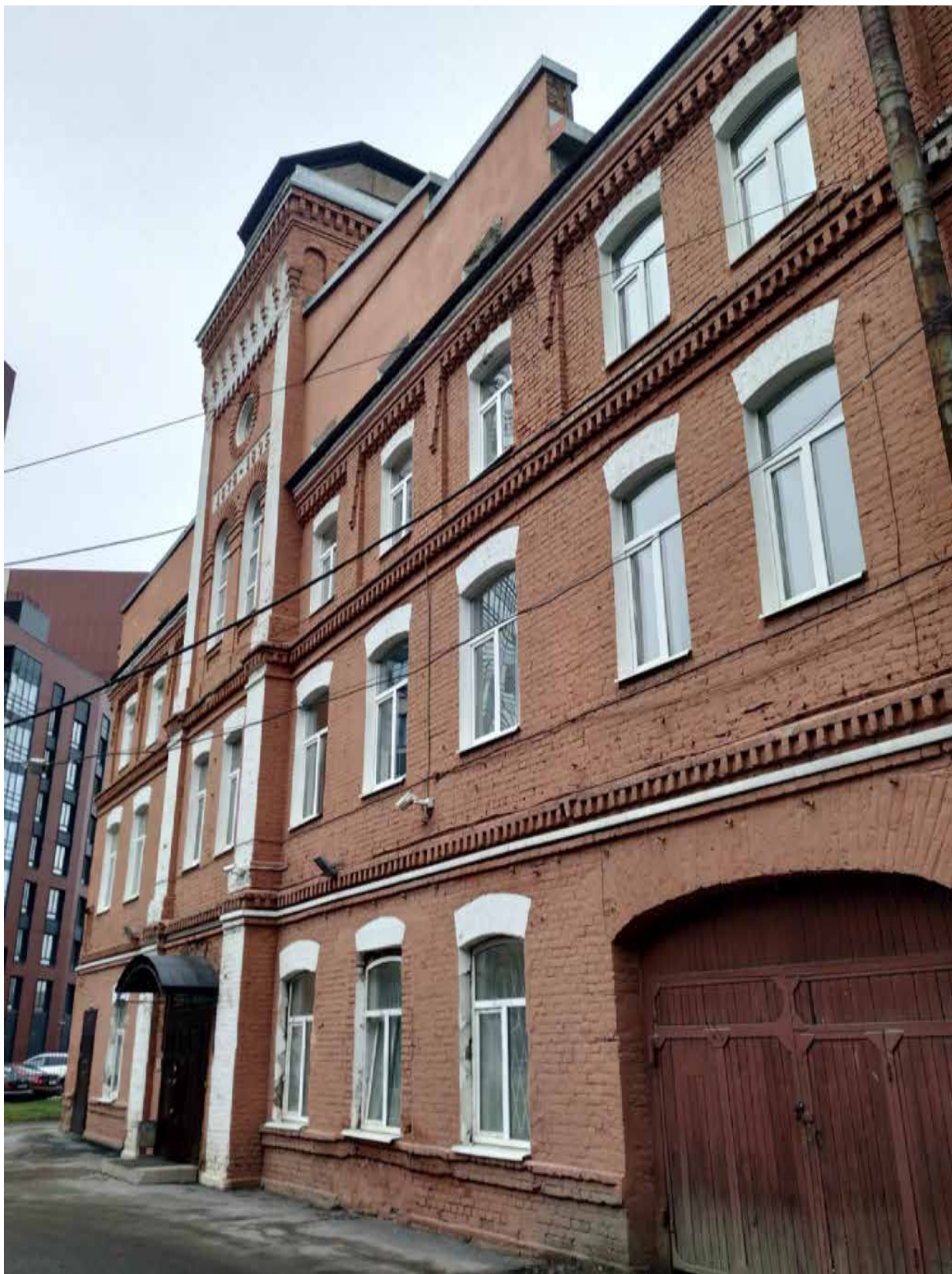
5. Фото 01 июля 2025г. Общий северо-западного фасада над. Комплекс машиностроительного завода Н.Н. Струка. Производственное здание.
