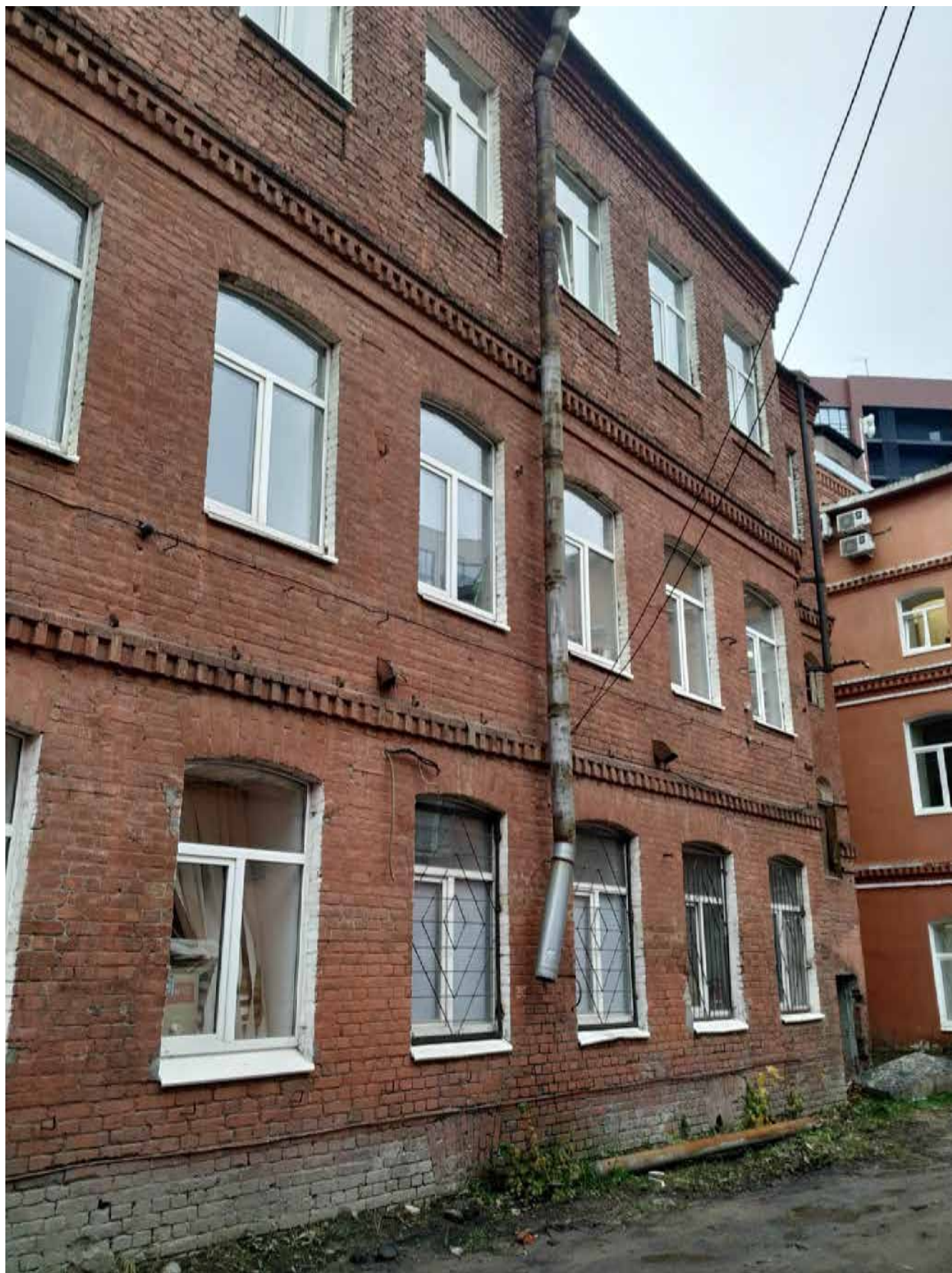
12. Фото 01 июля 2025г. Фрагмент северо-восточного фасада. Комплекс машиностроительного завода Н.Н. Струка. Административное здание абразивного завода
