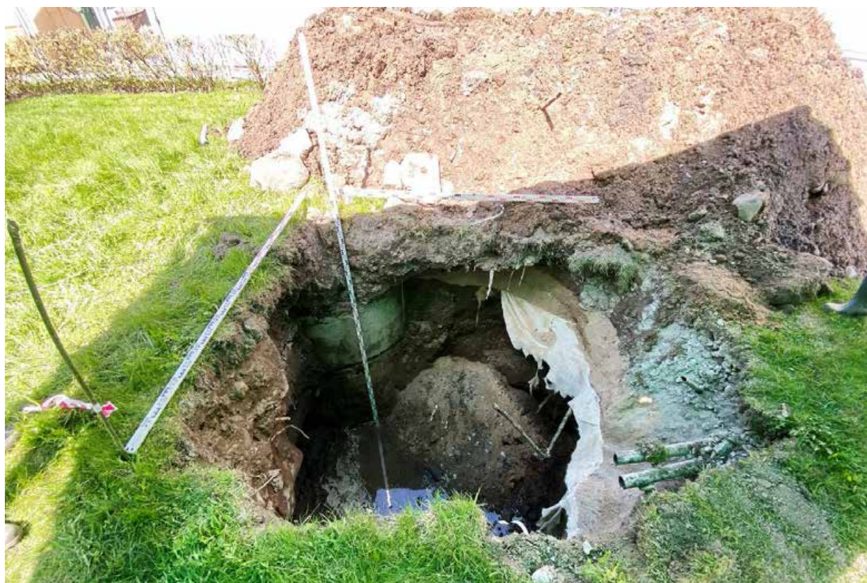
Рис. 50. СПБ-2024. Красногвардейский район. Земельный участок: 78:11:0006047:2514. Шурф №2. Общий вид шурфа на этапе прекращения работ.
