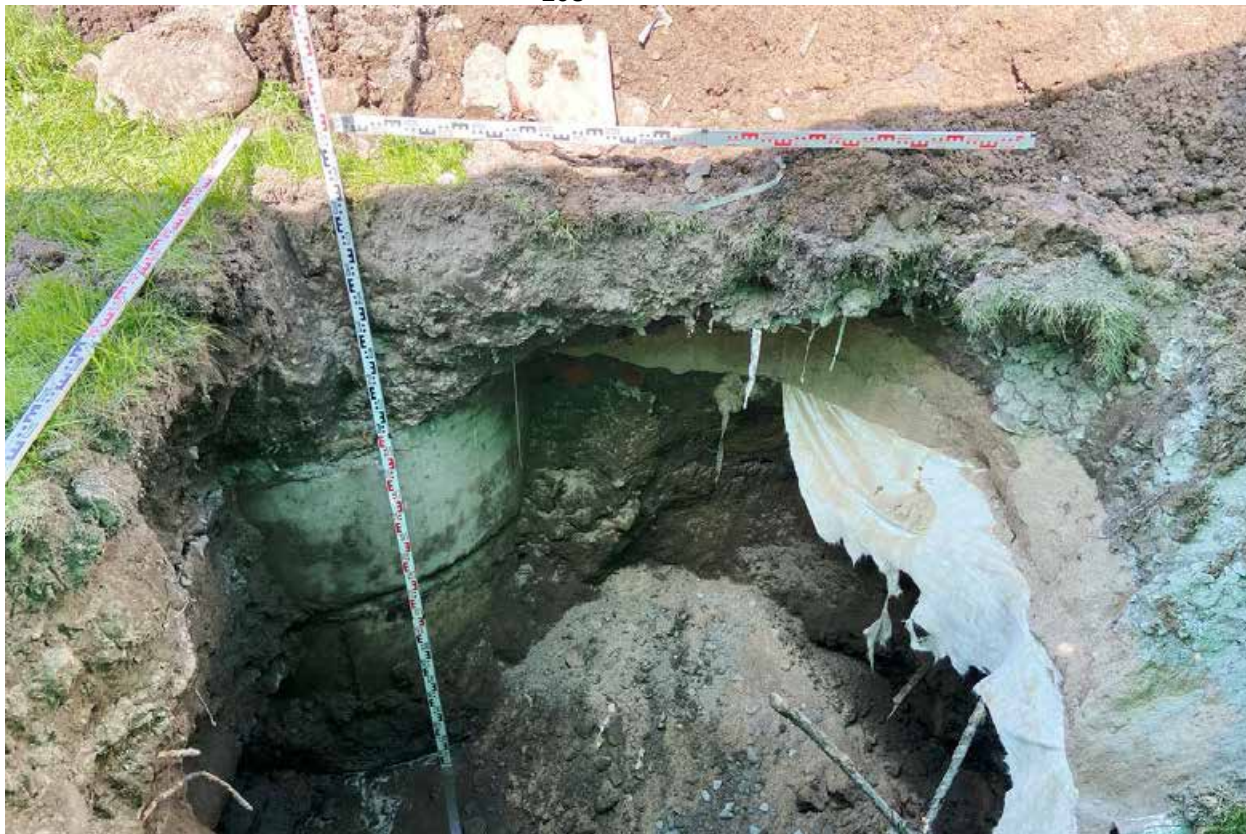
Рис. 49. СПБ-2024. Красногвардейский район. Земельный участок: 78:11:0006047:2514. Шурф №2. Стратиграфия. Обвал на месте северной стенки. Вид с юга.
