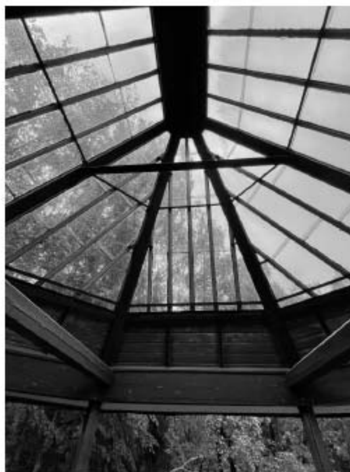
Фото №46. Стропильная система над открытой верандой.
