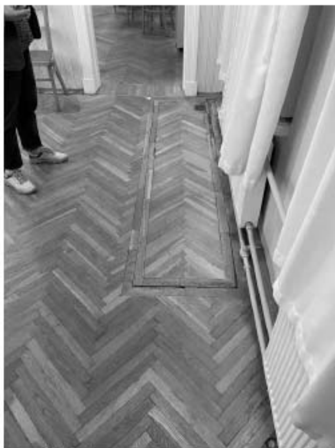
Фото №92. Люк в техподполье в помещении 1.13.
