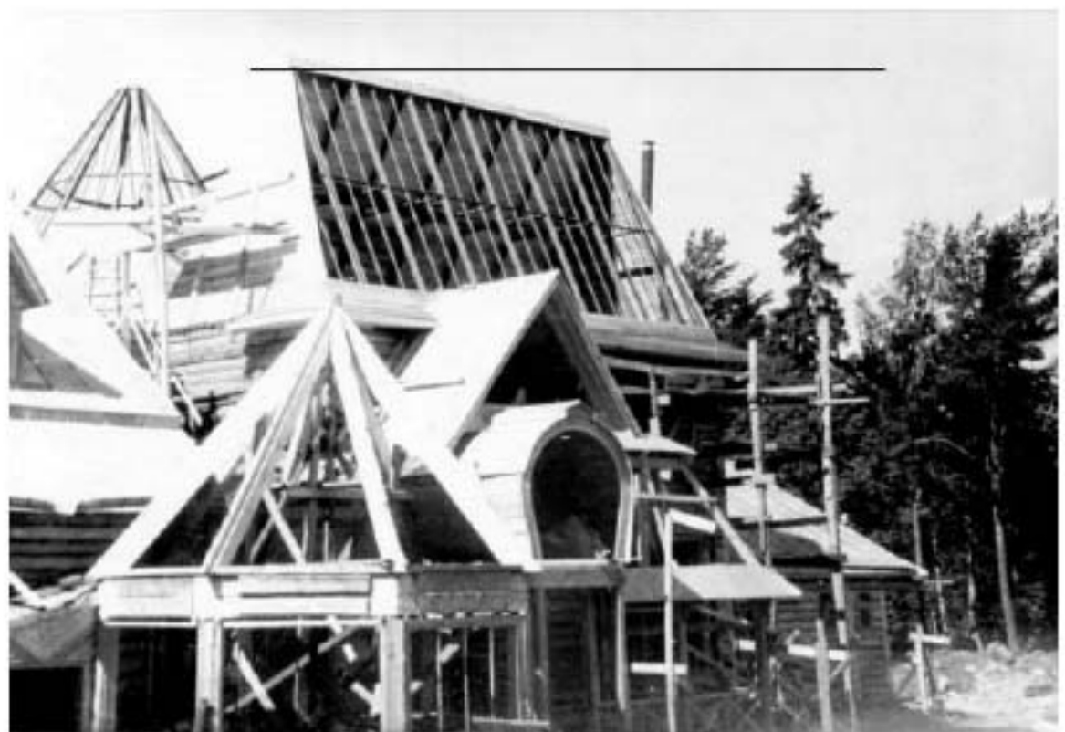
Илл. 52. Усадьба И.Е. Репина «Пенать». Работы по восстановлению жилого дома. Фотография. Конец 1950-х-начало 1960-х гг. https://terijoki.spb.ru .
