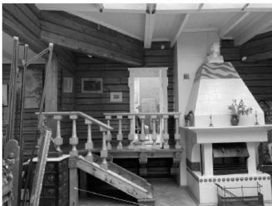
Фото №21. Помещение 2.6 по плану ПИБ, камин, переход в помещение 2.7.
