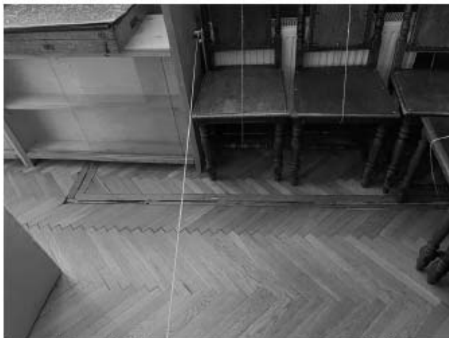
Фото №95. Люк в техподполье в помещении 1.24.
