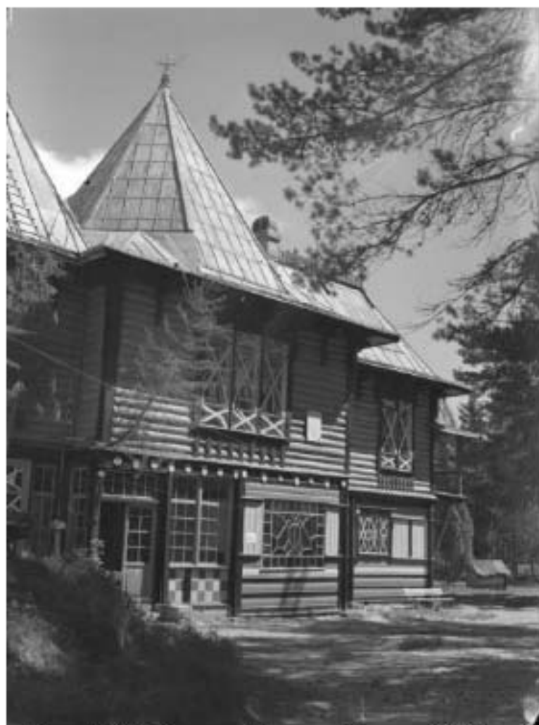
Илл. 45. Куоккала. Усадьба И.Е. Репина «Пенать». Дом жилой. Южный фасад. Фрагмент. Фотография. 1942 г. https://terijoki.spb.ru .
