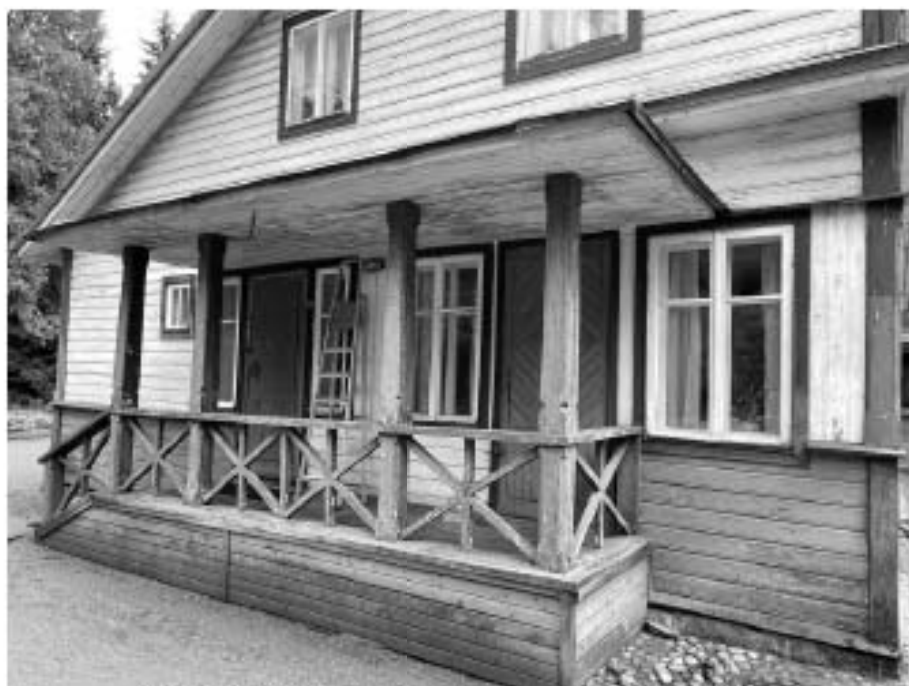
Фото №110. Крыльцо западного фасада здания.
