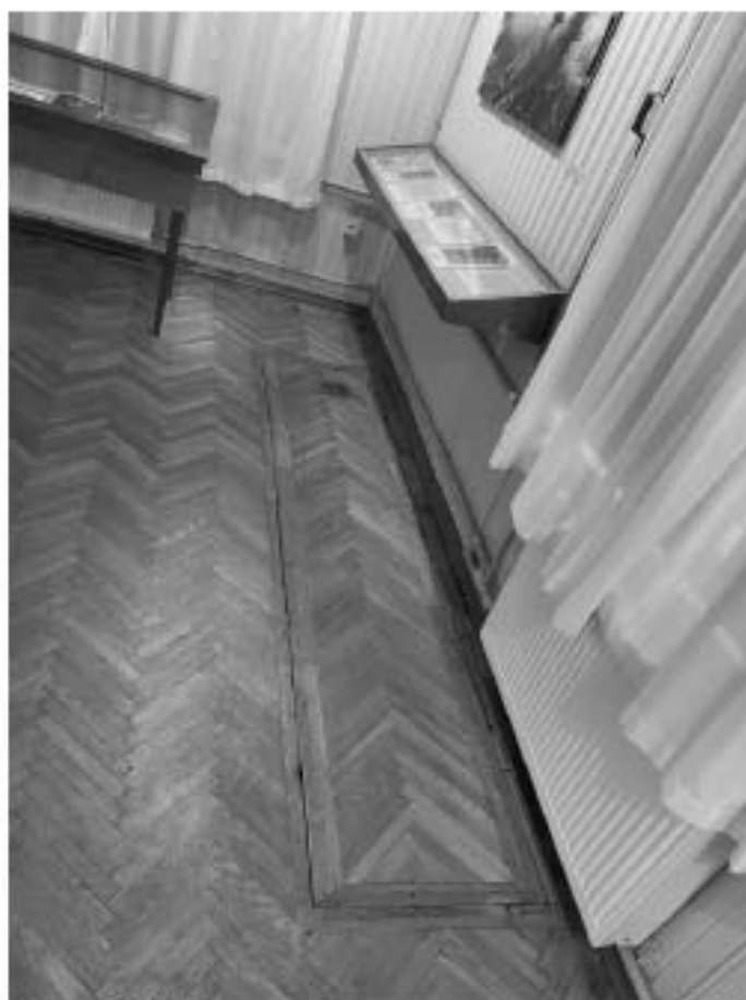
Фото №94. Люк в техподполье в помещении 1.25.
