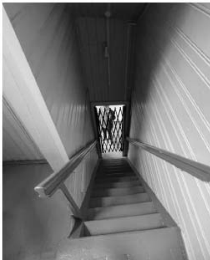
Фото №56. Лестница на 1 этаж из помещения 1.17 по плану ПИБ.
