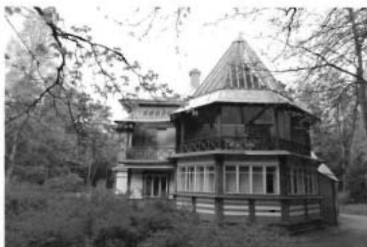
4. Южный лицевой фасад:
