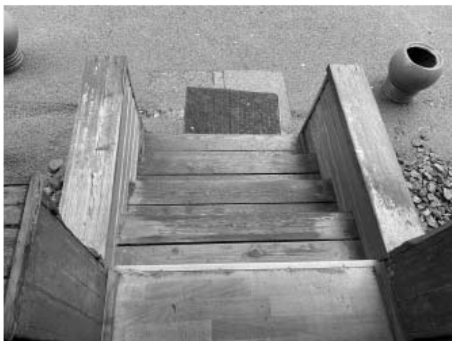
Фото №100. Крыльцо, вход на веранду.
