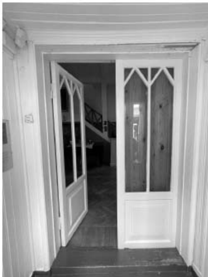
Фото №64. Дверной проем из помещения 1.16 в помещение 1.18 по плану ПИБ.
