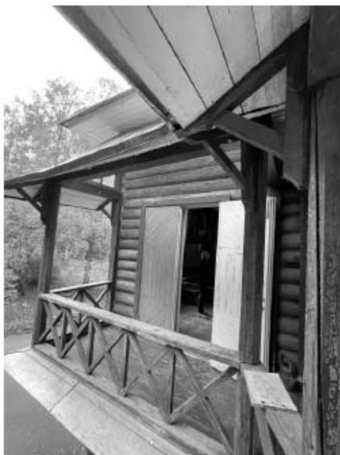
Фото №50. Переход из помещения 2.15 в помещение 2.6 по плану ПИБ.
