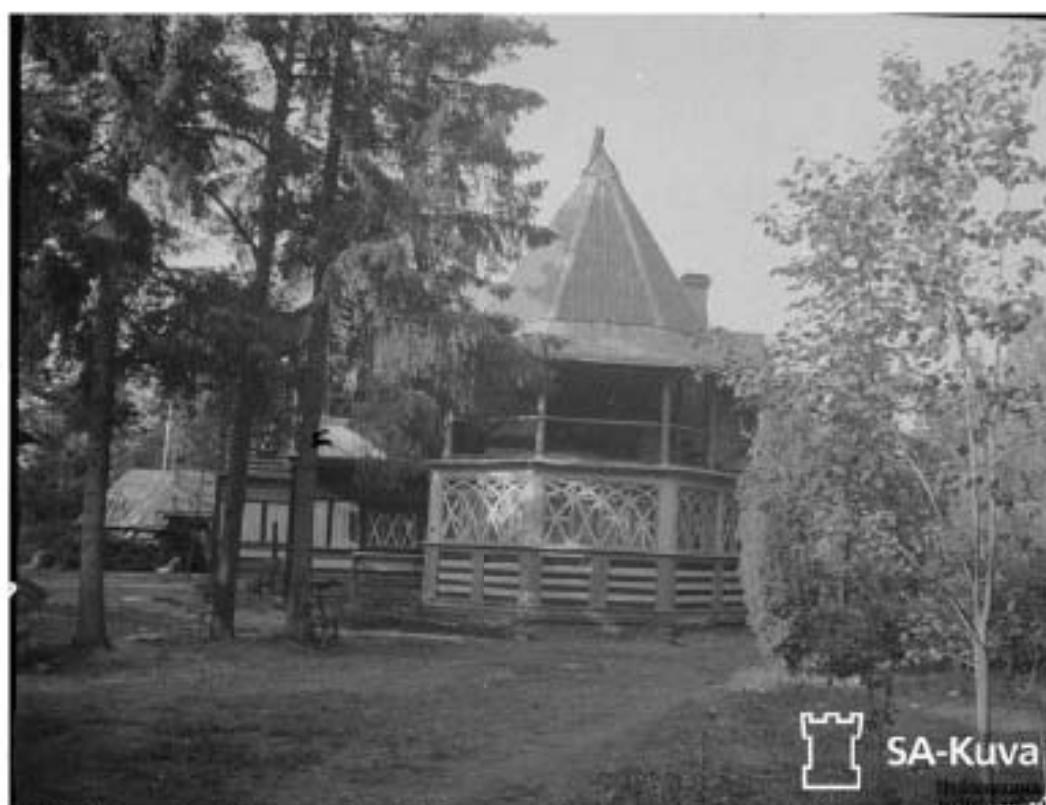
Илл. 42. Куоккала. Усадьба И.Е. Репина «Пенать». Дом жилой. Восточный фасад. 25.09.1941 г. Фотография из архива Сил Оборона Финляндии http://sa-kuva.fi
