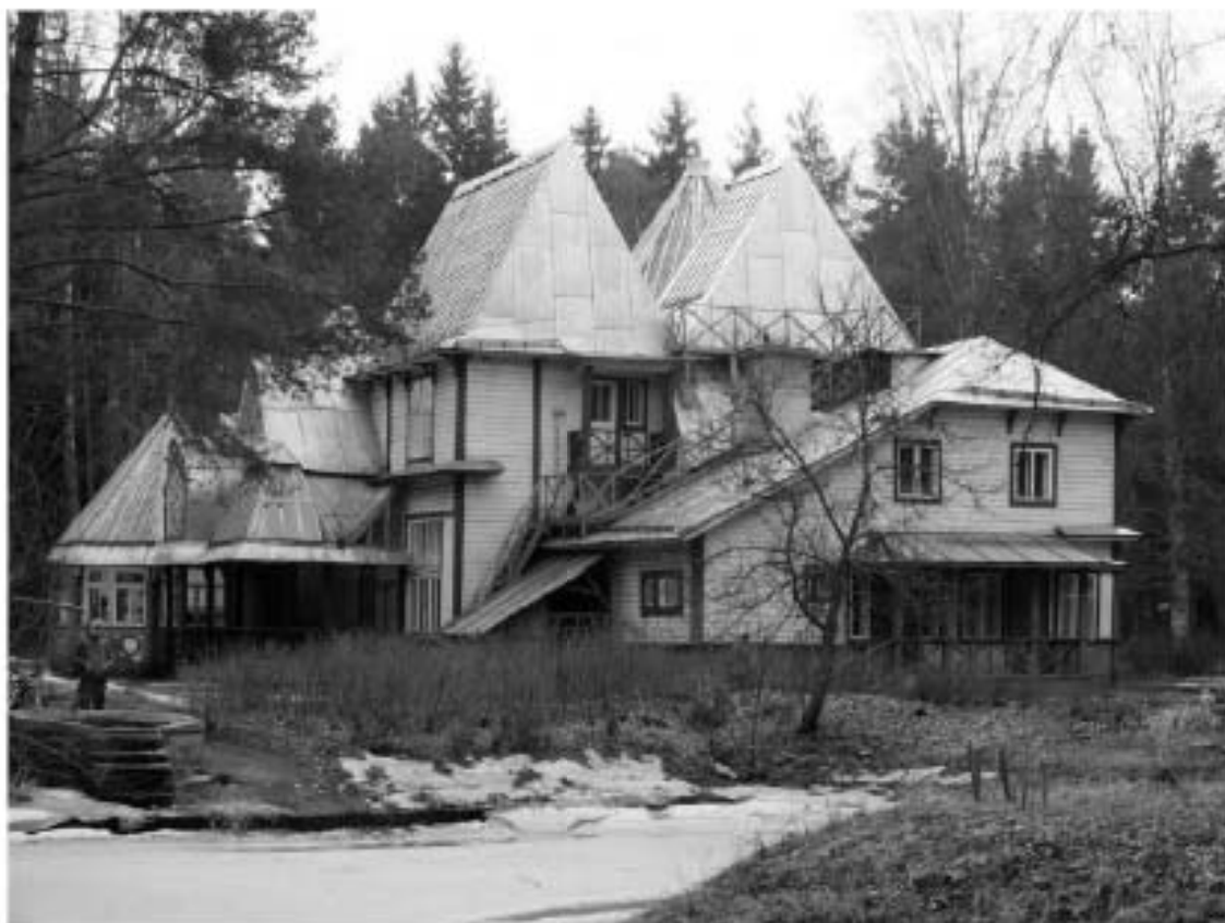
Илл. 63. Усадьба И.Е. Репина «Пенать». Дом жилой. Вид на западный фасад. Фотография. 2010-е гг. www.citywalls.ru .
