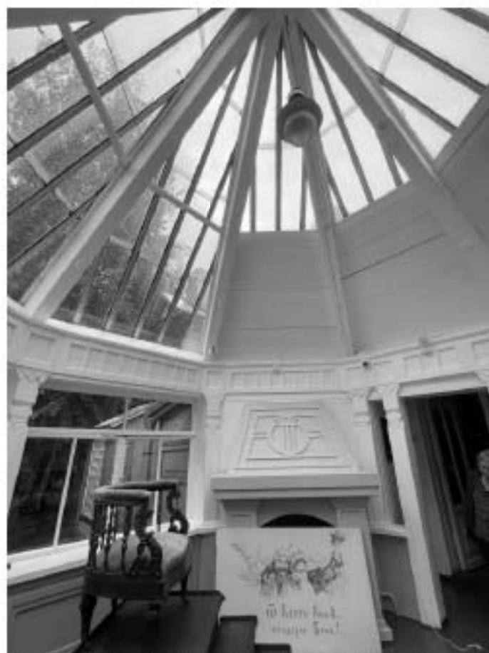
Фото №62. Стропильная система, камин в помещении 1.15.
