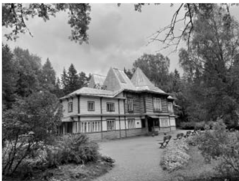
Фото №111. Общий вид здания и прилегающей территории.
