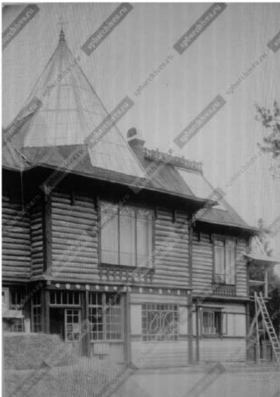
Илл. 25. Куоккала. Усадьба И.Е. Репина «Пенать». Дом жилой. Вид дома со стороны главного входа с надписью для гостей. Фотография. 1913 г. ЦГА КФФД СПб. Д-763.
