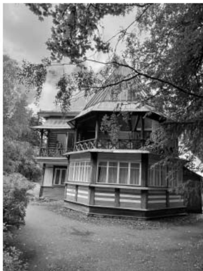
Фото №104. Вид на восточный фасад здания.
