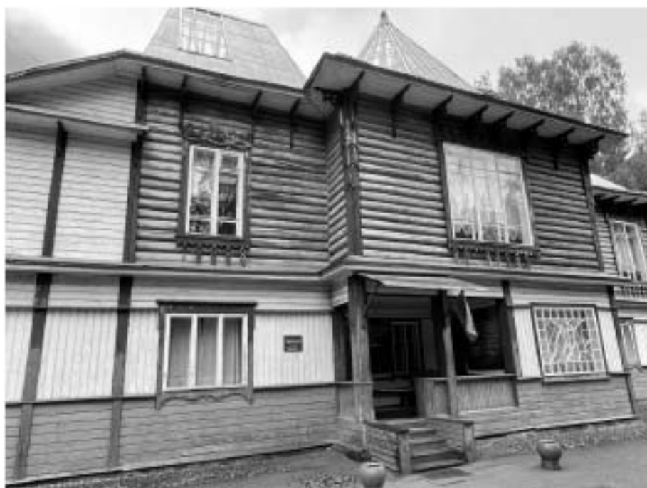
Фото №102. Южный фасад здания, крыльцо, вход для посетителей.
