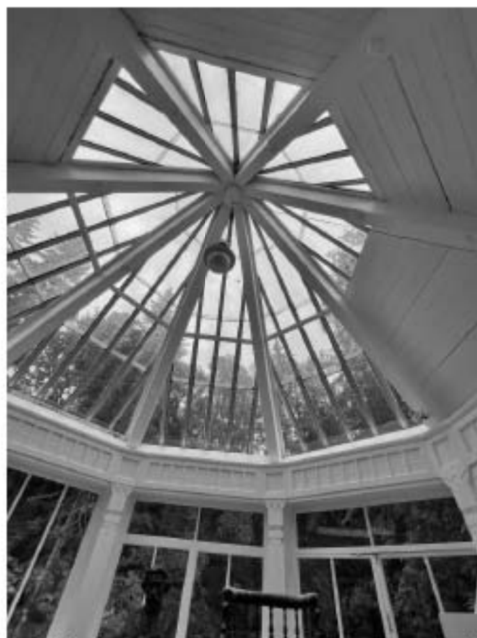
Фото №61. Стропильная система над помещением 1.15.
