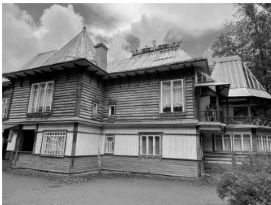
Фото №103. Южный фасад здания.
