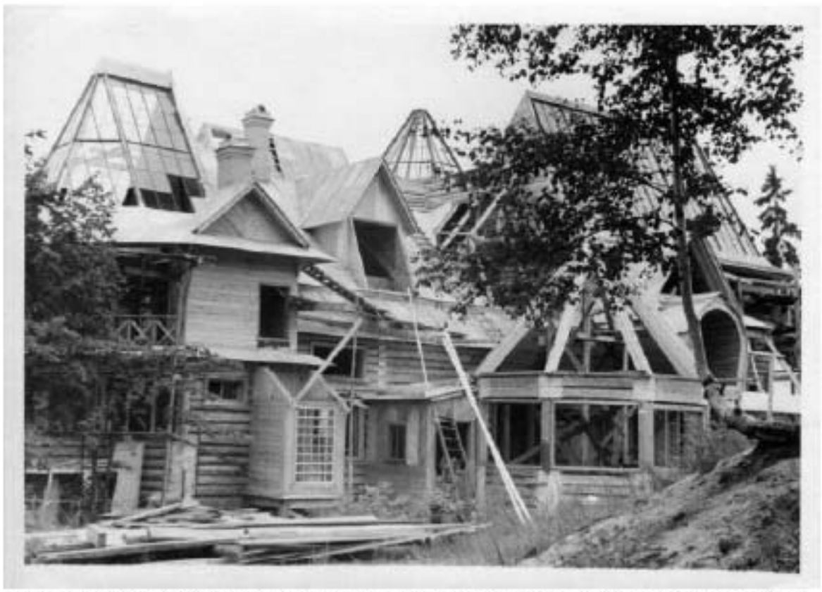
Илл. 51. Усадьба И.Е. Репина «Пенать». Работы по восстановлению жилого дома. Фотография. Конец 1950-х-начало 1960-х гг. https://terijoki.spb.ru .
