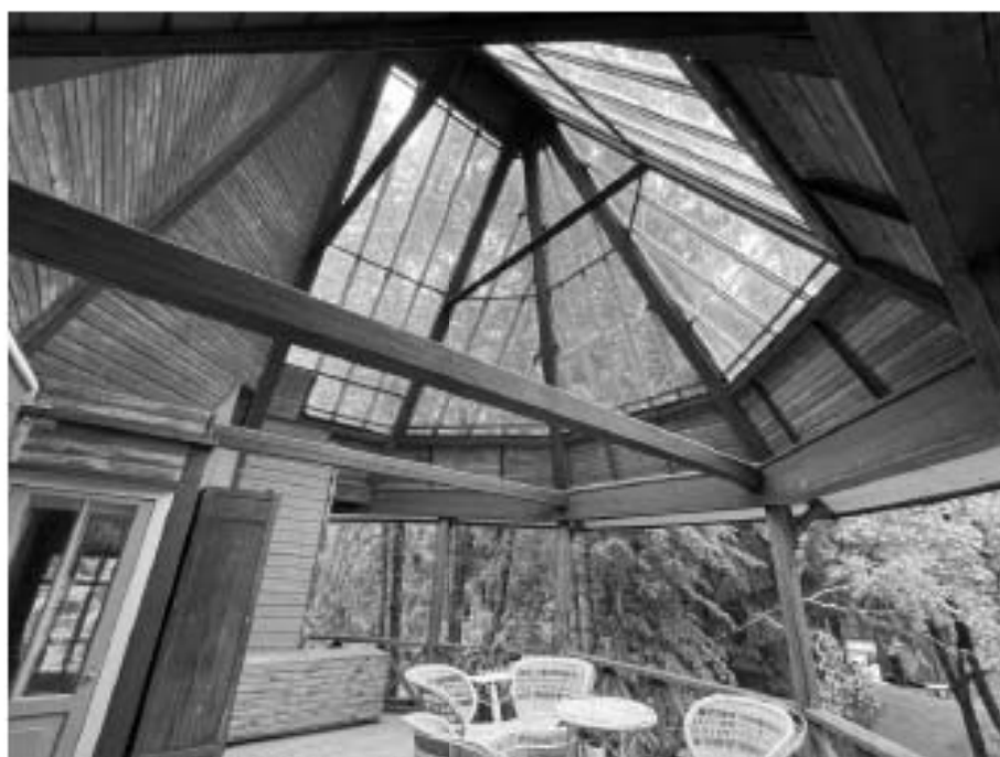
Фото №45. Открытая веранда (помещение 2.15 по плану ПИБ), стропильная система над помещением.
