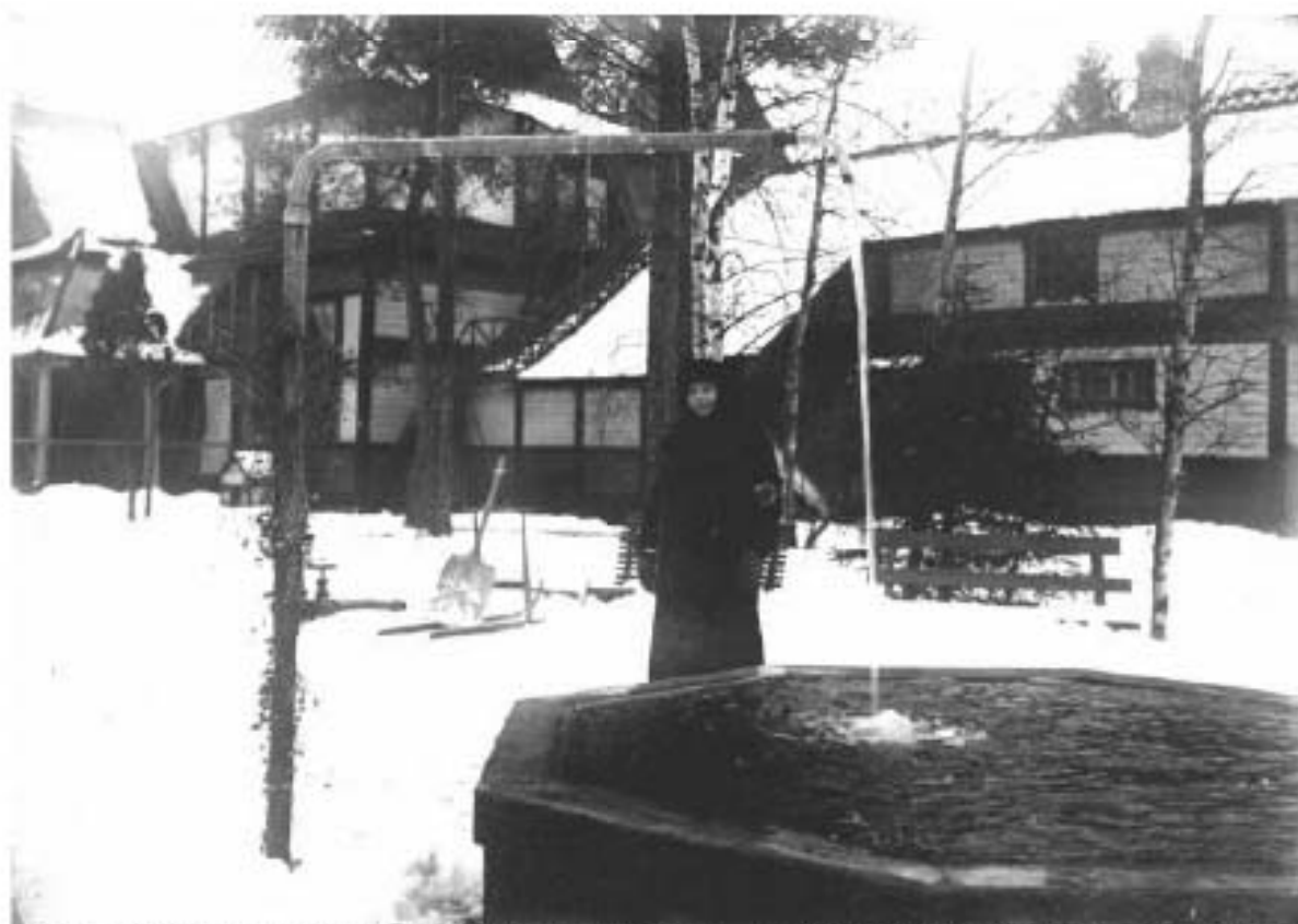
Илл. 24. Куоккала. Усадьба И.Е. Репина «Пенать». Дом жилой. Фрагмент северного фасада. Фотография. 1910-е гг. (после 1914 г.). НИМ РАХ.
