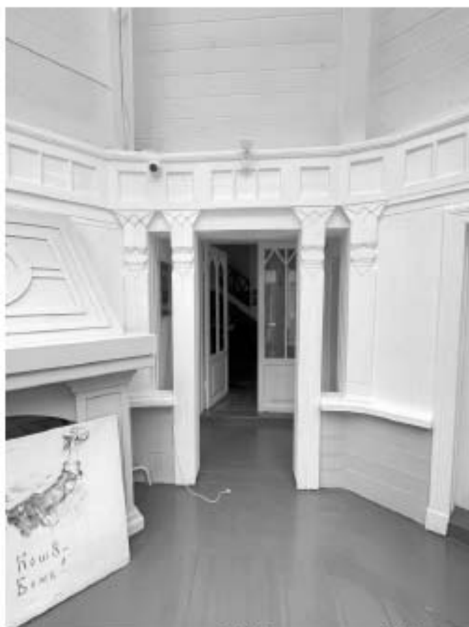
Фото №63. Выход из помещения 1.15, помещение 1.16 по плану ПИБ.
