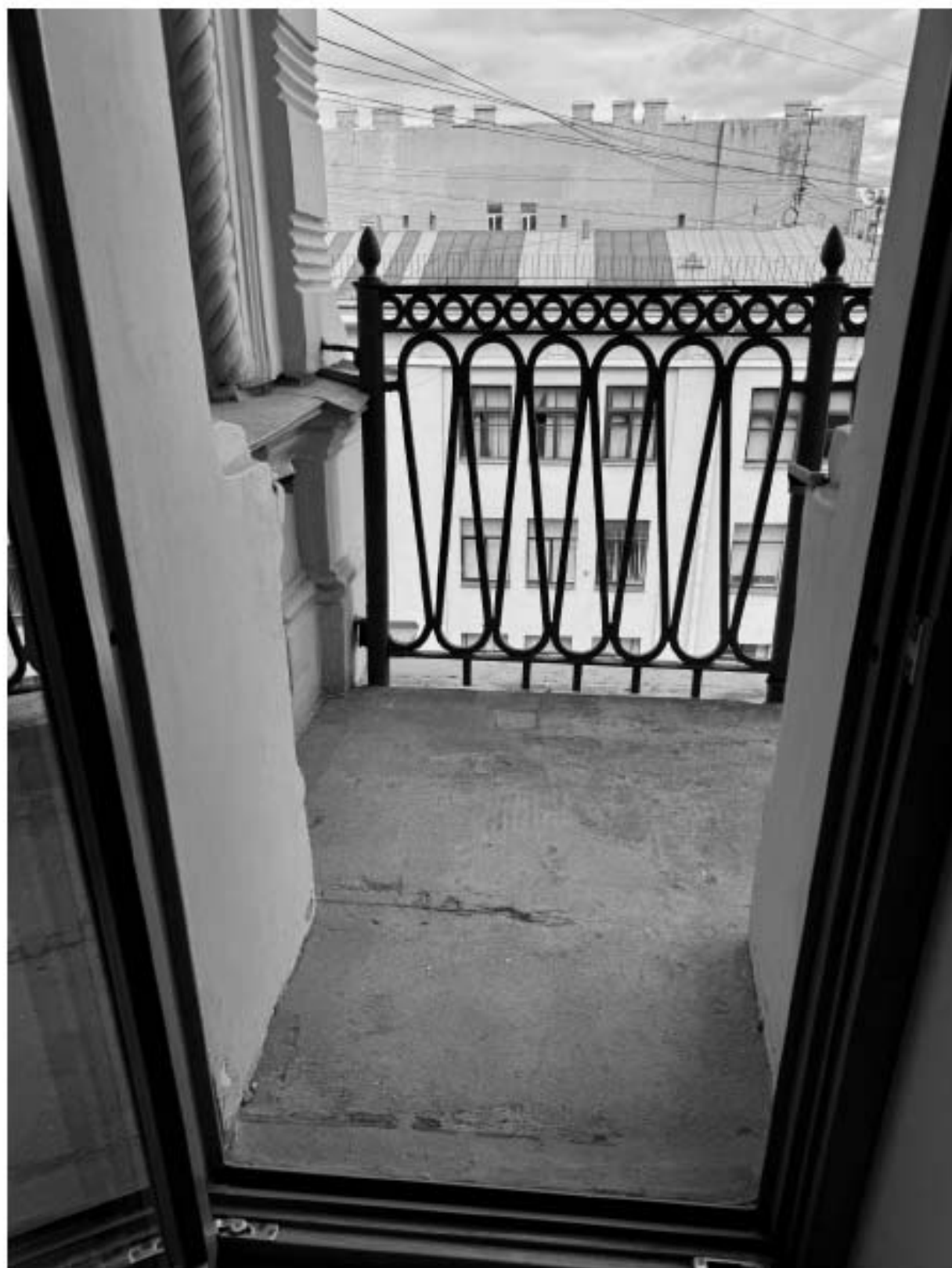
Фото 28. Западный балкон квартиры № 34 объекта культурного наследия.
