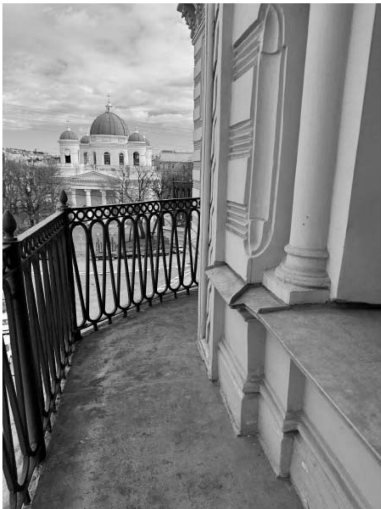
Фото 29. Западный балкон квартиры № 34 объекта культурного наследия.
