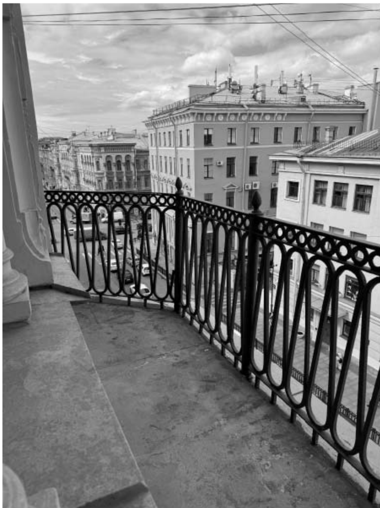
Фото 25. Восточный балкон квартиры № 34 объекта культурного наследия.
