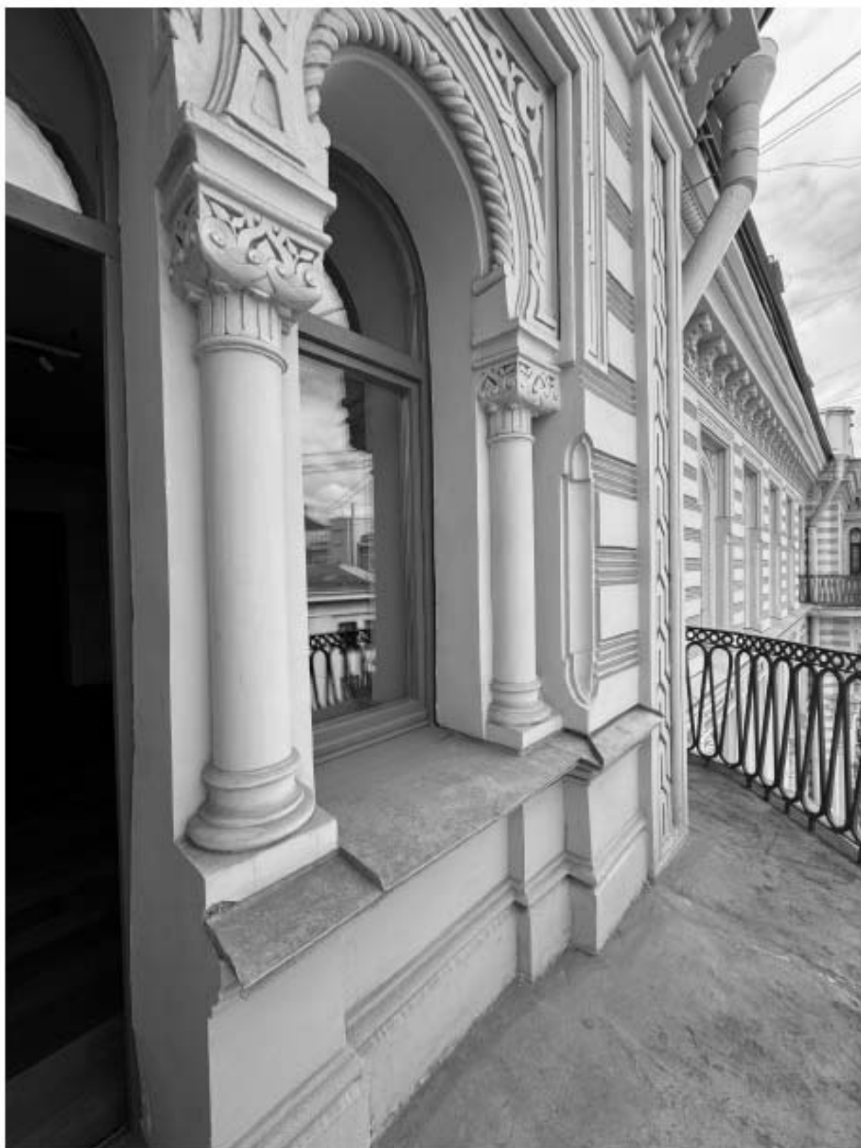
Фото 27. Восточный балкон квартиры № 34 объекта культурного наследия.
