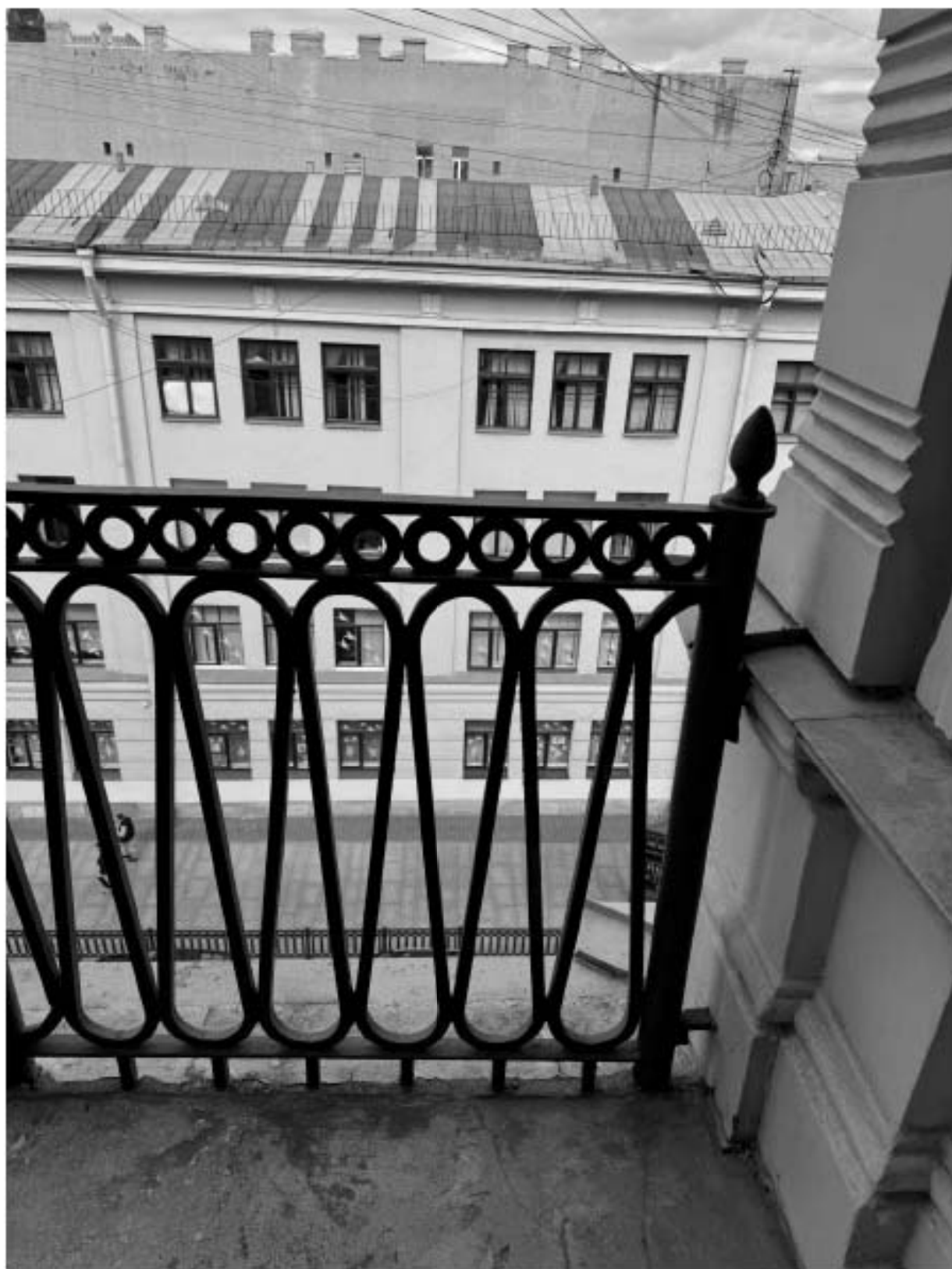
Фото 26. Восточный балкон квартиры № 34 объекта культурного наследия.
