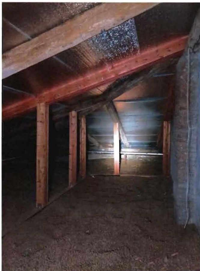
16. Чердачное пространство объекта культурного наследия (фото от 28.11.2023).
