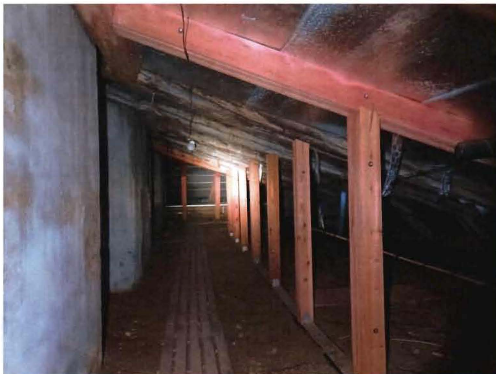
17. Чердачное пространство объекта культурного наследия (фото от 28.11.2023).
