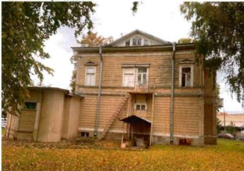
4. Общий вид на южный фасад здания.
