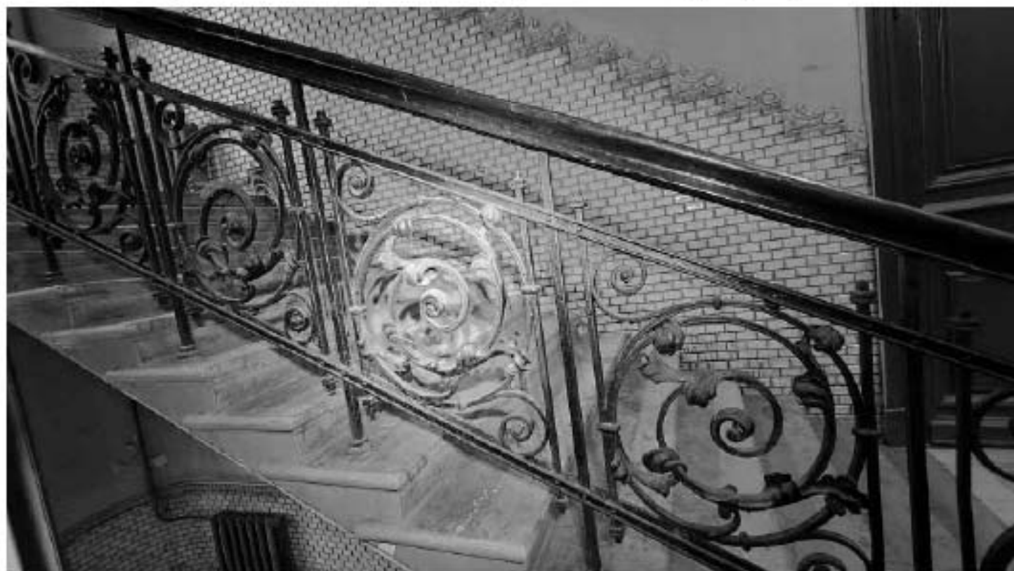
Фото 164. Отражение – кованый металл, вертикальные стойки с перехватами, между ними растительные волнообразные завитки с акантовыми листьями. Фрагмент. Дата фотофиксации: 18.03.25
