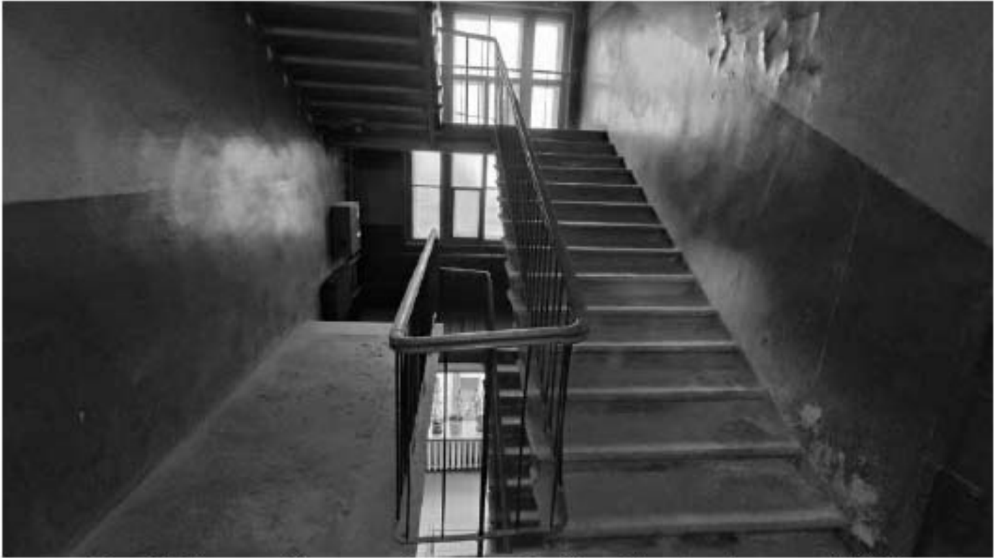
Фото 375. Лестница Л2 в уровне 5-го этажа. Общий вид. Дата фотофиксации: 18.03.25
