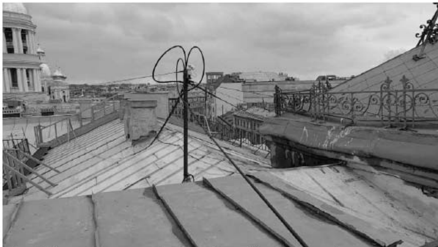
Фото 55. Скатная крыша лицевого фасада четырёхскатный шатёр центральной оси лицевого фасада. Фрагмент. Дата фотофиксации: 18.03.25
