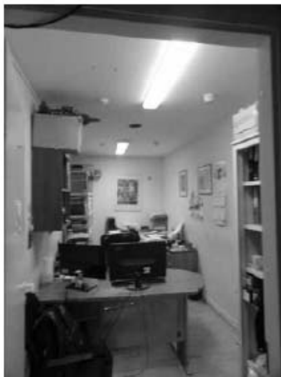
Фото 448. Пространство помещения 5 (18-Н). Общий вид. Дата фотофиксации: 18.03.25
