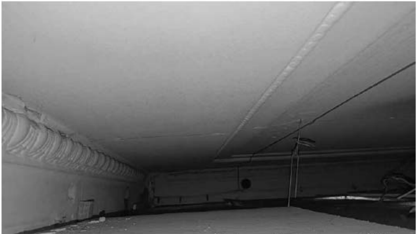
Фото 303. Тяги с лепным декором в помещении 17. Фрагмент. Дата фотофиксации: 18.03.25
