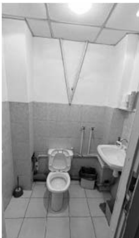
Фото 349. Помещение 9 (38-Н). Общий вид. Дата фотофиксации: 18.03.25
