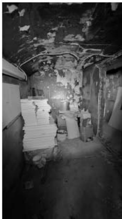
Фото 249. Объём чердака. Фрагмент. Дата фотофиксации: 18.03.25
