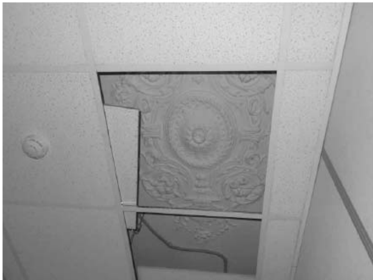
Фото 425. Потолочная розетка в помещениях 1, 2 (16-Н). Фрагмент. Дата фотофиксации: 18.03.25
