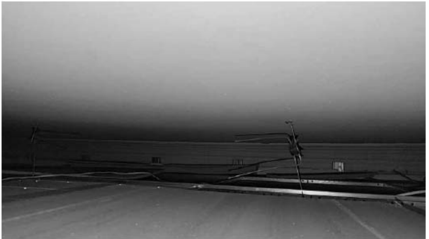
Фото 229. Тяги в помещении 1, 22-Н. Общий вид. Дата фотофиксации: 18.03.25
