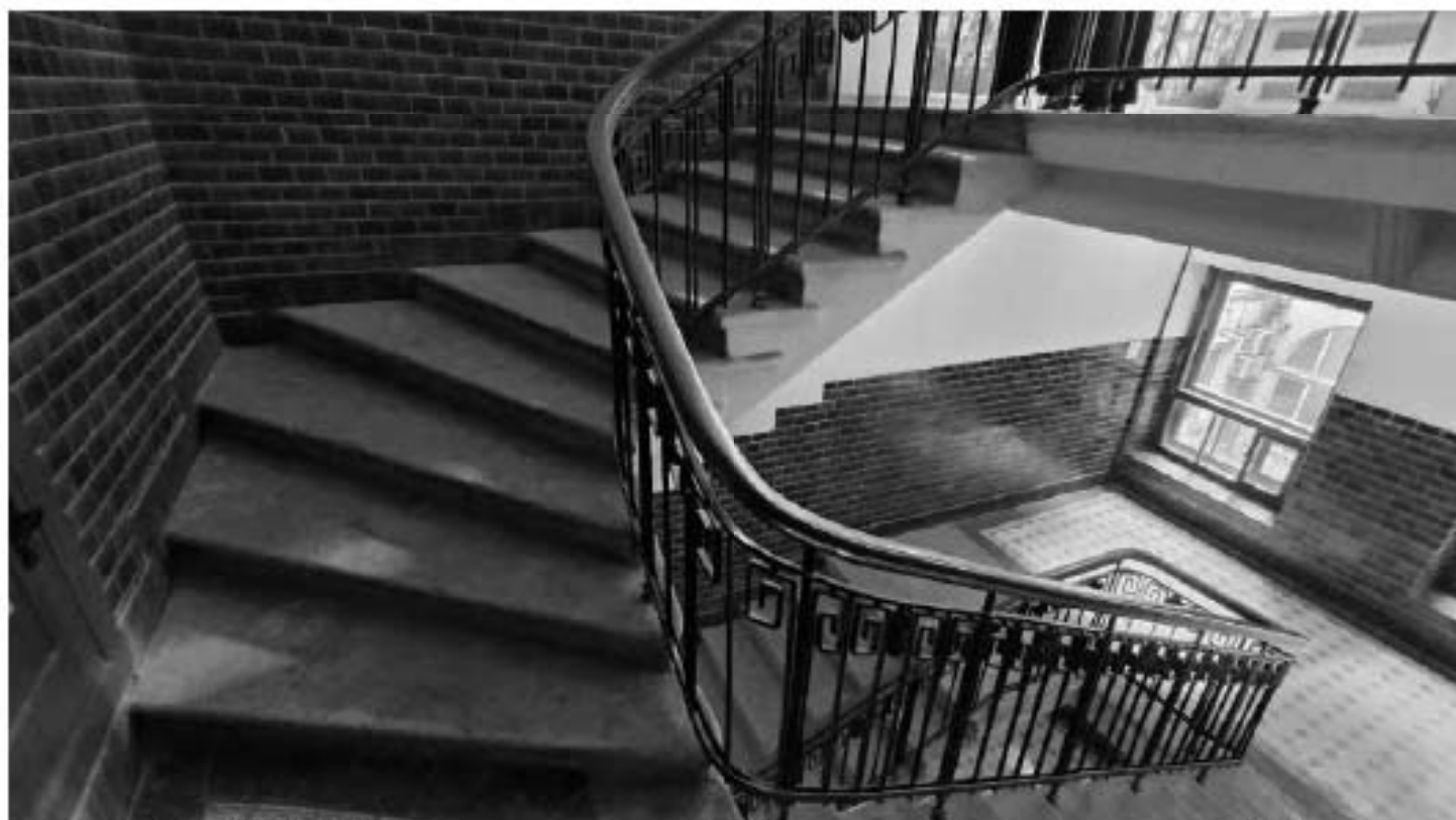
Фото 386. Забежные ступени лестницы Л5. Фрагмент. Дата фотофиксации: 18.03.25
