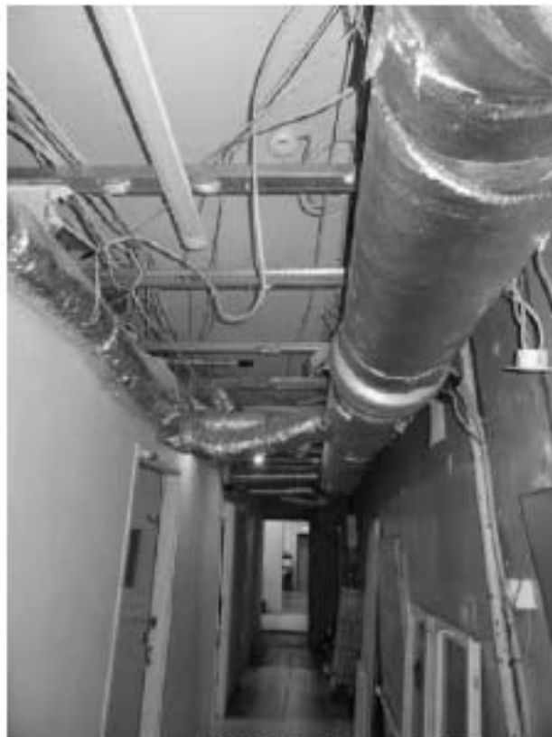
Фото 445. Пространство помещения 5 (18-Н). Фрагмент. Дата фотофиксации: 18.03.25
