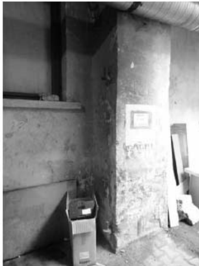
Фото 42. Исторические подставы для ворот в воротном проезде поперечного флигеля. Фрагмент. Дата фотофиксации: 18.03.25
