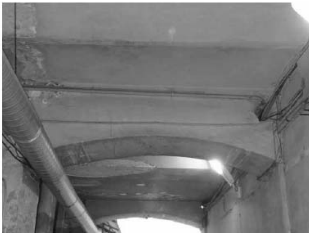
Фото 40. Подпружная арка воротного проезда поперечного флигеля. Общий вид. Дата фотофиксации: 18.03.25
