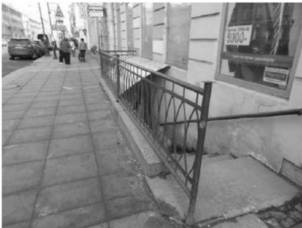
Фото 21. Современная ограда лестницы в помещения цоколя. Общий вид. Дата фотофиксации: 18.03.25
