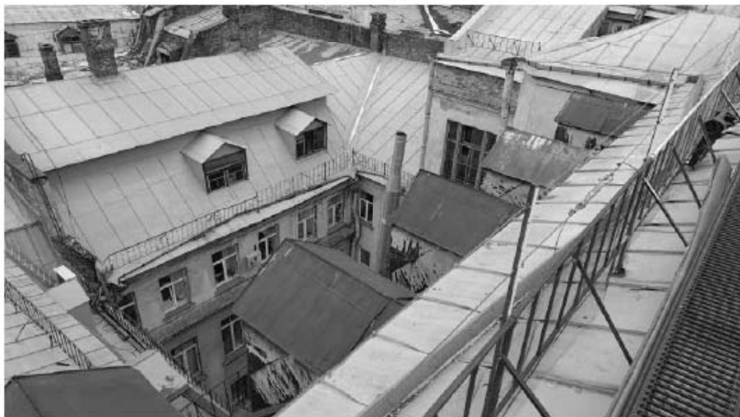
Фото 54. Двускатная крыша поперечного фасада. Фрагмент. Дата фотофиксации: 18.03.25
