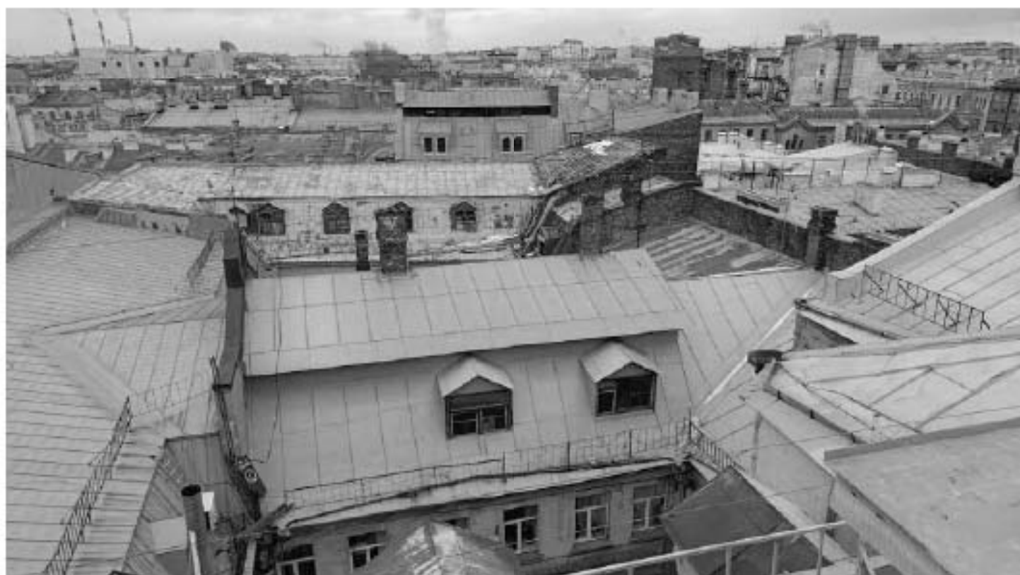
Фото 56. Двускатные и скатные крыши северного, южного, восточного и поперечного корпусов. Исторические дымовые трубы. Фрагмент. Дата фотофиксации: 18.03.25
