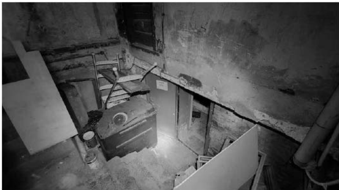
Фото 64. Объем служебной лестницы Л6. Фрагмент. Дата фотофиксации: 18.03.25
