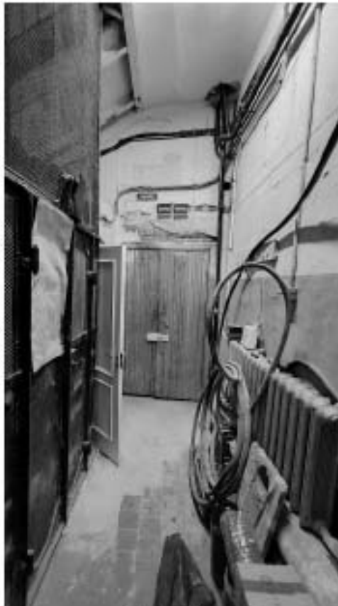
Фото 489. Площадка 1-го этажа. Общий вид. Дата фотофиксации: 18.03.25
