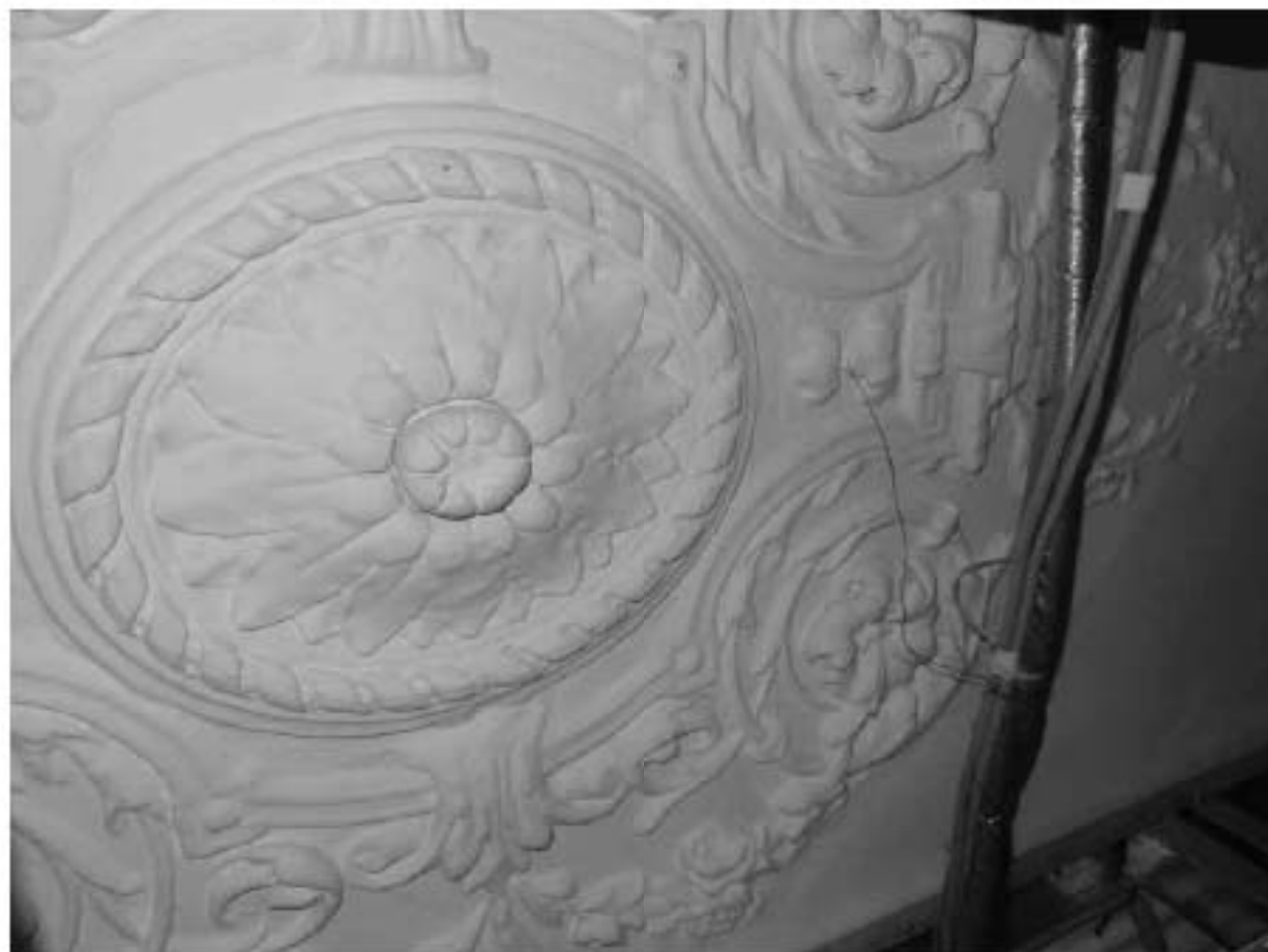
Фото 426. Потолочная розетка в помещениях 1, 2 (16-Н). Фрагмент. Дата фотофиксации: 18.03.25
