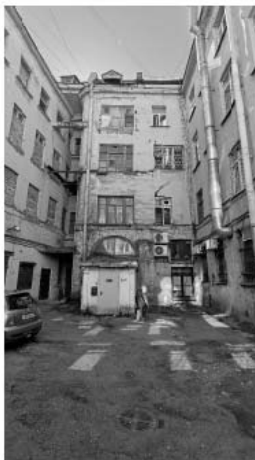
Фото 48. Южный фасад. Общий вид со стороны объёма дворового фасада восточного флигеля. Дата фотофиксации: 14.08.25
