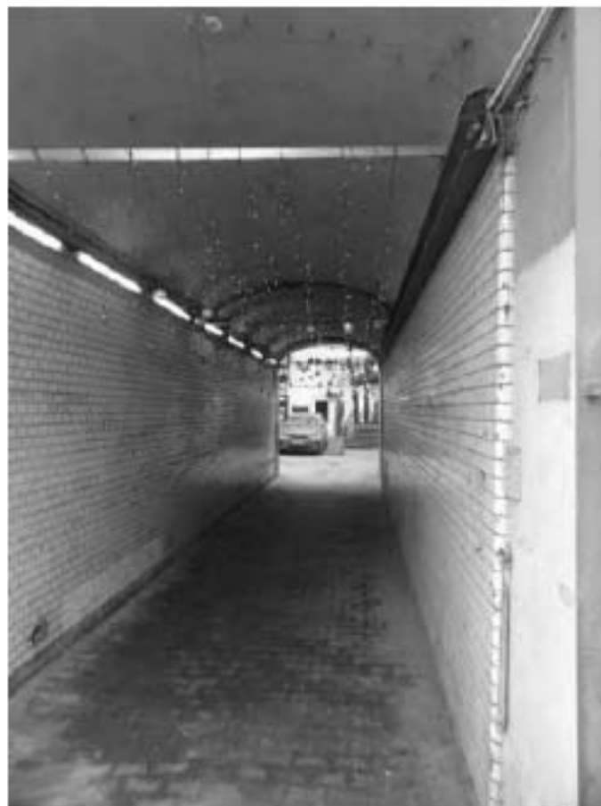
Фото 23. Исторический воротный проезд лицевого фасада (западного флигеля). Общий вид. Дата фотофиксации: 18.03.25
