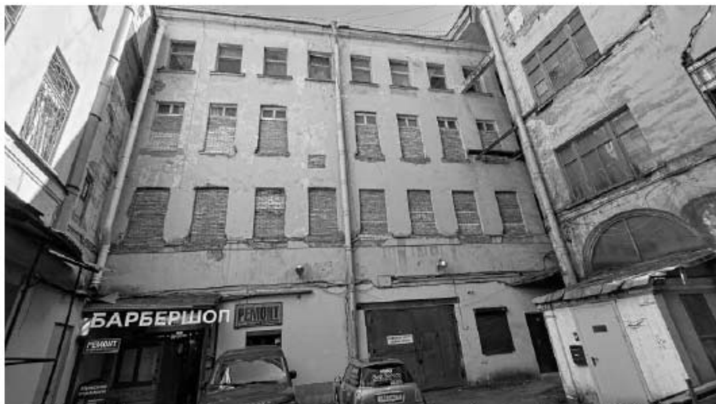
Фото 45. Восточный флигель. Дворовый фасад. Общий вид. Дата фотофиксации: 14.08.25
