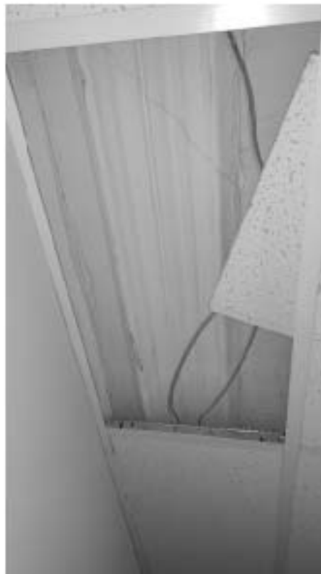
Фото 206. Пространство помещений 6 и 7. Тяги. Фрагмент. Дата фотофиксации: 18.03.25
