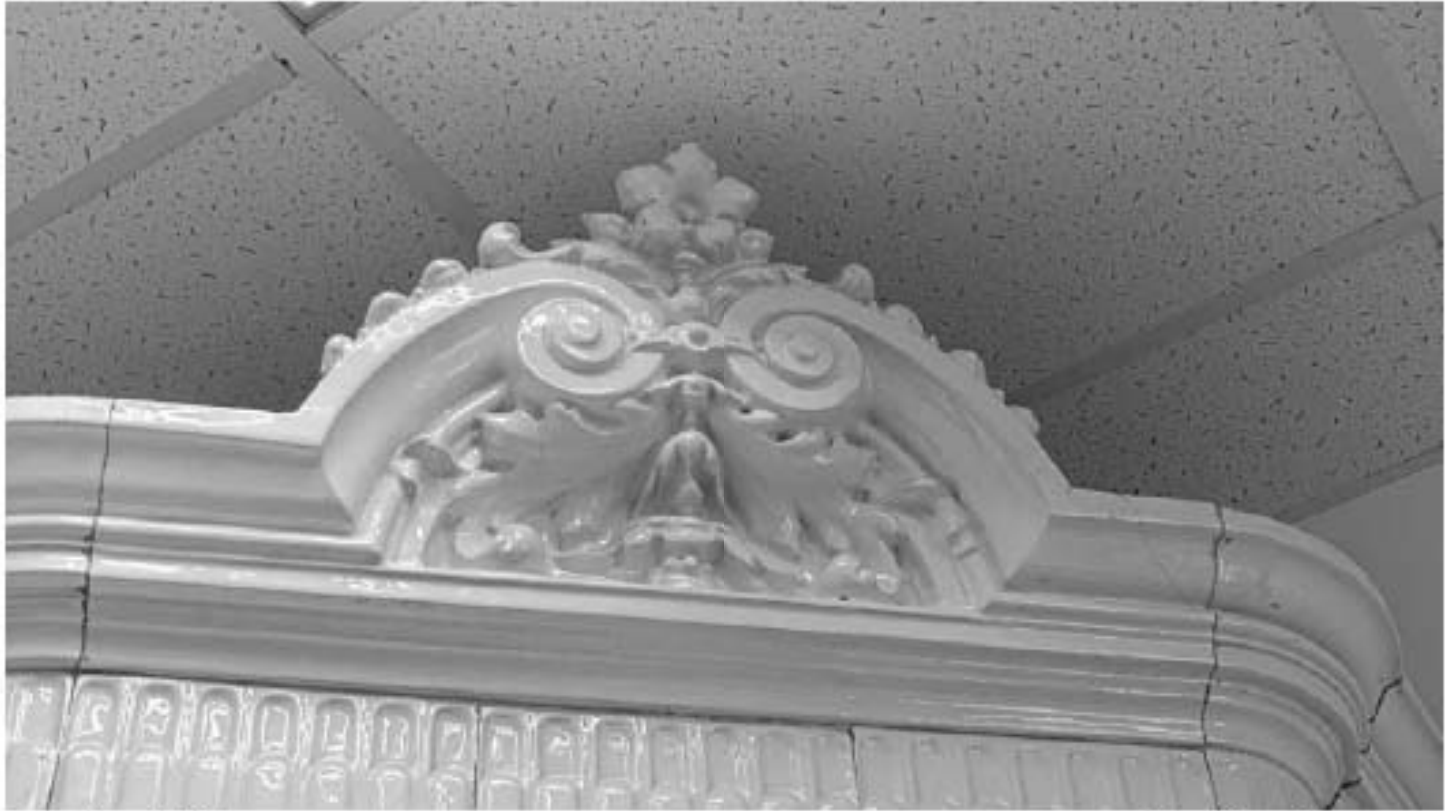
Фото 218. Аттиковая композиция из двух волют с растительными мотивами. Общий вид. Дата фотофиксации: 18.03.25
