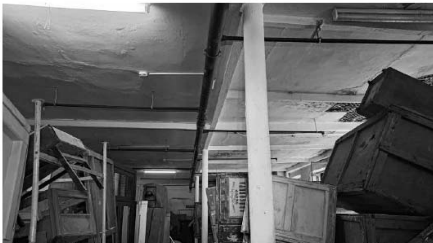
Фото 509. Пространство помещения 4 (40-Н). Фрагмент. Дата фотофиксации: 18.03.25
