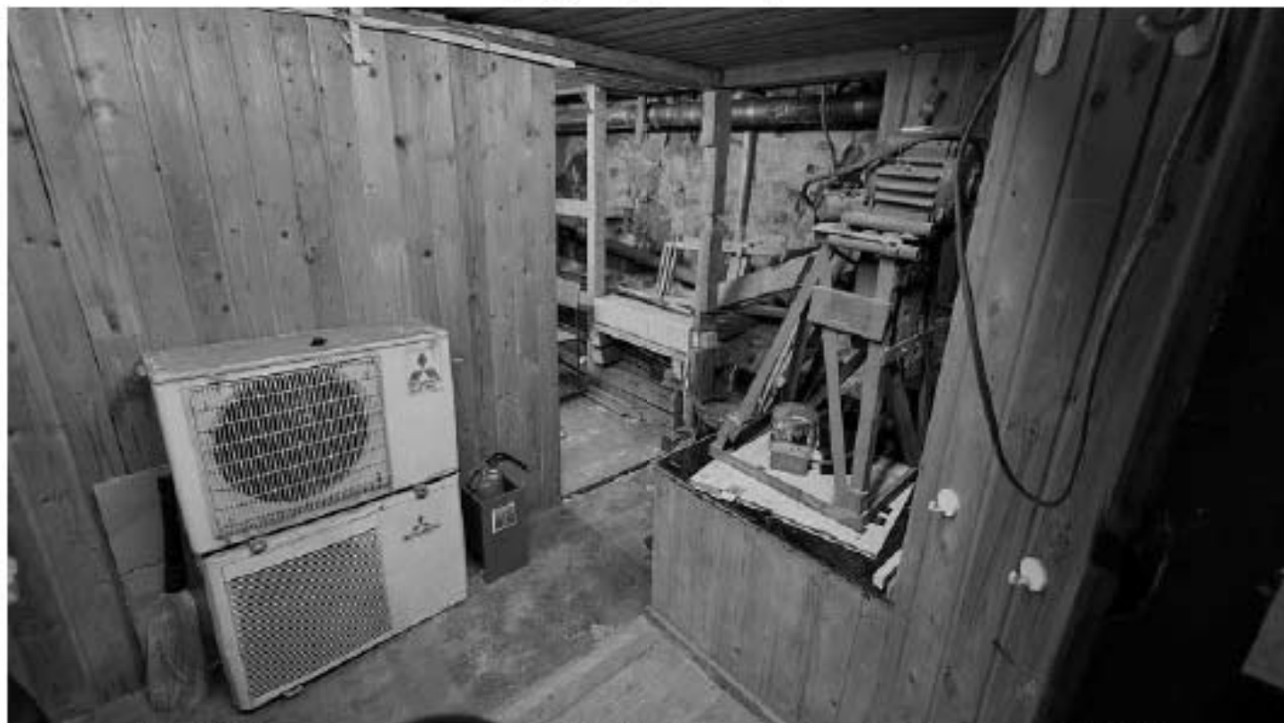
Фото 79. Пространство помещения 1 (2-Н). Фрагмент. Дата фотофиксации: 18.03.25
