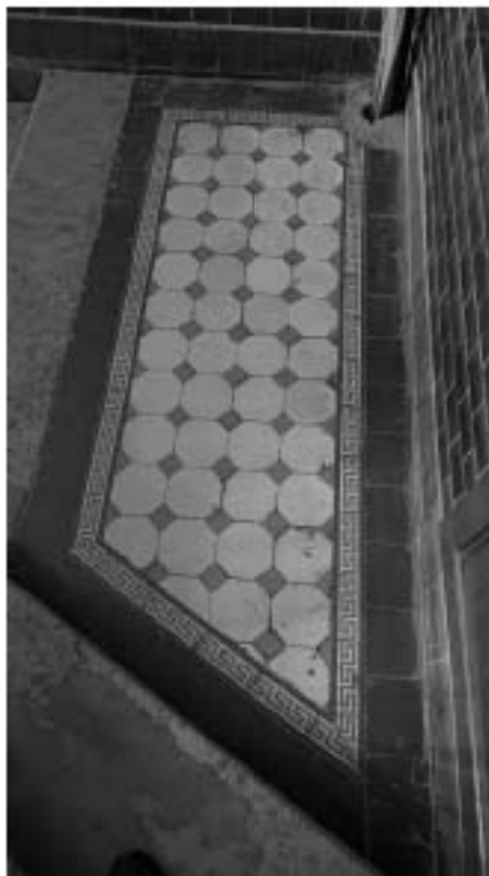
Фото 385. Метлахская плитка в межэтажном пространстве 3-го и 2-го этажей лестницы Л5. Общий вид. Дата фотофиксации: 18.03.25
