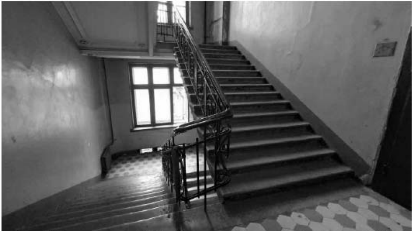
Фото 183. Парадная лестница Л1. Общий вид в уровне 5-го этажа. Дата фотофиксации: 18.03.25
