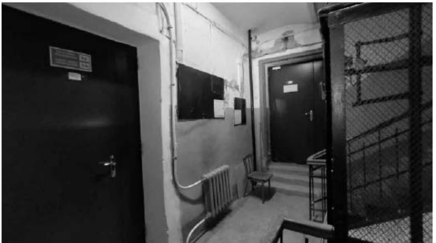
Фото 498. Площадка 4-го этажа. Фрагмент. Дата фотофиксации: 18.03.25
