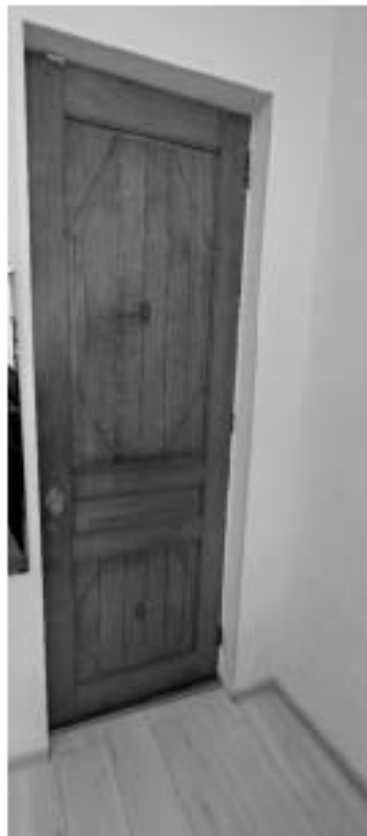
Фото 316. Историческое деревянное дверное заполнение в характере модерна в помещении 18 (21-Н). Общий вид. Дата фотофиксации: 18.03.25
