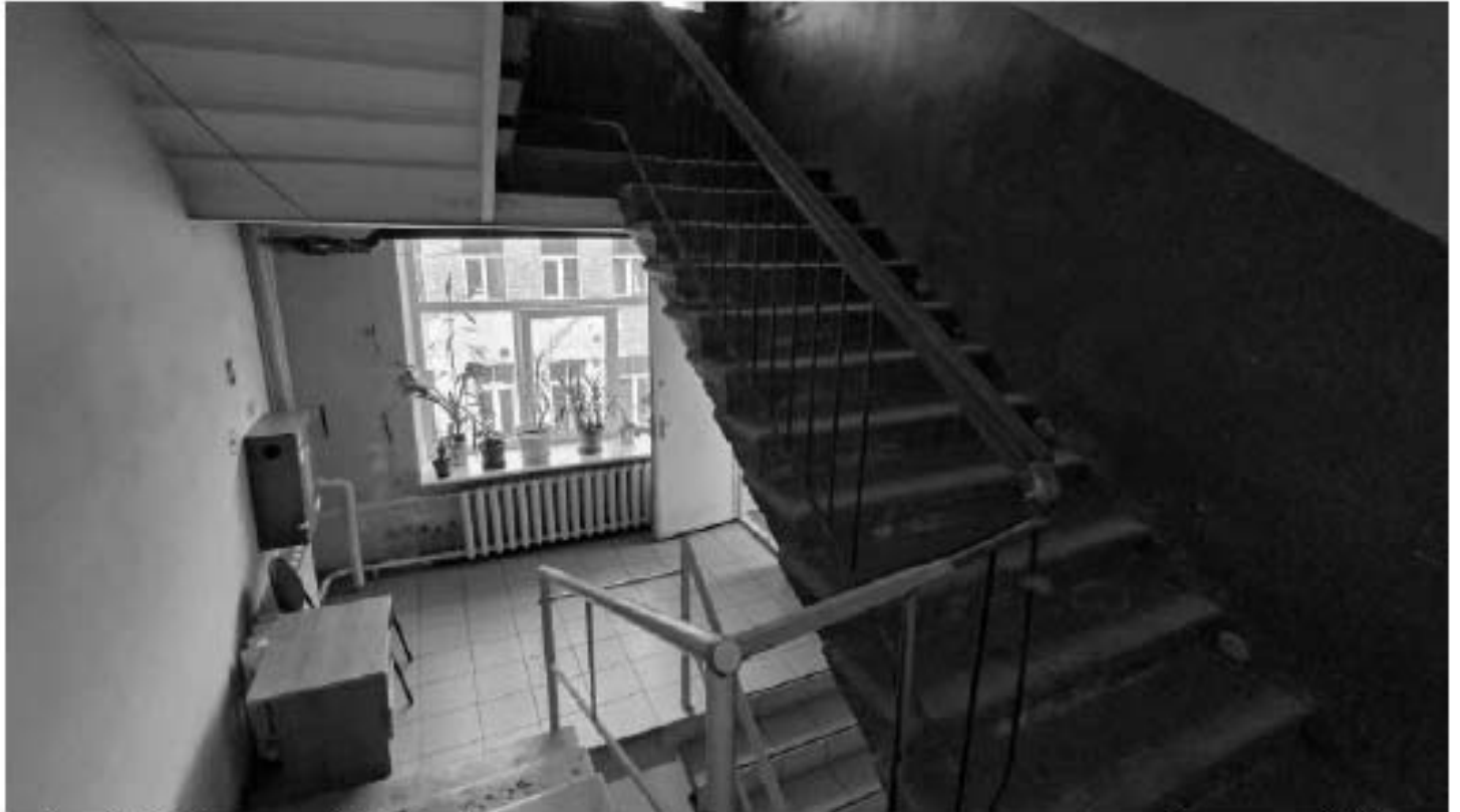
Фото 373. Лестница Л2. Общий вид со стороны межэтажного пространства 4-го и 5-го этажей. Дата фотофиксации: 18.03.25
