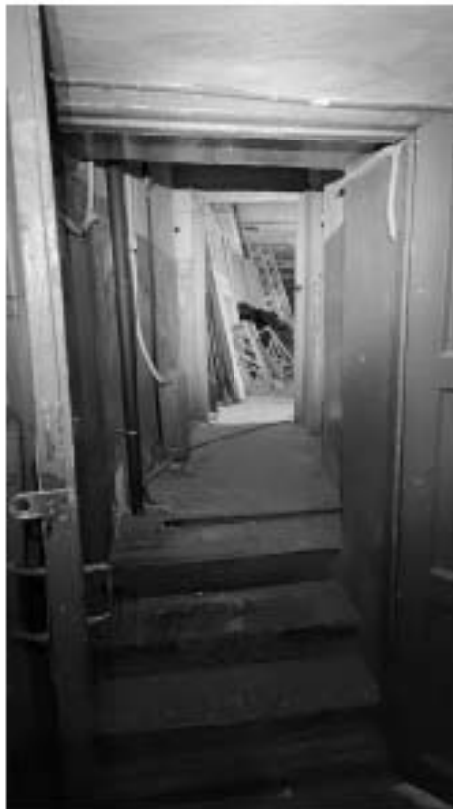
Фото 518. Помещение 1 (41-Н). Общий вид. Дата фотофиксации: 18.03.25
