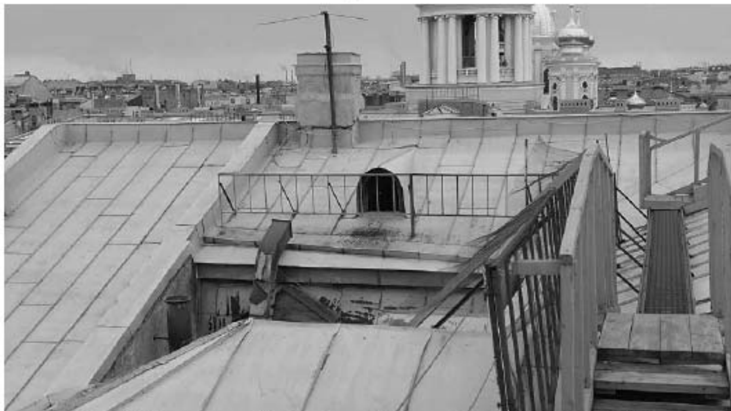
Фото 53. Скатная крыша Южного фасада. Фрагмент. Дата фотофиксации: 18.03.25
