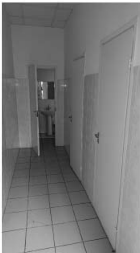
Фото 355. Помещение 43. Общий вид. Дата фотофиксации: 18.03.25
