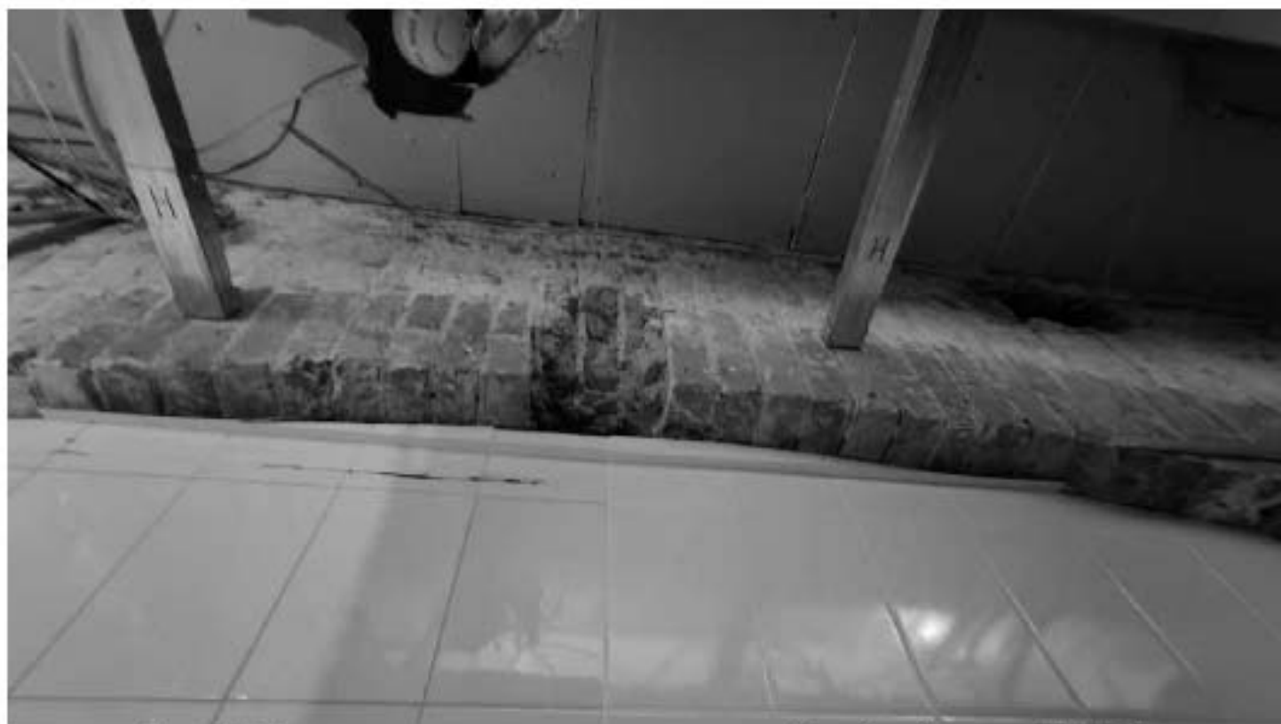
Фото 130. Фрагмент заложённого каретного проёма. Дата фотофиксации: 18.03.25
