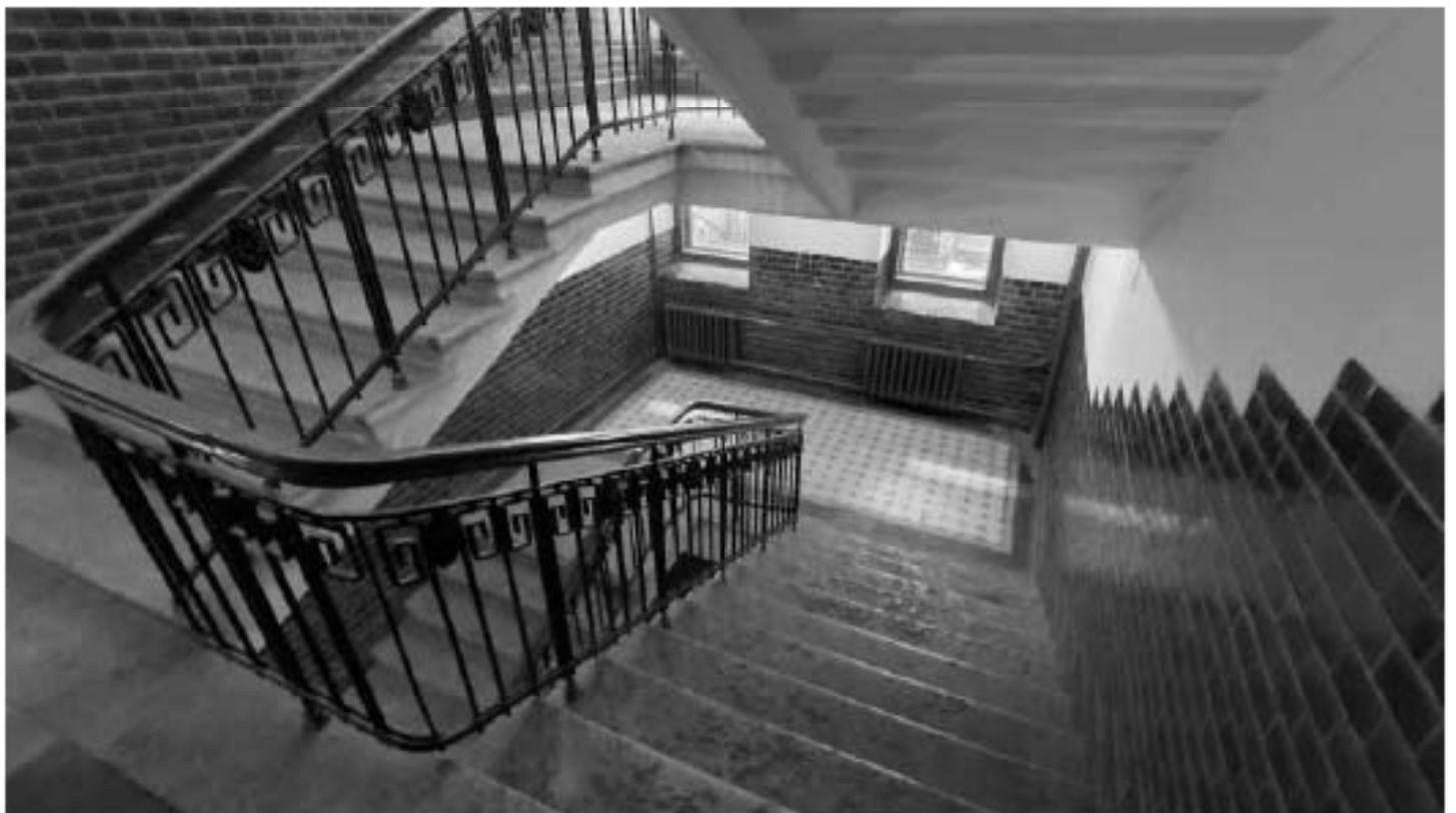
Фото 390. Метлахская плитка на площадке межэтажного пространства 1-го и 2-го этажей лестницы Л5. Общий вид. Дата фотофиксации: 18.03.25
