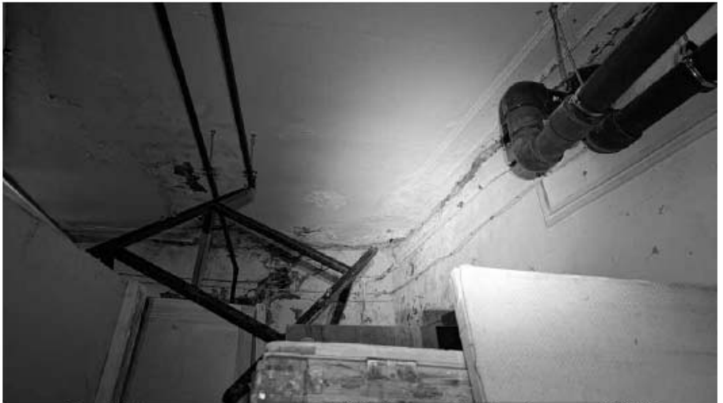
Фото 506. Пространство помещения 4 (40-Н). Фрагмент. Дата фотофиксации: 18.03.25
