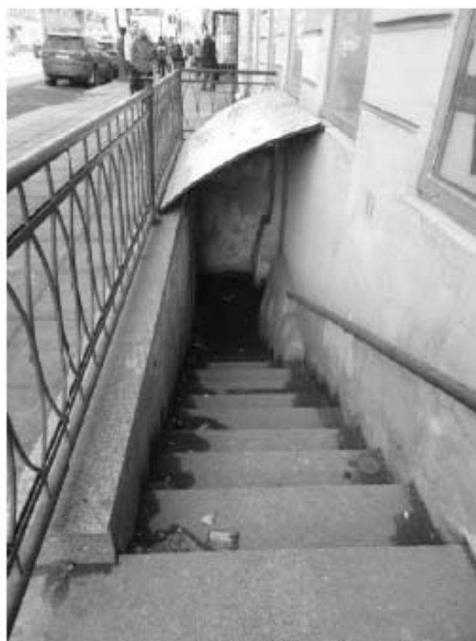
Фото 22. Лестница в помещения цоколя (З (1-Н)). Общий вид. Дата фотофиксации: 18.03.25
