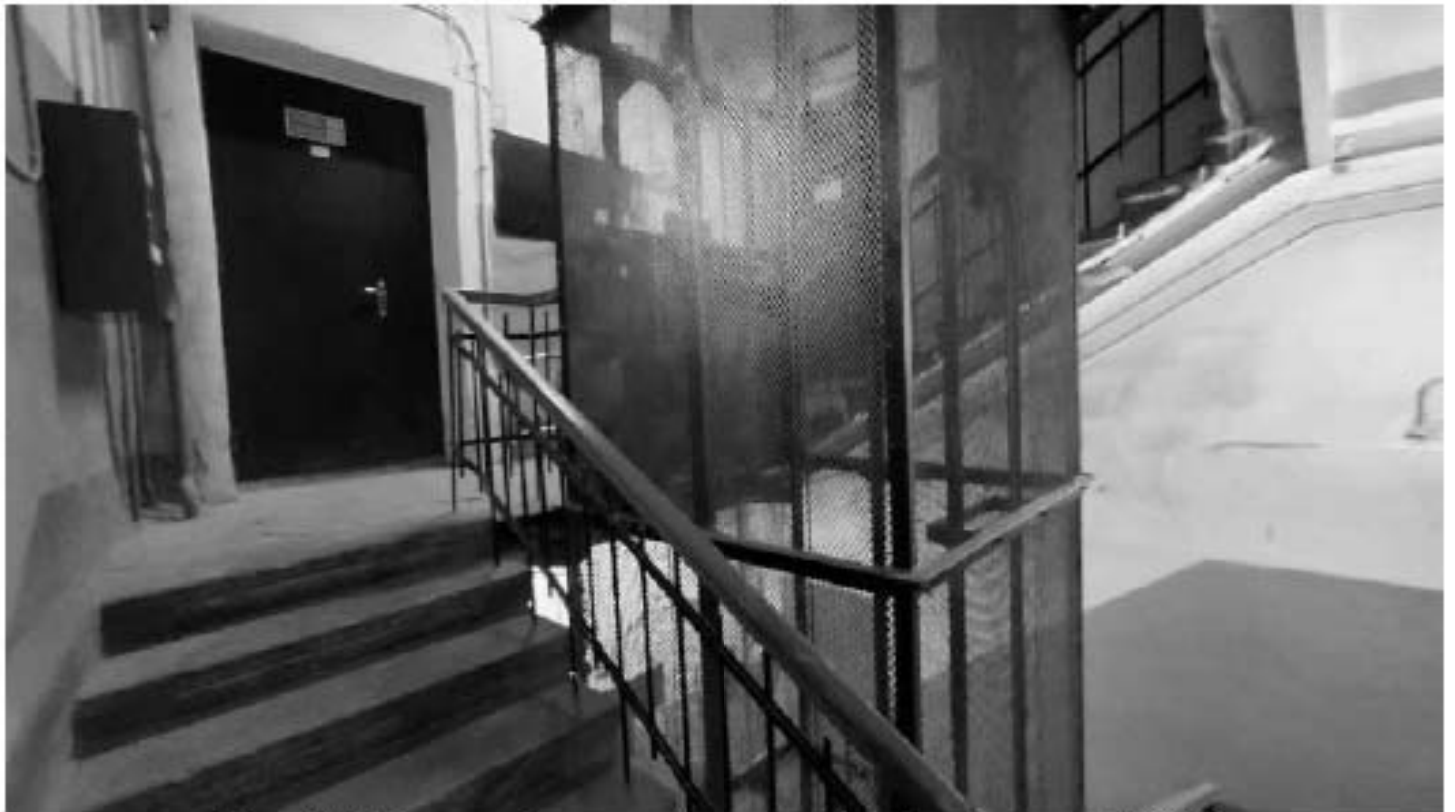
Фото 497. Площадка 4-го этажа. Фрагмент. Дата фотофиксации: 18.03.25
