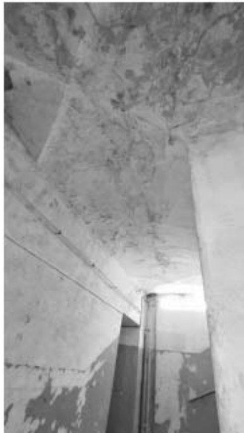
Фото 338. Фрагменты крестовых сводов в уровне 2-го этажа. Дата фотофиксации: 18.03.25
