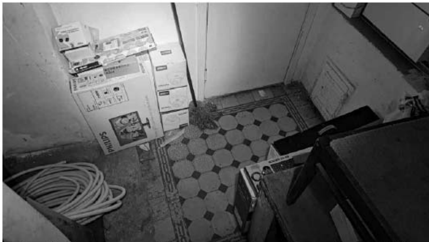
Фото 149. Метлахская плитка в объёме под лестницей. Фрагмент. Дата фотофиксации: 18.03.25
