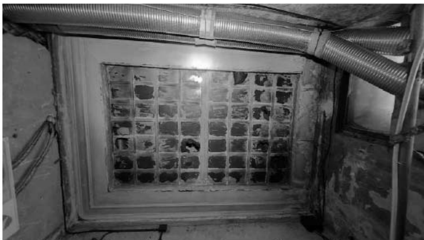
Фото 66. Исторический световой фонарь над объемом служебной лестницы Л-6 главного корпуса (западного флигеля). Общий вид. Дата фотофиксации: 18.03.25
