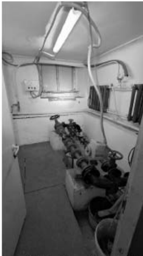
Фото 73. Помещение 6. Общий вид. Дата фотофиксации: 18.03.25
