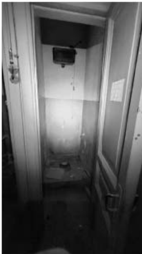
Фото 527. Помещение 7 (41-Н). Общий вид. Дата фотофиксации: 18.03.25
