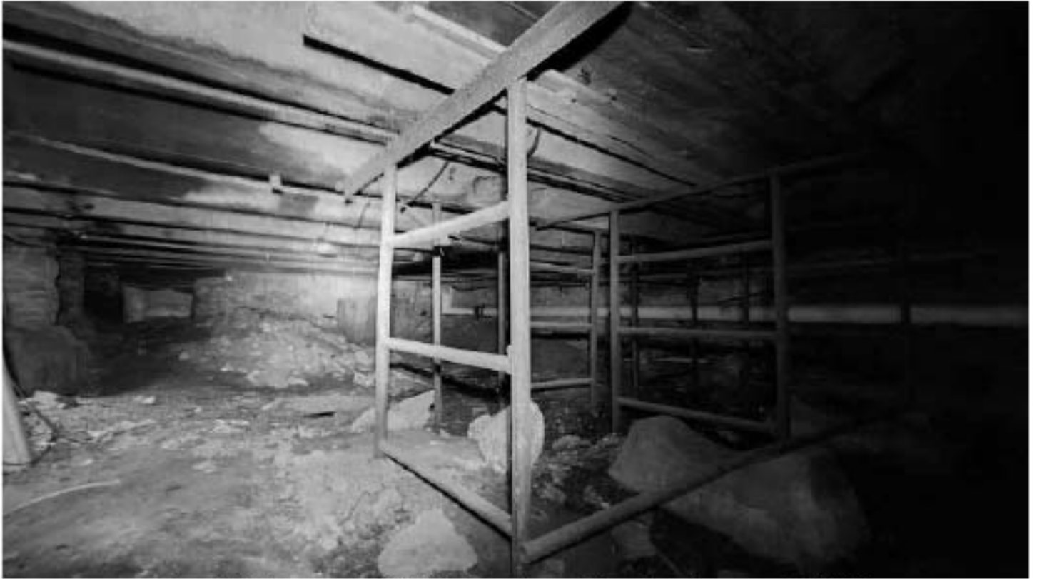
Фото 85. Помещение 1 (33-Н). Общий вид. Дата фотофиксации: 14.08.25
