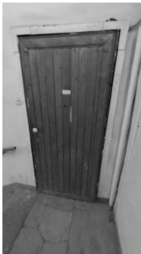
Фото 341. Современная дверь в помещение 2 (21-Н). Общий вид. Дата фотофиксации: 18.03.25
