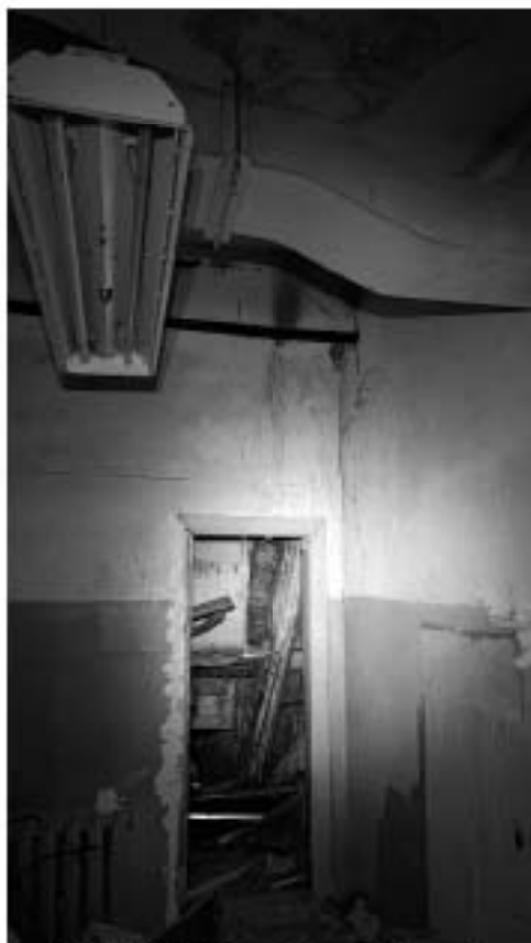
Фото 520. Помещение 2 (41-Н). Общий вид. Дата фотофиксации: 18.03.25
