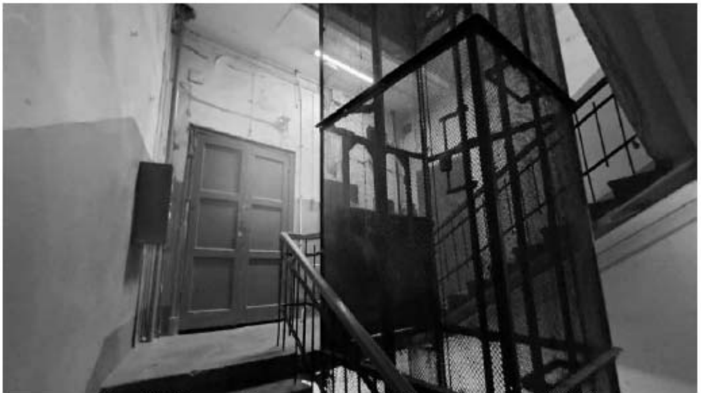
Фото 493. Площадка 3-го этажа. Фрагмент. Дата фотофиксации: 18.03.25
