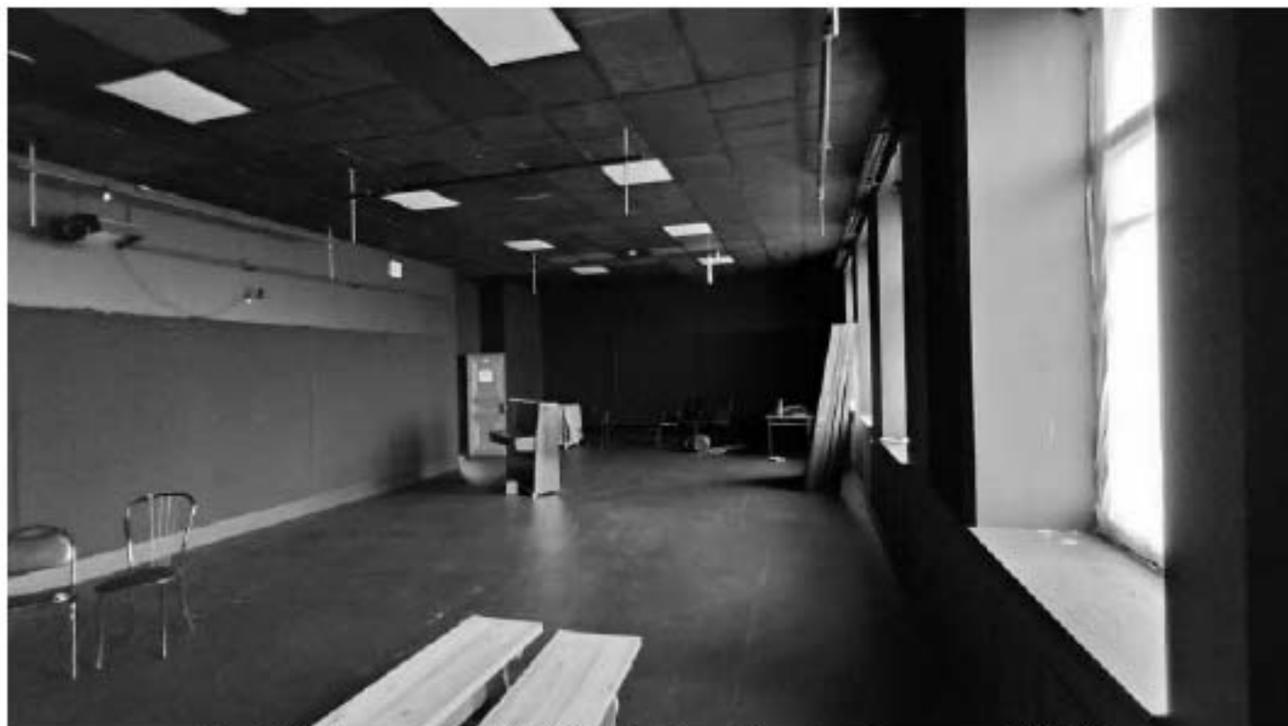
Фото 252. Помещение 7 (24-Н). Общий вид. Дата фотофиксации: 18.03.25
