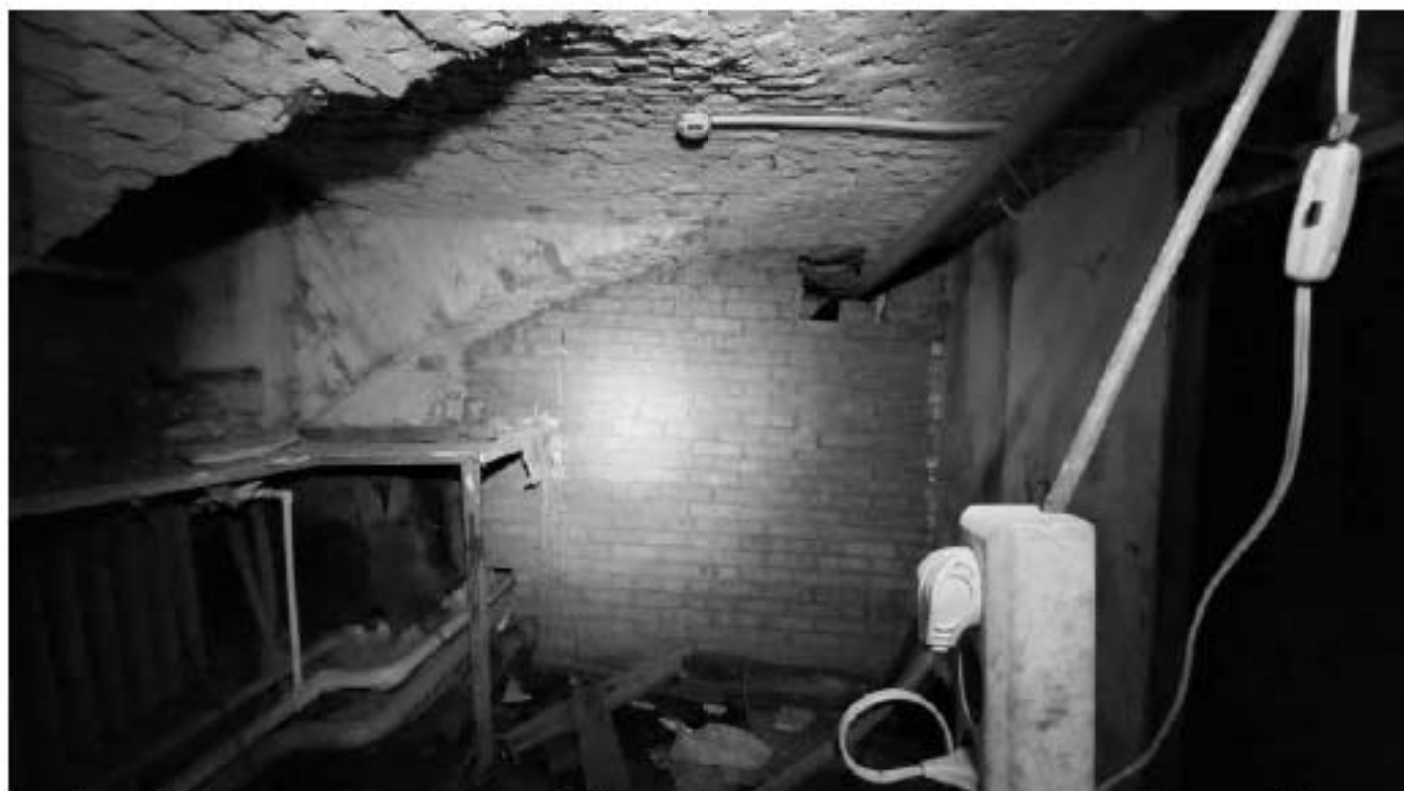
Фото 75. Пространство помещения 5. Цилиндрические с распалубками своды. Фрагмент. Дата фотофиксации: 18.03.25
