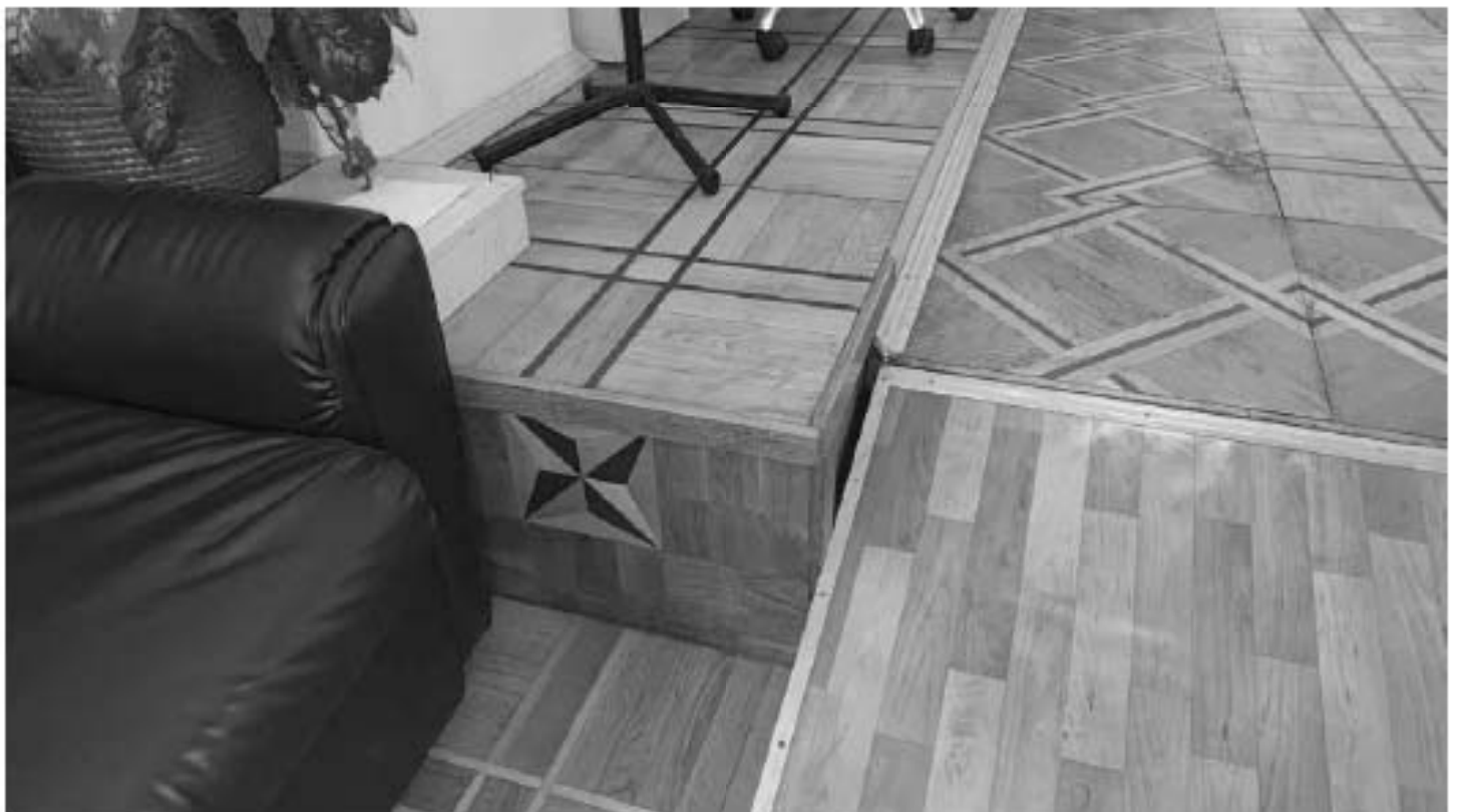
Фото 332. Исторический паркет из ценных пород дерева. Помещение 1 (21-Н). Фрагмент. Дата фотофиксации: 18.03.25
