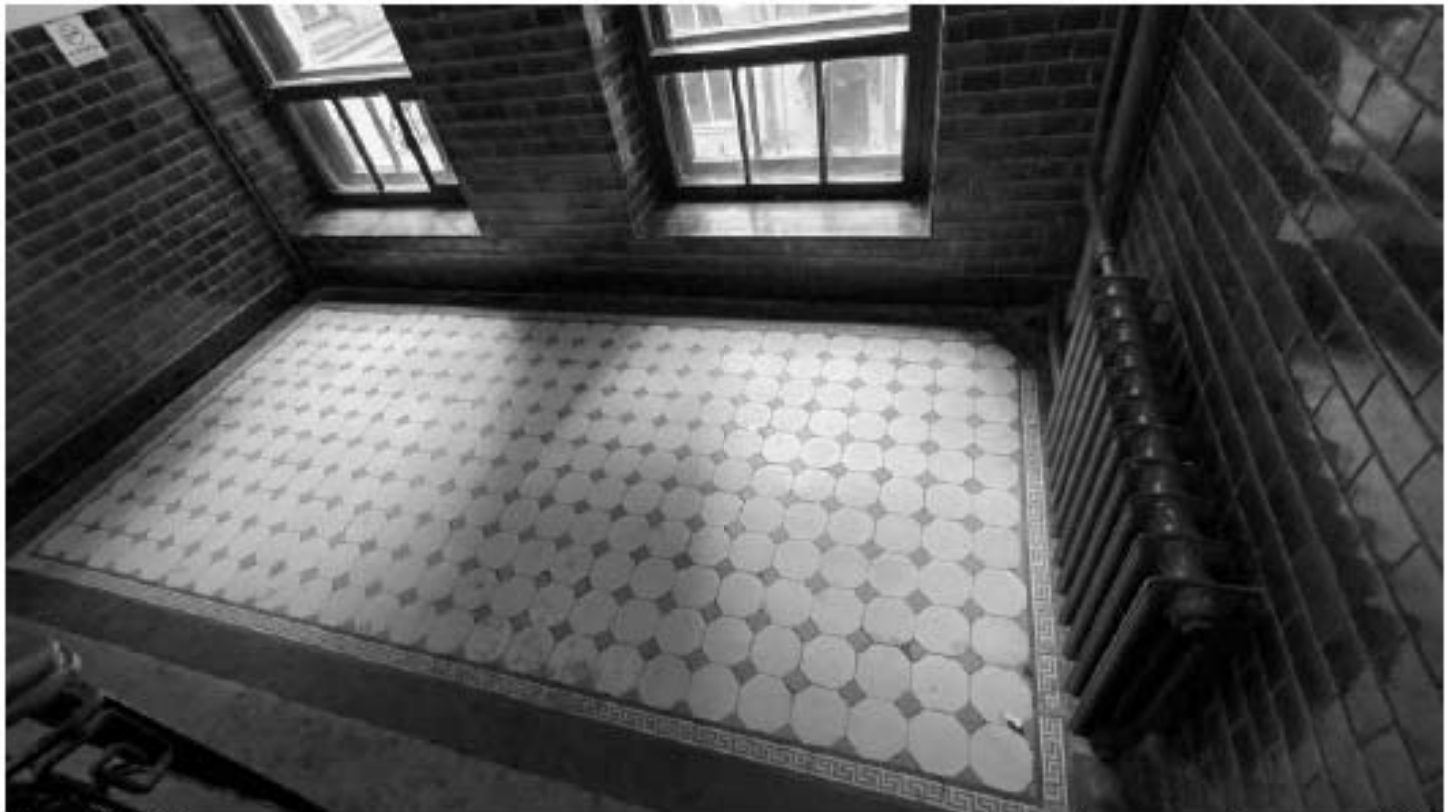
Фото 387. Метлахская плитка на площадке межэтажного пространства 2-го и 3-го этажей лестницы Л5. Общий вид. Дата фотофиксации: 18.03.25
