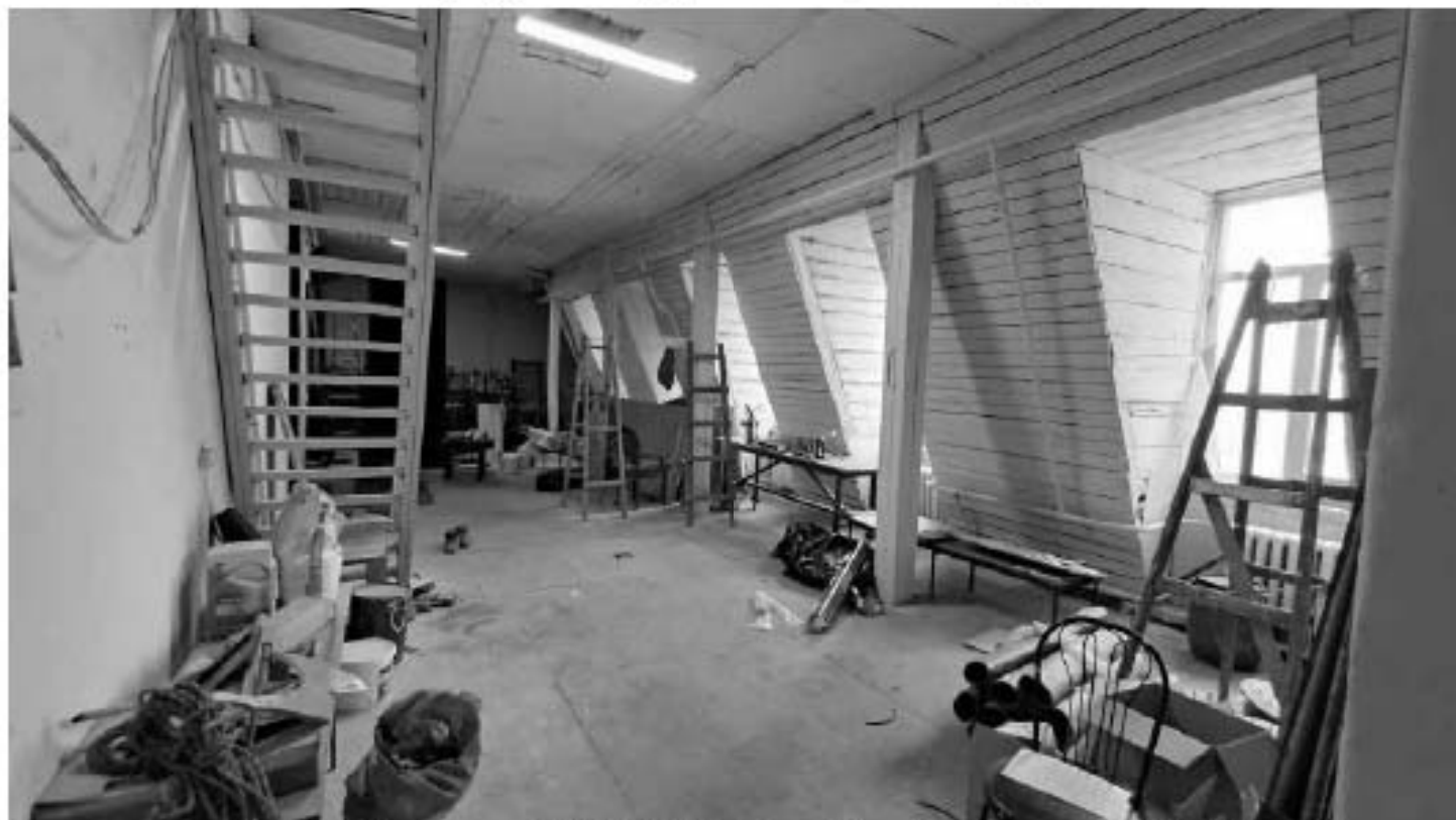
Фото 261. Помещение 1 (27-Н). Общий вид. Дата фотофиксации: 18.03.25
