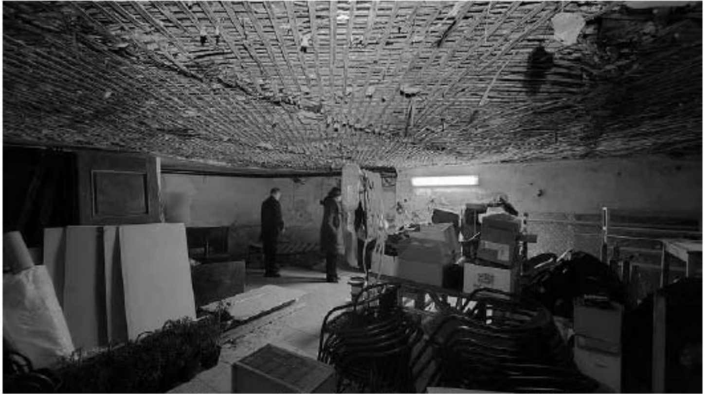
Фото 69. Помещение 3. Общий вид. Дата фотофиксации: 18.03.25
