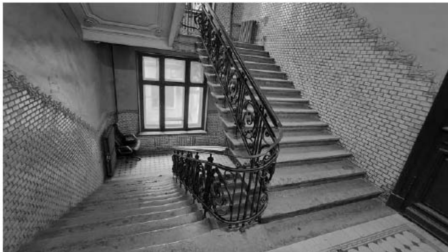
Фото 163. Парадная лестница Л1. Общий вид в уровне 2-го этажа. Дата фотофиксации: 18.03.25
