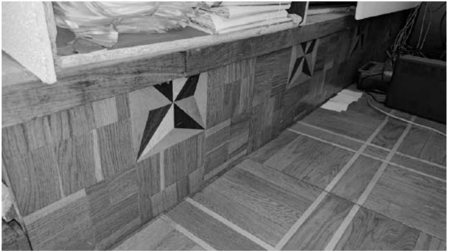
Фото 331. Исторический паркет из ценных пород дерева. Помещение 1 (21-Н). Фрагмент. Дата фотофиксации: 18.03.25
