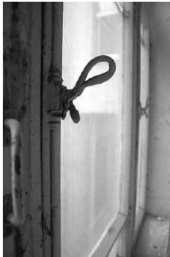
Фото 169. Исторические шпингалеты стержневые в межэтажном пространстве 2-го и 3-го этажей. Фрагмент. Дата фотофиксации: 18.03.25
