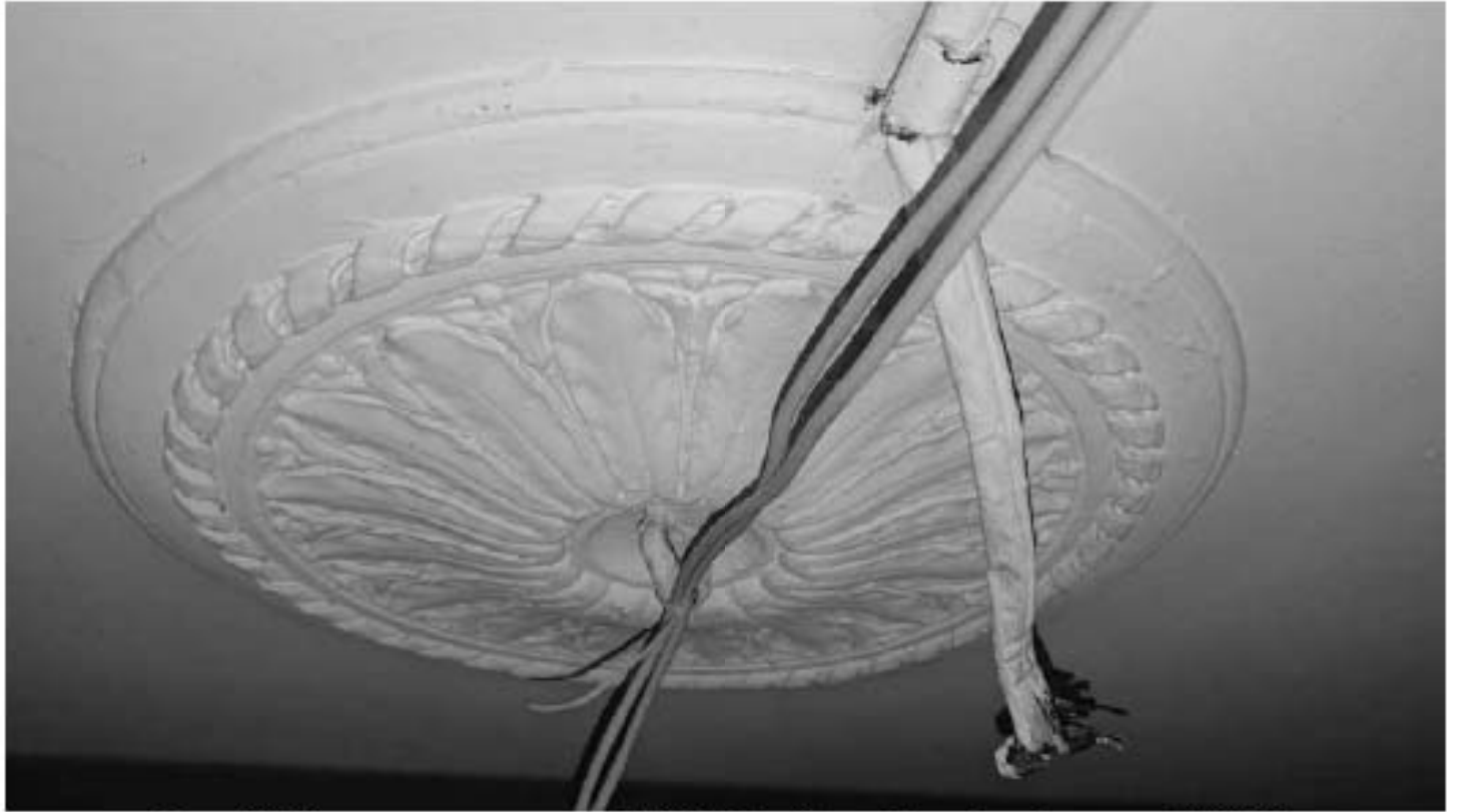
Фото 228. Розетка в помещении 1, 22-Н. Общий вид. Дата фотофиксации: 18.03.25
