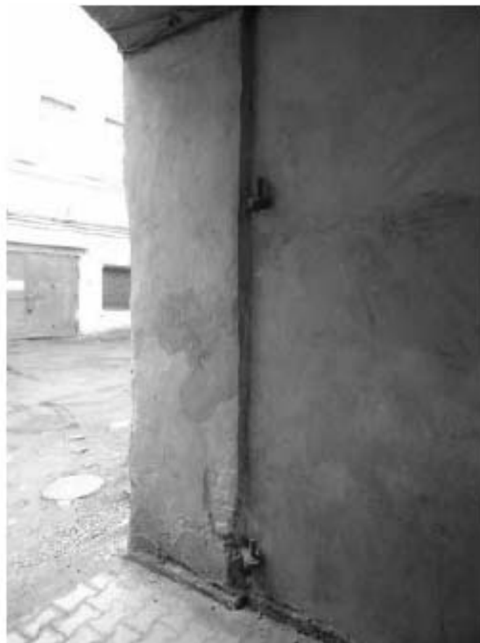
Фото 43. Исторические подставы для ворот в воротном проезде поперечного флигеля. Фрагмент. Дата фотофиксации: 18.03.25
