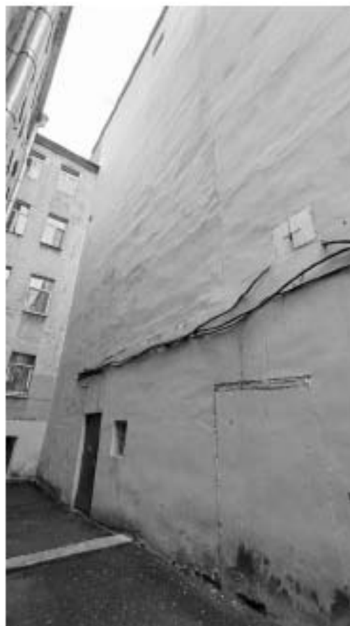
Фото 51. Восточный флигель. Фасад. Фрагмент. Дата фотофиксации: 18.03.25
