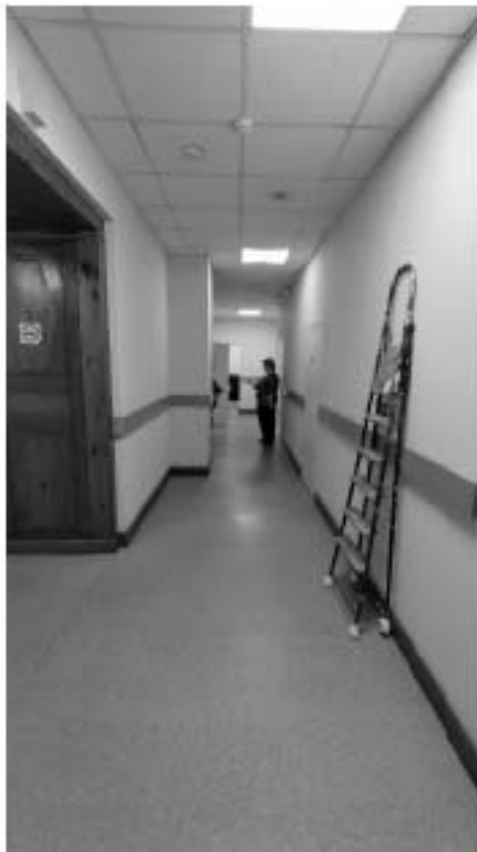
Фото 295. Пространство помещения 14. Общий вид. Дата фотофиксации: 18.03.25
