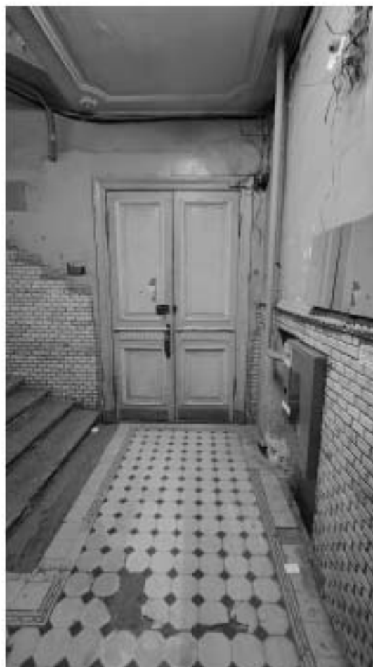
Фото 153. Историческое дверное заполнение в уровне 1-го этажа. Общий вид. Дата фотофиксации: 18.03.25
