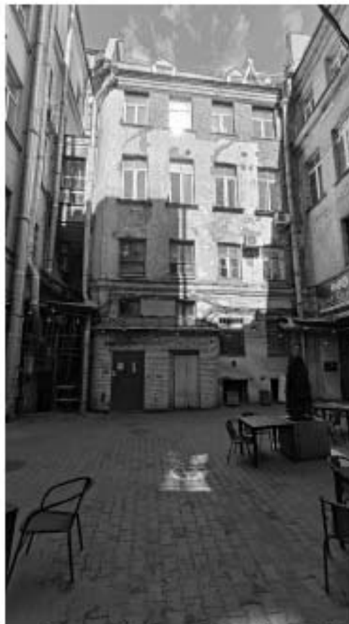
Фото 31. Северный флигель. Дворовый фасад. Общий вид. Дата фотофиксации: 14.08.25
