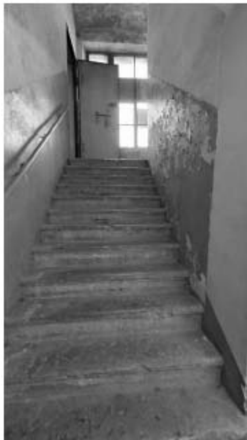
Фото 340. Общий вид лестницы ЛЗ с уровня 2-го этажа. Дата фотофиксации: 18.03.25
