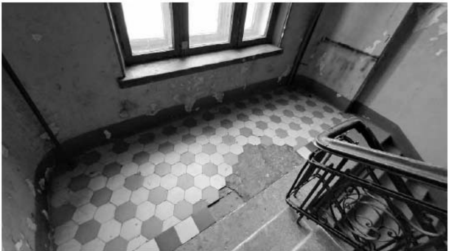
Фото 184. Метлахская плитка в межэтажном пространстве 5-го этажа и мансарды. Общий вид. Дата фотофиксации: 18.03.25
