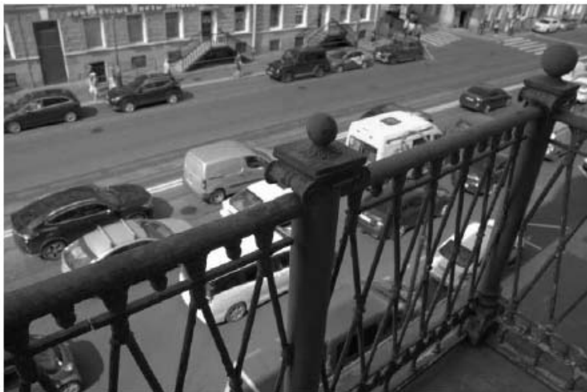
Фото 9. Литое металлическое ограждение в виде трельяжной сетки с перехватами. Фрагмент. Дата фотофиксации: 14.08.25
