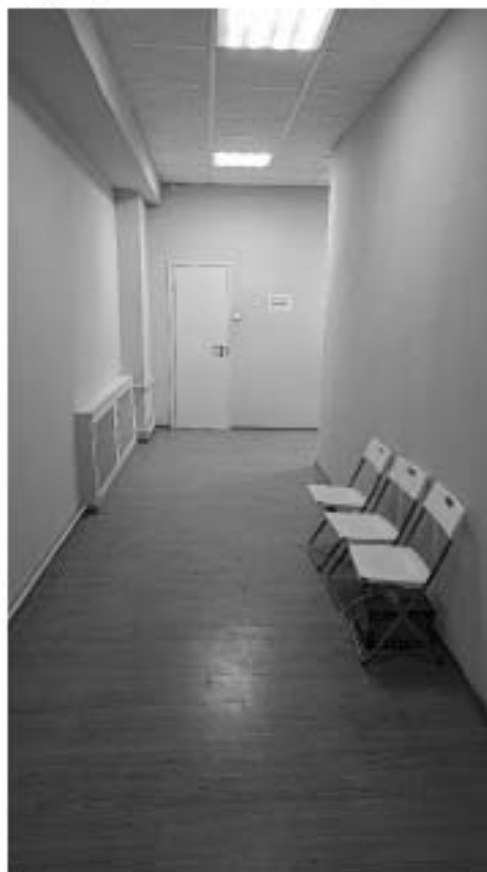
Фото 399. Пространство помещения 1 (18-Н). Фрагмент. Дата фотофиксации: 18.03.25
