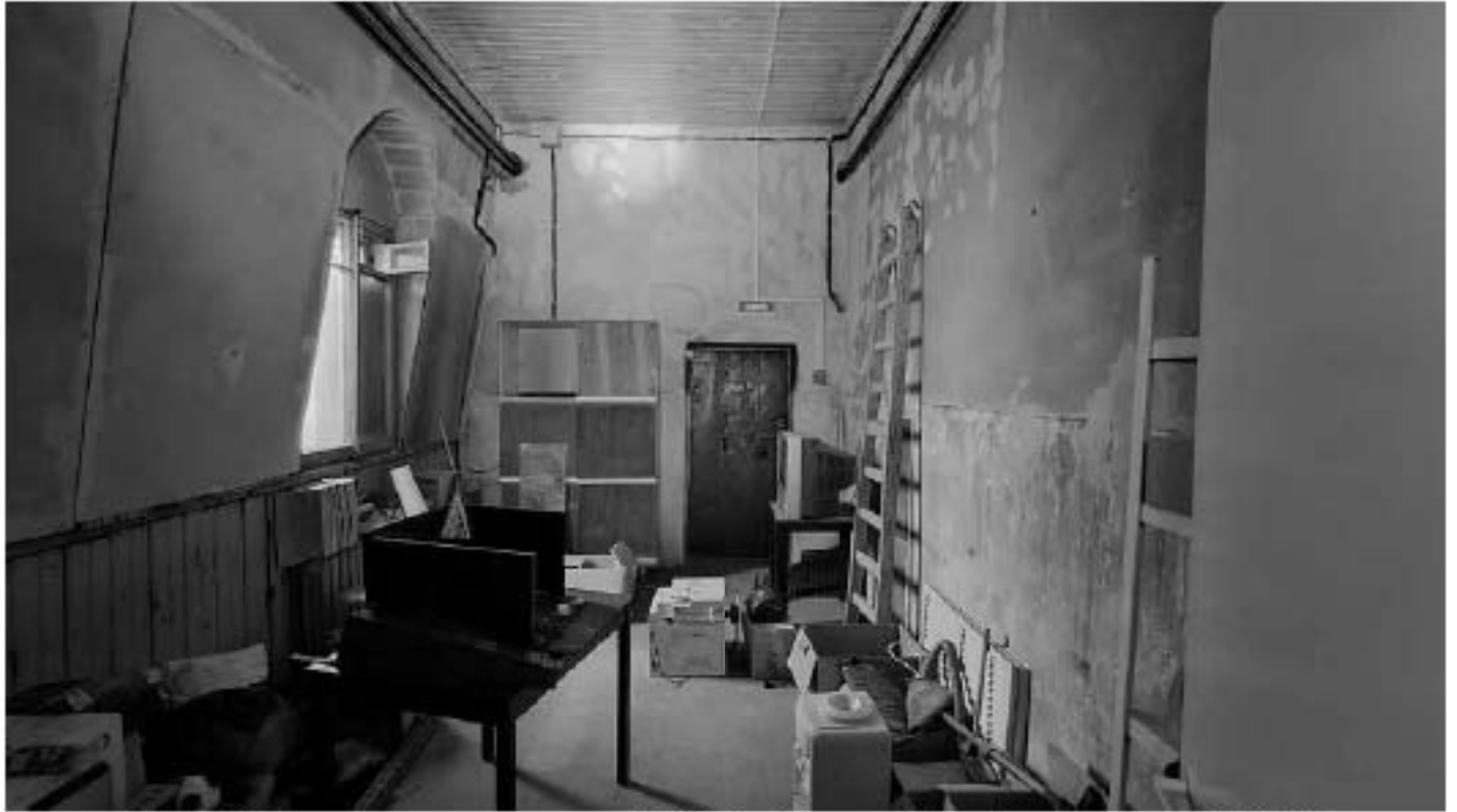
Фото 269. Пространство помещения 2 (26-Н). Фрагмент. Дата фотофиксации: 18.03.25
