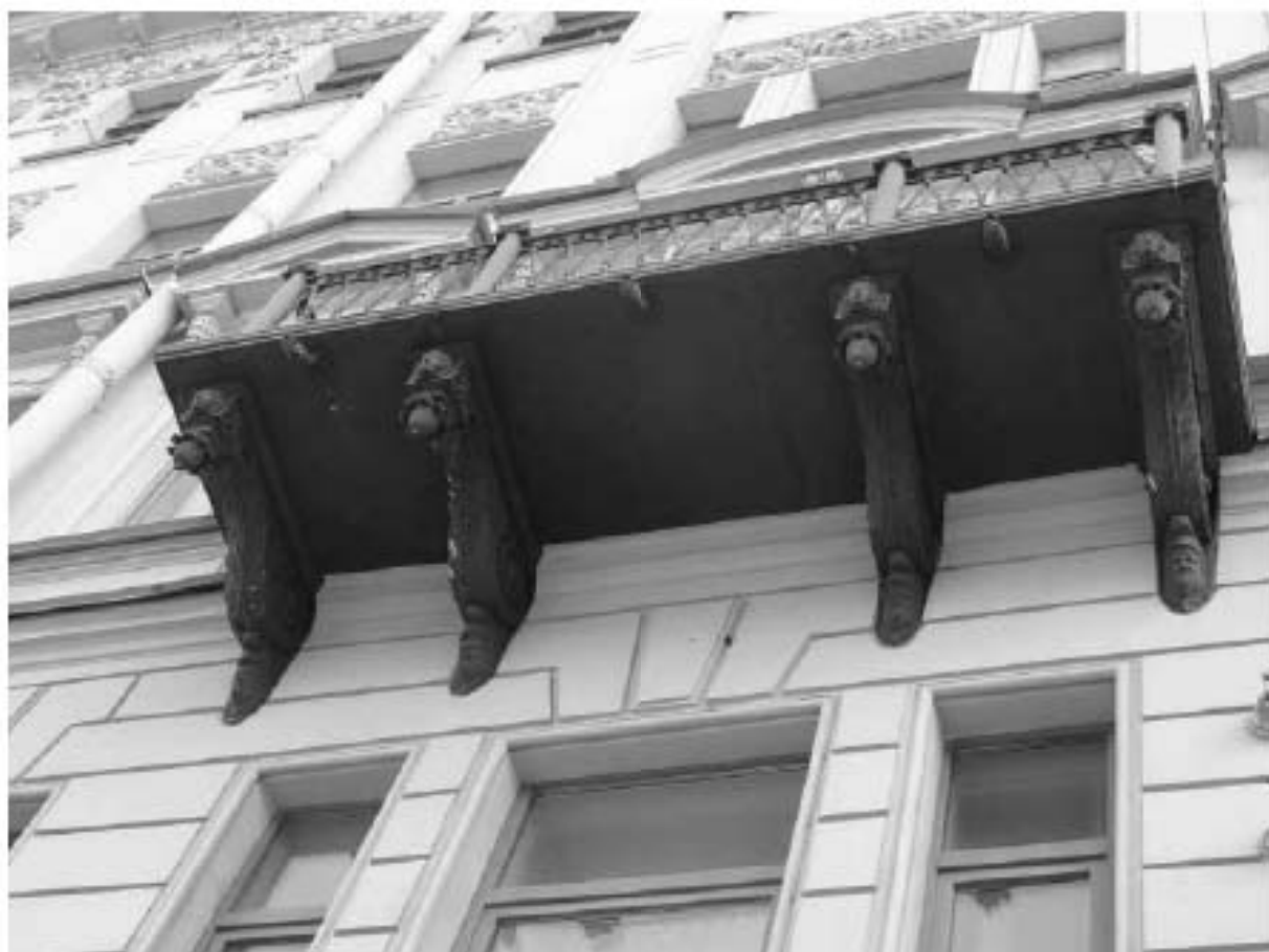
Фото 6. Балкон по центральной оси в уровне 3-го этажа. Фрагмент. Дата фотофиксации: 18.03.25
