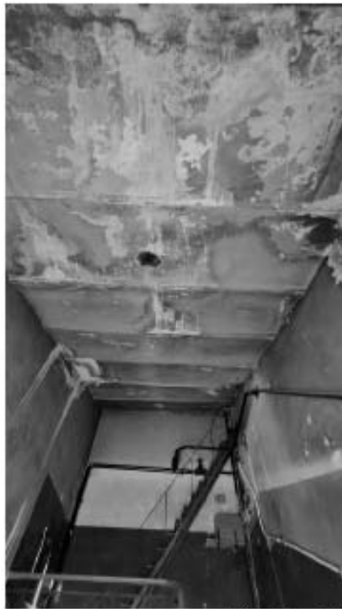
Фото 380. Пруссские своды в уровне мансарды лестницы Л2. Общий вид. Дата фотофиксации: 18.03.25
