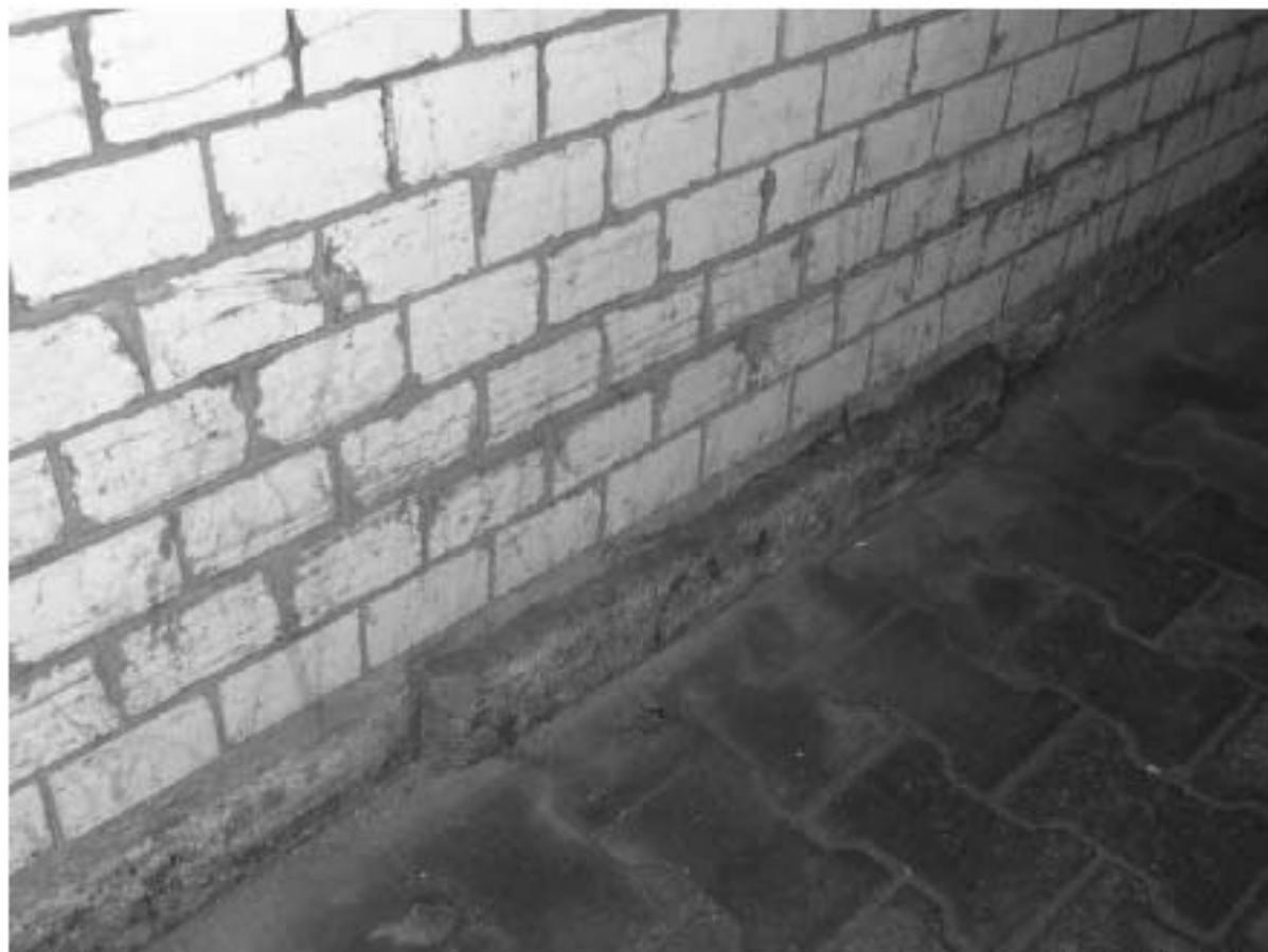
Фото 27. Материал отделки цоколя воротного проезда – известняк. Фрагмент. Дата фотофиксации: 18.03.25
