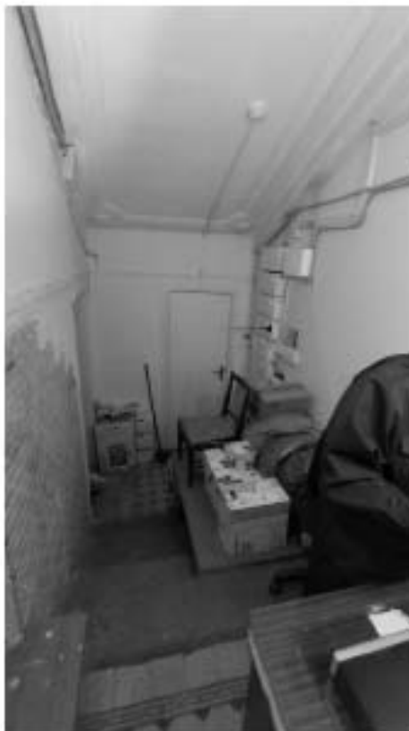
Фото 147. Объем под лестницей. Общий вид. Дата фотофиксации: 18.03.25
