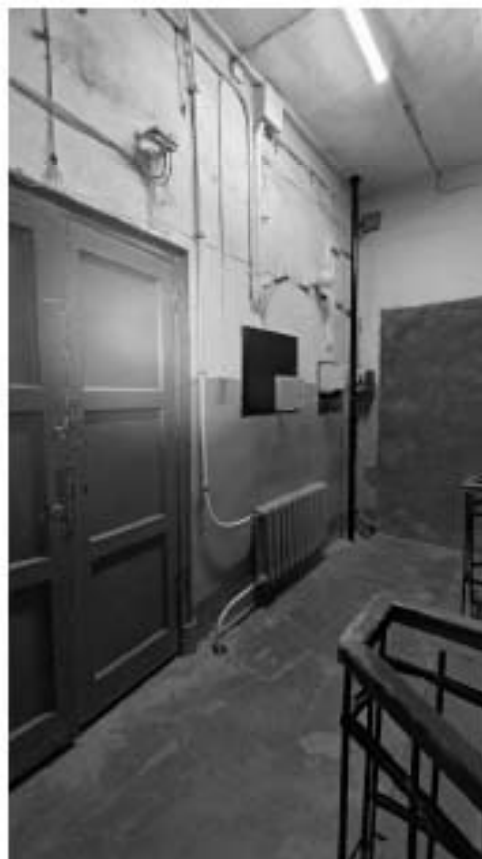
Фото 494. Площадка 3-го этажа. Фрагмент. Дата фотофиксации: 18.03.25
