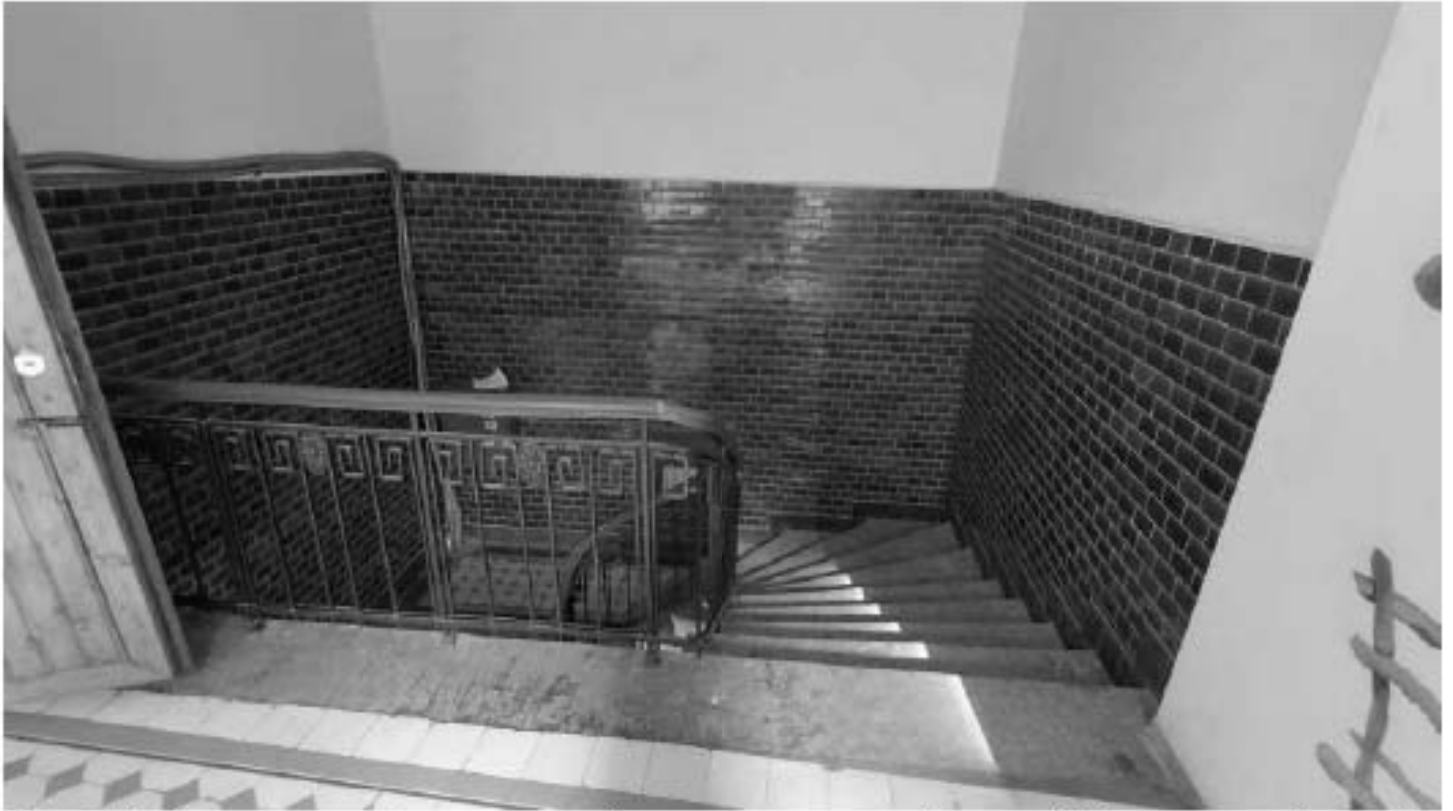
Фото 383. Декоративная облицовка нижней части стен лестничной клетки (Л5) керамической плиткой коричневого тона («кабанчию») в уровне 3-го этажа. Общий вид. Дата фотофиксации: 18.03.25
