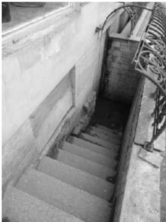
Фото 20. Лестница в помещения цоколя (1 (1-Н)). Общий вид. Дата фотофиксации: 18.03.25
