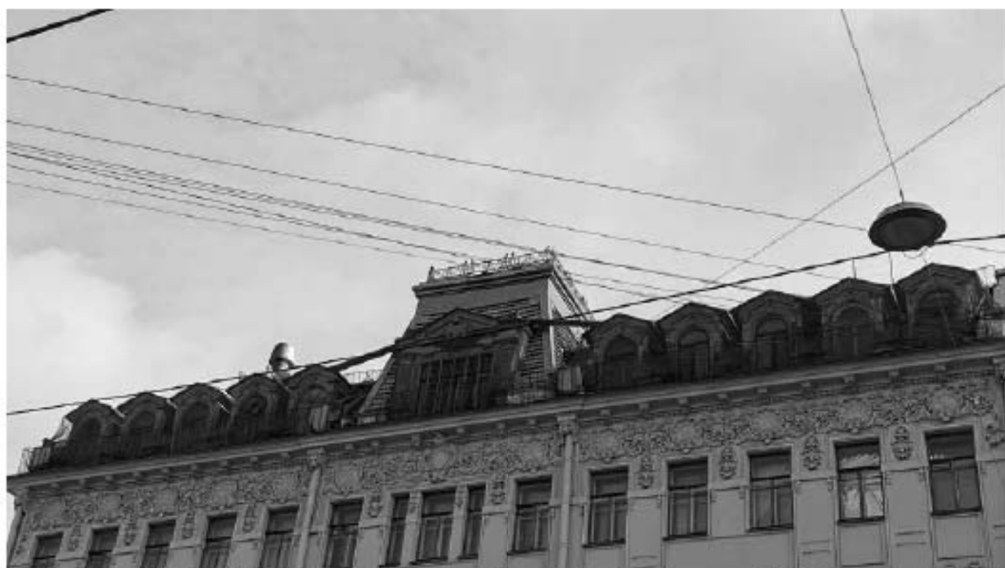
Фото 2. Объёмы мансарды. Общий вид. Дата фотофиксации: 18.03.25
