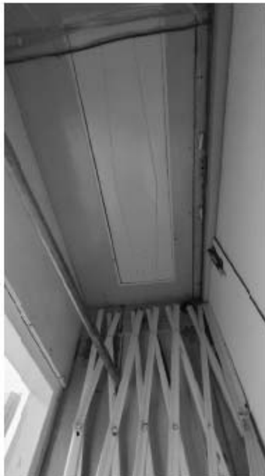
Фото 293. Тамбур между помещением 20 и площадкой лестницы Л1. Фрагмент. Дата фотофиксации: 18.03.25
