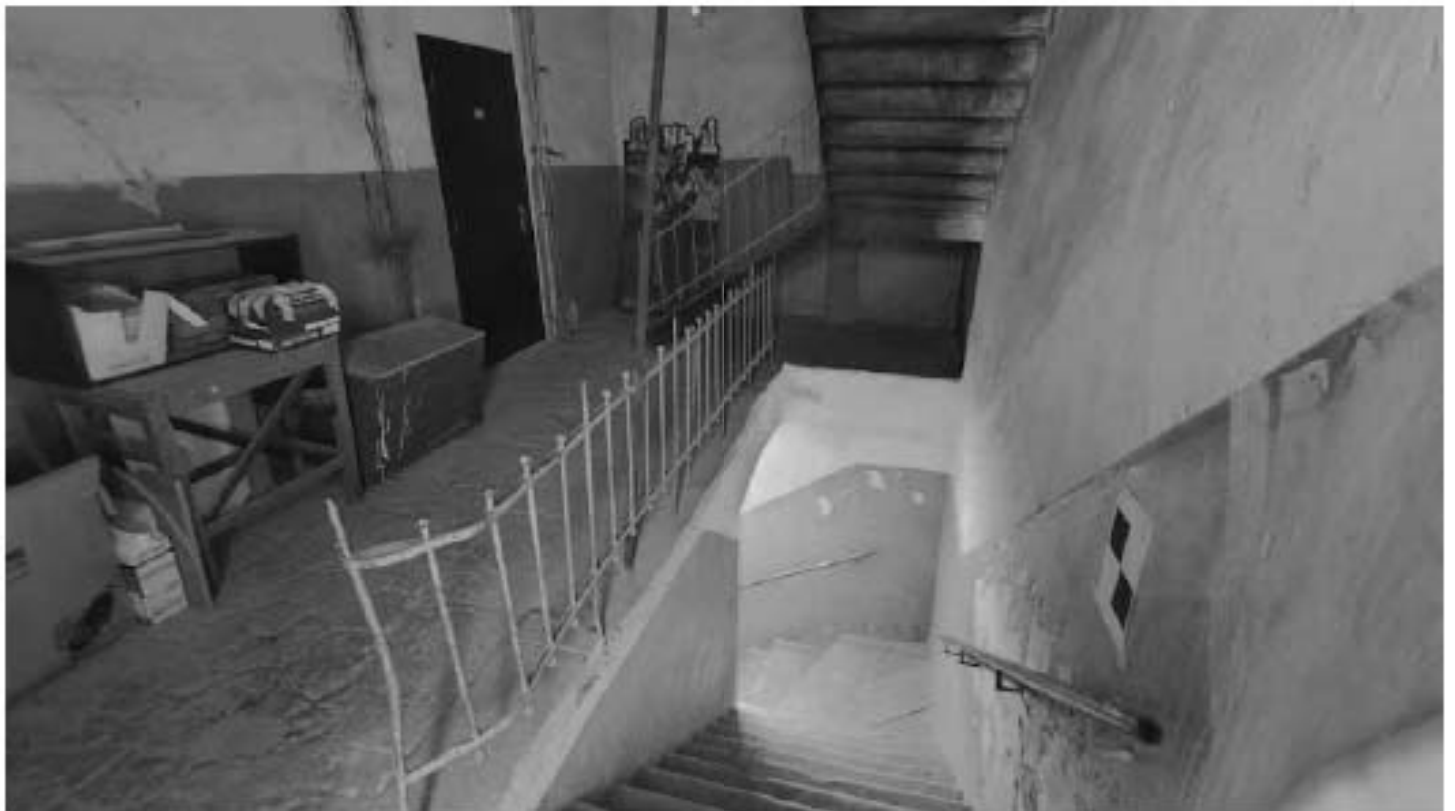
Фото 351. Площадка 4-го этажа. Общий вид. Дата фотофиксации: 18.03.25
