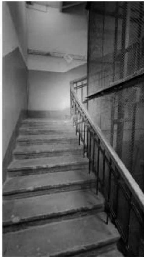
Фото 491. Межэтажное пространство 2-го и 3-го этажей лестницы Л4. Фрагмент. Дата фотофиксации: 18.03.25
