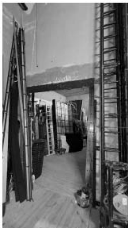
Фото 471. Портал между помещениями 1 и 4. Общий вид. Дата фотофиксации: 18.03.25
