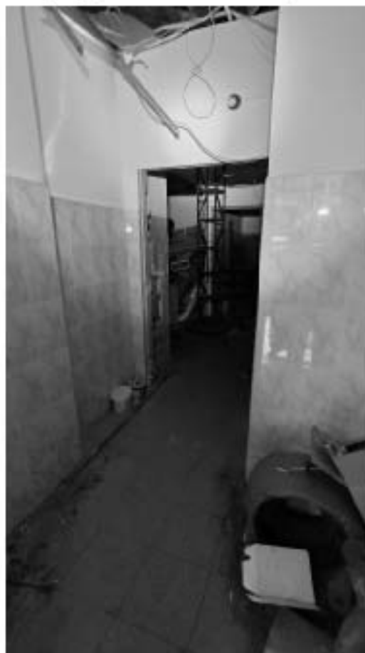
Фото 105. Пространство помещений 7 и 8. Фрагмент. Дата фотофиксации: 18.03.25
