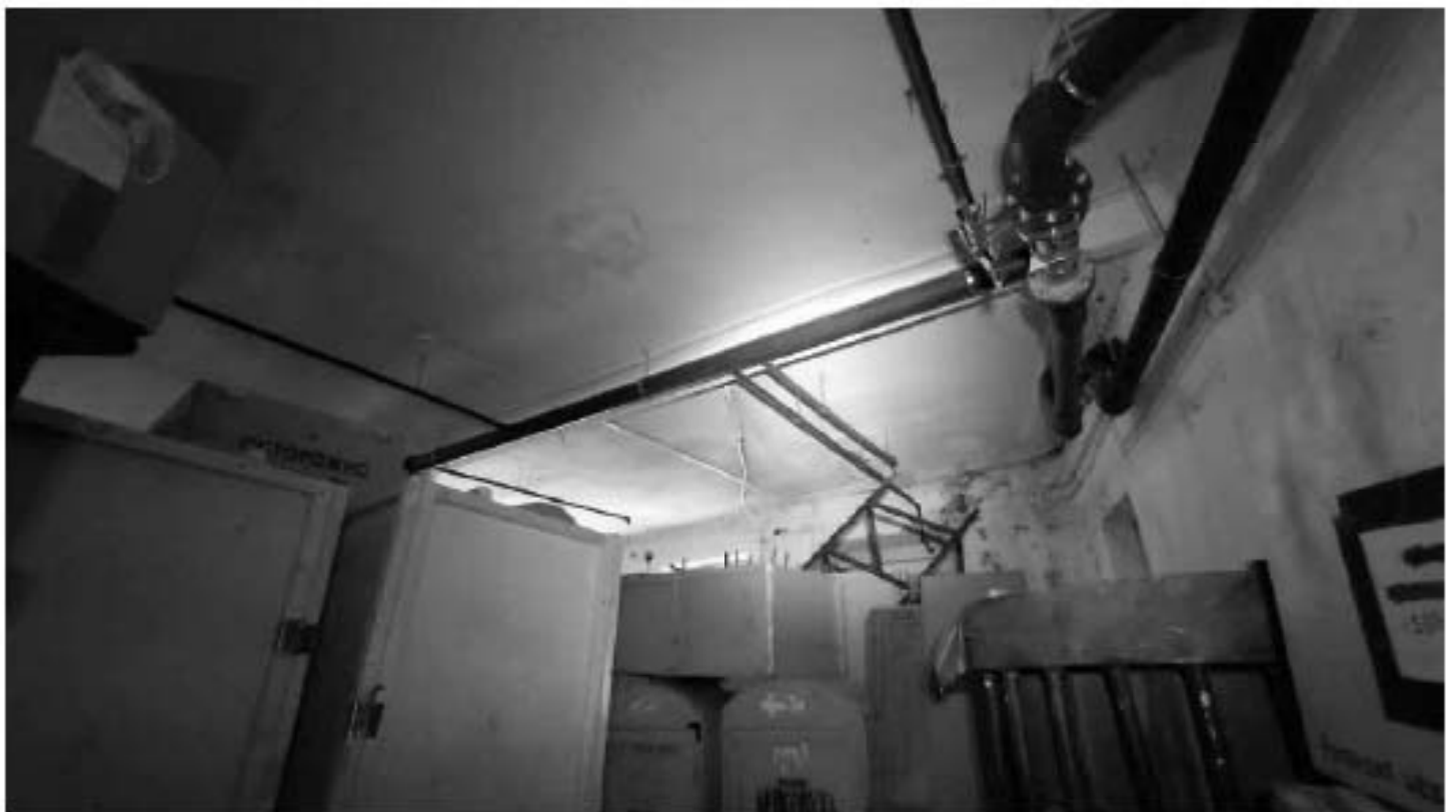
Фото 507. Пространство помещения 4 (40-Н). Фрагмент. Дата фотофиксации: 18.03.25
