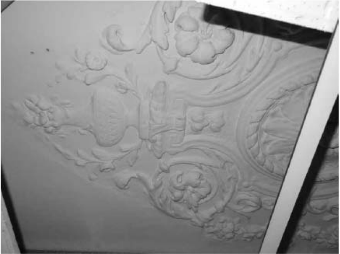
Фото 427. Потолочная розетка в помещениях 1, 2 (16-Н). Фрагмент. Дата фотофиксации: 18.03.25
