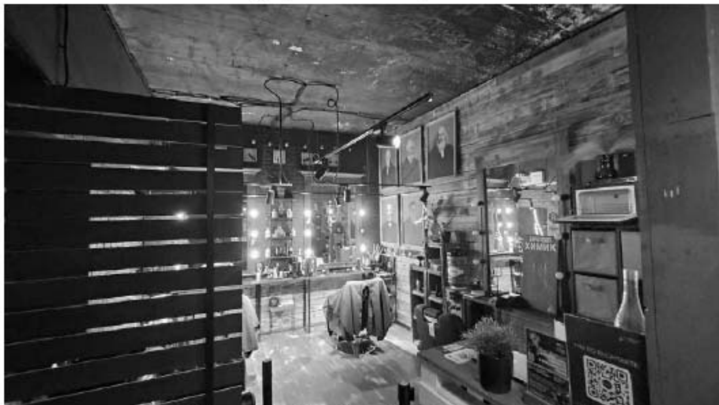
Фото 98. Помещение 1. Общий вид. Дата фотофиксации: 18.03.25
