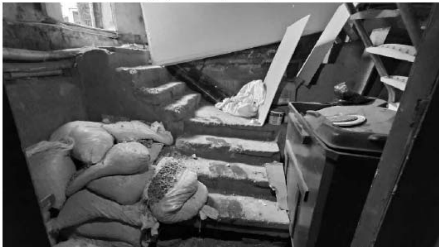
Фото 63. Служебная лестница Л6. Общий вид. Дата фотофиксации: 14.08.25
