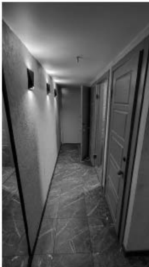
Фото 123. Пространство помещений 1, 2, 3 (19-Н). Фрагмент. Дата фотофиксации: 18.03.25
