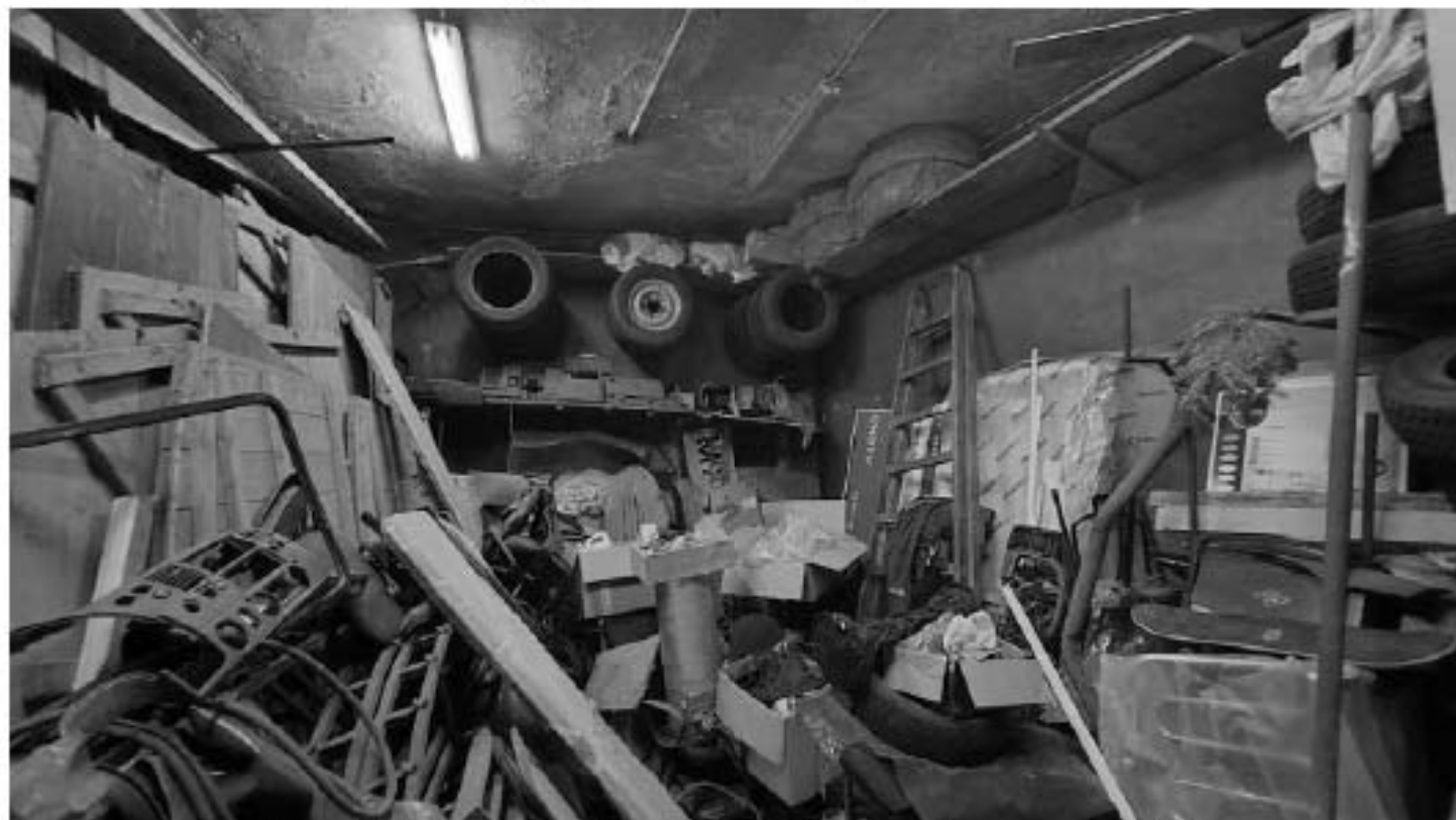
Фото 100. Помещение 2. Общий вид. Дата фотофиксации: 18.03.25
