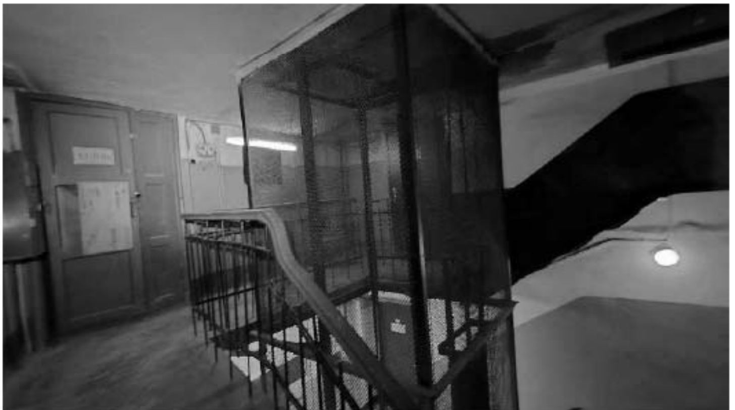
Фото 500. Площадка 5-го этажа. Общий вид. Дата фотофиксации: 18.03.25
