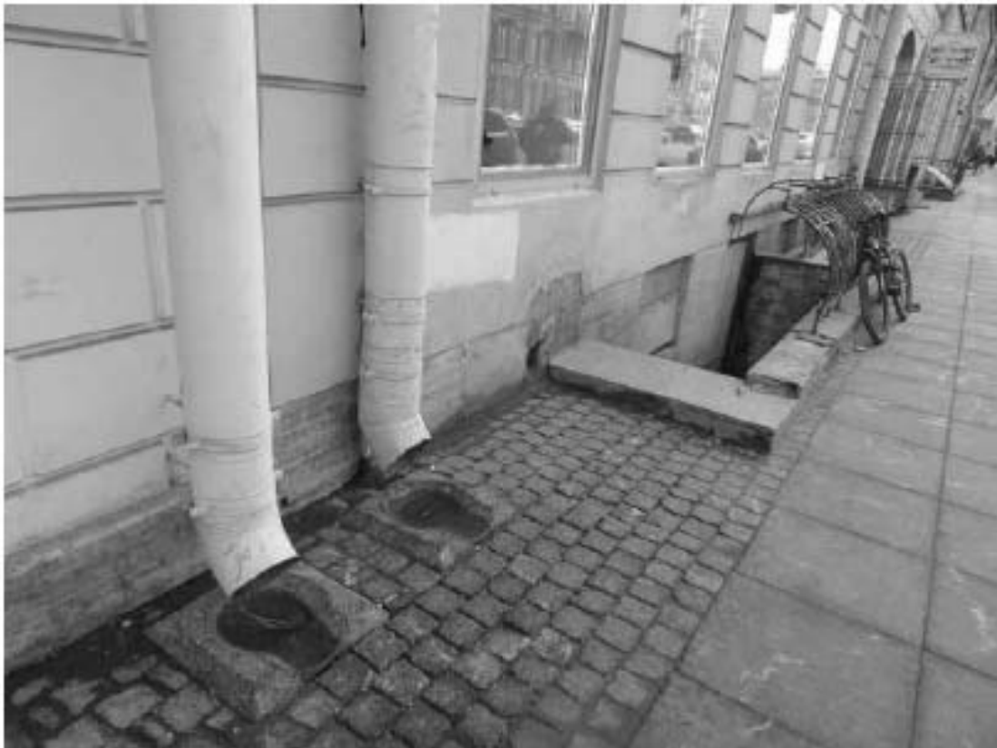
Фото 19. Известняковый цоколь лицевого фасада. Фрагмент. Дата фотофиксации: 18.03.25
