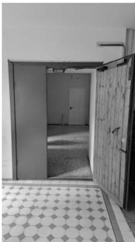
Фото 382. Современное дверное заполнение в уровне 3-го этажа лестницы Л5. Общий вид. Дата фотофиксации: 18.03.25
