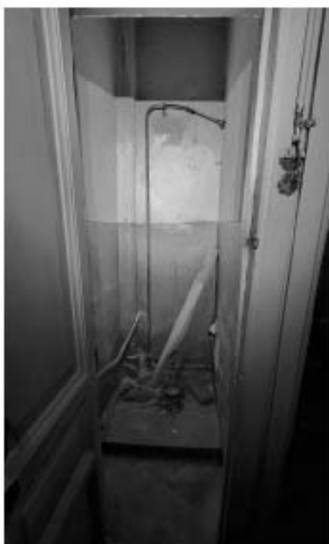
Фото 528. Помещение 6 (41-Н). Общий вид. Дата фотофиксации: 18.03.25
