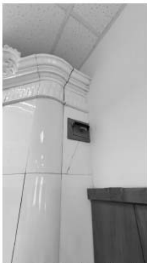
Фото 215. Латунные душники. Общий вид. Дата фотофиксации: 18.03.25
