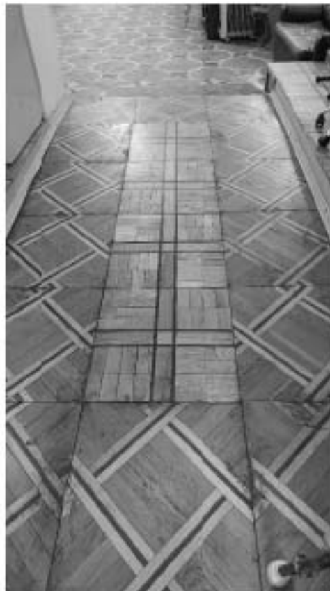
Фото 327. Исторический паркет из ценных пород дерева геометрического рисунка в три цвета (дуб, бук, орех). Помещение 1 (21-Н). Фрагмент. Дата фотофиксации: 18.03.25
