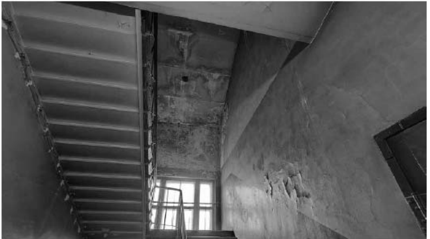
Фото 378. Косоуры лестницы Л2. Фрагмент. Дата фотофиксации: 18.03.25
