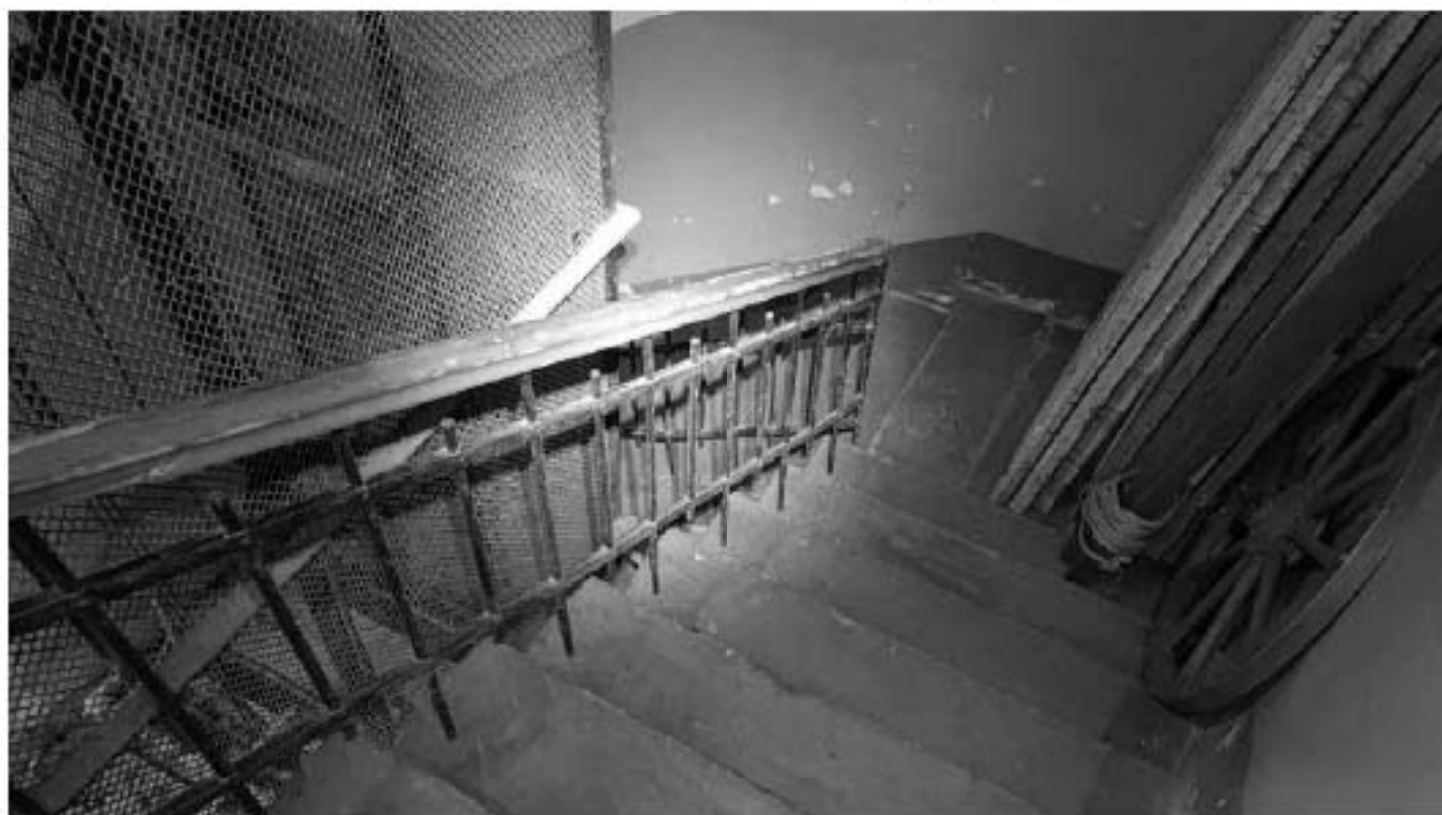
Фото 486. Межэтажное пространство 2-го и 1-го этажей лестницы Л4. Фрагмент. Дата фотофиксации: 18.03.25
