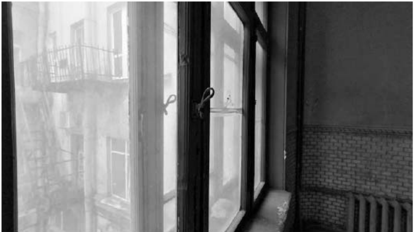
Фото 168. Исторические шпингалеты стержневые в межэтажном пространстве 2-го и 3-го этажей. Фрагмент. Дата фотофиксации: 18.03.25
