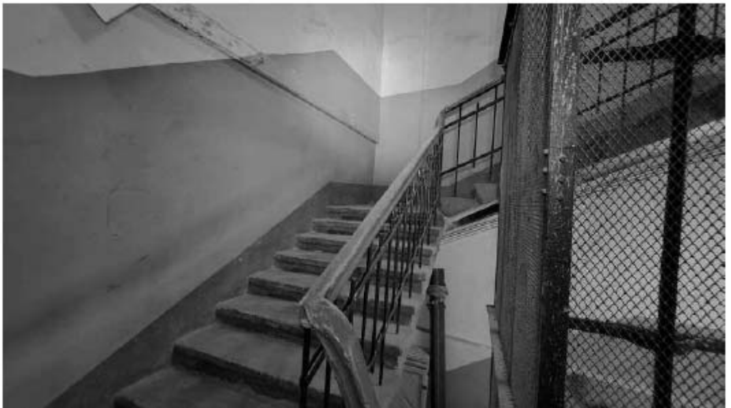
Фото 492. Межэтажное пространство 2-го и 3-го этажей лестницы Л4. Фрагмент. Дата фотофиксации: 18.03.25
