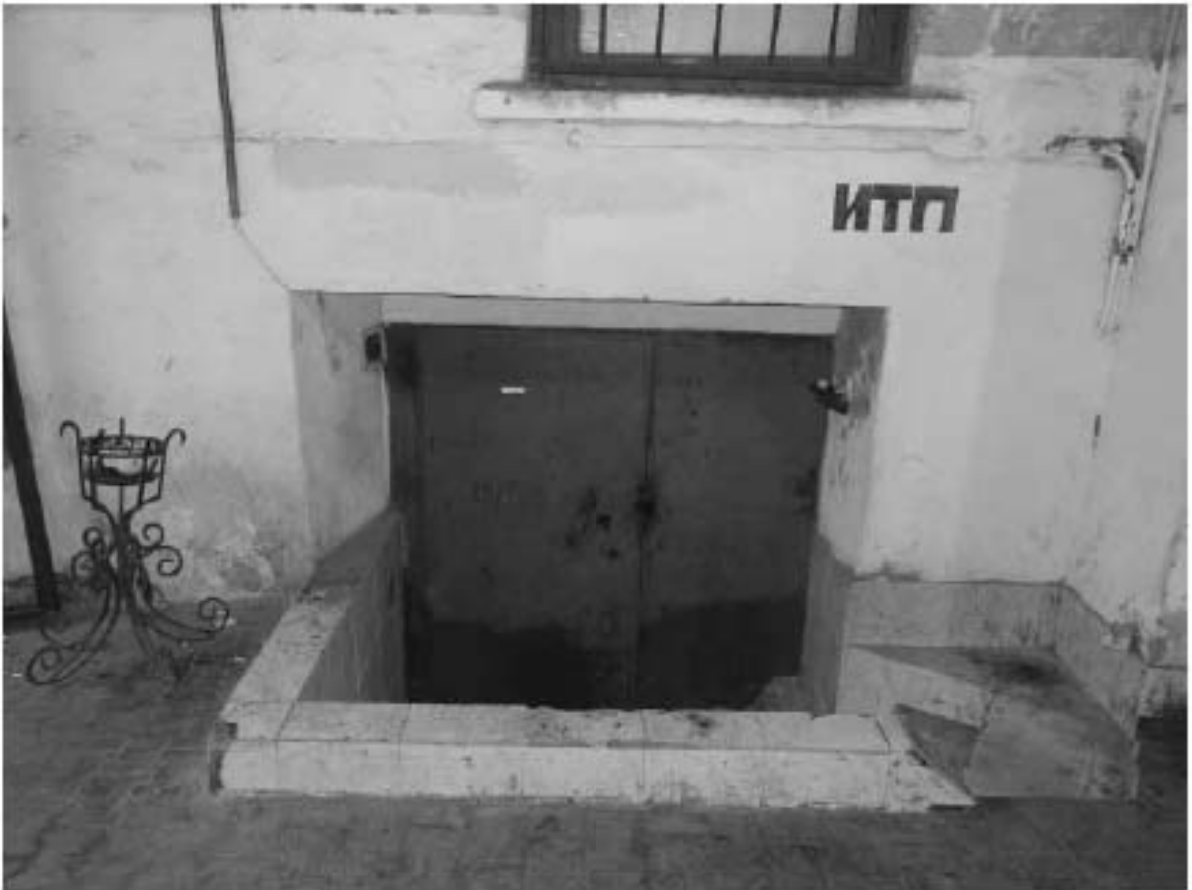
Фото 41. Вход в помещения цокольного этажа 2-Н. Общий вид. Дата фотофиксации: 18.03.25
