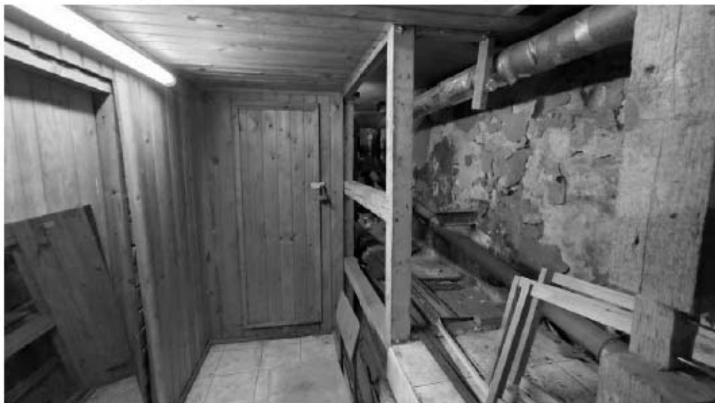
Фото 80. Пространство помещения 1 (2-Н). Фрагмент. Дата фотофиксации: 18.03.25
