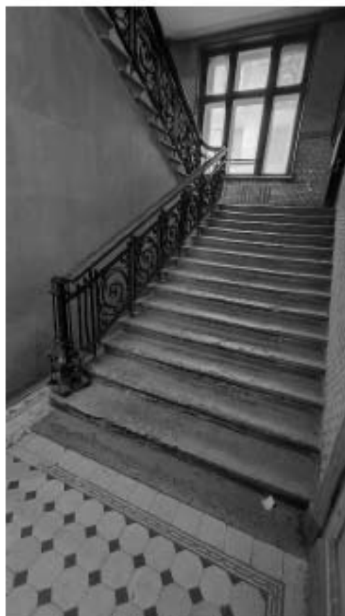
Фото 154. Двухмаршевая парадная лестница Л1. Общий вид в уровне 1-го этажа. Дата фотофиксации: 18.03.25
