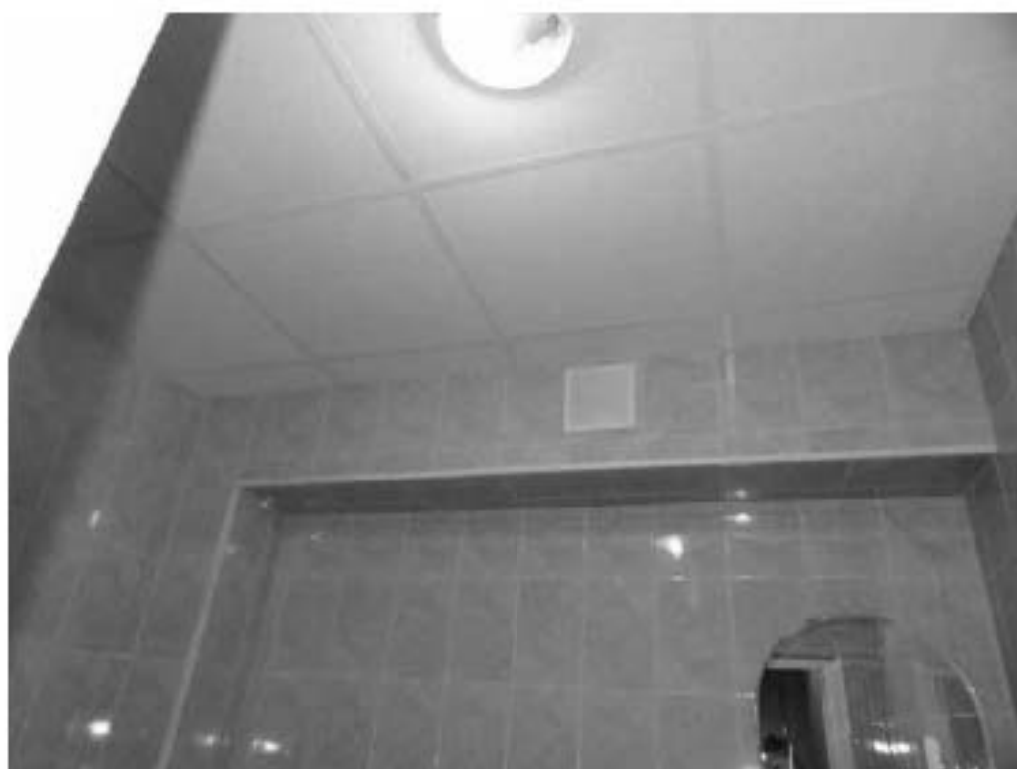
Фото 430. Пространство помещений 8, 7, 4 (16-Н). Фрагмент. Дата фотофиксации: 18.03.25
