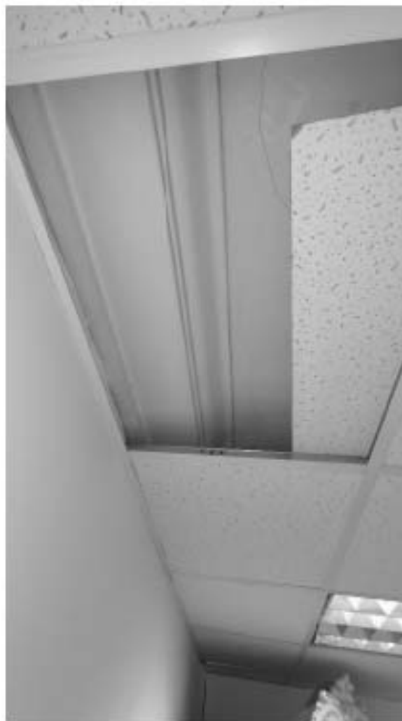
Фото 213. Тяги в помещении 5. Фрагмент. Дата фотофиксации: 18.03.25
