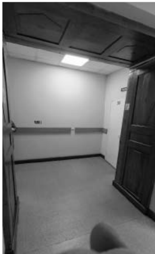
Фото 290. Оформление проема деревянными филенчатыми панелями с усеченными ромбами в филенках с овальной розеткой по центру в технике маркетри. Фрагмент. Дата фотофиксации: 18.03.25
