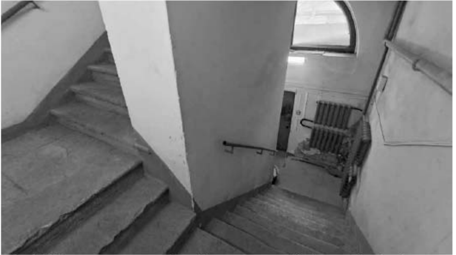
Фото 346. Межэтажное пространство 1-го и 2-го этажа лестницы ЛЗ. Фрагмент. Дата фотофиксации: 18.03.25
