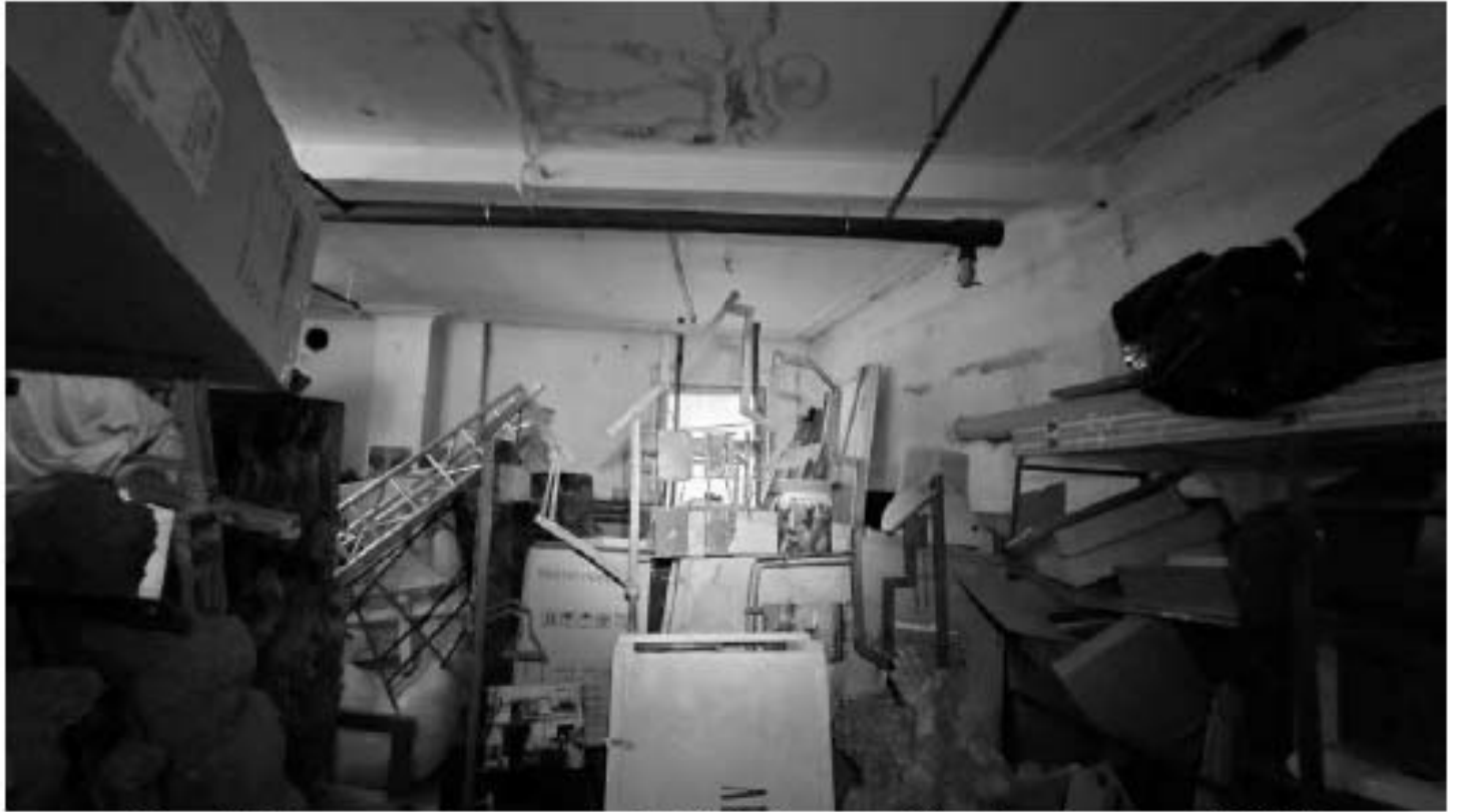
Фото 512. Пространство помещения 4 (40-Н). Фрагмент. Дата фотофиксации: 18.03.25
