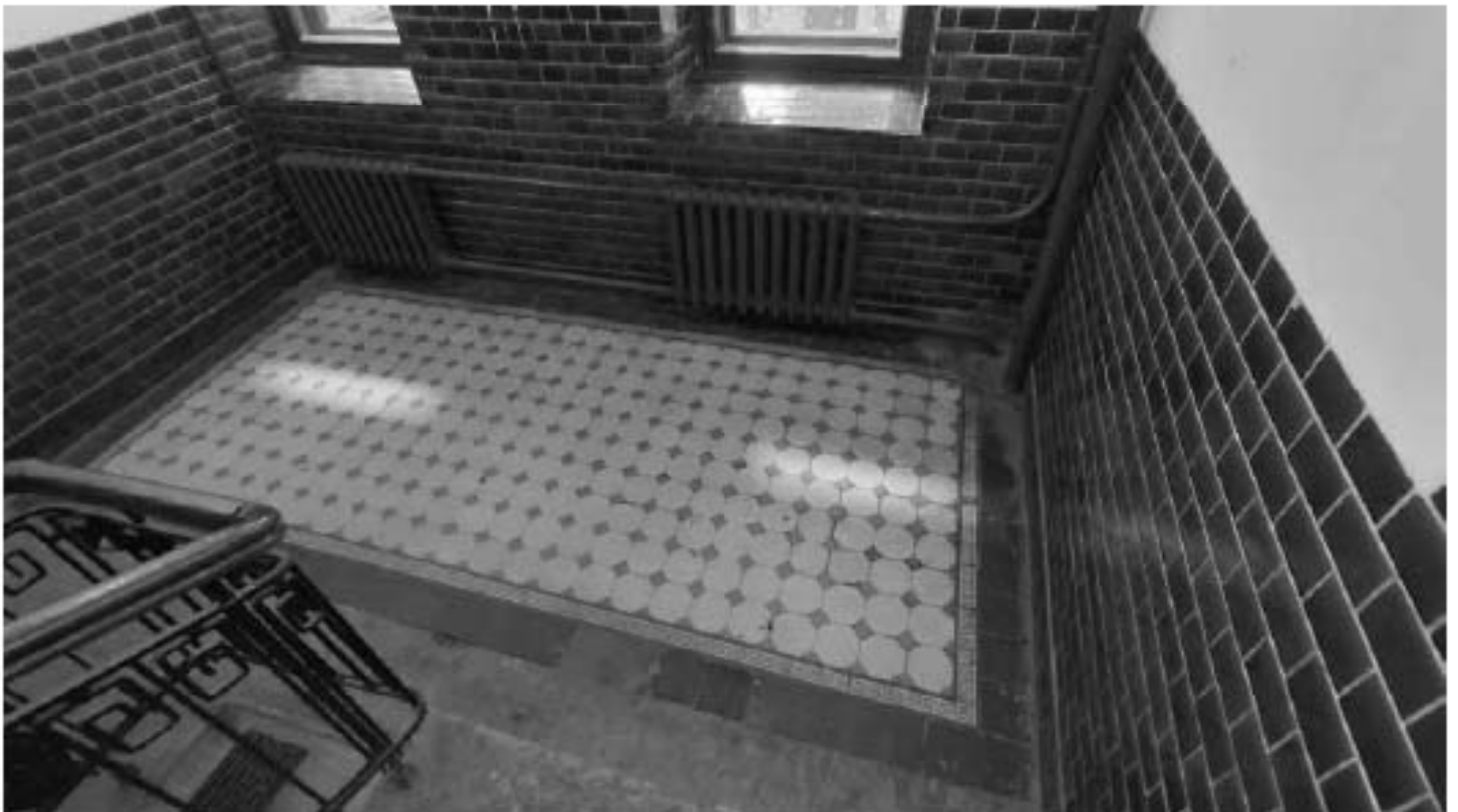
Фото 394. Метлахская плитка на площадке межэтажного пространства 1-го и 2-го этажей лестницы Л5. Общий вид. Дата фотофиксации: 18.03.25
