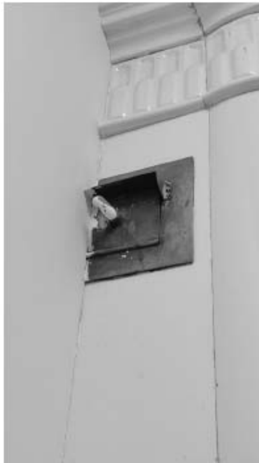
Фото 209. Латунные душники. Общий вид. Дата фотофиксации: 18.03.25
