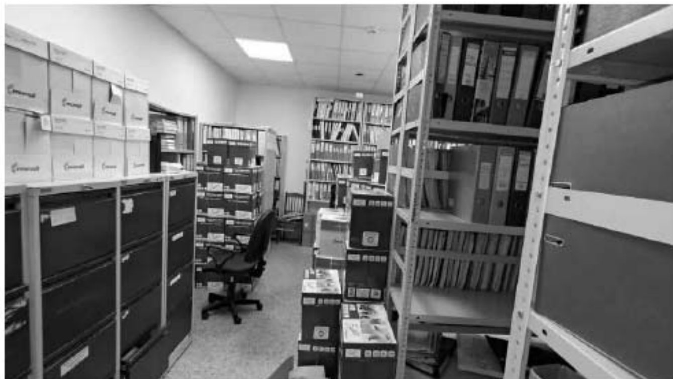
Фото 358. Помещение 40 (23-Н). Общий вид. Дата фотофиксации: 18.03.25
