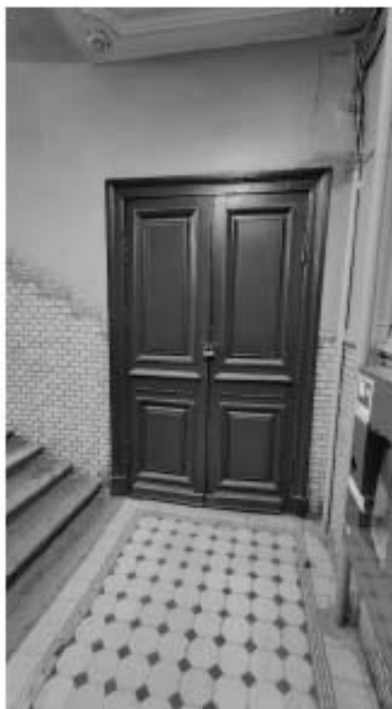
Фото 166. Историческое дверное заполнение в уровне 2-го этажа. Общий вид. Дата фотофиксации: 18.03.25
