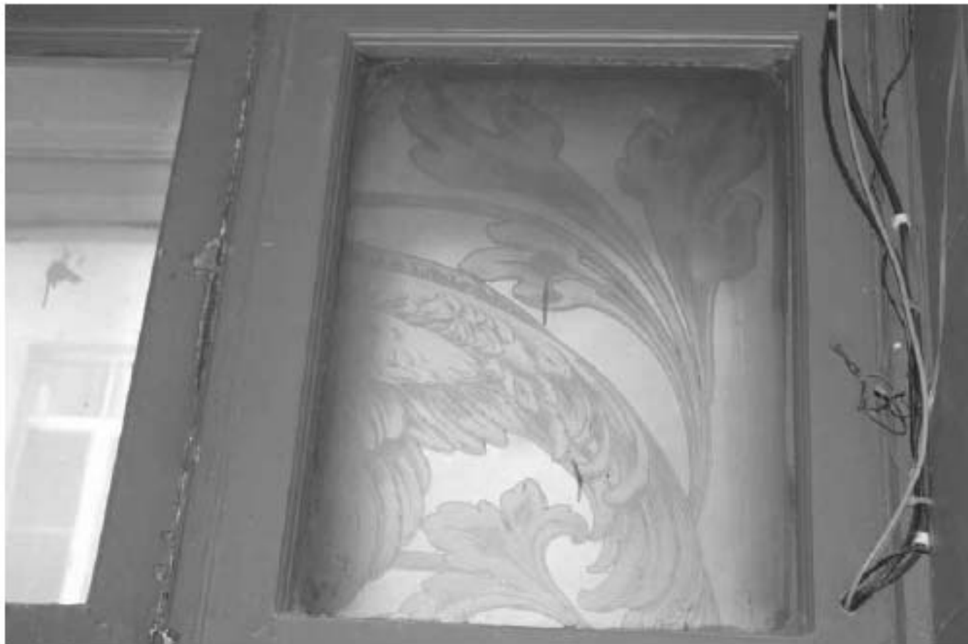
Фото 161. Фрагмент исторического витража в стилистике модерна, на межэтажной площадке 1-2-го этажей, с изображением хвоста павлина и растительных побегов. Дата фотофиксации: 18.03.25
