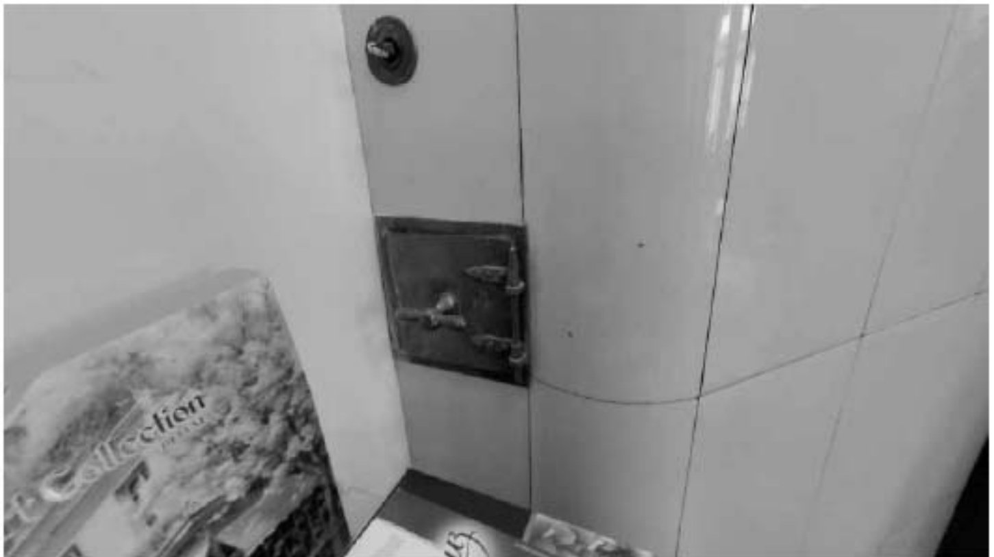
Фото 217. Латунные душники. Общий вид. Дата фотофиксации: 18.03.25
