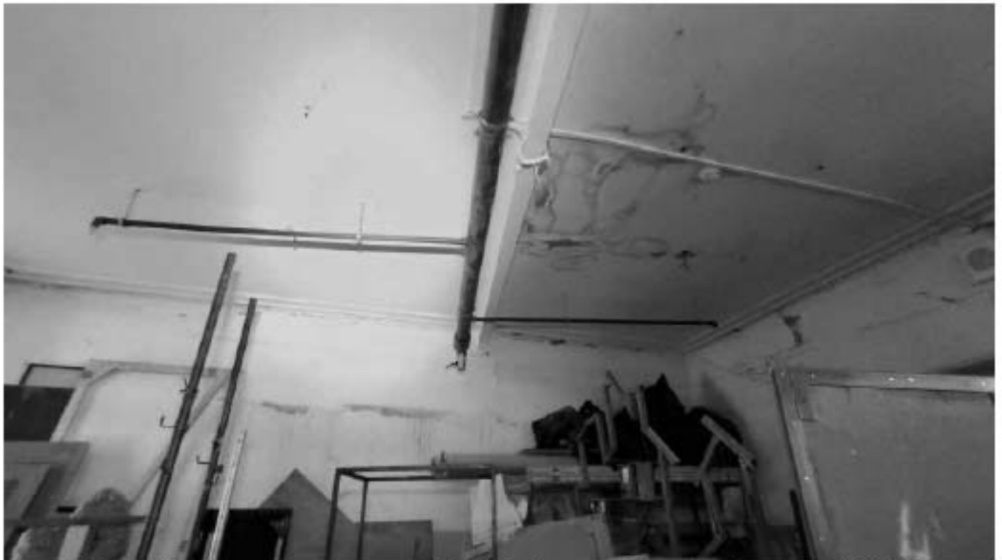
Фото 511. Пространство помещения 4 (40-Н). Фрагмент. Дата фотофиксации: 18.03.25
