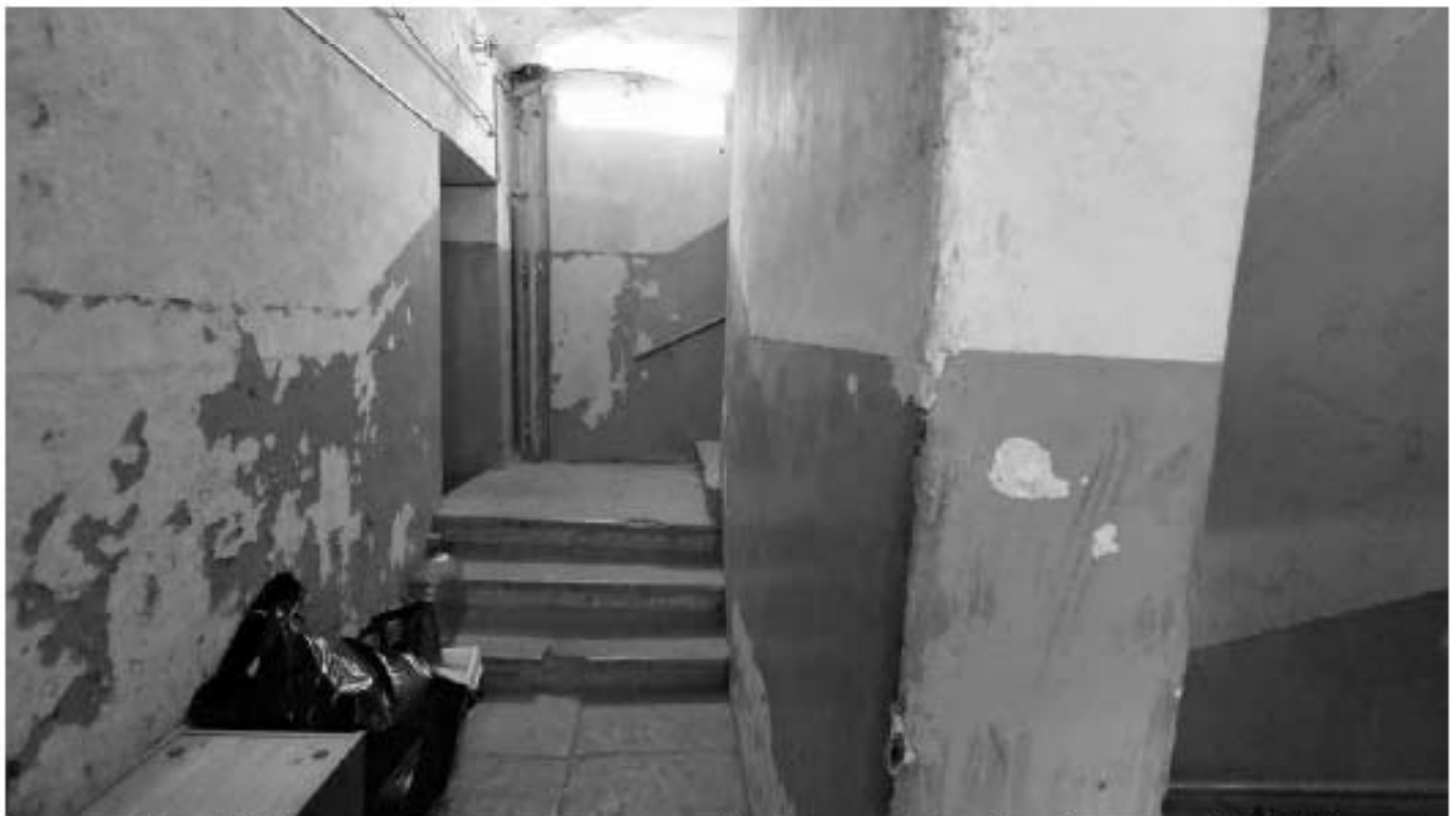
Фото 337. Площадка 3-го этажа лестницы ЛЗ. Фрагмент. Дата фотофиксации: 18.03.25
