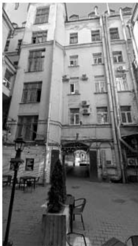
Фото 30. Западный флигель. Дворовый фасад. Общий вид. Дата фотофиксации: 14.08.25
