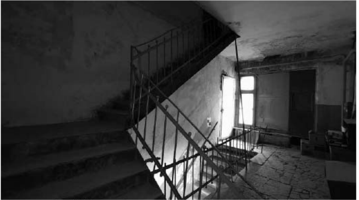
Фото 352. Площадка 4-го этажа. Общий вид. Дата фотофиксации: 18.03.25
