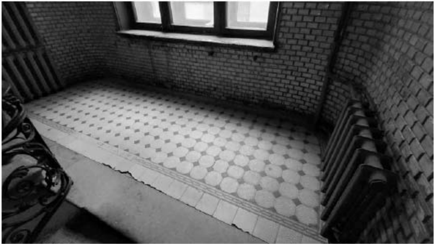
Фото 167. Метлахская плитка в межэтажном пространстве 2-го и 3-го этажей. Общий вид. Дата фотофиксации: 18.03.25
