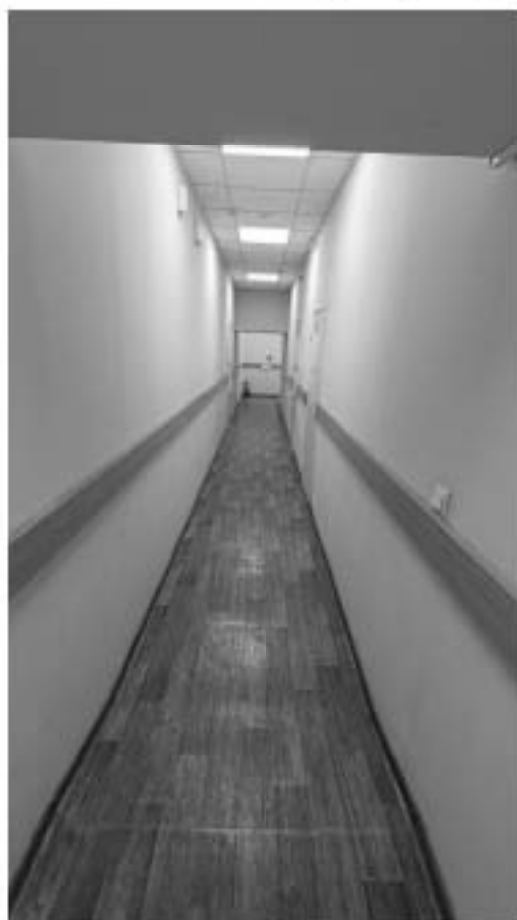
Фото 357. Пространство помещения 31 (23-Н). Общий вид. Дата фотофиксации: 18.03.25
