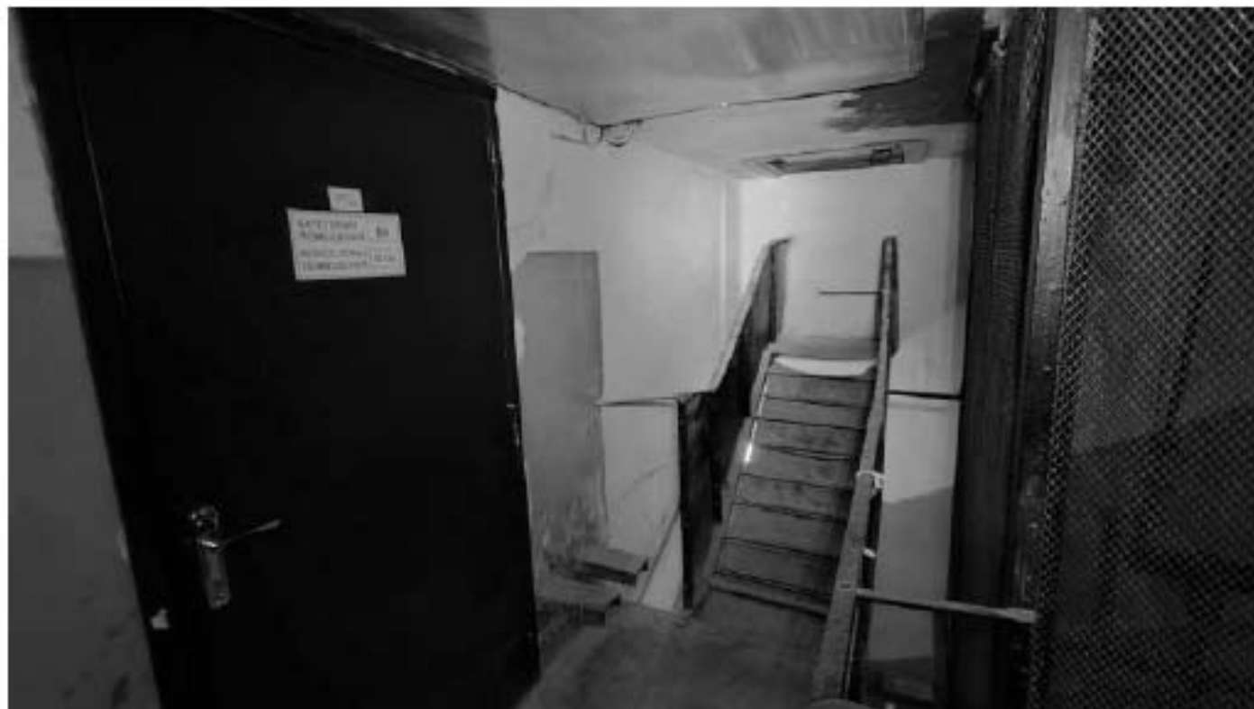
Фото 501. Ступени в антресоль на площадке 5-го этажа. Общий вид. Дата фотофиксации: 18.03.25
