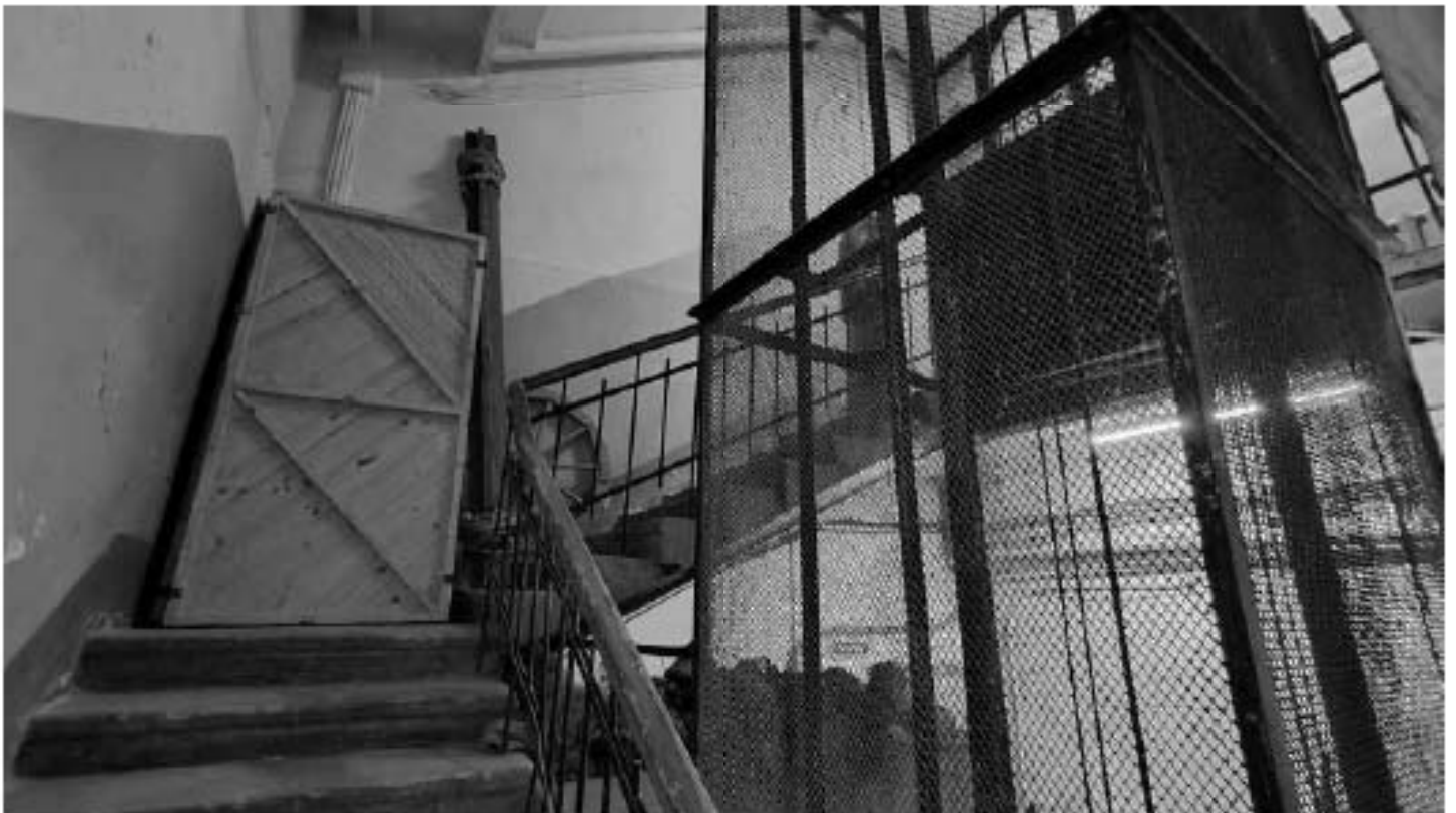
Фото 488. Межэтажное пространство 2-го и 1-го этажей лестницы Л4. Фрагмент. Дата фотофиксации: 18.03.25
