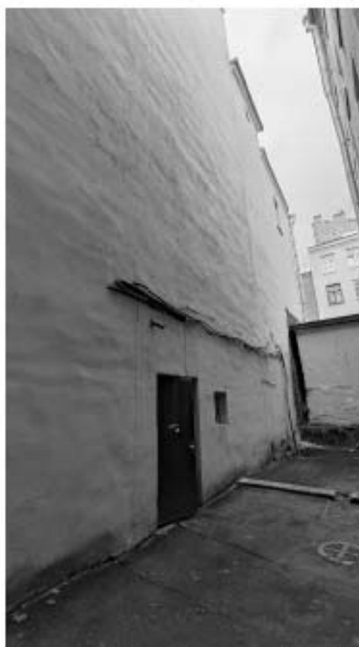
Фото 52. Восточный флигель. Фасад. Фрагмент. Дата фотофиксации: 18.03.25
