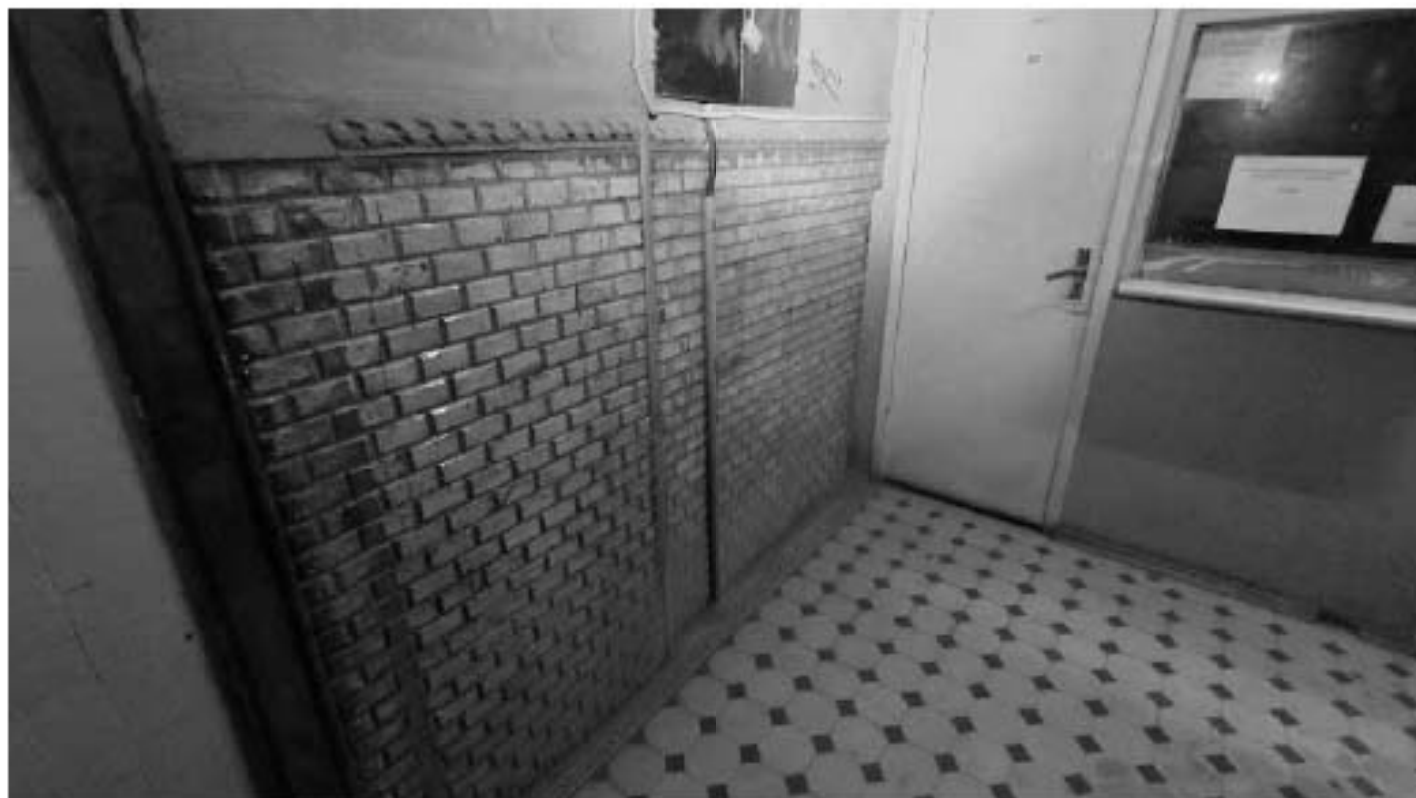
Фото 151. Декоративная облицовка нижней части стен лестничной клетки керамической плиткой светло-серого цвета («кабанчик») в уровне первого этажа. Фрагмент. Дата фотофиксации: 18.03.25
