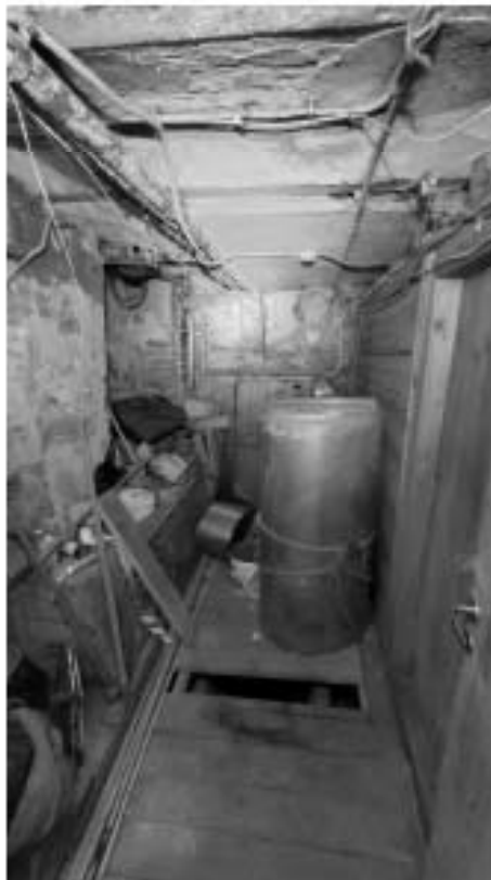
Фото 82. Пространство помещения 6 (2-Н). Фрагмент. Дата фотофиксации: 18.03.25
