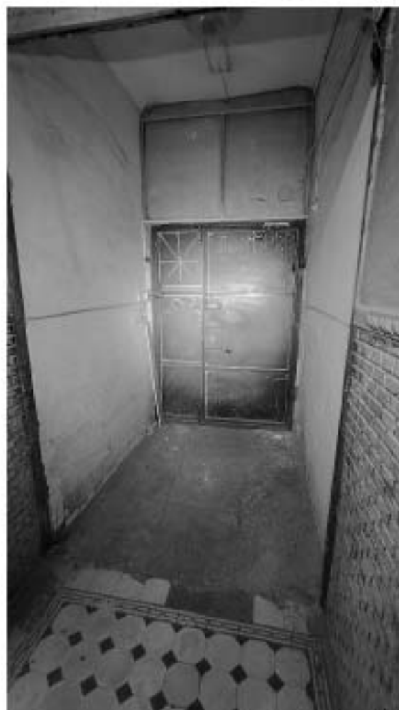
Фото 150. Современное дверное заполнение в уровне первого этажа. Общий вид. Дата фотофиксации: 18.03.25
