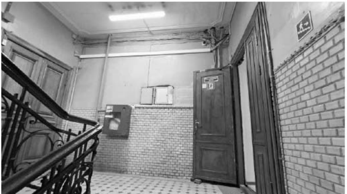
Фото 180. Площадка 4 этажа. Общий вид. Дата фотофиксации: 18.03.25
