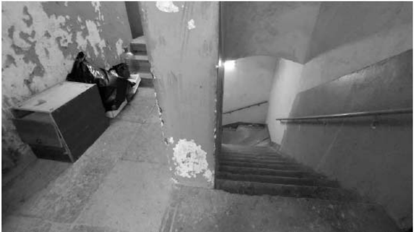
Фото 336. Срединная лестница ЛЗ с забежными ступенями в уровне 3-го этажа. Общий вид. Дата фотофиксации: 18.03.25
