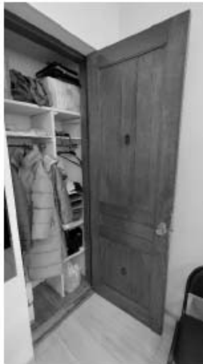
Фото 317. Историческое деревянное дверное заполнение в характере модерна в помещении 18 (21-Н). Общий вид. Дата фотофиксации: 18.03.25
