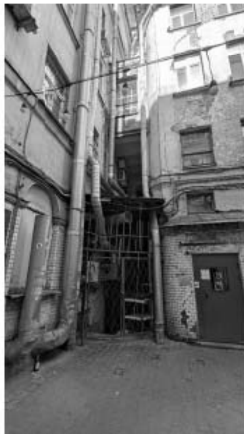
Фото 34. Карман дворового фасада северного флигеля. Общий вид. Дата фотофиксации: 14.08.25
