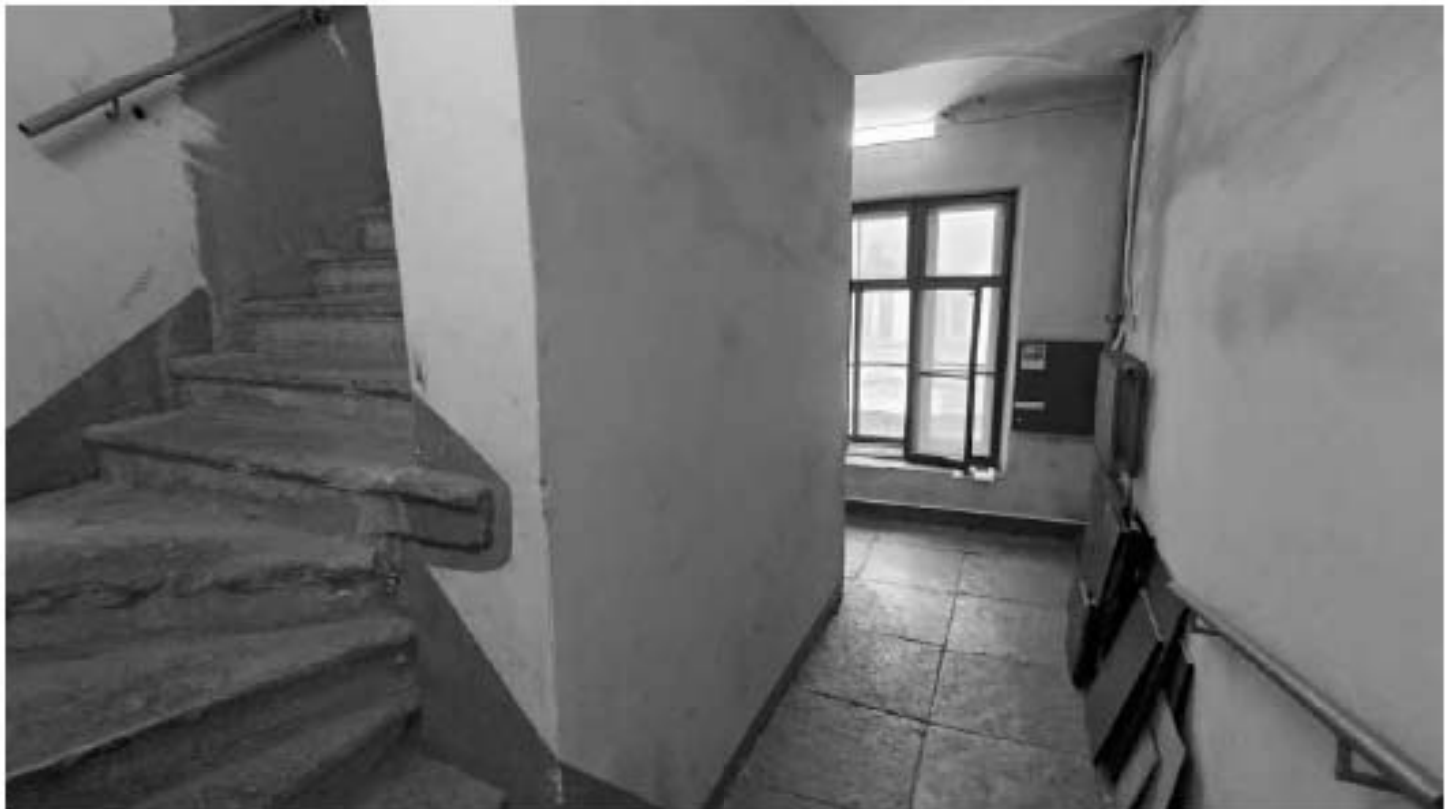
Фото 339. Забежные ступени в уровне 2-го этажа. Фрагмент. Дата фотофиксации: 18.03.25
