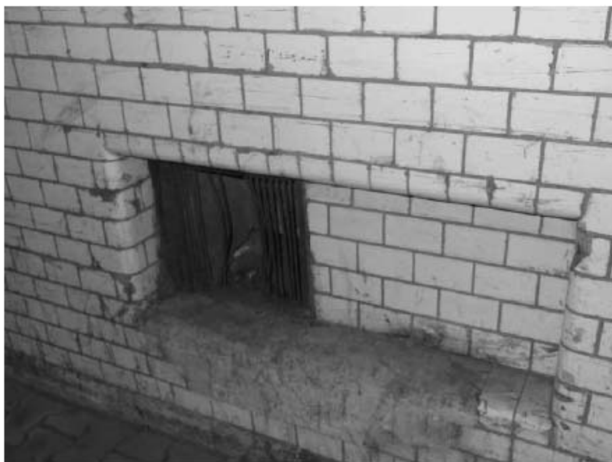
Фото 28. Вентиляционное отверстие воротного проезда. Общий вид. Дата фотофиксации: 18.03.25
