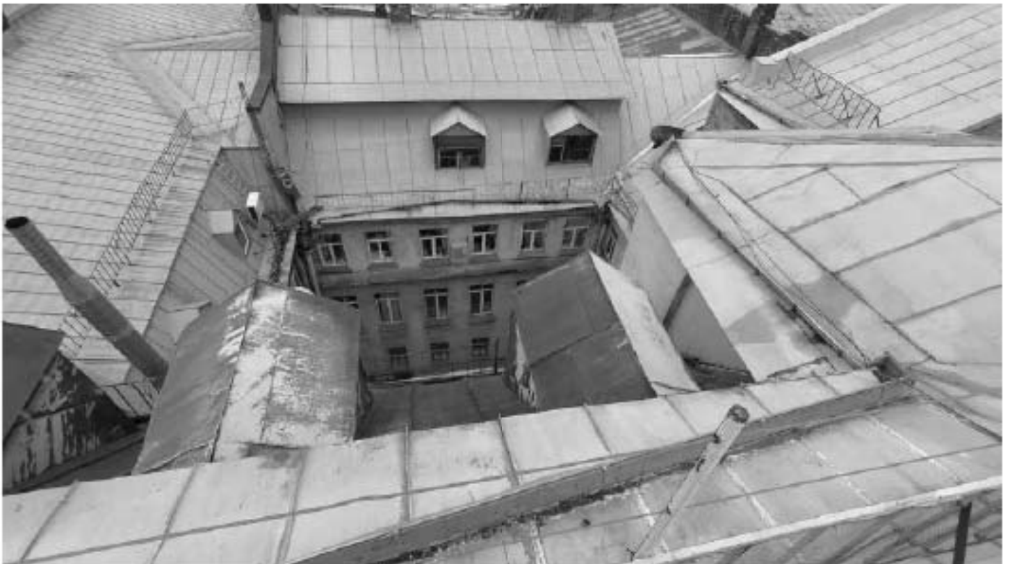
Фото 62. Мансардные объёмы поперечного и западного корпусов (флигелей). Фрагмент. Дата фотофиксации: 18.03.25
