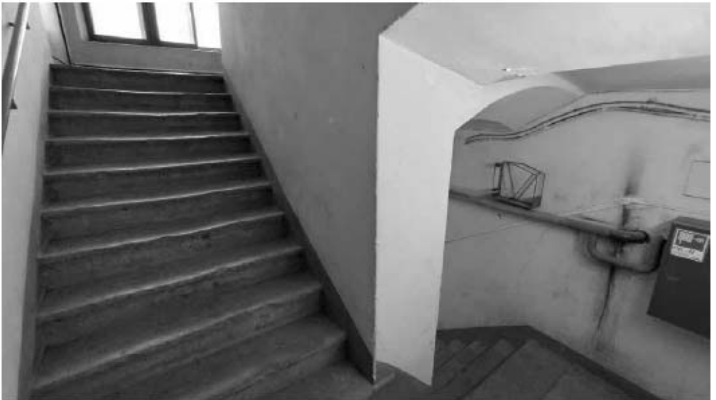
Фото 345. Межэтажное пространство 1-го и 2-го этажа лестницы ЛЗ. Фрагмент. Дата фотофиксации: 18.03.25
