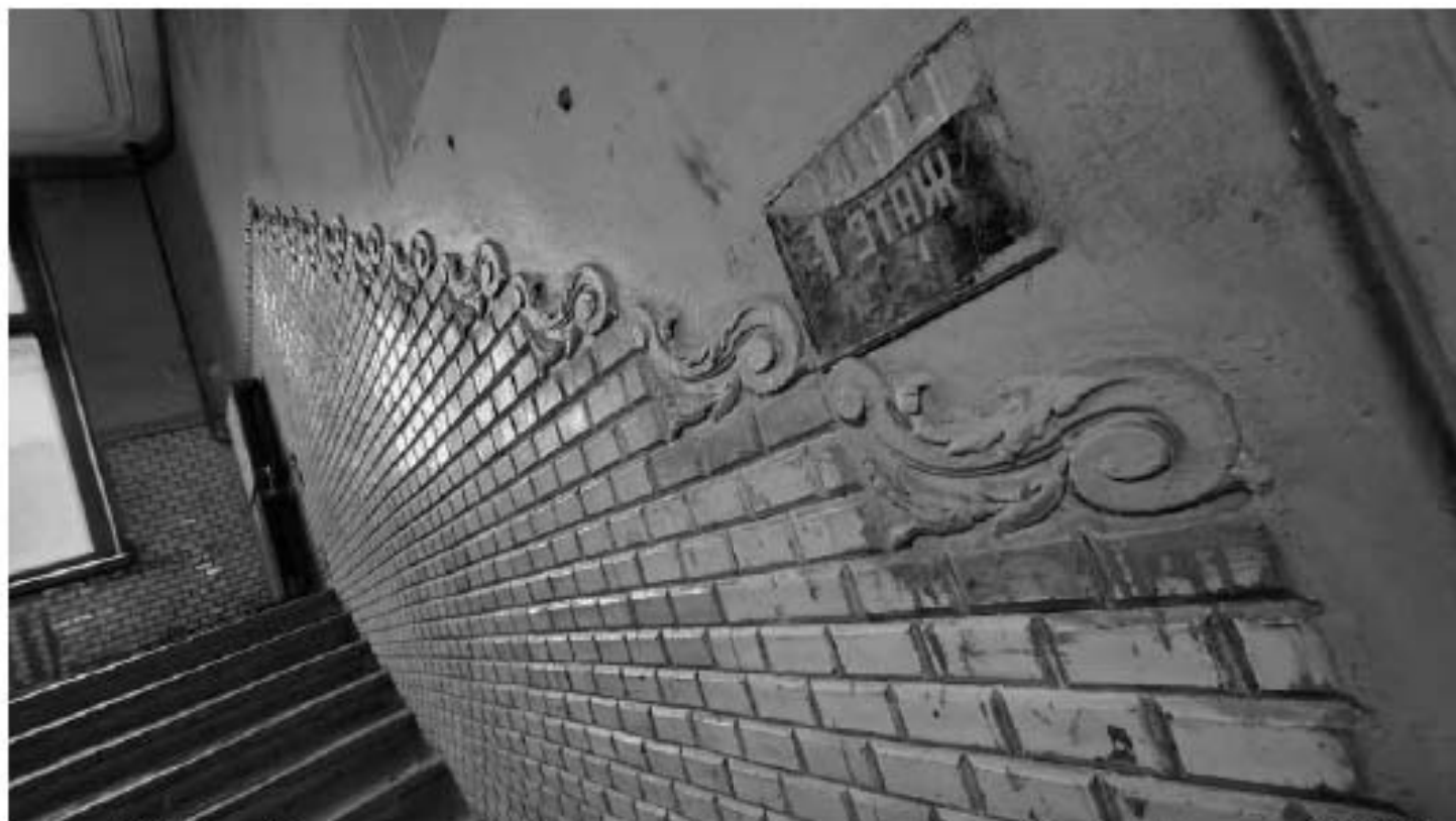
Фото 155. Лепной декор над плиткой в уровне 1-го этажа. Общий вид. Дата фотофиксации: 18.03.25
