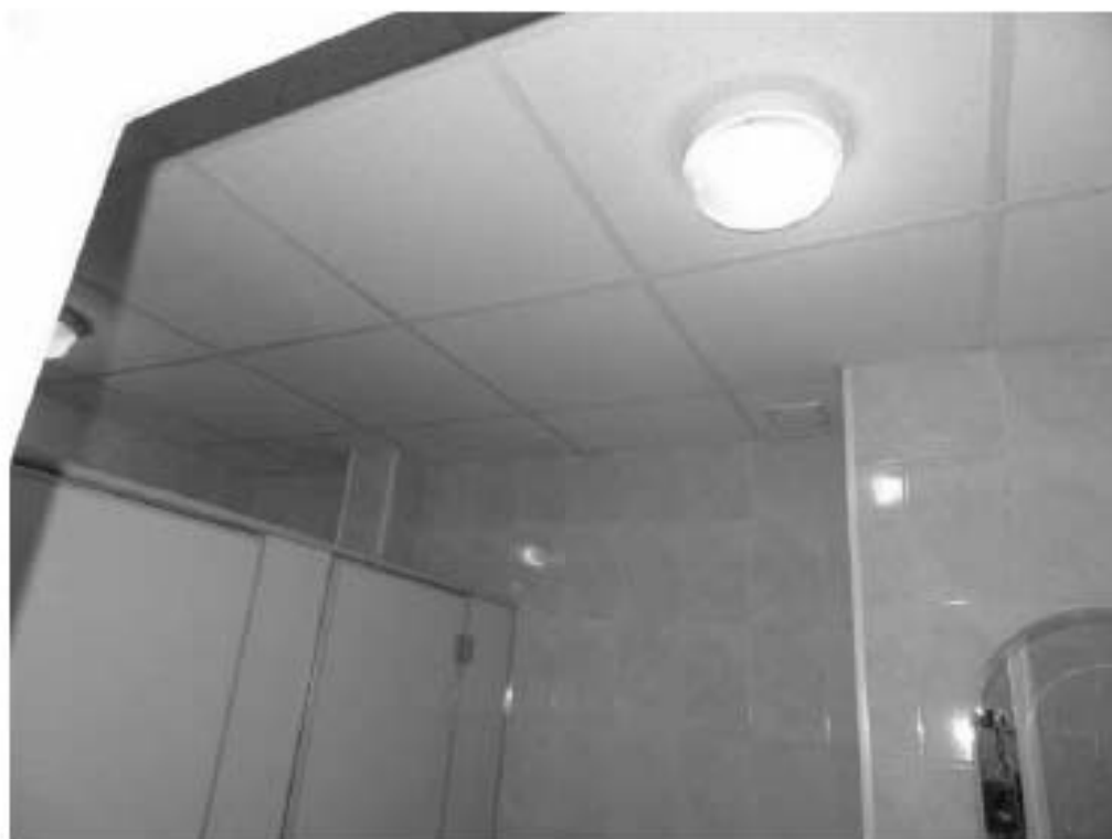
Фото 429. Пространство помещений 8, 7, 4 (16-Н). Фрагмент. Дата фотофиксации: 18.03.25
