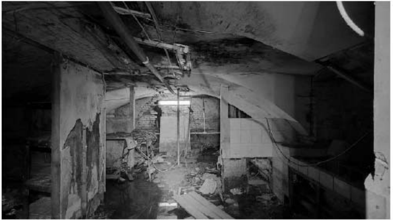
Фото 76. Пространство помещения 2. Цилиндрические с распалубками своды. Фрагмент. Дата фотофиксации: 18.03.25
