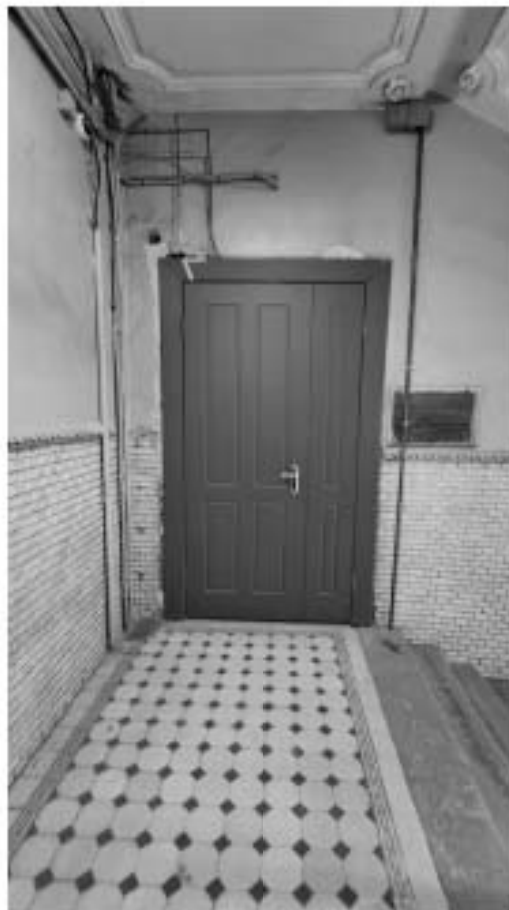
Фото 173. Современное дверное заполнение в уровне 3-го этажа. Общий вид. Дата фотофиксации: 18.03.25
