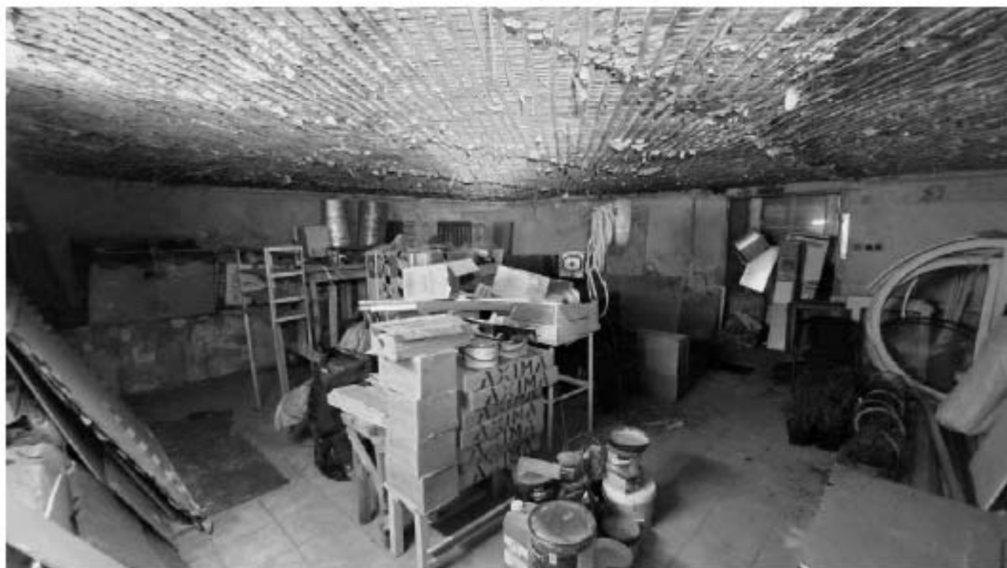
Фото 68. Помещение 3. Общий вид. Дата фотофиксации: 18.03.25
