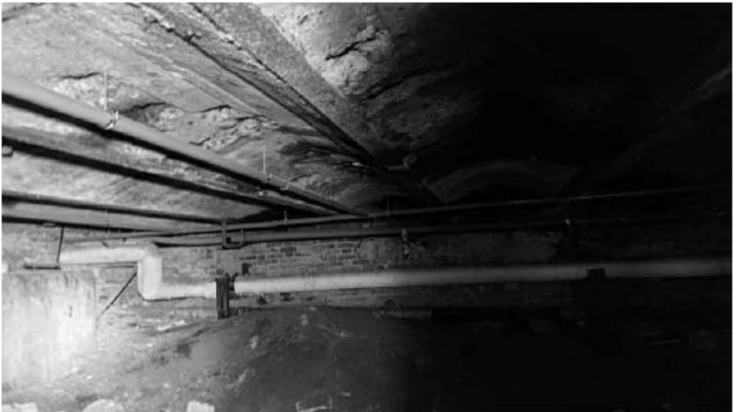
Фото 88. Помещение 1 (33-Н). Пруссские своды. Фрагмент. Дата фотофиксации: 14.08.25
