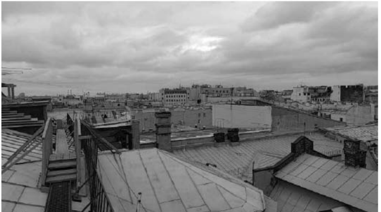
Фото 59. Скатная крыша северного корпуса (флигеля). Фрагмент. Дата фотофиксации: 18.03.25
