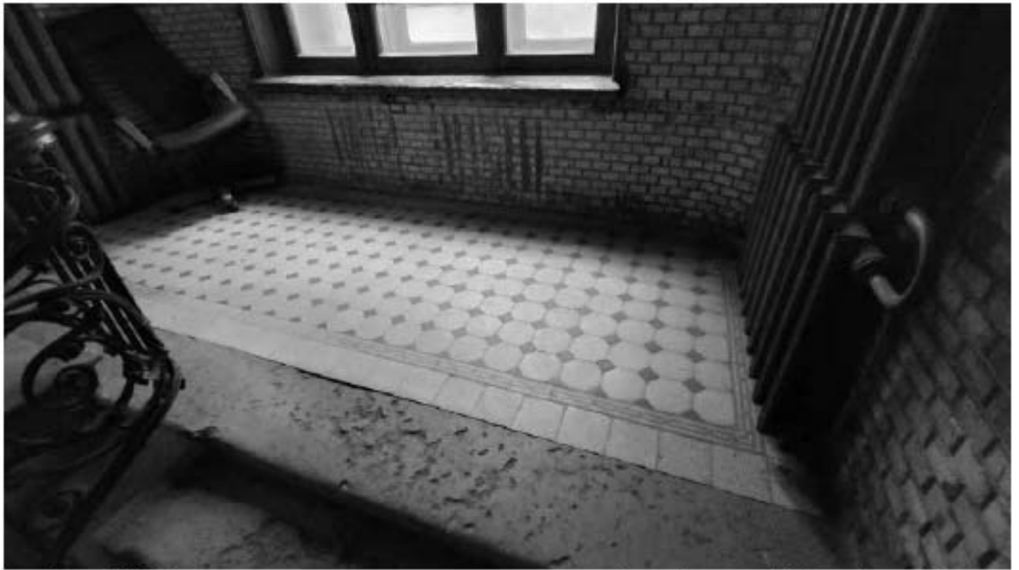
Фото 157. Метлахская плитка в межэтажном пространстве 1-го и 2-го этажей. Общий вид. Дата фотофиксации: 18.03.25
