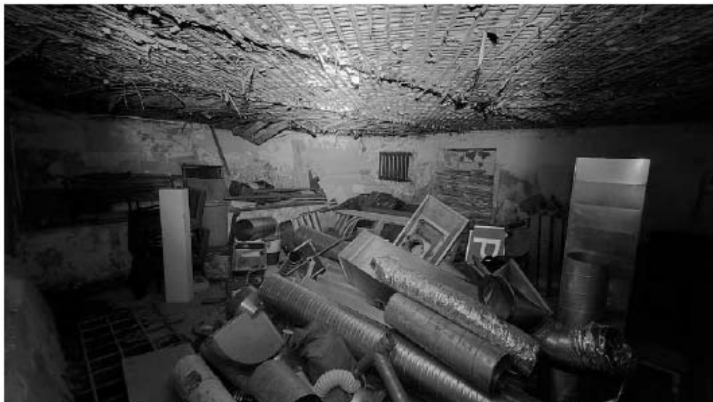
Фото 67. Помещение 2. Общий вид. Дата фотофиксации: 18.03.25
