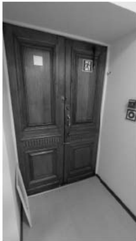
Фото 178. Историческое дверное заполнение в уровне 4-го этажа. Общий вид со стороны помещения 4 (22-Н). Дата фотофиксации: 18.03.25
