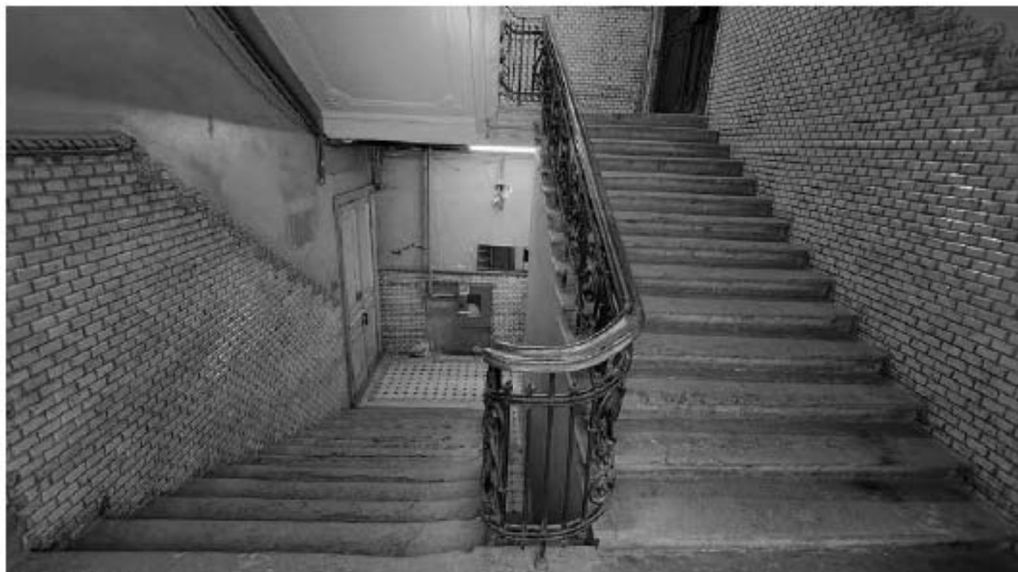
Фото 159. Двухмаршевая парадная лестница Л1. Общий вид со стороны межлестничного пространства 1-го и 2-го этажей. Дата фотофиксации: 18.03.25
