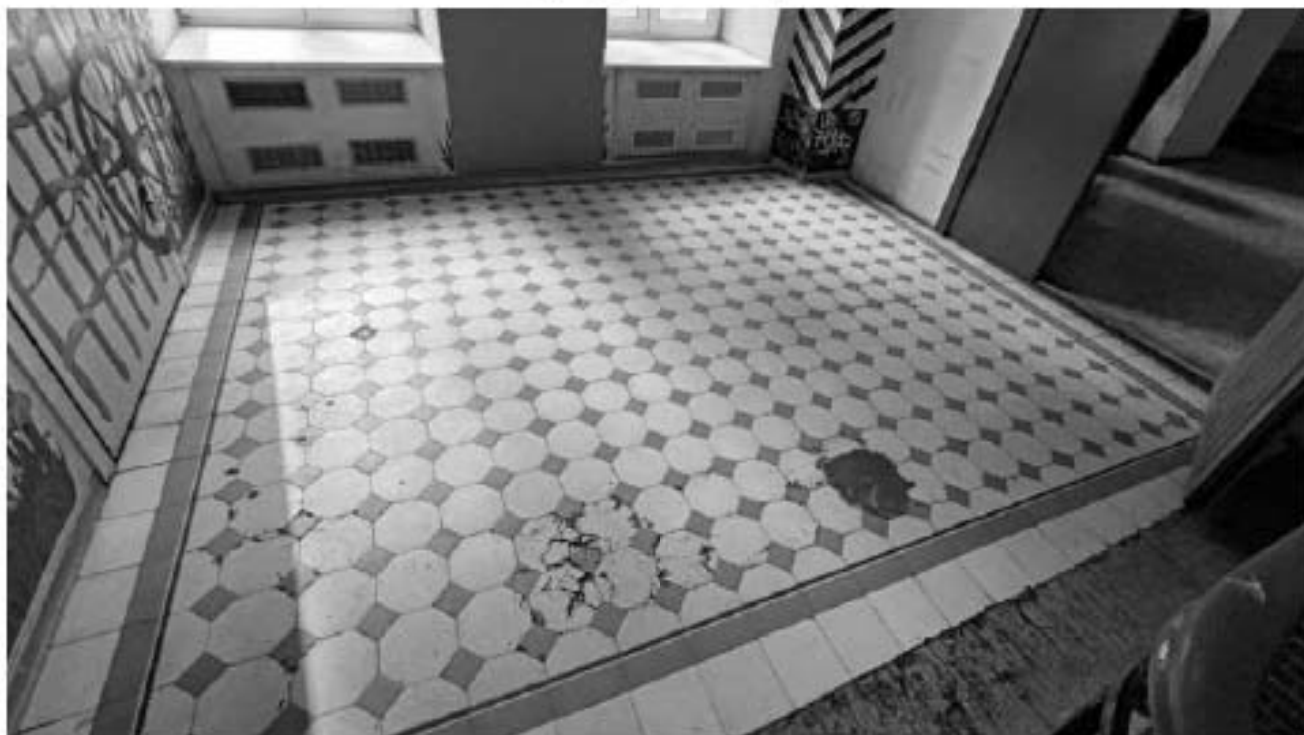
Фото 381. Площадка 3-го этажа лестницы Л5 – метлахская плитка. Общий вид. Дата фотофиксации: 18.03.25
