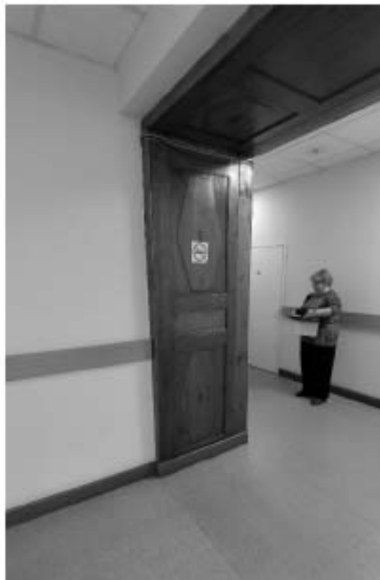
Фото 291. Оформление проема деревянными филенчатыми панелями с усеченными ромбами в филенках с овальной розеткой по центру в технике маркетри. Фрагмент. Дата фотофиксации: 18.03.25
