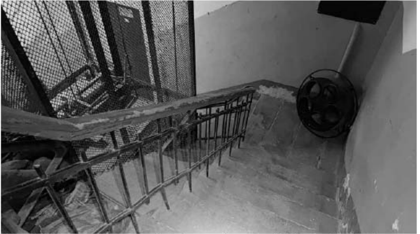
Фото 487. Межэтажное пространство 2-го и 1-го этажей лестницы Л4. Фрагмент. Дата фотофиксации: 18.03.25
