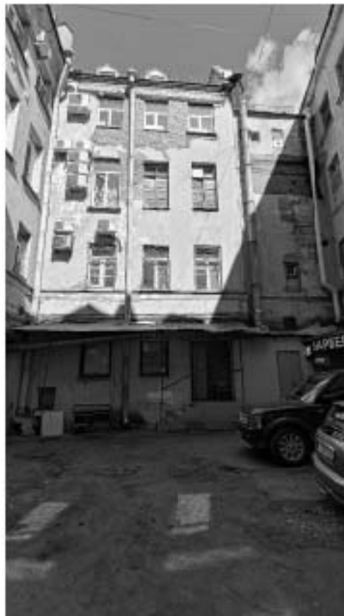
Фото 47. Северный фасад. Общий вид со стороны объёма дворового фасада восточного флигеля. Дата фотофиксации: 14.08.25
