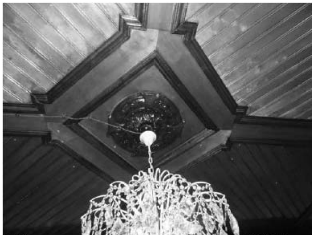
Фото 416. Центральная часть деревянной отделки в помещении 10 (16-Н). Фрагмент. Дата фотофиксации: 18.03.25
