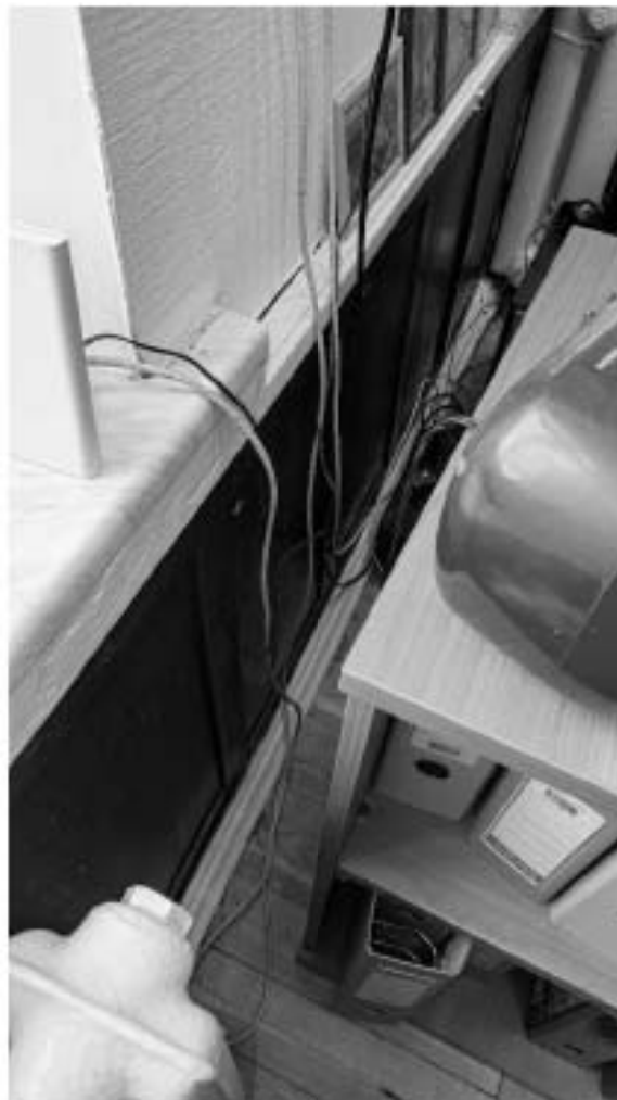
Фото 301. Деревянные панели на стенах радиаторов в помещении 17. Фрагмент. Дата фотофиксации: 18.03.25
