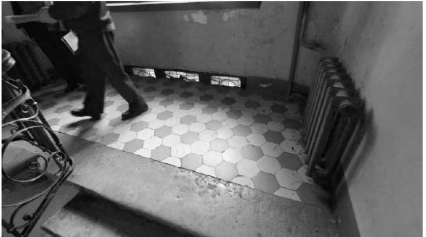
Фото 181. Метлахская плитка в межэтажном пространстве 4-го и 5-го этажей. Общий вид. Дата фотофиксации: 18.03.25
