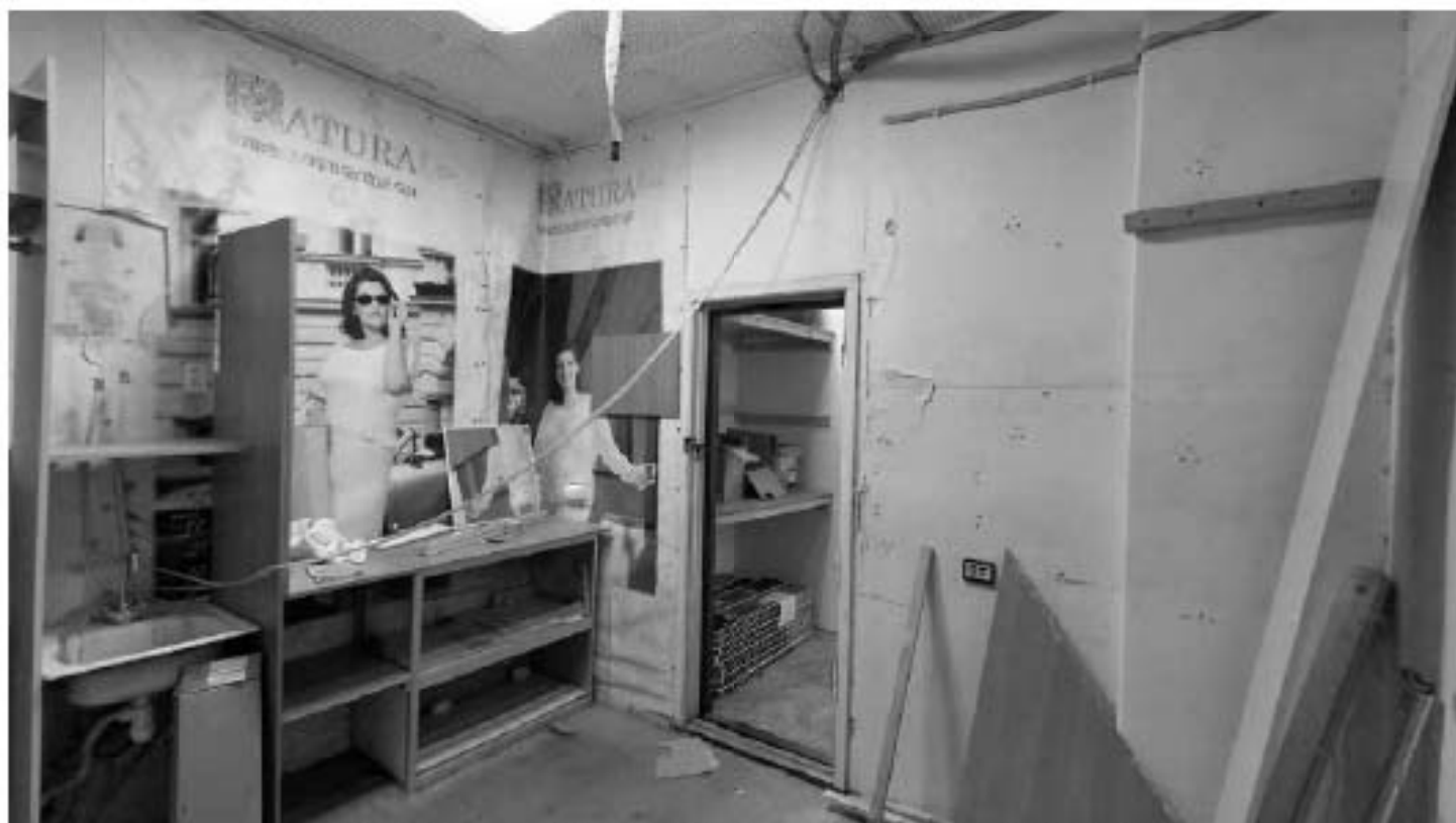
Фото 97. Помещение 3. Общий вид. Дата фотофиксации: 18.03.25
