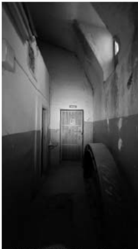
Фото 525. Помещение 8 (41-Н). Общий вид. Дата фотофиксации: 18.03.25
