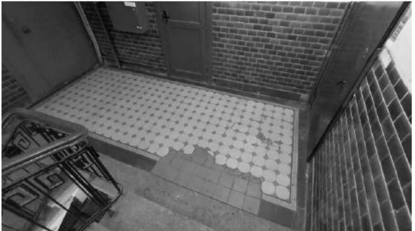
Фото 389. Площадка 2-го этажа лестницы Л5. Метлахская плитка. Общий вид. Дата фотофиксации: 18.03.25
