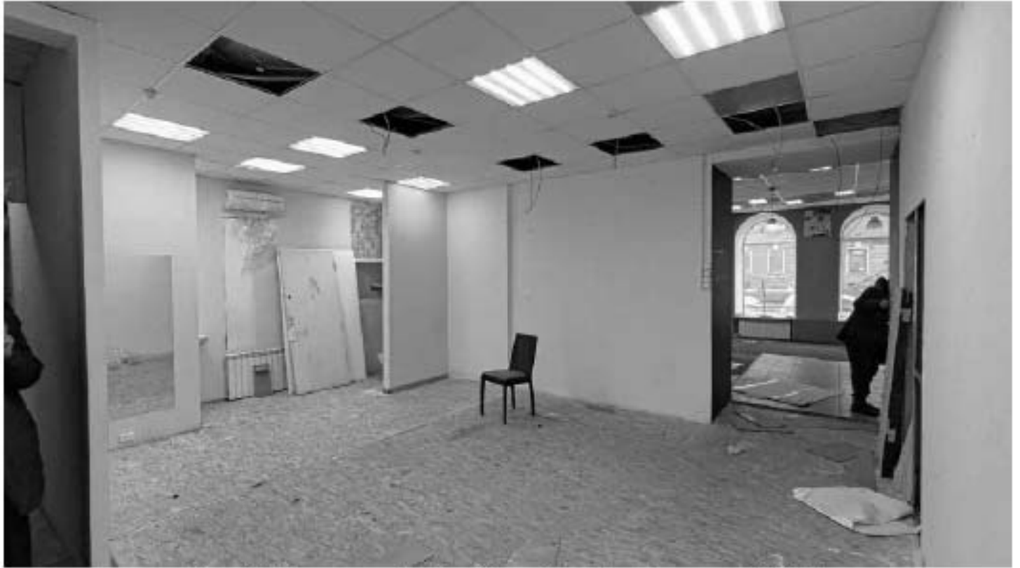
Фото 92. Помещение 2. Общий вид. Дата фотофиксации: 18.03.25
