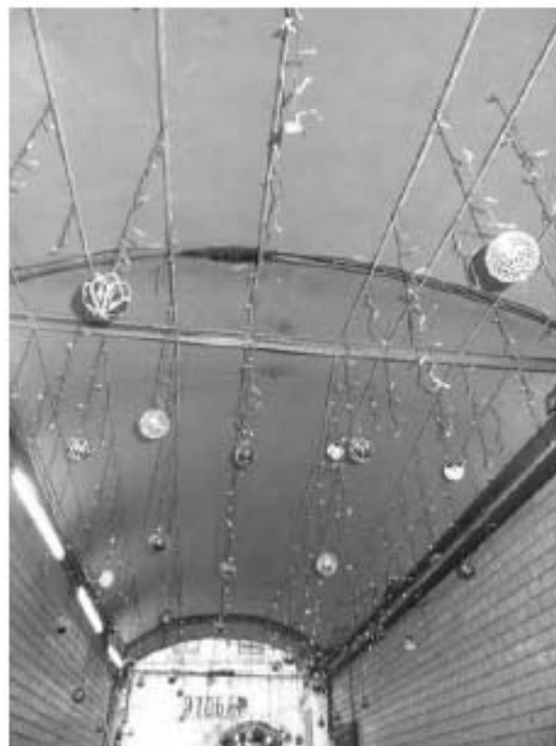
Фото 26. Цилиндрический свод воротного проезда западного флигеля. Общий вид. Дата фотофиксации: 18.03.25
