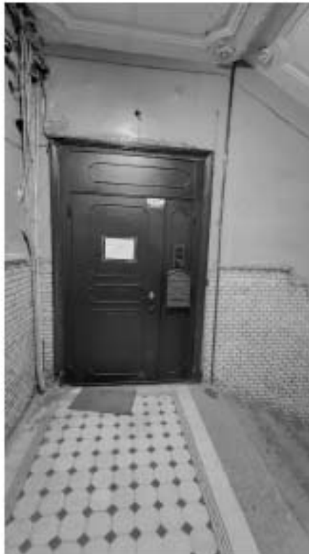
Фото 165. Современное дверное заполнение в уровне 2-го этажа. Общий вид. Дата фотофиксации: 18.03.25
