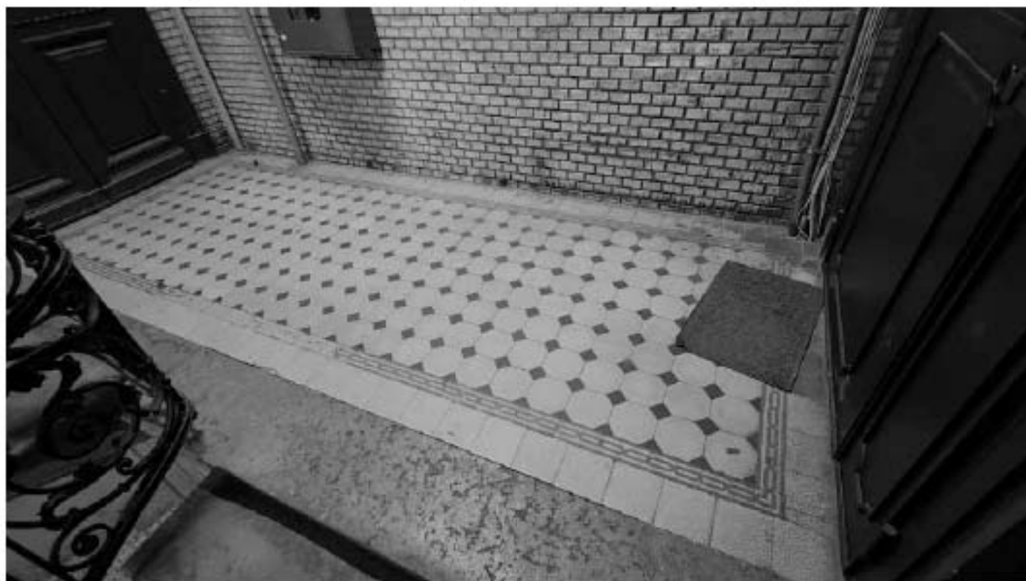
Фото 162. Метлахская плитка на площадке 2-го этажа. Общий вид. Дата фотофиксации: 18.03.25
