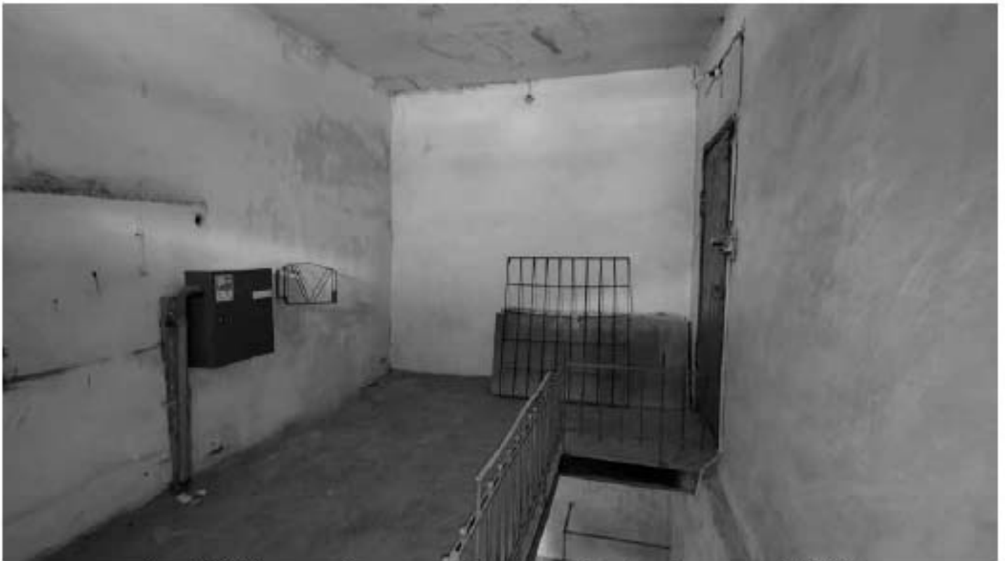
Фото 353. Площадка 5-го этажа. Общий вид. Дата фотофиксации: 18.03.25
