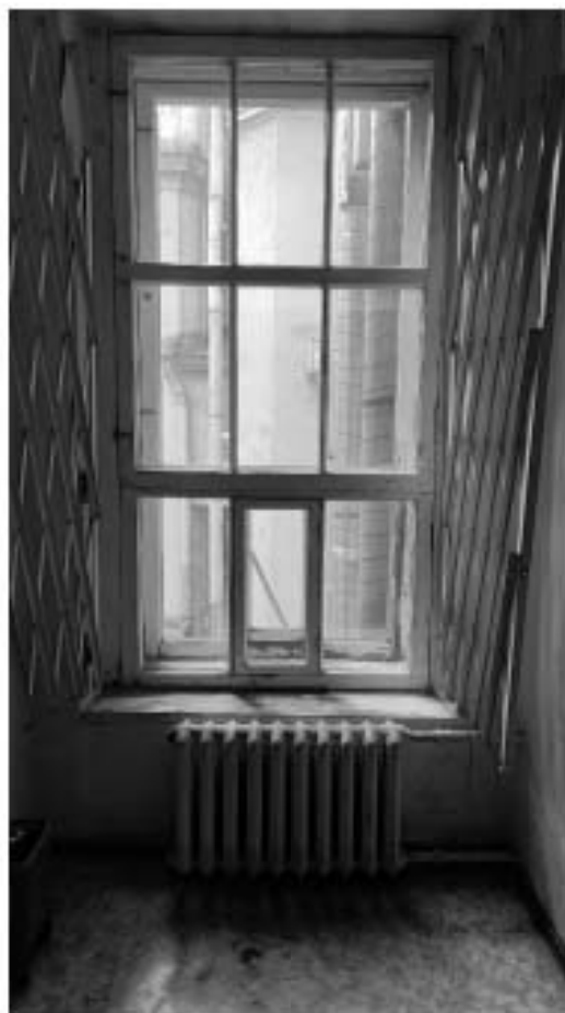
Фото 311. Оконное заполнение в помещении 29. Общий вид. Дата фотофиксации: 18.03.25
