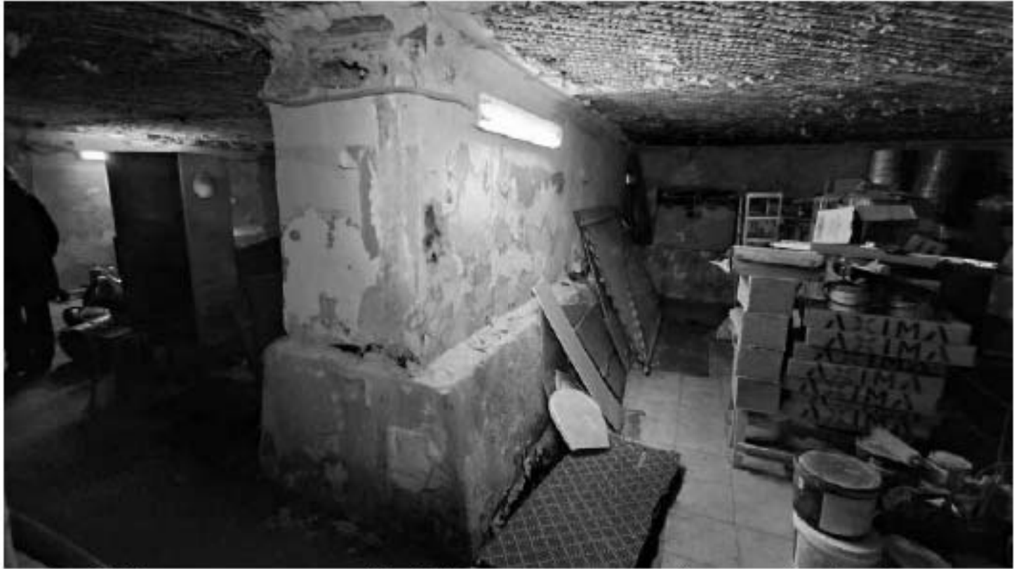
Фото 71. Пространство помещений 2 и 3. Несущие опоры цоколя. Фрагмент. Дата фотофиксации: 18.03.25
