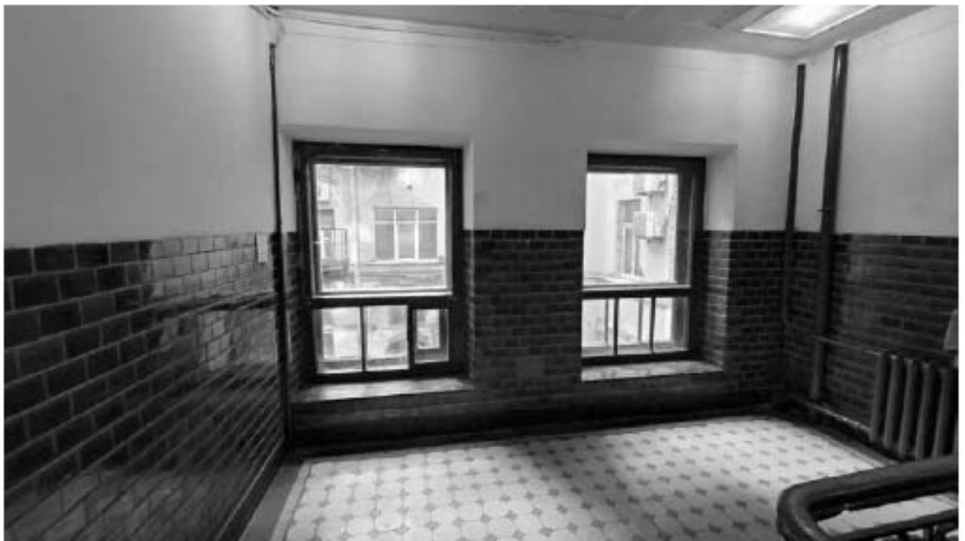
Фото 388. Оконные заполнения на площадке межэтажного пространства 2-го и 3-го этажей лестницы Л5. Общий вид. Дата фотофиксации: 18.03.25
