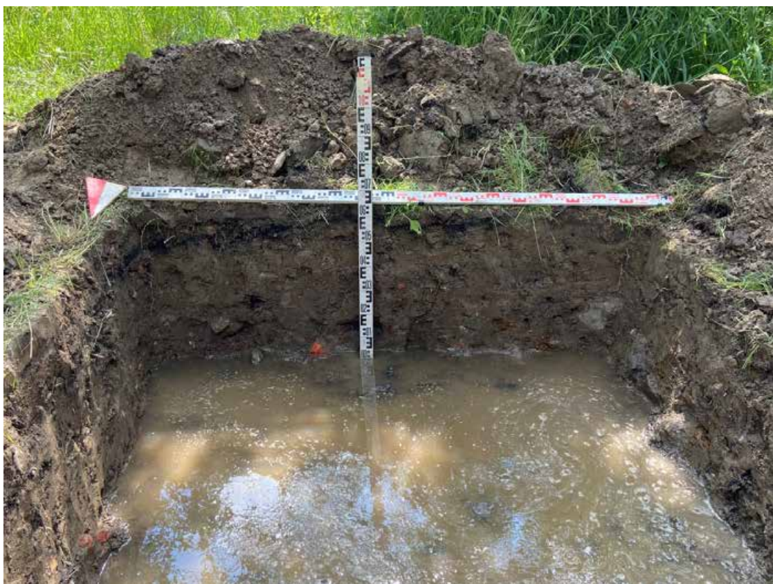
Рис. 46. Санкт-Петербург, Ленинский проспект, дом 80, литера А» (кадастровый номер: 78:40:0008391:14307). Шурф №1. Южная стенка. Вид с севера.
