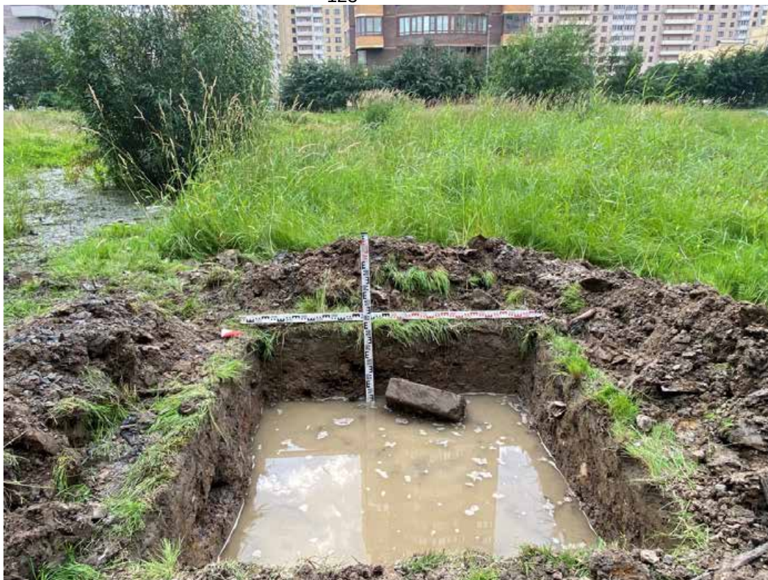
Рис. 53. Санкт-Петербург, Ленинский проспект, дом 80, литера А» (кадастровый номер: 78:40:0008391:14307). Шурф №2. Зачистка дна шурфа на уровне стояния грунтовых вод по слою строительного мусора. Вид с севера.
