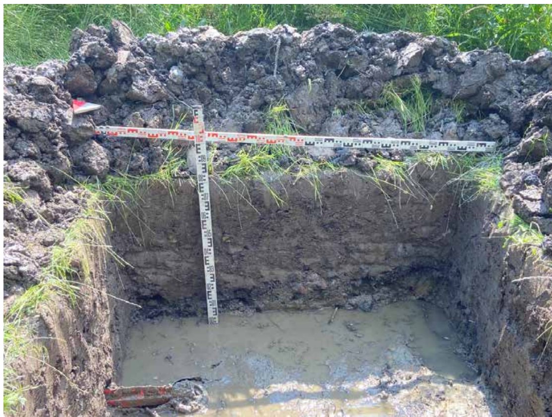
Рис. 66. Санкт-Петербург, Ленинский проспект, дом 80, литера А» (кадастровый номер: 78:40:0008391:14307). Шурф №3. Южная стенка. Вид с севера.
