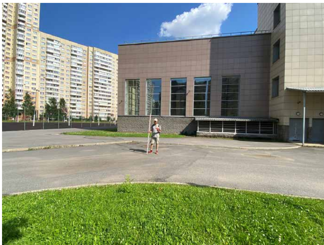
Рис. 24. Санкт-Петербург, Ленинский проспект, дом 80, литера А» (кадастровый номер: 78:40:0008391:14307). Photo 3. Общий вид территории обследования. Вид с запада.
