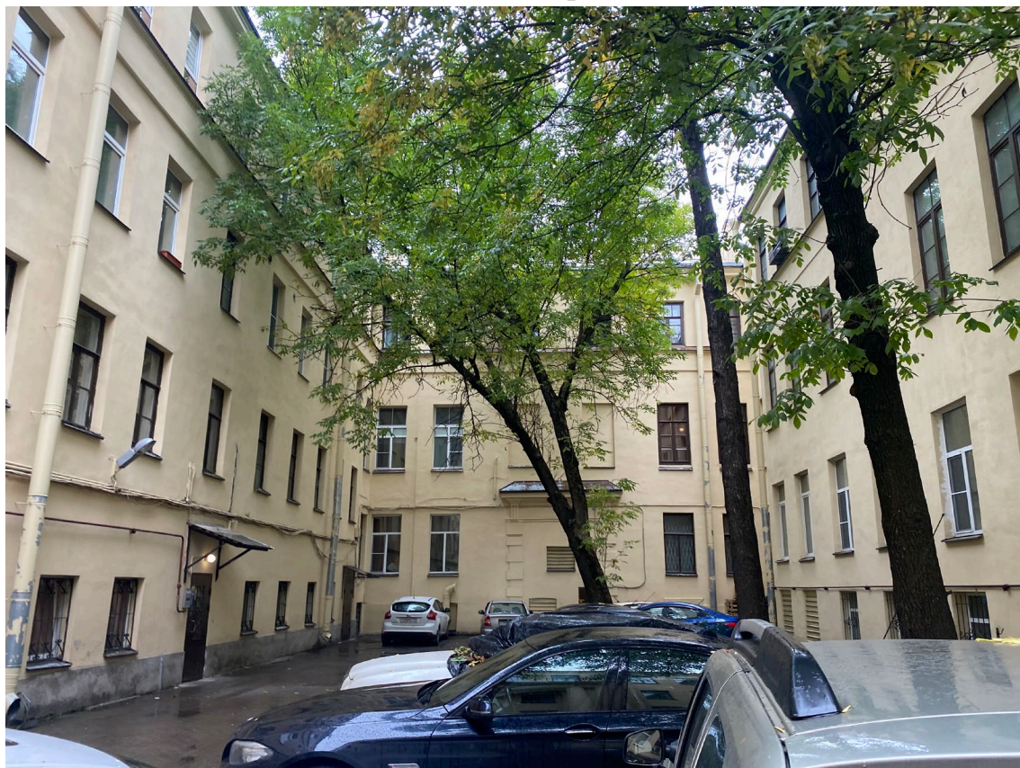
2. Вид на дворовые фасады
