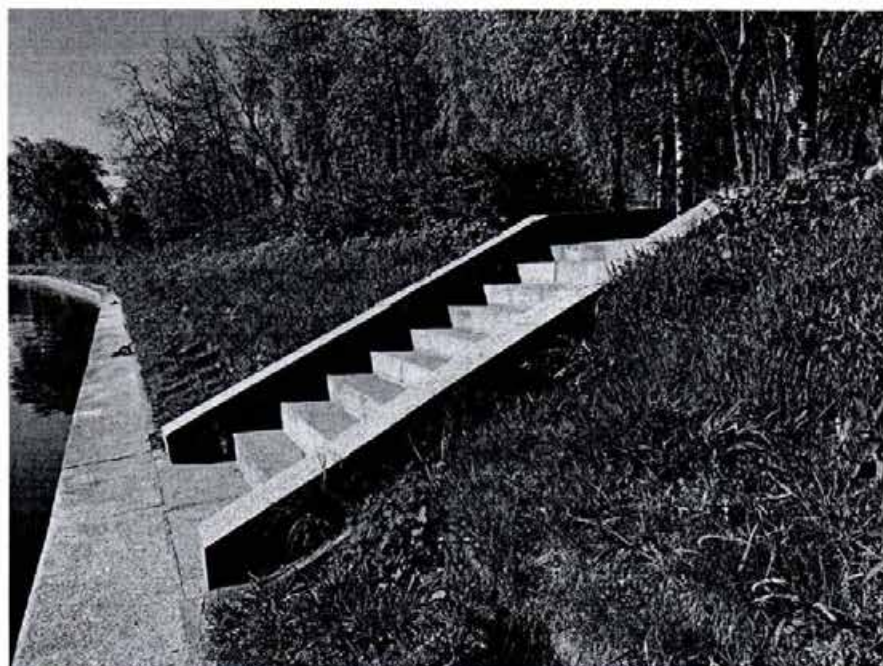
21. Фрагмент гранитного спуска и банкета с северной стороны объекта культурного наследия.
