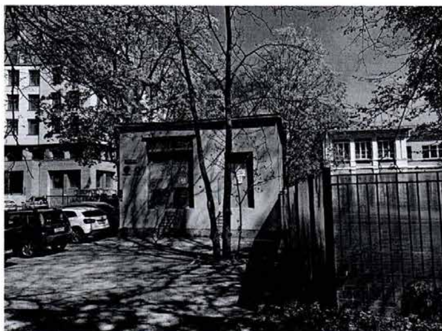
27. Здание трансформаторной подстанции электросети с кадастровым номером 78:3152Д:2:1, расположенное западной стороне по адресу: г. Санкт-Петербург, Петровский проспект, дом 12а, литера Т.
