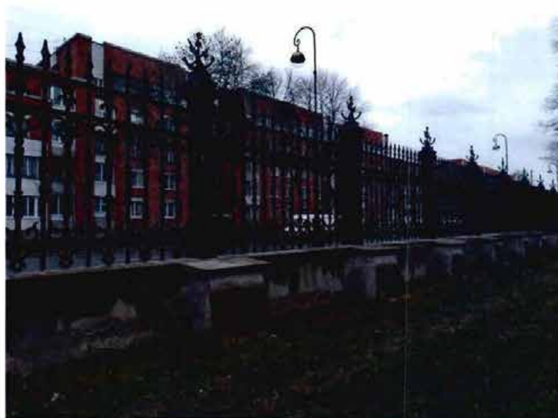
2. Фрагмент ограды. Вид со стороны сада.
