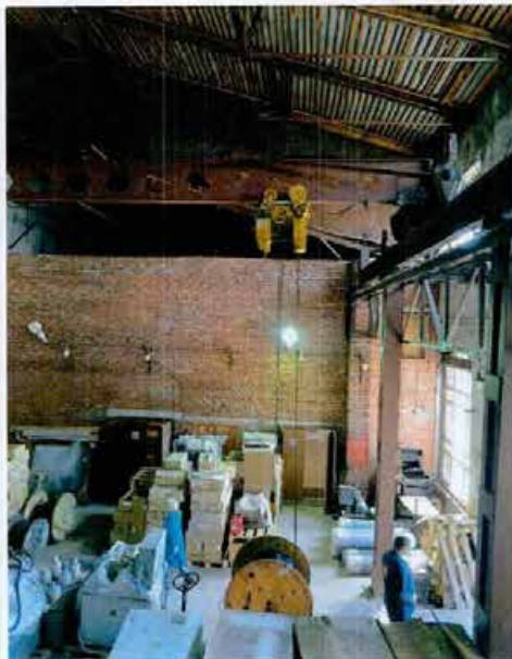
7. Помещение машинного зала объекта культурного наследия.
