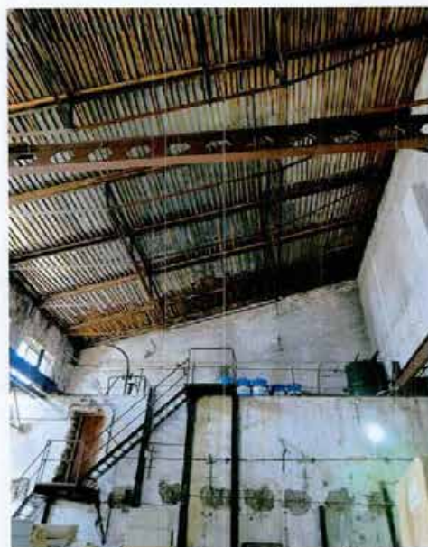
8. Помещение машинного зала объекта культурного наследия.
