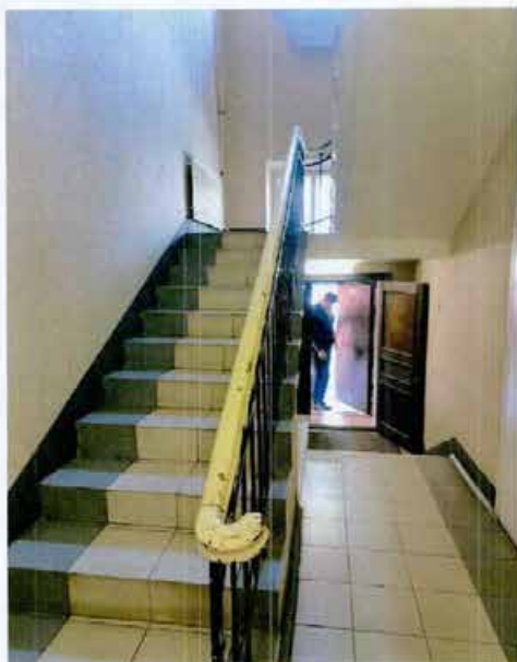
6. Помещение лестничной клетки объекта культурного наследия.
