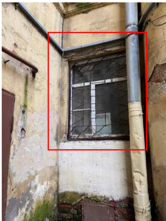
Фото 6. Вид на оконное заполнение со стороны двора.
