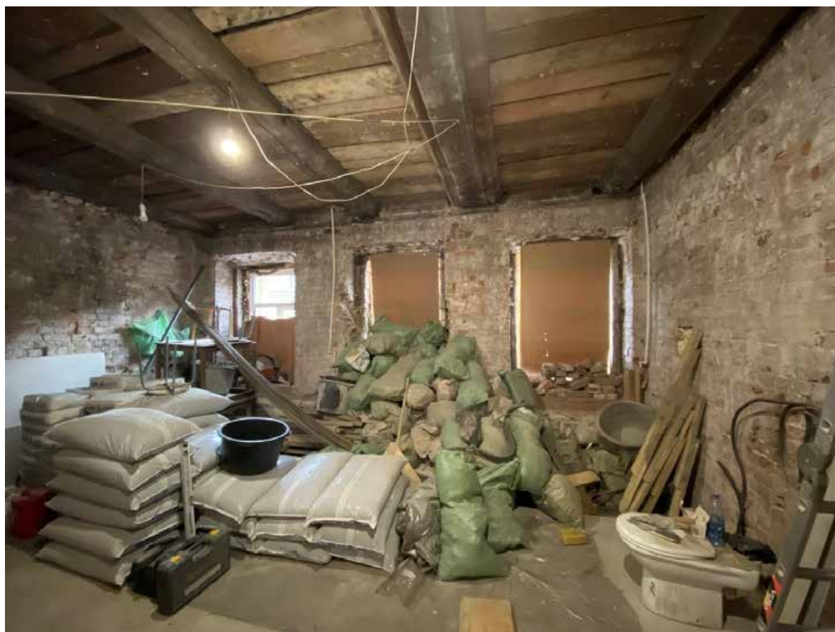
Фото 6. Вид на помещение № 1.
