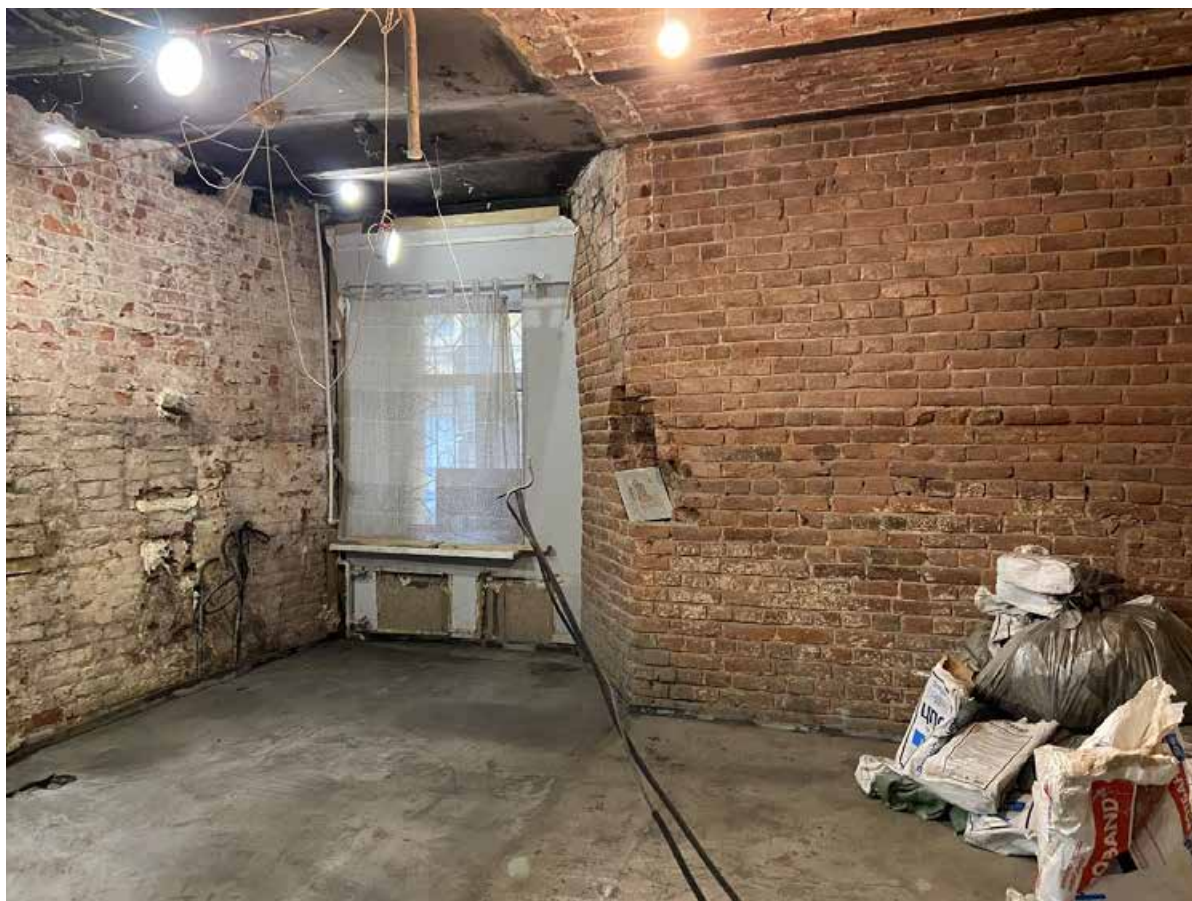
Фото 3. Вид на помещение № 2.
