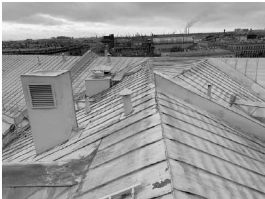
Фото 5. Вид на крышу объекта культурного наследия федерального значения «Гостиница «Астория»
