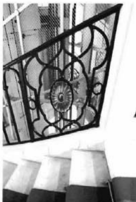
33. Фрагмент перильного ограждения лестницы.
