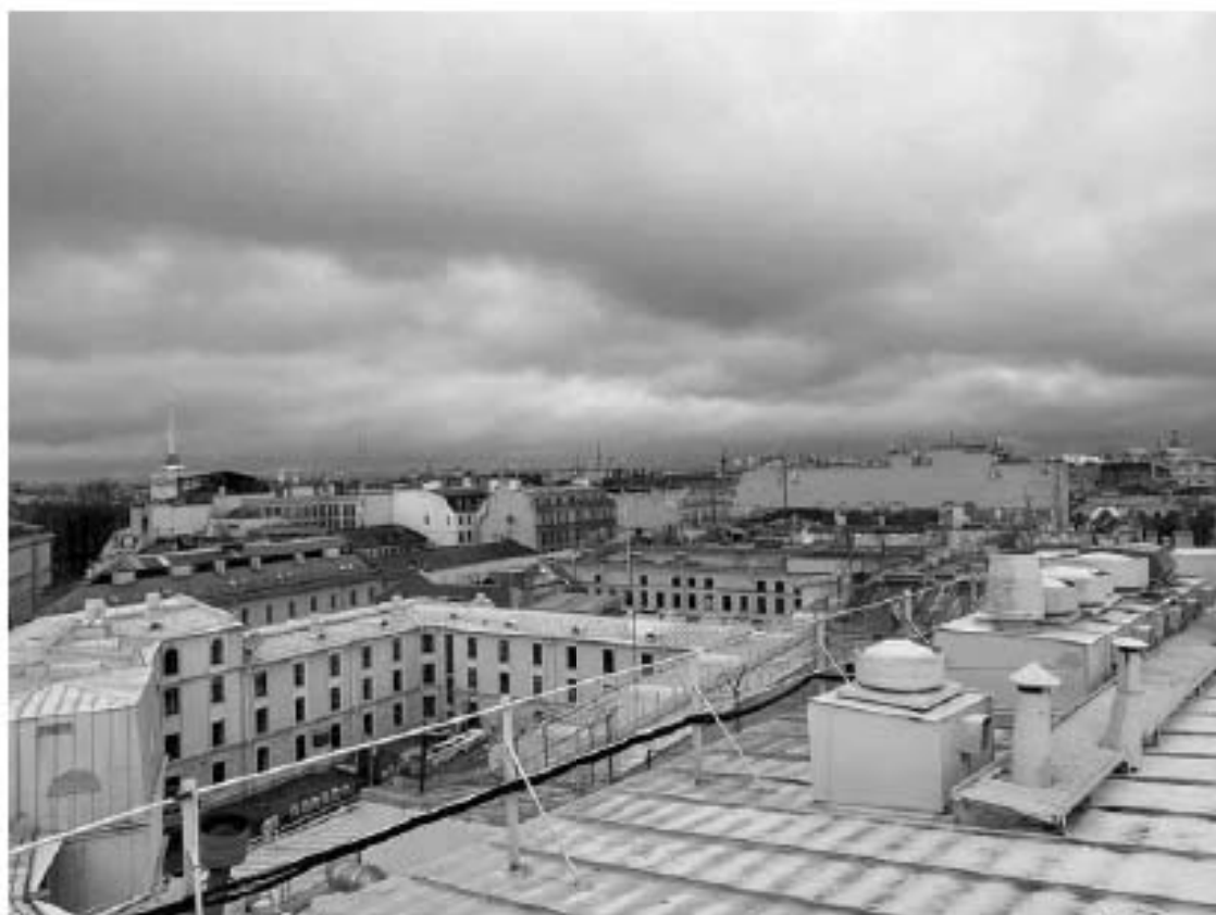
Фото 6. Вид на крышу объекта культурного наследия федерального значения «Гостиница «Астория»
