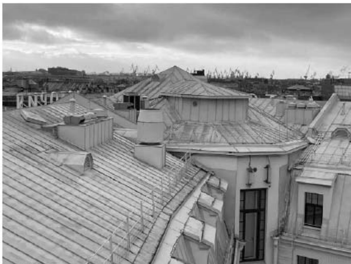
Фото 4. Вид на крышу объекта культурного наследия федерального значения «Гостиница «Астория»
