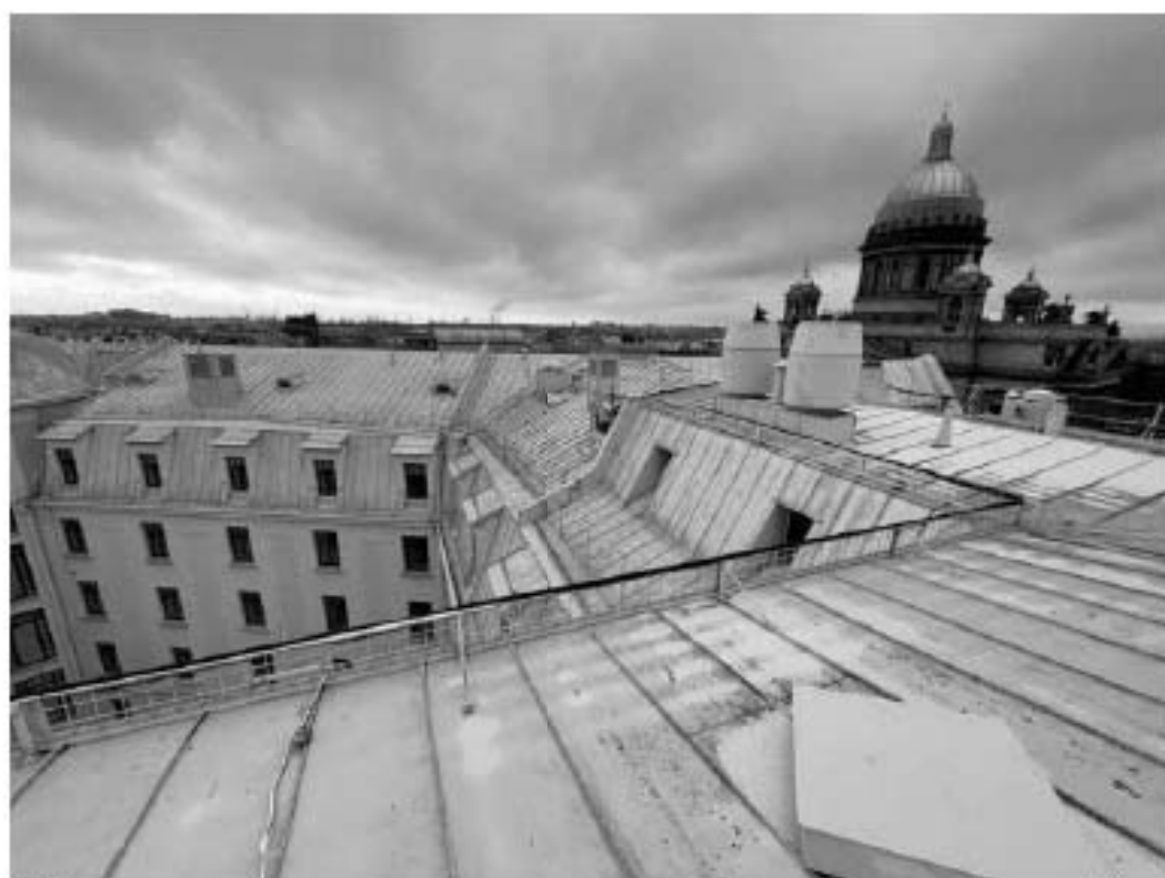
Фото 2. Вид на крышу объекта культурного наследия федерального значения «Гостиница «Астория»
