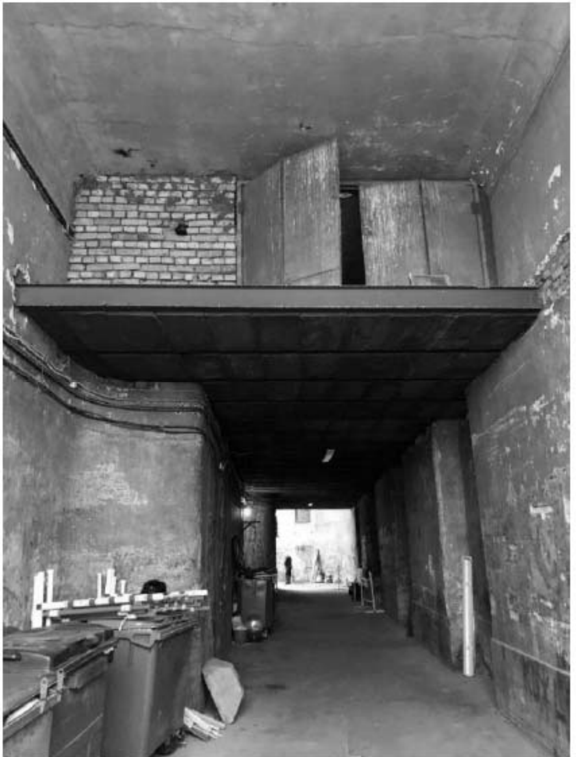
18. «Особняк Безобразовой». Санкт-Петербург, Моховая ул., 34, литера А (Моховая ул., 34). Воротный проезд лицевого корпуса. Фото: 26.10.2021.
