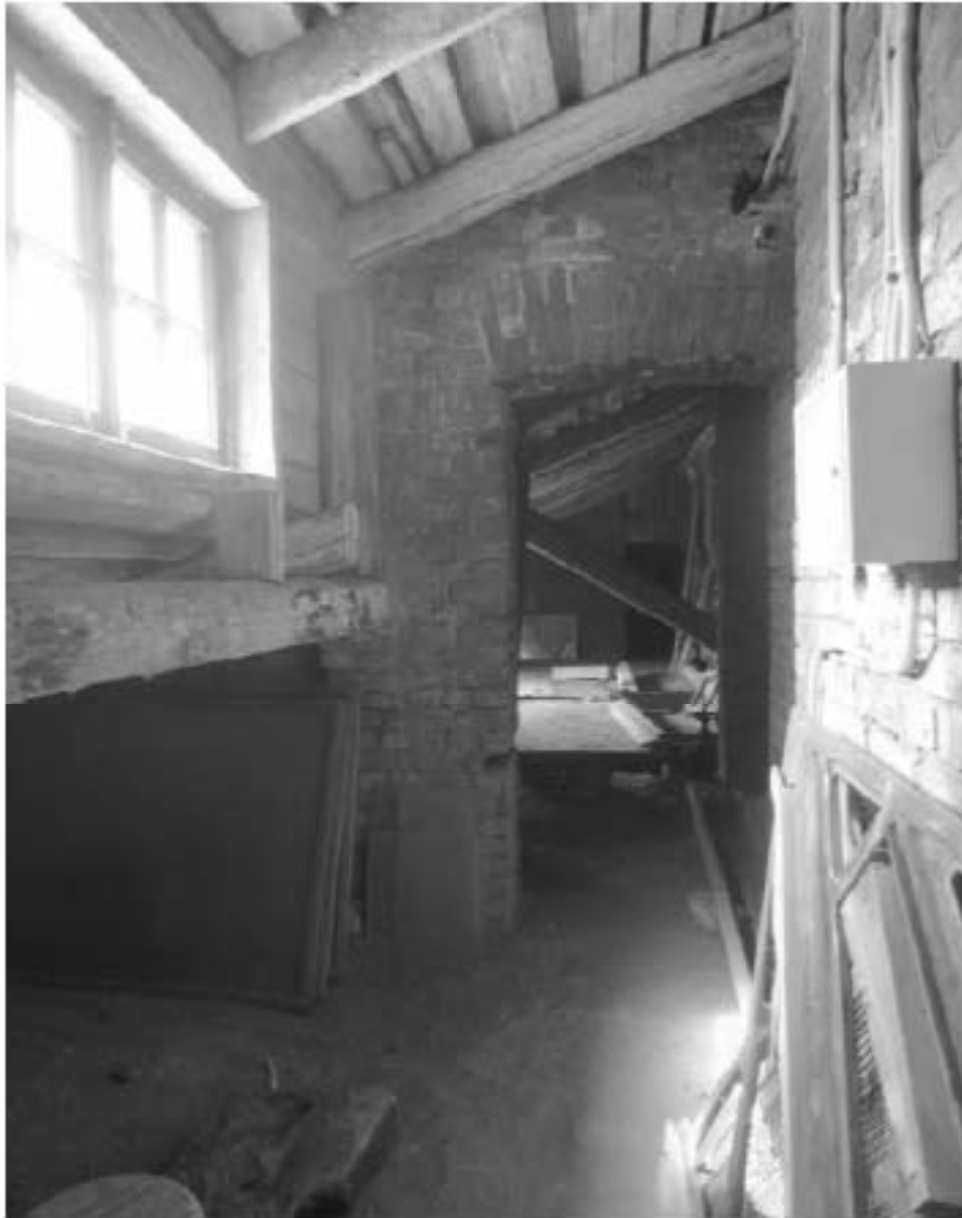
182. «Особняк Безобразовой». Санкт-Петербург, Моховая ул., 34, литера А (Моховая ул., 34). Фрагмент чердачного помещения. Фото: 26.10.2021.
