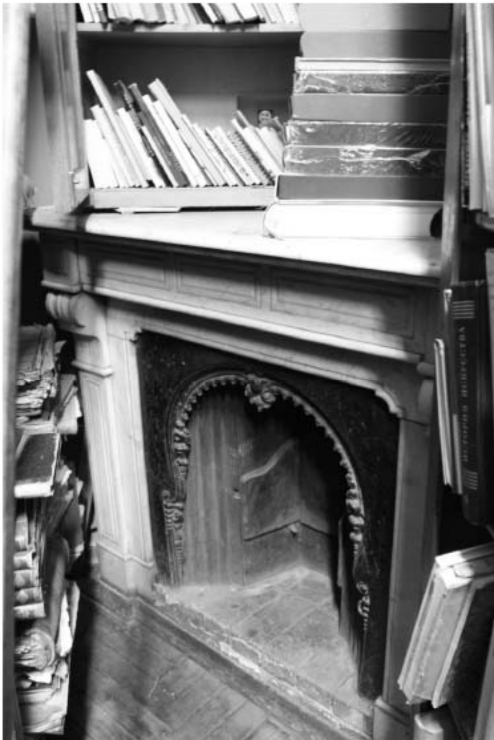
83. «Особняк Безобразовой». Санкт-Петербург, Моховая ул., 34, литера А (Моховая ул., 34). Лицевой корпус. 2-й этаж. Фрагмент помещения 19-Н(4). Фото: 26.10.2021.
