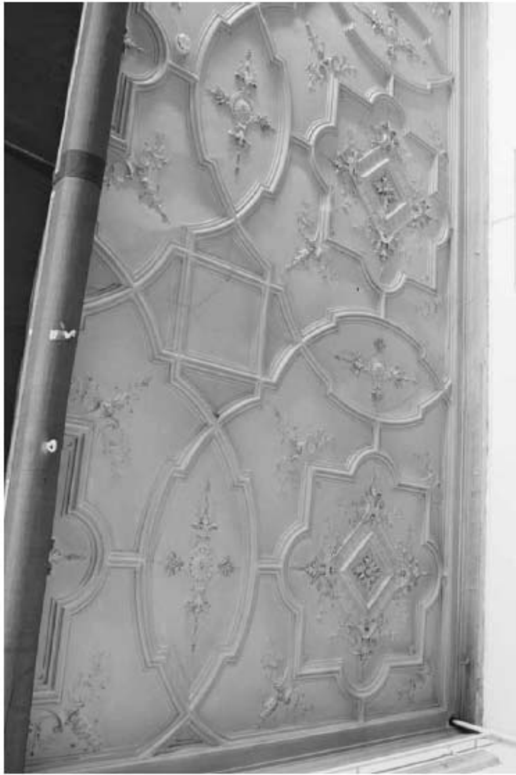
92. «Особняк Безобразовой». Санкт-Петербург, Моховая ул., 34, литера А (Моховая ул., 34). Дворовый корпус. 2-й этаж. Фрагмент помещения 19-Н(14). Фото: 26.10.2021.
