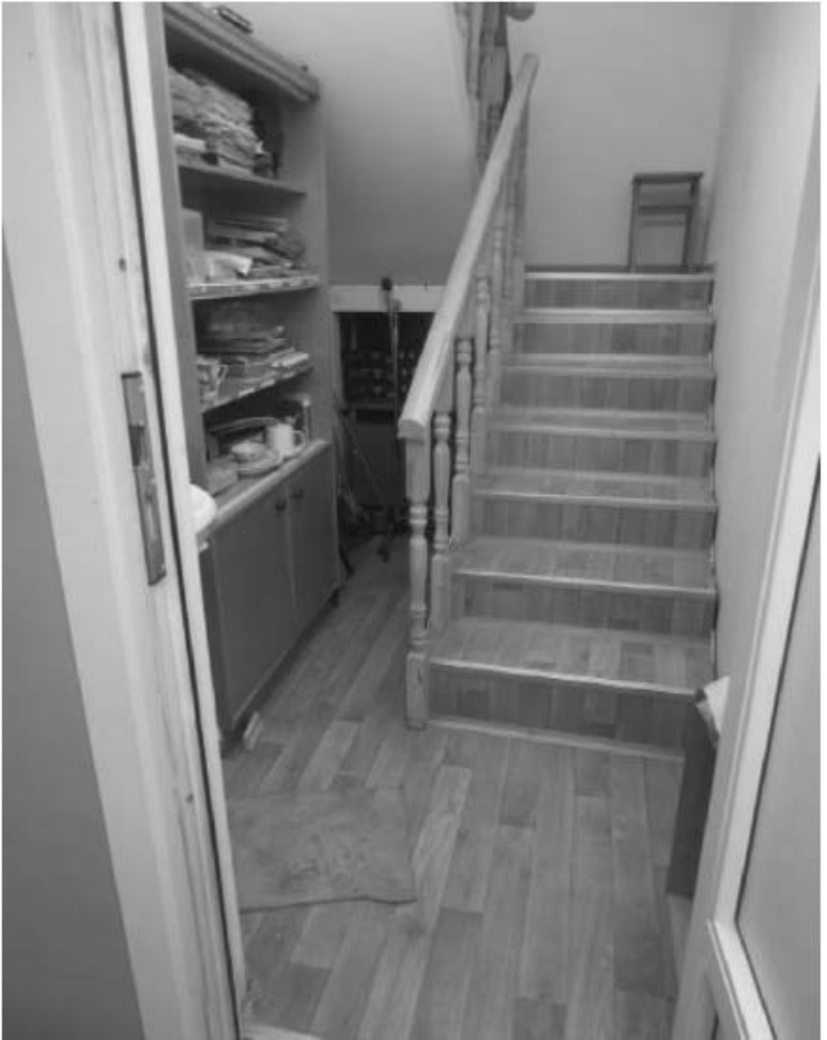
161. «Особняк Безобразовой». Санкт-Петербург, Моховая ул., 34, литера А (Моховая ул., 34). Дворовый корпус. 5-й этаж. Фрагмент помещения 26-Н(2). Фото: 26.10.2021.
