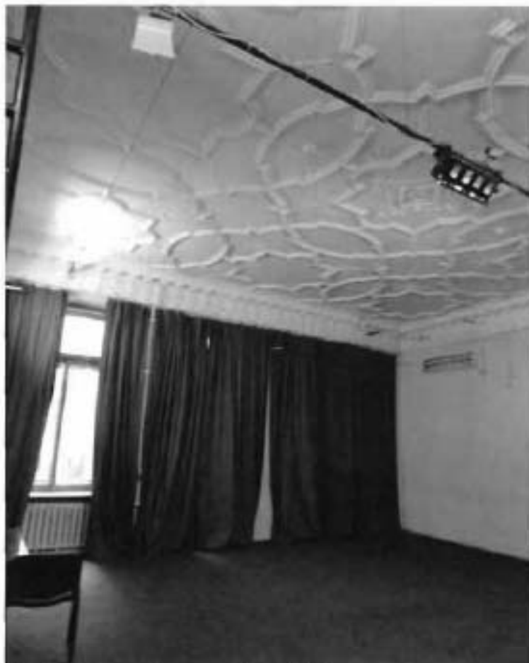
8. Помещение 1 этажа (10-Н(20)).
