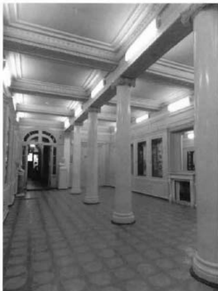
6. Помещение 1 этажа (10-Н(1)).
