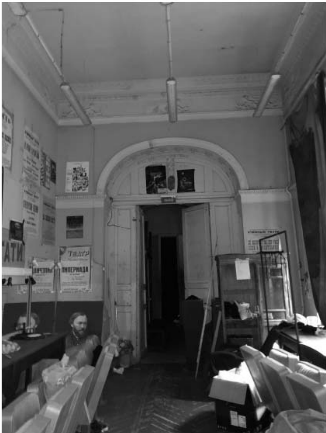
88. «Особняк Безобразовой». Санкт-Петербург, Моховая ул., 34, литера А (Моховая ул., 34). Лицевой корпус. 2-й этаж. Фрагмент помещения 19-Н(17). Фото: 26.10.2021.
