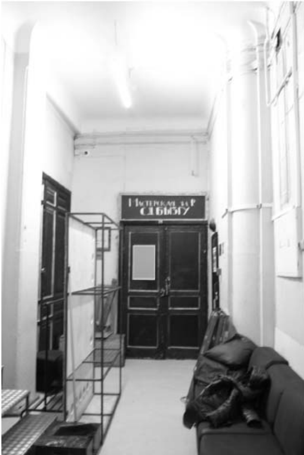
127. «Особняк Безобразовой». Санкт-Петербург, Моховая ул., 34, литера А (Моховая ул., 34). Лицевой корпус. 3-й этаж. Фрагмент помещения 21-Н(3). Фото: 26.10.2021.
