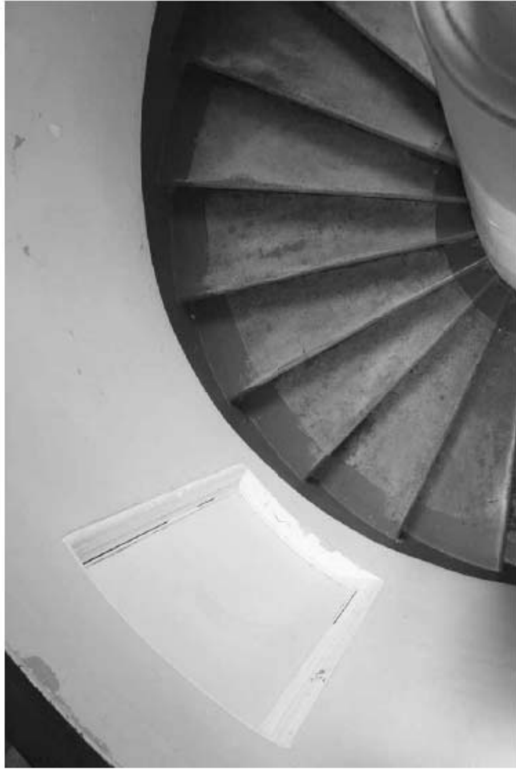
18. «Особняк Безобразовой». Санкт-Петербург, Моховая ул., 34, литера А (Моховая ул., 34). Дворовой корпус. Винтовая лестница в северной части здания. Фото: 26.10.2021.
