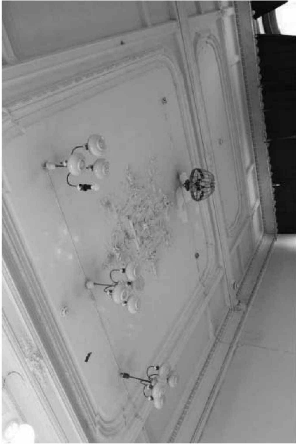
28. «Особняк Безобразовой». Санкт-Петербург, Моховая ул., 34, литера А (Моховая ул., 34). Лицевой корпус. 1-й этаж. Фрагмент помещения 10-Н(2). Фото: 26.10.2021.
