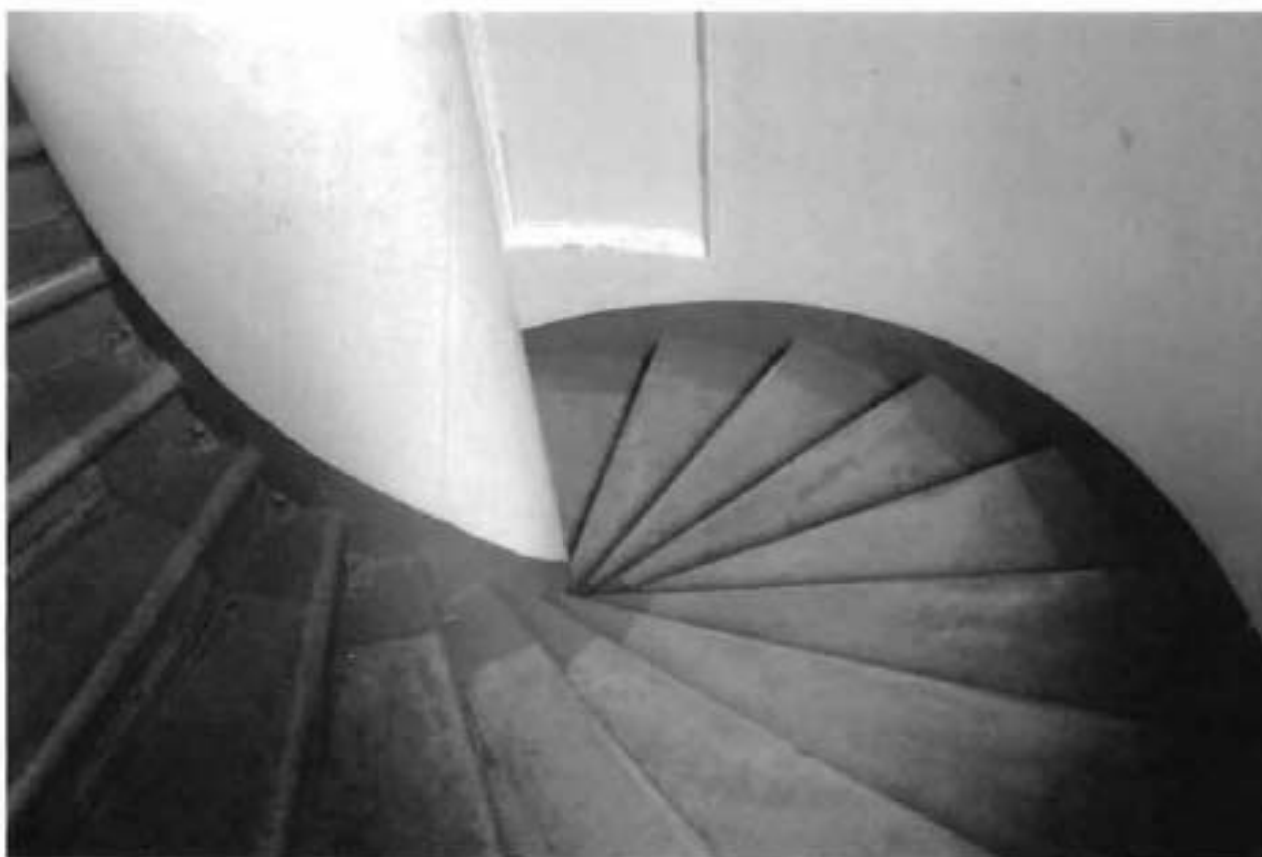
18. Винтовая лестница в северной части здания.
