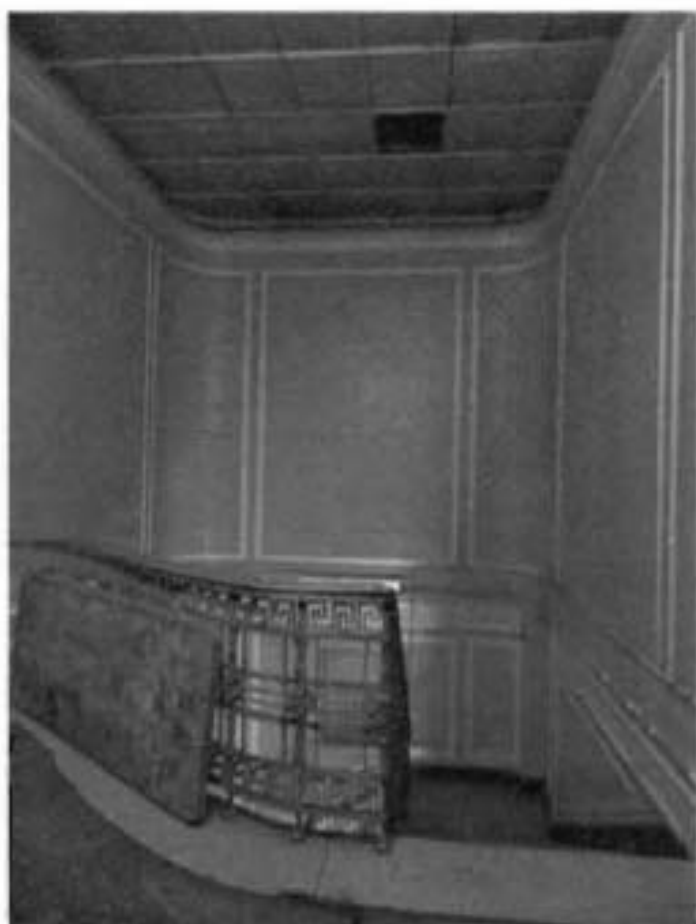
20. Лестница в северо-западной части здания
