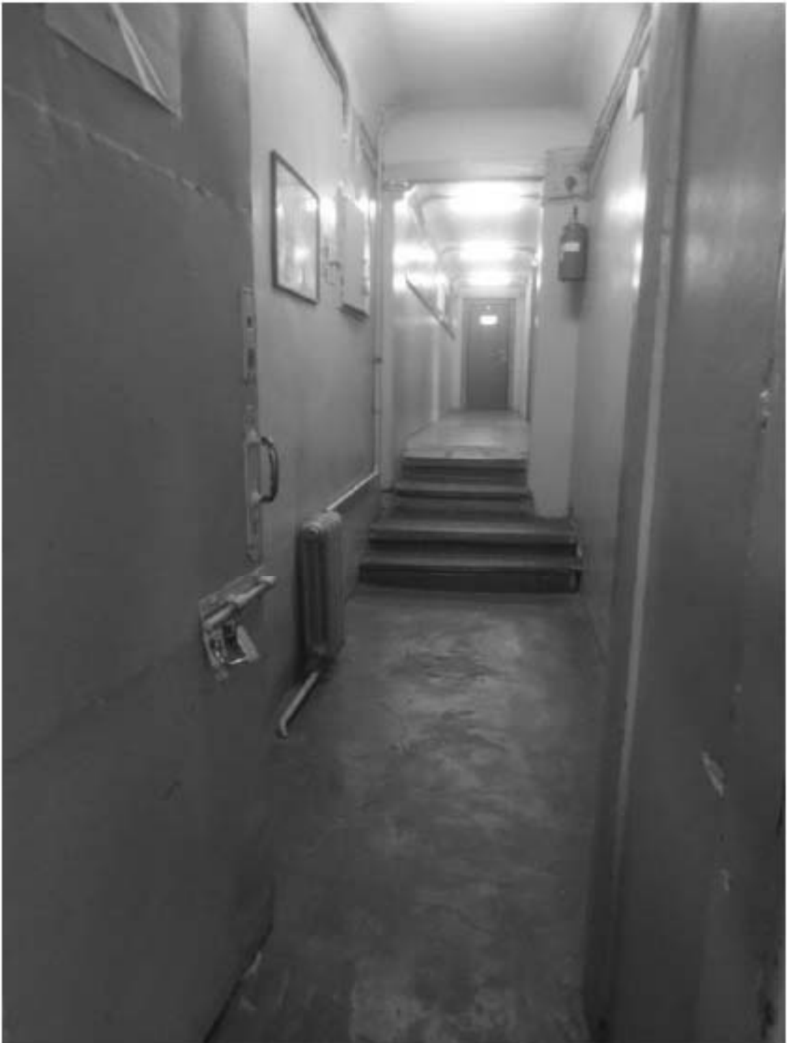
119. «Особняк Безобразовой». Санкт-Петербург, Моховая ул., 34, литера А (Моховая ул., 34). Лицевой корпус. 2-й этаж. Фрагмент помещения 17-Н(2). Фото: 26.10.2021.
