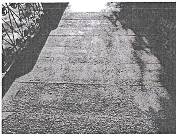
3. Покрытие проходной части моста.
