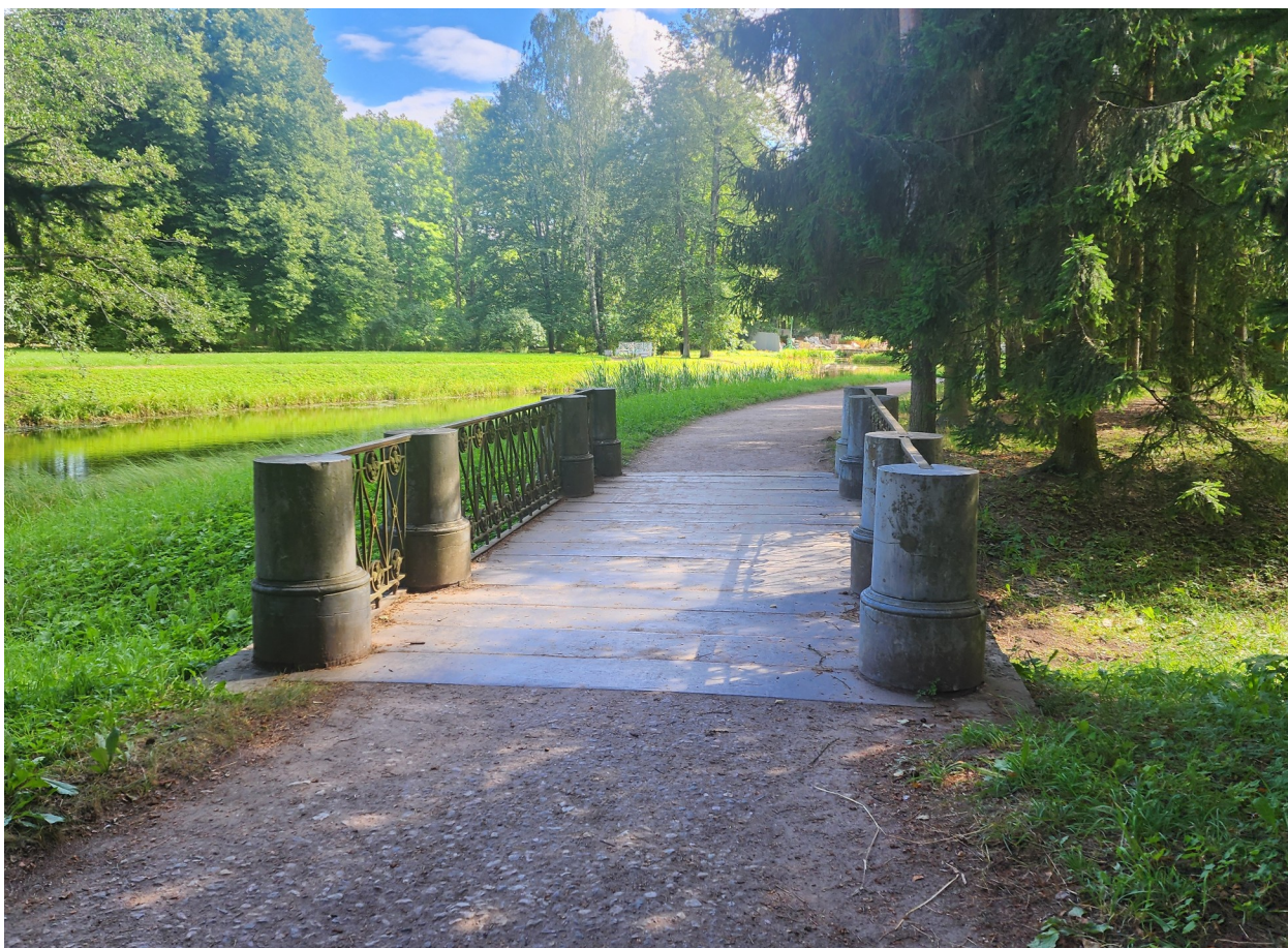
Фото 1. Общий вид моста.
