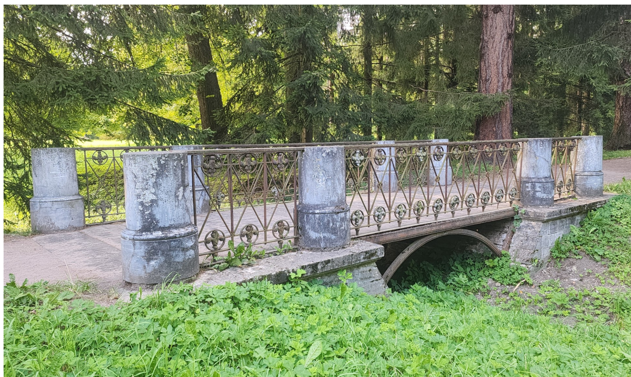
Фото 6. Общий вид на мост с юго-востока.
