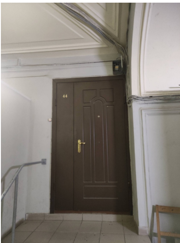
Фото 8. Входное дверное заполнение в квартиру, Вид со стороны коридора
