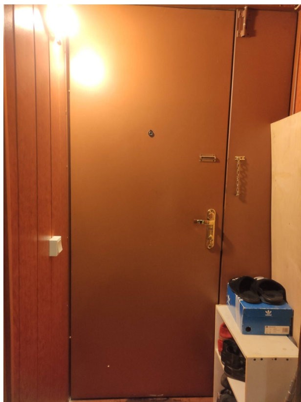
Фото 9. Входное дверное заполнение в квартиру, Вид со стороны квартиры
