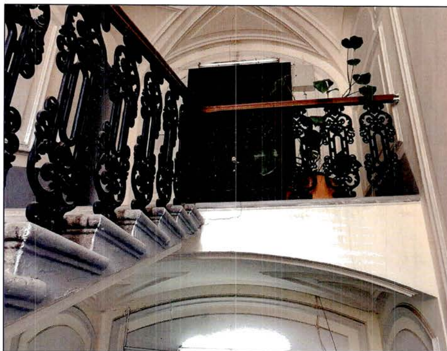
4. Двухмаршевая лестница 6-ЛК. Верхняя площадка.
