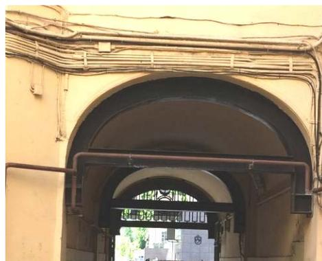
ажурные чугунные кронштейны козырьков с рисунком растительного характера из листьев аканта, шестилепестковых и «вихревых» розеток, с водосточными трубами круглого сечения, литые;\*
