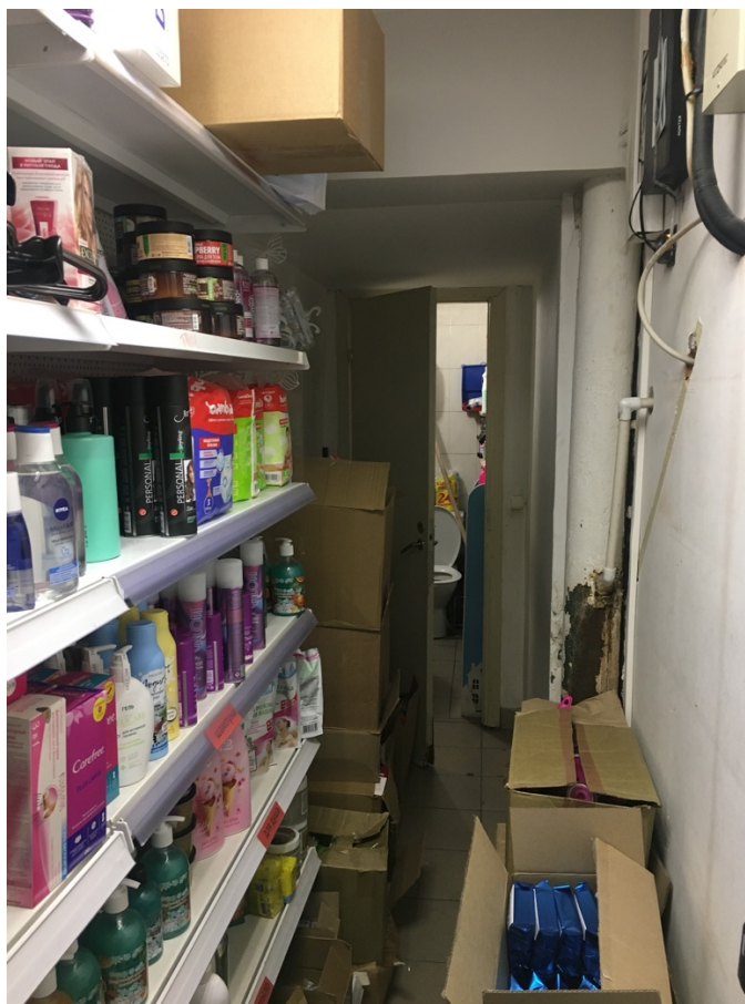
13. Выявленный объект культурного наследия «Дом С.Д. Шереметьева», г. Санкт-Петербург, пр. Литейный, дом № 51, лит. А. Помещение 2-Н. Вид подсобного помещения и санузла.
