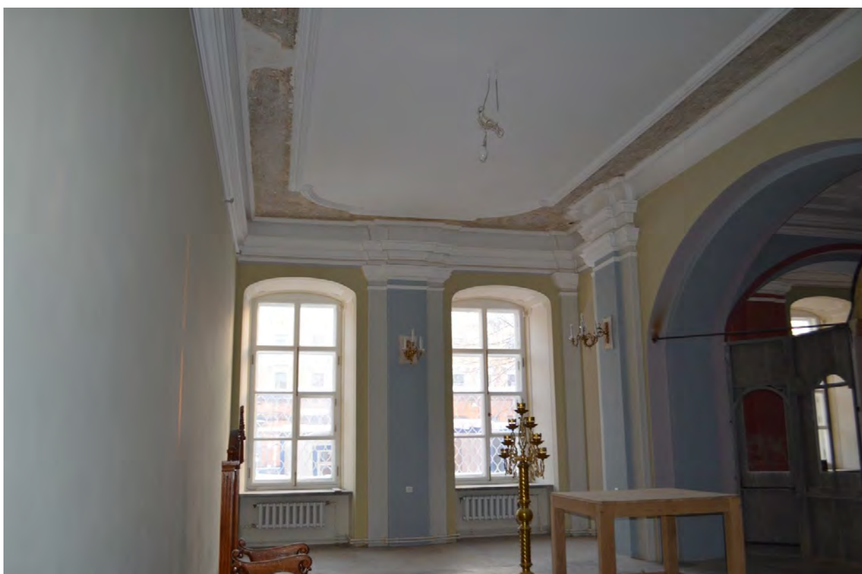
Фото 44. ОКН федерального значения «Церковь святого князя Феодора Новгородского». Первый этаж. Нижняя Фёдоровская церковь. Съёмка 10.11.2021 г.
