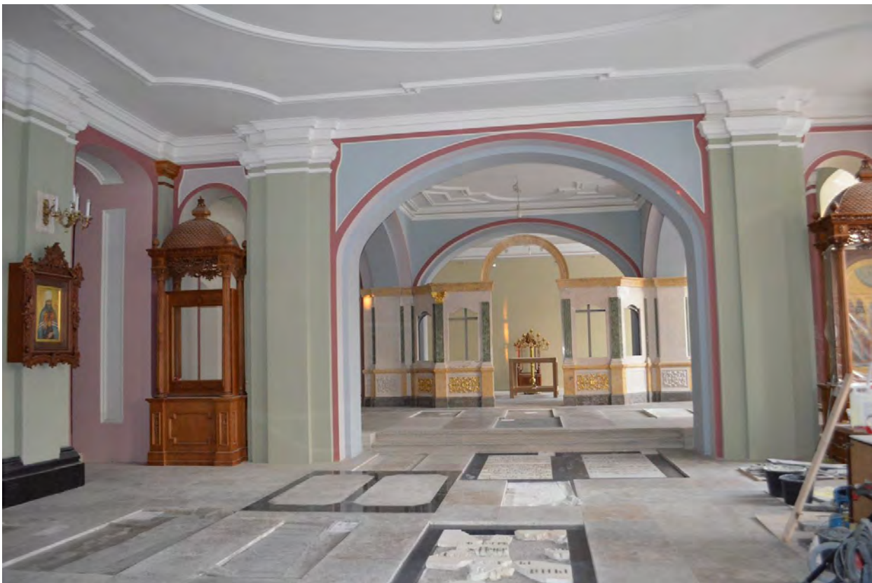
Фото 31. ОКН федерального значения «Церковь святого князя Феодора Новгородского». Первый этаж. Нижняя Фёдоровская церковь. Съёмка 10.11.2021 г.
