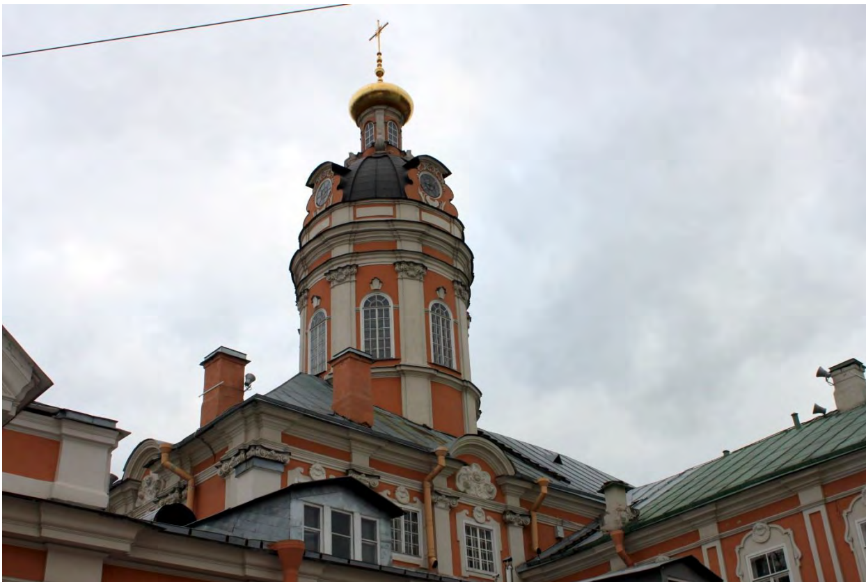
Фото 04. ОКН федерального значения «Церковь святого князя Феодора Новгородского». Северный фасад. Барабан и купол. Общий вид. Съёмка 10.11.2021 г.
