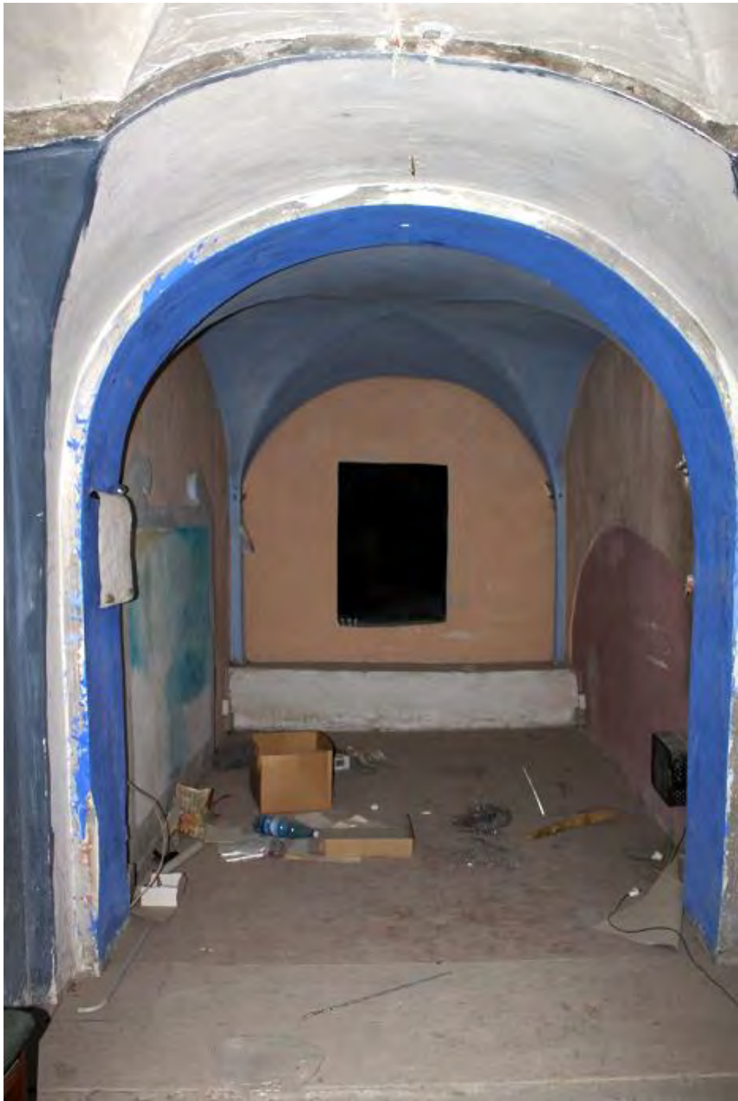
Фото 77. ОКН федерального значения «Церковь святого князя Феодора Новгородского». Чердак. Съёмка 10.11.2021 г.
