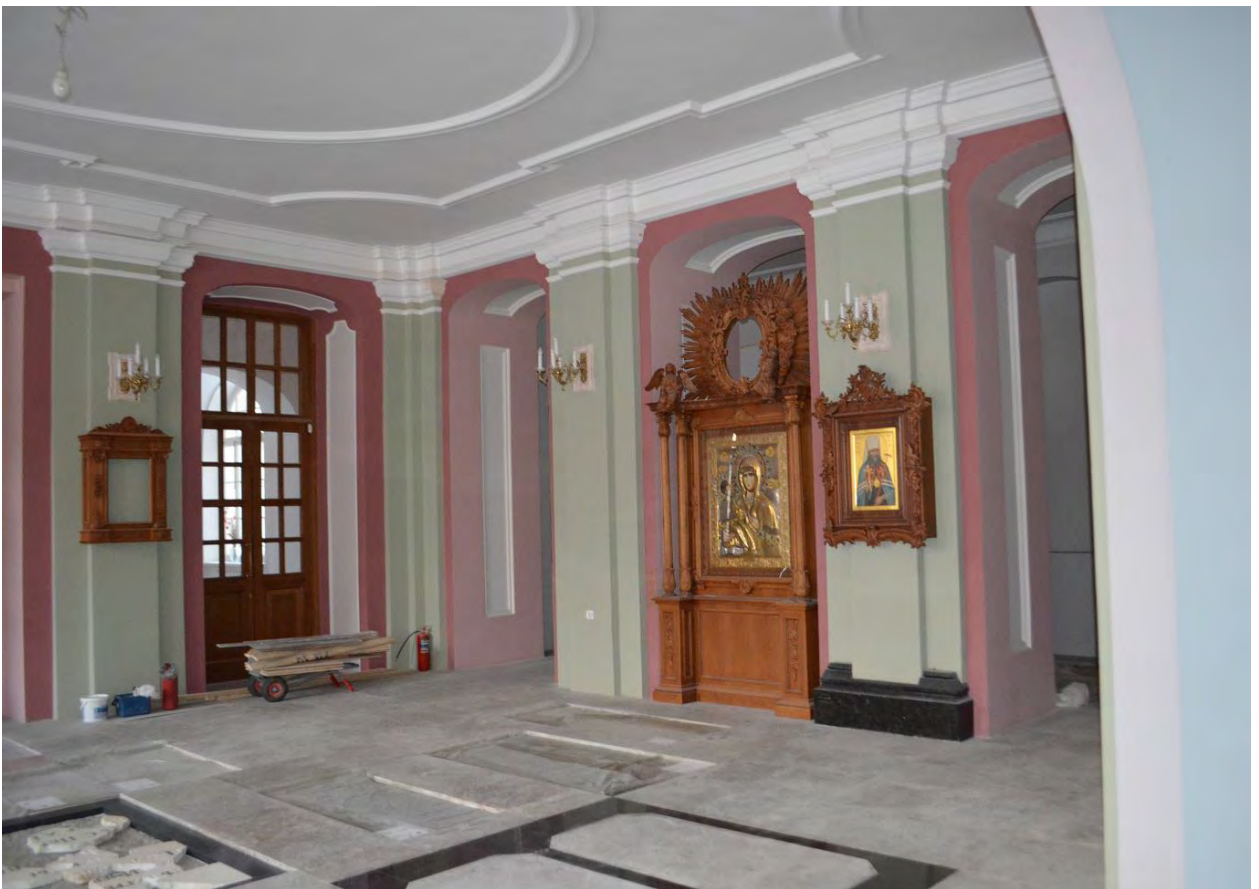
Фото 34. ОКН федерального значения «Церковь святого князя Феодора Новгородского». Первый этаж. Нижняя Фёдоровская церковь. Съёмка 10.11.2021 г.
