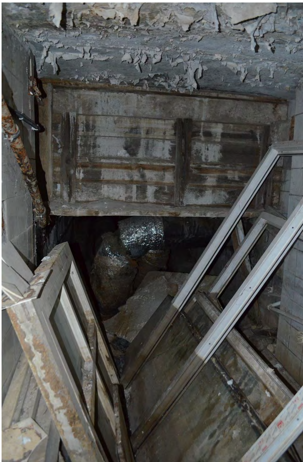
Фото 10. ОКН федерального значения «Церковь святого князя Феодора Новгородского». Подвальное помещение. Съёмка 10.11.2021 г.
