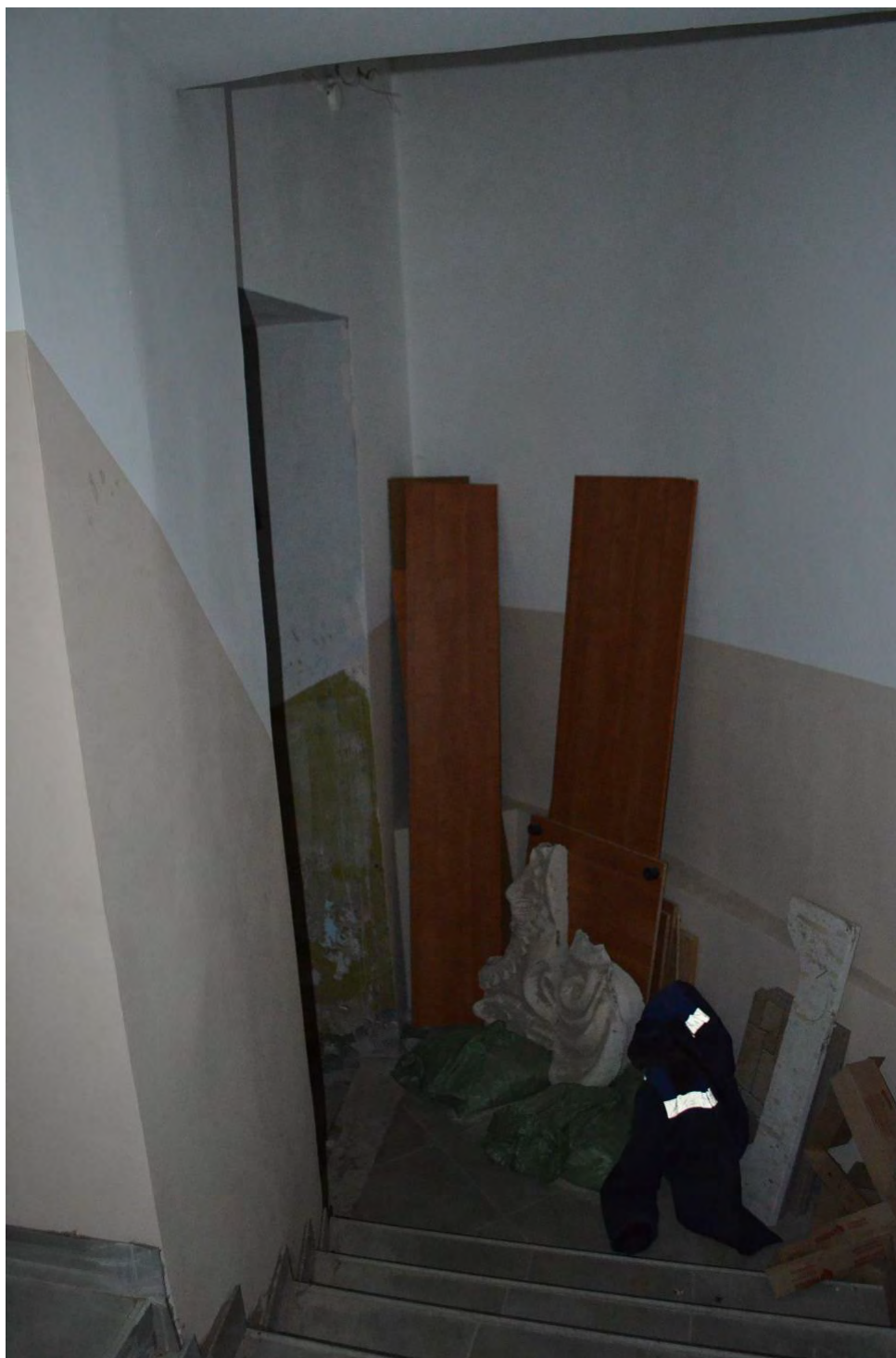
Фото 52. ОКН федерального значения «Церковь святого князя Феодора Новгородского». Помещение первого этажа. Вход в подвальные помещения. Съёмка 10.11.2021 г.
