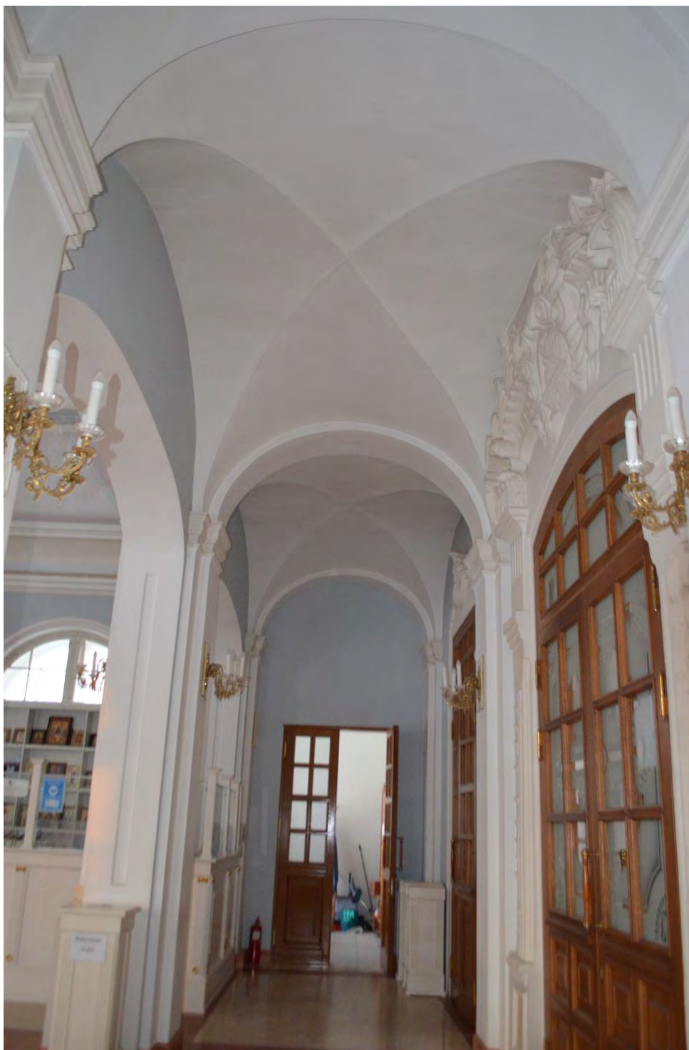
Фото 57. ОКН федерального значения «Церковь святого князя Феодора Новгородского». Лестничный объём второго этажа. Съёмка 10.11.2021 г.
