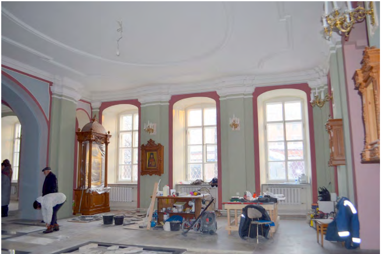
Фото 36. ОКН федерального значения «Церковь святого князя Феодора Новгородского». Первый этаж. Нижняя Фёдоровская церковь. Съёмка 10.11.2021 г.
