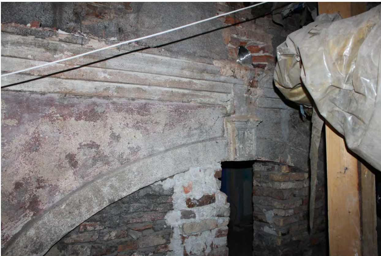
Фото 76. ОКН федерального значения «Церковь святого князя Феодора Новгородского». Чердак. Съёмка 10.11.2021 г.
