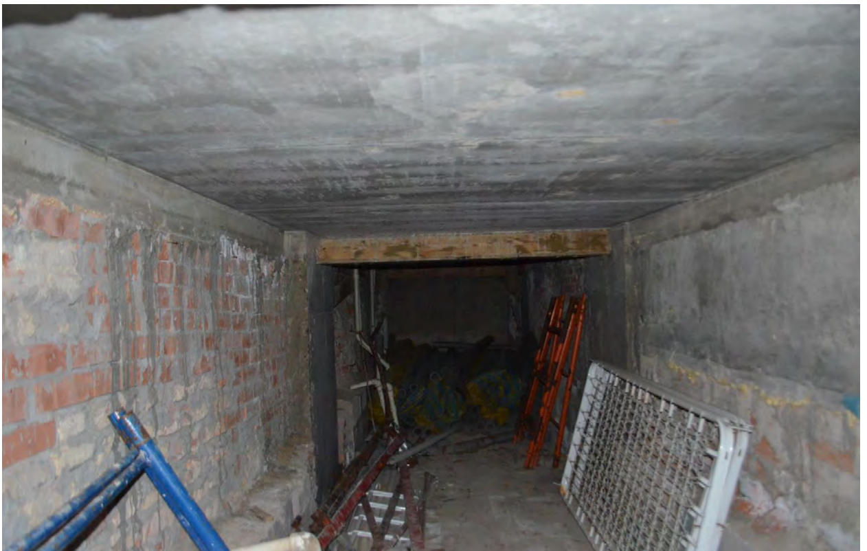
Фото 12. ОКН федерального значения «Церковь святого князя Феодора Новгородского». Подвальное помещение. Съёмка 10.11.2021 г.
