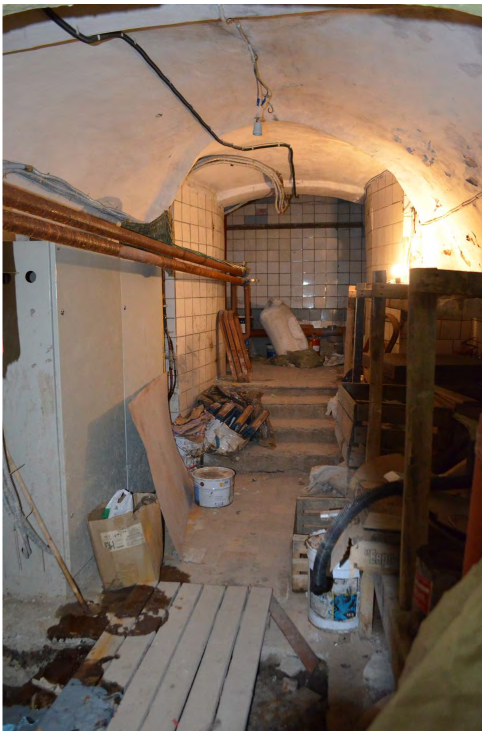
Фото 07. ОКН федерального значения «Церковь святого князя Феодора Новгородского». Подвальное помещение. Съёмка 10.11.2021 г.
