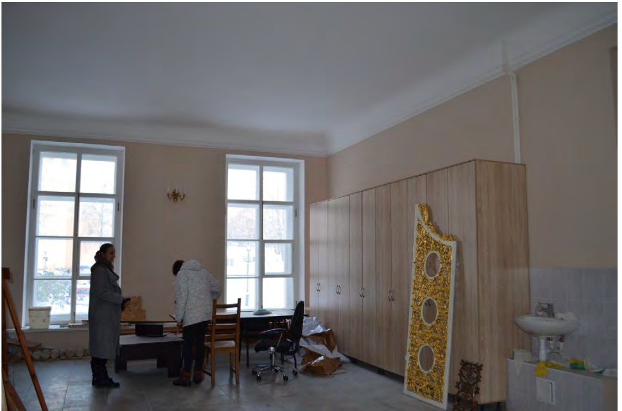
Фото 47. ОКН федерального значения «Церковь святого князя Феодора Новгородского». Помещение первого этажа. Съёмка 10.11.2021 г.
