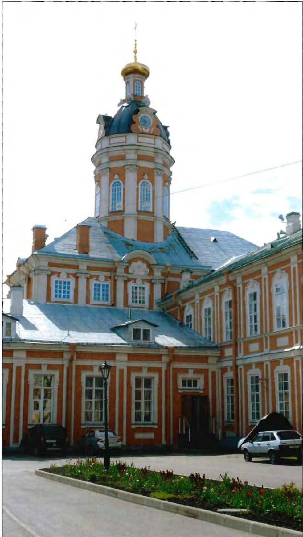
2. Общий вид с северо-востока.
