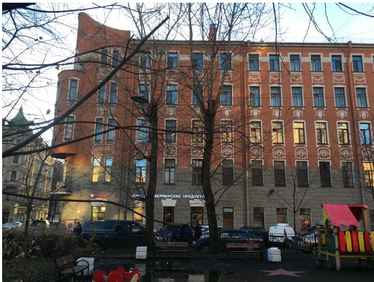
Фото №3. Северо-восточный лицевой фасад.
