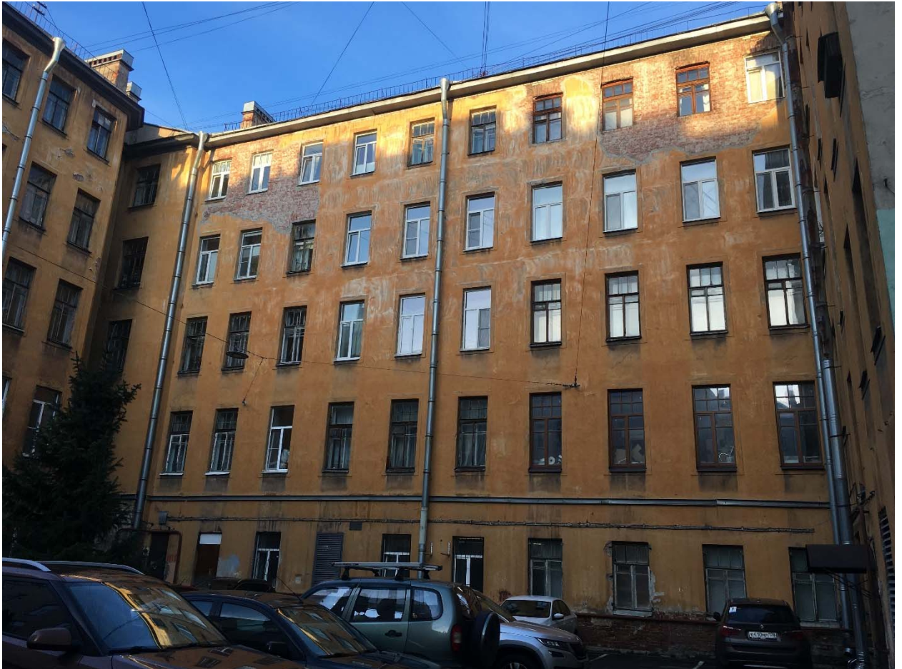
Фото №19. Юго-западный дворовый фасад.
