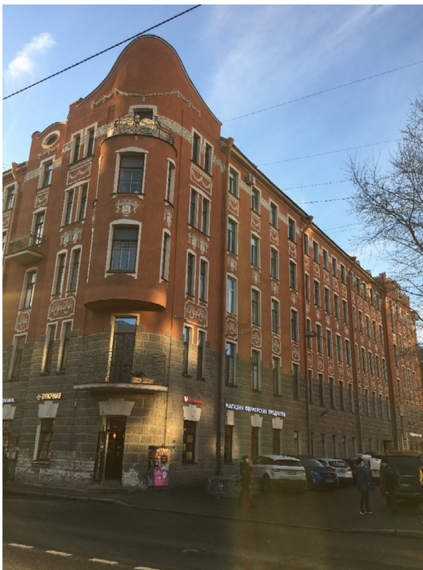
Фото №1. Угол северо-восточного и юго-восточного лицевых фасадов.
