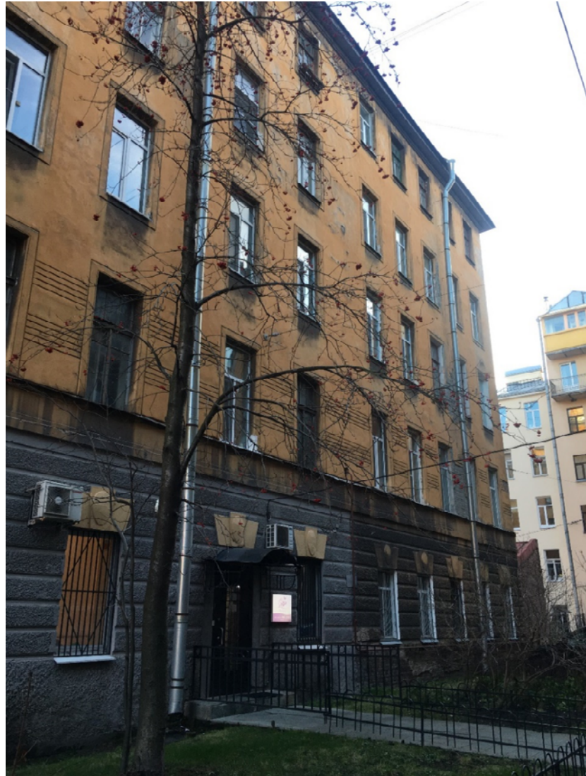
Фото №15. Северо-западный дворовый фасад.
