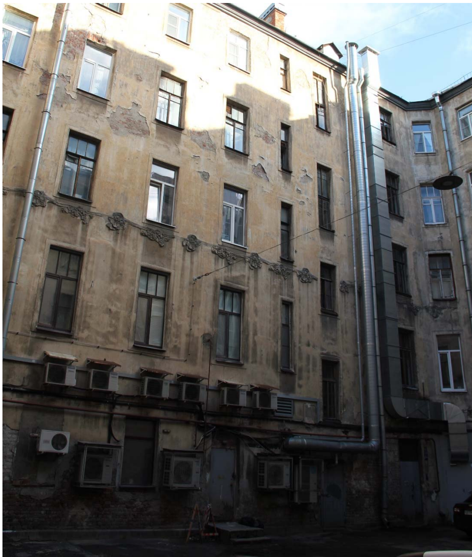
Фото №25. Юго-западный фасад замкнутого двора.
