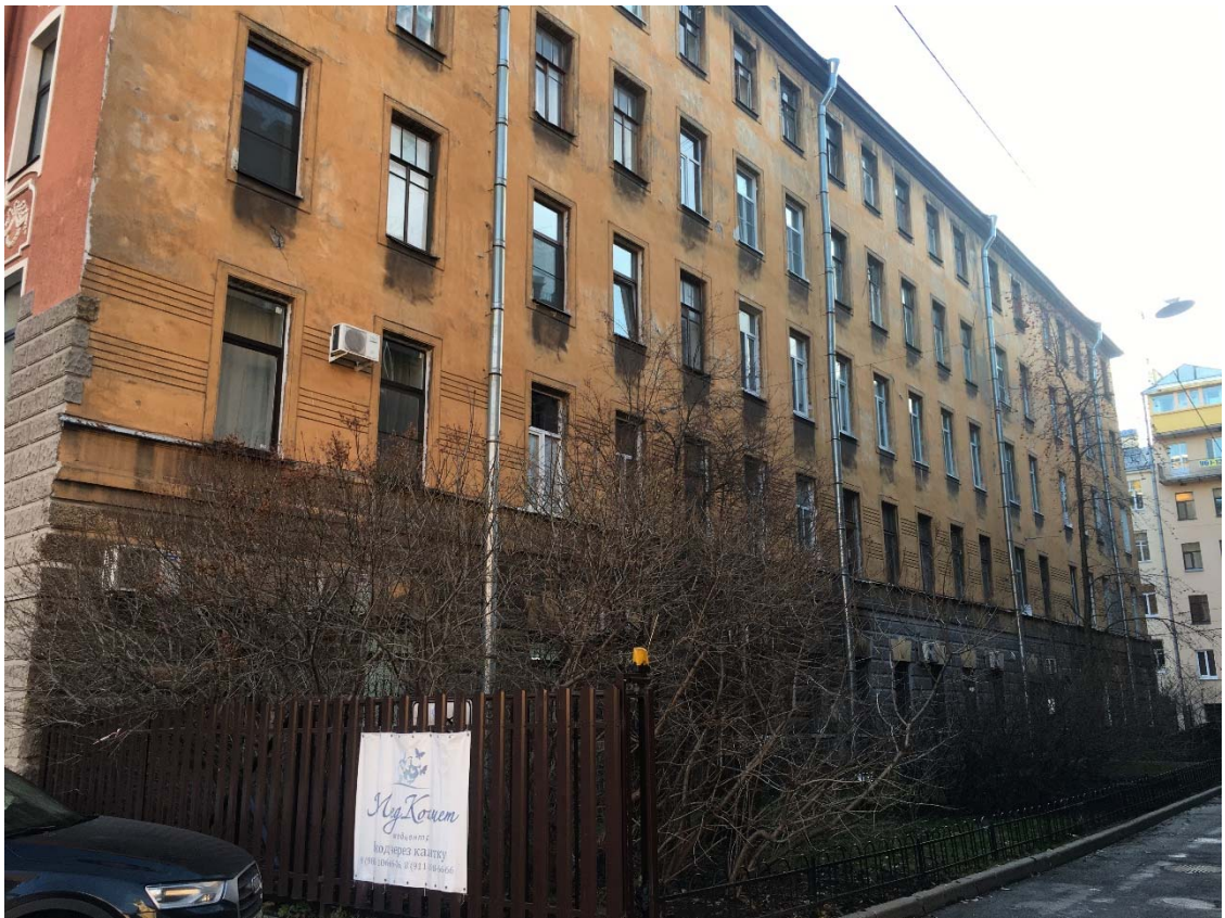
Фото №13. Северо-западный дворовый фасад.
