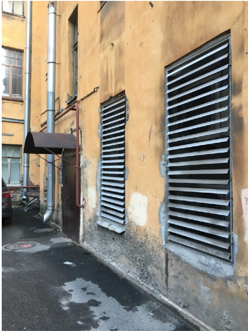
Фото №23. Северо-западный дворовый фасад, решетки на окнах.
