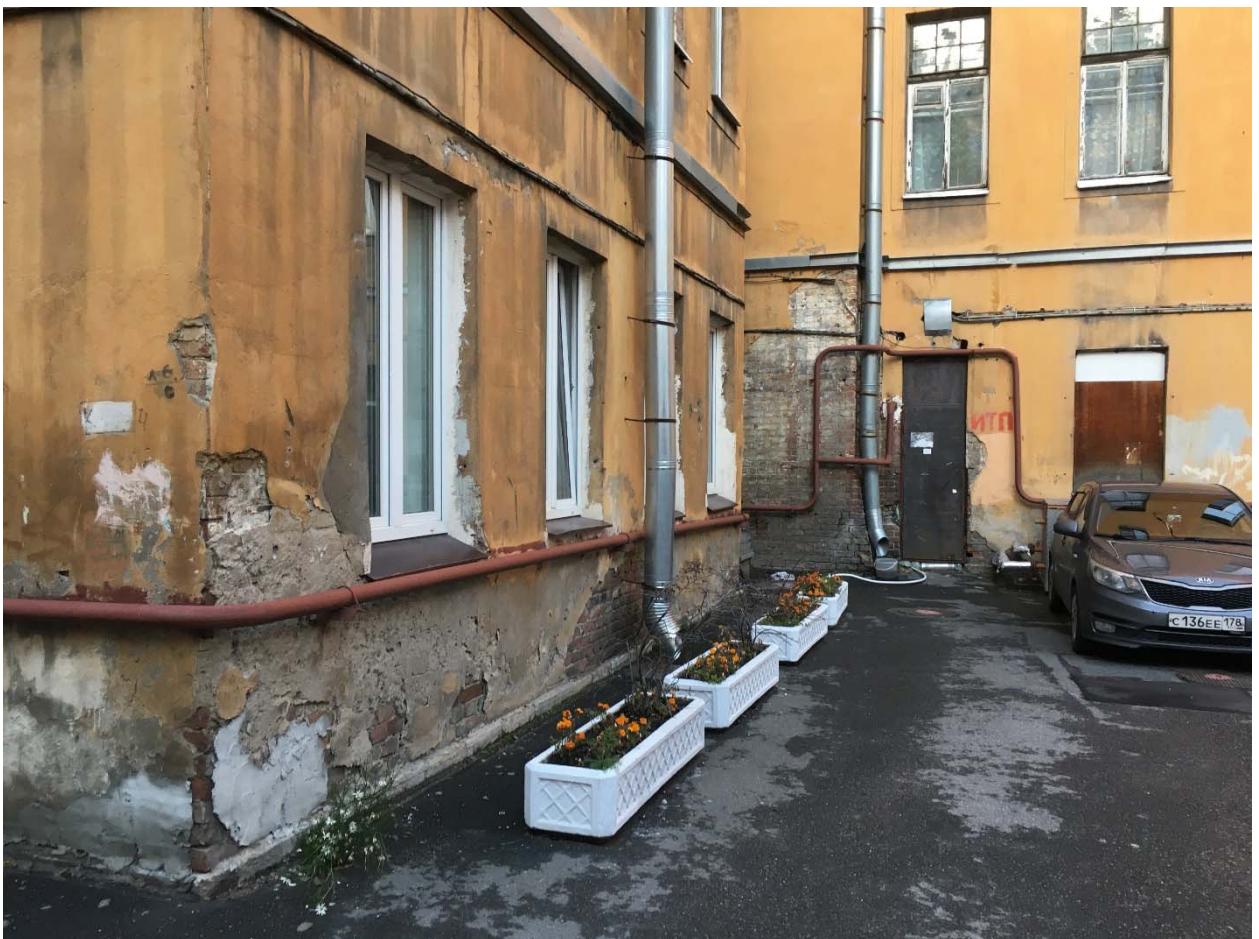
Фото №14. Юго-западный внутренний фасад, левый внутренний угол.
