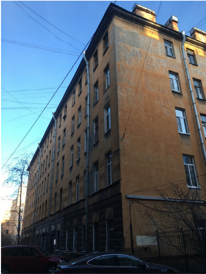
Фото №16. Северо-западный дворовый фасад.
