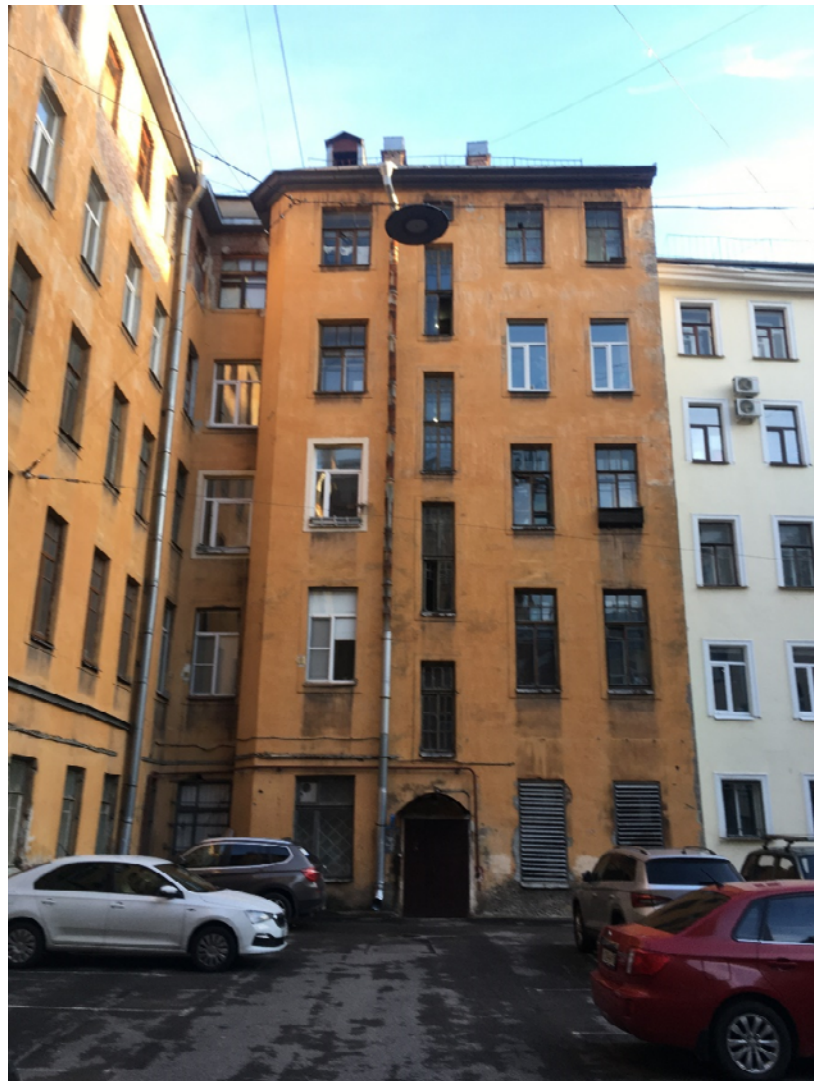
Фото №20. Северо-западный дворовый фасад.
