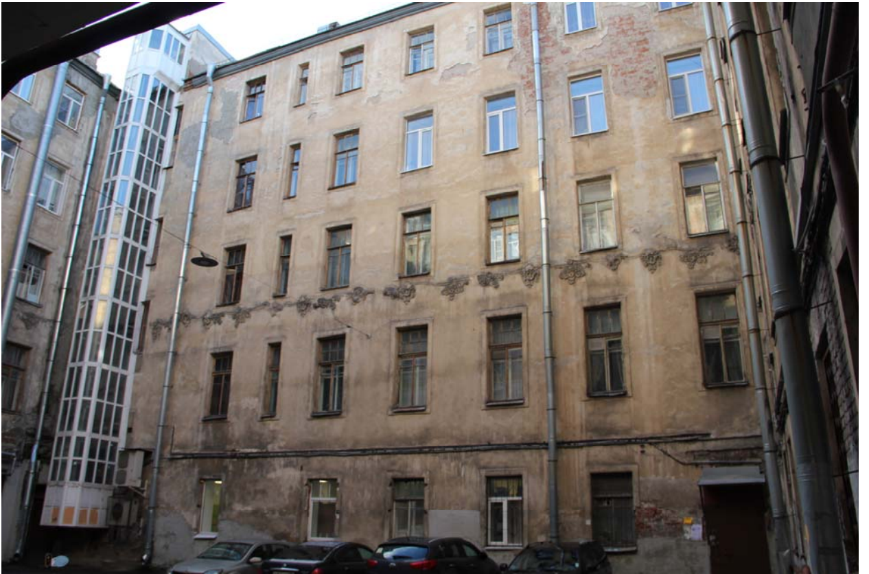
Фото №27. Северо-восточный фасад замкнутого двора.
