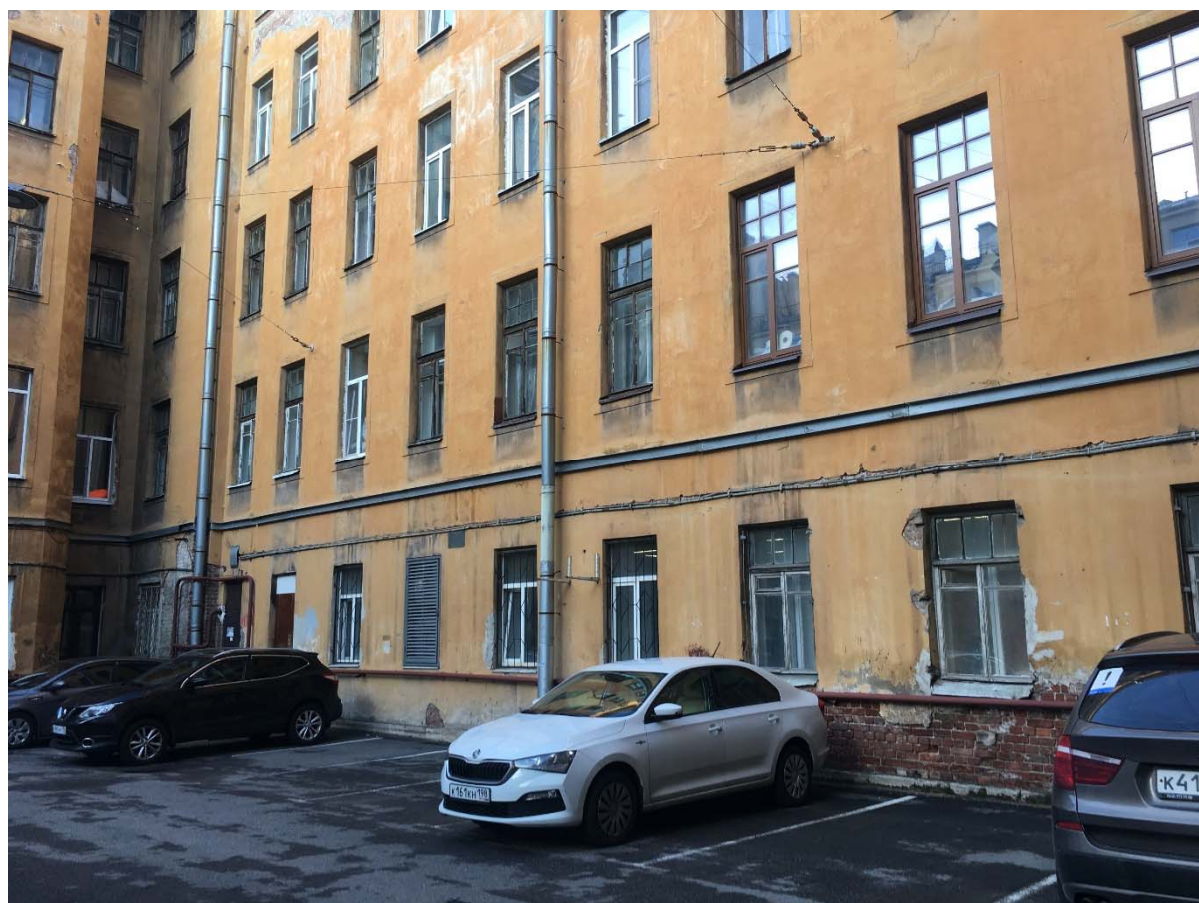
Фото №22. Юго-западный дворовый фасад.
