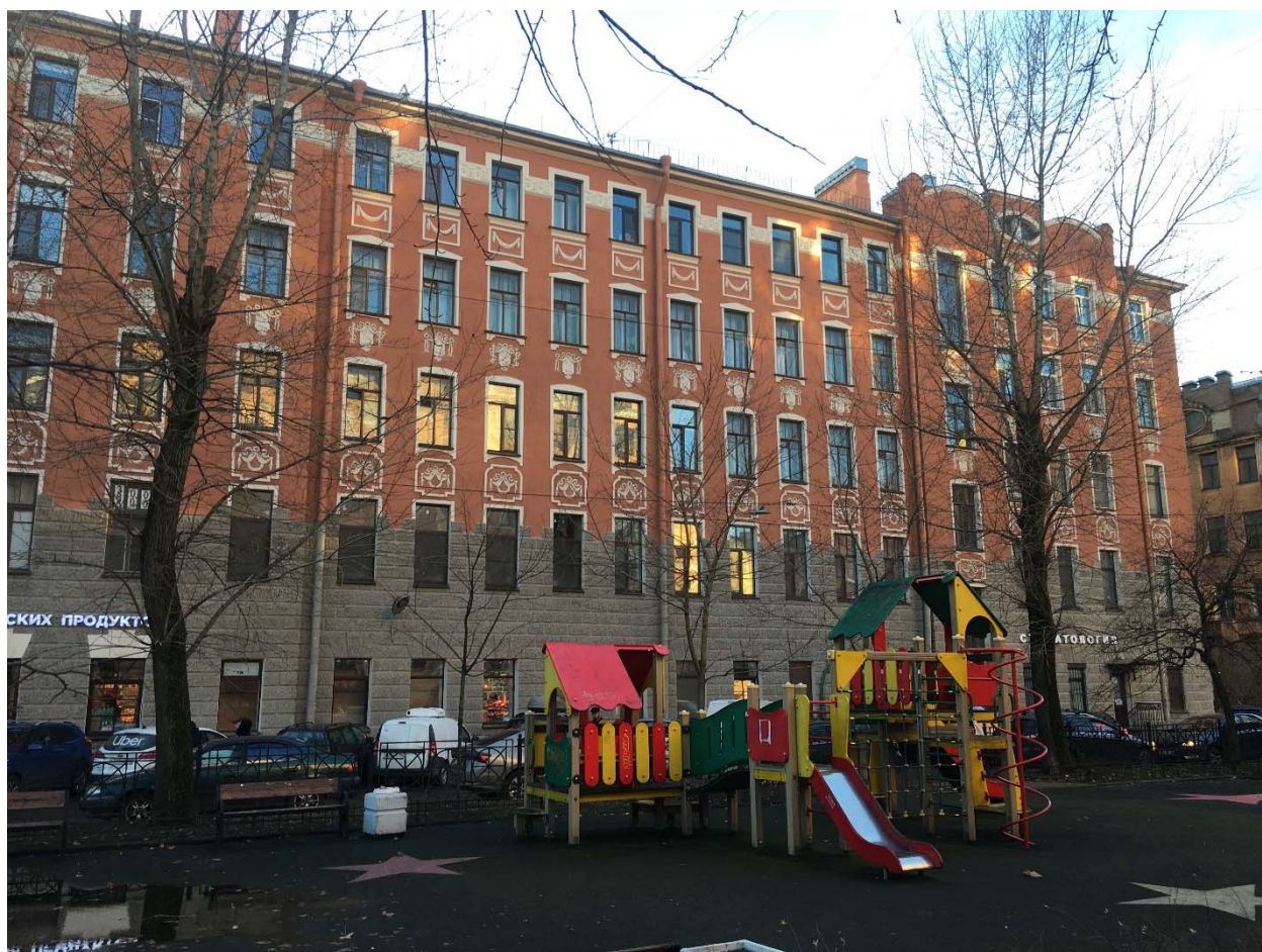
Фото №2. Северо-восточный лицевой фасад.
