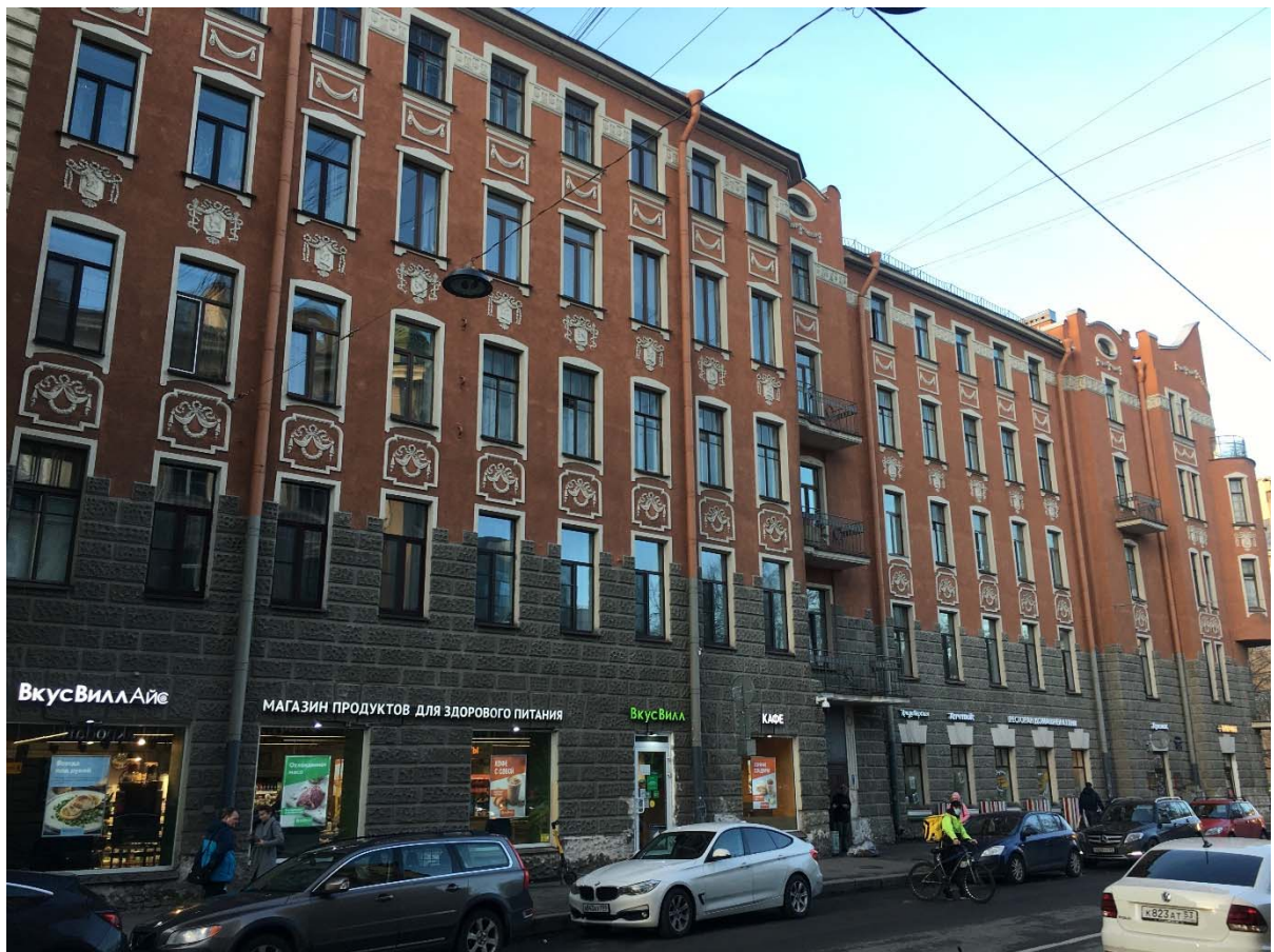
Фото №6. Юго-западный лицевой фасад.
