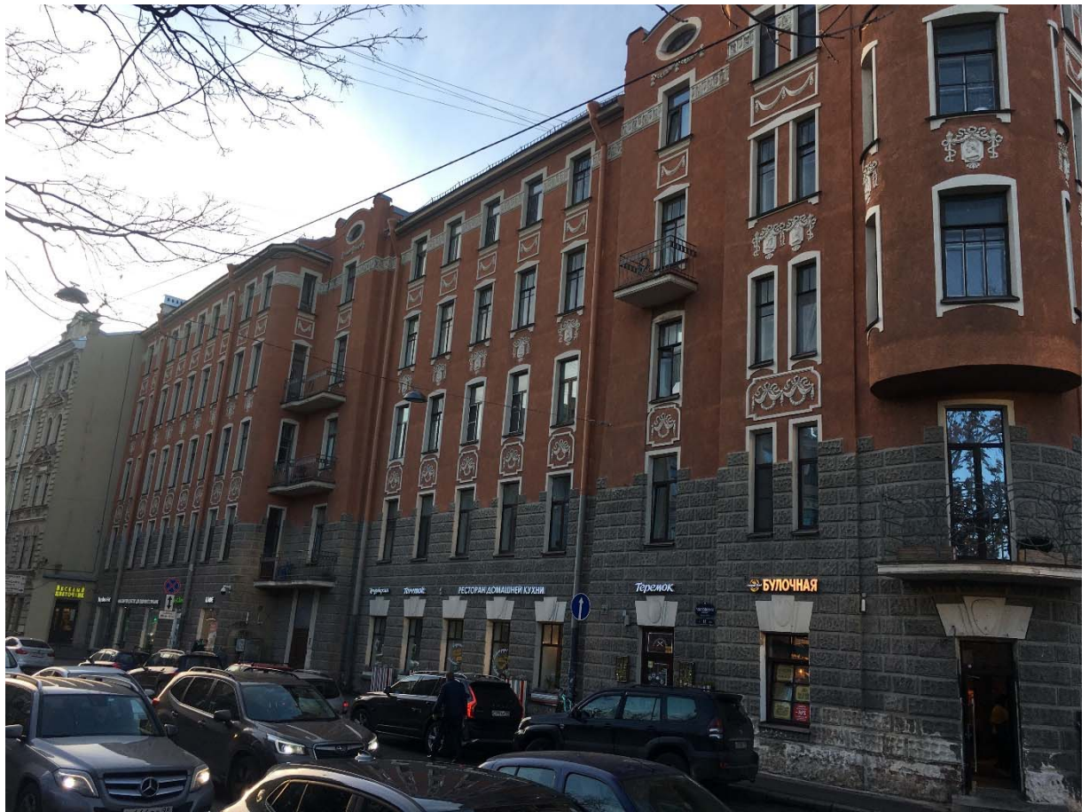
Фото №7. Юго-западный лицевой фасад.
