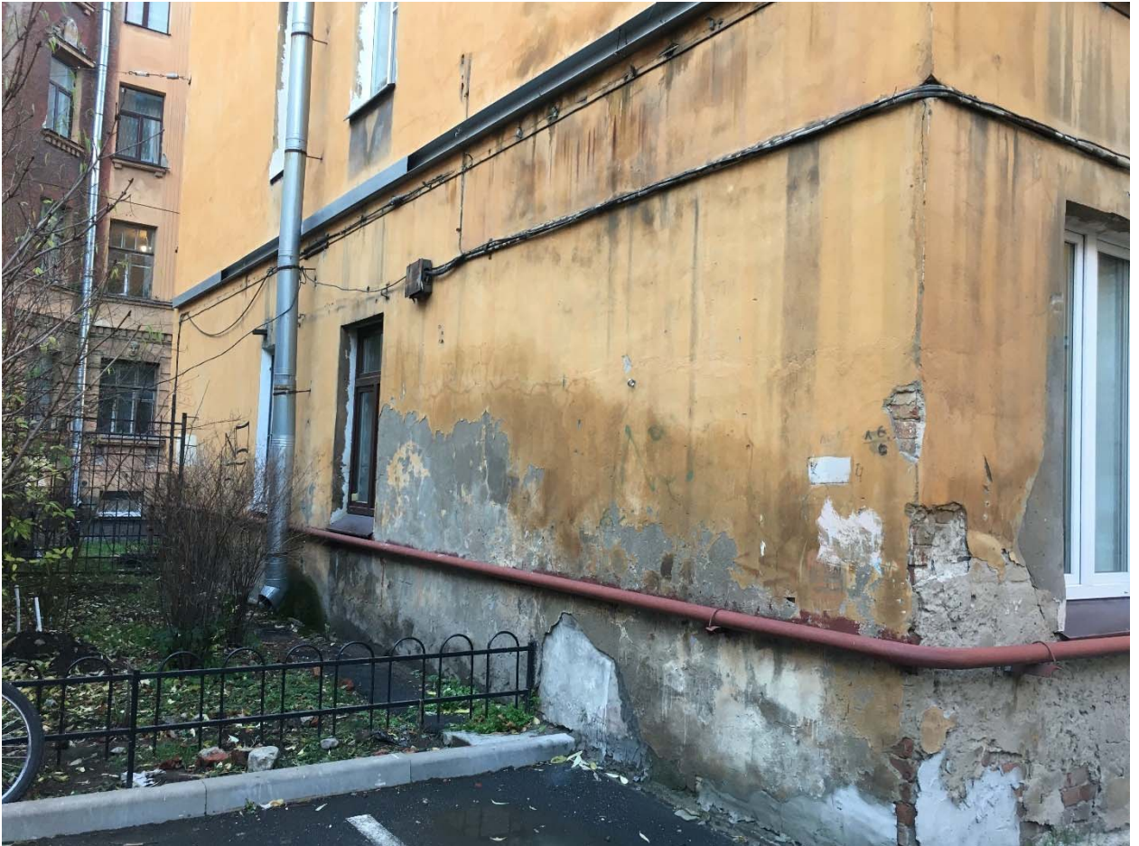
Фото №18. Юго-западный дворовый (торцевой) фасад.
