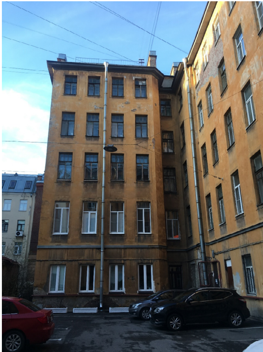
Фото №21. Юго-восточный дворовый фасад.
