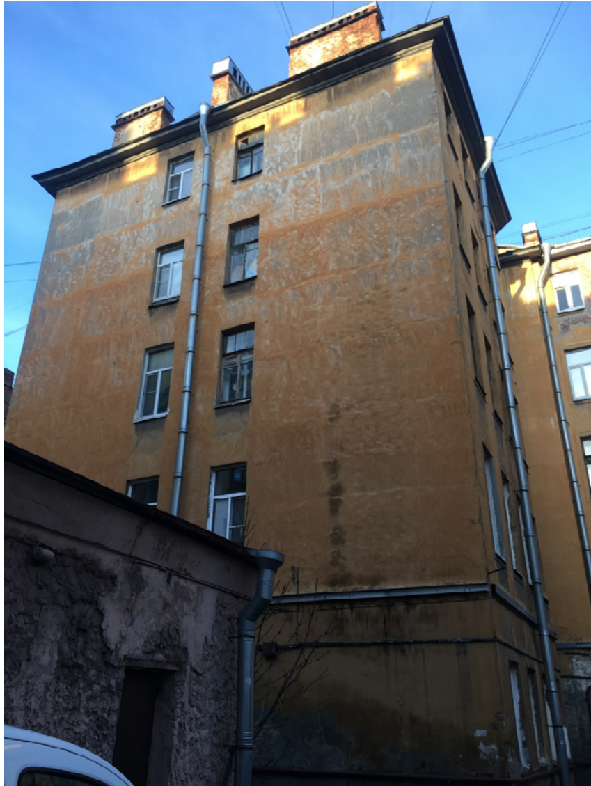
Фото №17. Юго-западный дворовый фасад.
