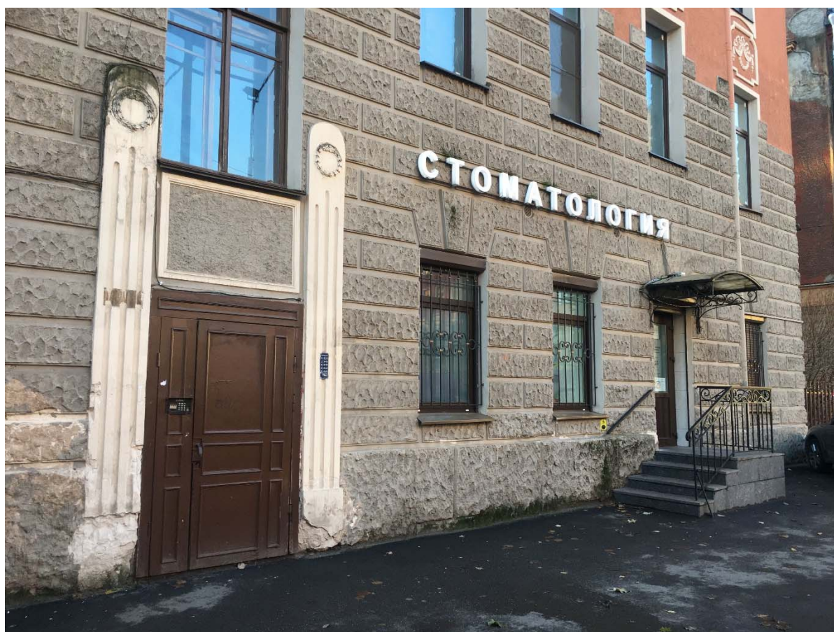
Фото №5. Северо-восточный лицевой фасад, вход в общедомовую лестничную клетку.
