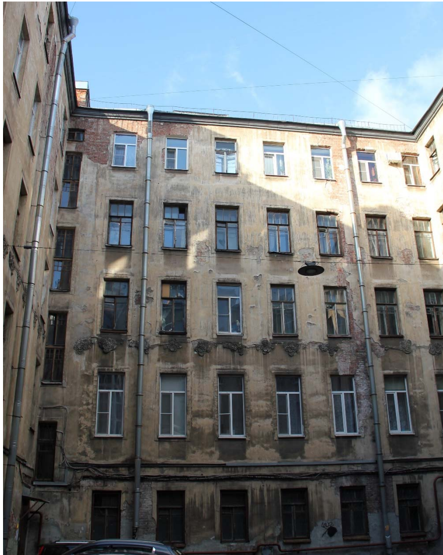
Фото №26. Юго-восточный фасад замкнутого двора.
