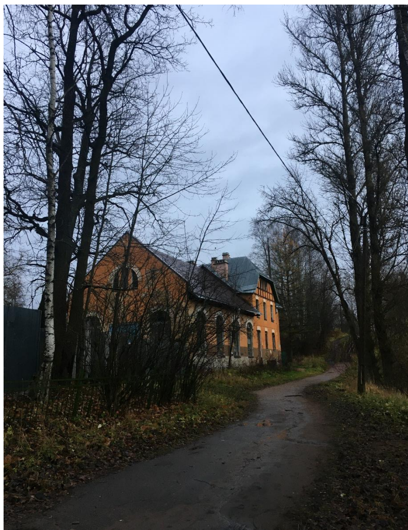
18. Объект культурного наследия федерального наследия «Парк «Мариенталь»». Вид на территорию парка. Павловская электрическая станция. Направление съемки юго-восток.
