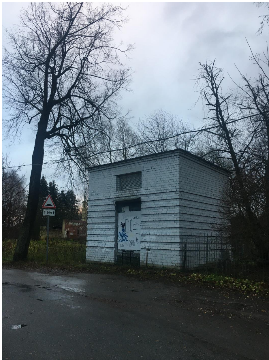
1. Объект культурного наследия федерального наследия «Парк «Мариенталь»». Трансформаторная подстанция-территория проектирования. Направление съемки юго-восток. Автор съемки Т.Д. Глебова. Дата съемки 28.10.2021.
