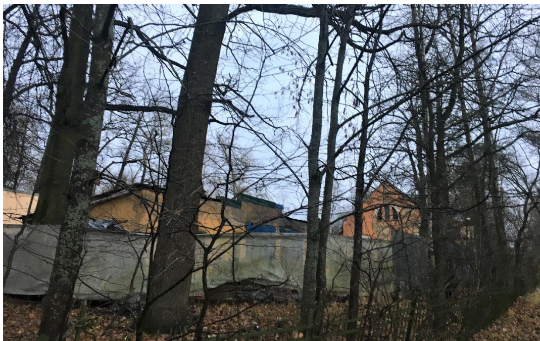
17. Объект культурного наследия федерального наследия «Парк «Мариенталь»». Вид на территорию парка. Павловская электрическая станция. Направление съемки юго-восток.
