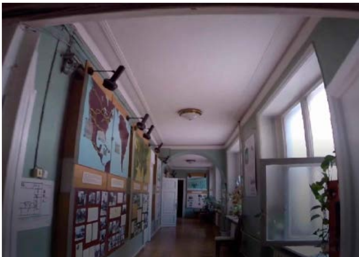
16. Помещение №7 (27Н) объекта культурного наследия федерального значения «Дом министра государственных имуществ», расположенного по адресу: г. Санкт-Петербург, Большая Морская ул., д. 44, литера А. 26.10.2021
