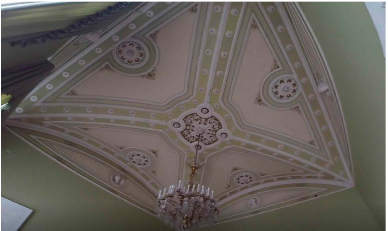
18. Помещение №10 (27Н) объекта культурного наследия федерального значения «Дом министра государственных имуществ», расположенного по адресу: г. Санкт-Петербург, Большая Морская ул., д. 44, литера А. 26.10.2021
