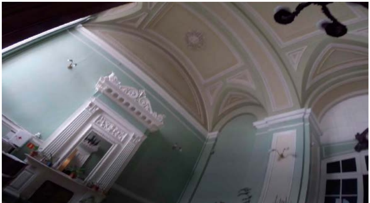
3. Помещение №3 (5Н) объекта культурного наследия федерального значения «Дом министра государственных имуществ», расположенного по адресу: г. Санкт-Петербург, Большая Морская ул., д. 44, литера А. 26.10.2021
