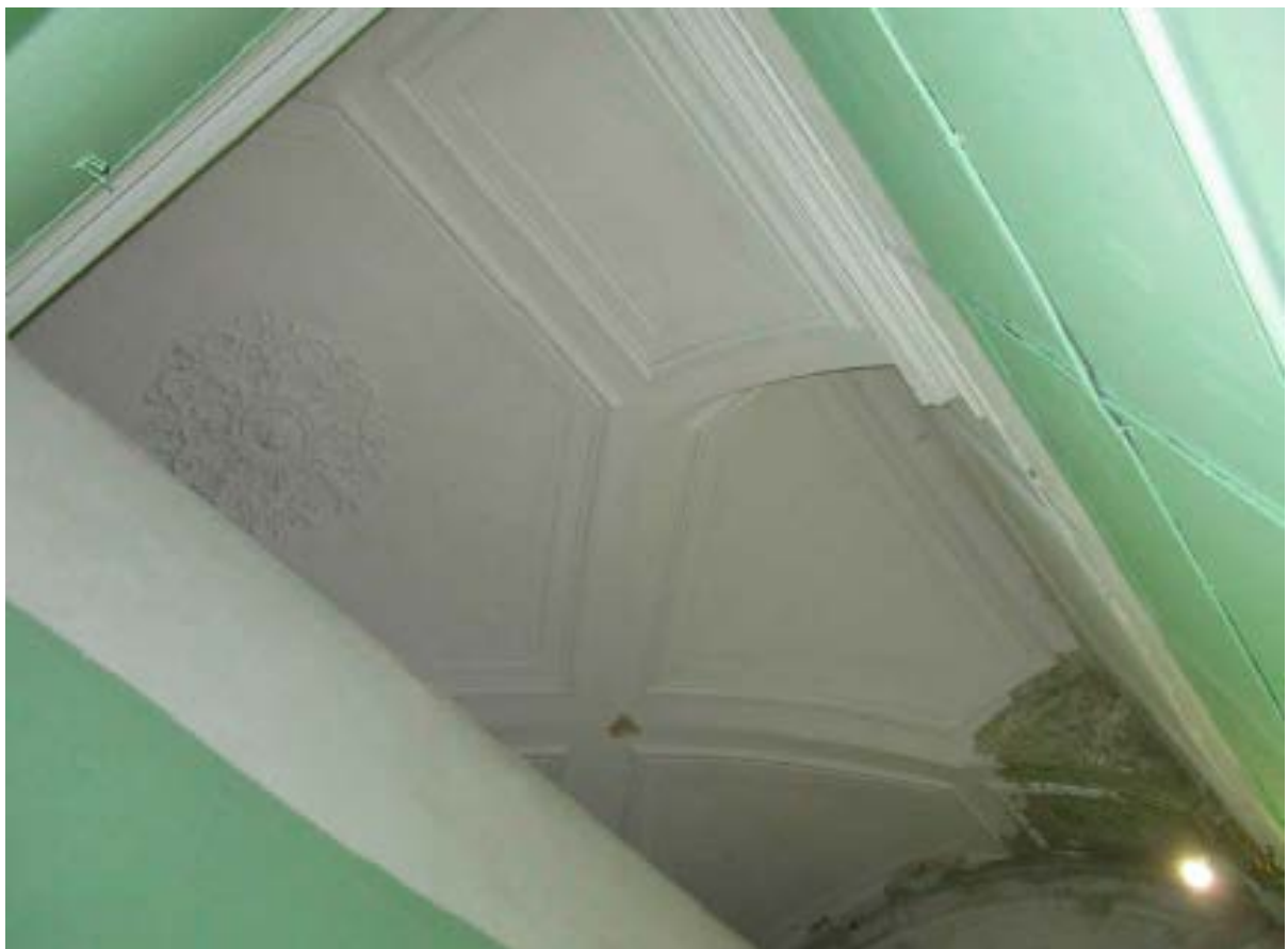
20. Помещение №15 (27Н) объекта культурного наследия федерального значения «Дом министра государственных имуществ», расположенного по адресу: г. Санкт-Петербург, Большая Морская ул., д. 44, литера А. 26.10.2021
