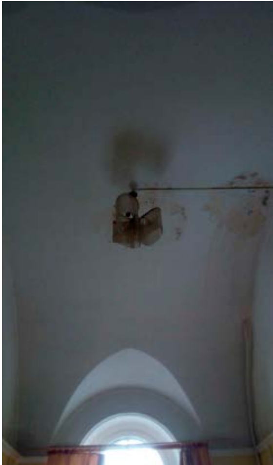
23. Помещение №10 (35Н) объекта культурного наследия федерального значения «Дом министра государственных имуществ», расположенного по адресу: г. Санкт-Петербург, Большая Морская ул., д. 44, литера А. 26.10.2021
