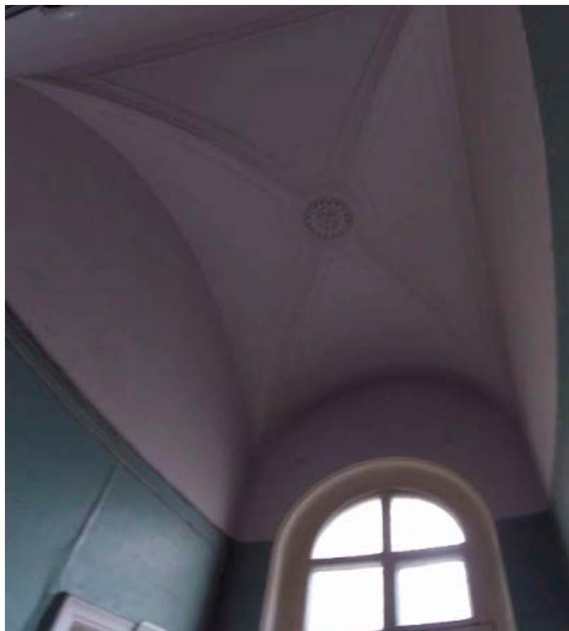
4. Помещение №8 (5Н) объекта культурного наследия федерального значения «Дом министра государственных имуществ», расположенного по адресу: г. Санкт-Петербург, Большая Морская ул., д. 44, литера А. 26.10.2021
