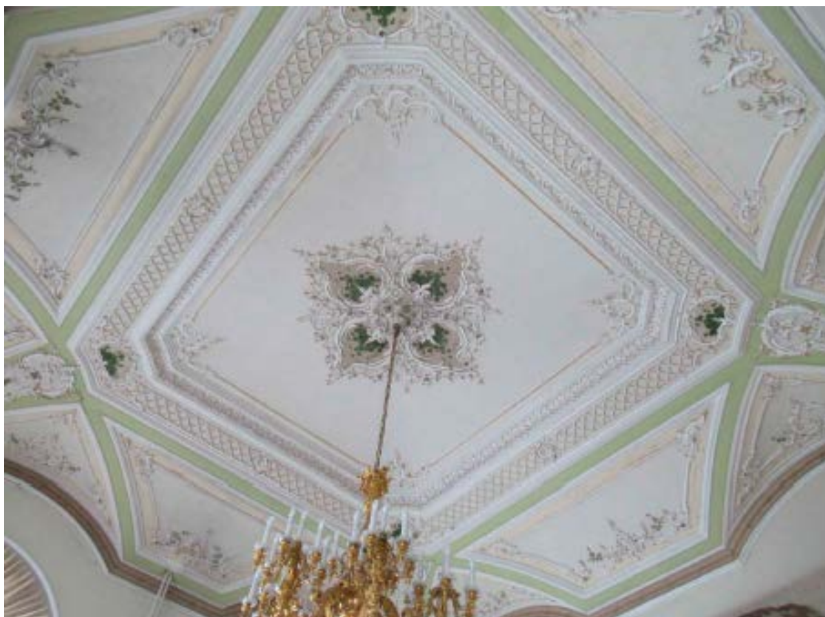
17. Помещение №9 (27Н) объекта культурного наследия федерального значения «Дом министра государственных имуществ», расположенного по адресу: г. Санкт-Петербург, Большая Морская ул., д. 44, литера А. 26.10.2021
