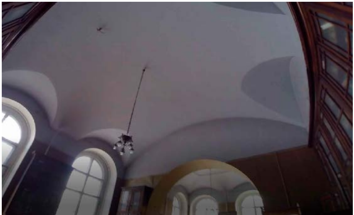
8. Помещение №16 (5Н) объекта культурного наследия федерального значения «Дом министра государственных имуществ», расположенного по адресу: г. Санкт-Петербург, Большая Морская ул., д. 44, литера А. 26.10.2021
