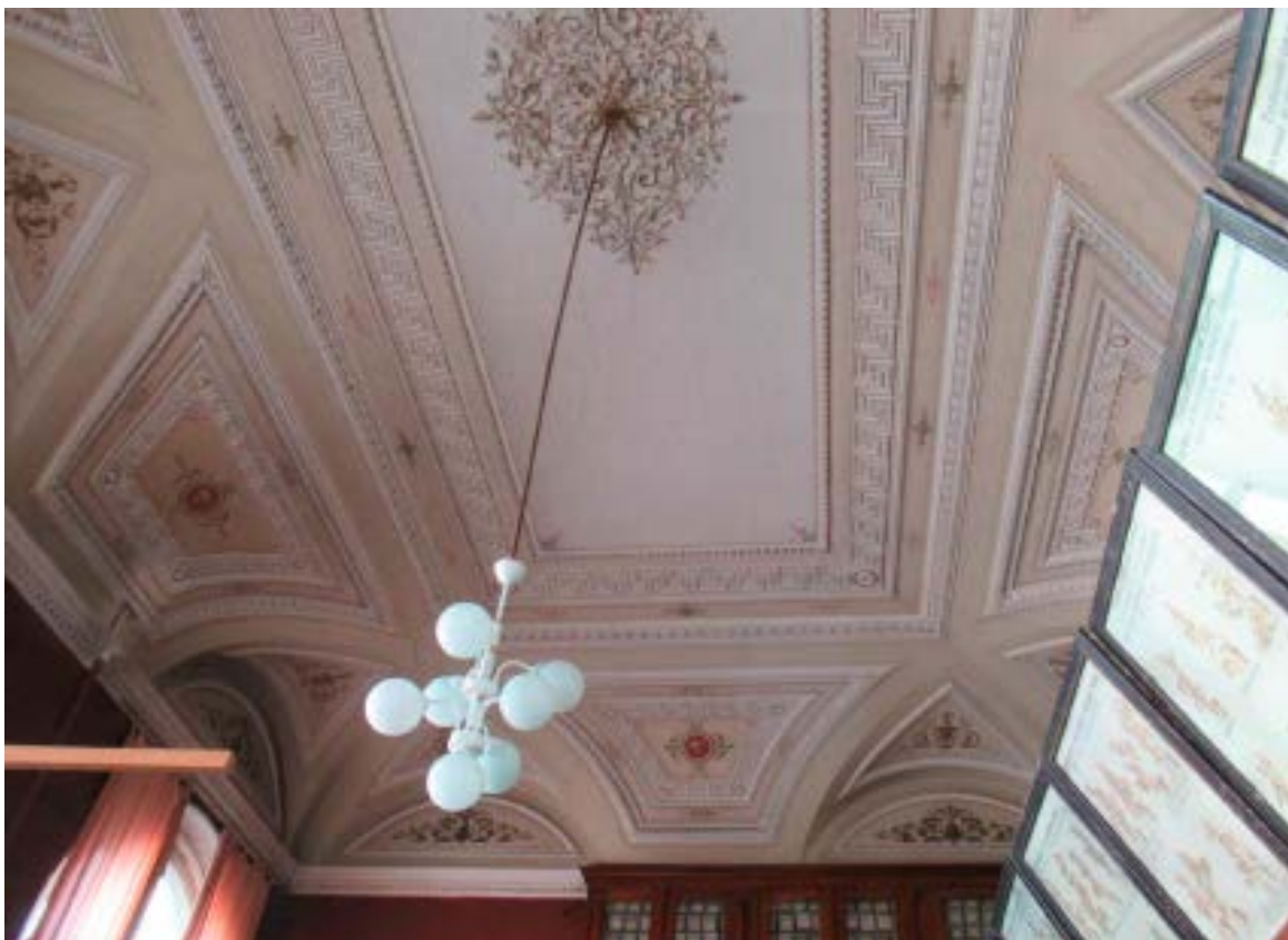
21. Помещение №19 (27Н) объекта культурного наследия федерального значения «Дом министра государственных имуществ», расположенного по адресу: г. Санкт-Петербург, Большая Морская ул., д. 44, литера А. 26.10.2021
