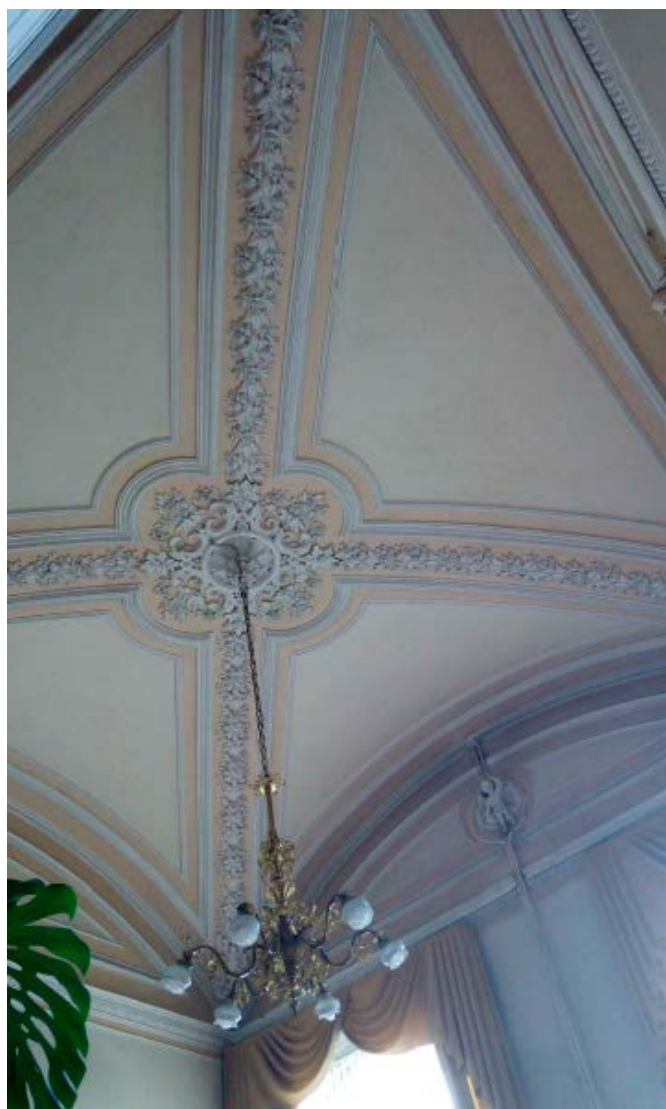
12. Помещение №8 (27Н) объекта культурного наследия федерального значения «Дом министра государственных имуществ», расположенного по адресу: г. Санкт-Петербург, Большая Морская ул., д. 44, литера А. 26.10.2021
