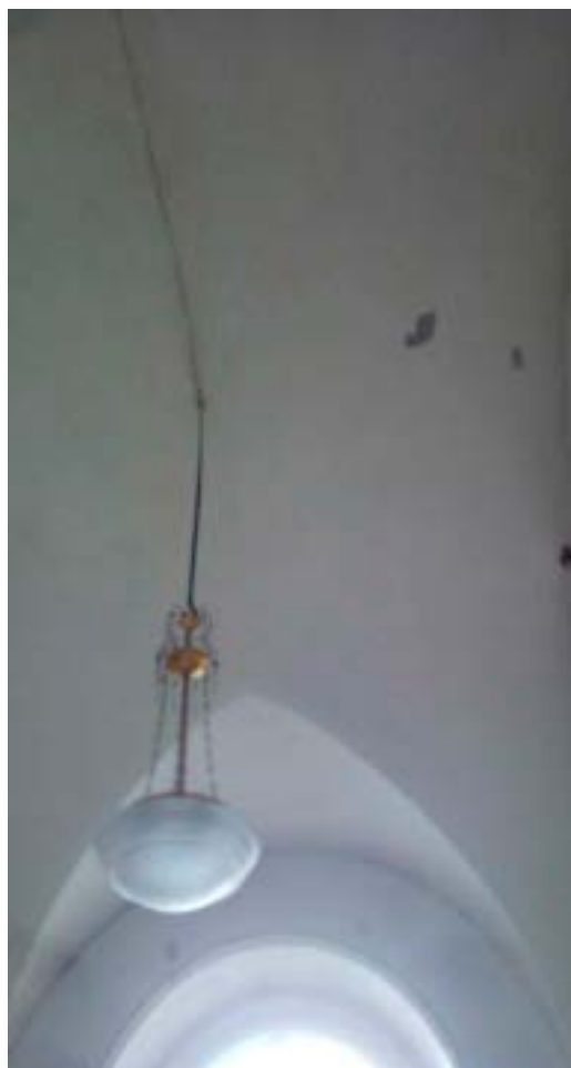
7. Помещение №4 (5Н) объекта культурного наследия федерального значения «Дом министра государственных имуществ», расположенного по адресу: г. Санкт-Петербург, Большая Морская ул., д. 44, литера А. 26.10.2021
