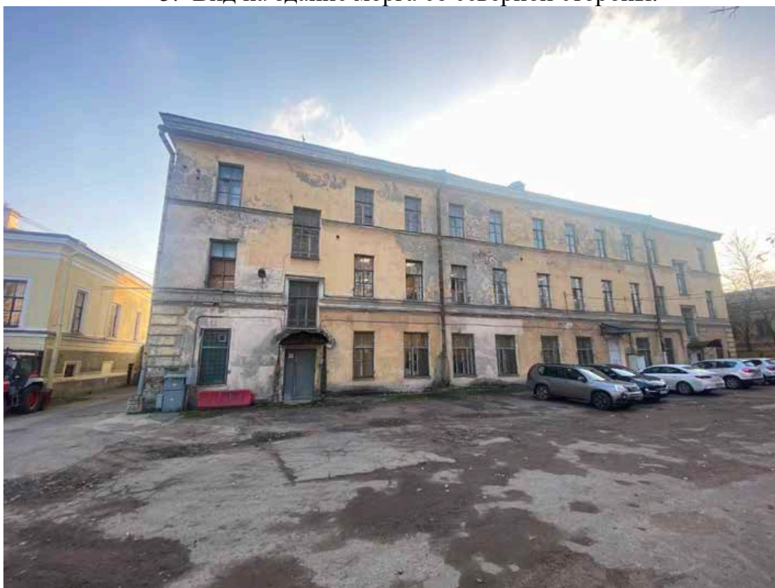
6. Вид с северной стороны на здание №132 лит. Г.
