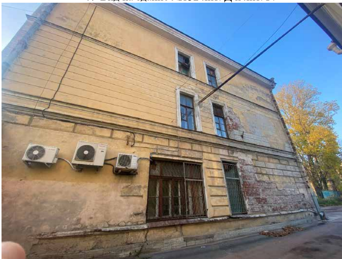
8. Вид с восточной стороны на здание №132 лит. Г.
