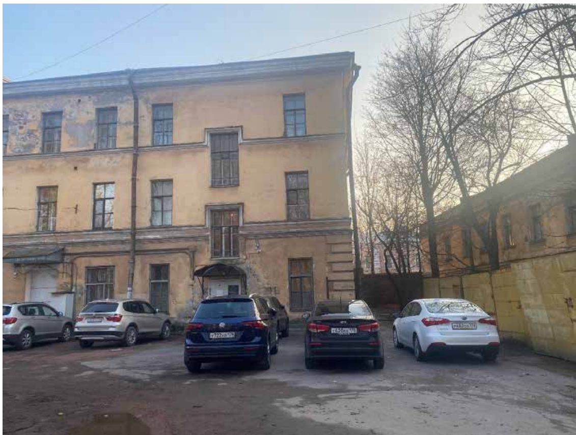
9. Вид на здание №132 лит. Г.
