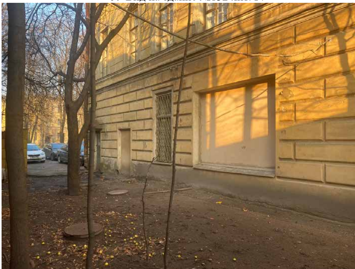
10. Вид с западной стороны на здание №132 лит. Г.
