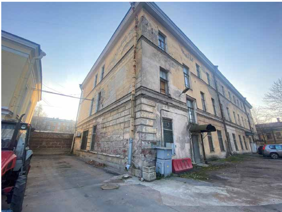
7. Вид на здание №132 лит. Д и лит. Г.
