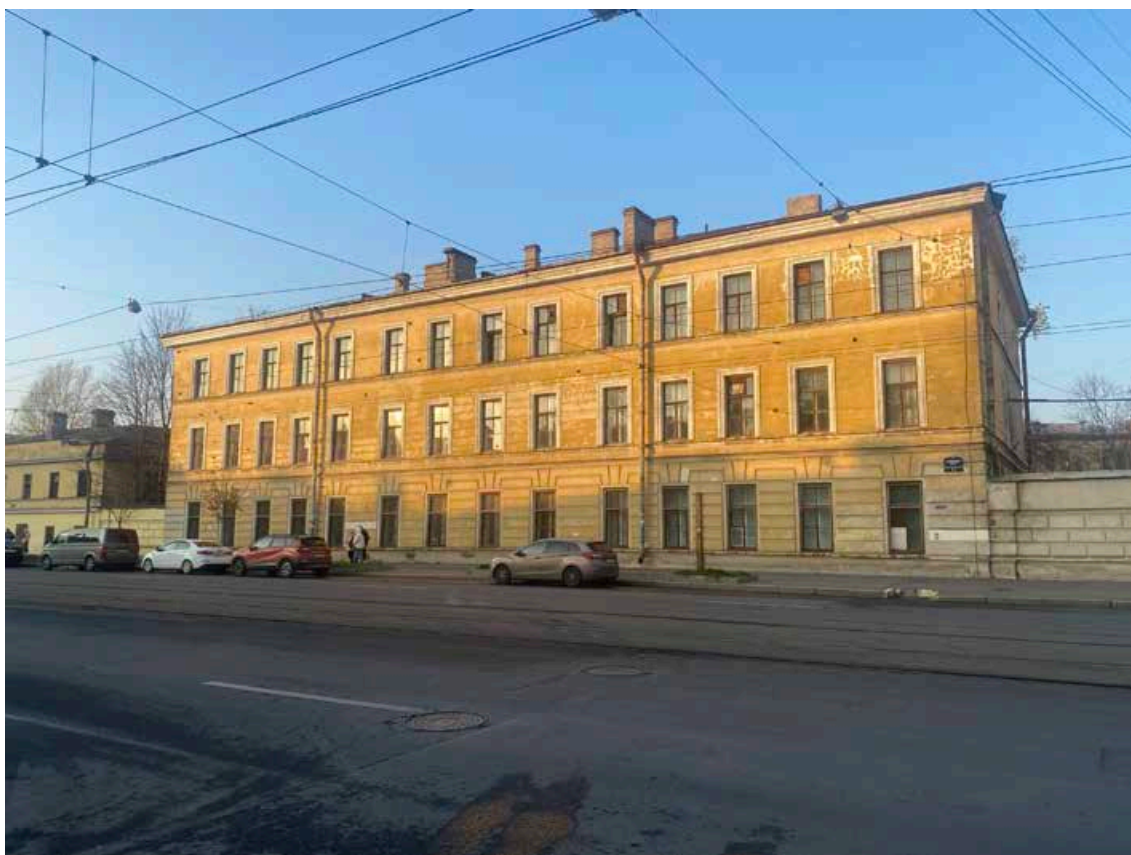
1. Вид со стороны Троицкого проспекта.
