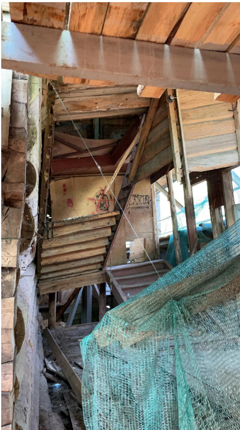
Фото 15. Вид на помещение лестничной клетки здания в осях 4-5;Д-Е. Фото 1.08.2021 г.
