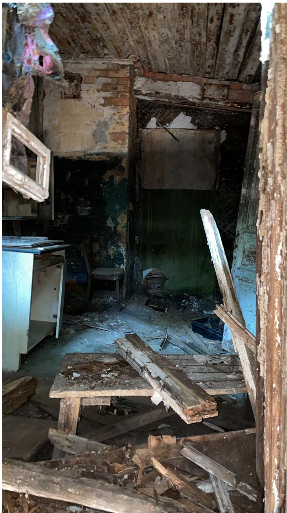
Фото 16. Вид на помещение здания в осях 3-4;Д-Е. Фото 1.08.2021 г.
