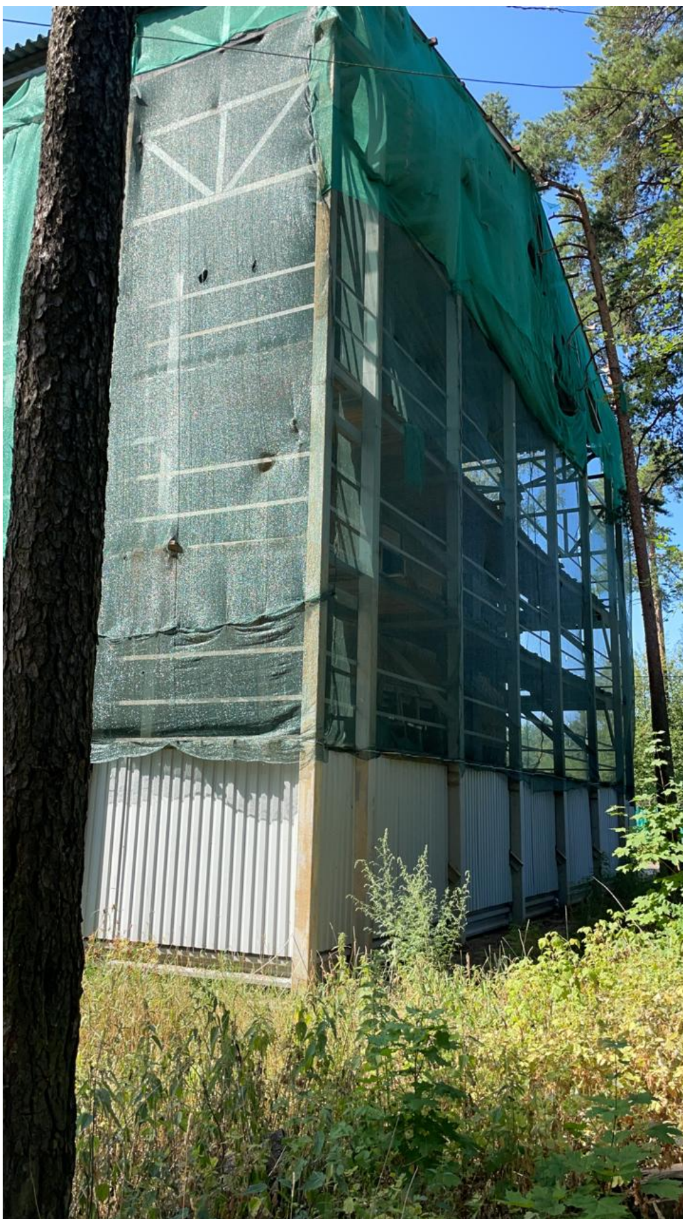
Фото 5. Вид с юго-восточного угла здания в защитном сооружении. Фасад А-Е. Фото 1.08.2021 г.
