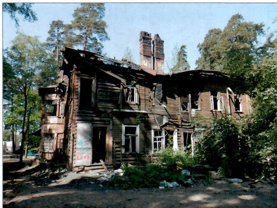
4. "Загородный дом Л.А. Змигородского". Восточный фасад.
