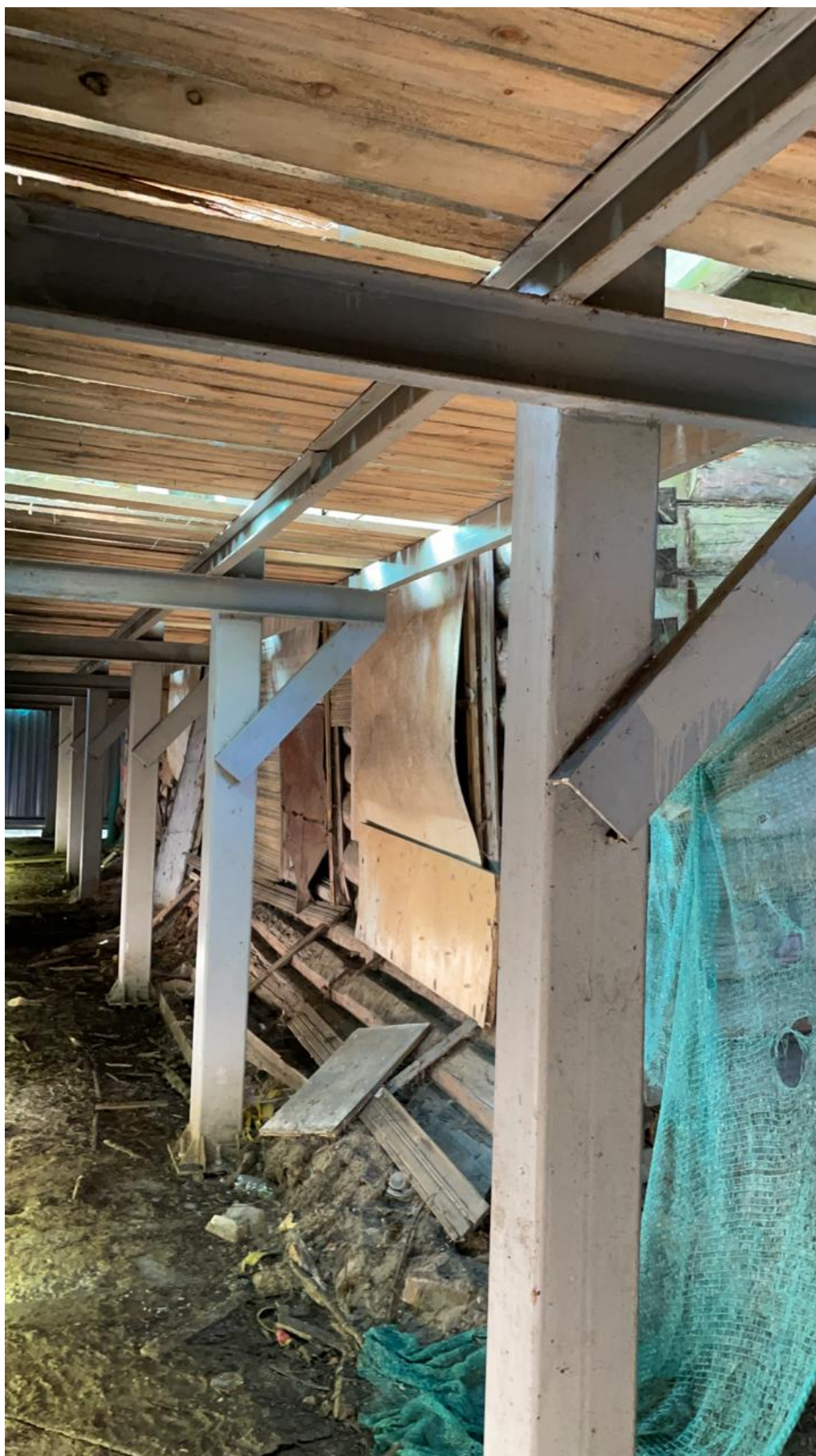
Фото 14. Вид с юго-западного угла здания под защитным сооружением. Фасад А-Е. Фото 1.08.2021 г.
