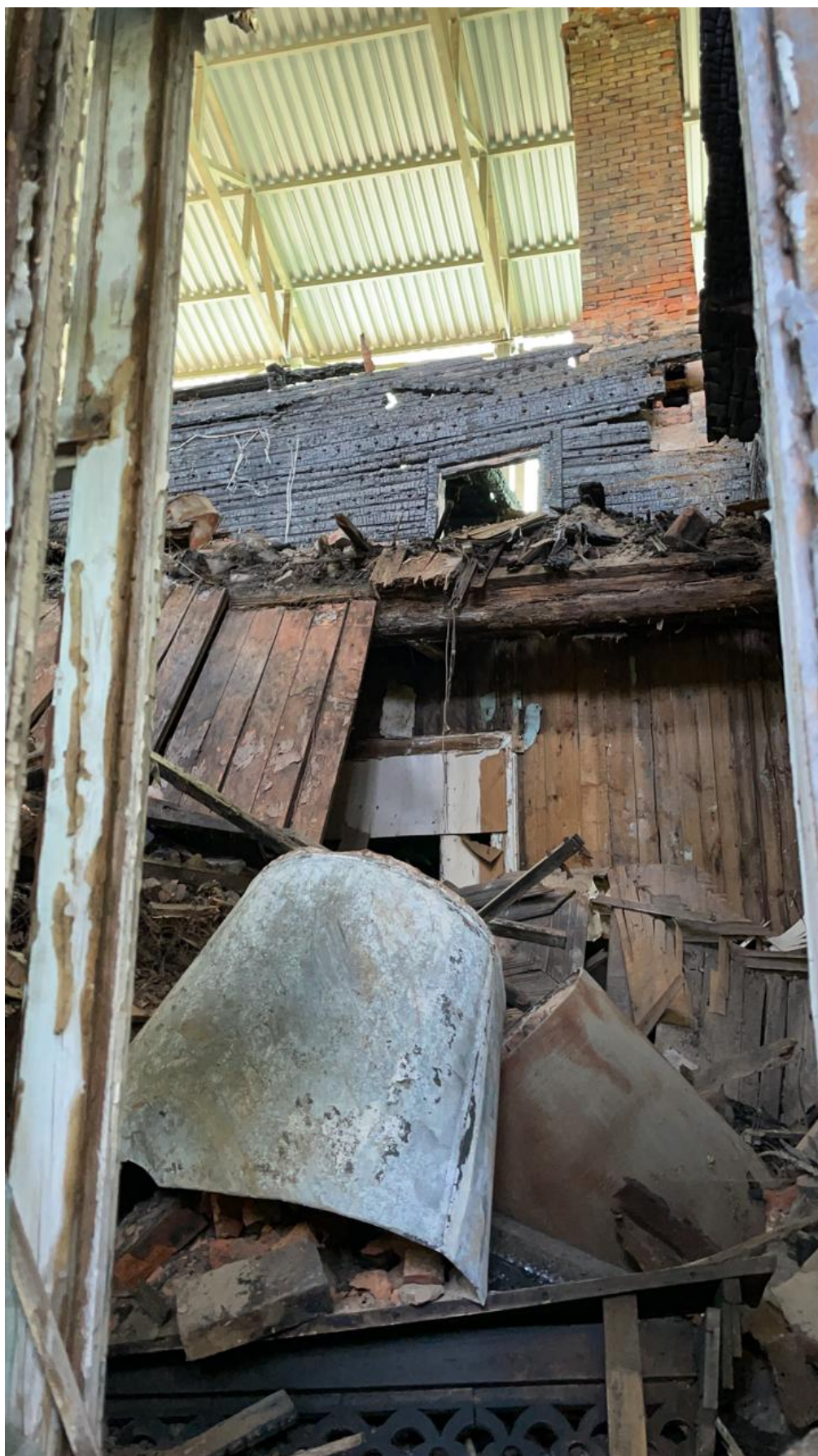
Фото 10. Вид на помещение в осях 3-4; А-Д здания. Фото 1.08.2021 г.
