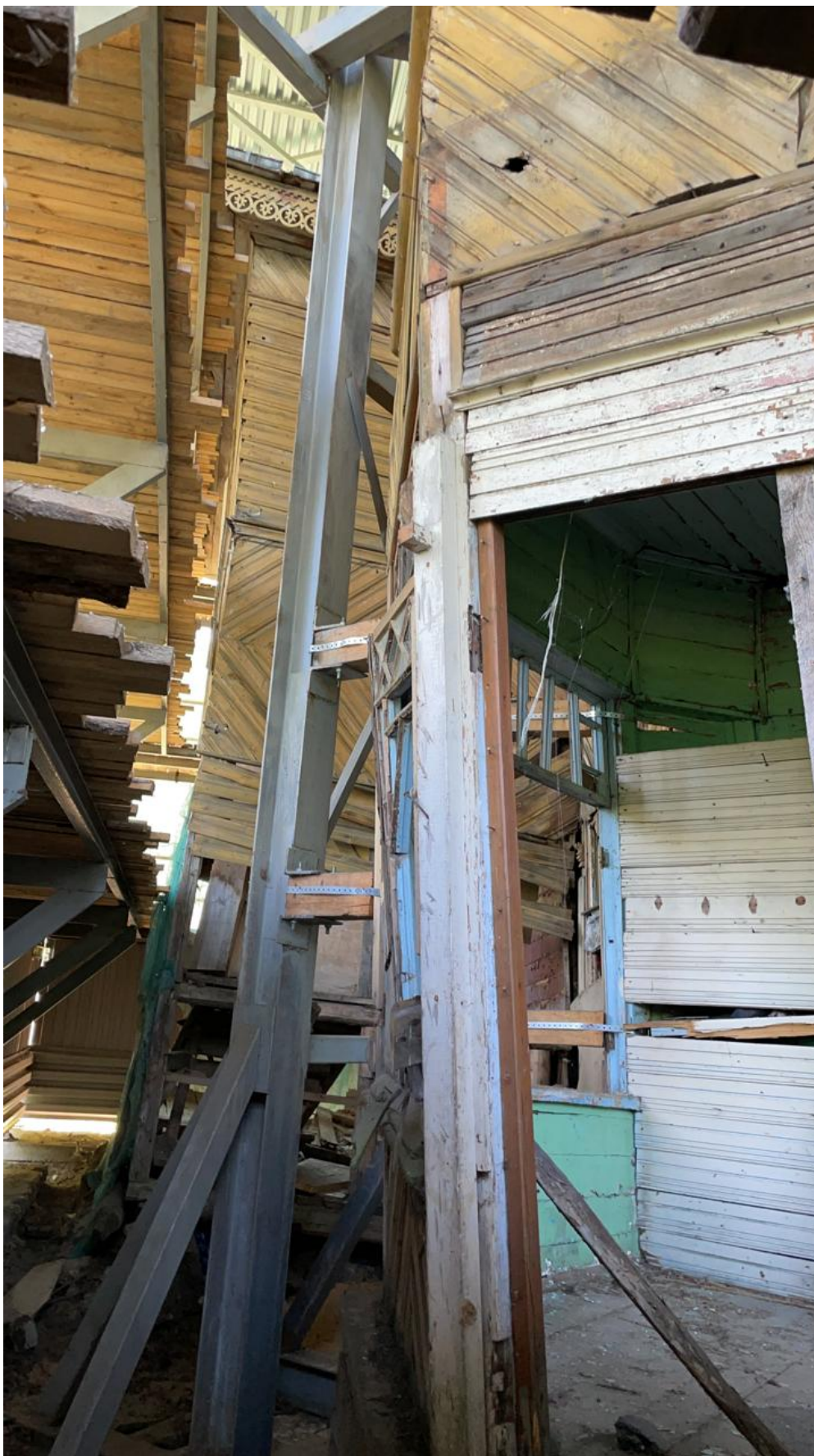
Фото 7. Вид на помещение юго-западной башни здания в защитном сооружении. Фото 1.08.2021 г.
