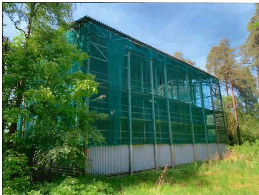
2. Общий вид объекта культурного наследия с юго-востока.
