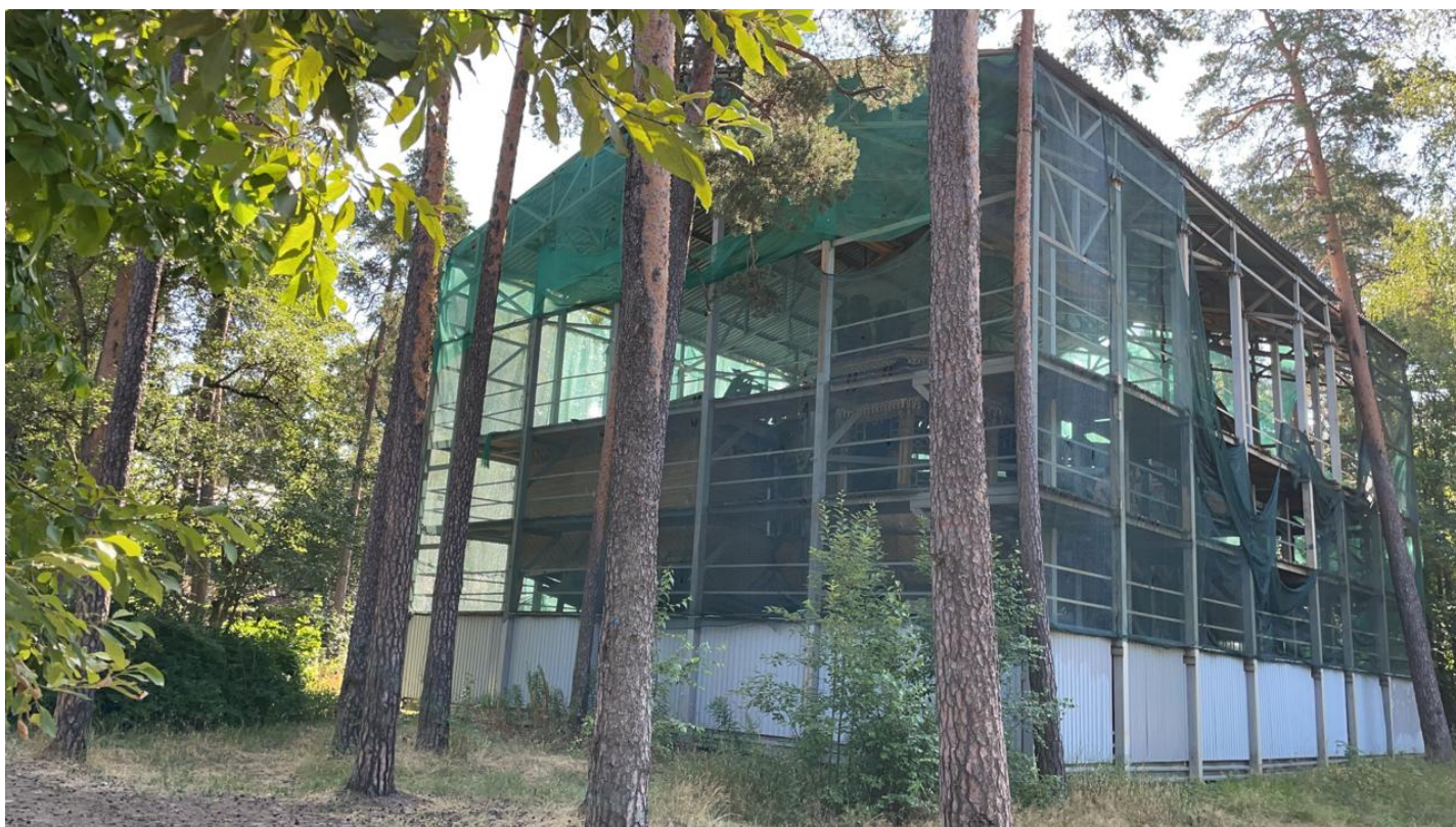
Фото 1. Общий вид здания в защитном сооружении. Северо-западная сторона. Фото 1.08.2021 г.
