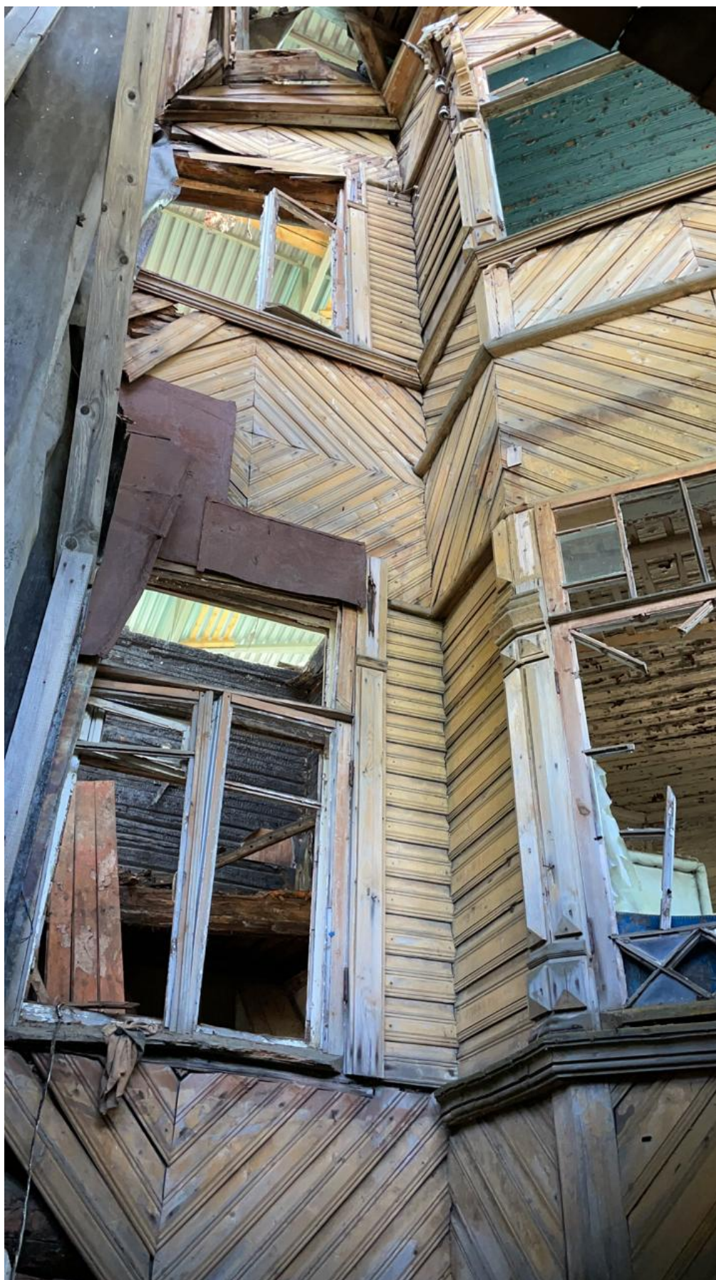
Фото 12. Вид на юго-западную башню здания. Фото 1.08.2021 г.
