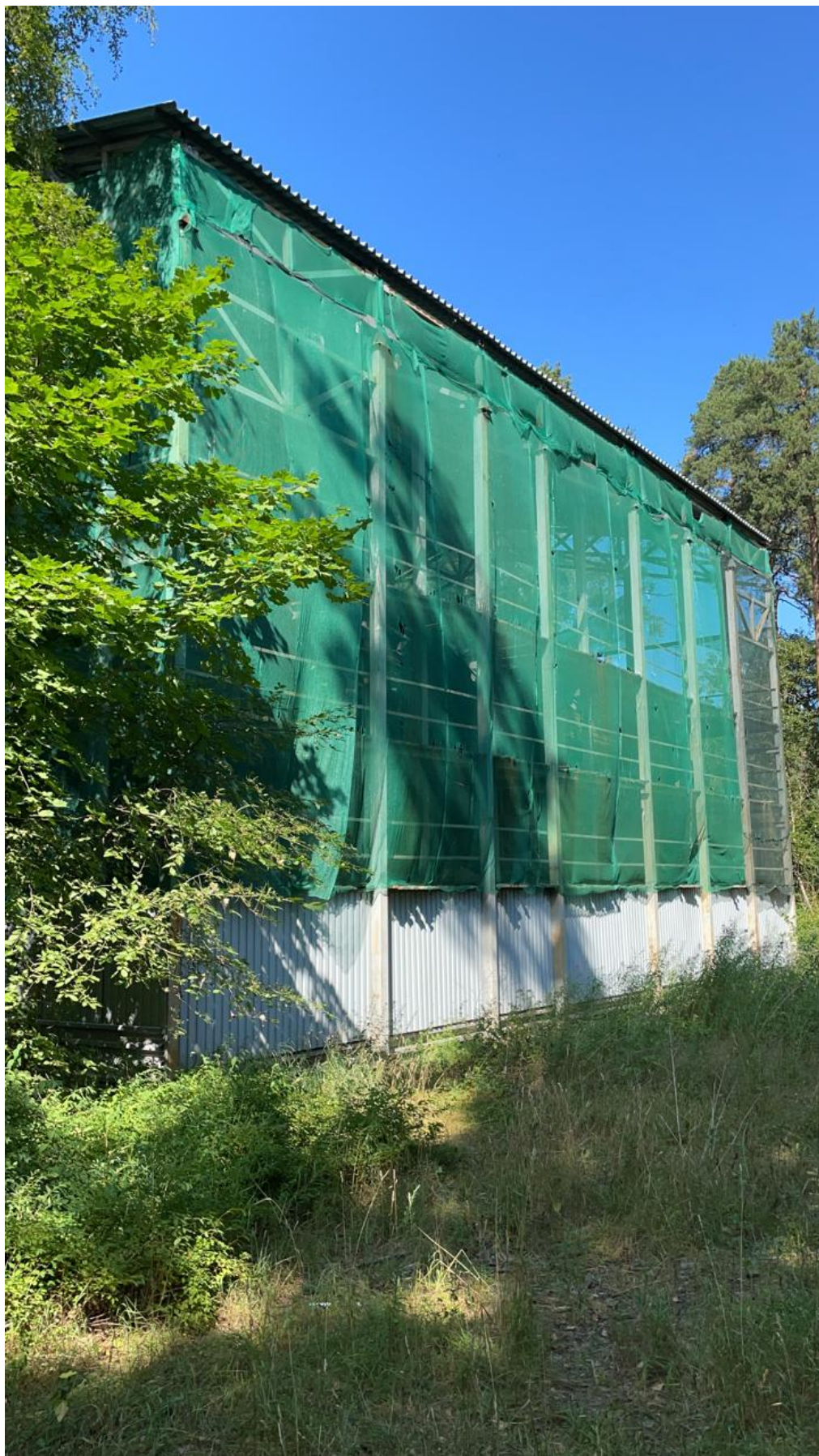
Фото 3. Вид с западного угла здания в защитном сооружении. Фасад Е-А. Фото 1.08.2021 г.
