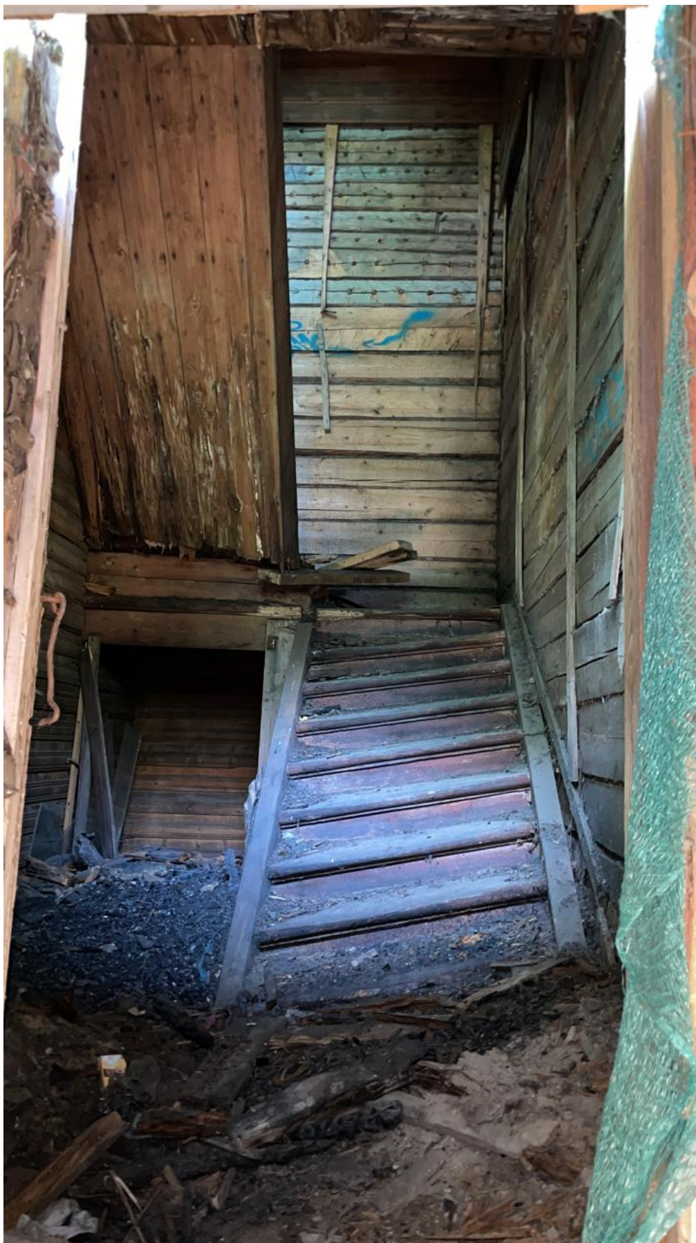
Фото 17. Вид на помещение лестничной клетки здания в осях 1;Г-Е. Фото 1.08.2021 г.
