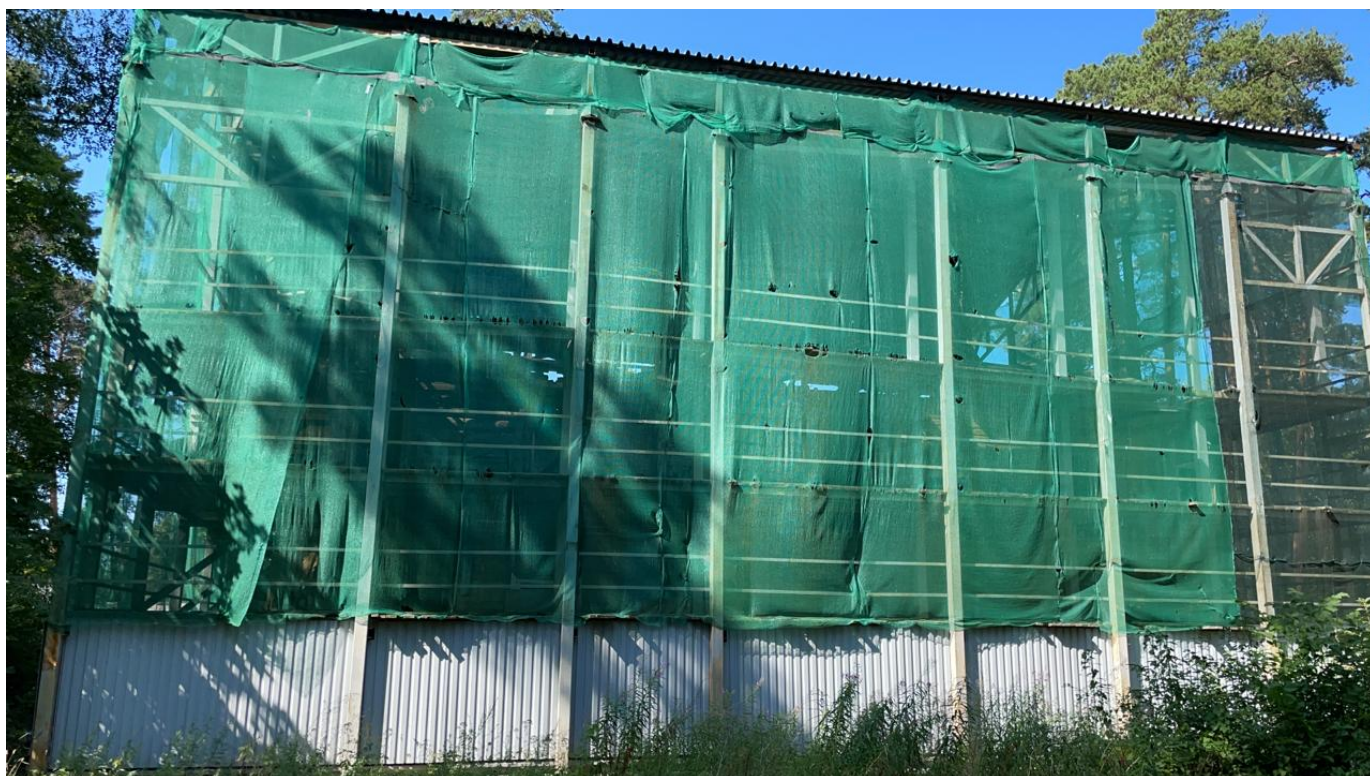
Фото 4. Вид с восточной стороны здания в защитном сооружении. Фасад 5-1. Фото 1.08.2021 г.
