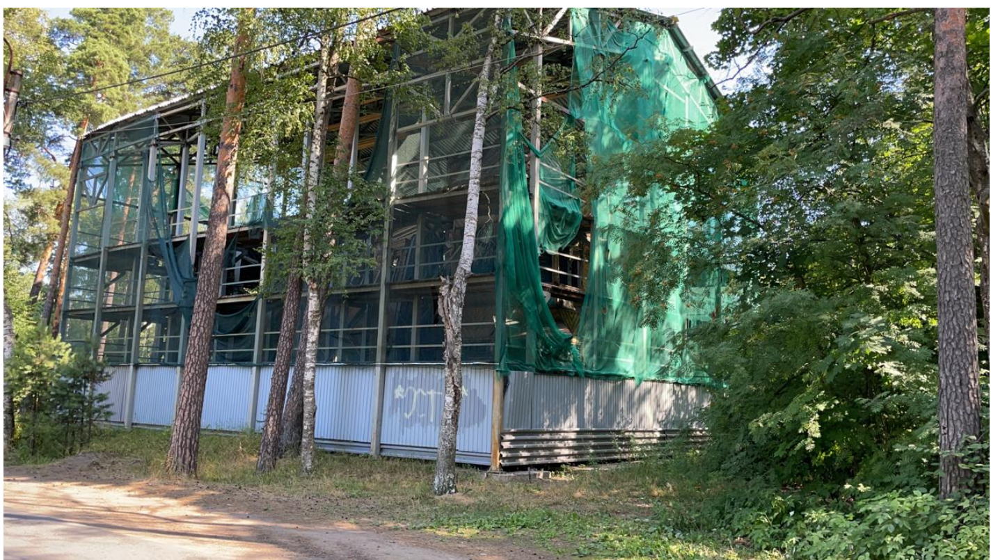
Фото 2. Общий вид здания в защитном сооружении. Юго-западная сторона. Фото 1.08.2021 г.
