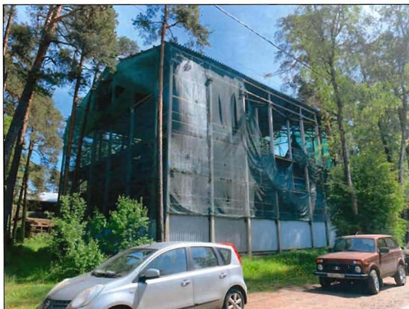
1. Общий вид объекта культурного наследия с северо-запада.
