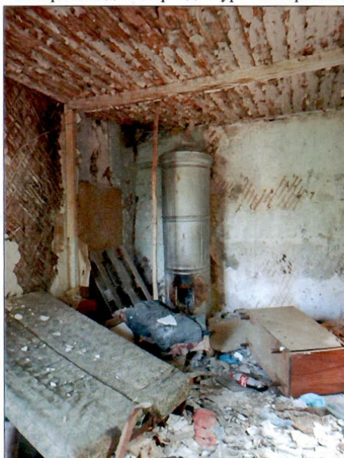
10. Помещение в южной части здания.
