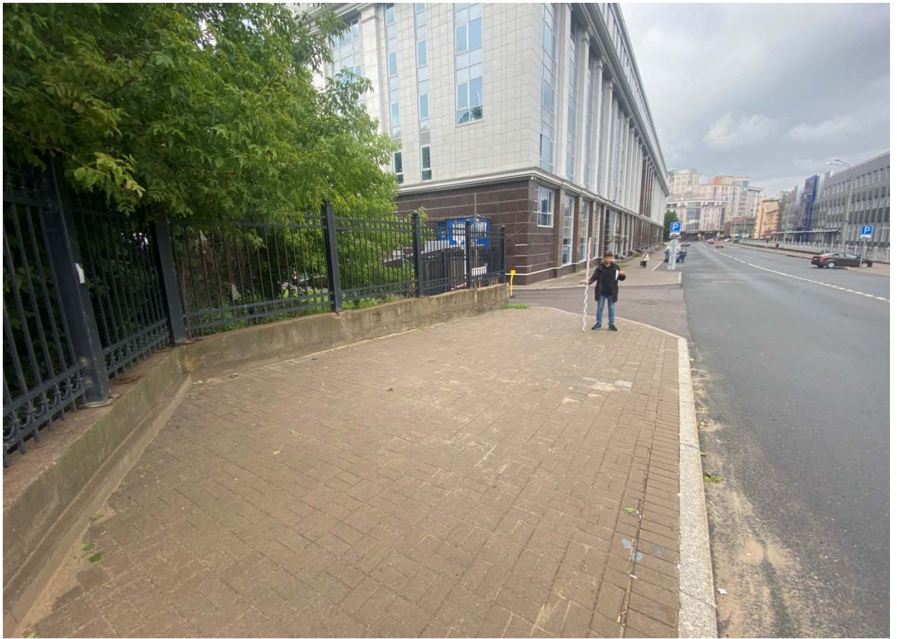
Рис. 24. СПб, Наб. р. Карповки в створе ул. Барочной. Photo 6. Общий вид территории обследования. Вид с СЗ
