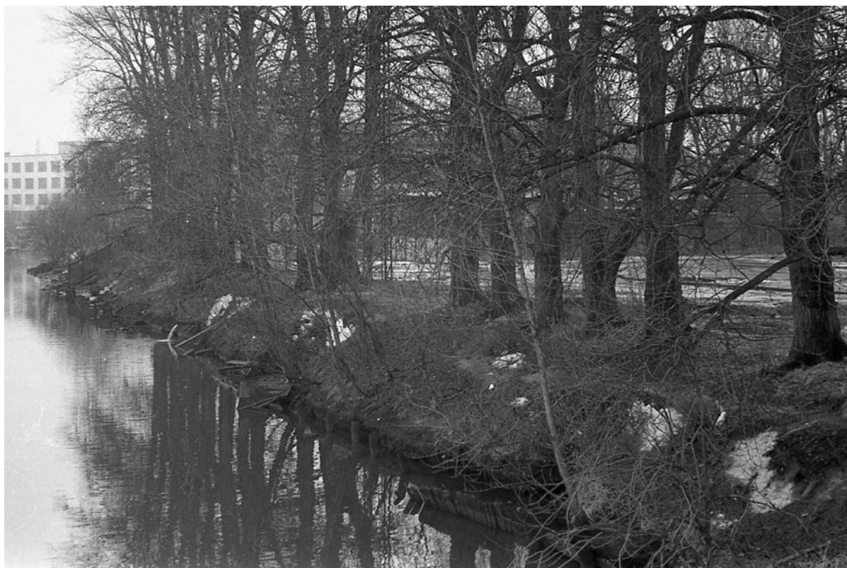
Рис. 18. СПб, Наб. р. Карповки в створе ул. Барочной. Набережная реки Карповки, 1988 г. Вид с СЗ
