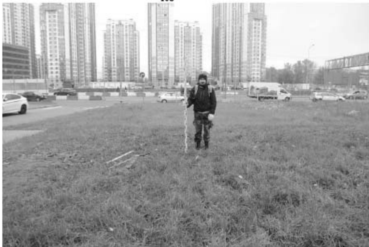
Рис. 68. Санкт-Петербург, пересечение Московского шоссе с Дунайским пр. Шурф 1. Фотофиксация до начала работ. Вид на север
