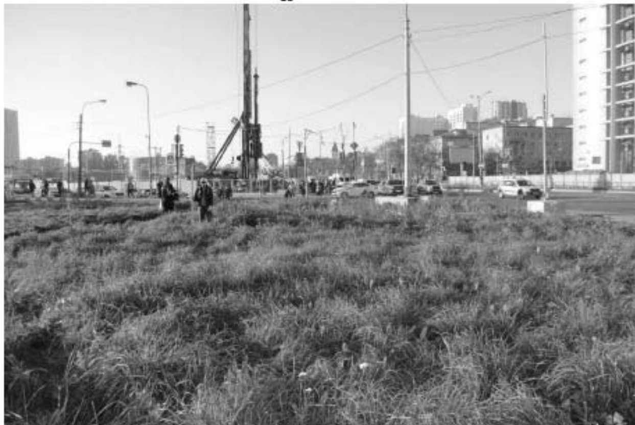
Рис. 22. Санкт-Петербург, пересечение Московского шоссе с Дунайским пр. Общий вид участка обследования. Точка съемки 4. Вид на север
