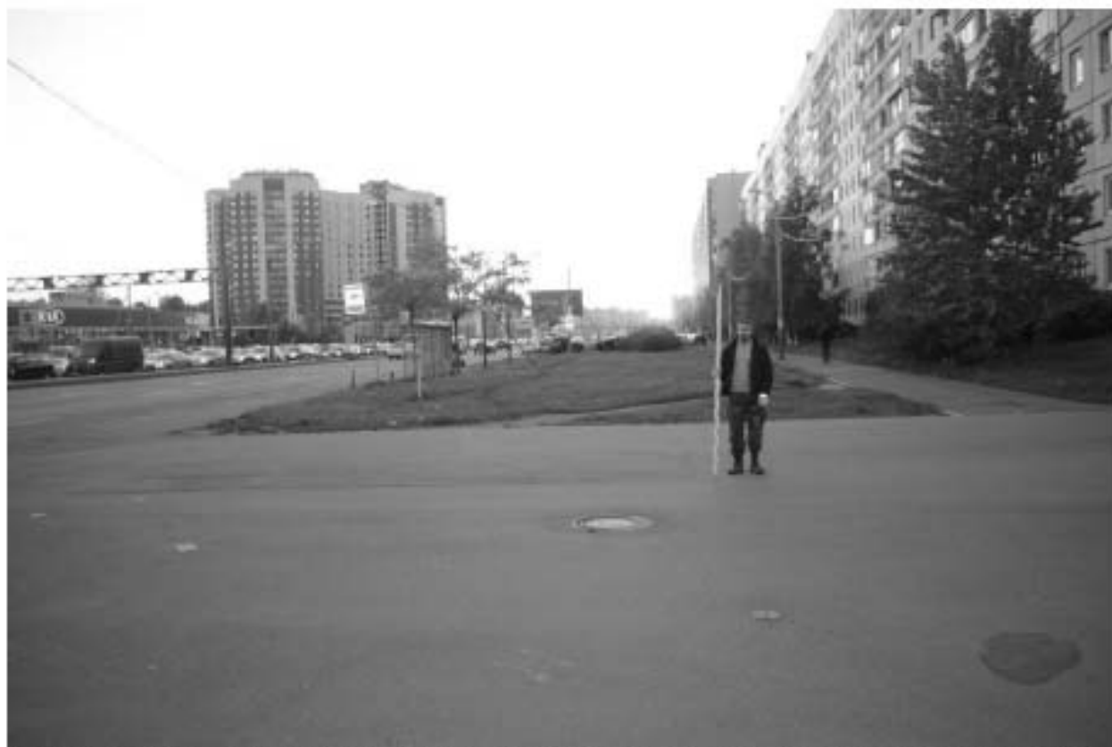
Рис. 51. Санкт-Петербург, пересечение Московского шоссе с Дунайским пр. Общий вид участка обследования. Точка съемки 16. Вид на запад
