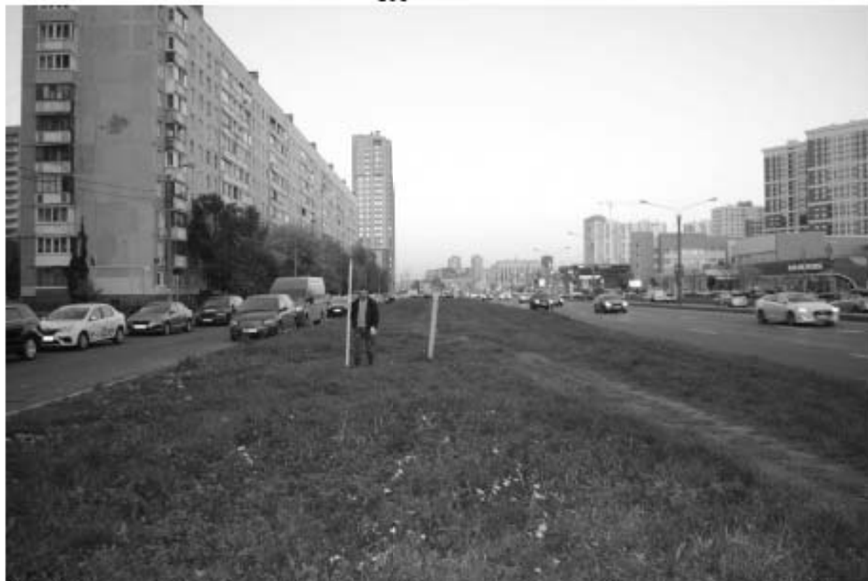
Рис. 52. Санкт-Петербург, пересечение Московского шоссе с Дунайским пр. Общий вид участка обследования. Точка съемки 17. Вид на восток
