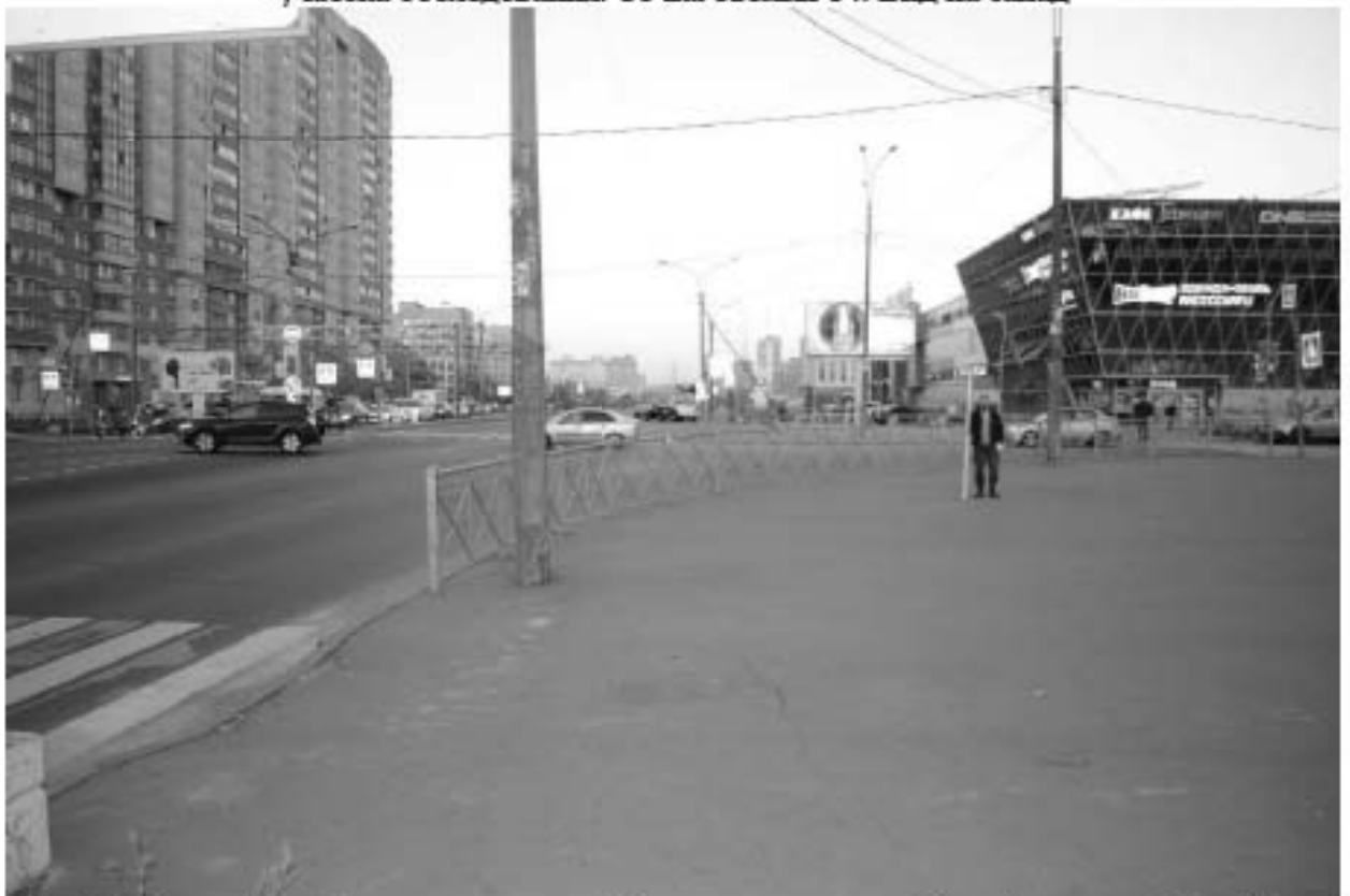
Рис. 47. Санкт-Петербург, пересечение Московского шоссе с Дунайским пр. Общий вид участка обследования. Точка съемки 15. Вид на восток
