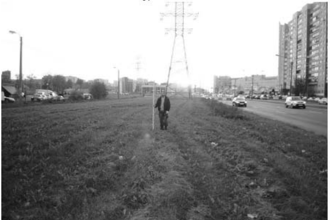
Рис. 46. Санкт-Петербург, пересечение Московского шоссе с Дунайским пр. Общий вид участка обследования. Точка съемки 14. Вид на запад
