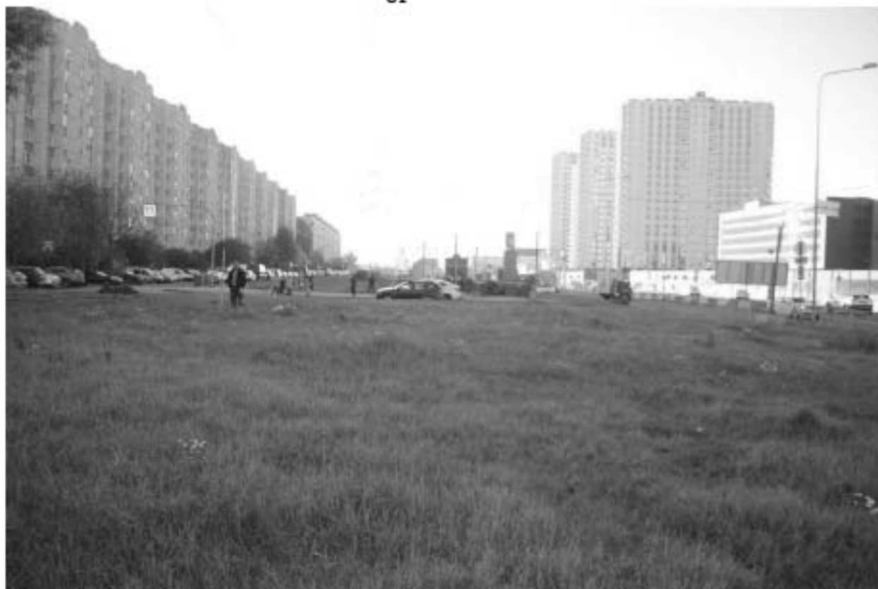
Рис. 14. Санкт-Петербург, пересечение Московского шоссе с Дунайским пр. Общий вид участка обследования. Точка съемки 1. Вид на запад
