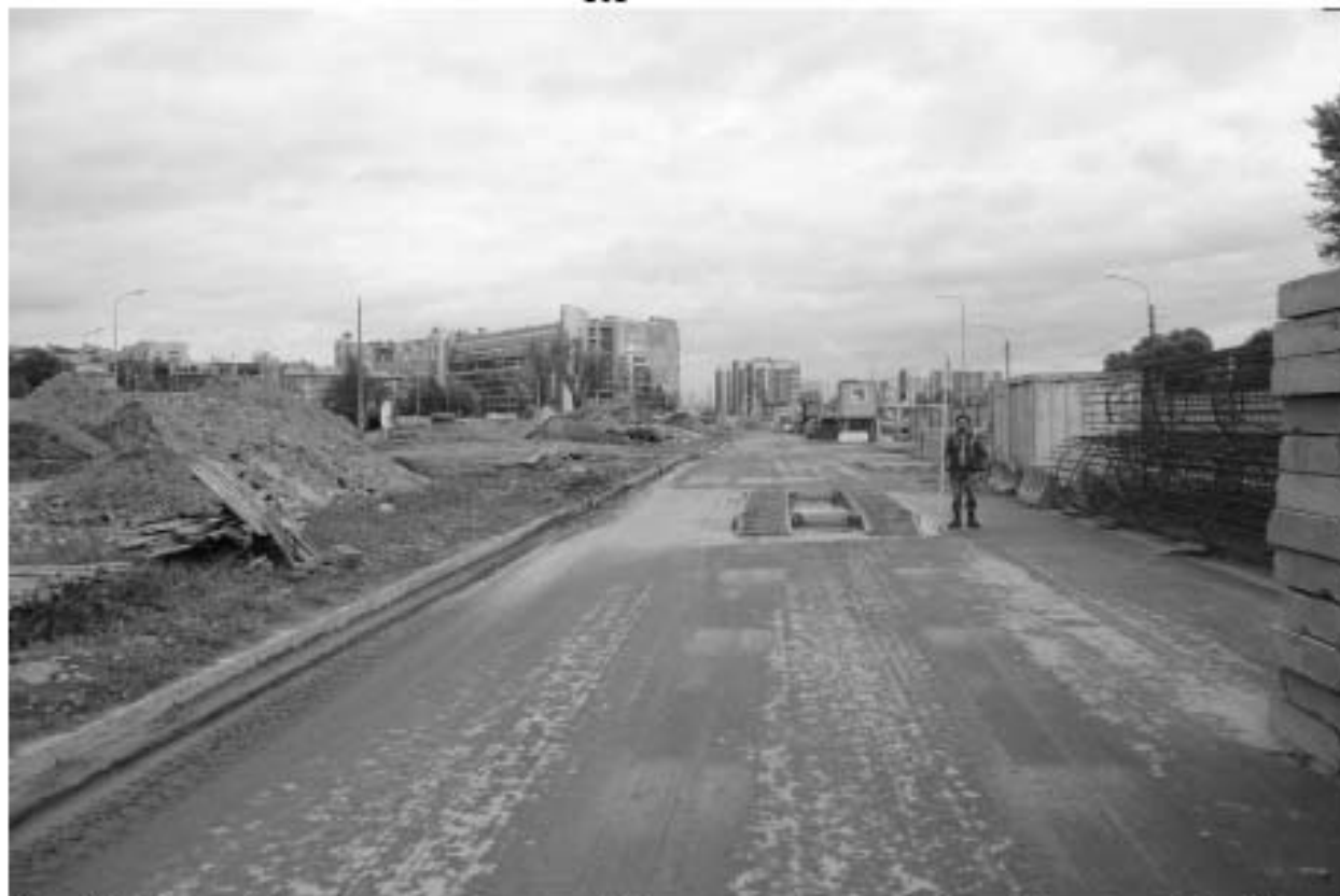
Рис. 58. Санкт-Петербург, пересечение Московского шоссе с Дунайским пр. Общий вид участка обследования. Точка съемки 20. Вид на восток
