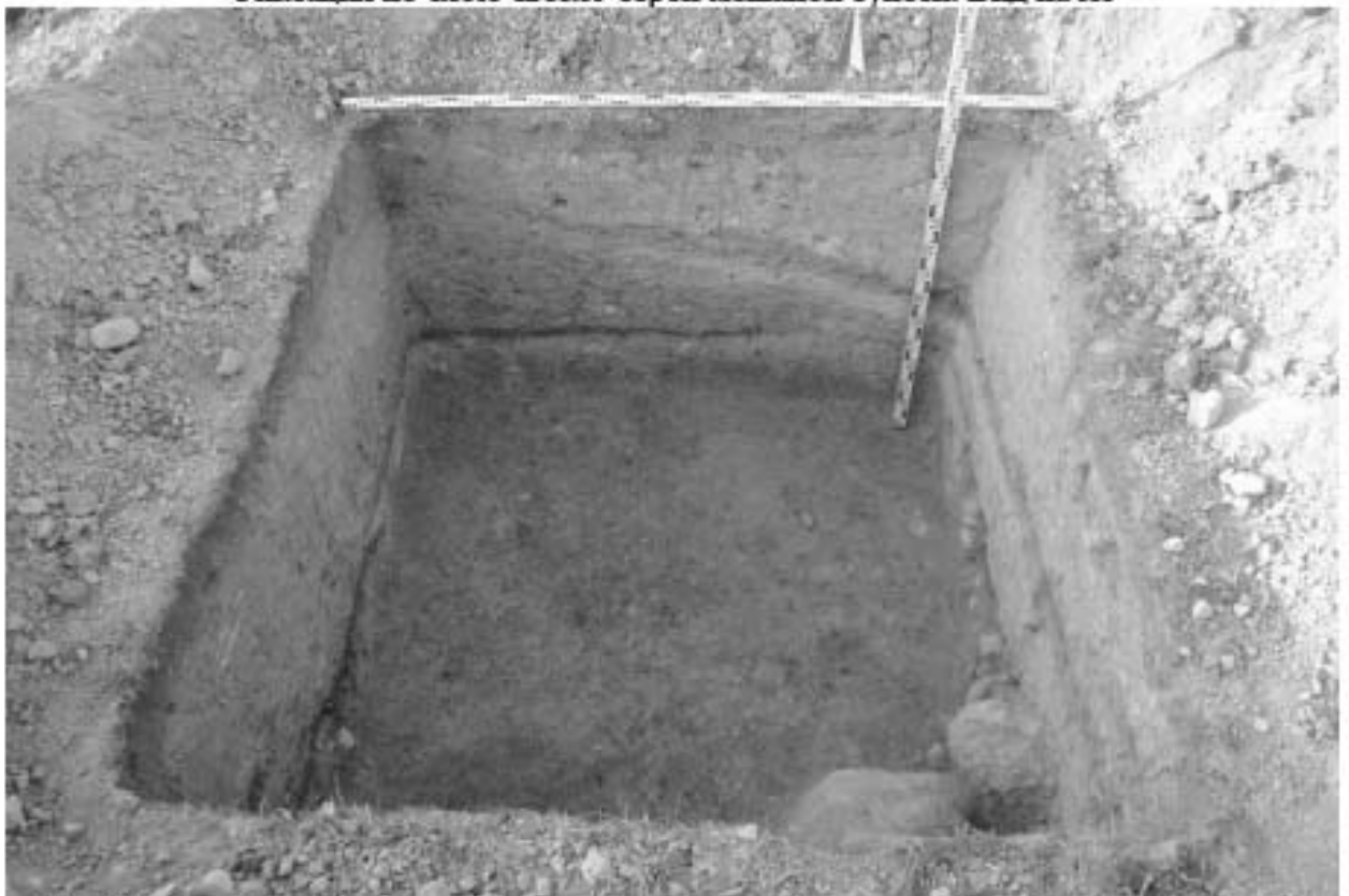
Рис. 92. Санкт-Петербург, пересечение Московского шоссе с Дунайским пр. Шурф 3. Фиксация по слою светло-желтого суглинка (материк). Уровень прекращения работ. Вид на север
