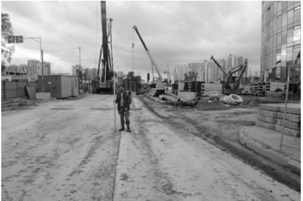
Рис. 64. Санкт-Петербург, пересечение Московского шоссе с Дунайским пр. Общий вид участка обследования. Точка съемки 24. Вид на запад
