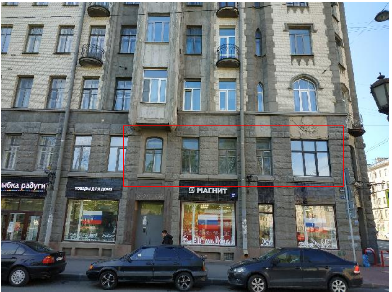
1. Оконные заполнения кв. №34 в уровне 2-го этажа выявленного объекта культурного наследия «Доходный дом сельскохозяйственного товарищества «Помещик»», расположенного по адресу: г. Санкт-Петербург, Измайловский пр., д. 16/30, литера А, по 7-ой Красноармейской. 15.09.2020.
