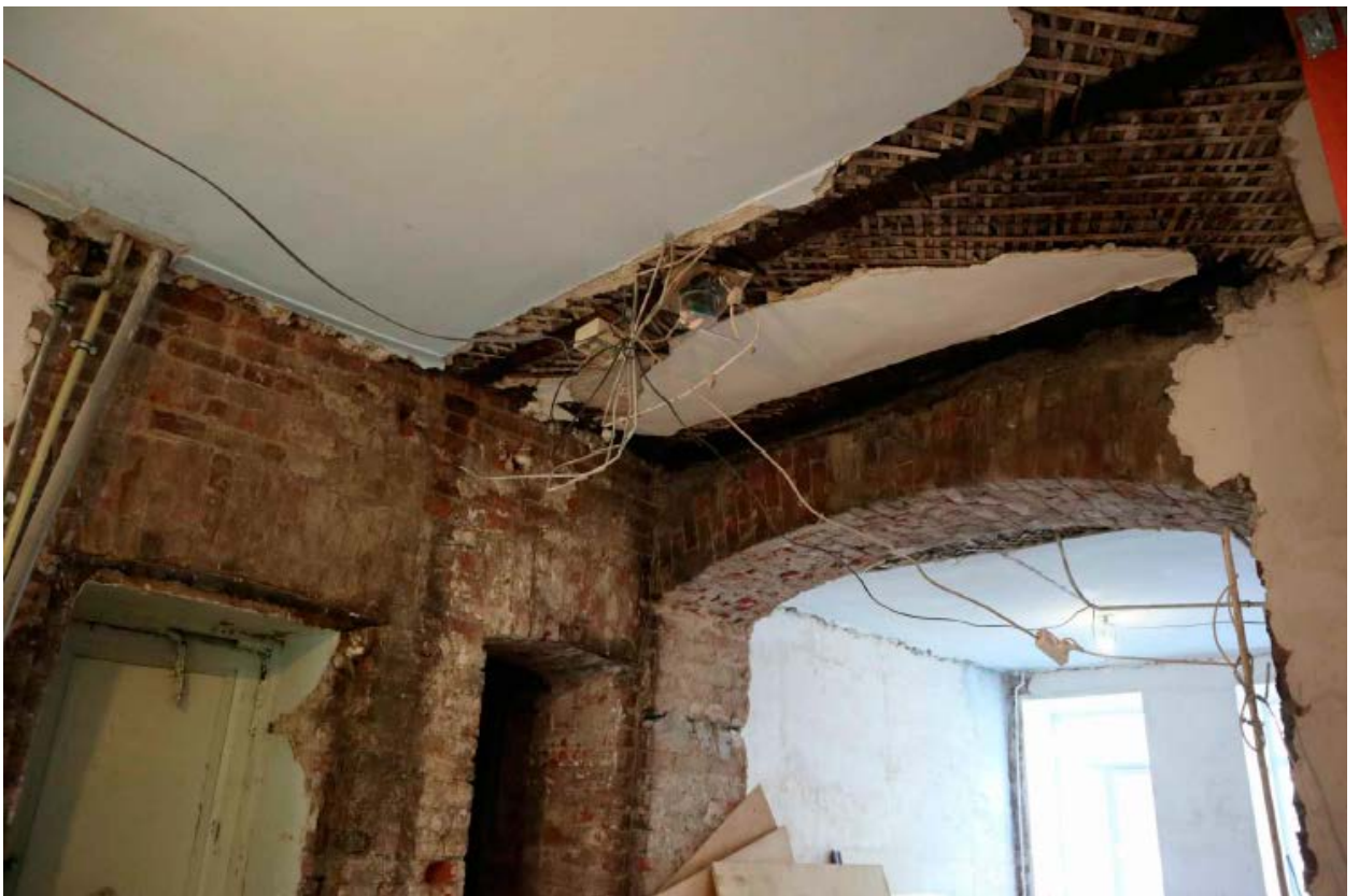
8. Помещения №№5, 1, 10 кв. №34 в уровне 2-го этажа выявленного объекта культурного наследия «Доходный дом сельскохозяйственного товарищества «Помещик»», расположенного по адресу: г. Санкт-Петербург, Измайловский пр., д. 16/30, литера А. 15.09.2020.
