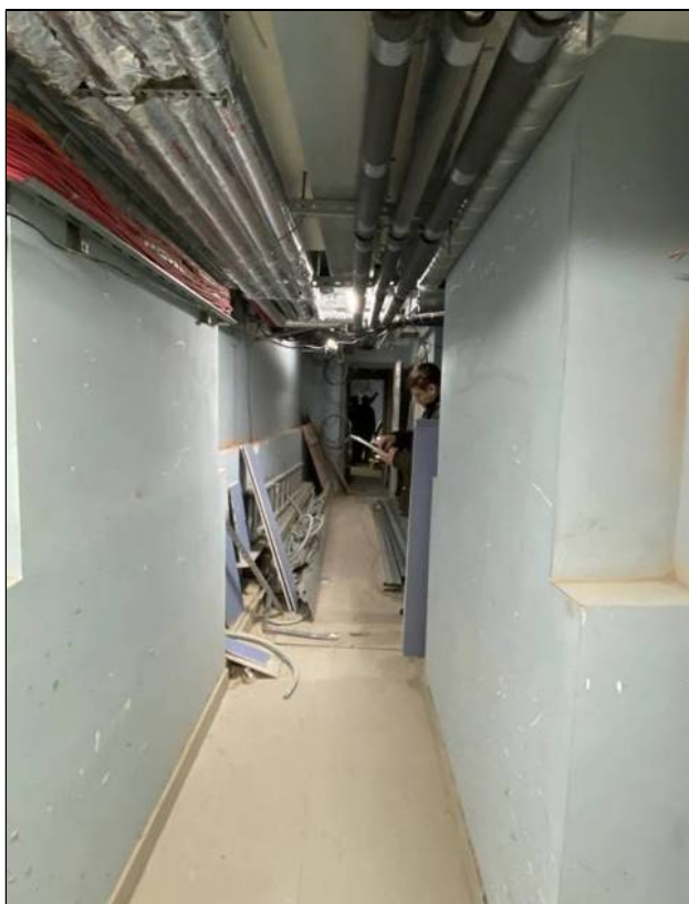
19. Объект культурного наследия «Большой железный ряд или Кожевенная линия». Северный корпус. Подвал, коридор вдоль помещений №№ 14, 27. Вид от помещения № 15. 24.02.2021 г.
