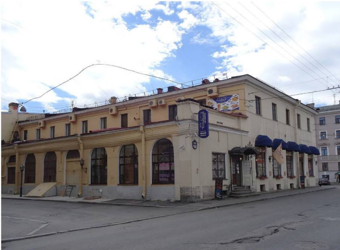
Илл. 47. Малый гостиный двор. Угол канала и Москательного переулка. Вид с набережной канала Грибоедова. с сайта citywalls.ru. Фото - Наталия, 06.2013.
