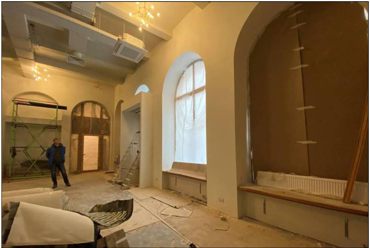
40. Объект культурного наследия «Большой железный ряд или Кожевенная линия». Средний корпус. 1-й этаж, южная часть помещения № 118. Вид от входа в помещения северного корпуса. 24.02.2021 г.
