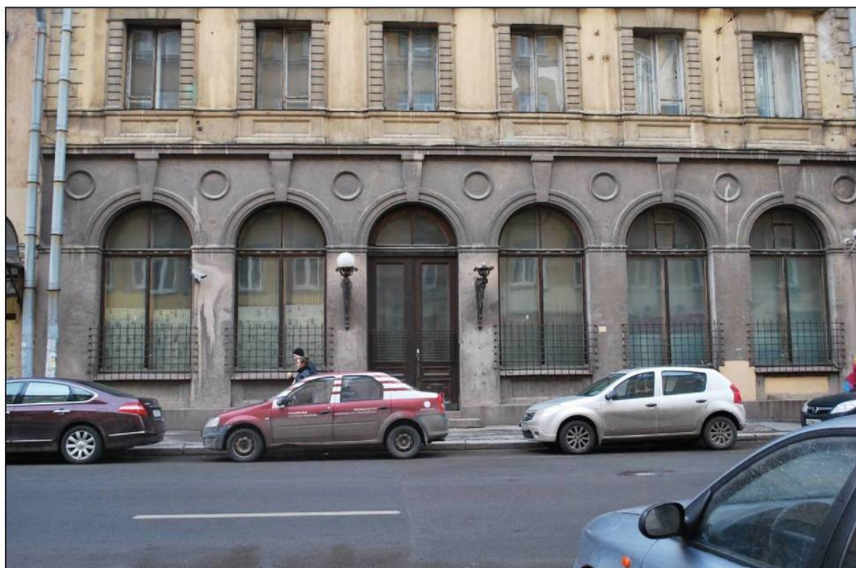
Илл. 185. Объект культурного наследия «Большой железный ряд или Кожевенная линия». Средний корпус. Фрагмент лицевого фасада по Мучному переулку. Оконные проемы 1-го и 2-го этажей. 31.03.2019 г.
