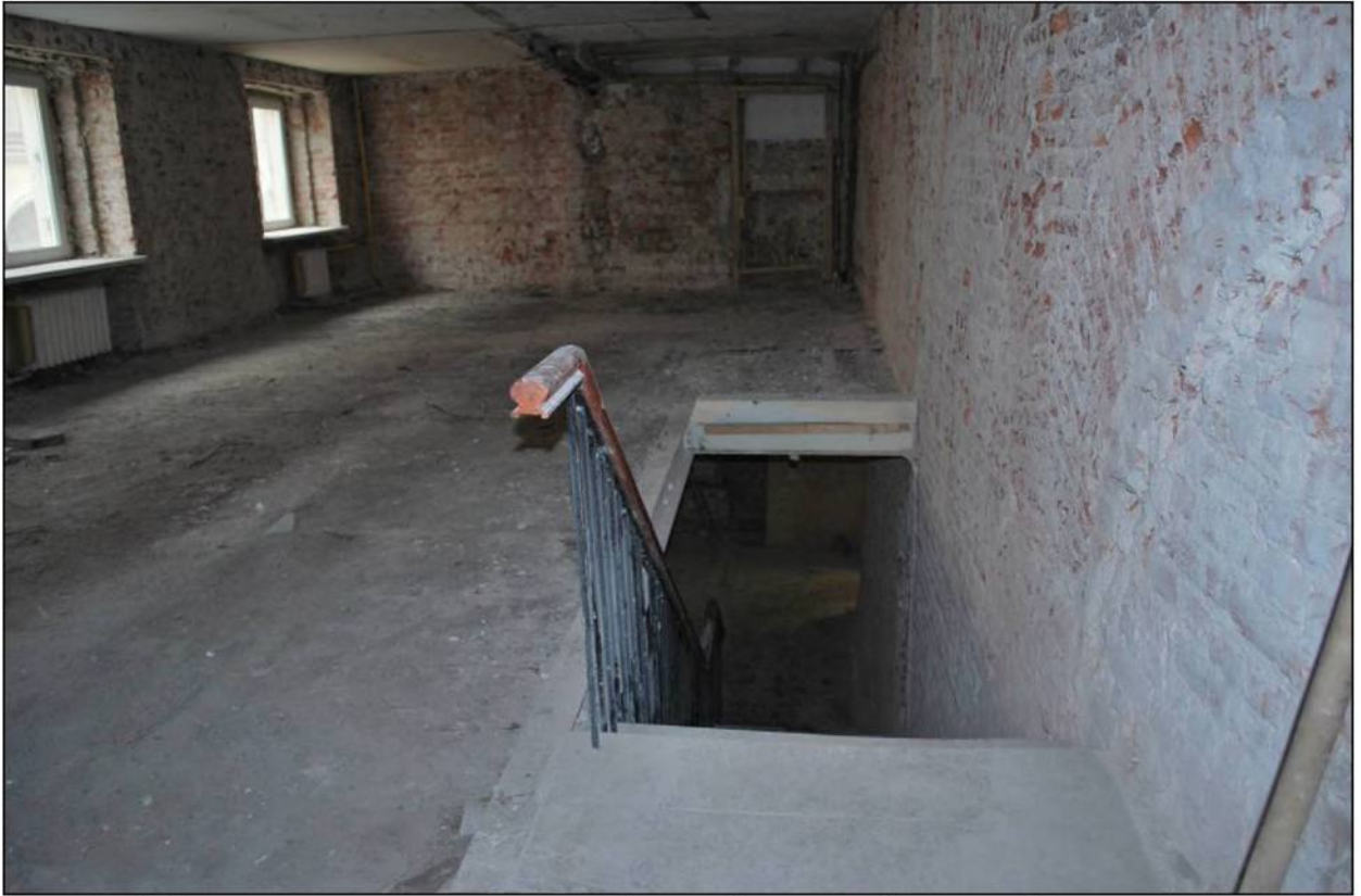
Илл. 231. Объект культурного наследия «Большой железный ряд или Кожевенная линия». Средний корпус. 2-й этаж, помещение № 63. 31.03.2019 г.
