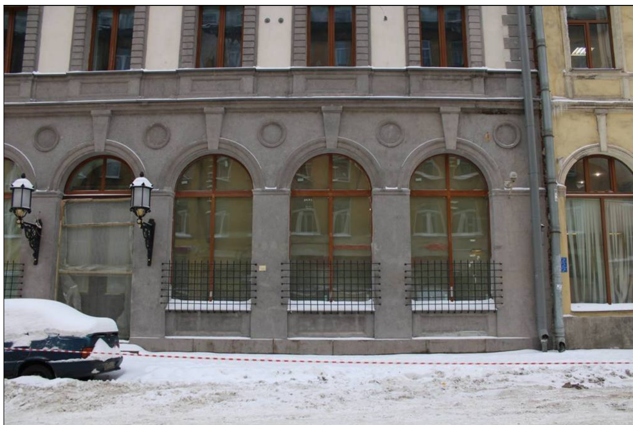
5. Объект культурного наследия «Большой железный ряд или Кожевенная линия». Средний корпус. Фрагмент лицевого фасада по Мучному переулку. Оконные проемы 1-го этажа. 24.02.2021 г.
