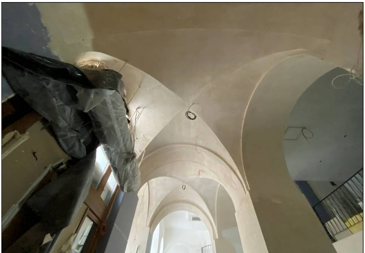
45. Объект культурного наследия «Большой железный ряд или Кожевенная линия». Северный корпус. 1-й этаж, помещение № 101. Своды. 24.02.2021 г.
