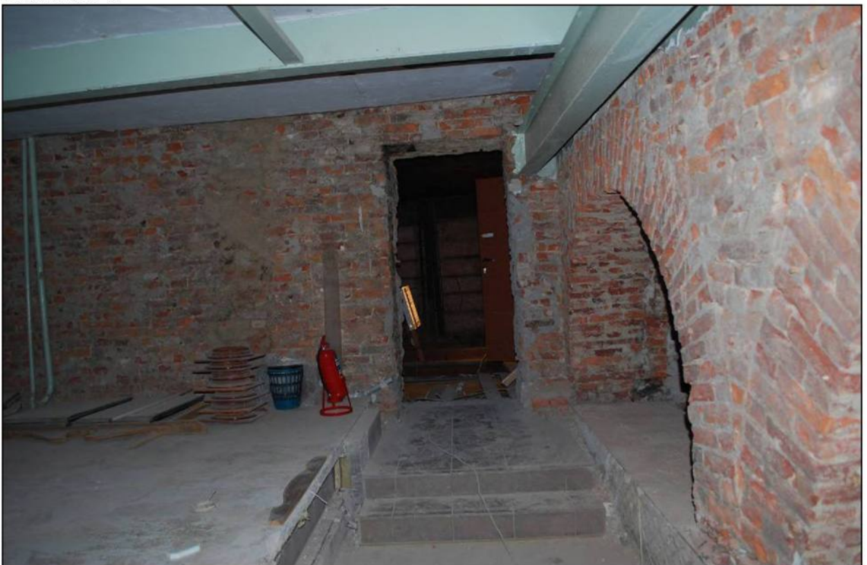
Илл. 226. Объект культурного наследия «Большой железный ряд или Кожевенная линия». Средний корпус. 2-й этаж, северо-западная часть помещения № 68, вход в помещение № 70. 31.03.2019 г.
