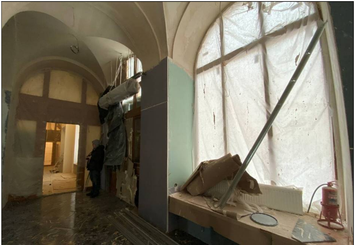
48. Объект культурного наследия «Большой железный ряд или Кожевенная линия». Северный корпус. 1-й этаж, оконный и дверные проемы в южной части помещения № 101. 24.02.2021 г.
