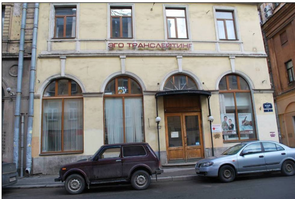
Илл. 193. Объект культурного наследия «Большой железный ряд или Кожевенная линия». Южный корпус. Фрагмент лицевого фасада по Мучному переулку. Оконные проемы 1-го и 2-го этажей. 31.03.2019 г.
