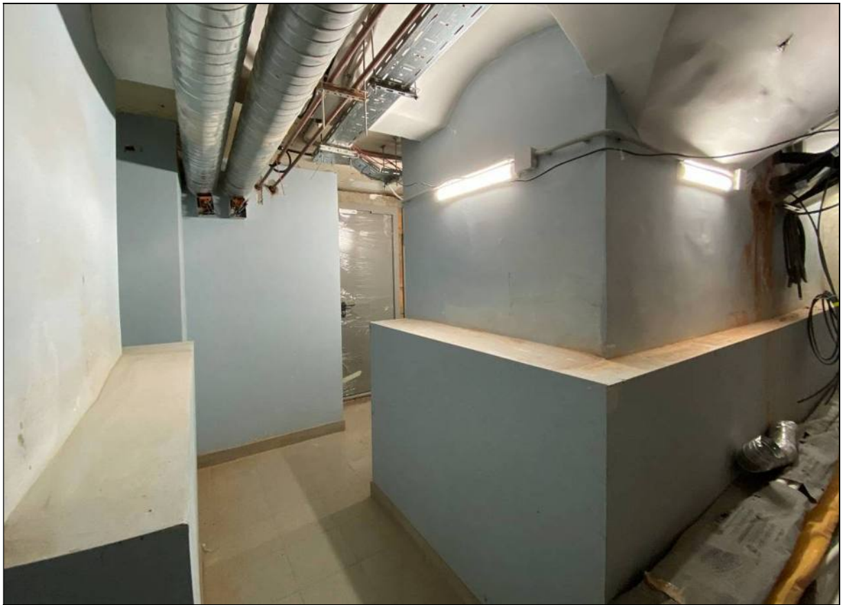
25. Объект культурного наследия «Большой железный ряд или Кожевенная линия». Северный корпус. Подвал, проход к помещениям №№ 13, 22. Капитальная стена по оси Д. 24.02.2021 г.
