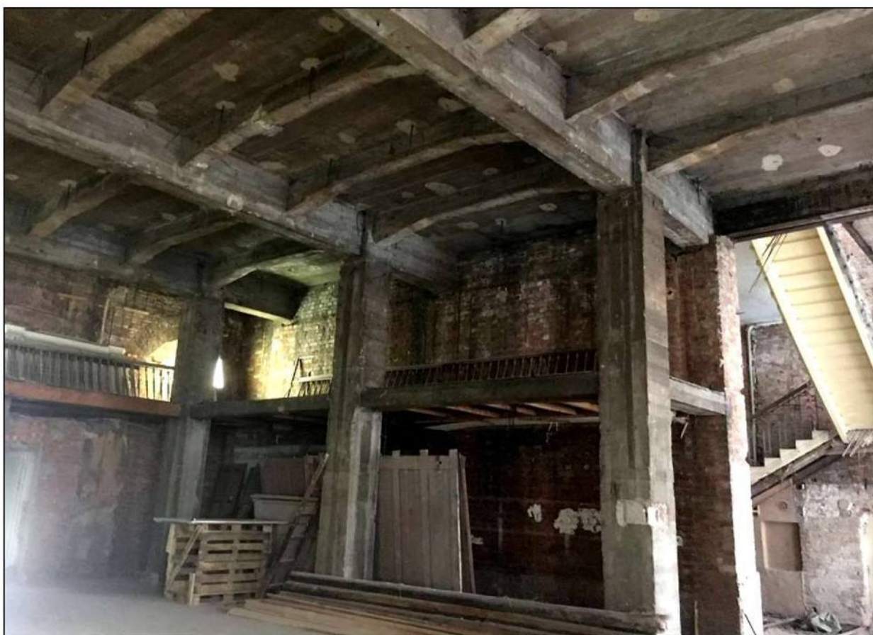
Илл. 206. Объект культурного наследия «Большой железный ряд или Кожевенная линия». Средний корпус. 1-й этаж, восточная часть помещения № 48. 31.03.2019 г.
