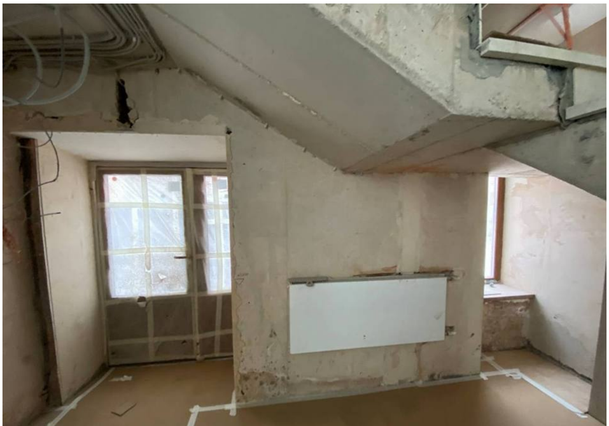
57. Объект культурного наследия «Большой железный ряд или Кожевенная линия». Средний корпус. 1-й этаж, помещение № 113. Дверной и оконные проемы. 24.02.2021 г.
