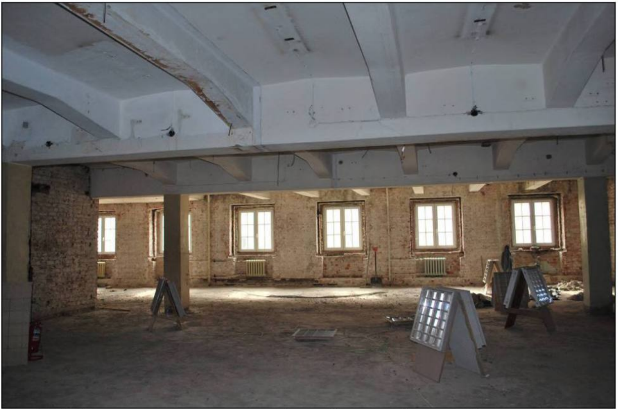
Илл. 243. Объект культурного наследия «Большой железный ряд или Кожевенная линия». Средний корпус. 4-й этаж, помещения №№ 104-119, вид на юг. 31.03.2019 г.
