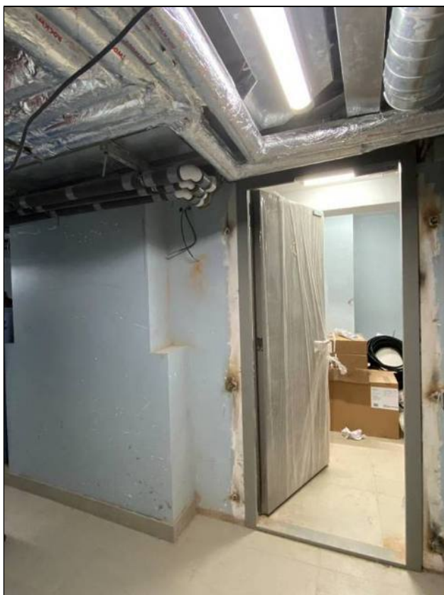
21. Объект культурного наследия «Большой железный ряд или Кожевенная линия». Северный корпус. Вход в помещение № 42. 24.02.2021 г.
