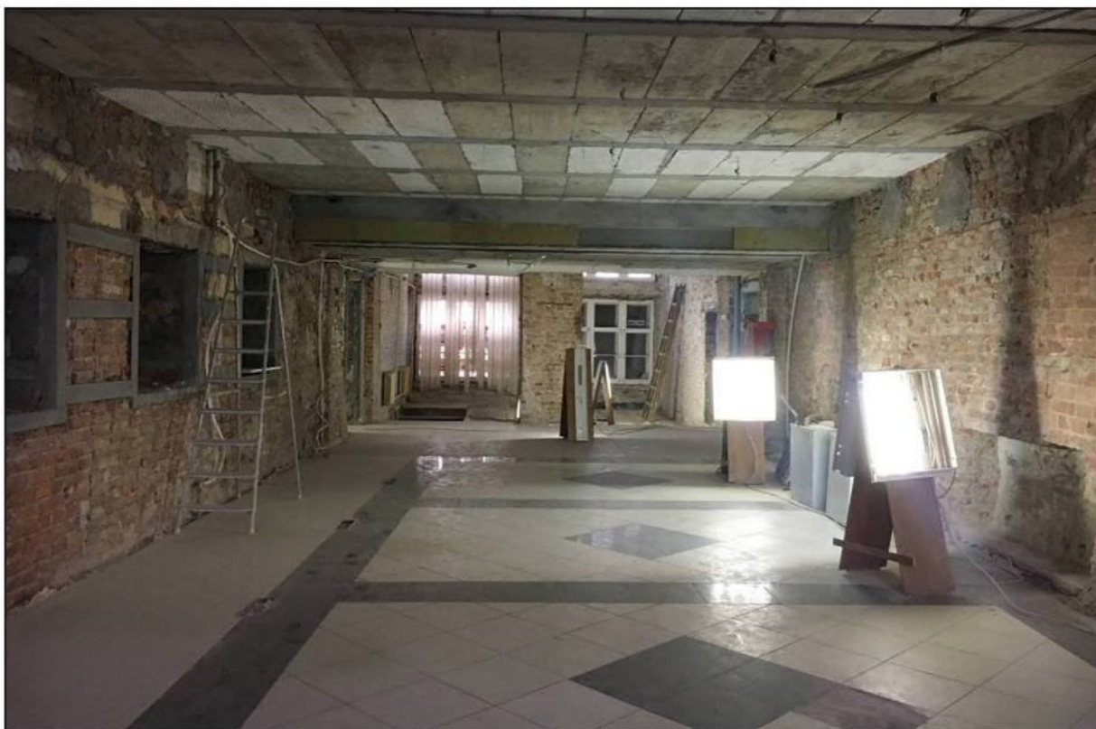
Илл. 209. Объект культурного наследия «Большой железный ряд или Кожевенная линия». Средний корпус. 1-й этаж, помещения №№ 41-45. 31.03.2019 г.
