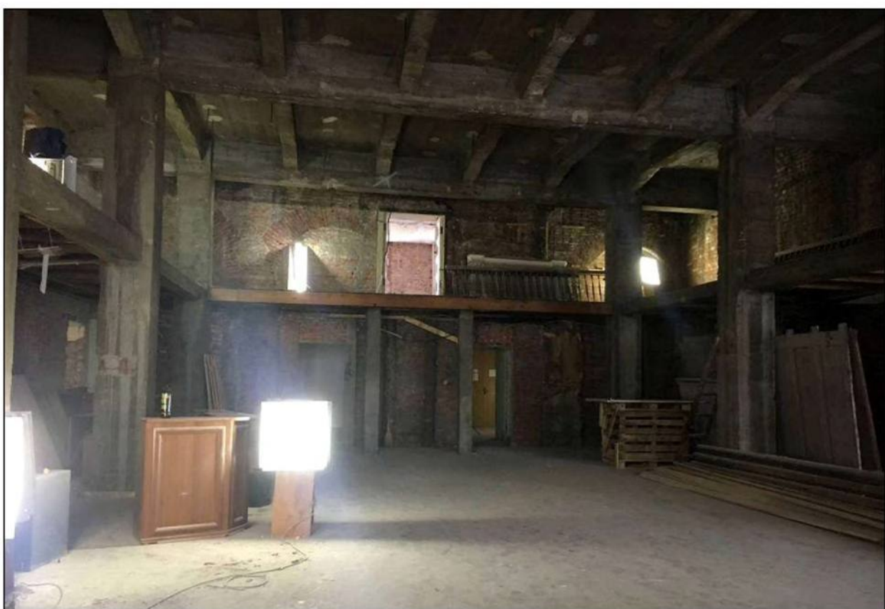
Илл. 204. Объект культурного наследия «Большой железный ряд или Кожевенная линия». Средний корпус. 1-й этаж, северная часть помещения № 48. 31.03.2019 г.
