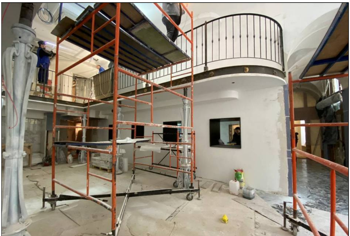
51. Объект культурного наследия «Большой железный ряд или Кожевенная линия». Северный корпус. 1-й этаж, восточная часть помещения № 105. 24.02.2021 г.
