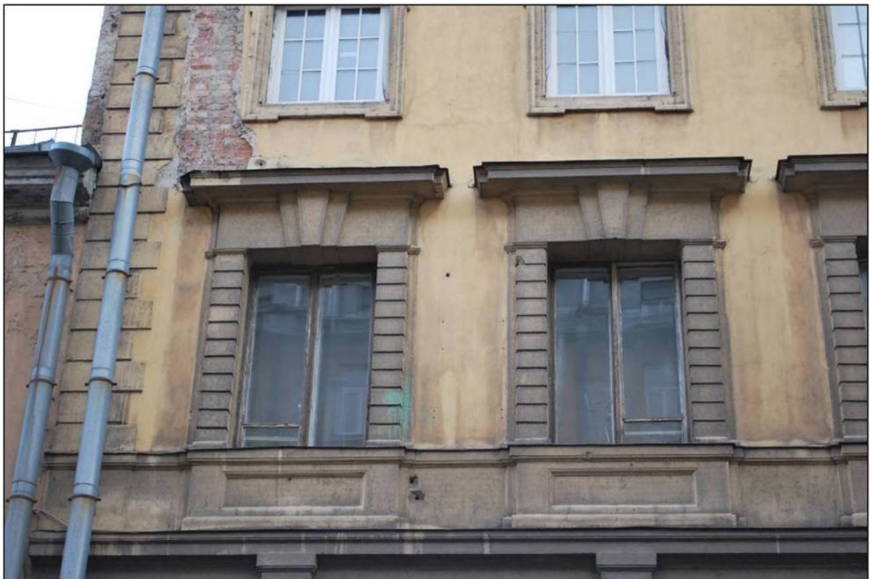
Илл. 190. Объект культурного наследия «Большой железный ряд или Кожевенная линия». Средний корпус. Фрагмент лицевого фасада по Мучному переулку. Оформление оконных проемов 2-го этажа. 31.03.2019 г.
