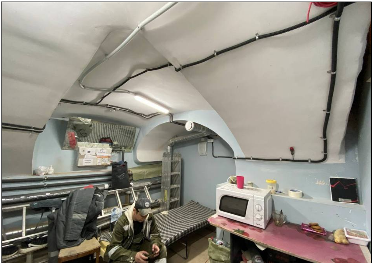
29. Объект культурного наследия «Большой железный ряд или Кожевенная линия». Северный корпус. Подвал, помещение № 41. 24.02.2021 г.
