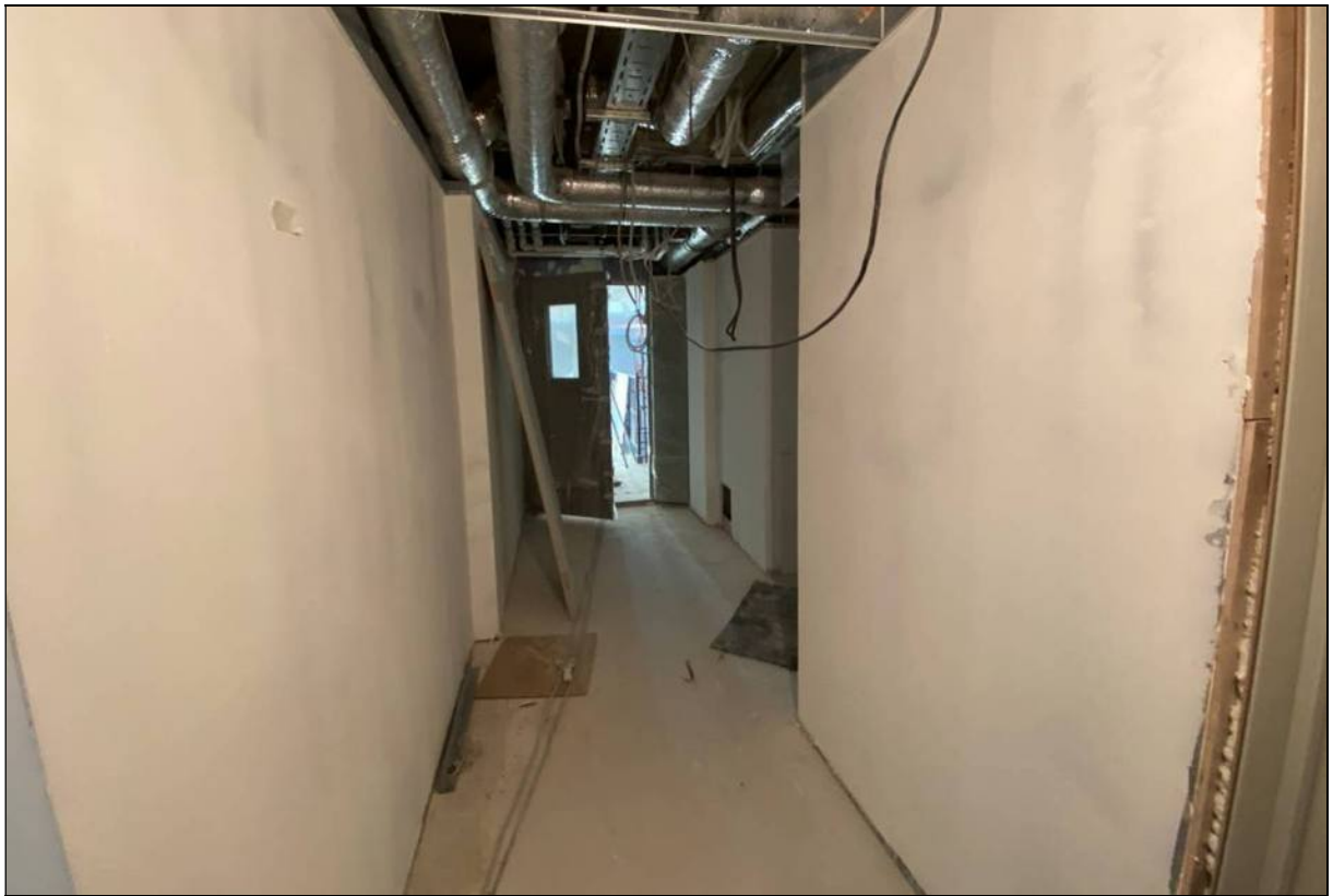
77. Объект культурного наследия «Большой железный ряд или Кожевенная линия». Северный корпус. 2-й этаж, помещение № 211. Вход в помещение № 209. 24.02.2021 г.
