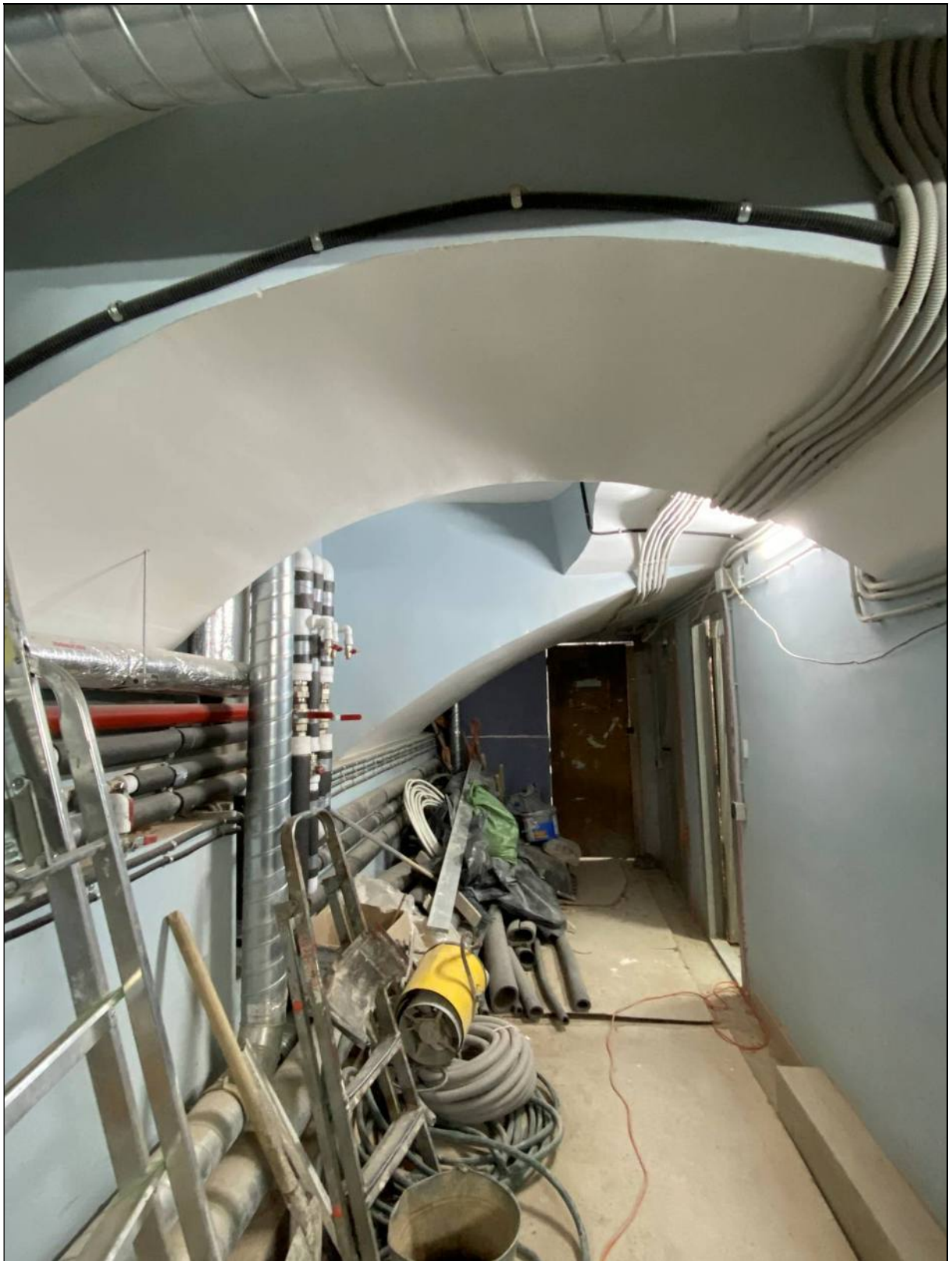
27. Объект культурного наследия «Большой железный ряд или Кожевенная линия». Северный корпус. Подвал, коридор вдоль помещений №№ 9, 41. Вид от помещения № 9. 24.02.2021 г.
