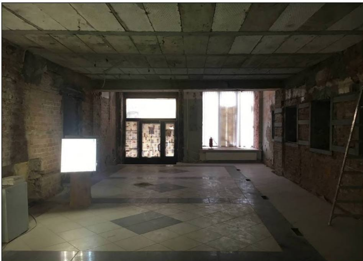
Илл. 213. Объект культурного наследия «Большой железный ряд или Кожевенная линия». Средний корпус. 1-й этаж, южная часть помещения № 41. 31.03.2019 г.
