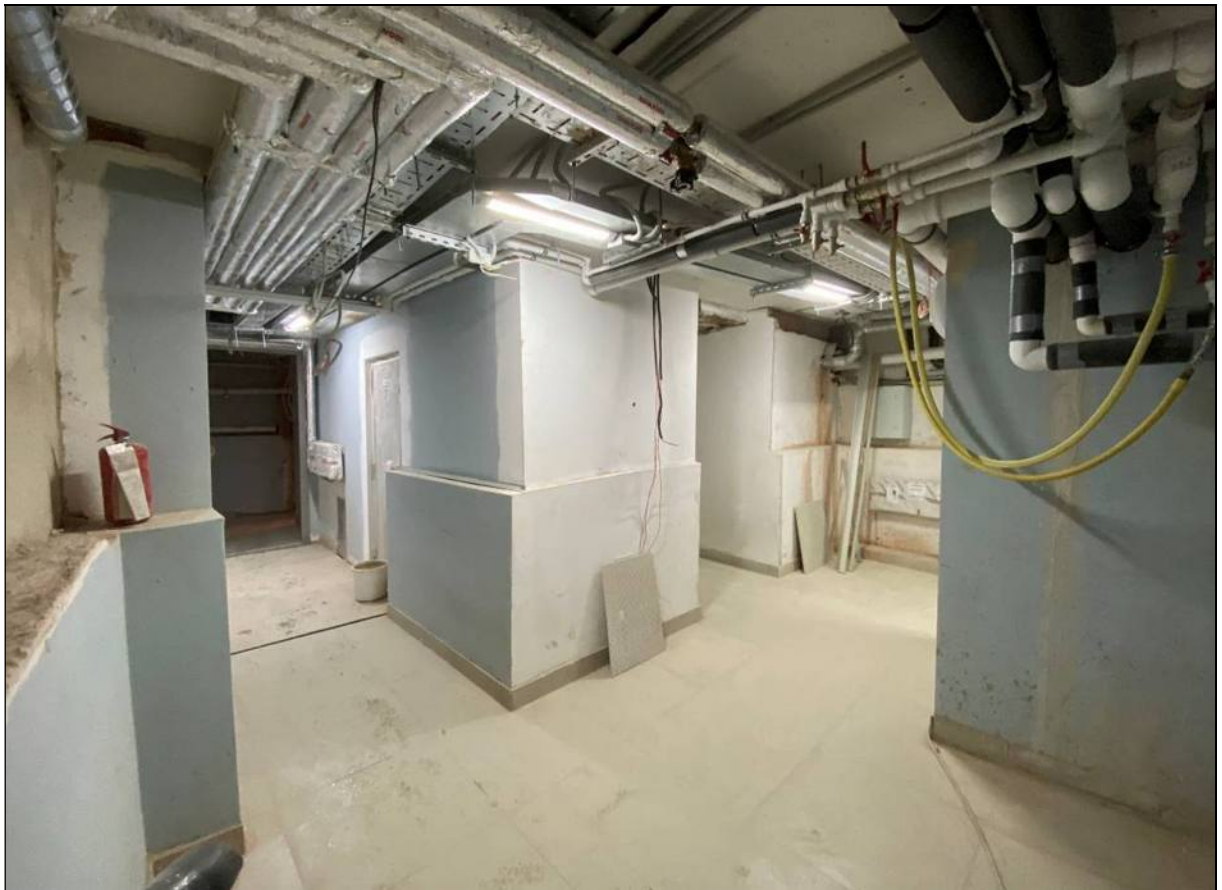
15. Объект культурного наследия «Большой железный ряд или Кожевенная линия». Средний корпус. Подвал, помещения № 19, 20. Входы на лестницы № 5 и № 6. 24.02.2021 г.
