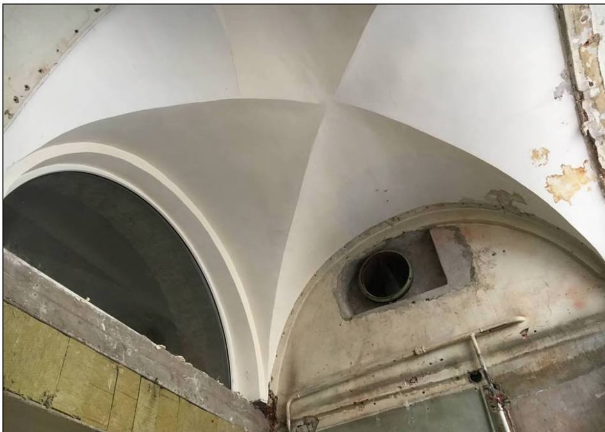
Илл. 210. Объект культурного наследия «Большой железный ряд или Кожевенная линия». Средний корпус. 1-й этаж, помещение № 42, свод. 31.03.2019 г.
