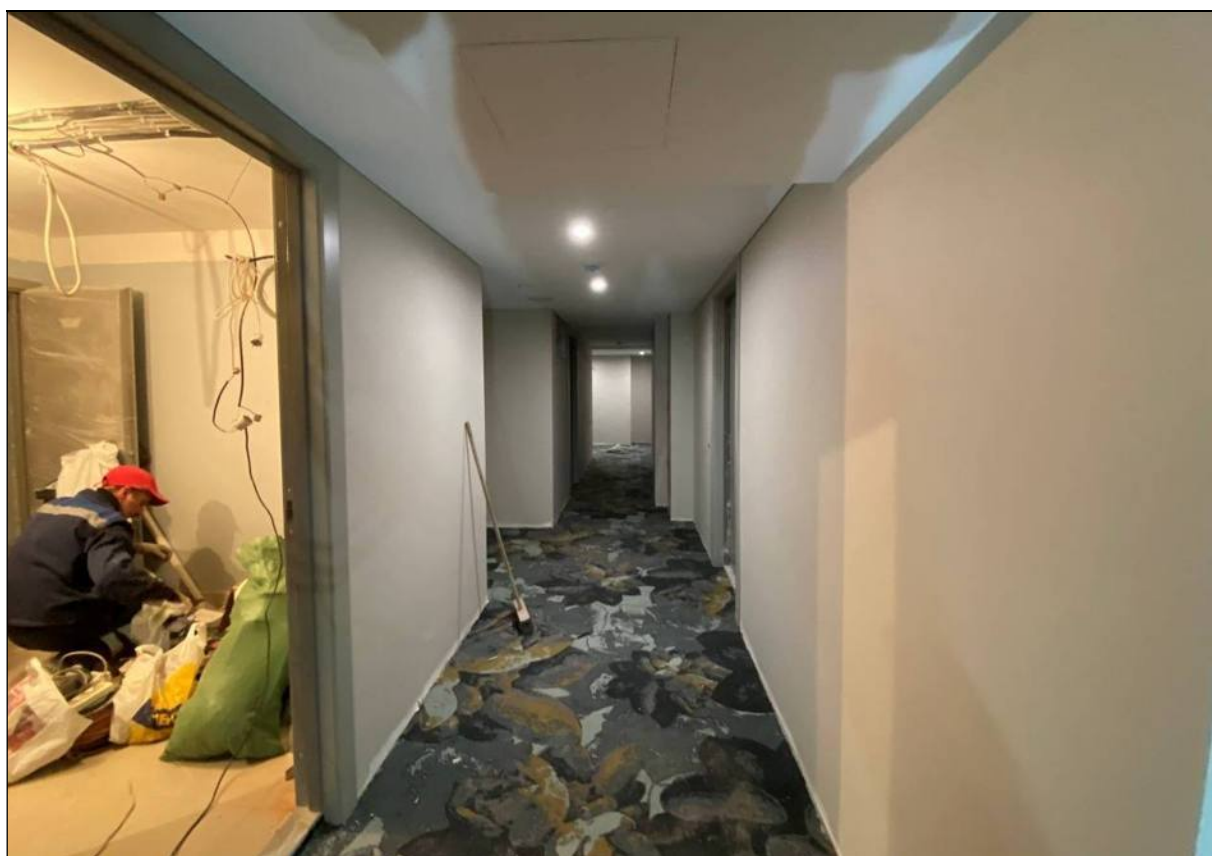
142. Объект культурного наследия «Большой железный ряд или Кожевенная линия». Средний корпус. 5-й этаж, помещение № 510. Коридор вдоль помещений №№ 504, 506, 507. 24.02.2021 г.
