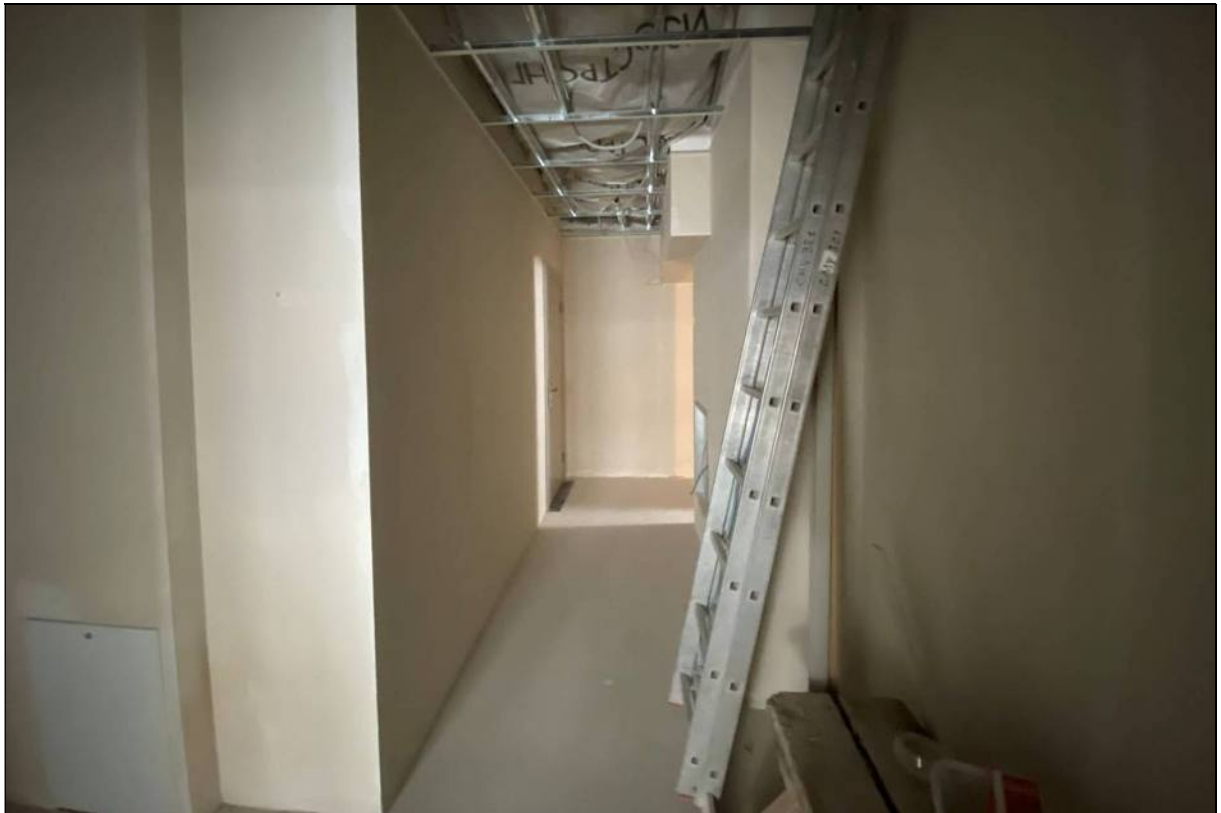
158. Объект культурного наследия «Большой железный ряд или Кожевенная линия». Средний корпус. Мансарда, помещение № 607. Коридор между помещениями №№ 602, 609. 24.02.2021 г.
