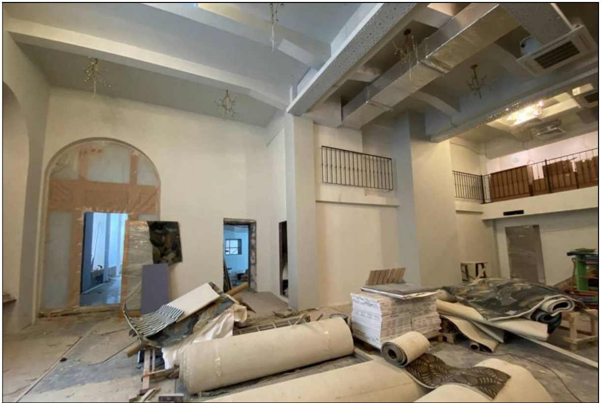
38. Объект культурного наследия «Большой железный ряд или Кожевенная линия». Средний корпус. 1-й этаж, западная часть помещения № 118. Входы в помещения северного корпуса. 24.02.2021 г.
