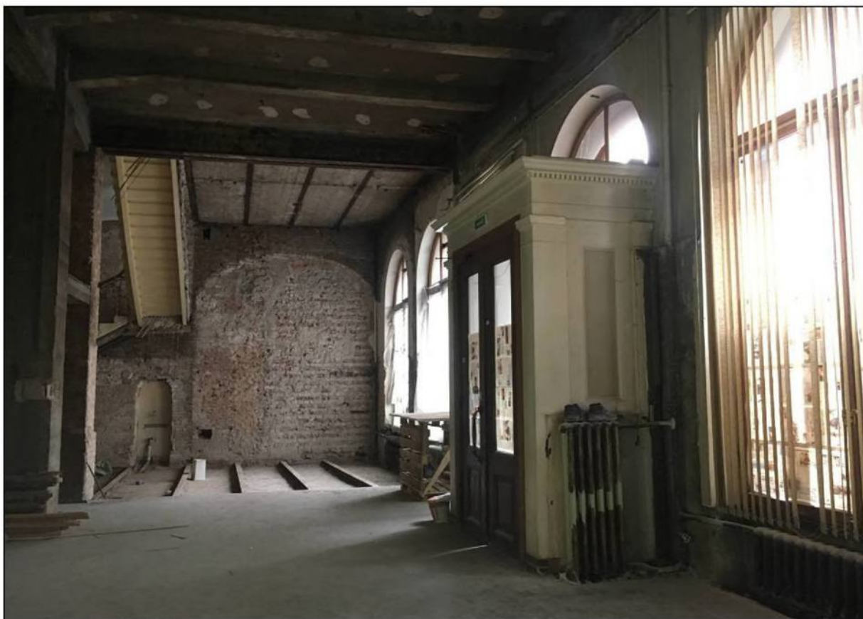
Илл. 207. Объект культурного наследия «Большой железный ряд или Кожевенная линия». Средний корпус. 1-й этаж, помещение № 48, главный вход. 31.03.2019 г.
