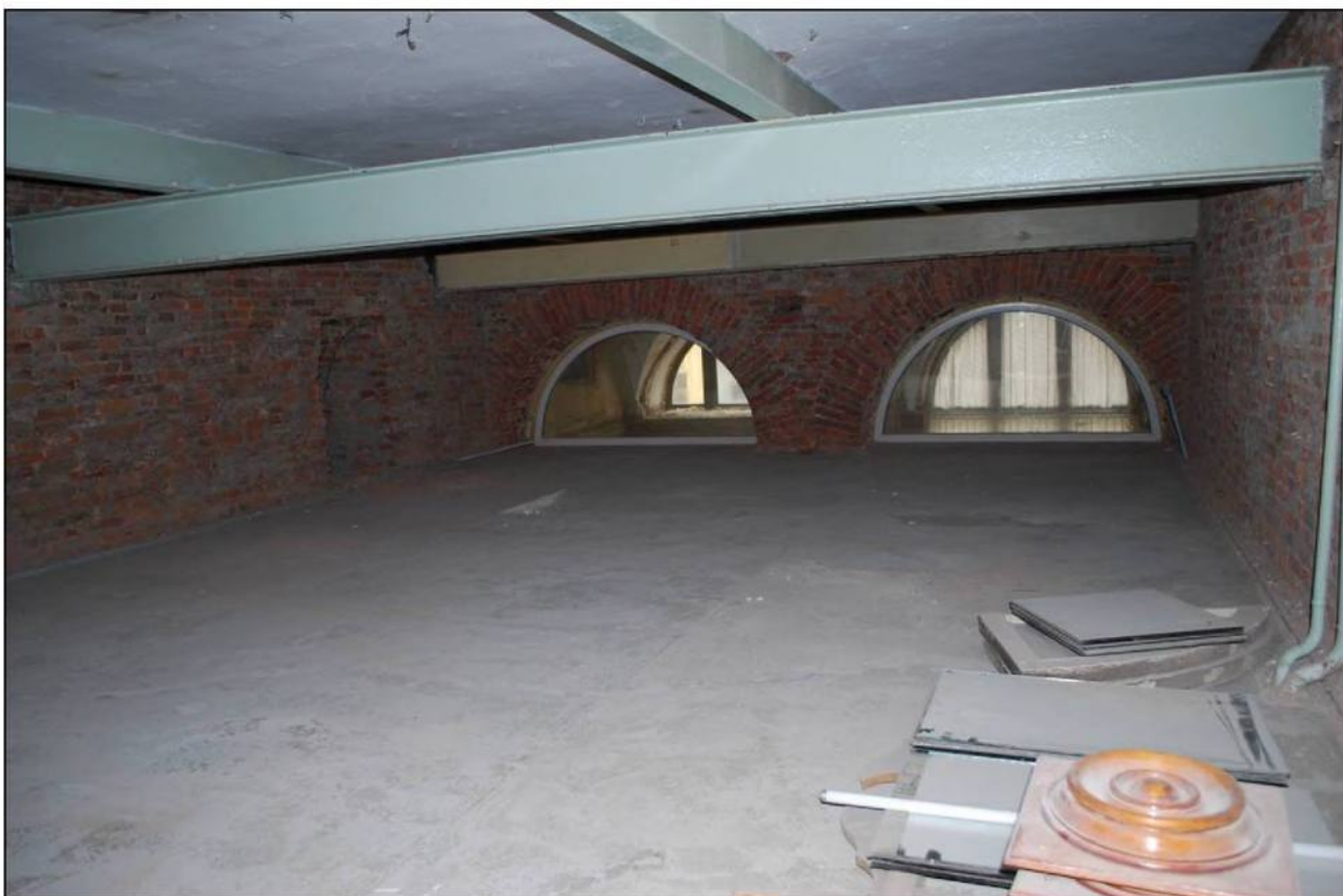
Илл. 221. Объект культурного наследия «Большой железный ряд или Кожевенная линия». Средний корпус. 2-й этаж, южная часть помещения № 68. 31.03.2019 г.
