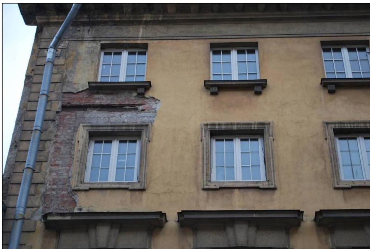
Илл. 191. Объект культурного наследия «Большой железный ряд или Кожевенная линия». Средний корпус. Фрагмент лицевого фасада по Мучному переулку. Оформление оконных проемов 3-го и 4-го этажей. 31.03.2019 г.
