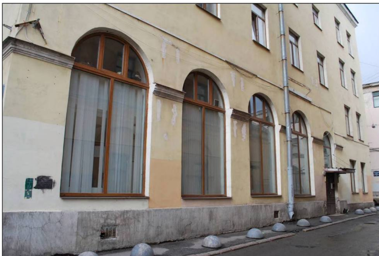
Илл. 196. Объект культурного наследия «Большой железный ряд или Кожевенная линия». Южный корпус. Фрагмент торцевого фасада Оконные проемы 1-го этажа. Вид от Мучного переулка в сторону Москательного переулка. 31.03.2019 г.
