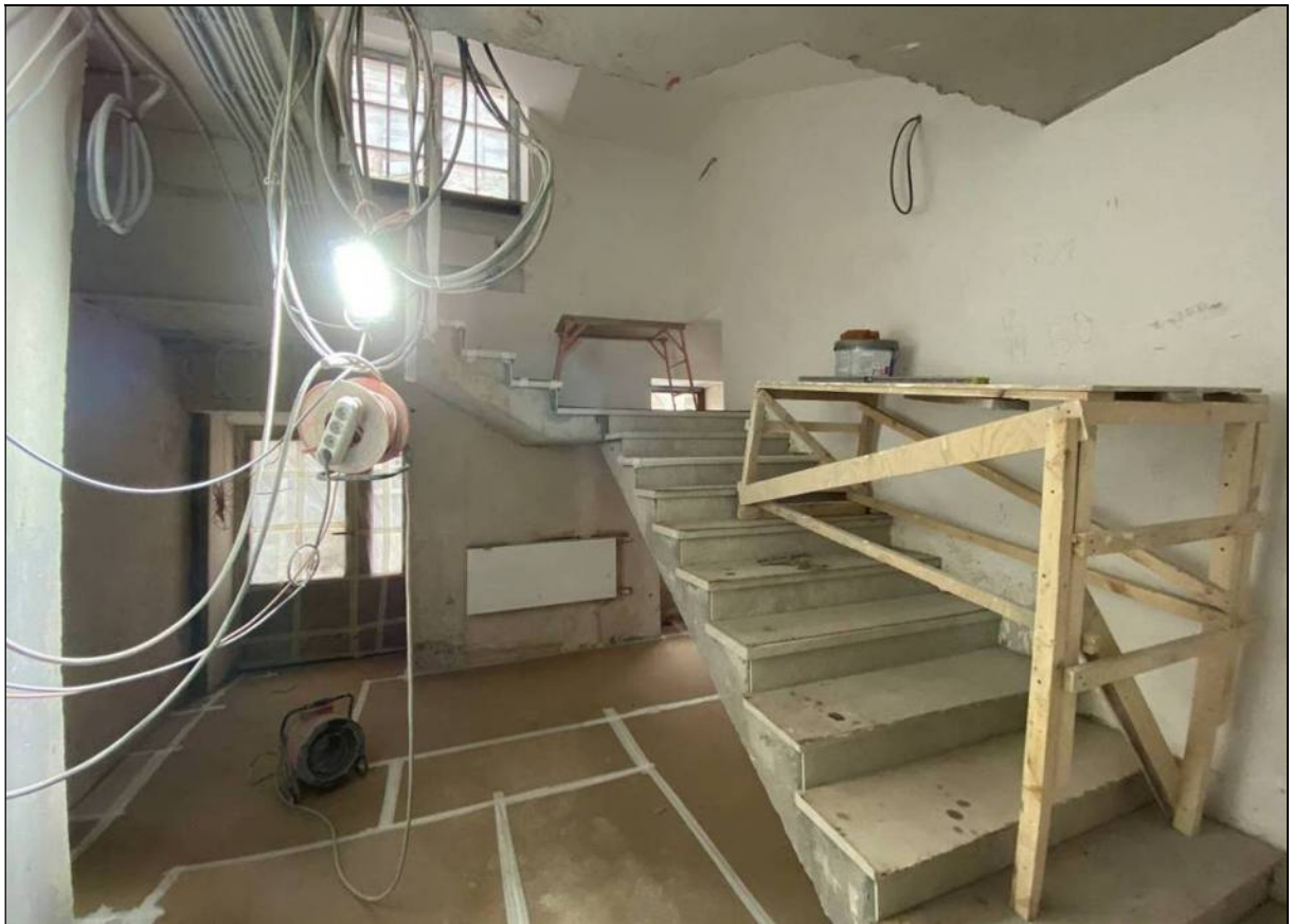
56. Объект культурного наследия «Большой железный ряд или Кожевенная линия». Средний корпус. 1-й этаж, помещение № 113. 24.02.2021 г.
