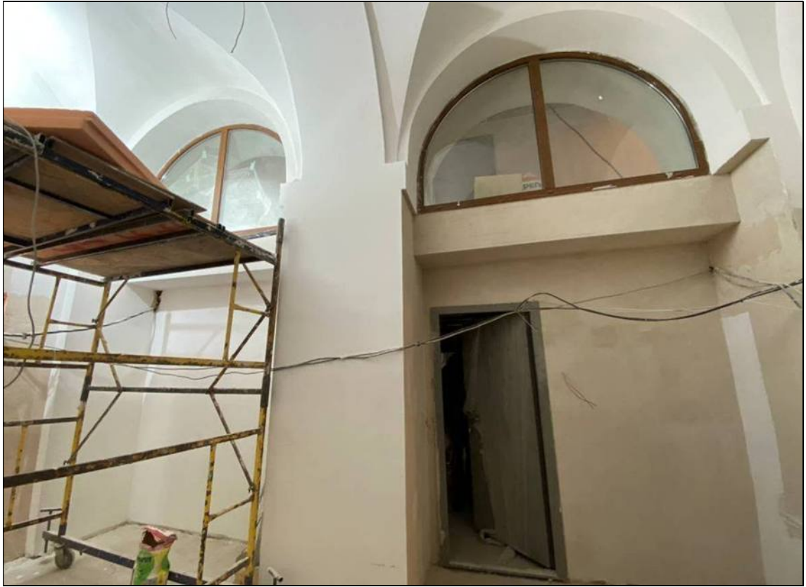
60. Объект культурного наследия «Большой железный ряд или Кожевенная линия». Северный корпус. 1-й этаж, северная часть помещения № 115. Вход в помещение № 116. 24.02.2021 г.
