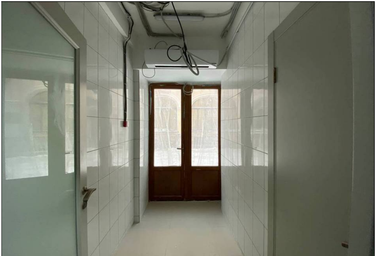
54. Объект культурного наследия «Большой железный ряд или Кожевенная линия». Средний корпус. 1-й этаж, помещение № 132. 24.02.2021 г.
