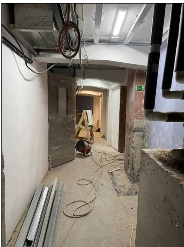
31. Объект культурного наследия «Большой железный ряд или Кожевенная линия». Северный корпус. Подвал, коридор вдоль помещений №№ 5, 7. Вид от помещения № 4. 24.02.2021 г.
