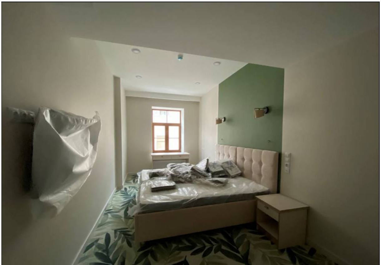
100. Объект культурного наследия «Большой железный ряд или Кожевенная линия». Северный корпус. 3-й этаж, помещение № 302/1. 24.02.2021 г.
