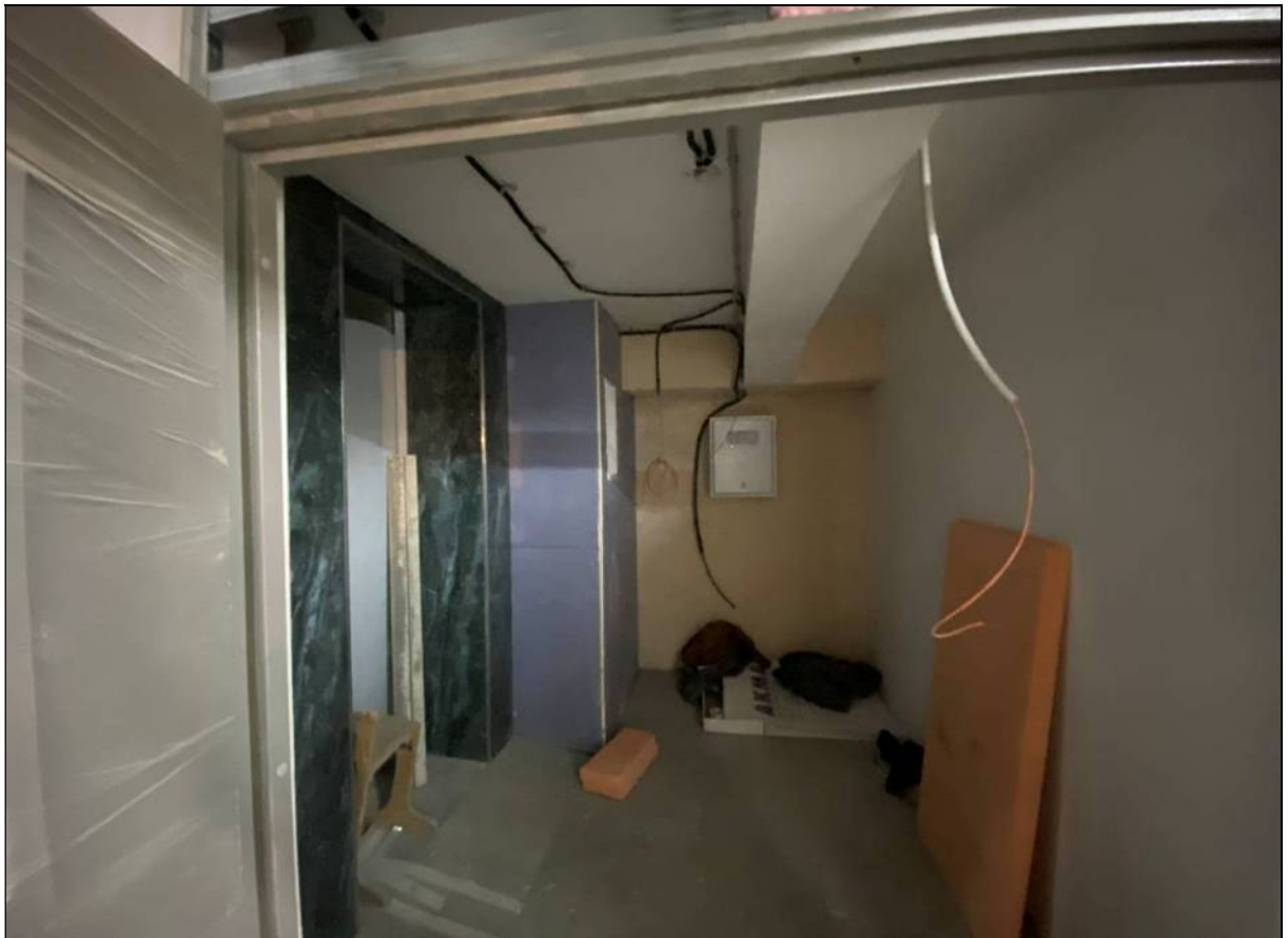
34. Объект культурного наследия «Большой железный ряд или Кожевенная линия». Средний корпус. Подвал, помещение № 2. 24.02.2021 г.
