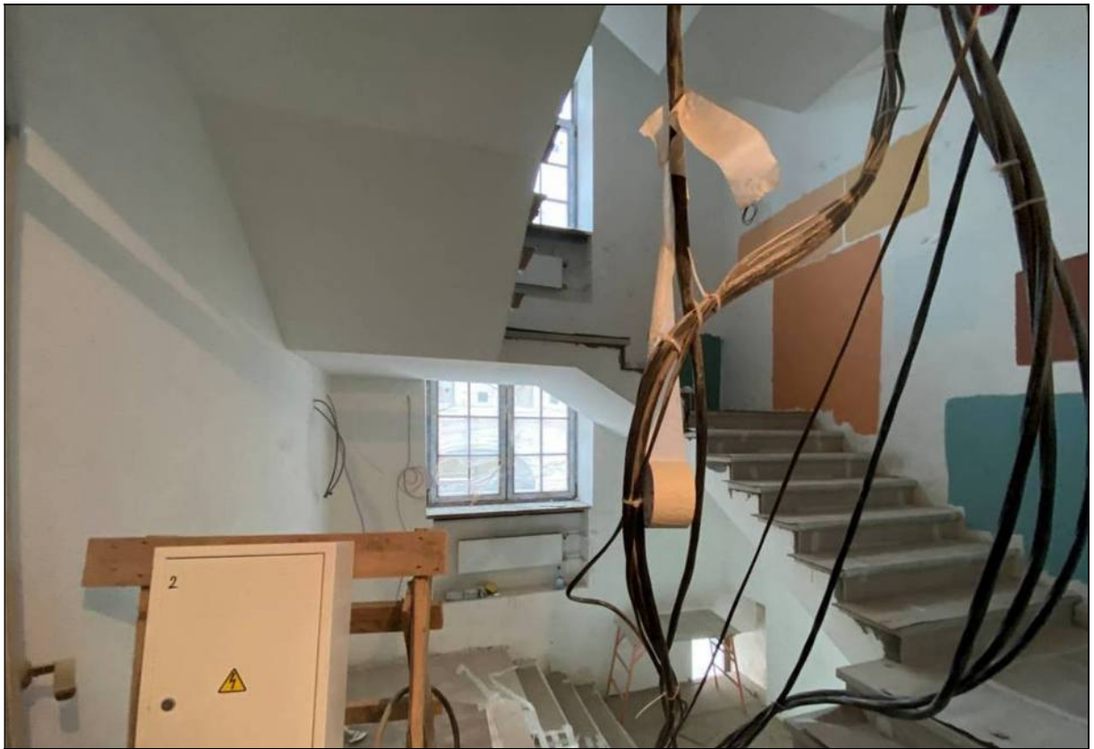
71. Объект культурного наследия «Большой железный ряд или Кожевенная линия». Средний корпус. 2-й этаж, помещение № 212. Лестничные марши. 24.02.2021 г.
