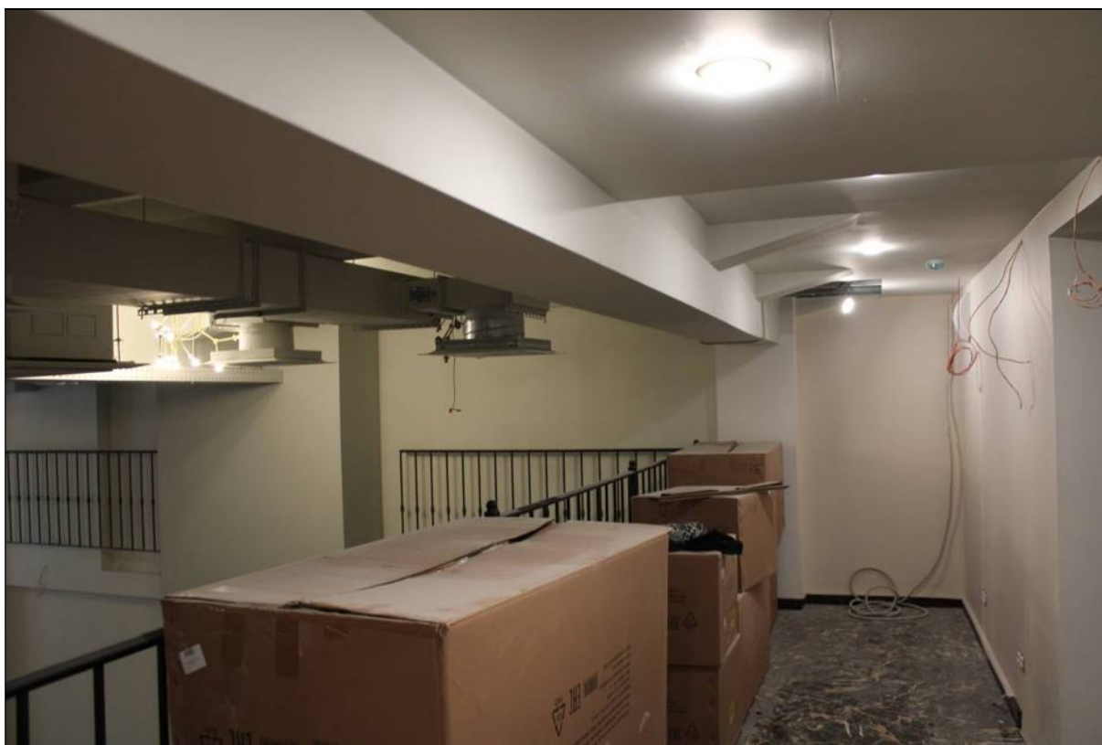
70. Объект культурного наследия «Большой железный ряд или Кожевенная линия». Средний корпус. 2-й этаж, помещение № 215. Западная часть балкона. 24.02.2021 г.
