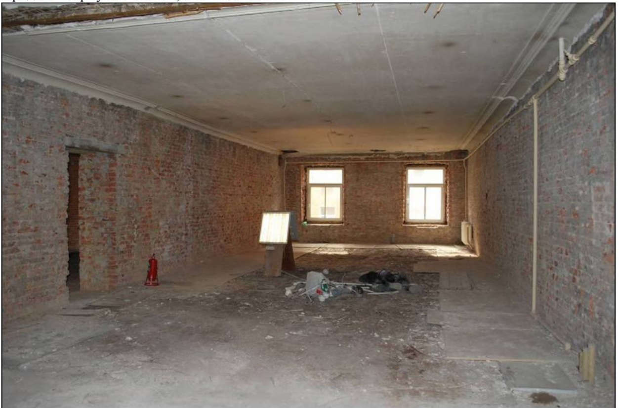
Илл. 236. Объект культурного наследия «Большой железный ряд или Кожевенная линия». Средний корпус. 3-й этаж, южная часть помещения №75. 31.03.2019 г.
