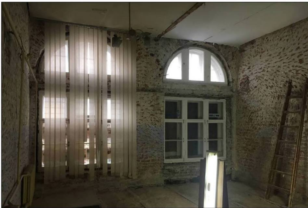
Илл. 212. Объект культурного наследия «Большой железный ряд или Кожевенная линия». Средний корпус. 1-й этаж, помещения №№ 43, 45. 31.03.2019 г.
