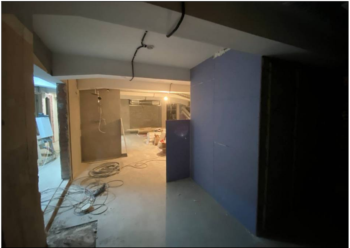
32. Объект культурного наследия «Большой железный ряд или Кожевенная линия». Северный корпус. Подвал, западная часть помещения № 5. 24.02.2021 г.
