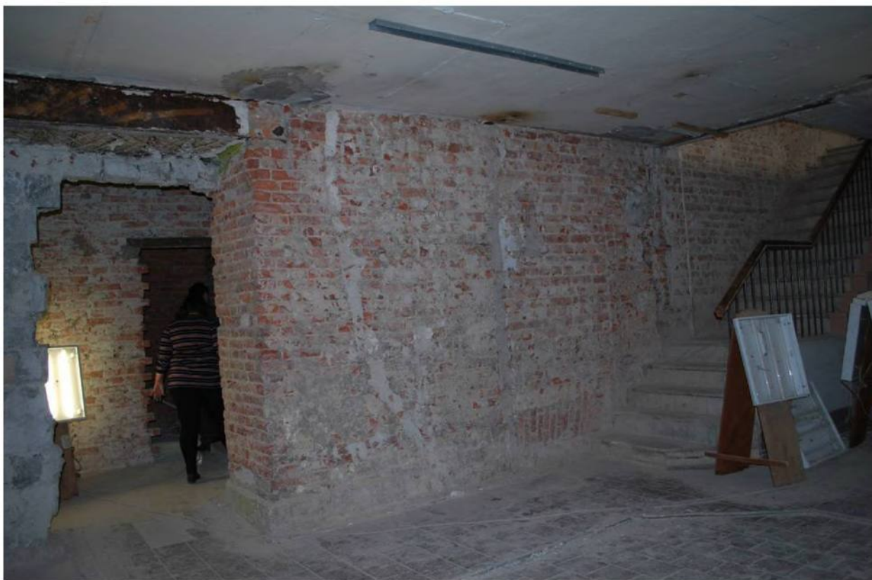
Илл. 215. Объект культурного наследия «Большой железный ряд или Кожевенная линия». Средний корпус. 1-й этаж, помещение № 46, проем в капитальной стене.. 31.03.2019 г.
