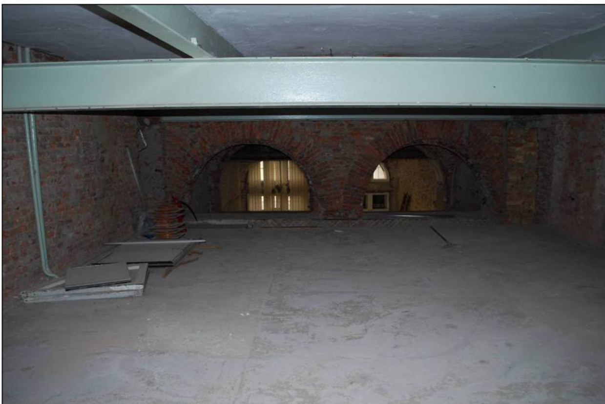
Илл. 223. Объект культурного наследия «Большой железный ряд или Кожевенная линия». Средний корпус. 2-й этаж, северная часть помещения № 68. 31.03.2019 г.
