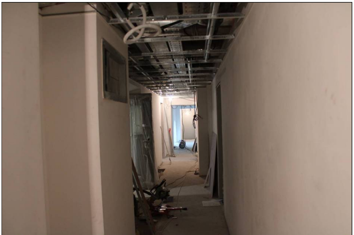
72. Объект культурного наследия «Большой железный ряд или Кожевенная линия». Средний корпус. 2-й этаж, помещение № 213. 24.02.2021 г.
