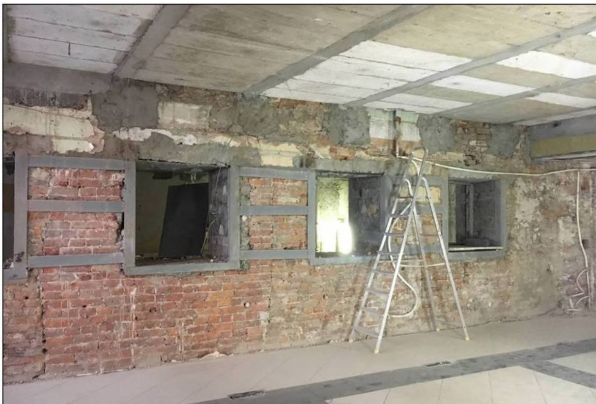
Илл. 214. Объект культурного наследия «Большой железный ряд или Кожевенная линия». Средний корпус. 1-й этаж, помещение № 41. 31.03.2019 г.
