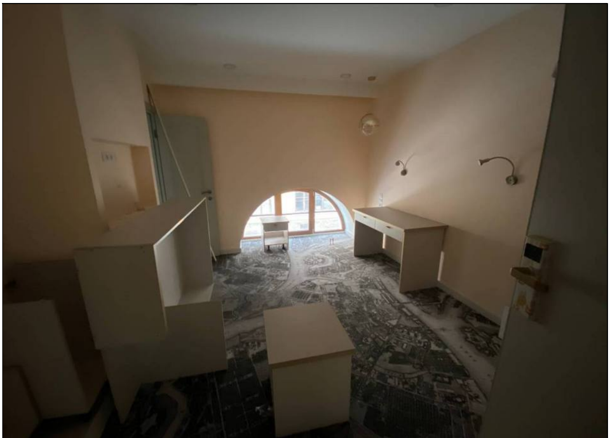
84. Объект культурного наследия «Большой железный ряд или Кожевенная линия». Северный корпус. 2-й этаж, помещение № 203/1. 24.02.2021 г.
