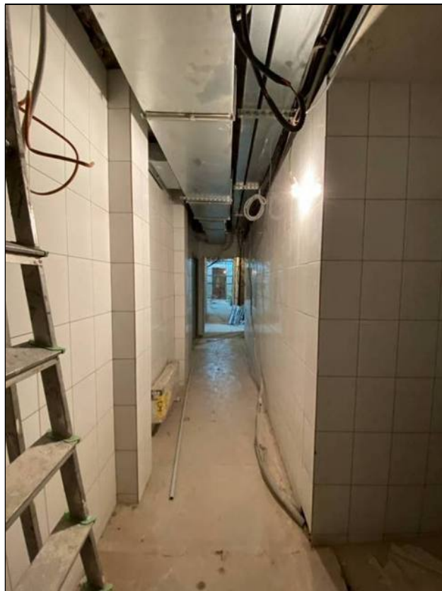
55. Объект культурного наследия «Большой железный ряд или Кожевенная линия». Средний корпус. 1-й этаж, помещение № 137. 24.02.2021 г.
