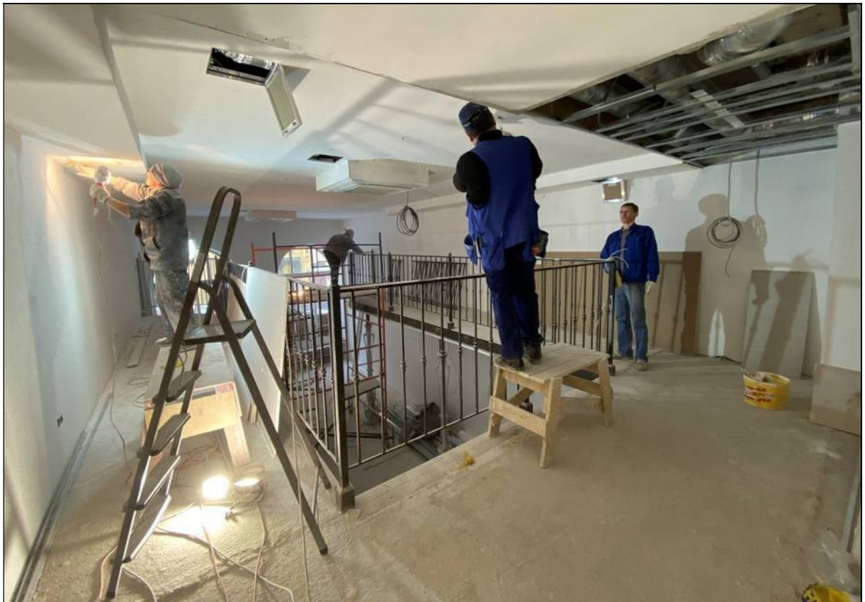
75. Объект культурного наследия «Большой железный ряд или Кожевенная линия». Северный корпус. 2-й этаж, помещение № 209. Балкон. 24.02.2021 г.
