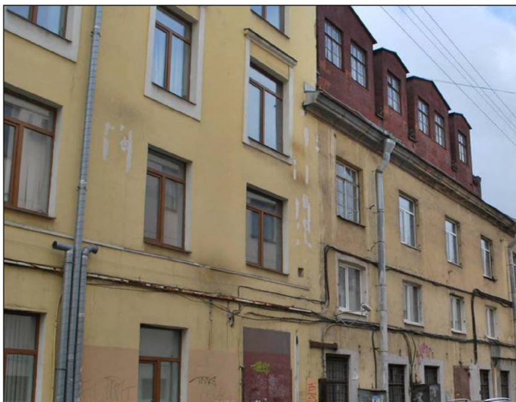
Илл. 201. Объект культурного наследия «Большой железный ряд или Кожевенная линия». Средний и северный корпуса. Фасады по Москательному переулку. Вид в сторону набережной канала Грибоедова. 31.03.2019 г.
