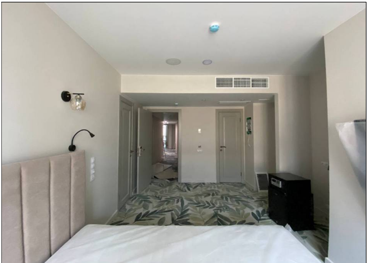
150. Объект культурного наследия «Большой железный ряд или Кожевенная линия». Средний корпус. 5-й этаж, северная часть помещения № 505/1. 24.02.2021 г.
