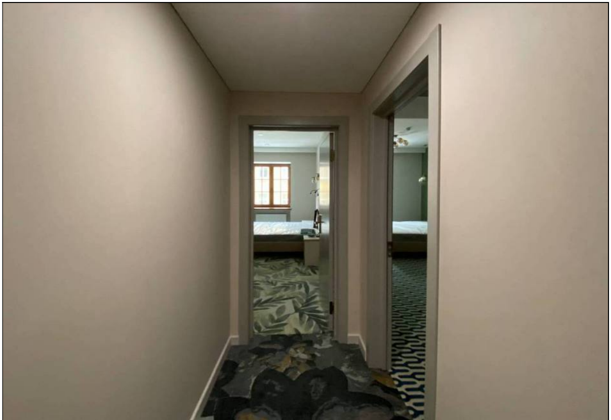
125. Объект культурного наследия «Большой железный ряд или Кожевенная линия». Средний корпус. 4-й этаж, помещение № 422. Входы в помещения №№ 405, 406. 24.02.2021 г.
