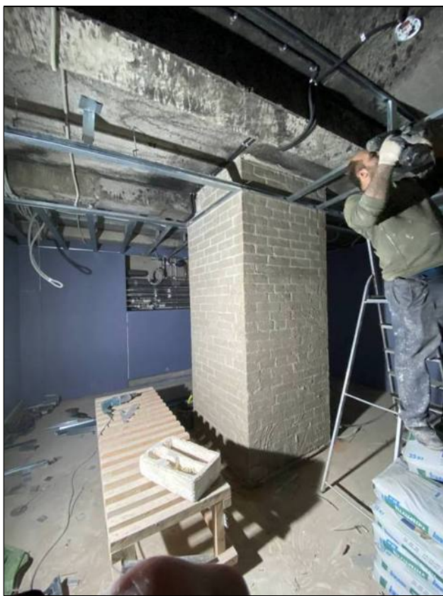
30. Объект культурного наследия «Большой железный ряд или Кожевенная линия». Северный корпус. Подвал, помещение № 4. 24.02.2021 г.
