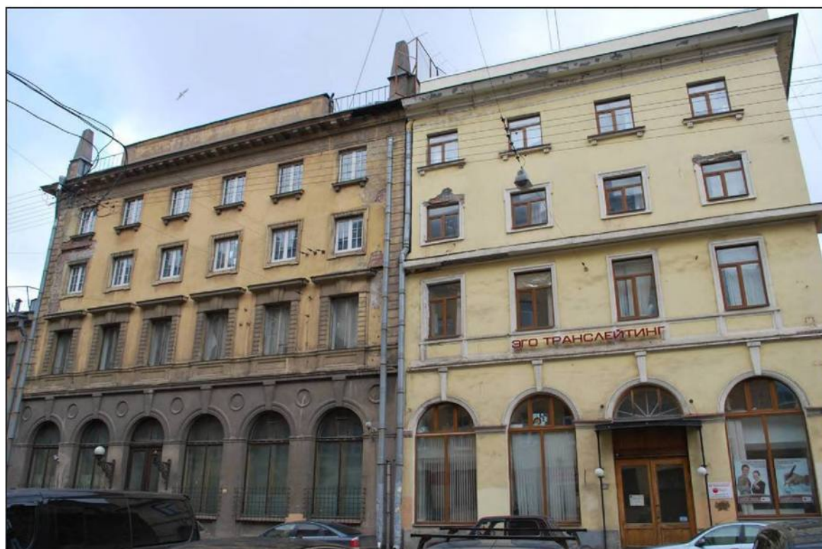
Илл. 184. Объект культурного наследия «Большой железный ряд или Кожевенная линия». Средний и южный корпуса. Лицевые фасады по Мучному переулку. 31.03.2019 г.
