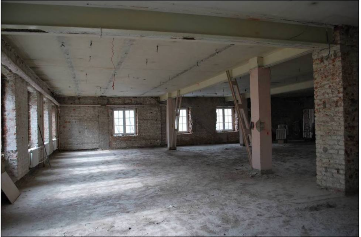
Илл. 245. Объект культурного наследия «Большой железный ряд или Кожевенная линия». Средний корпус. 5-й этаж, помещения №№ 127-137, южная часть. 31.03.2019 г.
