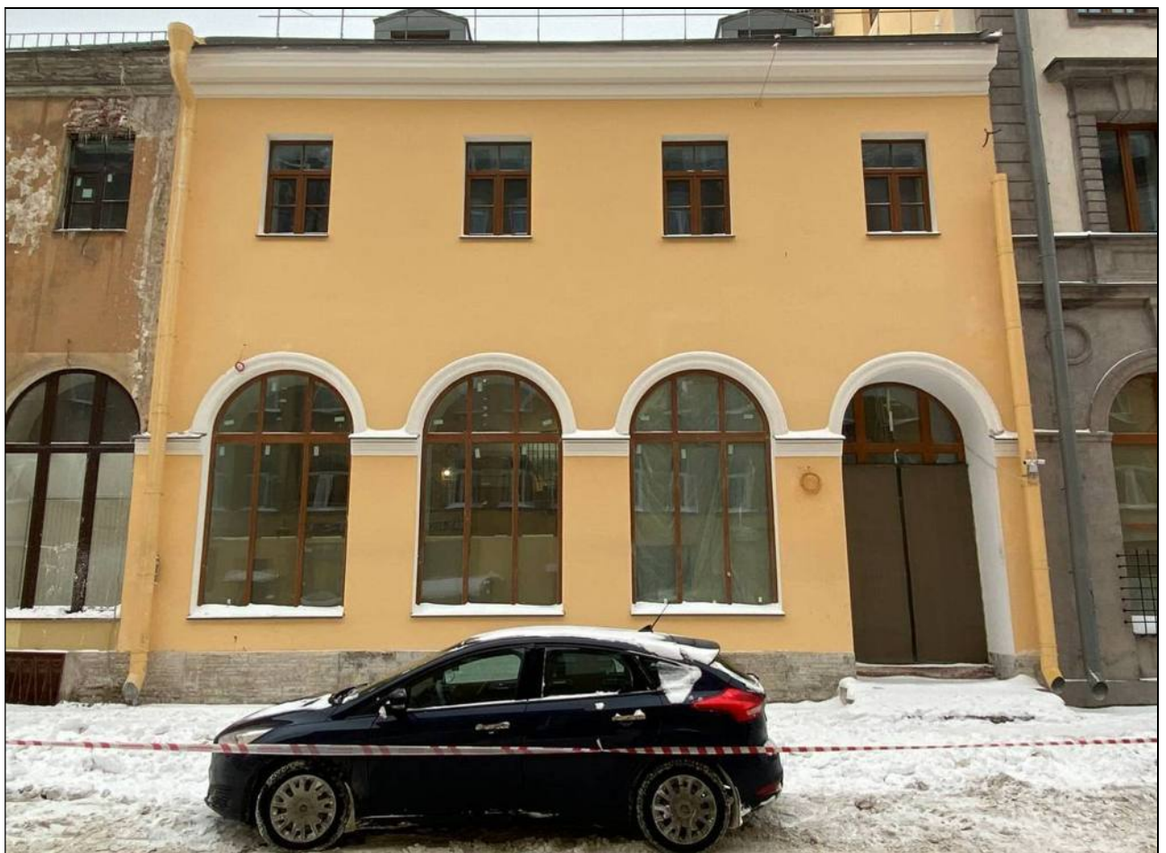
4. Объект культурного наследия «Большой железный ряд или Кожевенная линия». Северный корпус. Лицевой фасад по Мучному переулку. Вид на северо-восток от дома № 5 по Мучному переулку. 24.02.2021 г.
