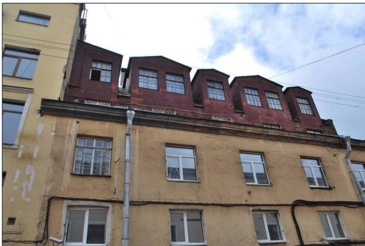
Илл. 200. Объект культурного наследия «Большой железный ряд или Кожевенная линия». Средний корпус. Фрагмент фасада по Москательному переулку. 31.03.2019 г.
