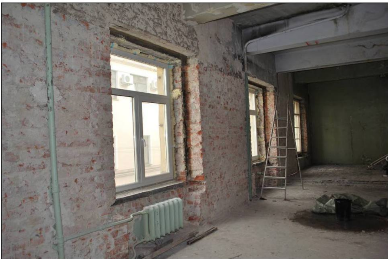
Илл. 241. Объект культурного наследия «Большой железный ряд или Кожевенная линия». Средний корпус. 3-й этаж, помещения №№ 93-102, оконные проемы. 31.03.2019 г.
