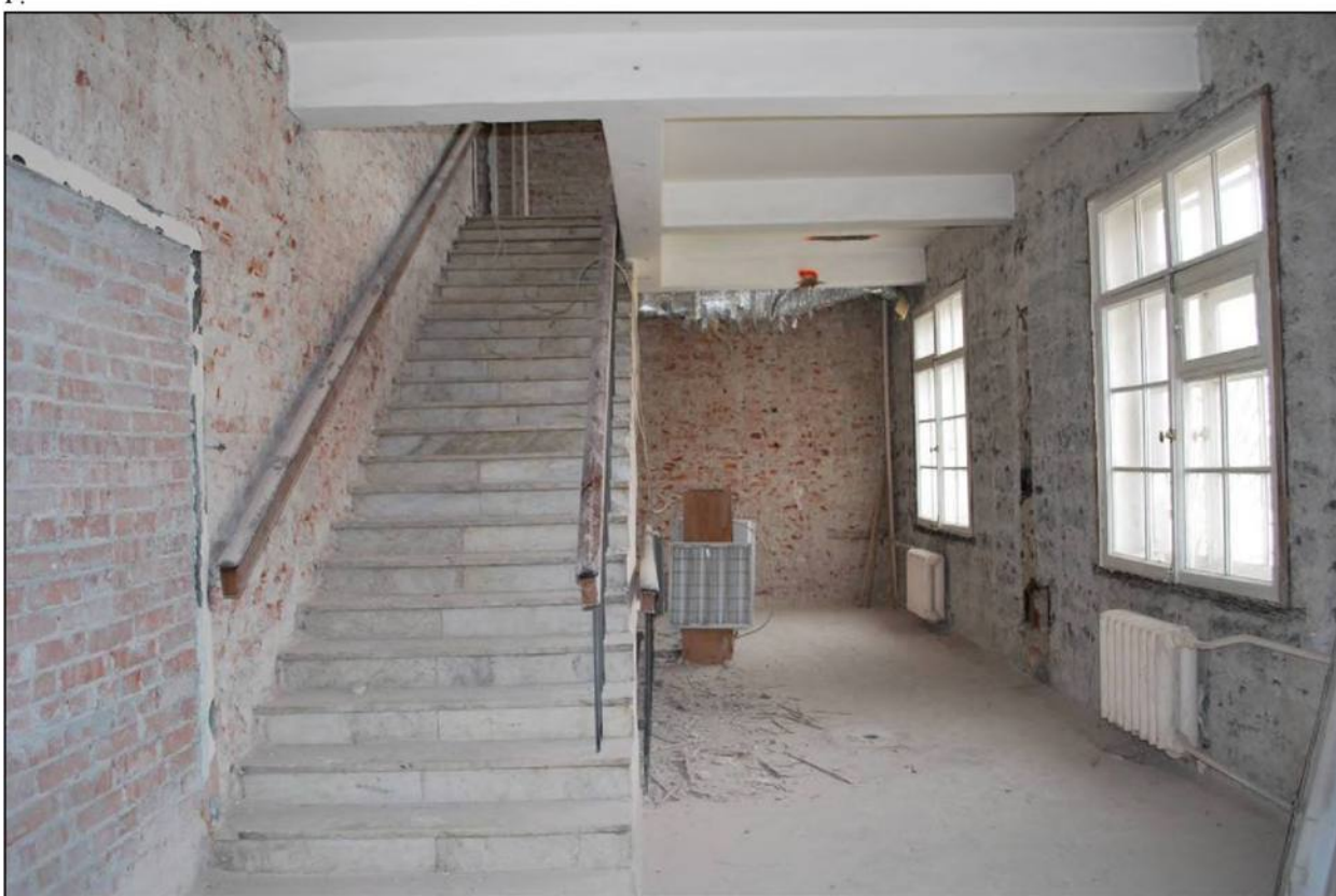
Илл. 242. Объект культурного наследия «Большой железный ряд или Кожевенная линия». Средний корпус. 4-й этаж, помещение № 103. 31.03.2019 г.
