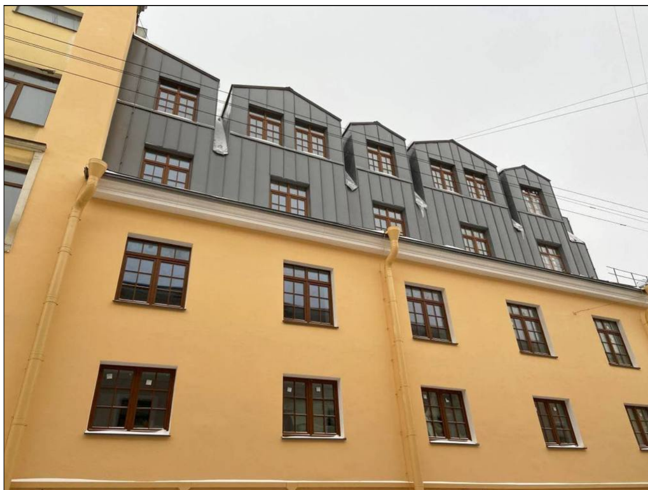
13. Объект культурного наследия «Большой железный ряд или Кожевенная линия». Средний корпус. Фрагмент фасада по Москательному переулку. Вид на запад. 24.02.2021 г.
