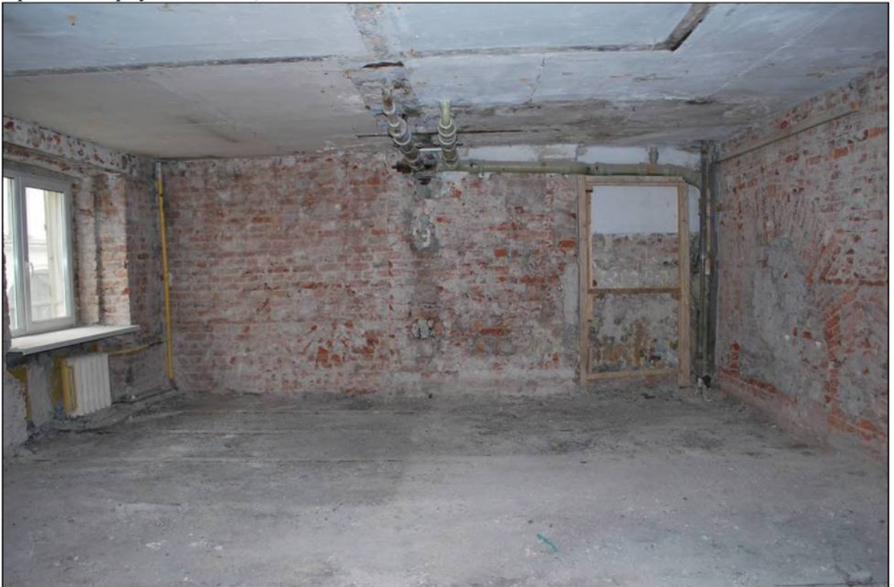
Илл. 232. Объект культурного наследия «Большой железный ряд или Кожевенная линия». Средний корпус. 2-й этаж, восточная часть помещения № 63. 31.03.2019 г.
