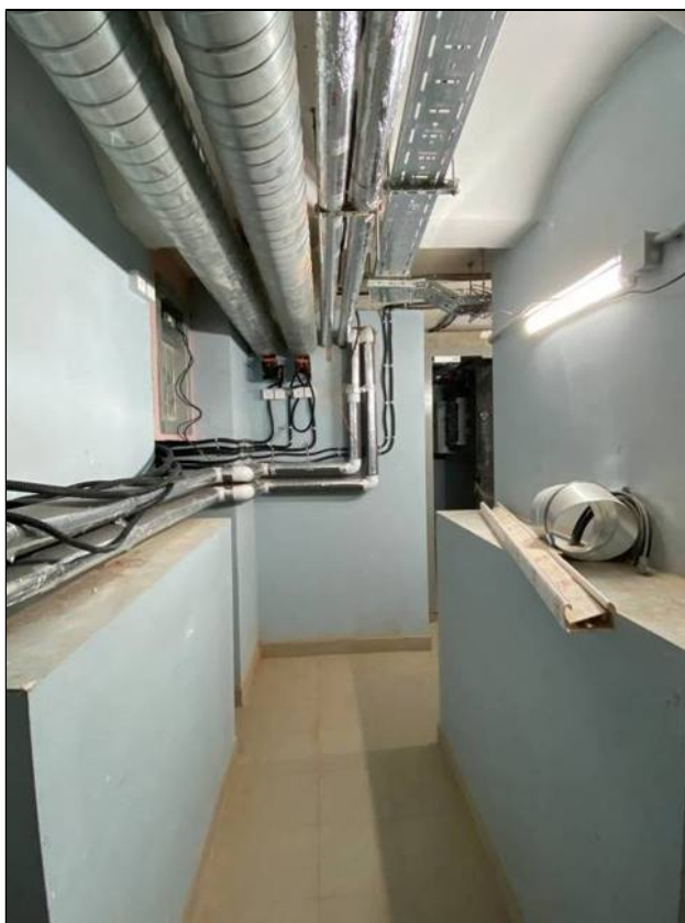
24. Объект культурного наследия «Большой железный ряд или Кожевенная линия». Северный корпус. Подвал, проход к помещениям №№ 13, 22. 24.02.2021 г.
