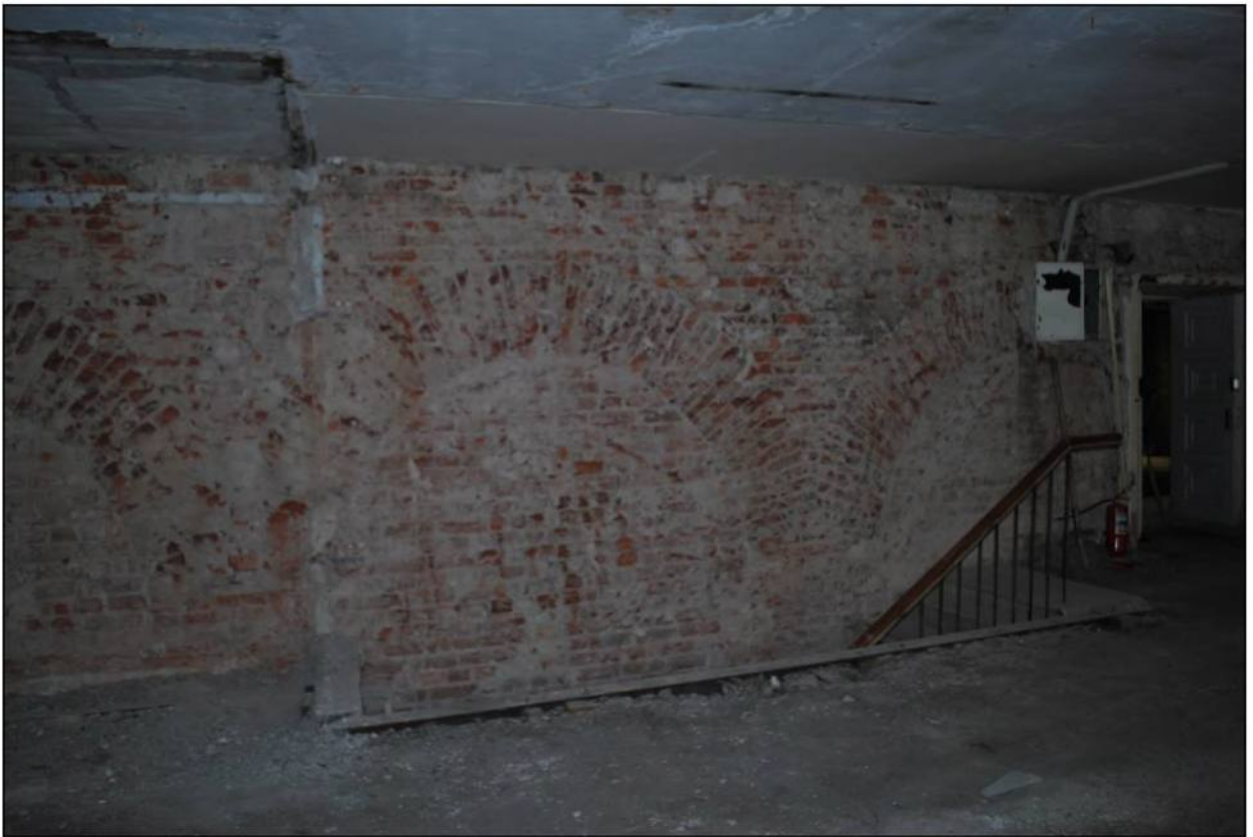
Илл. 233. Объект культурного наследия «Большой железный ряд или Кожевенная линия». Средний корпус. 2-й этаж, помещение № 63, заложенные арочные проемы. 31.03.2019 г.
