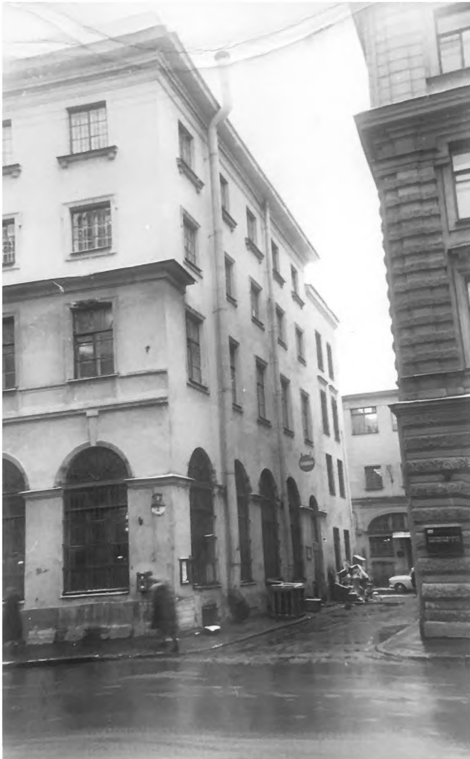
Илл. 26. Малый гостиный двор. Большой железный ряд. Фрагмент угловой части здания у проезда Архив института «Ленжилпроект». 1973 год.
