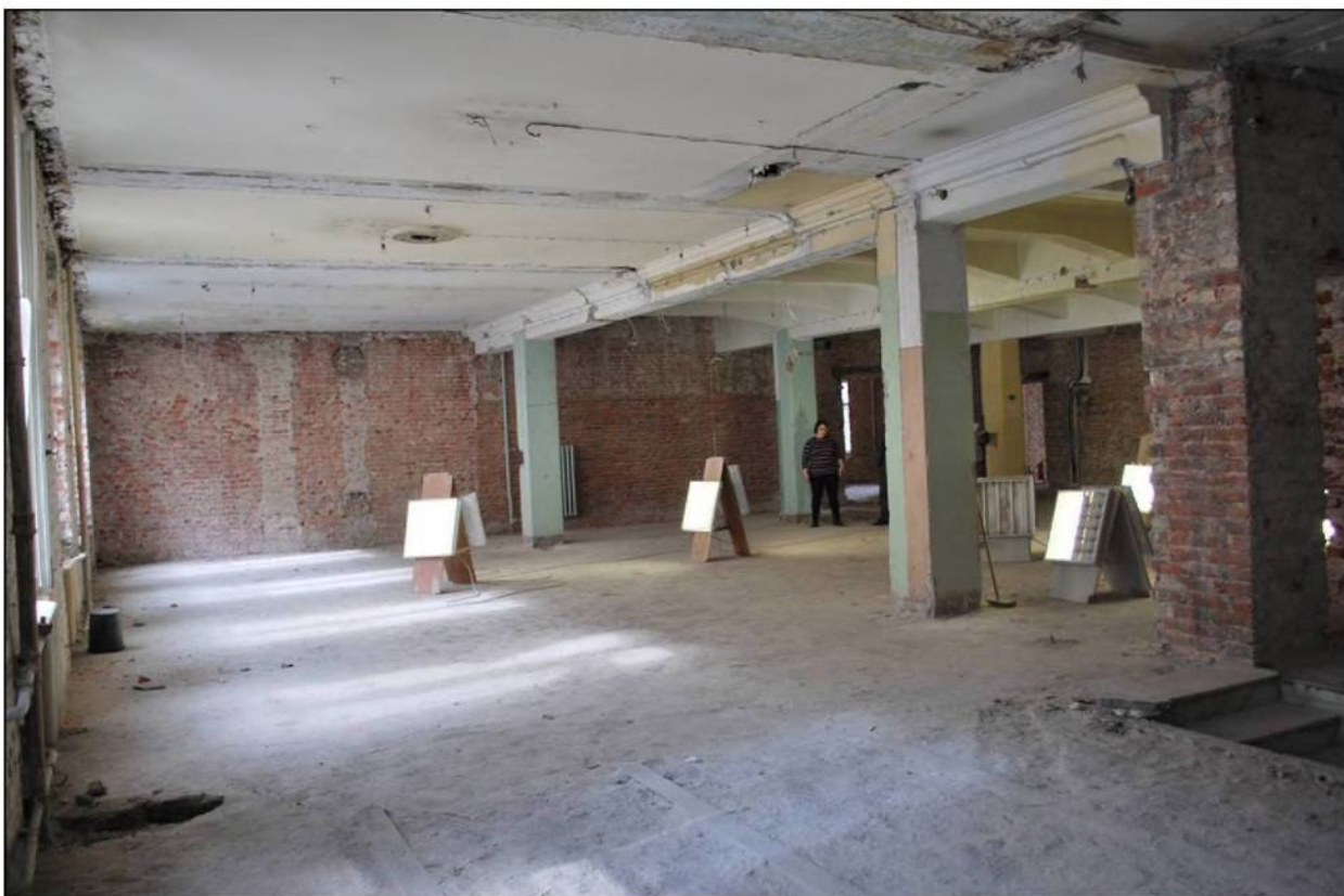
Илл. 239. Объект культурного наследия «Большой железный ряд или Кожевенная линия». Средний корпус. 3-й этаж, помещения №№ 77-92, вид на запад. 31.03.2019 г.
