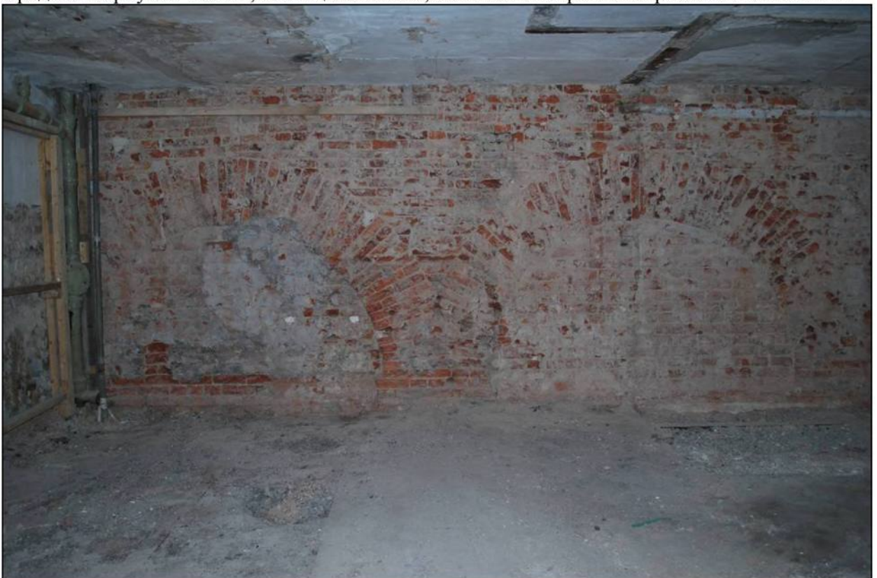
Илл. 234. Объект культурного наследия «Большой железный ряд или Кожевенная линия». Средний корпус. 2-й этаж, помещение № 63, заложенные арочные проемы. 31.03.2019 г.
