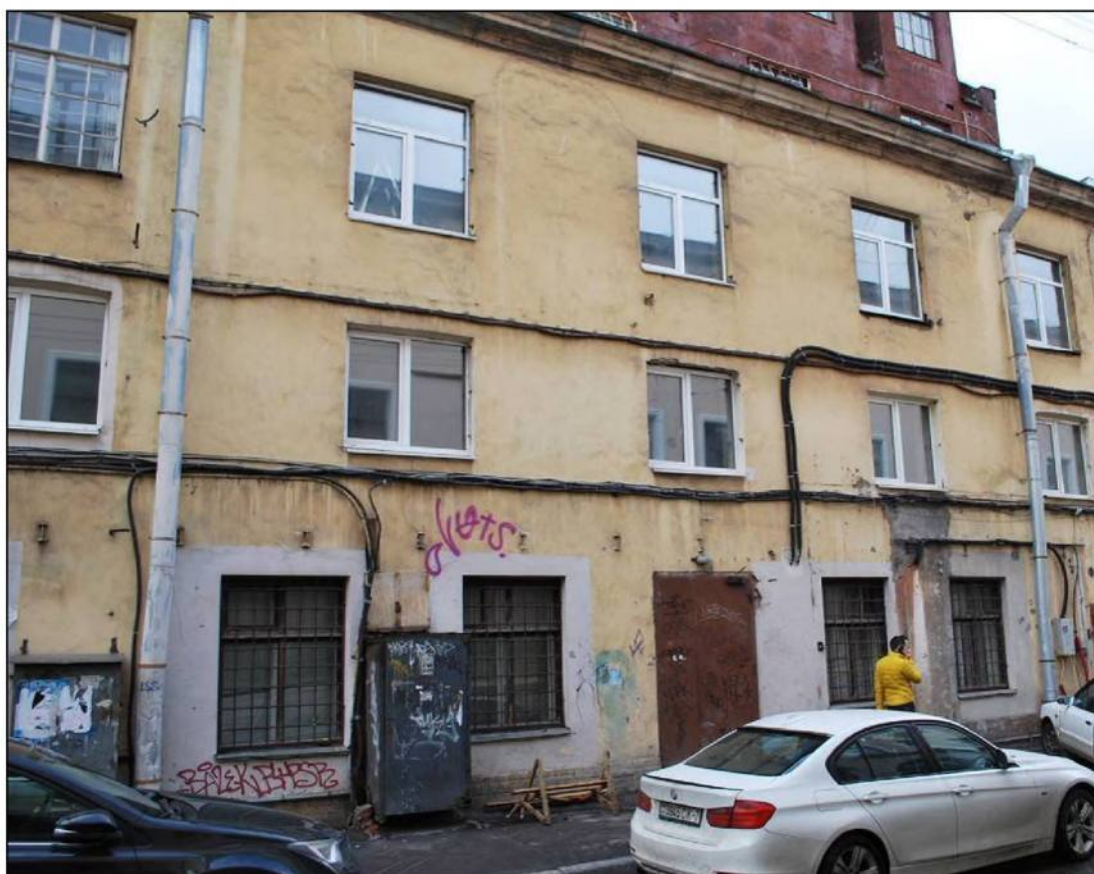
Илл. 199. Объект культурного наследия «Большой железный ряд или Кожевенная линия». Средний корпус. Фрагмент фасада по Москательному переулку. 31.03.2019 г.
