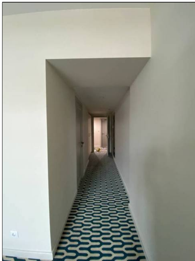
120. Объект культурного наследия «Большой железный ряд или Кожевенная линия». Средний корпус. 4-й этаж, помещение № 402/3. 24.02.2021 г.
