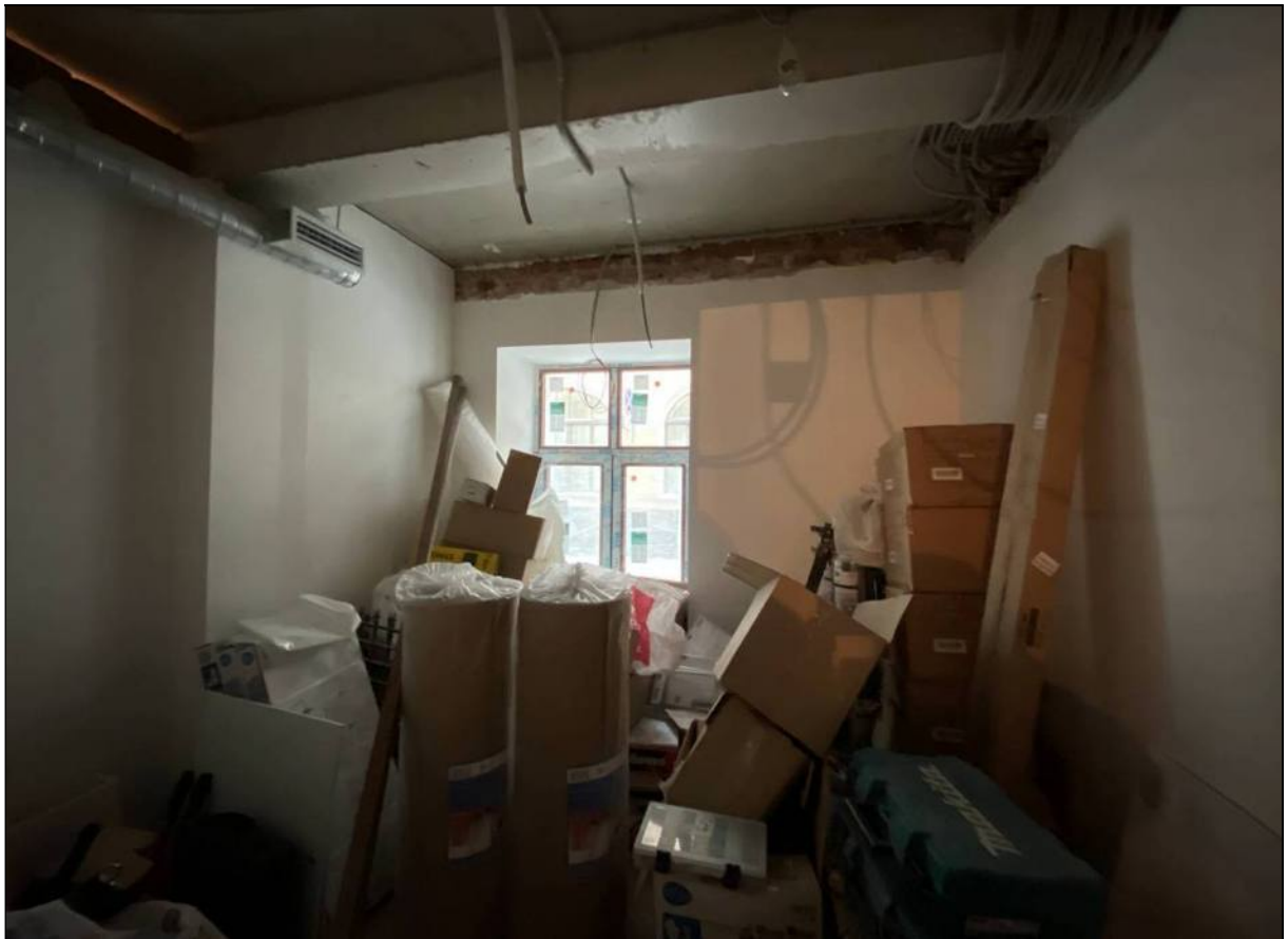
63. Объект культурного наследия «Большой железный ряд или Кожевенная линия». Северный корпус. 1-й этаж, помещение № 111. 24.02.2021 г.
