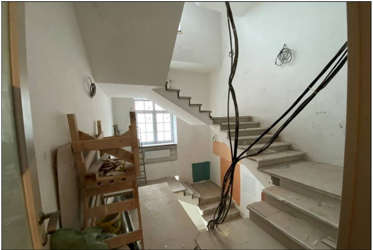
85. Объект культурного наследия «Большой железный ряд или Кожевенная линия». Средний корпус. 3-й этаж, помещение № 324. Лестничные марши. 24.02.2021 г.
