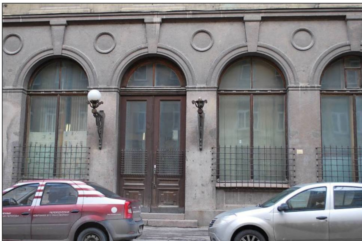
Илл. 187. Объект культурного наследия «Большой железный ряд или Кожевенная линия». Средний корпус. Фрагмент лицевого фасада по Мучному переулку. Оформление дверного проема. 31.03.2019 г.
