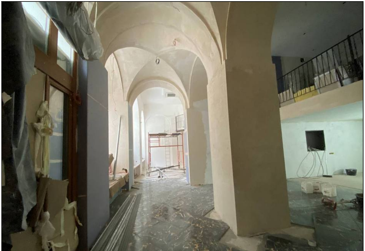
44. Объект культурного наследия «Большой железный ряд или Кожевенная линия». Северный корпус. 1-й этаж, помещение № 101. Вид от входа в помещение № 118 среднего корпуса. 24.02.2021 г.
