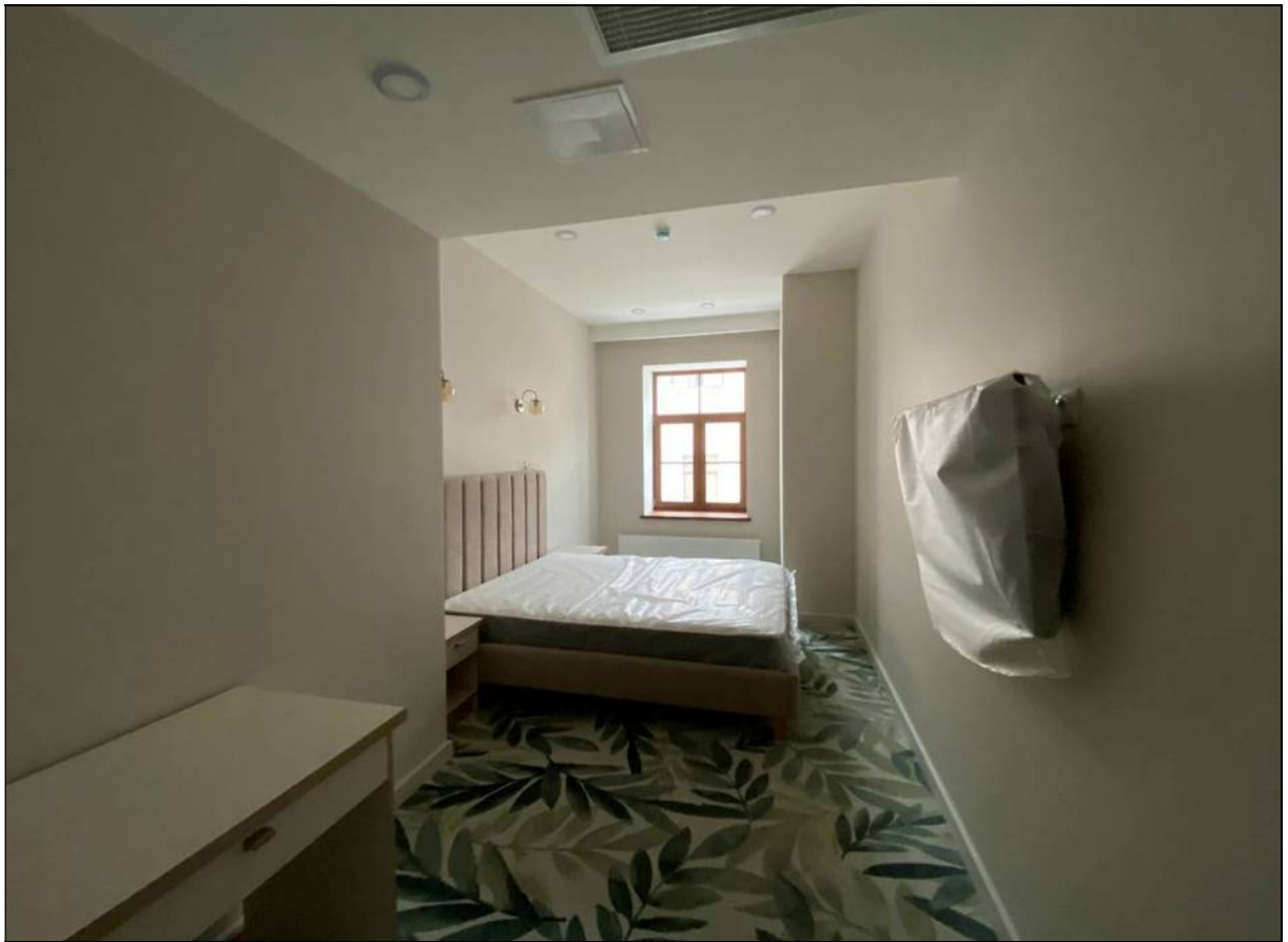
101. Объект культурного наследия «Большой железный ряд или Кожевенная линия». Северный корпус. 3-й этаж, северная часть помещения № 301/1. 24.02.2021 г.
