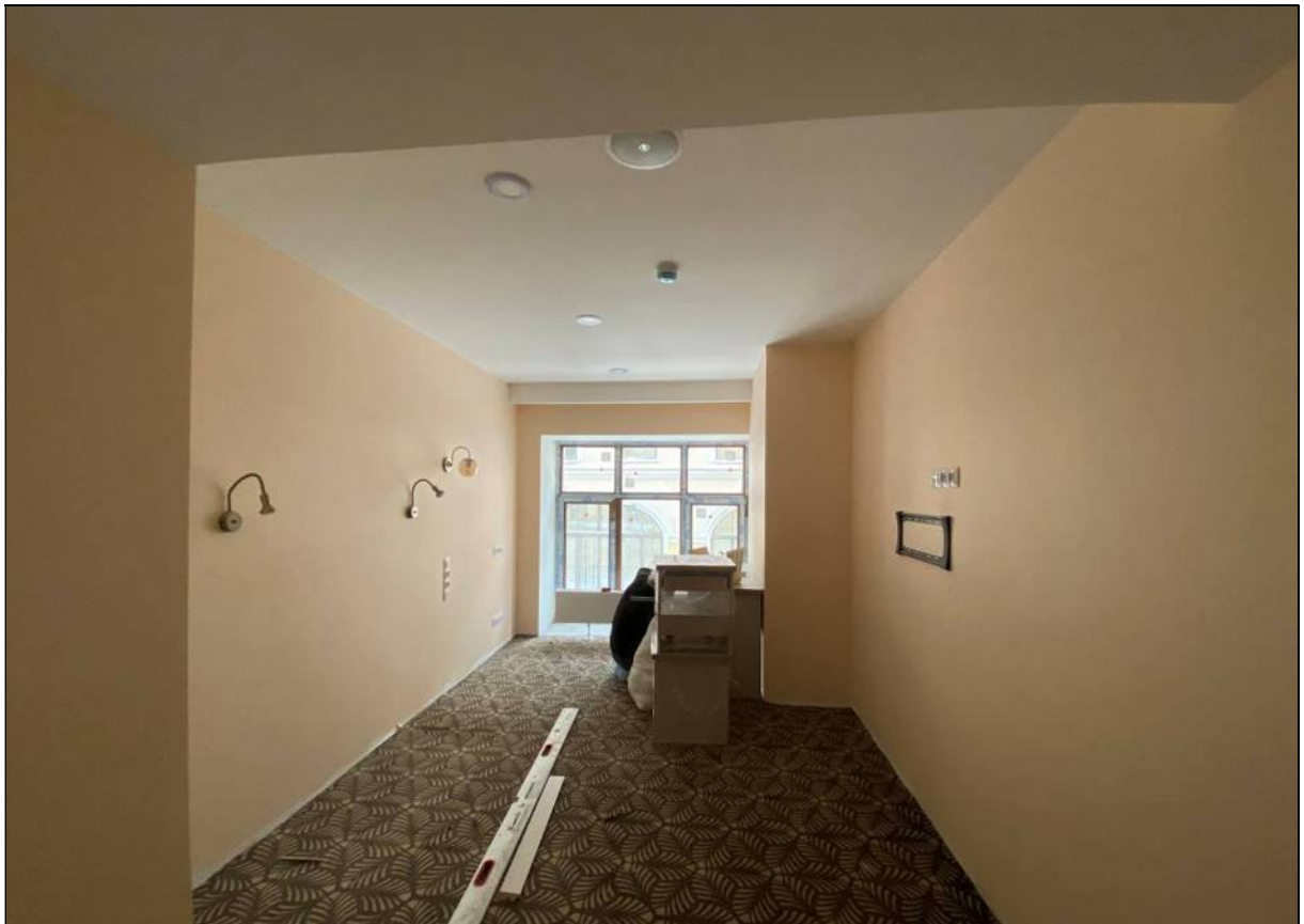
82. Объект культурного наследия «Большой железный ряд или Кожевенная линия». Северный корпус. 2-й этаж, помещение № 201/1. 24.02.2021 г.
