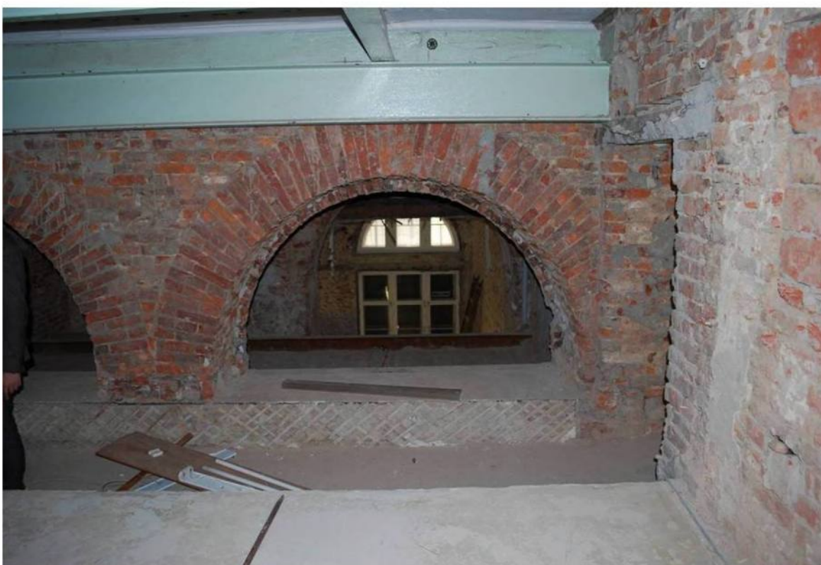
Илл. 224. Объект культурного наследия «Большой железный ряд или Кожевенная линия». Средний корпус. 2-й этаж, северная часть помещения № 68, арочный проем. 31.03.2019 г.
