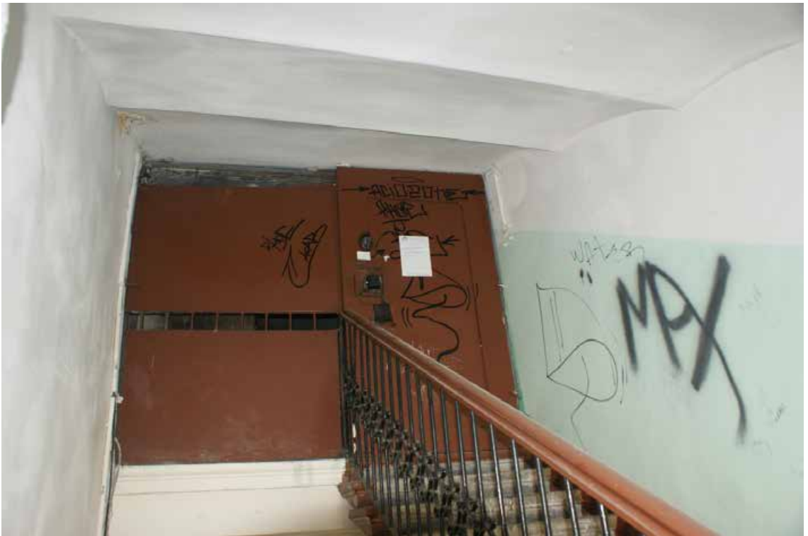
Фото 170. Лестница № 7. Чердачный этаж. Съемка 19.04.2021 г. Трушковский В.Э.
