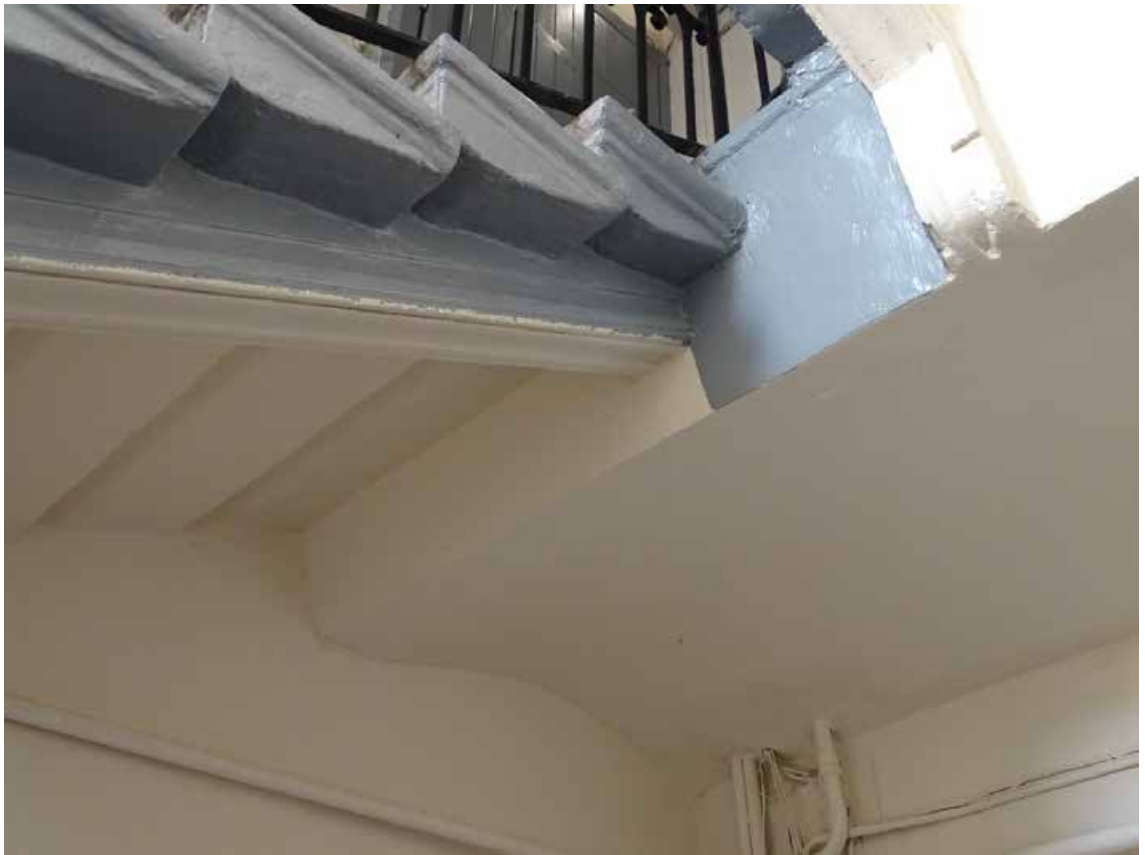
Фото 97. Лестница № 4. 3-й этаж. Оформление потолка. Съемка 19.04.2021 г. Трушковский В.Э.
