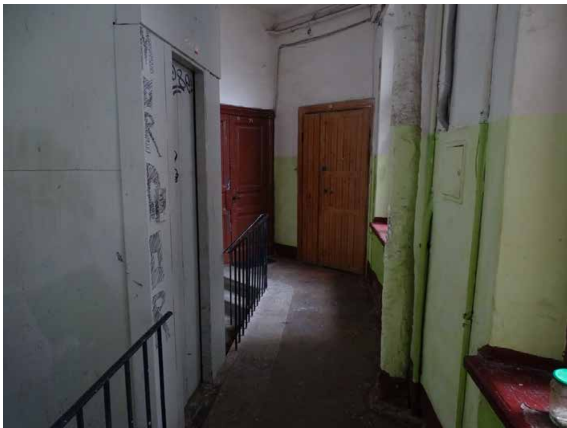
Фото 203. Лестница № 8. Площадка 5-го этажа. Съемка 19.04.2021 г. Трушковский В.Э.
