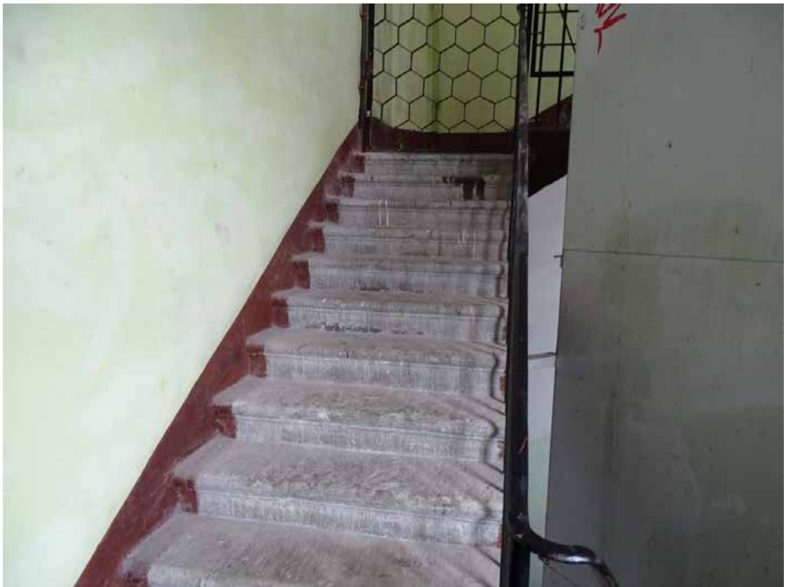
Фото 207. Лестница № 8. Лестничный марш м/у 5-м и 6-м этажом. Съемка 19.04.2021 г. Трушковский В.Э.
