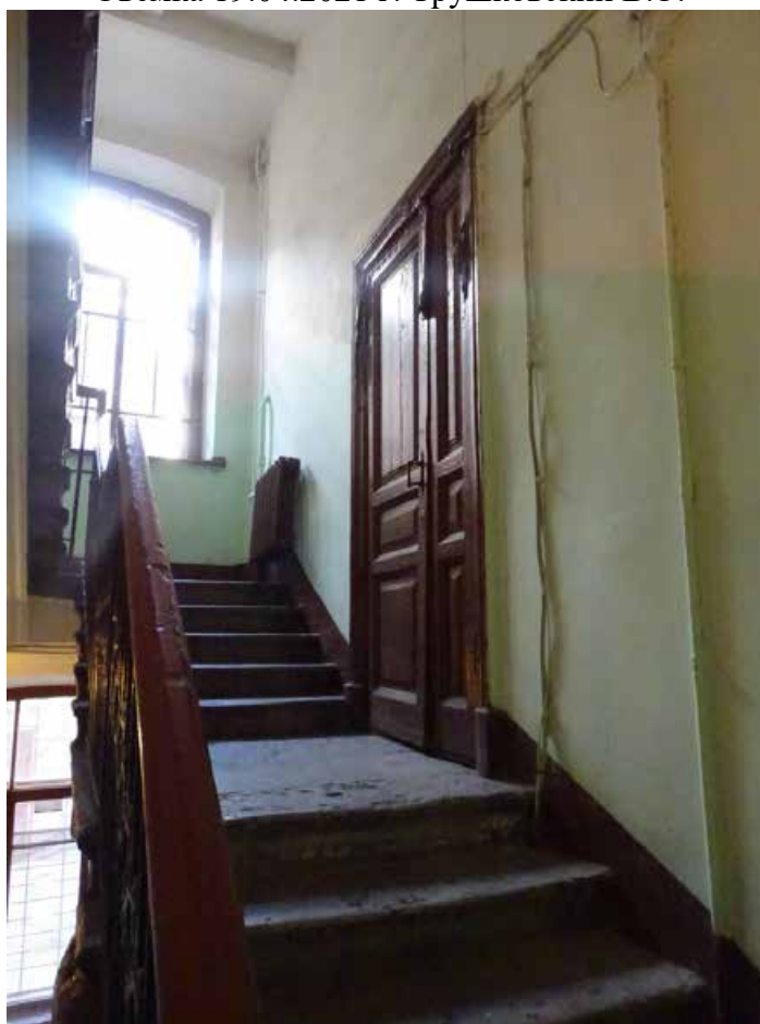
Фото 151. Лестница № 7. Промежуточная площадка м/у 1-м и 2-м этажом. Съемка 19.04.2021 г. Трушковский В.Э.
