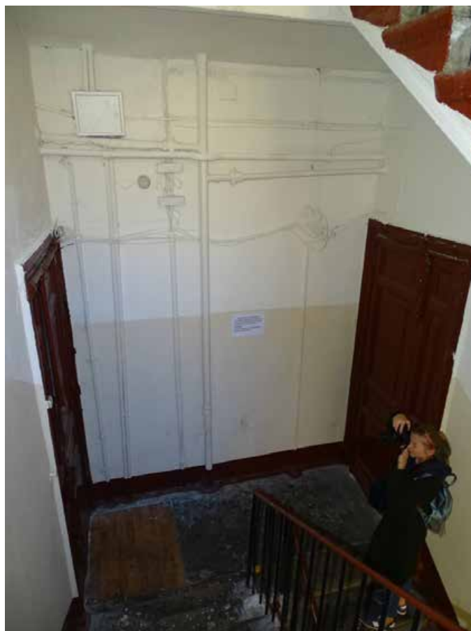
Фото 116. Лестница № 5. Площадка 2-го этажа. Съемка 19.04.2021 г. Трушковский В.Э.
