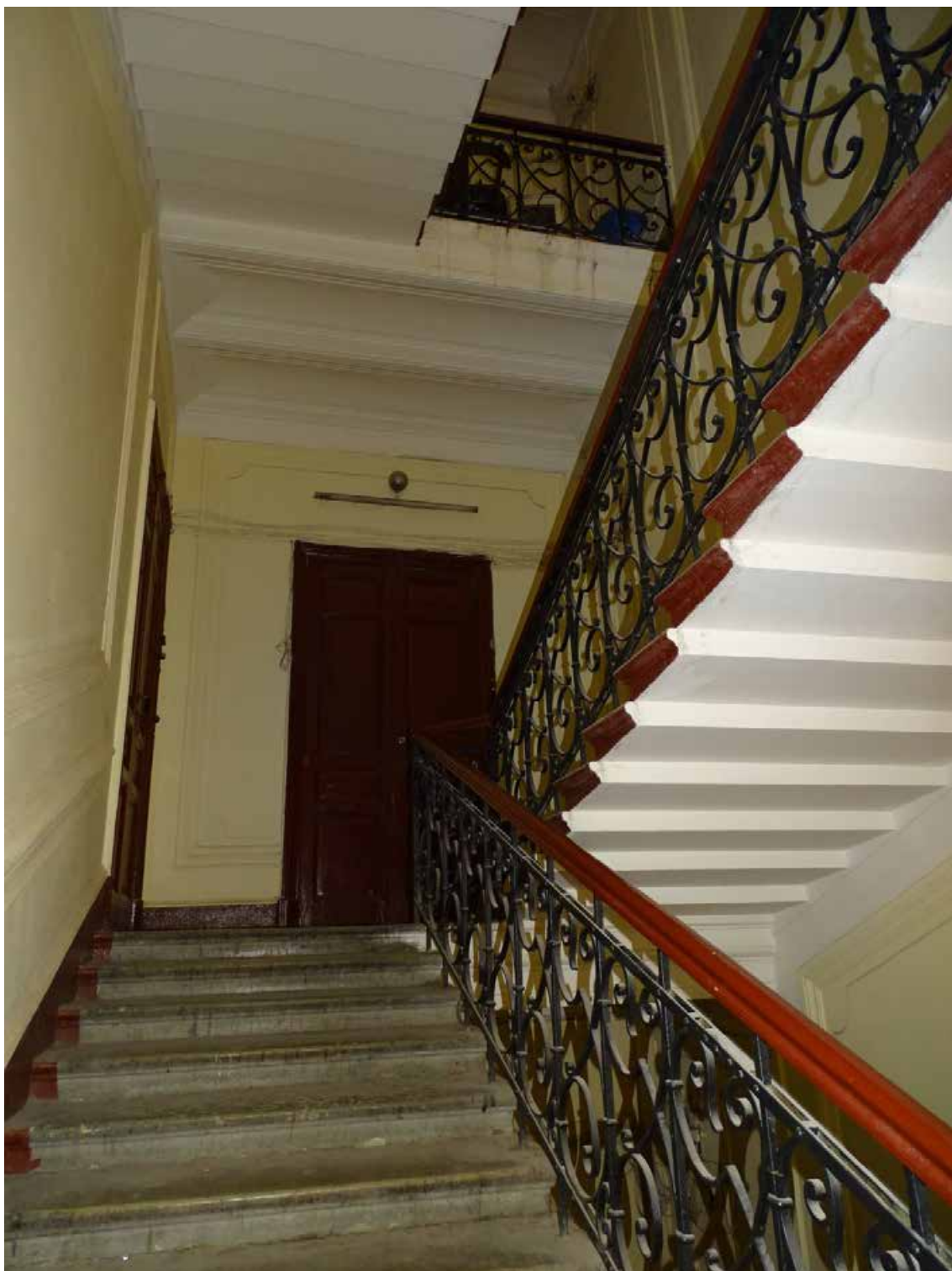
Фото 26. Лестница № 1. Вид на площадку 3-го этажа. Съемка 19.04.2021 г. Трушковский В.Э.
