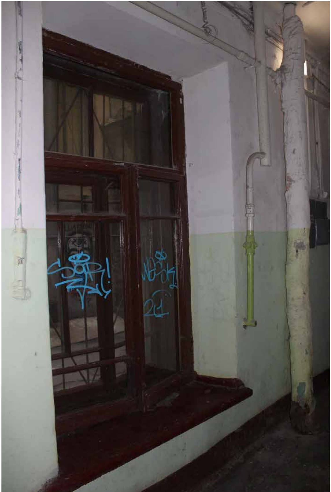
Фото 179. Лестница № 8. Вестибюль 1-го этажа. Оформление окна.
