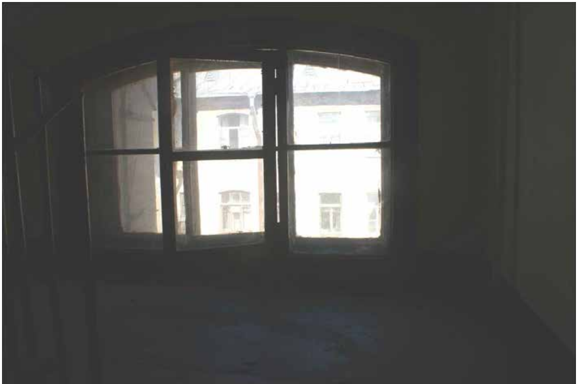
Фото 141. Лестница № 6. Площадка м/у 4-м и 5-м этажом. Съемка 19.04.2021 г. Трушковский В.Э.
