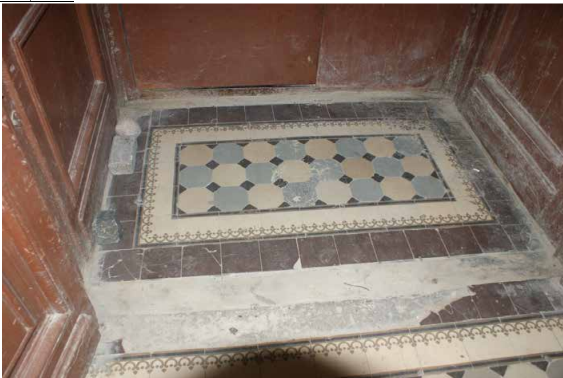
Фото 35. Лестница № 2. Тамбур. Покрытие пола. Съемка 19.04.2021 г. Трушковский В.Э.
