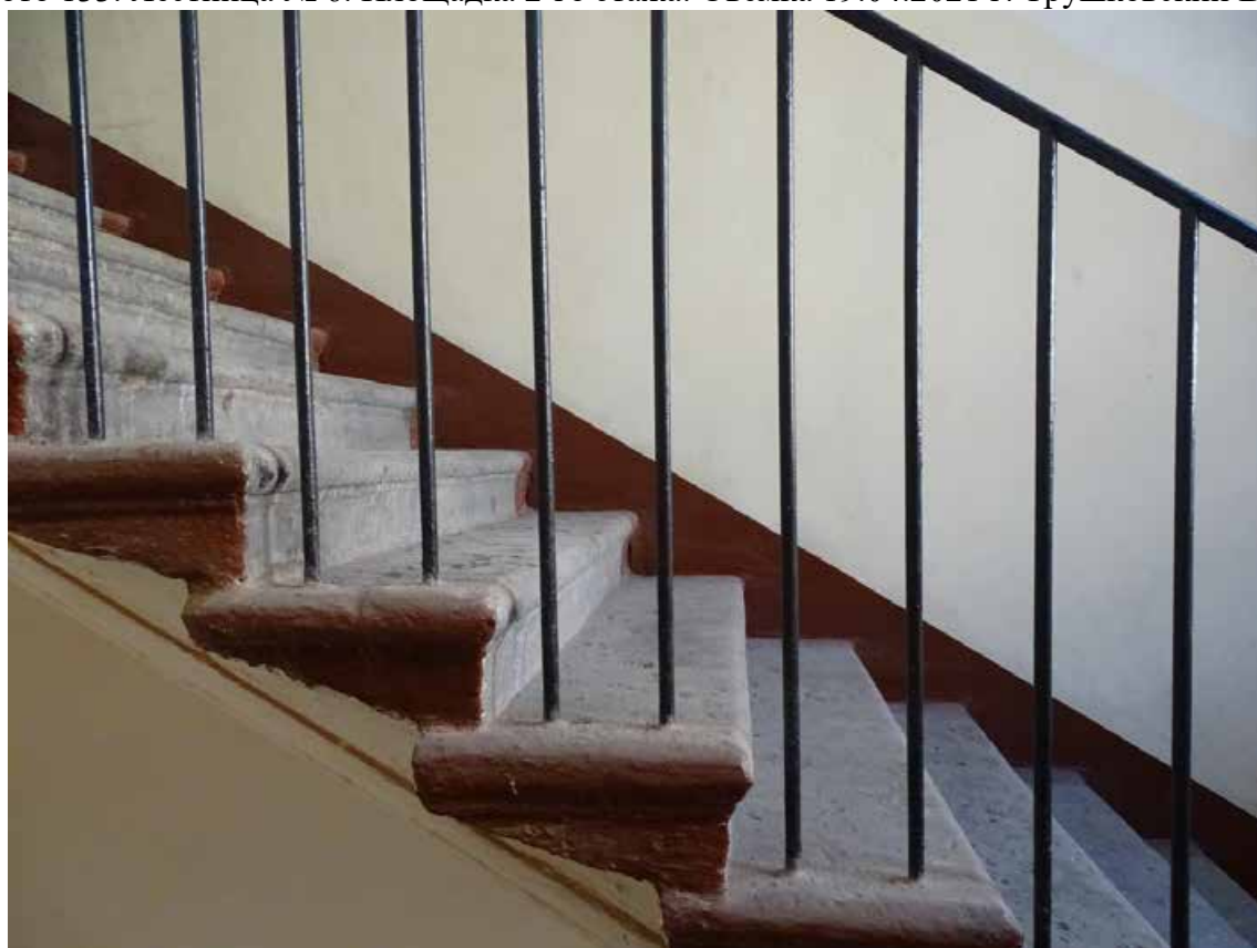
Фото 134. Лестница № 6. 2-й этажа. Лестничное ограждение. Съемка 19.04.2021 г. Трушковский В.Э.
