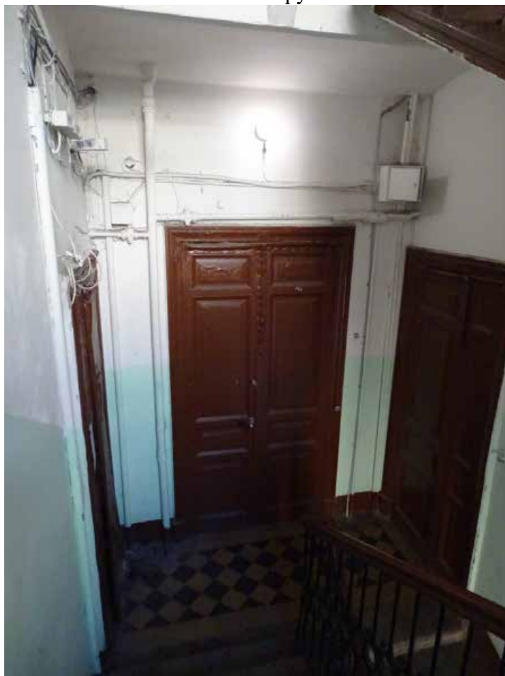
Фото 155. Лестница № 7. Площадка 2-го этажа. Съемка 19.04.2021 г. Трушковский В.Э.
