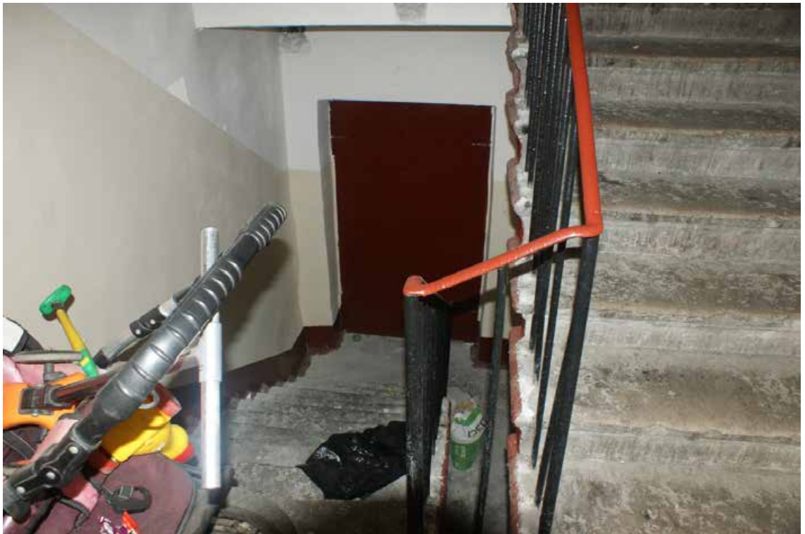
Фото 108. Лестница № 5. 1-й этаж. Спуск в подвал. Съемка 19.04.2021 г. Трушковский В.Э.
