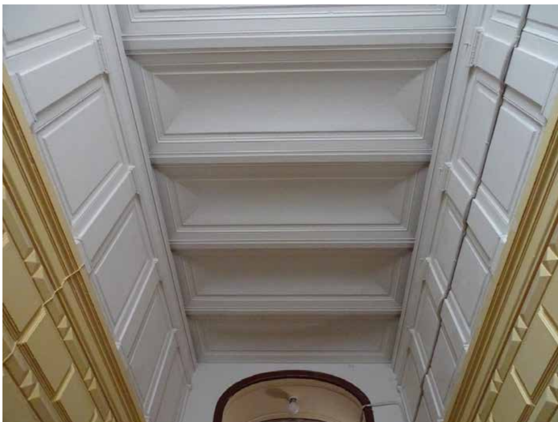
Фото 72. Лестница № 3. 1-й этаж. Вестибюль. Оформление потолка. Съёмка 19.04.2021 г. Трушковский В.Э.
