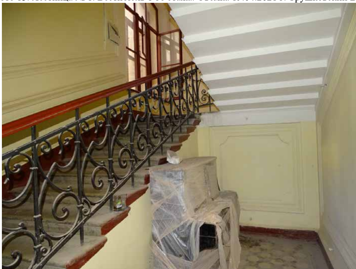
Фото 14. Лестница № 1. Вестибюль 1-го этажа. Съемка 19.04.2021 г. Трушковский В.Э.
