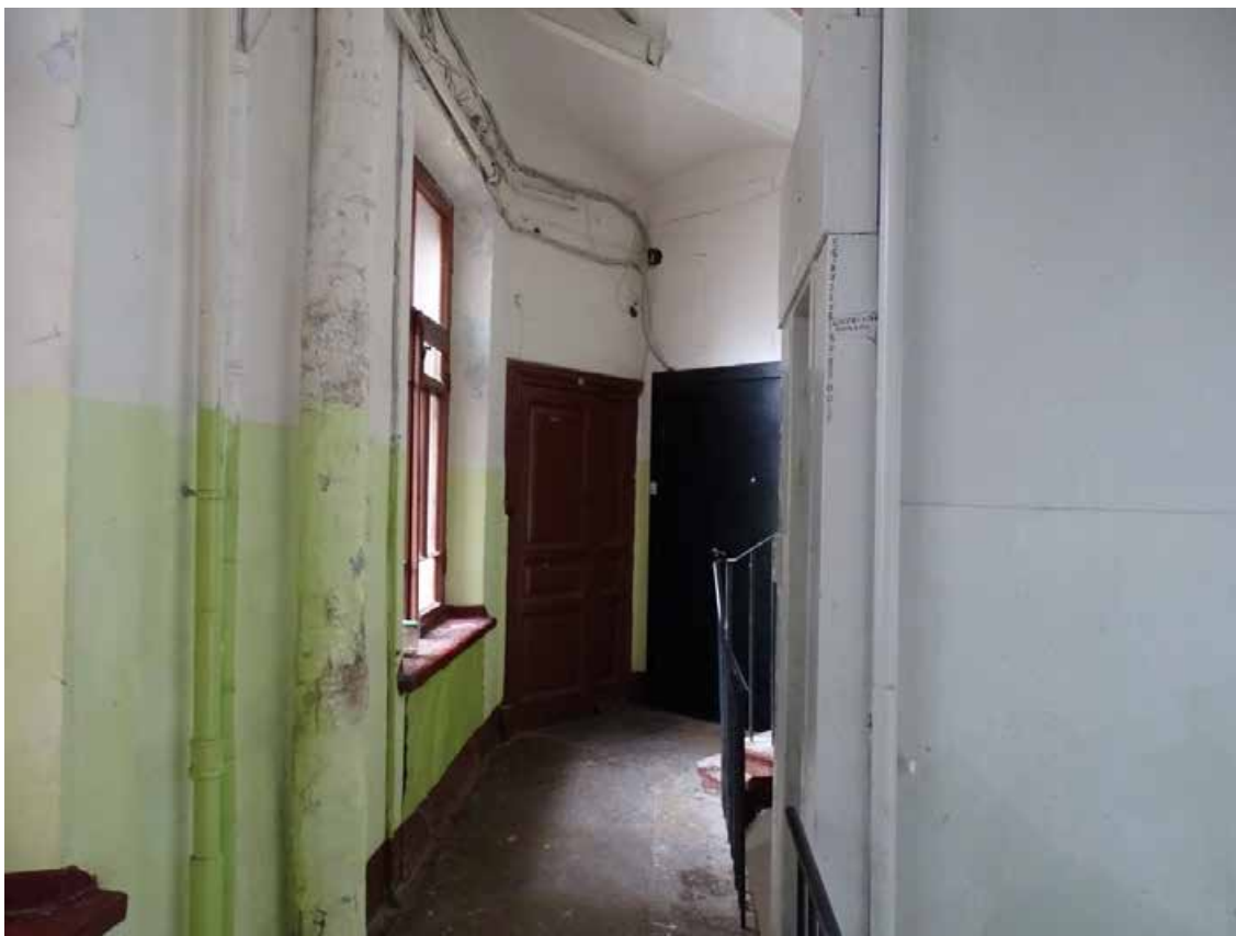
Фото 204. Лестница № 7. Площадка 5-го этажа. Съемка 19.04.2021 г. Трушковский В.Э.
