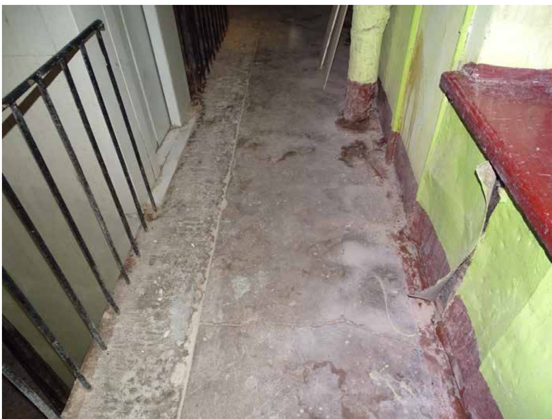
Фото 187. Лестница № 8. Площадка 2-го этажа. Покрытие пола. Съемка 19.04.2021 г. Трушковский В.Э.
