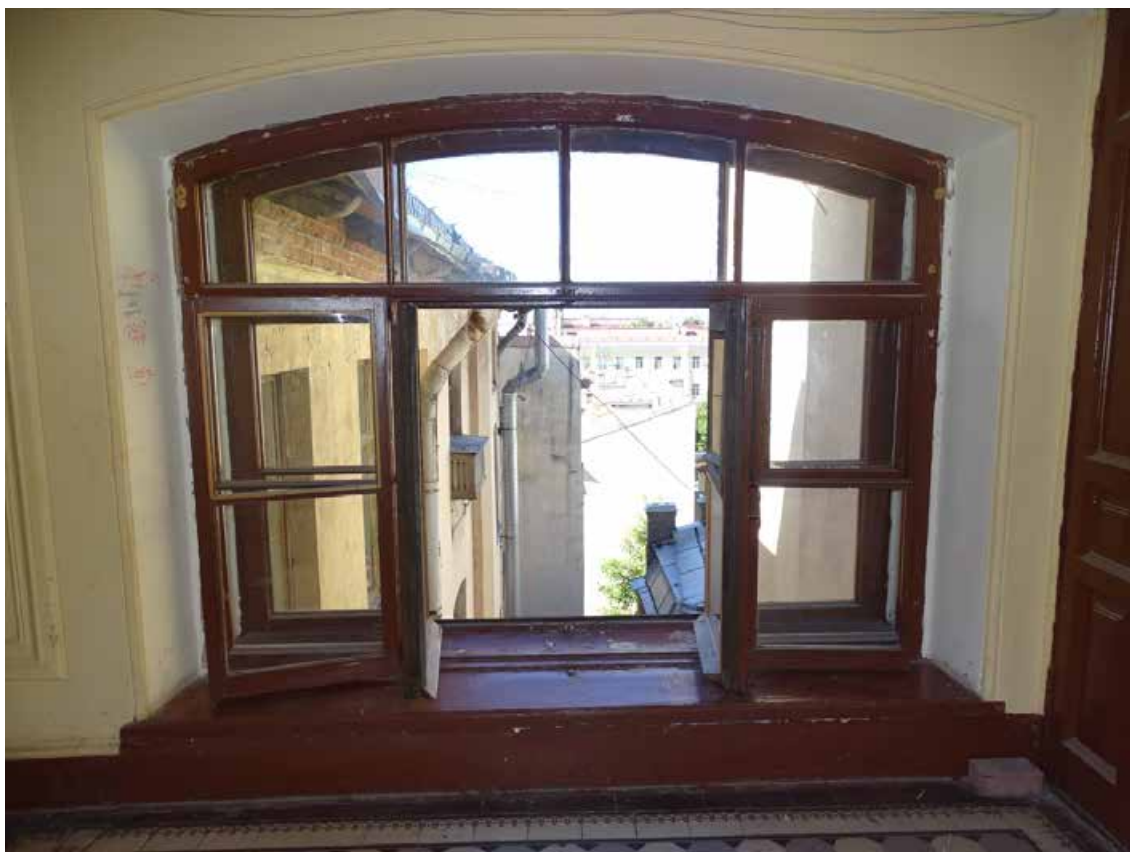
Фото 62. Лестница № 2. Площадкам 5-го этажа. Оконное заполнение. Съемка 19.04.2021 г. Трушковский В.Э.
