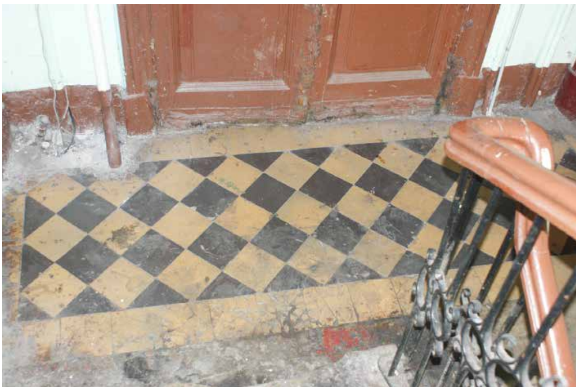
Фото 166. Лестница № 7. Площадка 4-го этажа. Покрытие пола. Съемка 19.04.2021 г. Трушковский В.Э.
