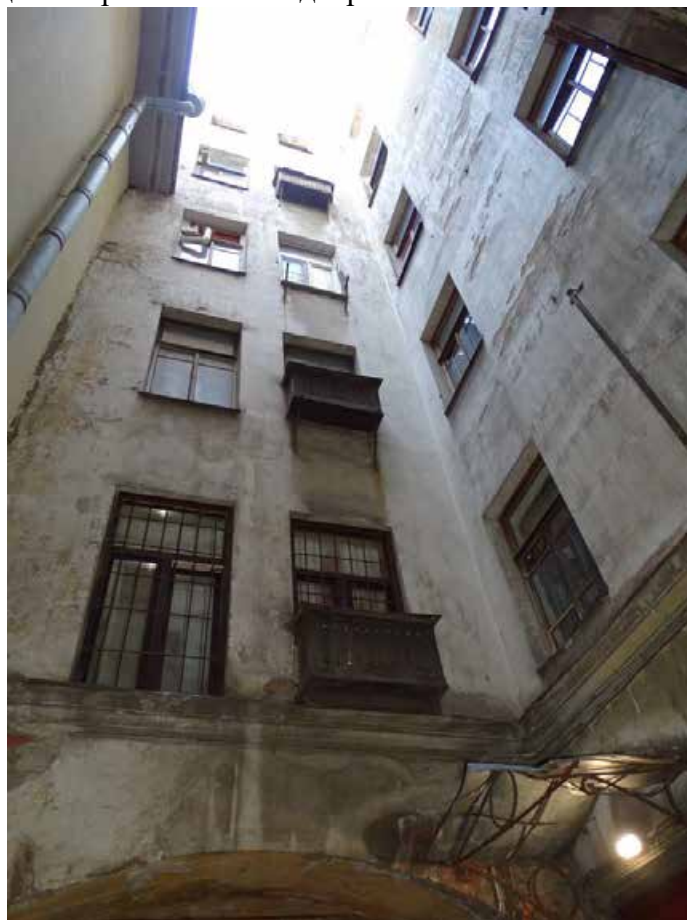
Фото 35. Здание по адресу: г. Санкт-Петербург, Тучков пер., 11/5, литера А. Дворовой фасад. Съемка 19.04.2021 г. Трушковский В.Э.
