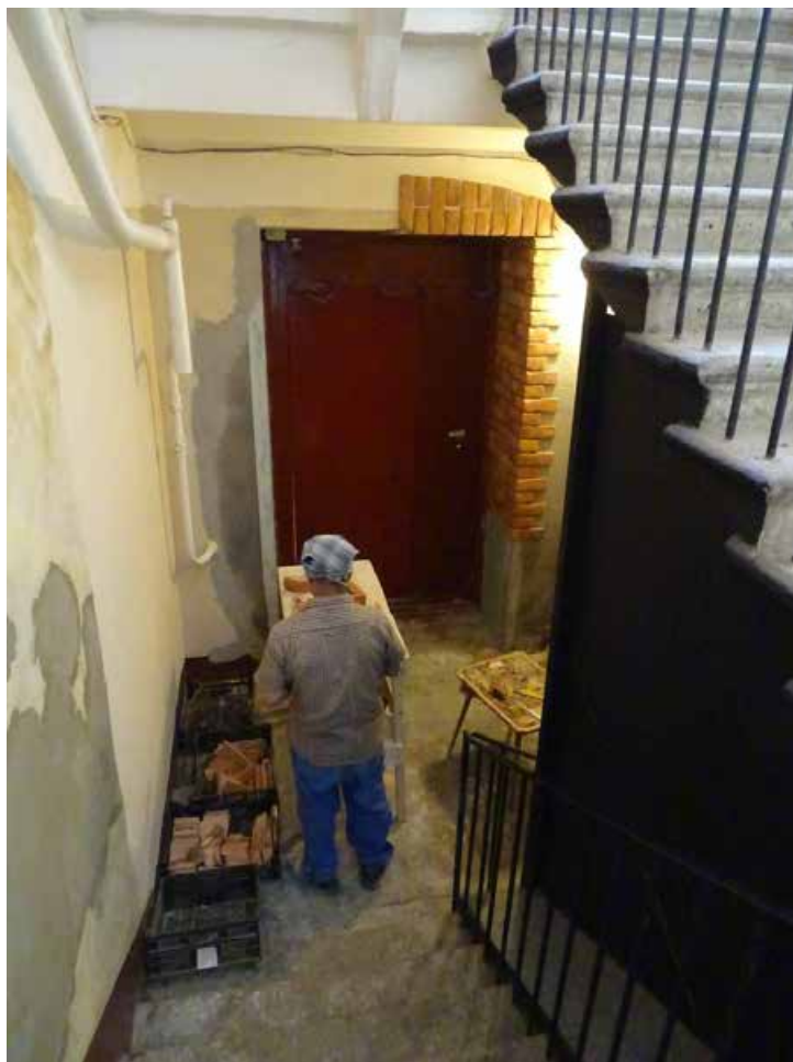
Фото 127. Лестница № 6. 1-й этаж. Входная дверь. Съемка 19.04.2021 г. Трушковский В.Э.
