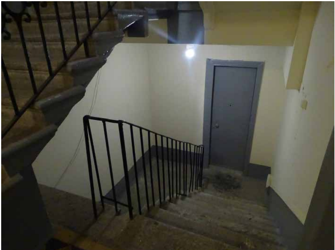
Фото 87. Лестница № 4. Подвал. Съемка 19.04.2021 г. Трушковский В.Э.
