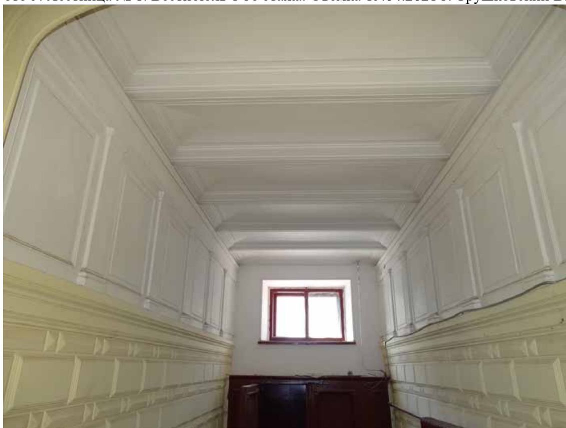
Фото 10. Лестница № 1. Вестибюль 1-го этажа. Оформление потолка. Съёмка 19.04.2021 г. Трушковский В.Э.
