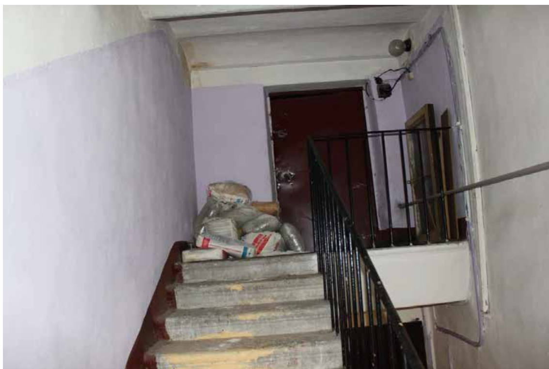
Фото 218. Лестница службы: Площадка 3-го этажа. Съемка 19.04.2021 г. Трушковский В.Э.
