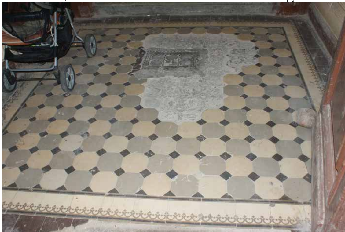
Фото 38. Лестница № 2. Вестибюль 1-го этажа. Покрытие пола. Съемка 19.04.2021 г. Трушковский В.Э.
