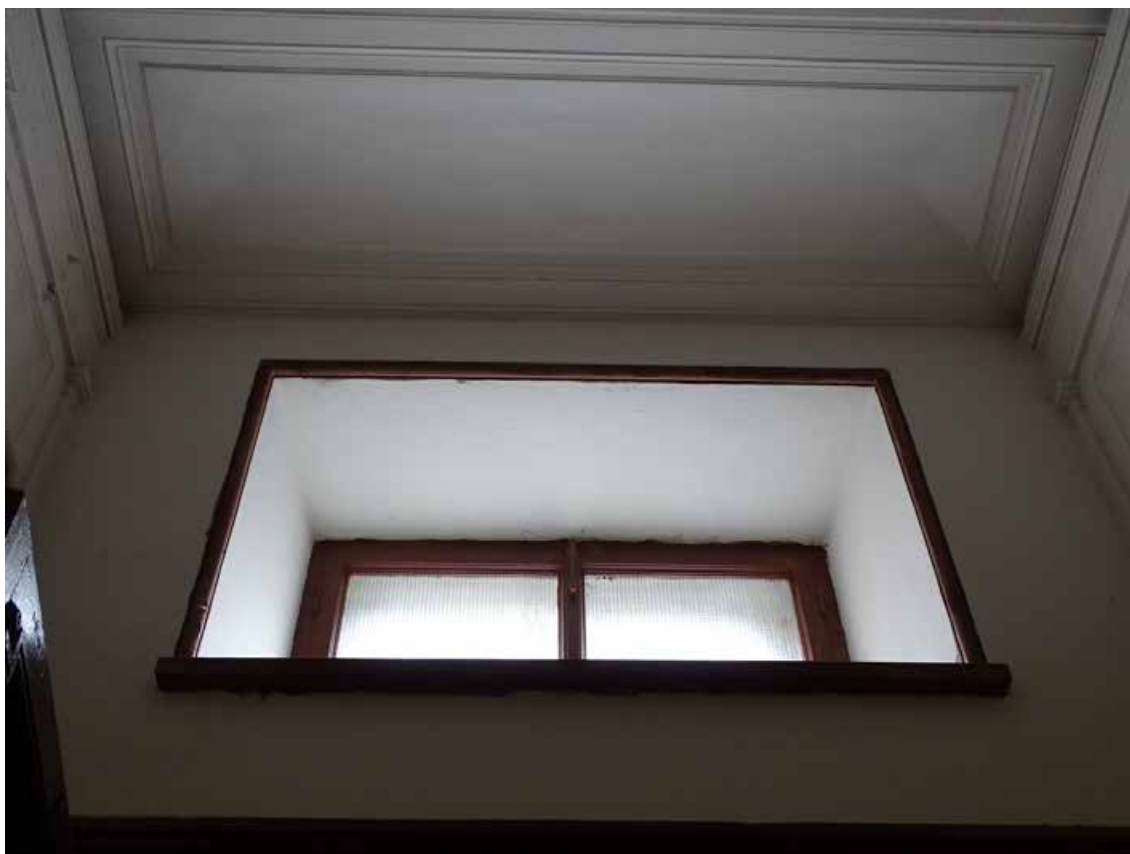
Фото 65. Лестница № 3. 1-й этаж. Вестибюль. Съемка 19.04.2021 г. Трушковский В.Э.
