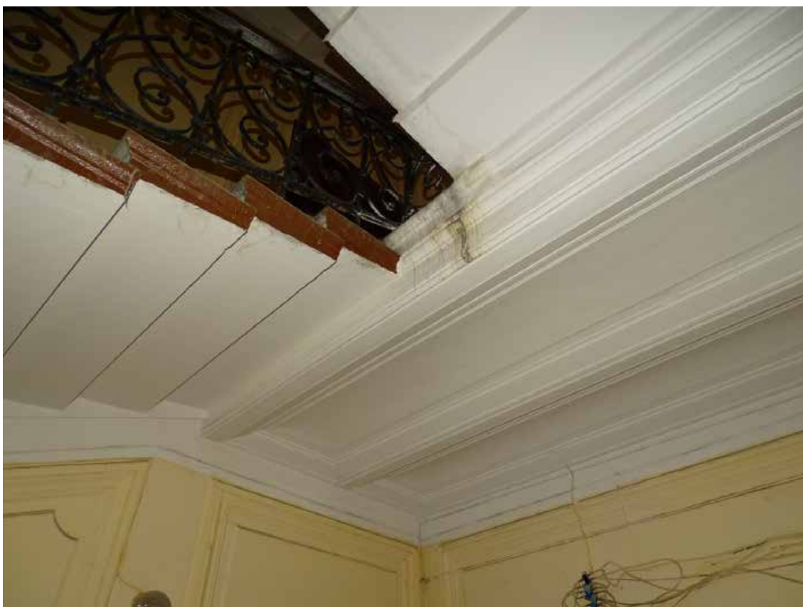
Фото 51. Лестница № 2. 2-й этаж. Оформление потолка. Съемка 19.04.2021 г. Трушковский В.Э.
