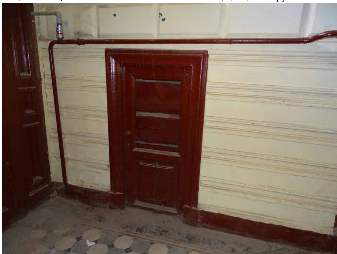
Фото 6. Лестница № 1. Вестибюль 1-го этажа. Съёмка 19.04.2021 г. Трушковский В.Э.
