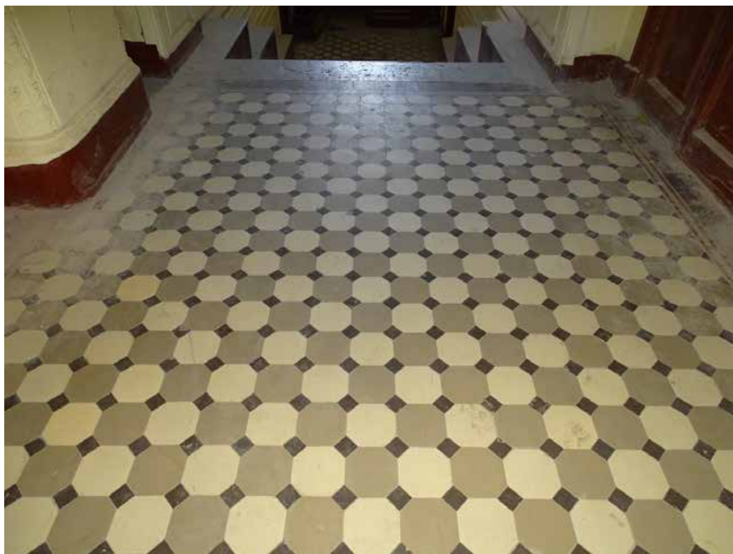
Фото 11. Лестница № 1. Вестибюль 1-го этажа. Покрытие пола. Съемка 19.04.2021 г. Трушковский В.Э.
