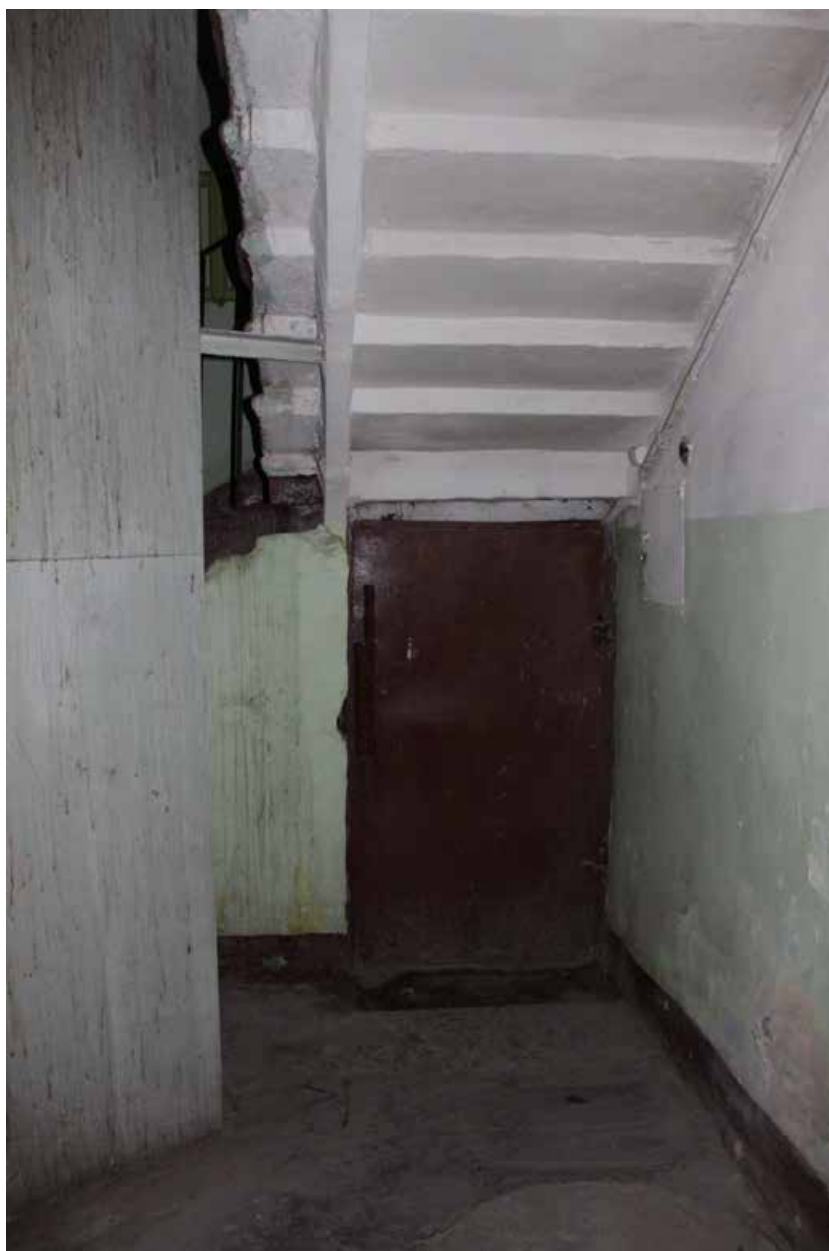
Фото 178. Лестница № 8. Вестибюль 1-го этажа. Пространство под лестницей. Съемка 19.04.2021 г. Трушковский В.Э.
