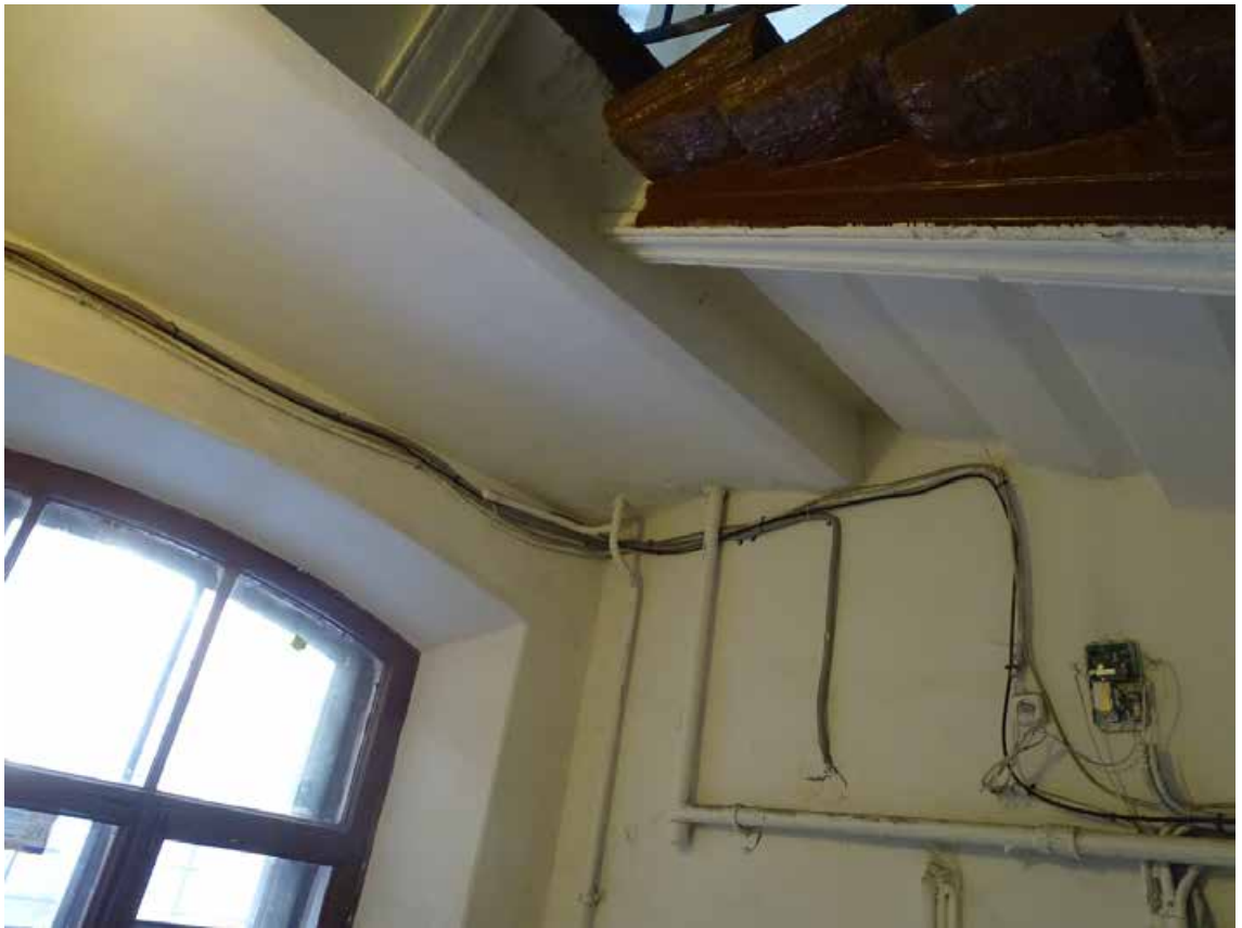
Фото 148. Лестница № 7. Вестибюль 1-й этаж. Съёмка 19.04.2021 г. Трушковский В.Э.
