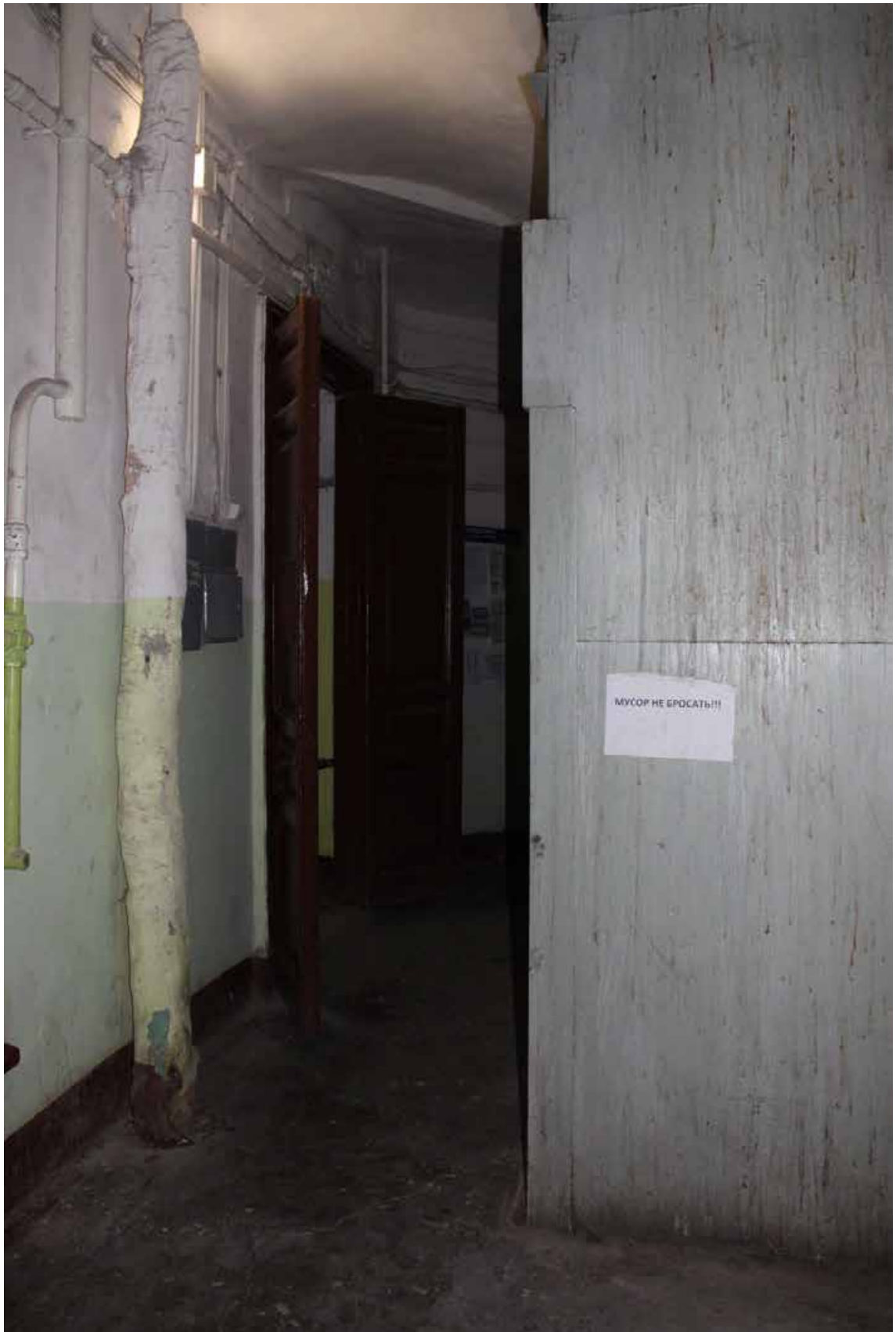
Фото 180. Лестница № 8. Вестибюль 1-го этажа. Съемка 19.04.2021 г. Трушковский В.Э.
