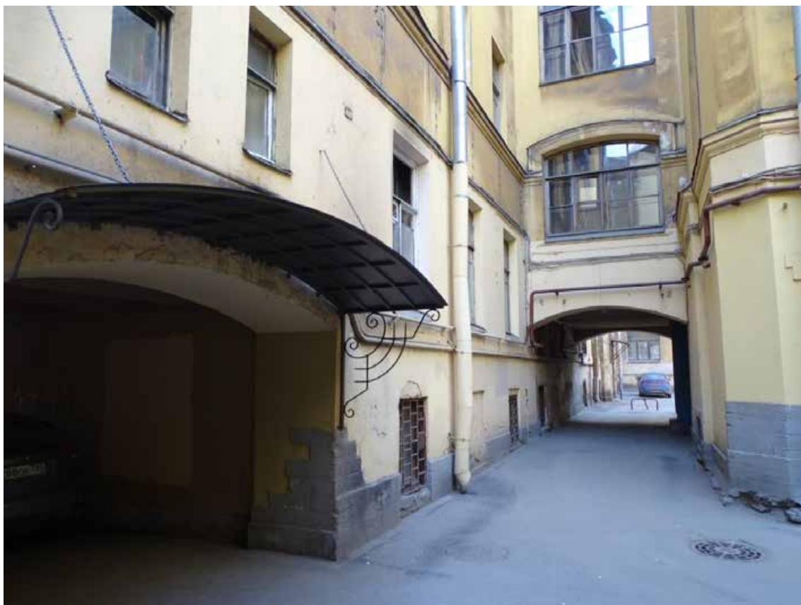
Фото 47. Здание по адресу: г. Санкт-Петербург, Тучков пер., 11/5, литера А. Фрагмент северо-восточного дворового фасада. Съемка 19.04.2021 г. Трушковский В.Э.
