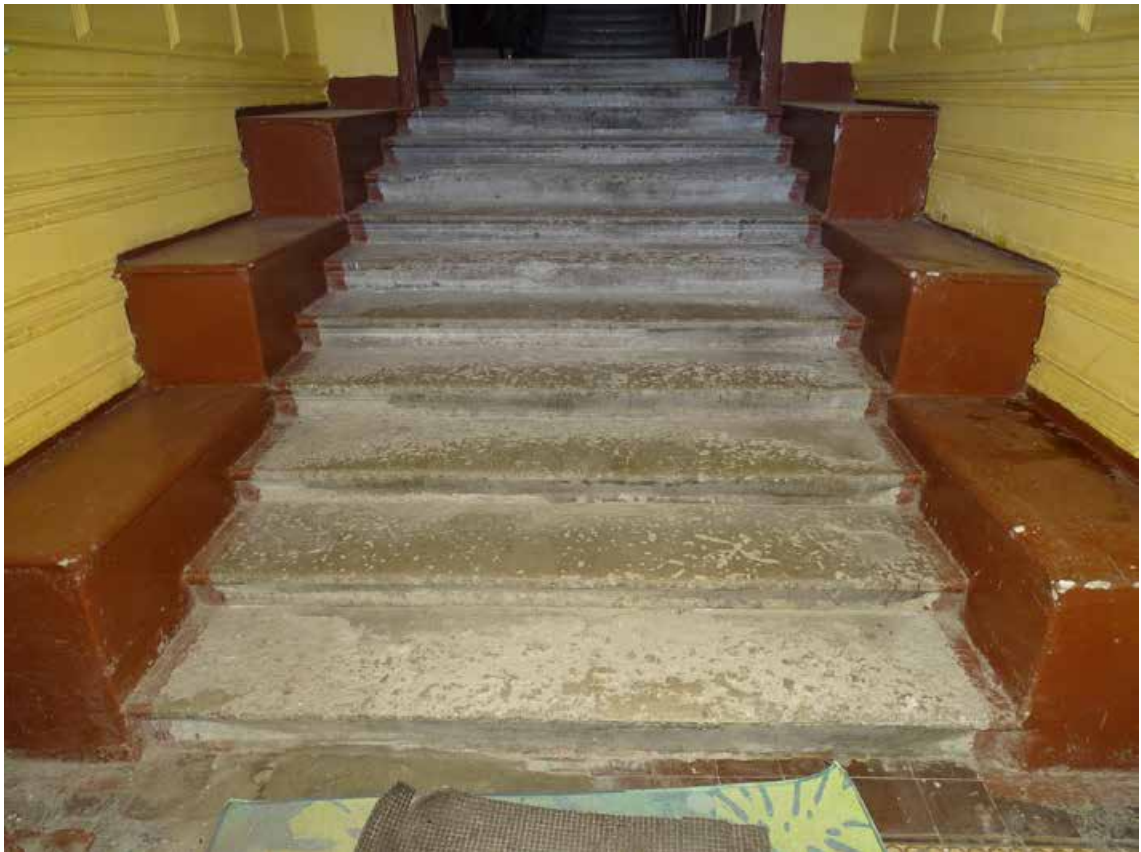
Фото 75. Лестница № 3. 1-й этаж. Вестибюль. Одномаршевая лестница. Съемка 19.04.2021 г. Трушковский В.Э.
