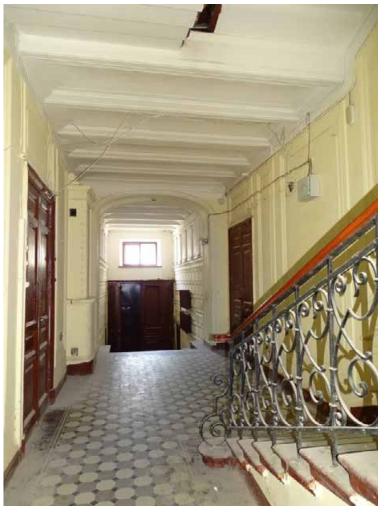
Фото 15. Лестница № 1. Вестибюль 1-го этажа. Съемка 19.04.2021 г. Трушковский В.Э.
