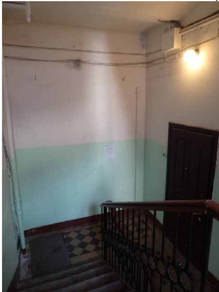
Фото 149. Лестница № 7. Площадка 1-го этажа. Съёмка 19.04.2021 г. Трушковский В.Э.
