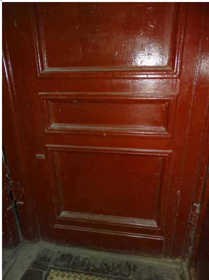
Фото 8. Лестница № 1. Вестибюль 1-го этажа. Входная дверь. Съемка 19.04.2021 г. Трушковский В.Э.
