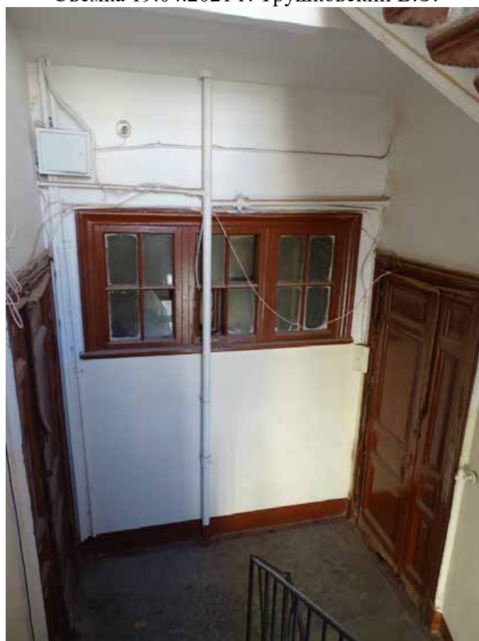
Фото 136. Лестница № 6. Площадка 3-го этажа. Съемка 19.04.2021 г. Трушковский В.Э.
