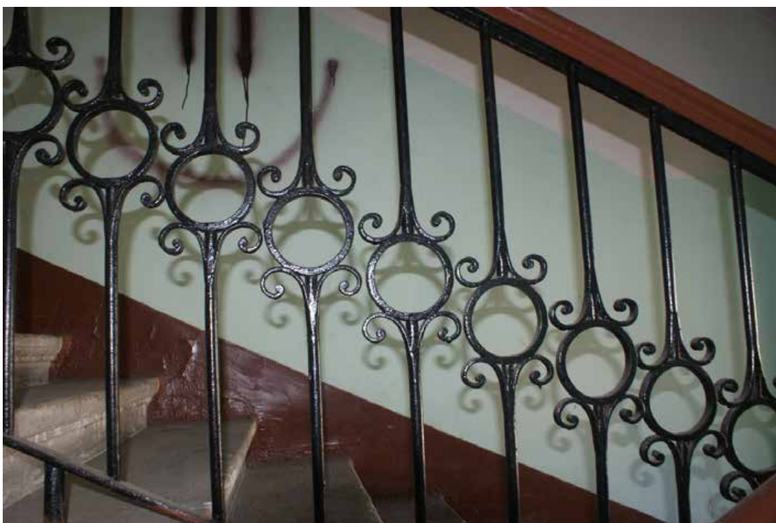
Фото 167. Лестница № 7. Площадка 4-го этажа. Лестничное ограждение. Съемка 19.04.2021 г. Трушковский В.Э.
