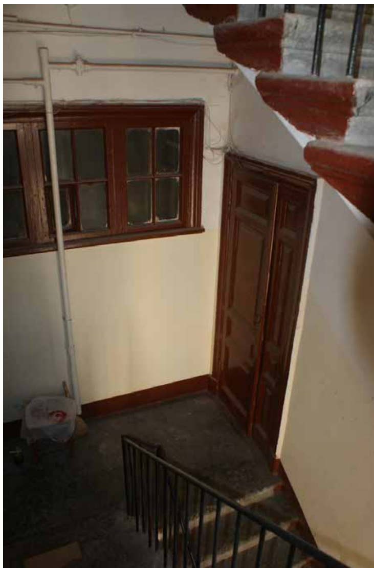
Фото 139. Лестница № 6. Площадка 4-го этажа. Съемка 19.04.2021 г. Трушковский В.Э.
