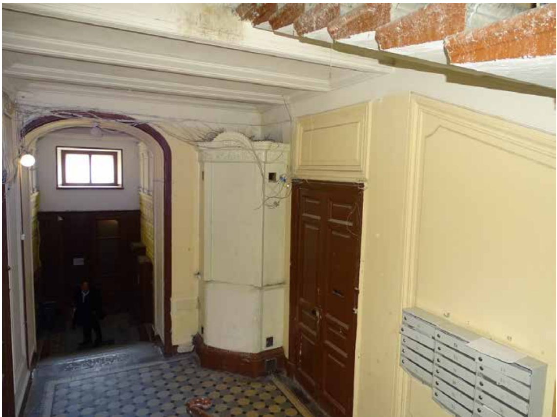
Фото 76. Лестница № 3. 1-й этаж. Вестибюль. Съемка 19.04.2021 г. Трушковский В.Э.
