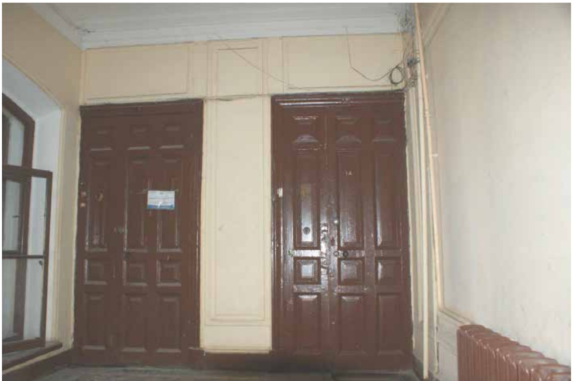
Фото 46. Лестница № 2. Площадка между 1-м и 2-м этажом. Съемка 19.04.2021 г. Трушковский В.Э.
