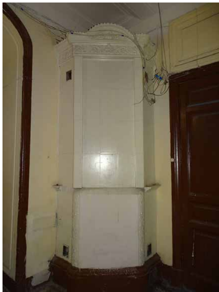
Фото 79. Лестница № 3. 1-й этаж. Вестибюль. Печь. Съемка 19.04.2021 г. Трушковский В.Э.
