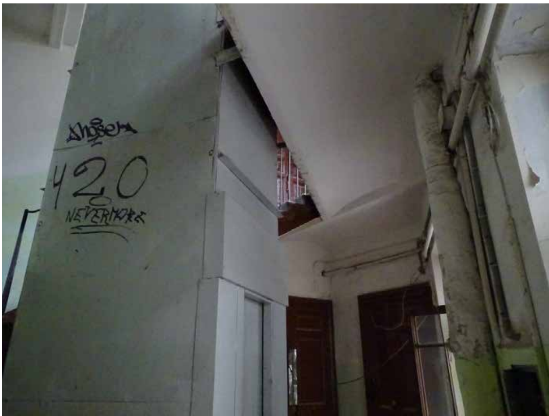
Фото 192. Лестница № 8. Площадка 3-го этажа. Съемка 19.04.2021 г. Трушковский В.Э.
