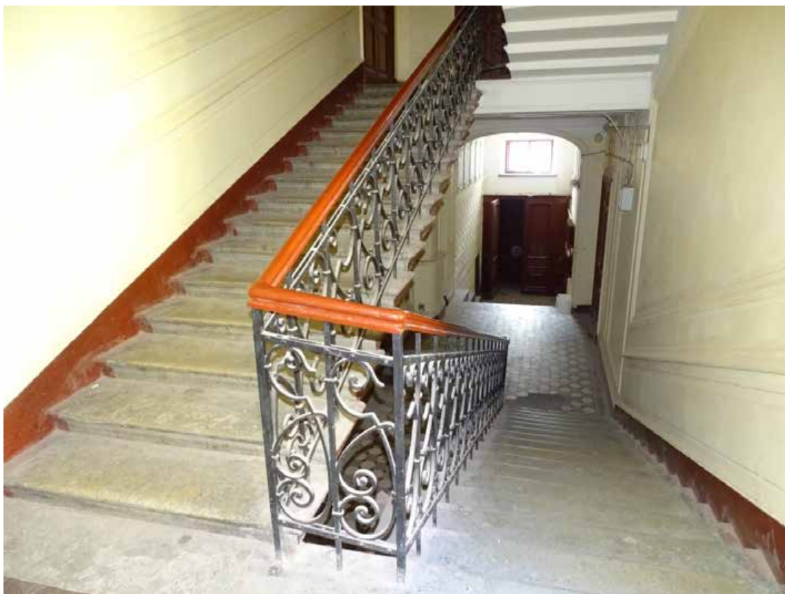
Фото 20. Лестница № 1. Площадка м/у 1-м и 2-м этажом. Вид на вестибюль 1-го этажа. Съемка 19.04.2021 г. Трушковский В.Э.
