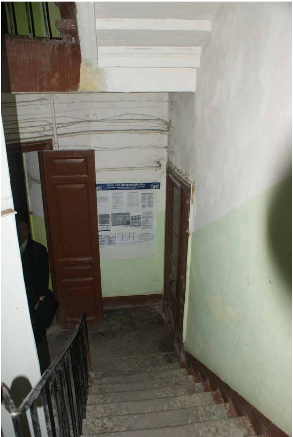
Фото 181. Лестница № 8. Вестибюль 1-го этажа. Съёмка 19.04.2021 г. Трушковский В.Э.
