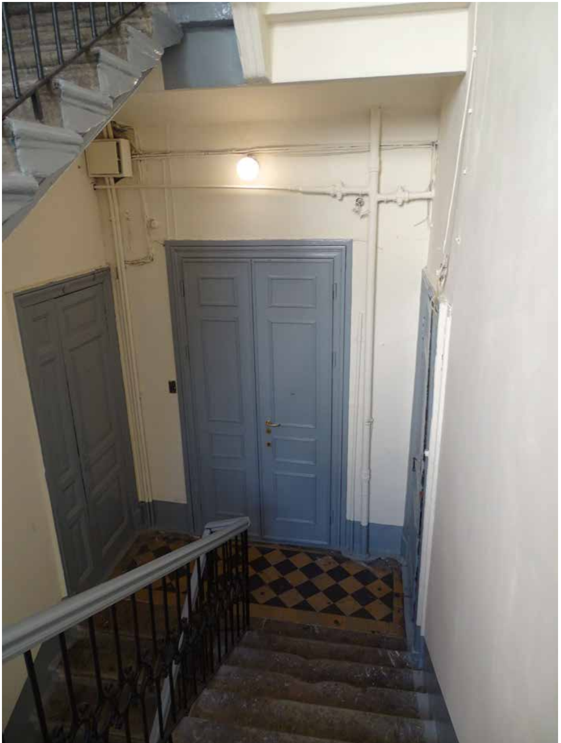
Фото 94. Лестница № 4. Площадка 2-го этажа. Съемка 19.04.2021 г. Трушковский В.Э.
