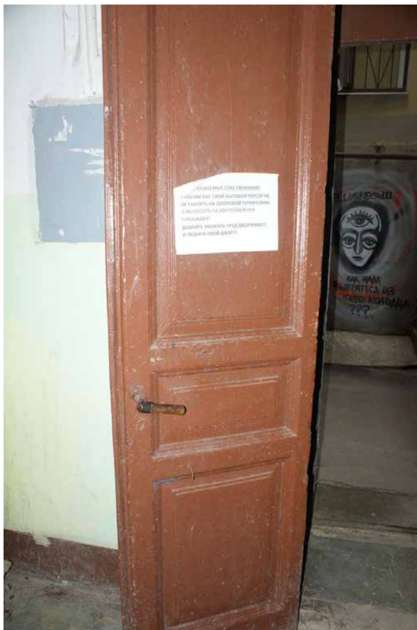
Фото 174. Лестница № 8. Вестибюль 1-го этажа. Входная дверь. Съемка 19.04.2021 г. Трушковский В.Э.
