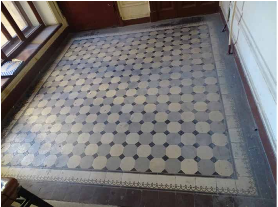
Фото 58. Лестница № 2. Площадка между 3-м и 4-м этажом. Покрытие пола. Съемка 19.04.2021 г. Трушковский В.Э.
