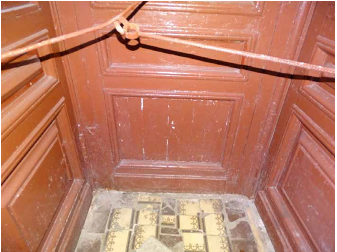
Фото 69. Лестница № 3. 1-й этаж. Тамбур. Съемка 19.04.2021 г. Трушковский В.Э.
