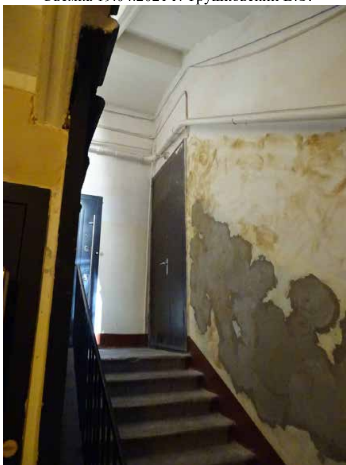
Фото 130. Лестница № 6. 1-й этаж. Съемка 19.04.2021 г. Трушковский В.Э.
