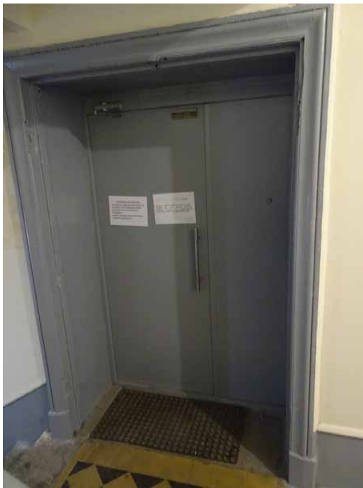
Фото 83. Лестница № 4. 1-й этаж. Вестибюль. Съемка 19.04.2021 г. Трушковский В.Э.
