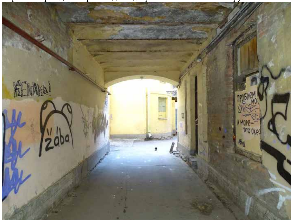
Фото 38. Здание по адресу: г. Санкт-Петербург, Тучков пер., 11/5, литера А. Воротный проезд в северо-восточный двор. Съемка 19.04.2021 г. Трушковский В.Э.
