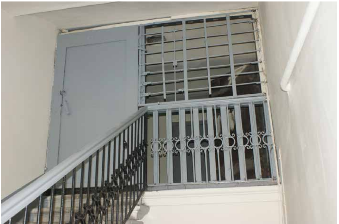
Фото 104. Лестница № 4. 5-й этаж. Съемка 19.04.2021 г. Трушковский В.Э.
