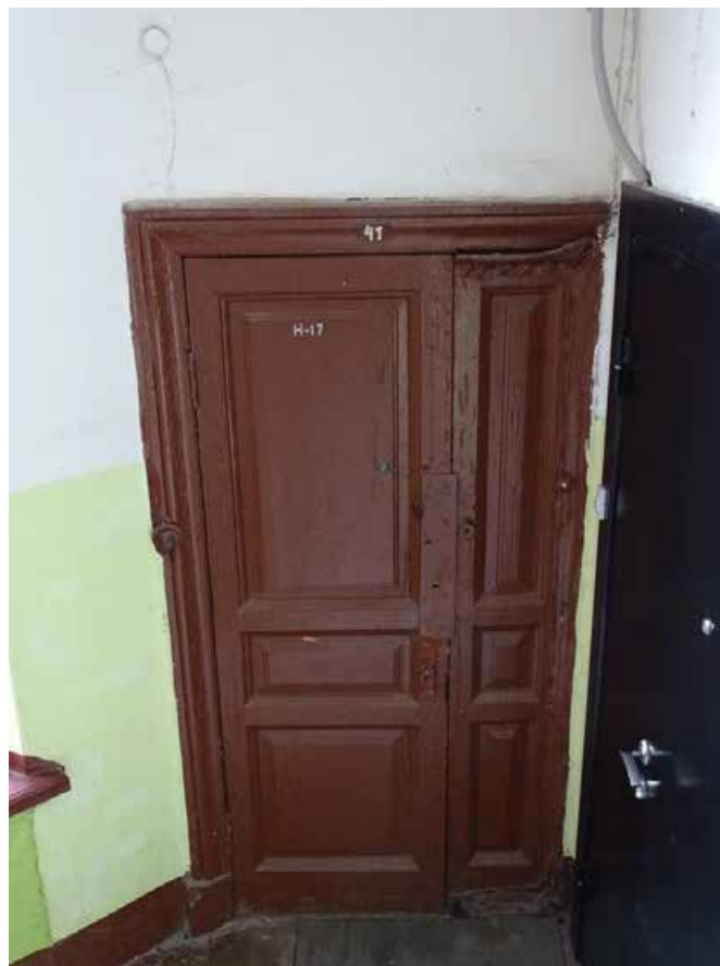
Фото 201. Лестница № 8. Площадка 5-го этажа. Оформление двери. Съемка 19.04.2021 г. Трушковский В.Э.
