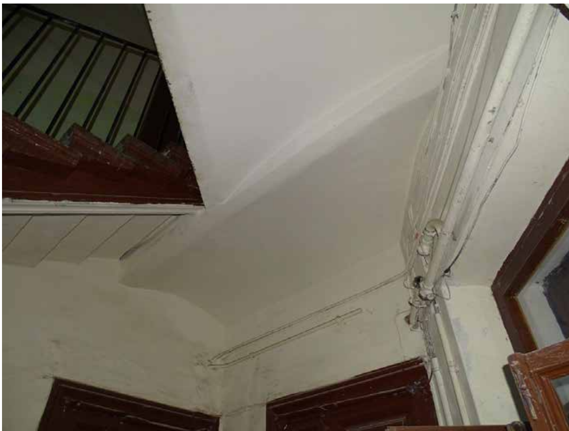
Фото 186. Лестница № 8. Площадка 2-го этажа. Съемка 19.04.2021 г. Трушковский В.Э.
