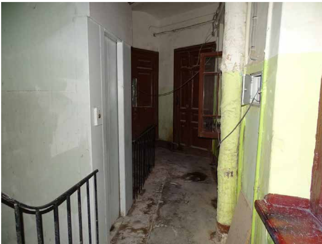
Фото 190. Лестница № 8. Площадка 3-го этажа. Съемка 19.04.2021 г. Трушковский В.Э.
