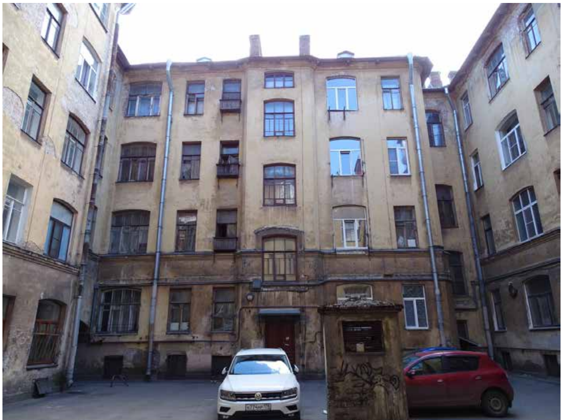
Фото 56. Здание по адресу: г. Санкт-Петербург, Тучков пер., 11/5, литера А. Дворовой фасад. Съемка 19.04.2021 г. Трушковский В.Э.
