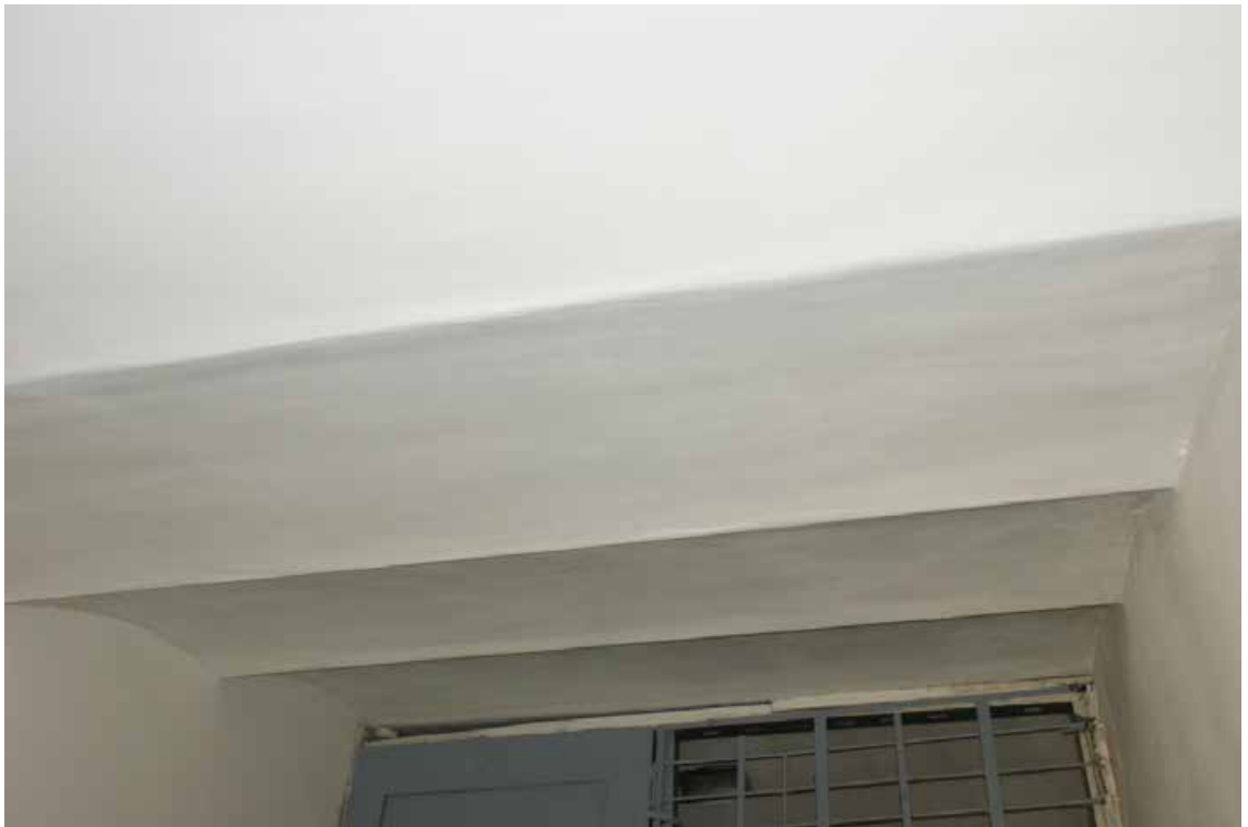
Фото 105. Лестница № 4. 6-й этаж. Оформление потолка. Съемка 19.04.2021 г. Трушковский В.Э.
