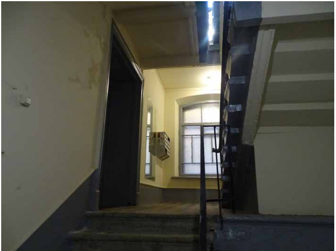
Фото 85. Лестница № 4. 1-й этаж. Вестибюль. Съемка 19.04.2021 г. Трушковский В.Э.
