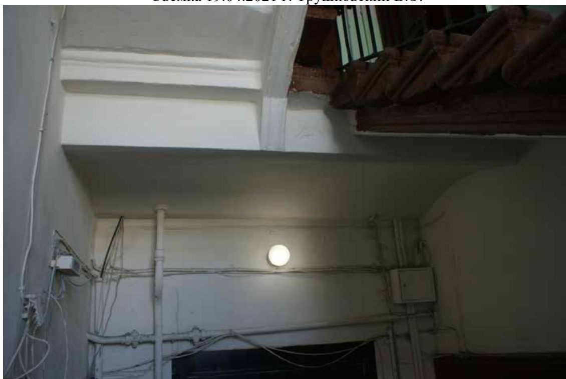
Фото 161. Лестница № 7. Площадка 3-го этажа. Съемка 19.04.2021 г. Трушковский В.Э.
