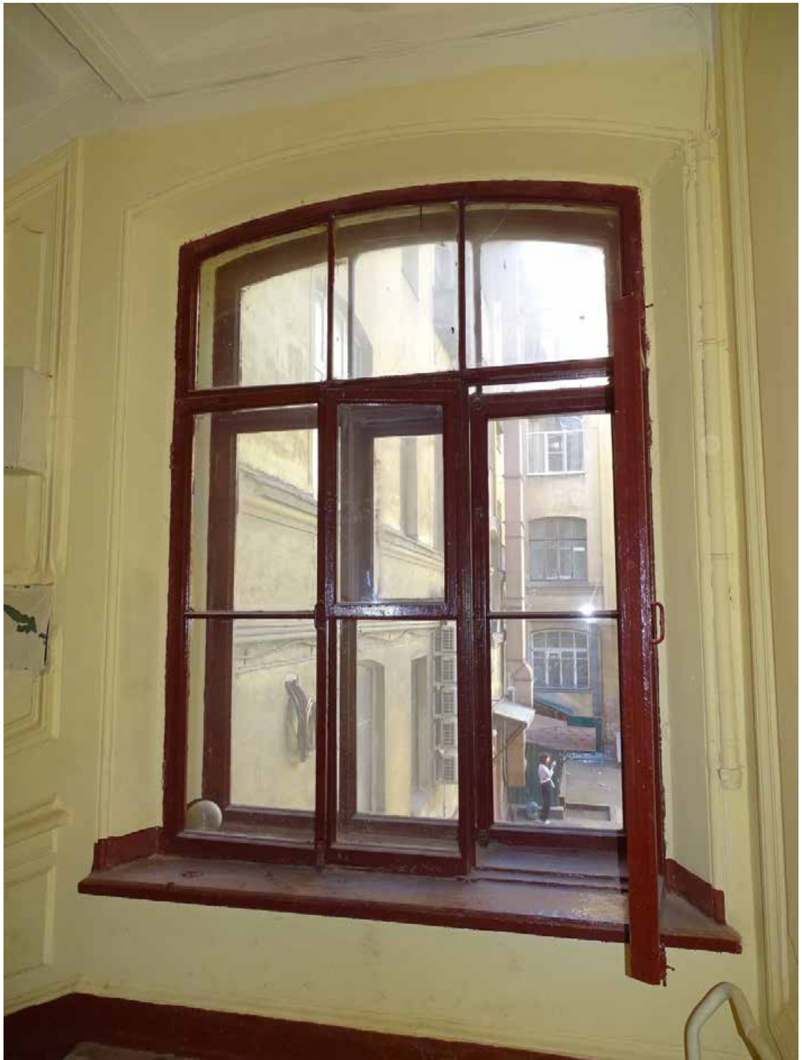
Фото 21. Лестница № 1. Площадка м/у 1-м и 2-м этажом. Оформление оконного проема. Съемка 19.04.2021 г. Трушковский В.Э.
