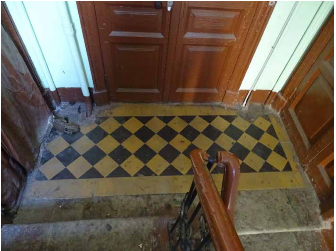
Фото 156. Лестница № 7. Площадка 2-го этажа. Покрытие пола. Съемка 19.04.2021 г. Трушковский В.Э.
