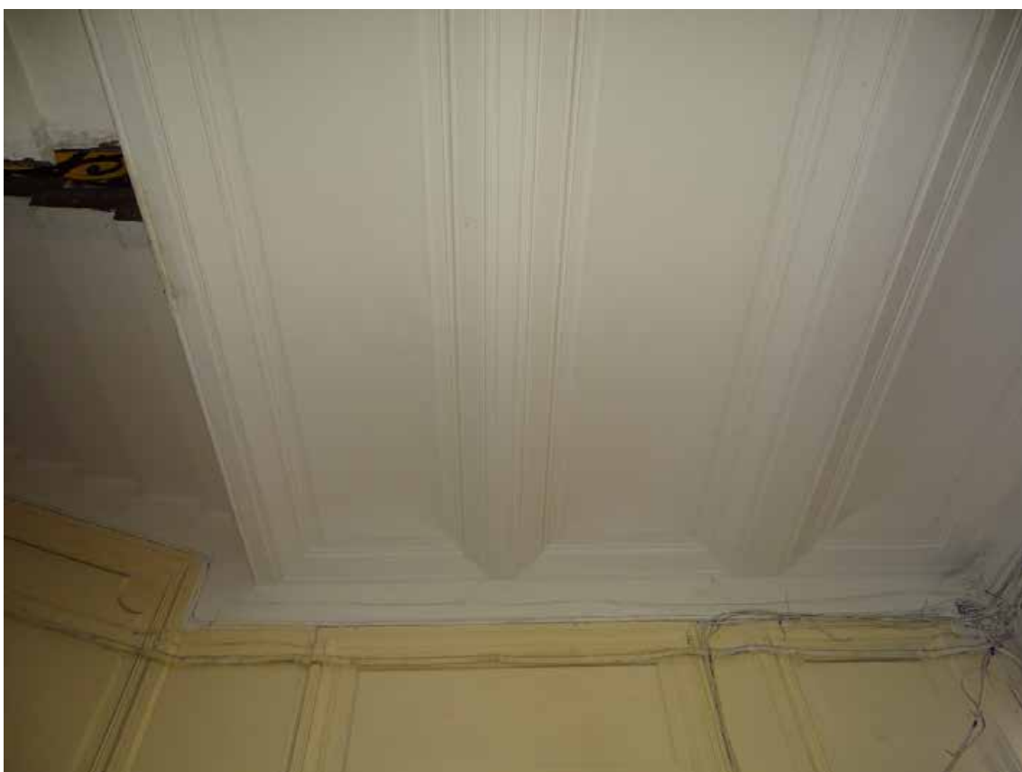
Фото 82. Лестница № 3. 1-й этаж. Вестибюль. Съемка 19.04.2021 г. Трушковский В.Э.
