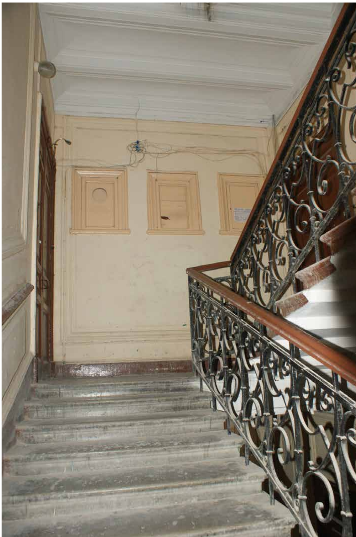
Фото 49. Лестница № 2. 2-й этаж. Съёмка 19.04.2021 г. Трушковский В.Э.
