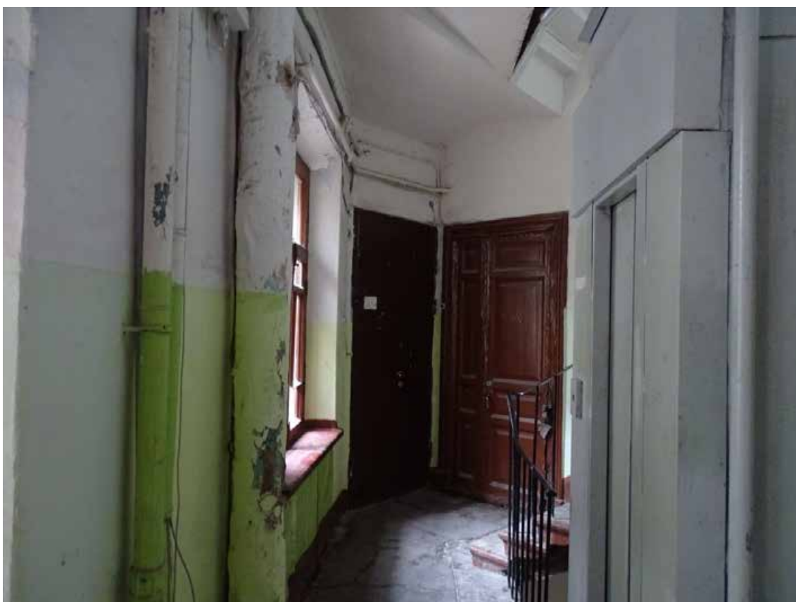
Фото 197. Лестница № 8. Площадка 4-го этажа. Съёмка 19.04.2021 г. Трушковский В.Э.
