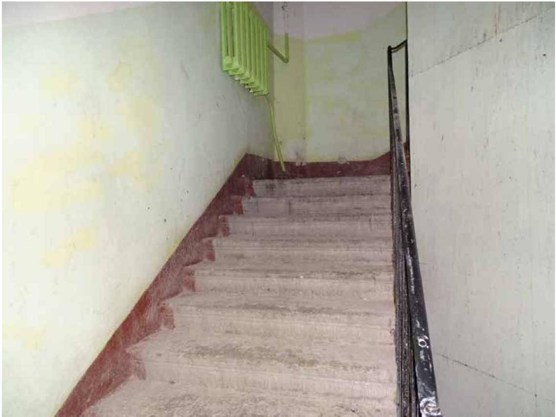
Фото 188. Лестница № 8. Лестничный марш м/у 2-м и 3-м этажом. Съемка 19.04.2021 г. Трушковский В.Э.
