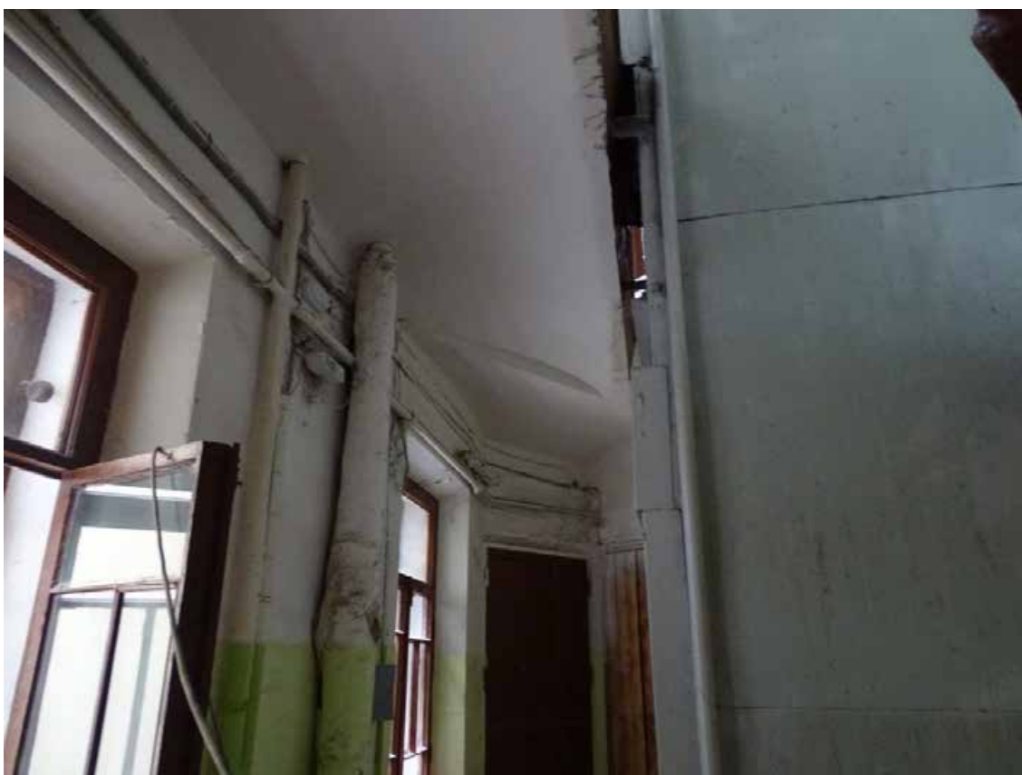
Фото 193. Лестница № 8. Площадка 3-го этажа. Съемка 19.04.2021 г. Трушковский В.Э.
