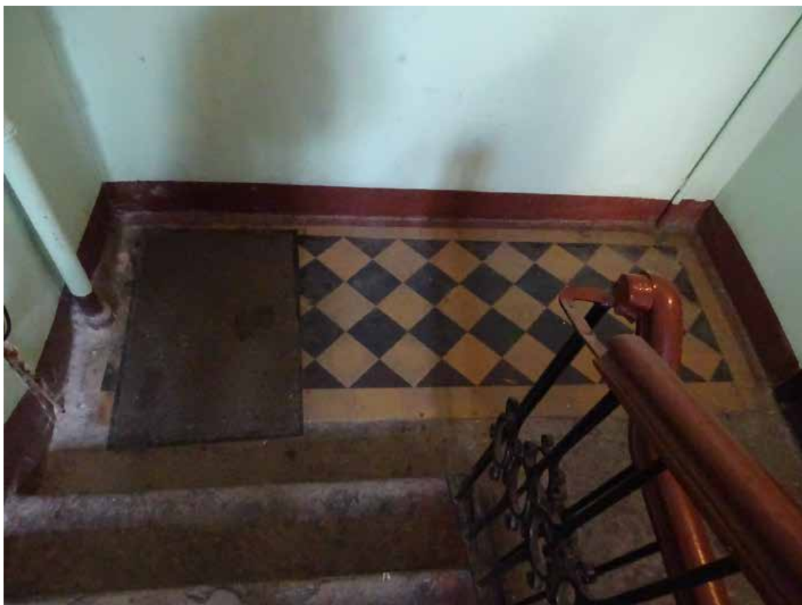
Фото 150. Лестница № 7. Площадка 1-го этажа. Покрытие пола. Съемка 19.04.2021 г. Трушковский В.Э.
