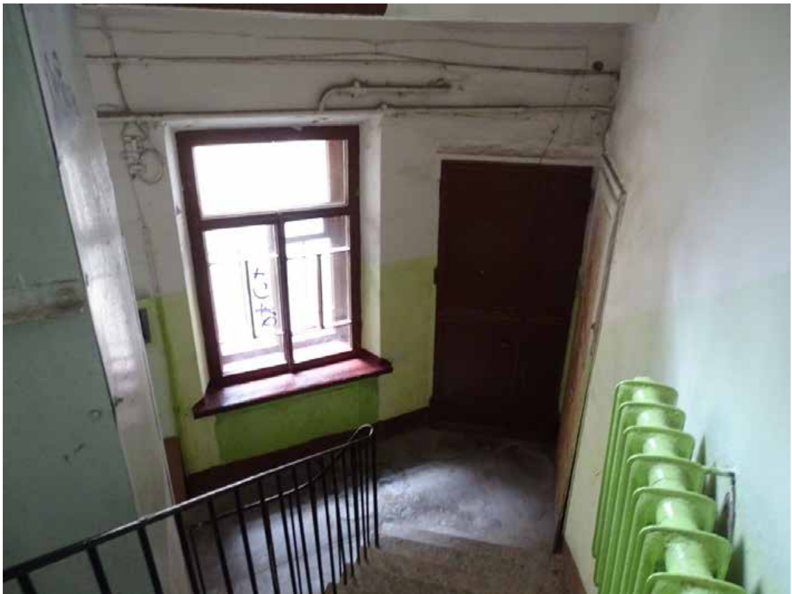
Фото 189. Лестница № 8. Площадка 3-го этажа. Съемка 19.04.2021 г. Трушковский В.Э.
