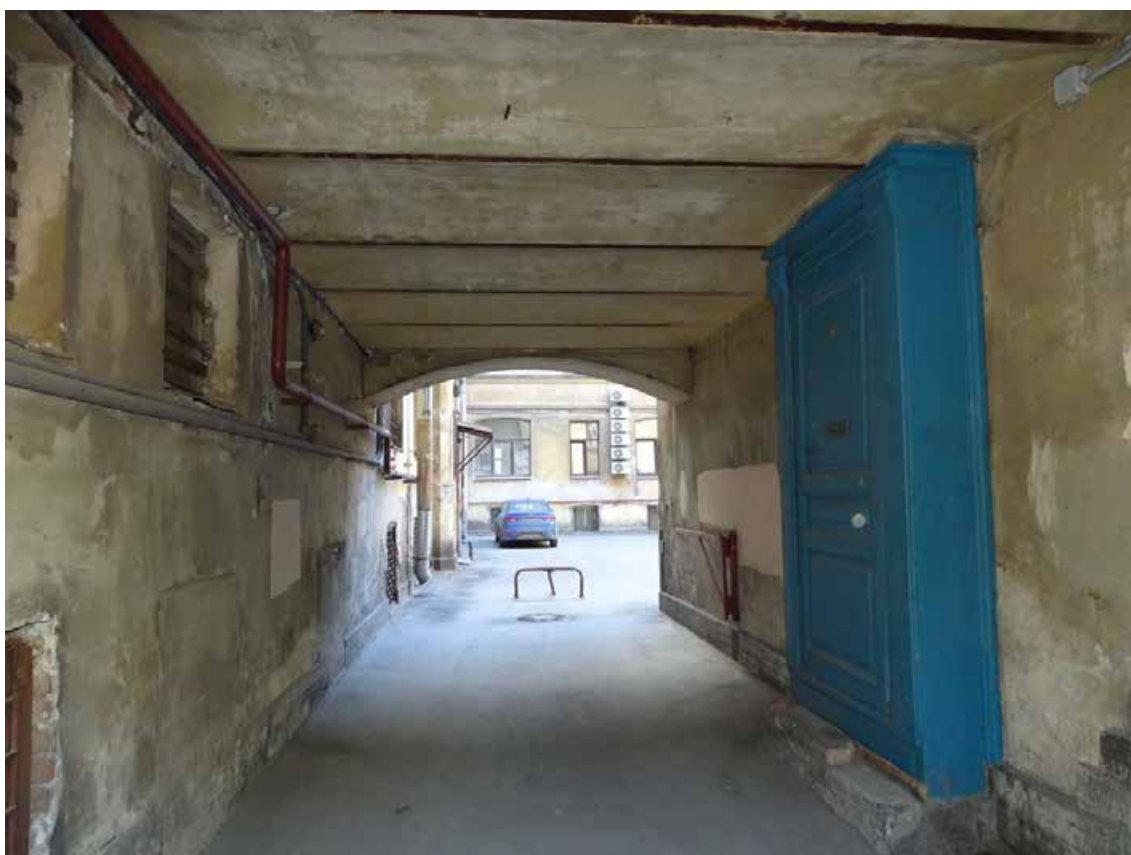
Фото 50. Здание по адресу: г. Санкт-Петербург, Тучков пер., 11/5, литера А. Воротный проезд. Съемка 19.04.2021 г. Трушковский В.Э.
