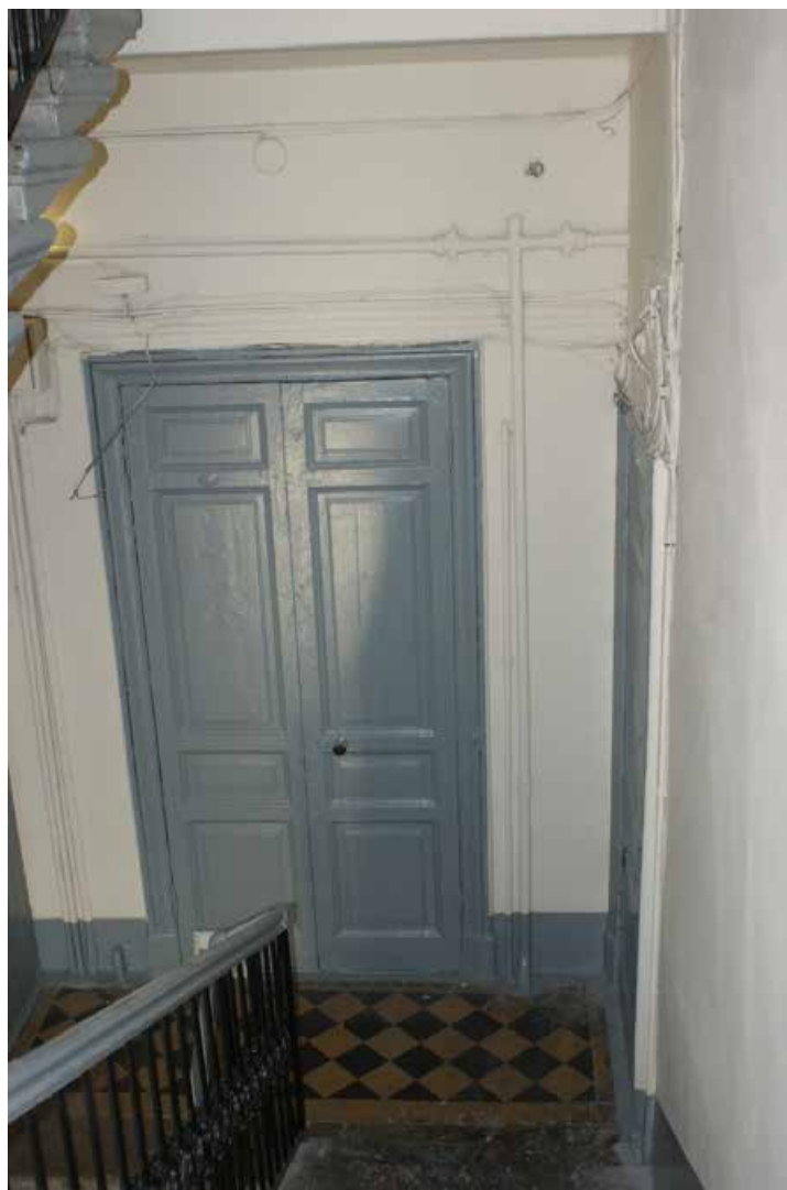
Фото 101. Лестница № 4. 4-й этаж. Съемка 19.04.2021 г. Трушковский В.Э.
