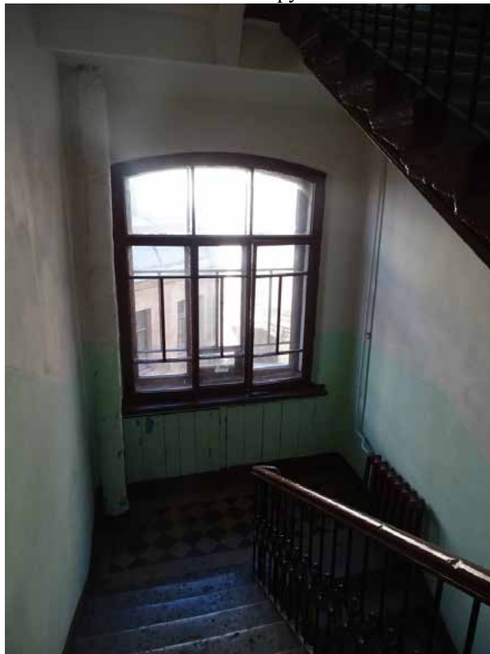
Фото 157. Лестница № 7. Площадка м/у 2-м и 3-м этажом. Съемка 19.04.2021 г. Трушковский В.Э.
