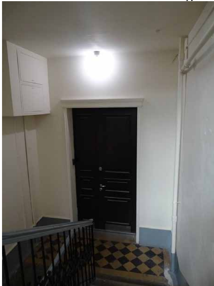
Фото 88. Лестница № 4. Площадка 1-го этажа. Съемка 19.04.2021 г. Трушковский В.Э.
