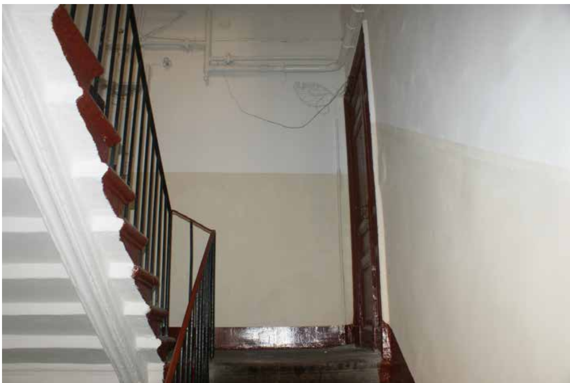
Фото 110. Лестница № 5. Площадка 1-го этажа. Съемка 19.04.2021 г. Трушковский В.Э.
