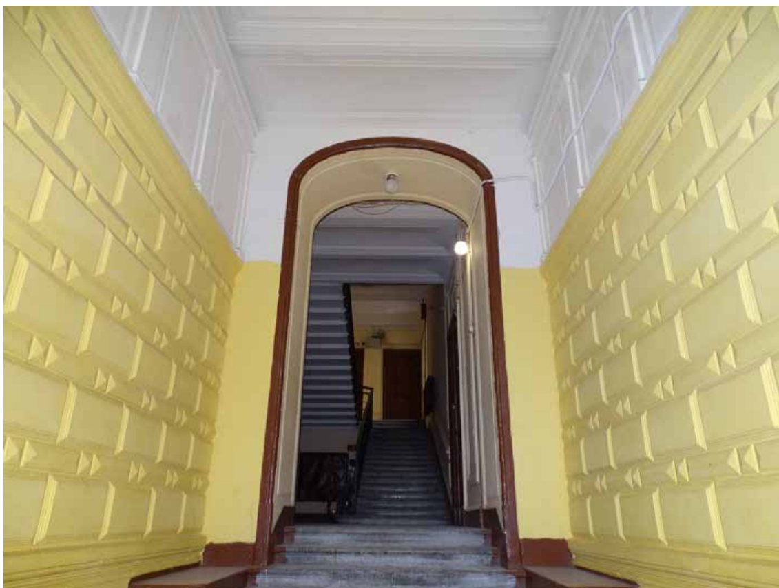
Фото 71. Лестница № 3. 1-й этаж. Вестибюль. Съёмка 19.04.2021 г. Трушковский В.Э.
