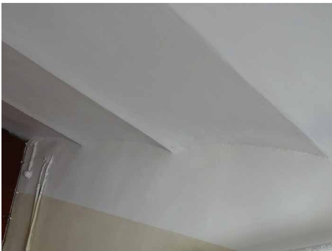
Фото 125. Лестница № 5. Площадка м/у 4-м и 5-м этажом. Оформление потолка. Съемка 19.04.2021 г. Трушковский В.Э.
