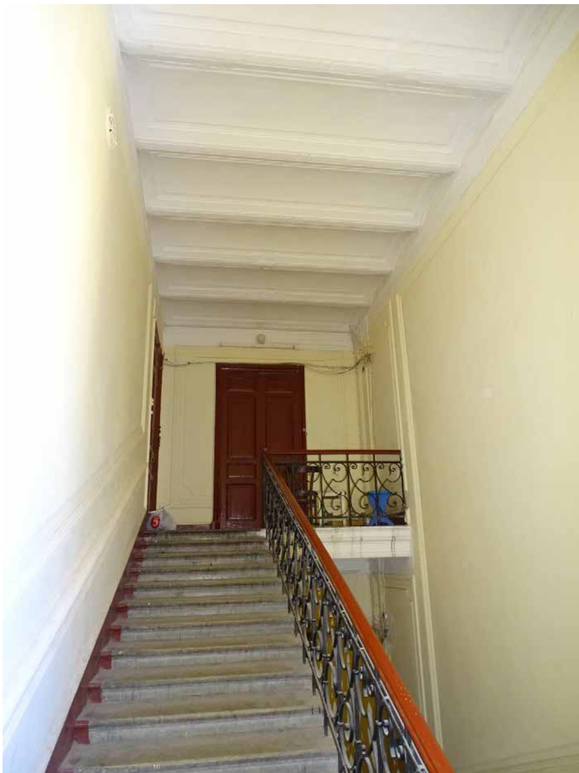
Фото 29. Лестница № 1. Вид на площадку 4-го этажа. Съемка 19.04.2021 г. Трушковский В.Э.
