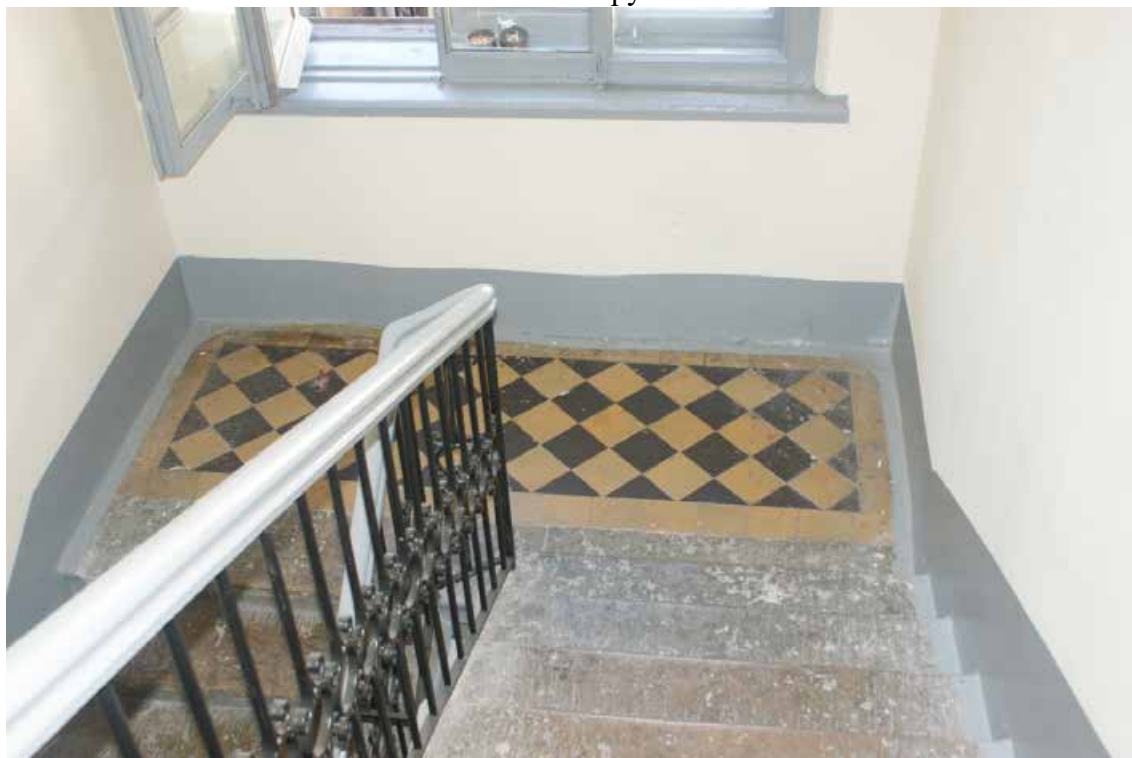
Фото 100. Лестница № 4. Площадка м/у 3-м и 4-м этажом. Покрытие пола. Съемка 19.04.2021 г. Трушковский В.Э.
