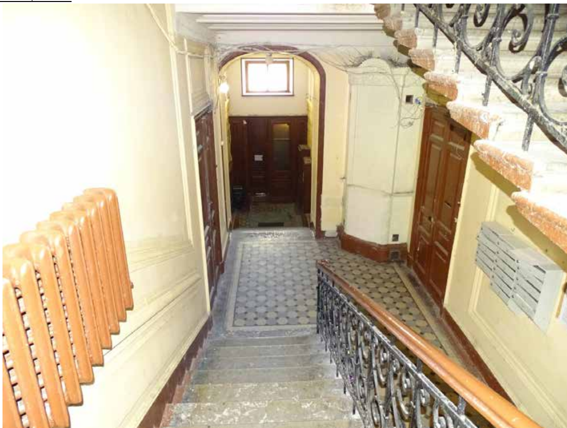
Фото 63. Лестница № 3. 1-й этаж. Вестибюль. Съемка 19.04.2021 г. Трушковский В.Э.
