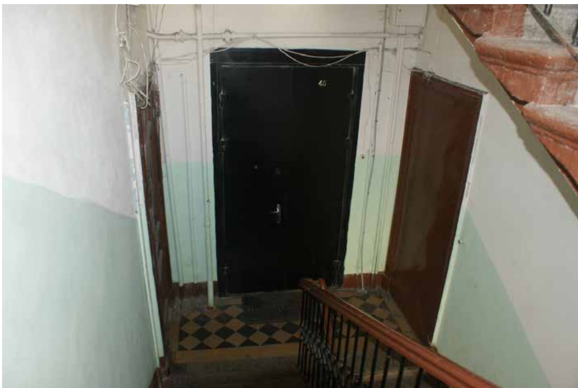
Фото 158. Лестница № 7. Площадка 3-го этажа. Съемка 19.04.2021 г. Трушковский В.Э.
