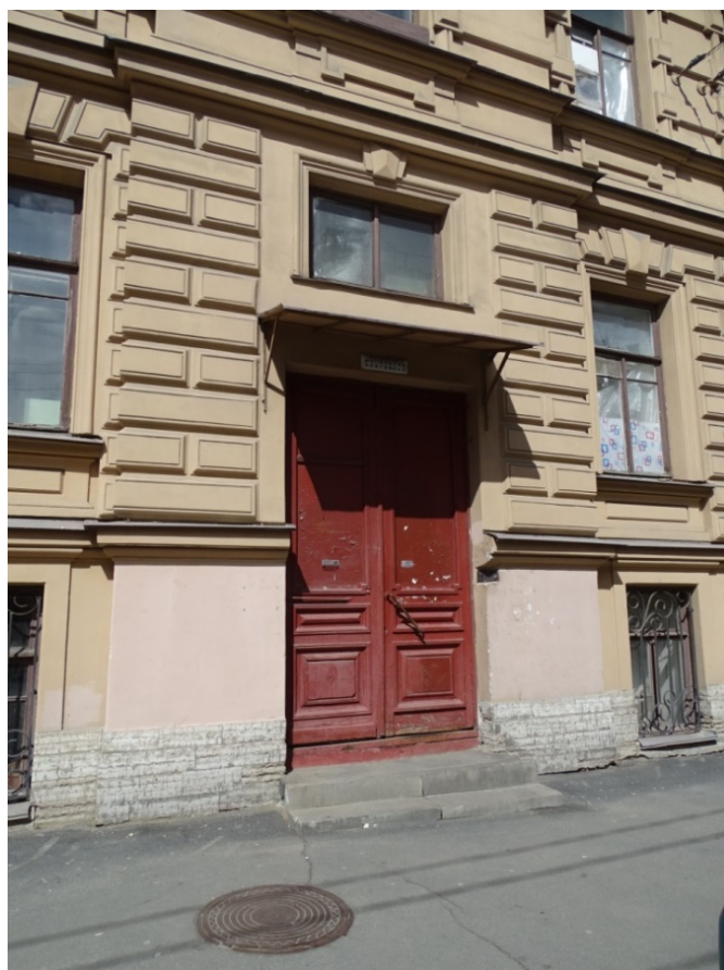
Фото 7. Здание по адресу: г. Санкт-Петербург, Тучков пер., 11/5, литера А. Фрагмент лицевого фасада с Волховского пер. Вход в парадную. Съемка 19.04.2021 г. Трушковский В.Э.
