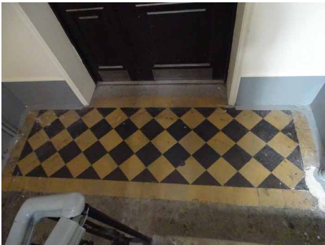
Фото 89. Лестница № 4. Площадка 1-го этажа. Покрытие пола. Съемка 19.04.2021 г. Трушковский В.Э.
