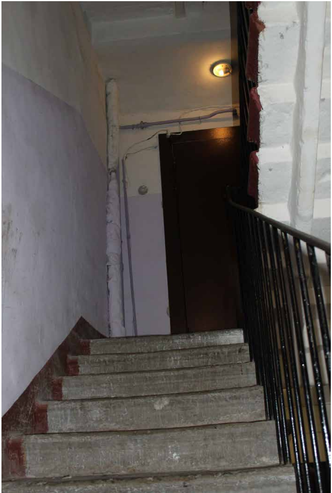
Фото 216. Лестница службы: Площадка 2-го этажа. Съемка 19.04.2021 г. Грушковский В.Э.
