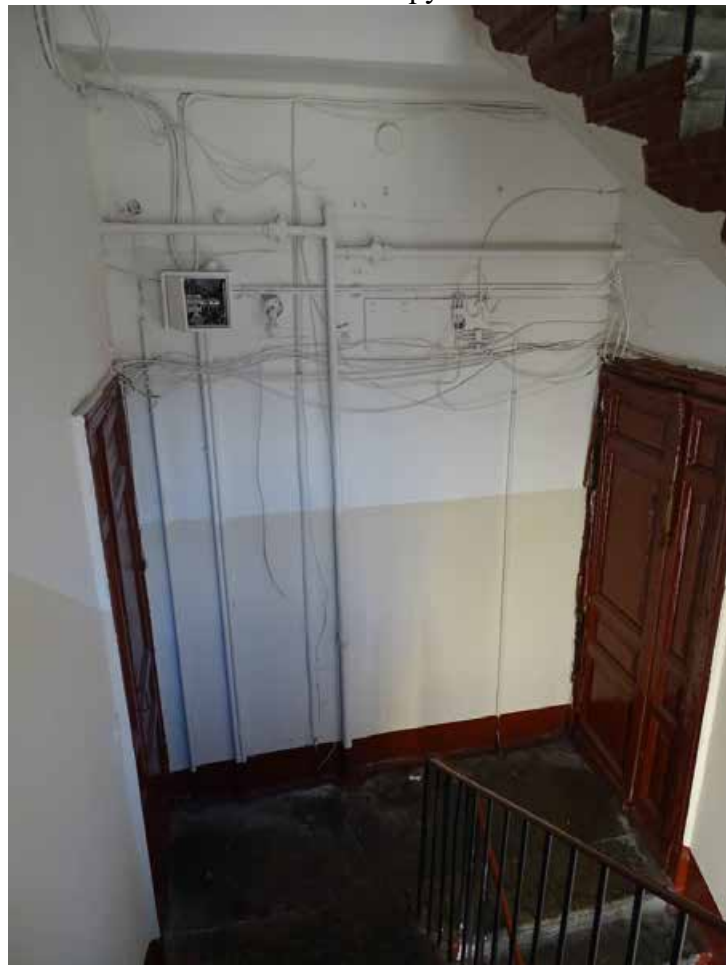
Фото 123. Лестница № 5. Площадка 4-го этажа. Съемка 19.04.2021 г. Трушковский В.Э.
