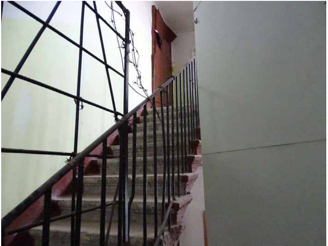
Фото 210. Лестница № 8. Вид на площадку 6-го этажа. Съемка 19.04.2021 г. Грушковский В.Э.
