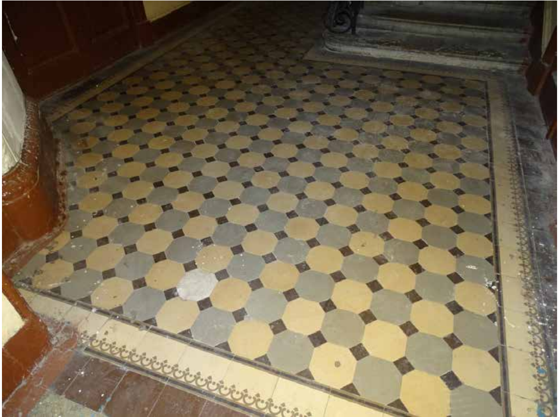
Фото 77. Лестница № 3. 1-й этаж. Вестибюль. Покрытие пола. Съемка 19.04.2021 г. Трушковский В.Э.
