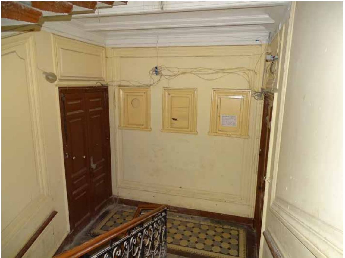
Фото 52. Лестница № 2. 2-й этаж. Съёмка 19.04.2021 г. Трушковский В.Э.
