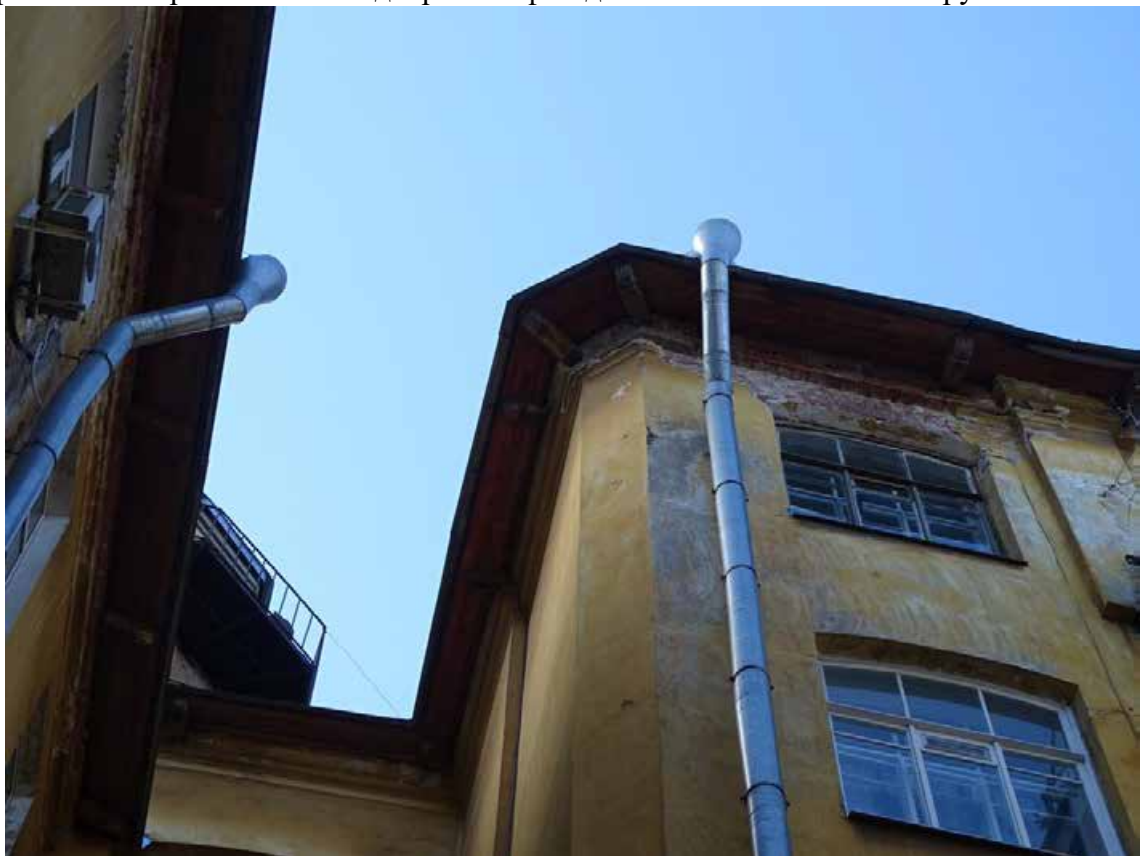
Фото 46. Здание по адресу: г. Санкт-Петербург, Тучков пер., 11/5, литера А. Фрагмент северо-восточного дворового фасада. Съемка 19.04.2021 г. Трушковский В.Э.
