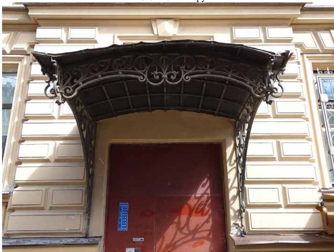
Фото 18. Здание по адресу: г. Санкт-Петербург, Тучков пер., 11/5, литера А. Фрагмент лицевого фасада со стороны Тучкова пер. Вход в парадную. Оформление навеса. Съемка 19.04.2021 г. Трушковский В.Э.
