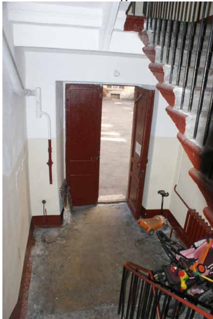
Фото 109. Лестница № 5. 1-й этаж. Вестибюль. Съемка 19.04.2021 г. Трушковский В.Э.
