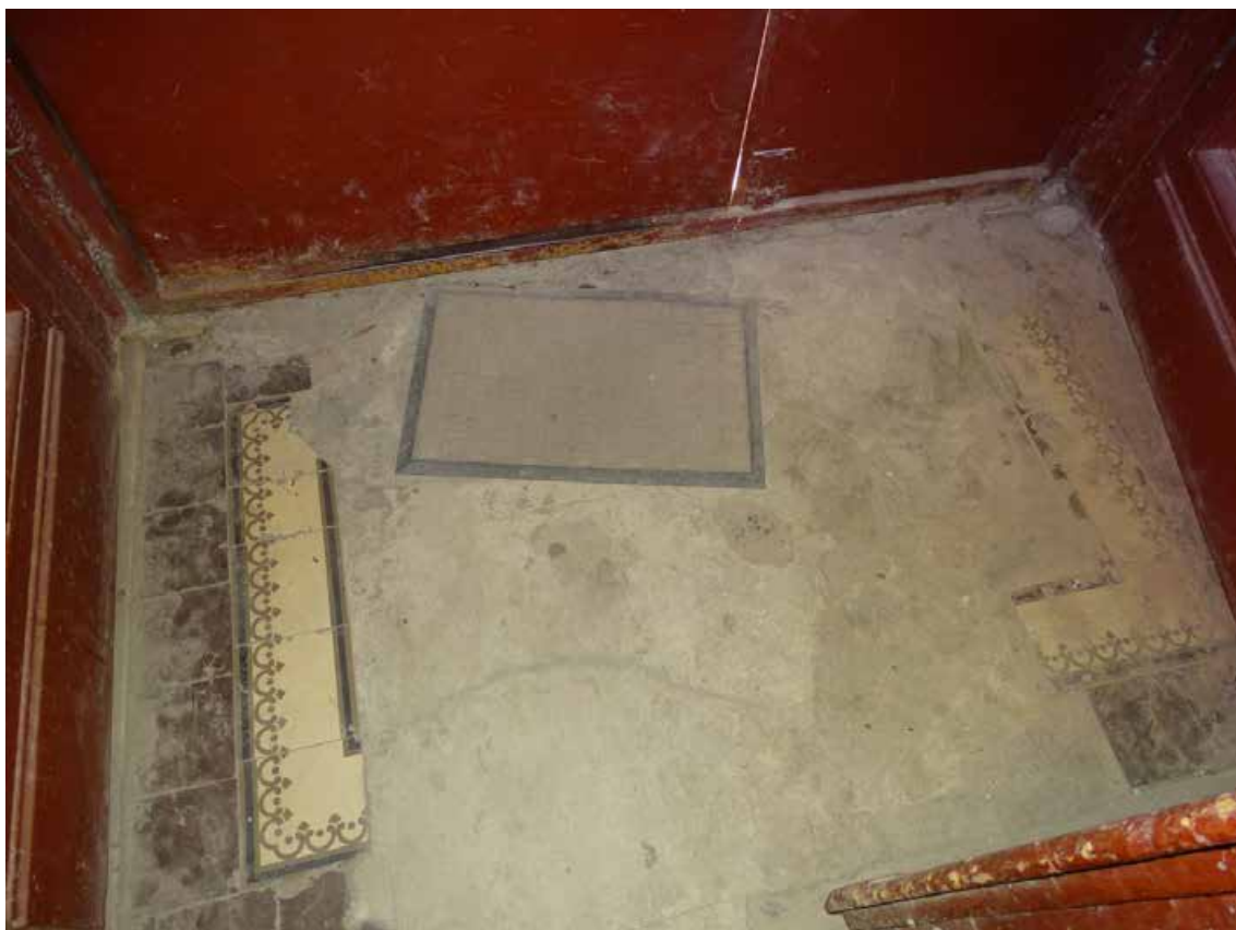
Фото 7. Лестница № 1. Вестибюль 1-го этажа. Съемка 19.04.2021 г. Трушковский В.Э.
