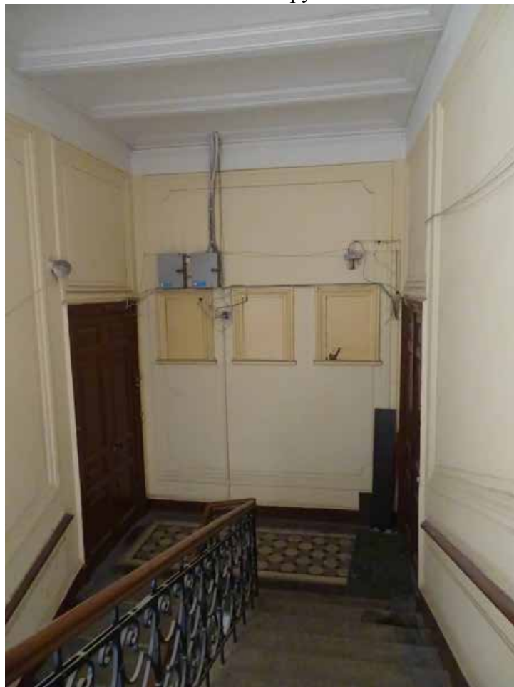
Фото 59. Лестница № 2. 4-й этажом. Съемка 19.04.2021 г. Трушковский В.Э.
