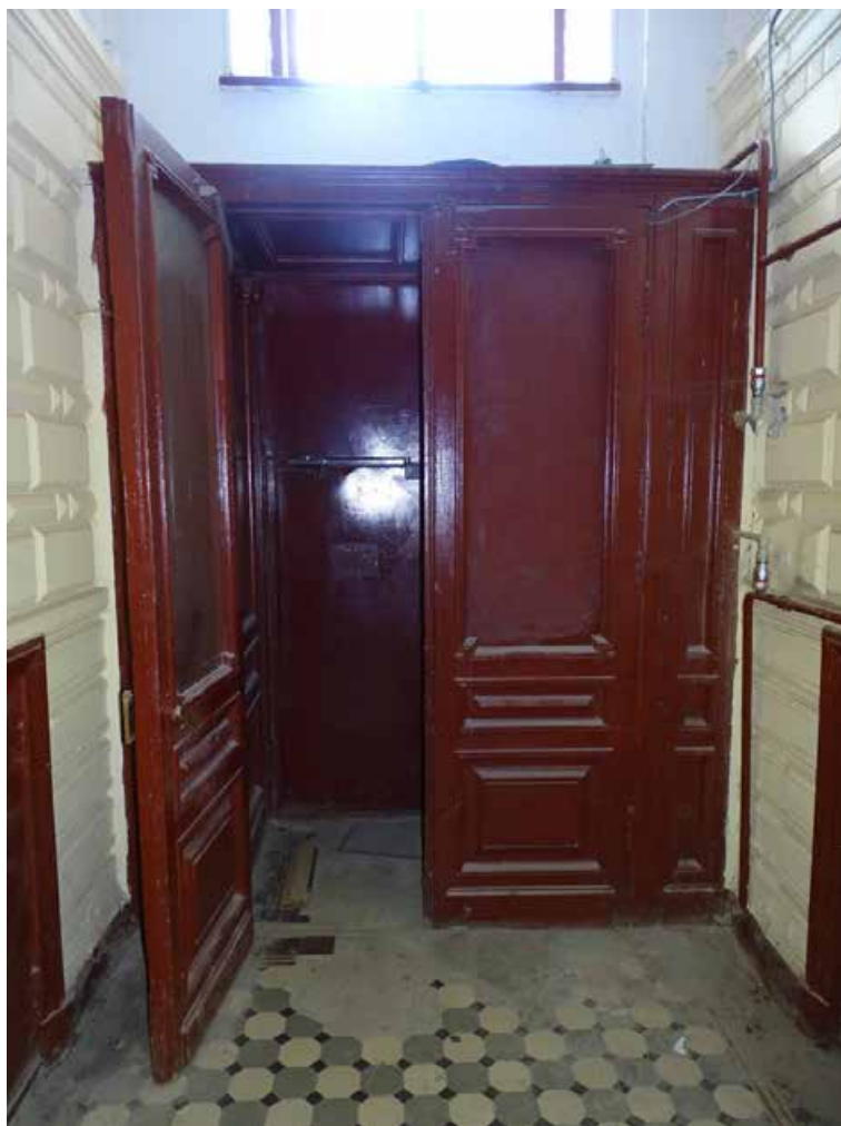
Фото 5. Лестница № 1. Вестибюль 1-го этажа. Съёмка 19.04.2021 г. Трушковский В.Э.
