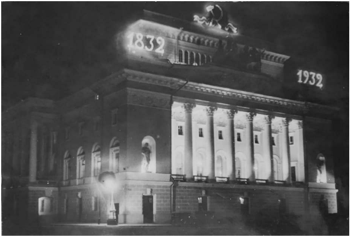
Илл. 60. Общий вид главного фасада со стороны пл. Островского. Фото после проведения ремонтных работ 1932 г. (ФГБУК «Национальный драматический театр России (Александринский театр)», литературный отдел. Фотоальбом «Ремонтные работы к 100-летию здания Александринского театра», 1932 г.)
