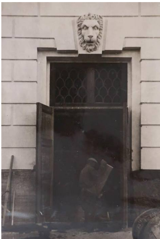
Илл. 45. Наружное дверное заполнение. Фото во время проведения ремонтных работ 1932 г. (ФГБУК «Национальный драматический театр России (Александринский театр)», литературный отдел. Фотоальбом «Ремонтные работы к 100-летию здания Александринского театра», 1932 г.)
