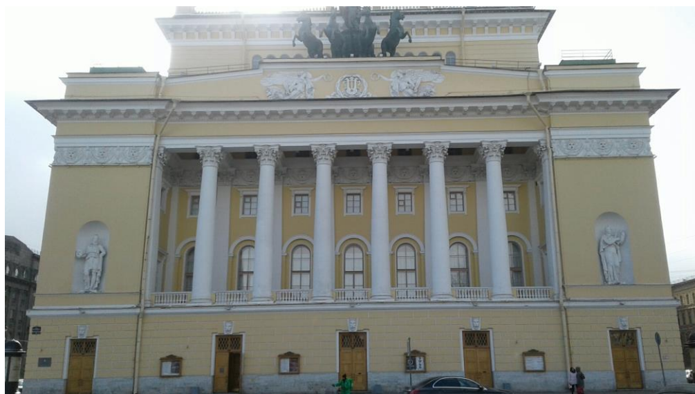
2. Объект культурного наследия федерального значения «Театр Александринский» по адресу: г. Санкт-Петербург, пл. Островского, д. 6, литера А. Главный (северный) фасад.
