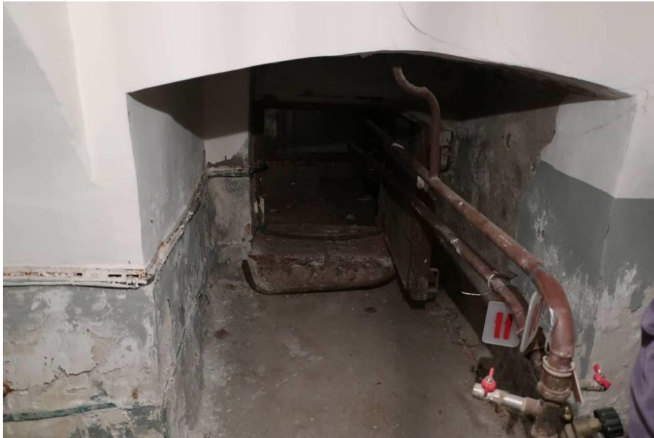
14. Объект культурного наследия федерального значения «Театр Александринский» по адресу: г. Санкт-Петербург, пл. Островского, д. 6, литера А. Вид из помещения №157. Вход в помещение №158.
