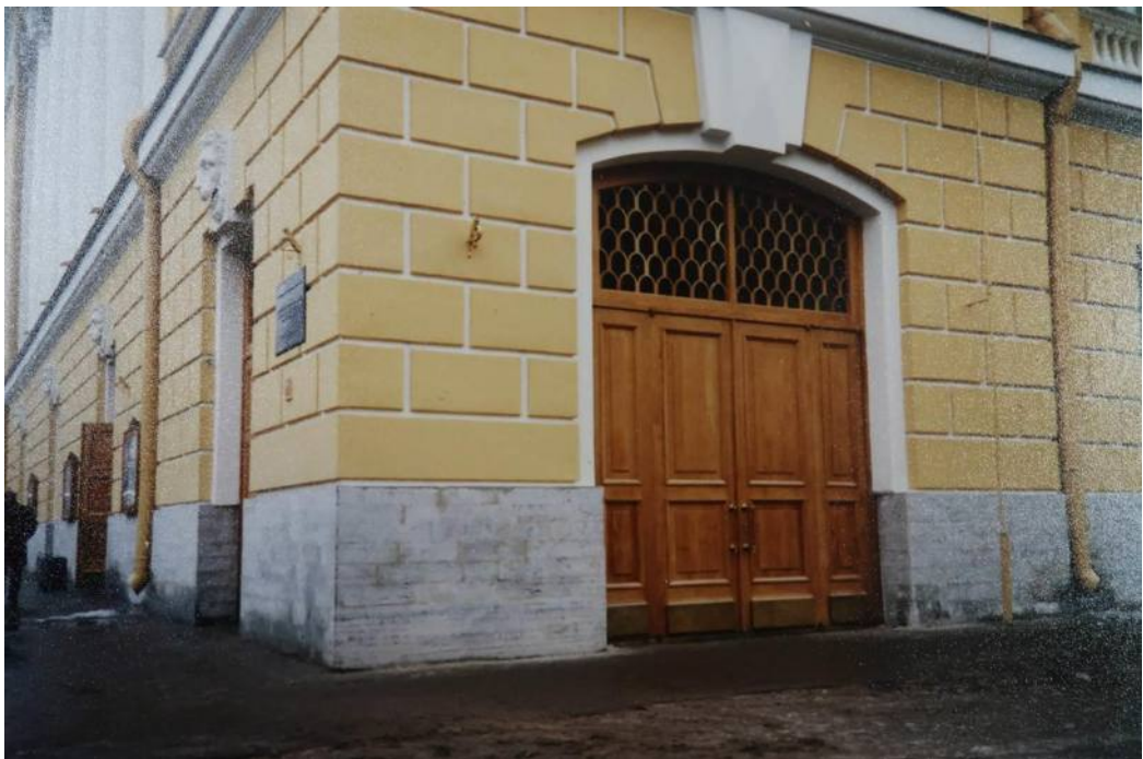
Илл. 79. Фрагмент цоколя в после проведения реставрационных работ 1999-2003 гг. Фото ноябрь 2002 г. (Архив С.В. Лалазарова, руководителя архитектурно-реставрационной мастерской НИИ «Спецпроектреставрация» во время производства проектных и реставрационных работ)
