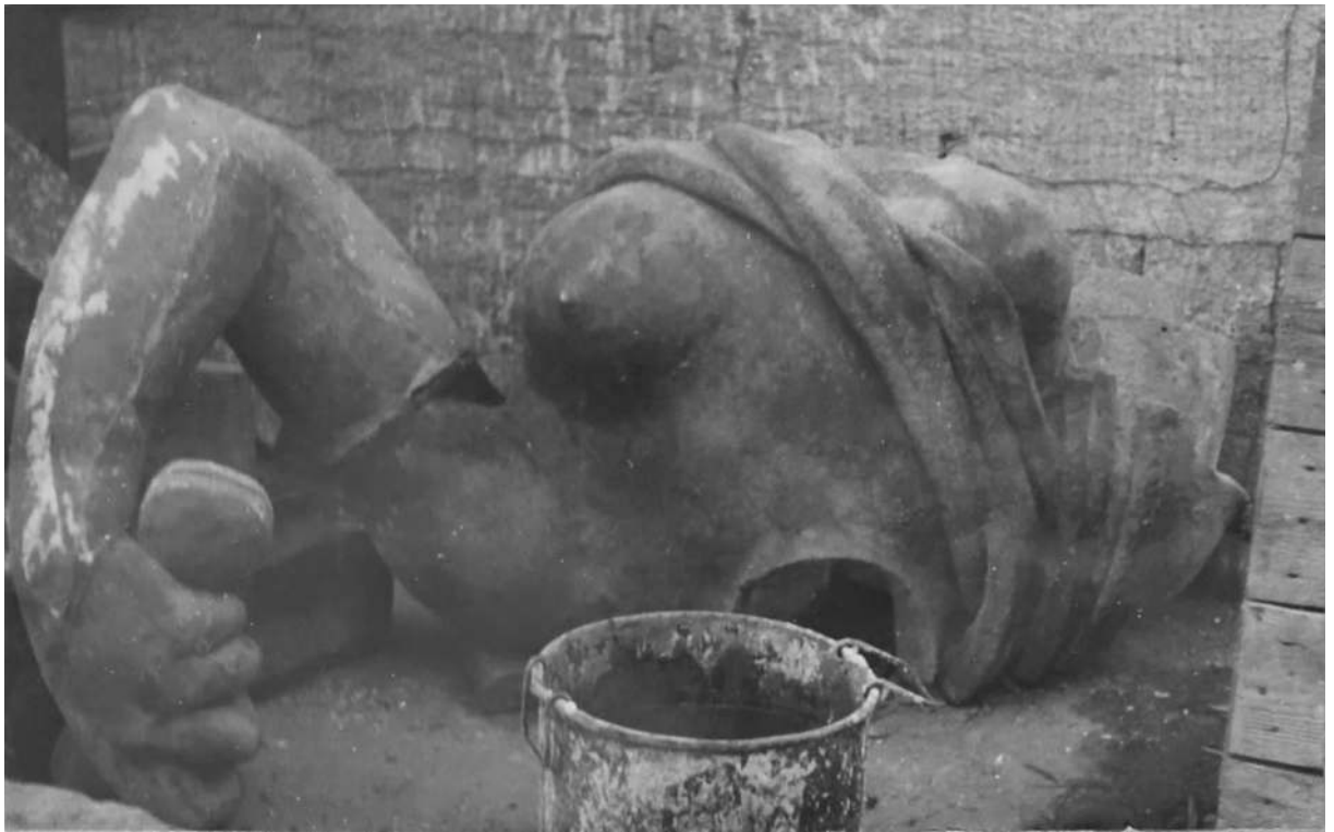
Илл. 53. Сегмент скульптуры Талии до монтажа. Фото во время проведения ремонтных работ 1932 г. (ФГБУК «Национальный драматический театр России (Александринский театр)», литературный отдел. Фотоальбом «Ремонтные работы к 100-летию здания Александринского театра», 1932 г.)
