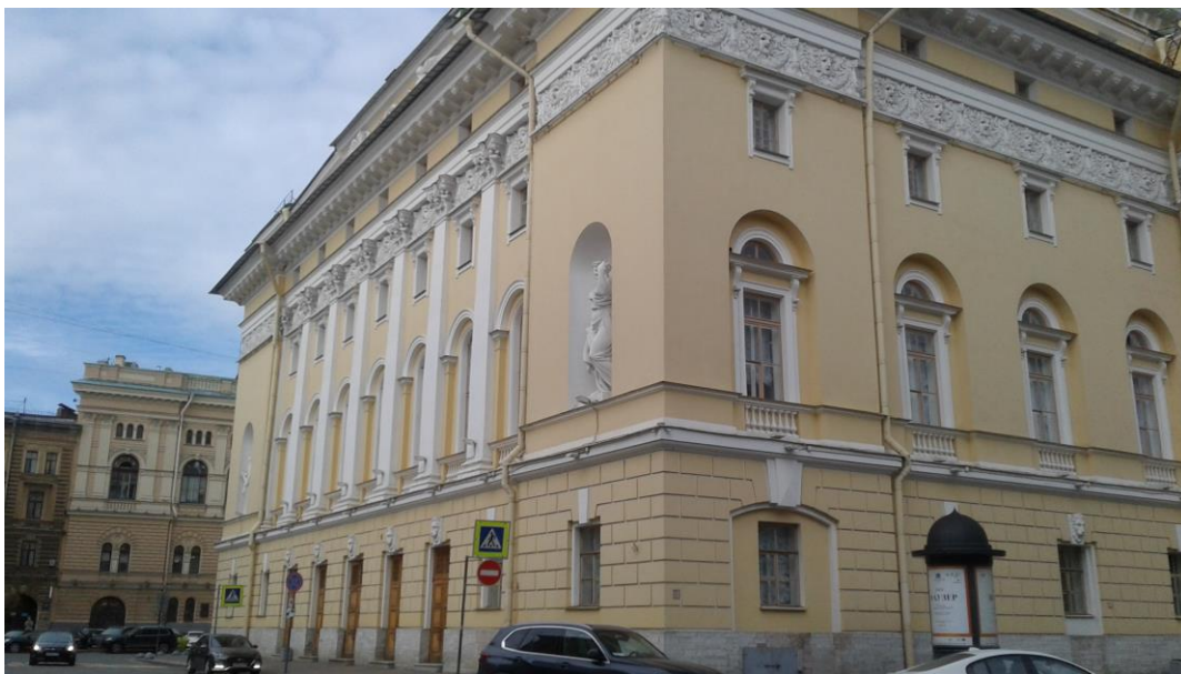
11. Объект культурного наследия федерального значения «Театр Александринский» по адресу: г. Санкт-Петербург, пл. Островского, д. 6, литера А. Вид в северо-западном направлении.
