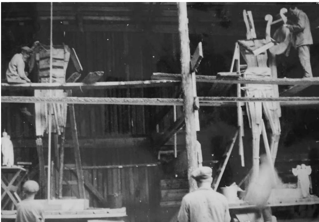
Илл. 48. Изготовление каркаса моделей скульптур в натуральную величину Мельпомены и Терпсихоры. Фото во время проведения ремонтных работ 1932 г. (ФГБУК «Национальный драматический театр России (Александринский театр)», литературный отдел. Фотоальбом «Ремонтные работы к 100-летию здания Александринского театра», 1932 г.)
