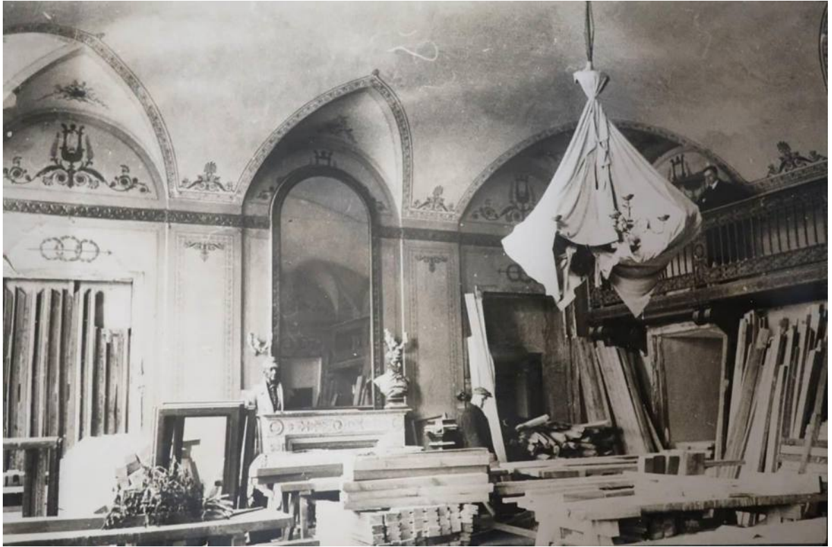
Илл. 57. Царское фойе во время проведения ремонтных работ 1932 г. (ФГБУК «Национальный драматический театр России (Александринский театр)», литературный отдел. Фотоальбом «Ремонтные работы к 100-летию здания Александринского театра», 1932 г.)
