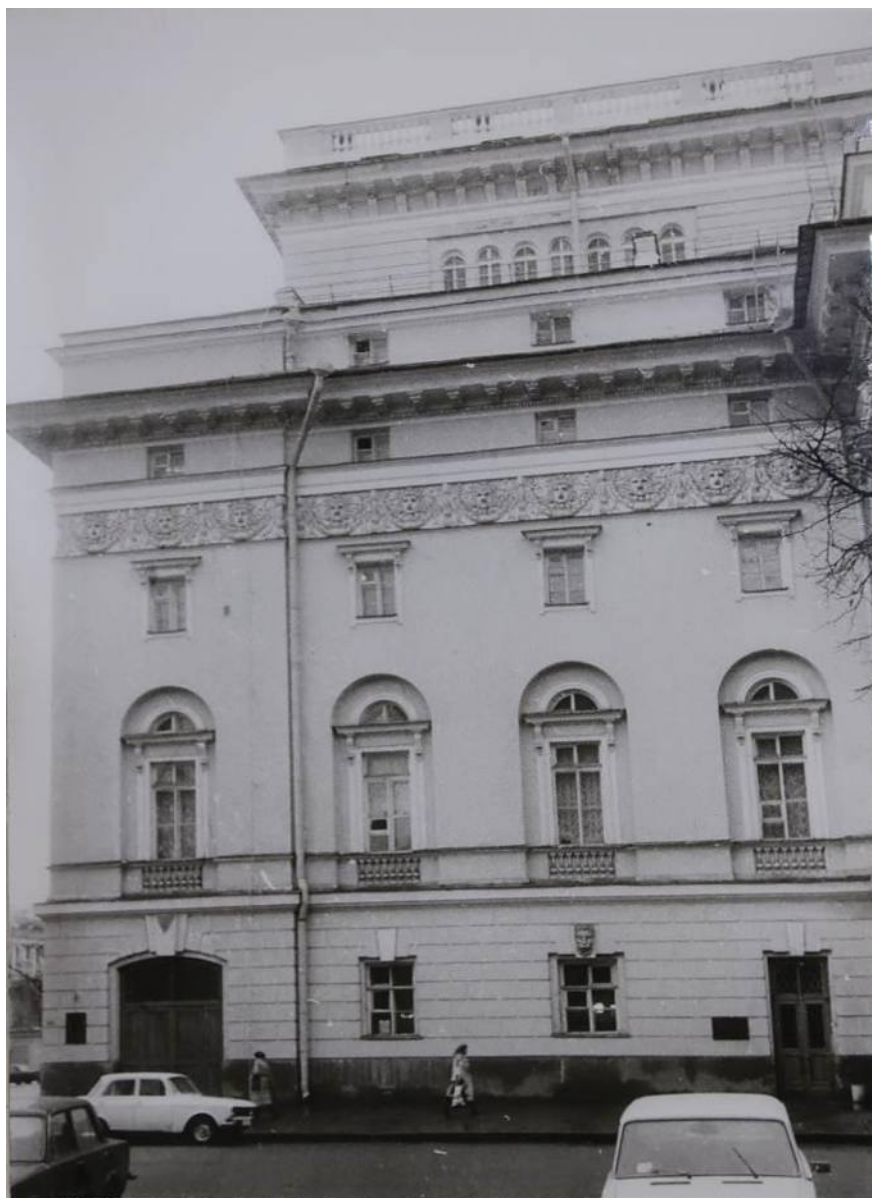
Илл. 71. Фрагмент бокового фасада. Фото 1991 г. (Архив КГИОП, ф. 112-1, № 108)
