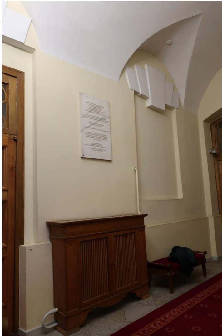
20. Объект культурного наследия федерального значения «Театр Александринский» по адресу: г. Санкт-Петербург, пл. Островского, д. 6, литера А. Помещение №1. Вид на южную стену.
