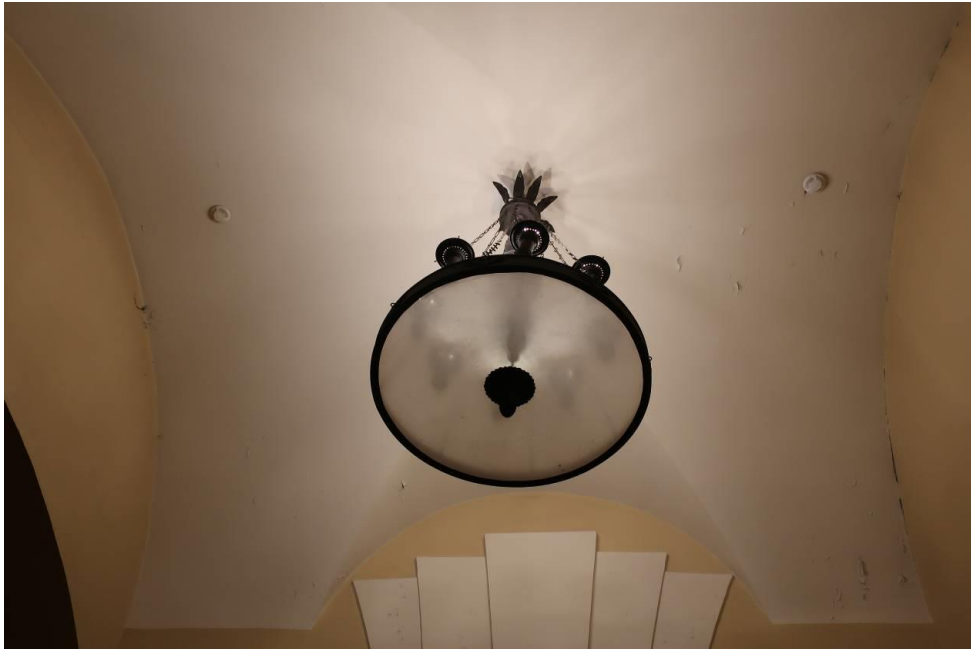
31. Объект культурного наследия федерального значения «Театр Александринский» по адресу: г. Санкт-Петербург, пл. Островского, д. 6, литера А. Помещение №2. Общий вид свода с распалубками.
