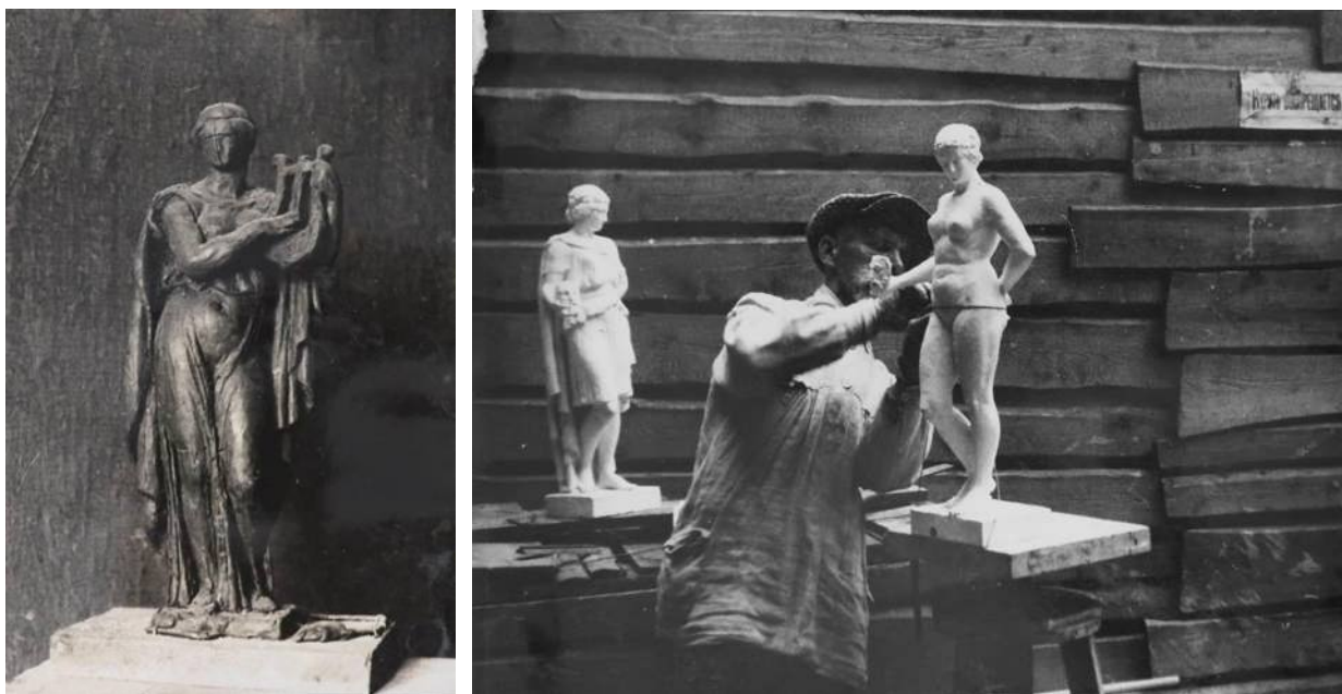
Илл. 46. Модели скульптур Мельпомены и Терпсихоры. Фото во время проведения ремонтных работ 1932 г. (ФГБУК «Национальный драматический театр России (Александринский театр)», литературный отдел. Фотоальбом «Ремонтные работы к 100-летию здания Александринского театра», 1932 г.)
