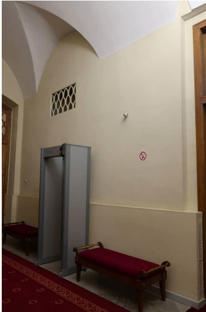
21. Объект культурного наследия федерального значения «Театр Александринский» по адресу: г. Санкт-Петербург, пл. Островского, д. 6, литера А. Помещение №1. Вид на северную стену.
