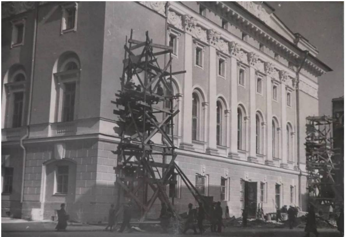
Илл. 55. Общий вид заднего фасада со стороны ул. Зодчего Росси, монтаж скульптур. Фото во время проведения ремонтных работ 1932 г. (ФГБУК «Национальный драматический театр России (Александринский театр)», литературный отдел. Фотоальбом «Ремонтные работы к 100-летию здания Александринского театра», 1932 г.)
