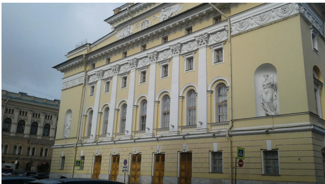
8. Объект культурного наследия федерального значения «Театр Александринский» по адресу: г. Санкт-Петербург, пл. Островского, д. 6, литера А. Южный фасад. Общий вид.
