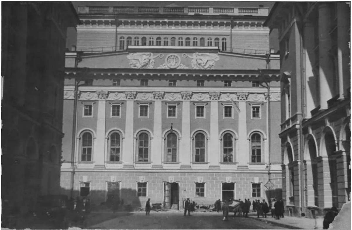
Илл. 42. Вид заднего фасада со стороны ул. Зодчего Росси. Фото во время проведения ремонтных работ 1932 г. (ФГБУК «Национальный драматический театр России (Александринский театр)», литературный отдел. Фотоальбом «Ремонтные работы к 100-летию здания Александринского театра», 1932 г.)
