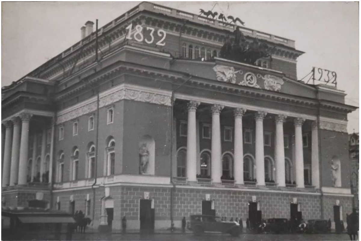
Илл. 59. Общий вид главного фасада со стороны пл. Островского. Фото после проведения ремонтных работ 1932 г. (ФГБУК «Национальный драматический театр России (Александринский театр)», литературный отдел. Фотоальбом «Ремонтные работы к 100-летию здания Александринского театра», 1932 г.)
