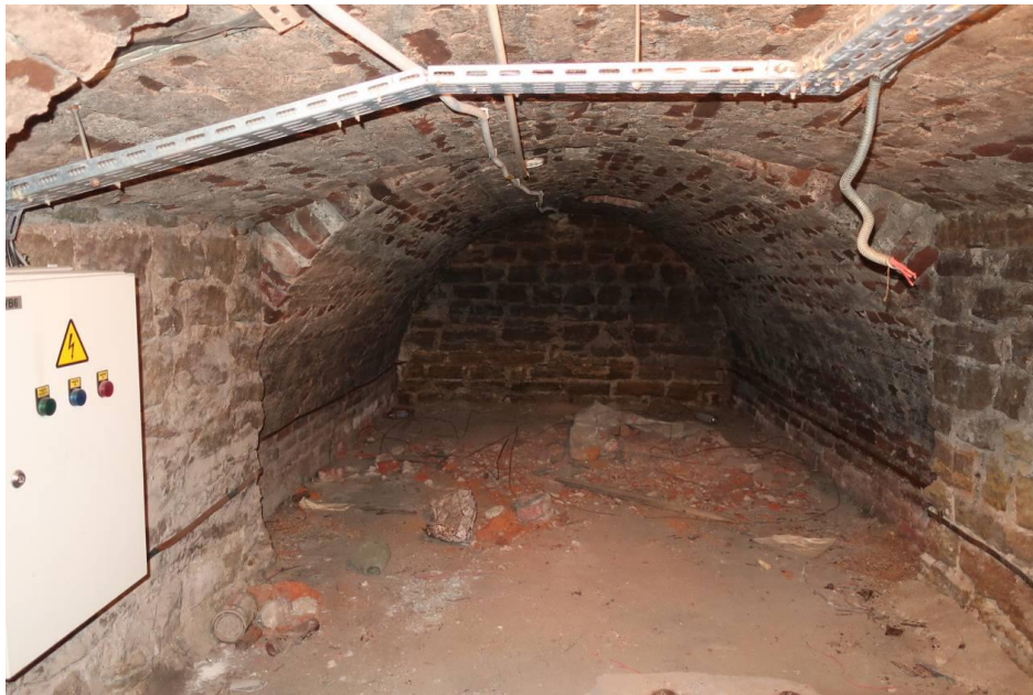
15. Объект культурного наследия федерального значения «Театр Александринский» по адресу: г. Санкт-Петербург, пл. Островского, д. 6, литера А. Помещение №158. Общий вид в западном направлении.
