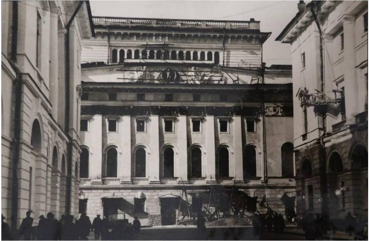
Илл. 40. Вид заднего фасада со стороны ул. Зодчего Росси. Фото во время проведения ремонтных работ 1932 г. (ФГБУК «Национальный драматический театр России (Александринский театр)», литературный отдел. Фотоальбом «Ремонтные работы к 100-летию здания Александринского театра», 1932 г.)
