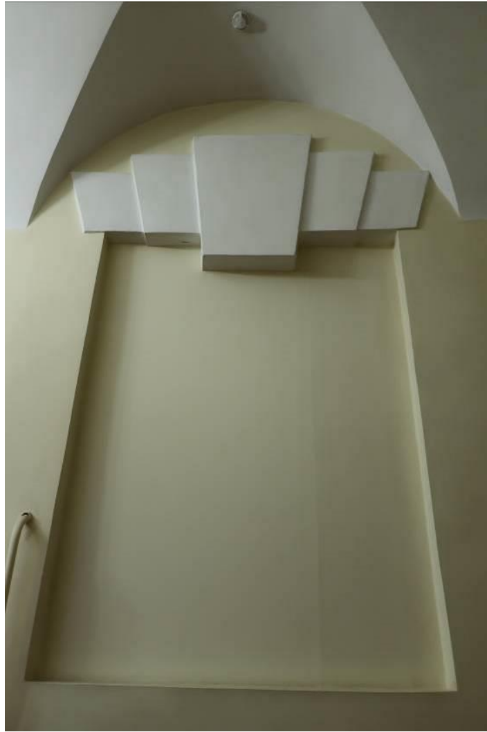
25. Объект культурного наследия федерального значения «Театр Александринский» по адресу: г. Санкт-Петербург, пл. Островского, д. 6, литера А. Помещение №1. Ниша в месте зашитого оконного проема. Вид из помещения №1.
