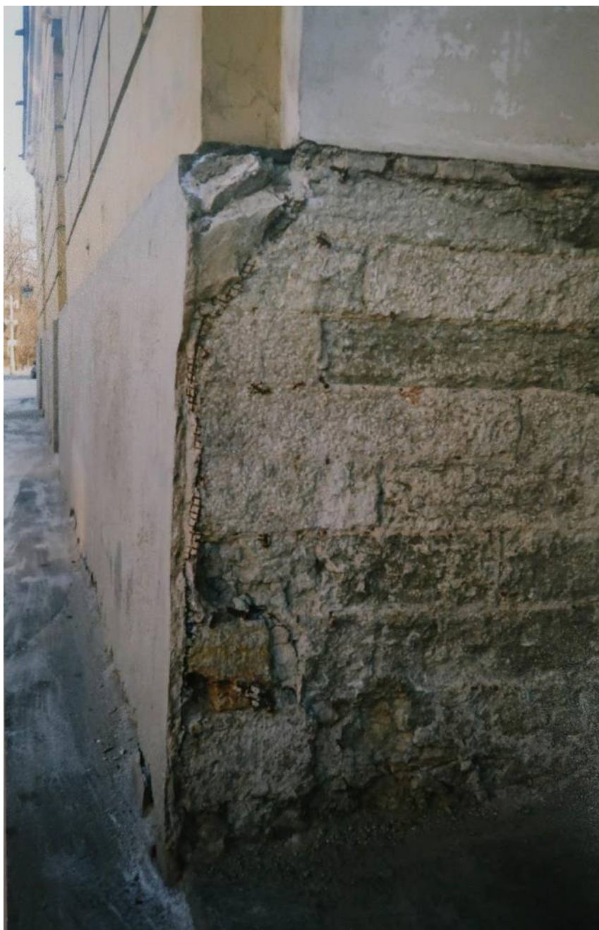
Илл. 77. Фрагмент цоколя в процессе проведения реставрационных работ 1999-2003 гг. Фото февраль 2000 г. (Архив С.В. Лалазарова, руководителя архитектурно-реставрационной мастерской НИИ «Спецпроектреставрация» во время производства проектных и реставрационных работ)
