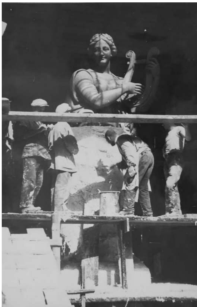
Илл. 50. Удаление формы после отливки скульптуры Терпсихоры. Фото во время проведения ремонтных работ 1932 г. (ФГБУК «Национальный драматический театр России (Александринский театр)», литературный отдел. Фотоальбом «Ремонтные работы к 100-летию здания Александринского театра», 1932 г.)
