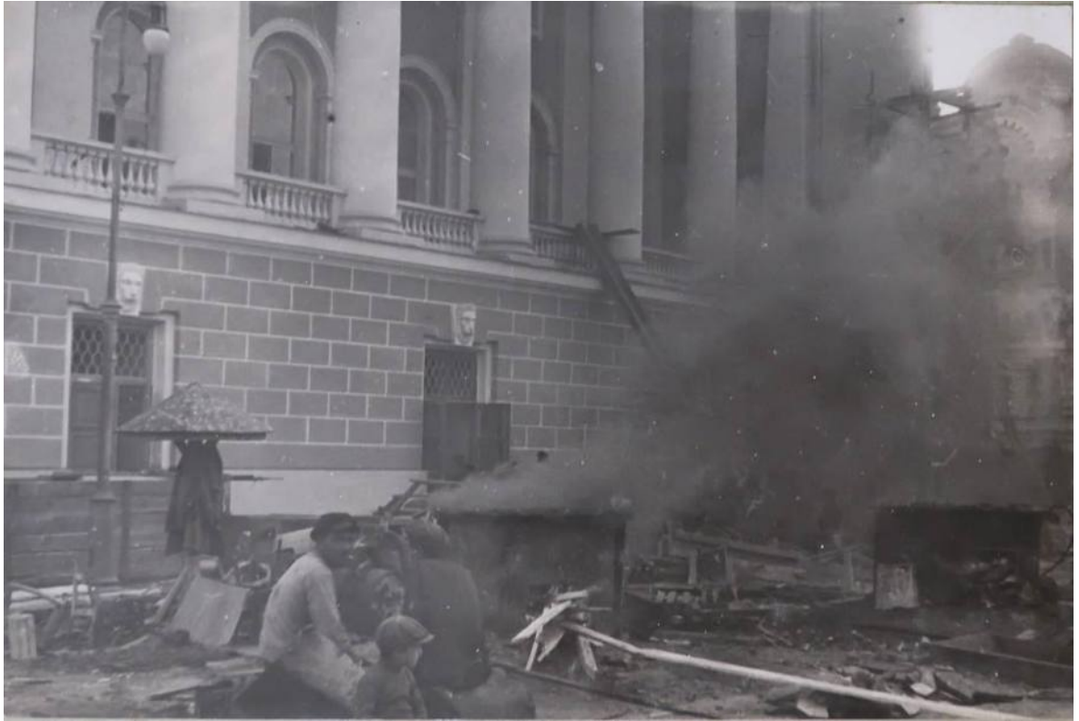
Илл. 44. Фрагмент главного фасада со стороны пл. Островского. Фото во время проведения ремонтных работ 1932 г. (ФГБУК «Национальный драматический театр России (Александринский театр)», литературный отдел. Фотоальбом «Ремонтные работы к 100-летию здания Александринского театра», 1932 г.)
