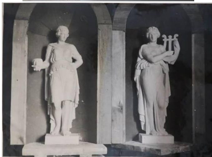
Илл. 47. Модели скульптур Мельпомены и Терпсихоры. Фото во время проведения ремонтных работ 1932 г. (ФГБУК «Национальный драматический театр России (Александринский театр)», литературный отдел. Фотоальбом «Ремонтные работы к 100-летию здания Александринского театра», 1932 г.)
