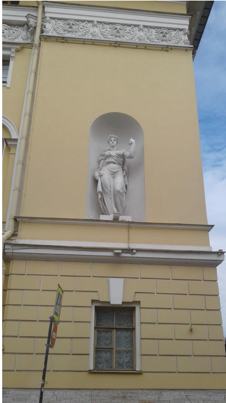
10. Объект культурного наследия федерального значения «Театр Александринский» по адресу: г. Санкт-Петербург, пл. Островского, д. 6, литера А. Южный фасад. Фрагмент. Круглая скульптура в нише. Талия.
