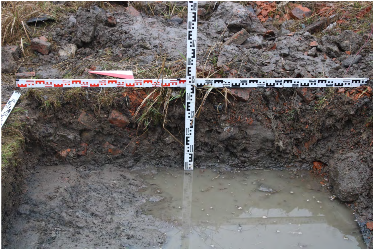
Рис. 75. Санкт-Петербург, г. Санкт-Петербург, Грузовой проезд, участок 1 (напротив дома 29, литера А по Грузовому проезду). Шурф 2. Восточная стенка.
