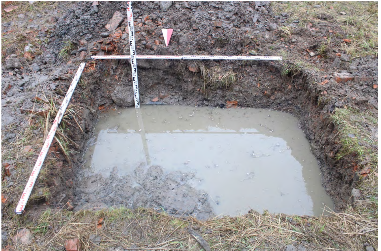
Рис. 76. Санкт-Петербург, г. Санкт-Петербург, Грузовой проезд, участок 1 (напротив дома 29, литера А по Грузовому проезду). Общий вид Шурфа 2. Вид на Ю.
