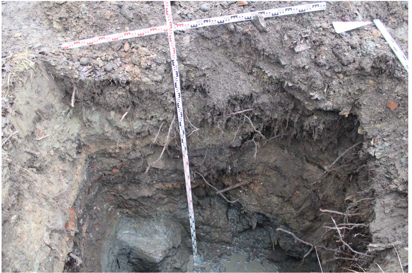
Рис. 65. Санкт-Петербург, г. Санкт-Петербург, Грузовой проезд, участок 1 (напротив дома 29, литера А по Грузовому проезду). Шурф 1. Западная стенка.
