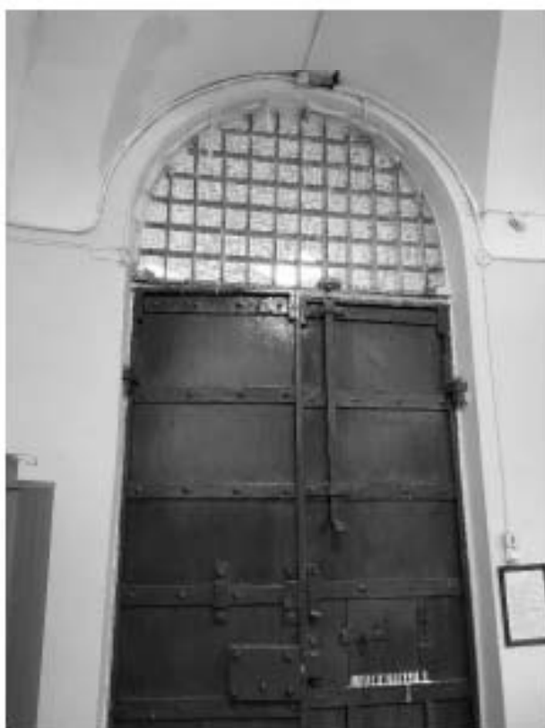
10. «Дворец Белосельских-Белозерских», пр. Невский, д.41, лит. А. Помещение №62. Фрагмент. Фото 30.04.2021 г.
