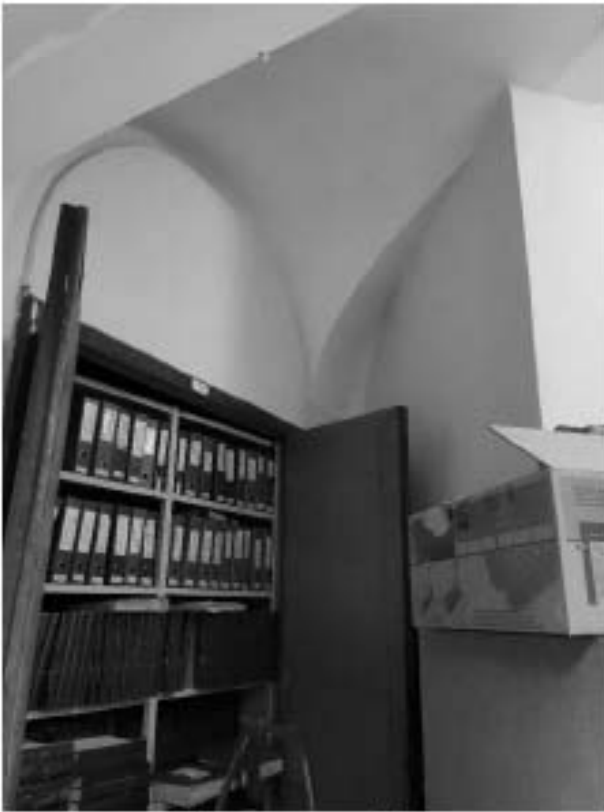
8. «Дворец Белосельских-Белозерских», пр. Невский, д.41, лит. А. Помещение №62. Фрагмент. Фото 30.04.2021 г.
