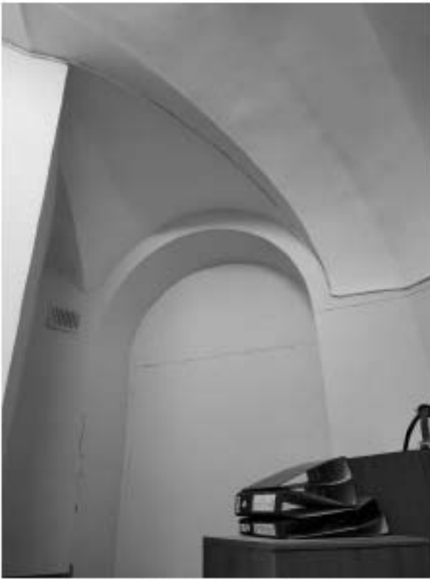
7. «Дворец Белосельских-Белозерских», пр. Невский, д.41, лит. А. Помещение №62. Фрагмент. Фото 30.04.2021 г.
