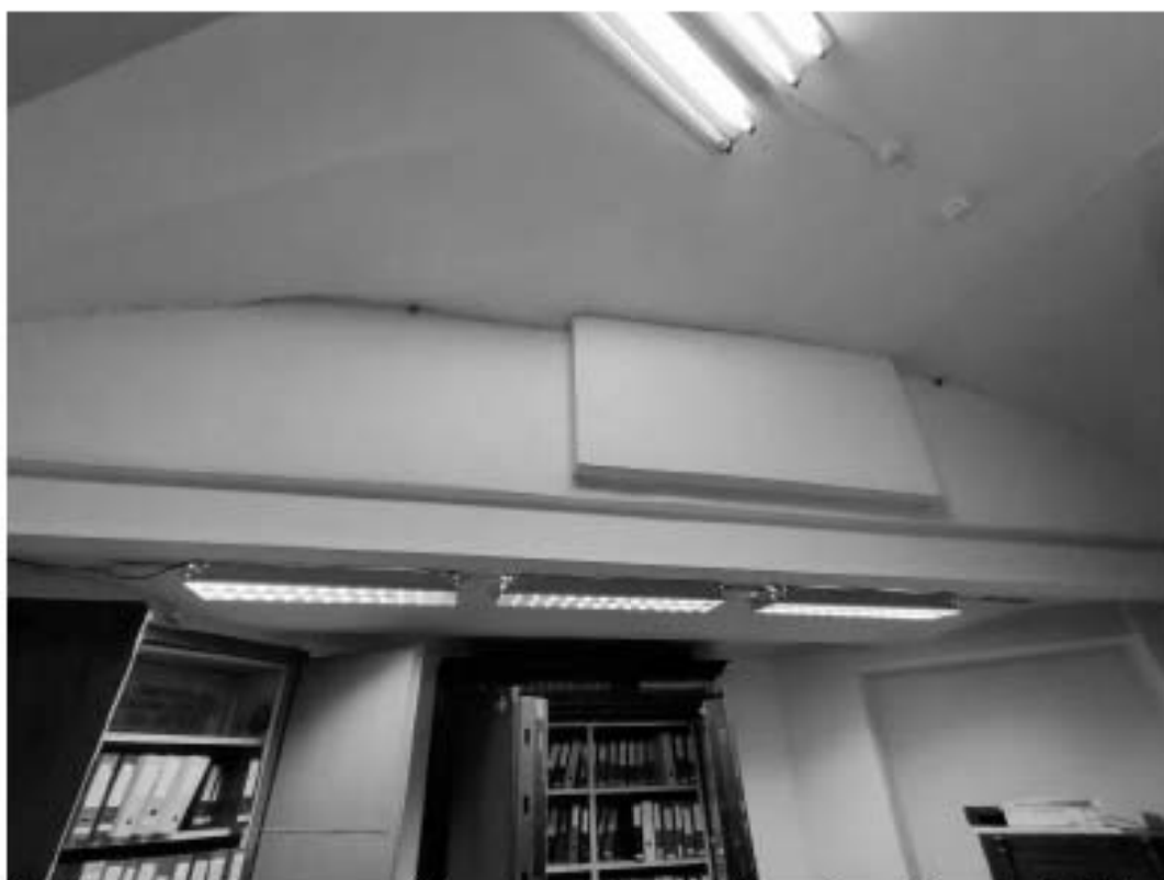
9. «Дворец Белосельских-Белозерских», пр. Невский, д.41, лит. А. Помещение №62. Фрагмент. Фото 30.04.2021 г.
