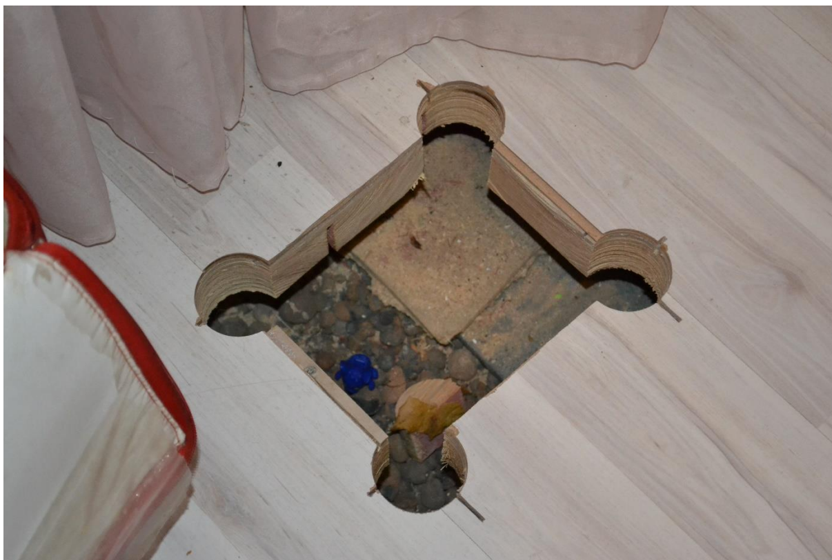
Фото 15. Участок вскрытия конструкций перекрытия под квартирой в помещении № 6. Вид с северо-запада
