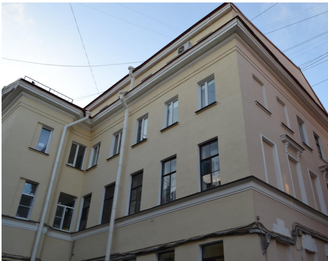
Фото 3. Северная часть дворового восточного фасада. На 3-м этаже оконные проемы квартиры № 47. Вид с северо-востока
