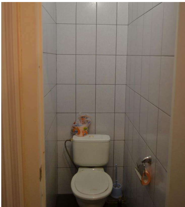
Фото 7. Помещение № 7 согласно техническому паспорту. Вид с юго-запада
