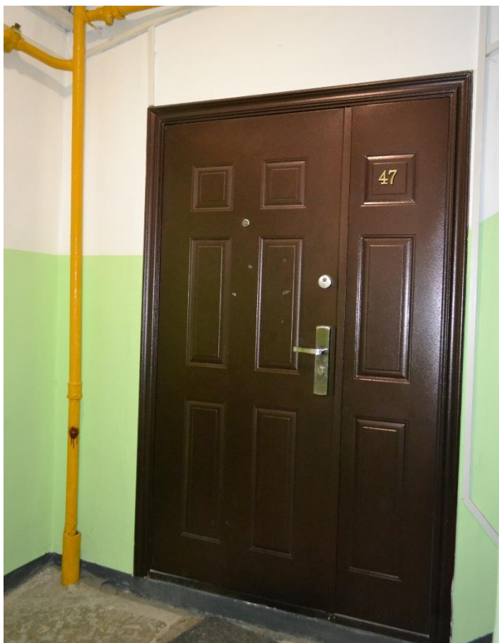
Фото 5. Вход в квартиру № 47. Вид с юго-востока
