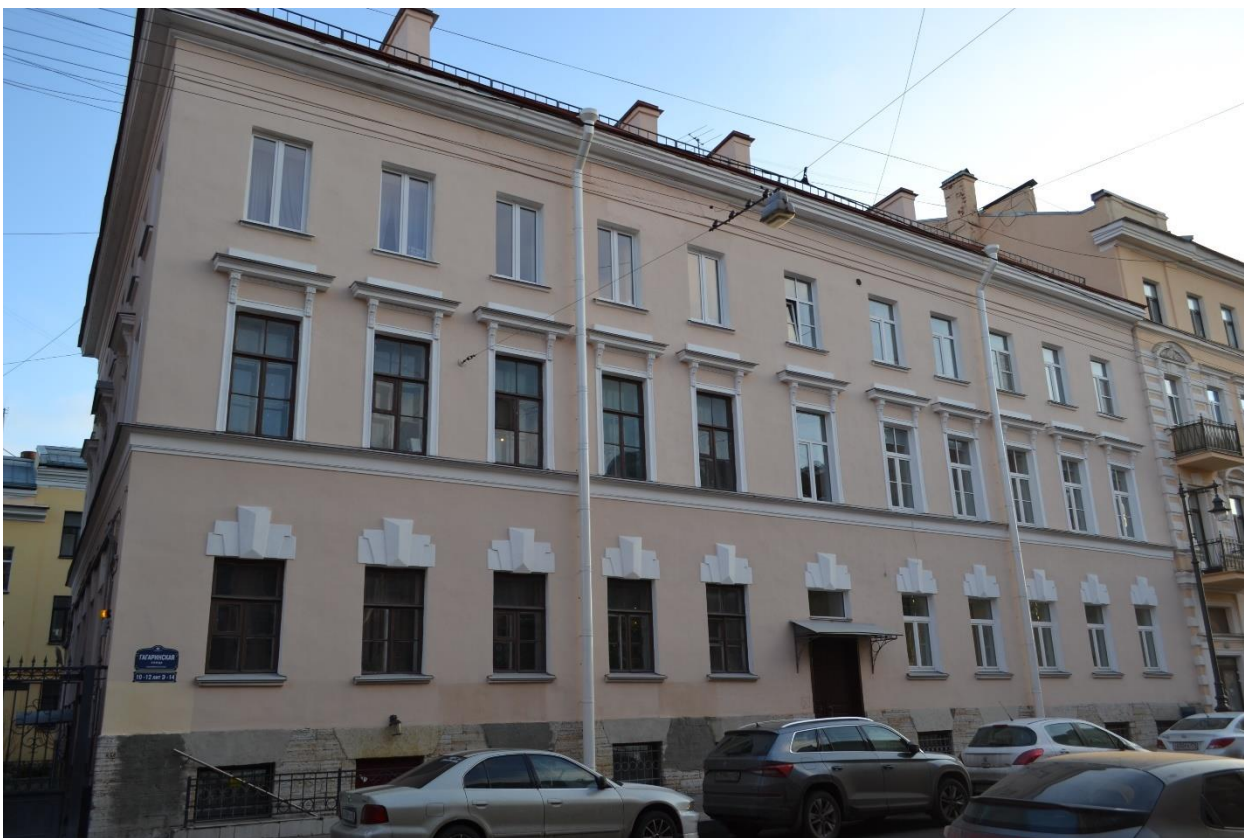
Фото 1. Лицевой западный фасад. Вид с северо-запада
