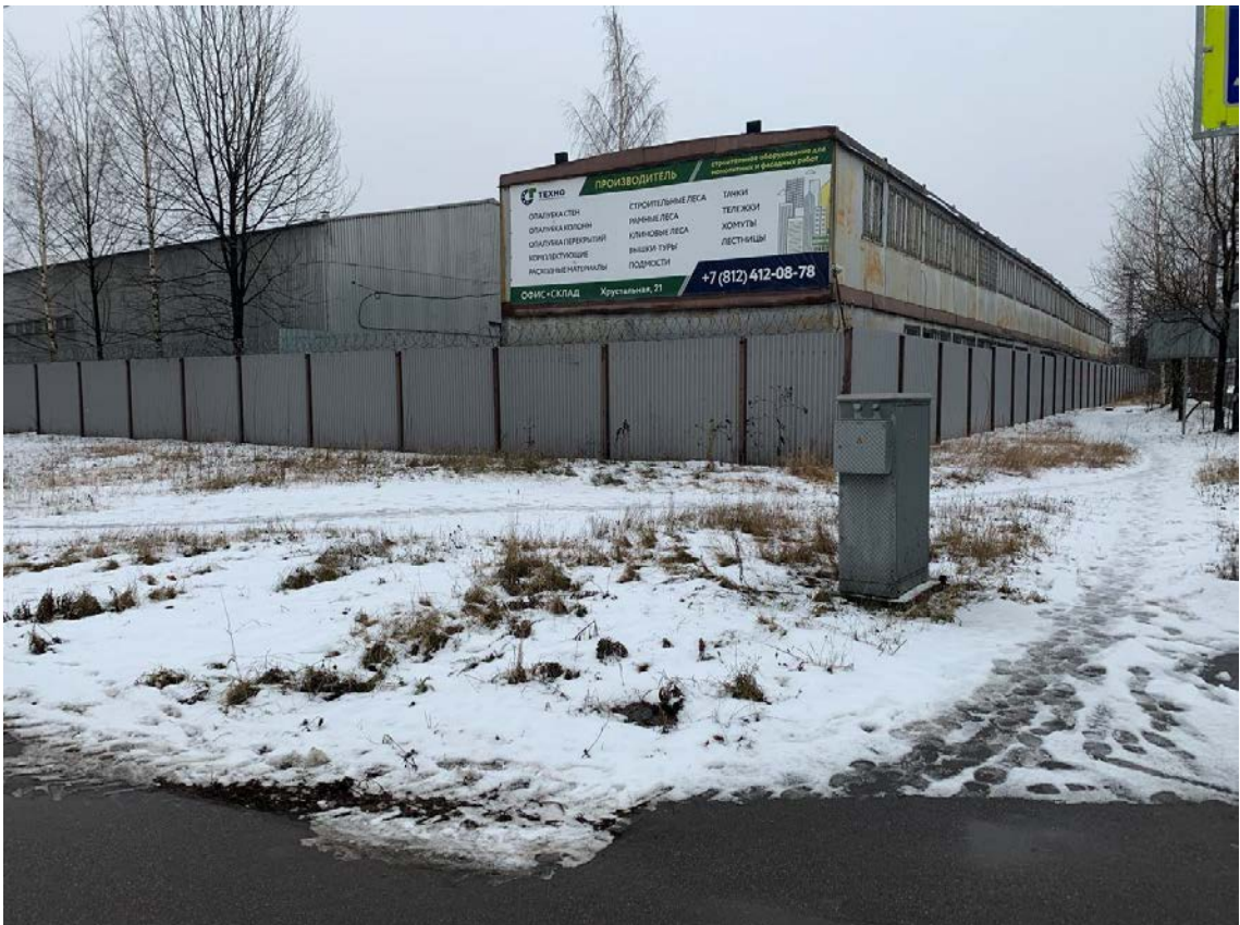
Рис. 97. Санкт-Петербург, Фрунзенский и Невский р-ны. Точка съемки 27. Общий вид участка обследования. Вид на ЮЗ.
