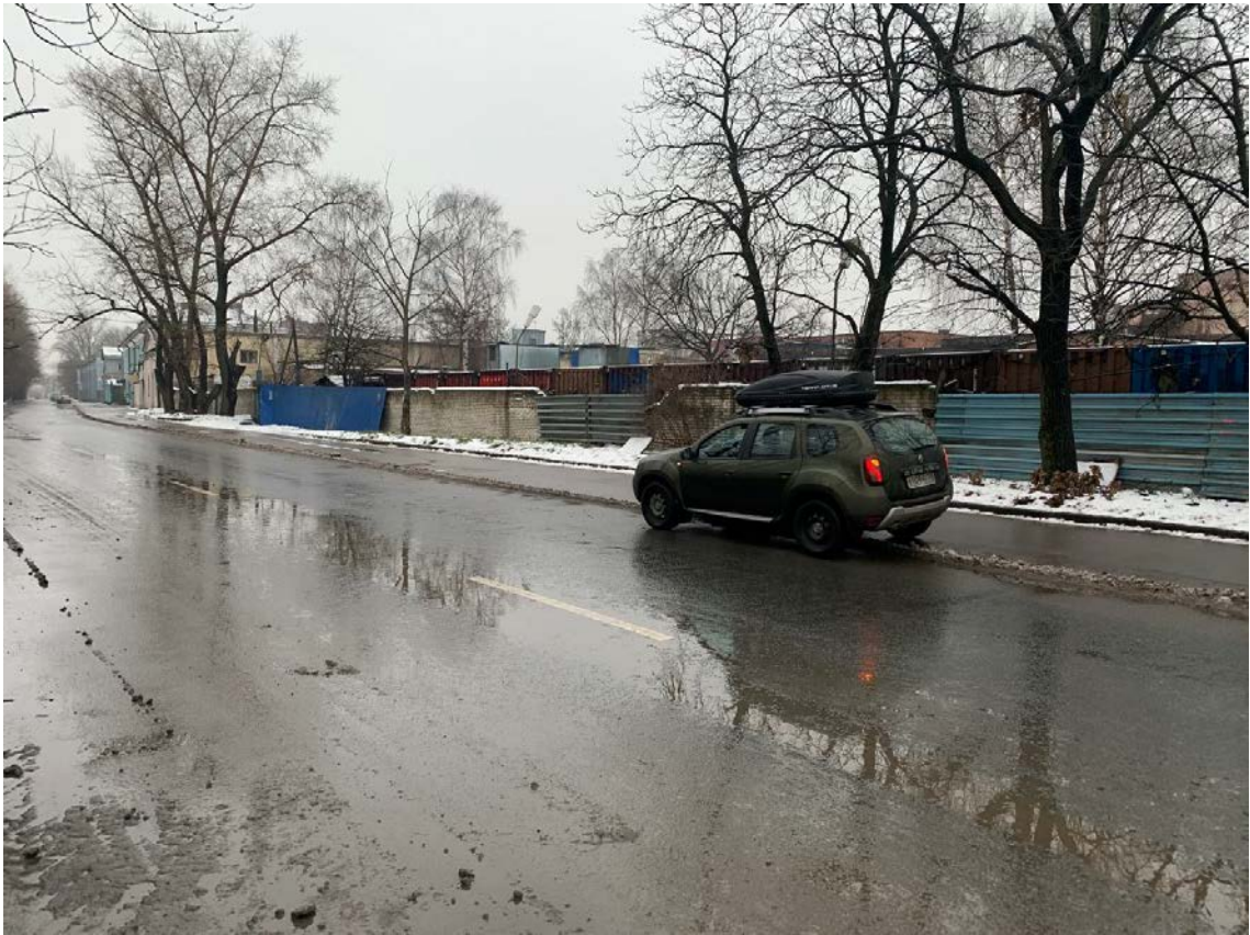
Рис. 70. Санкт-Петербург, Фрунзенский и Невский р-ны. Точка съемки 17. Общий вид участка обследования. Вид на ВСВ.
