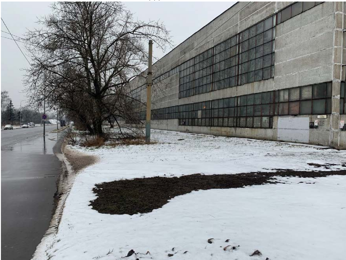
Рис. 66. Санкт-Петербург, Фрунзенский и Невский р-ны. Точка съемки 15. Общий вид участка обследования. Вид на ЗСЗ.
