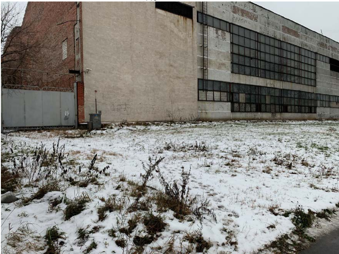
Рис. 64. Санкт-Петербург, Фрунзенский и Невский р-ны. Точка съемки 14. Общий вид участка обследования. Вид на ВСВ.
