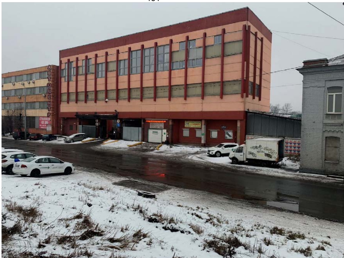
Рис. 80. Санкт-Петербург, Фрунзенский и Невский р-ны. Точка съемки 22. Общий вид участка обследования. Вид на З.
