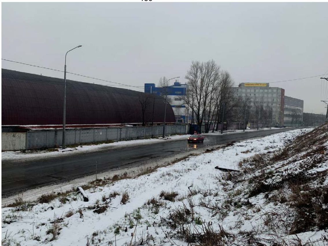
Рис. 78. Санкт-Петербург, Фрунзенский и Невский р-ны. Точка съемки 22. Общий вид участка обследования. Вид на СВ.
