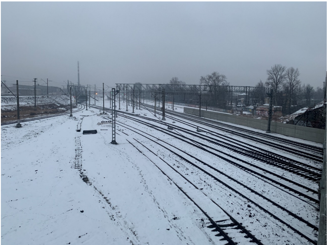
Рис. 47. Санкт-Петербург, Фрунзенский и Невский р-ны. Точка съёмки 7. Общий вид участка обследования. Вид на ЮВ.
