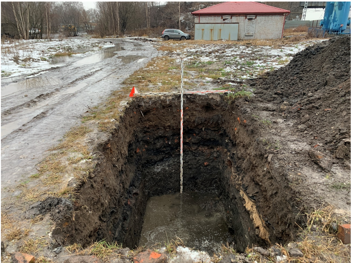
Рис. 107. Санкт-Петербург, Фрунзенский и Невский р-ны. Общий вид Шурфа 1. Зачистка по уровню грунтовых вод. Вид на С.
