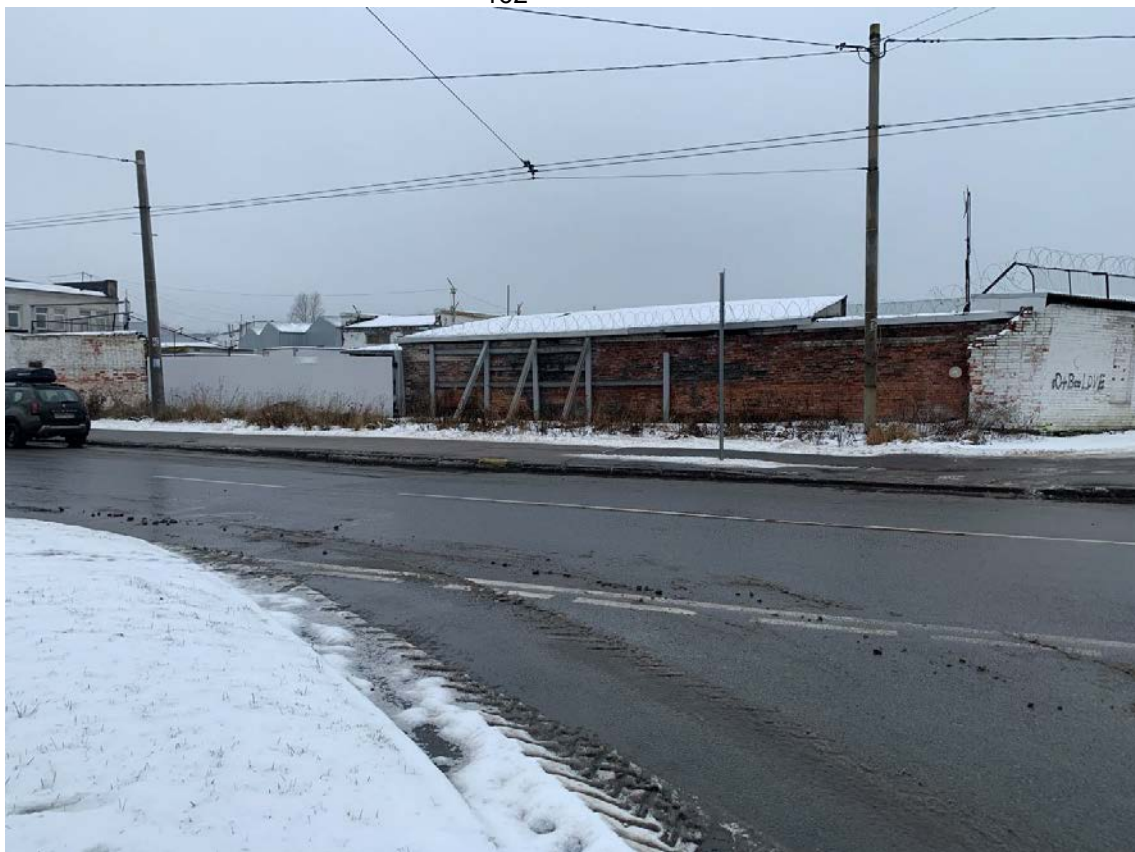
Рис. 102. Санкт-Петербург, Фрунзенский и Невский р-ны. Точка съемки 29. Общий вид участка обследования. Вид на З.
