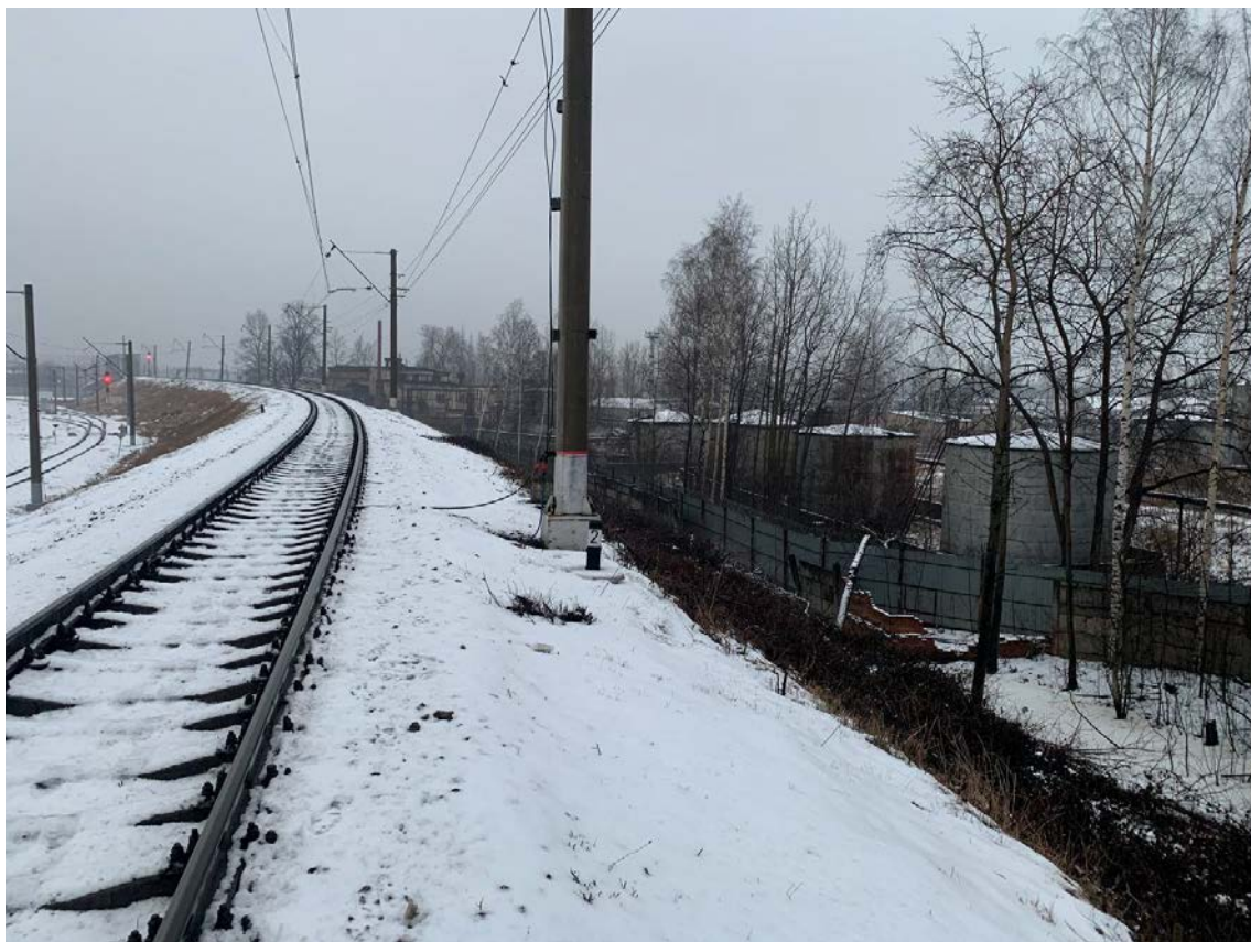
Рис. 27. Санкт-Петербург, Фрунзенский и Невский р-ны. Точка съёмки 2. Общий вид участка обследования. Вид на ССВ.
