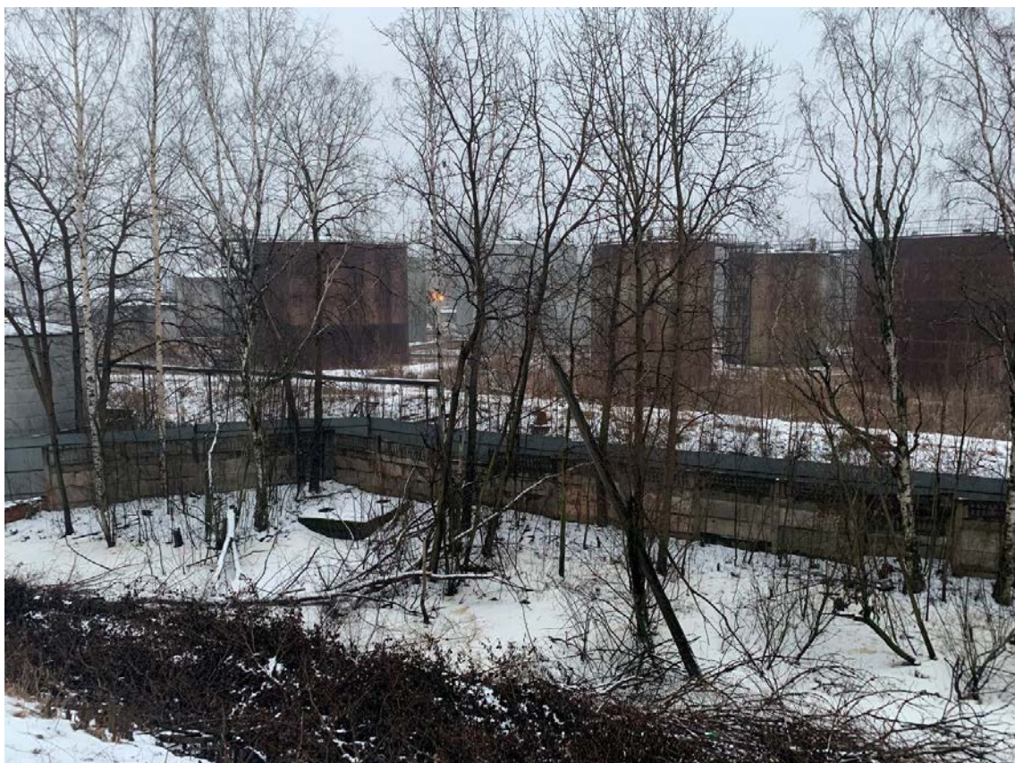
Рис. 25. Санкт-Петербург, Фрунзенский и Невский р-ны. Точка съёмки 2. Общий вид участка обследования. Вид на ВЮВ.
