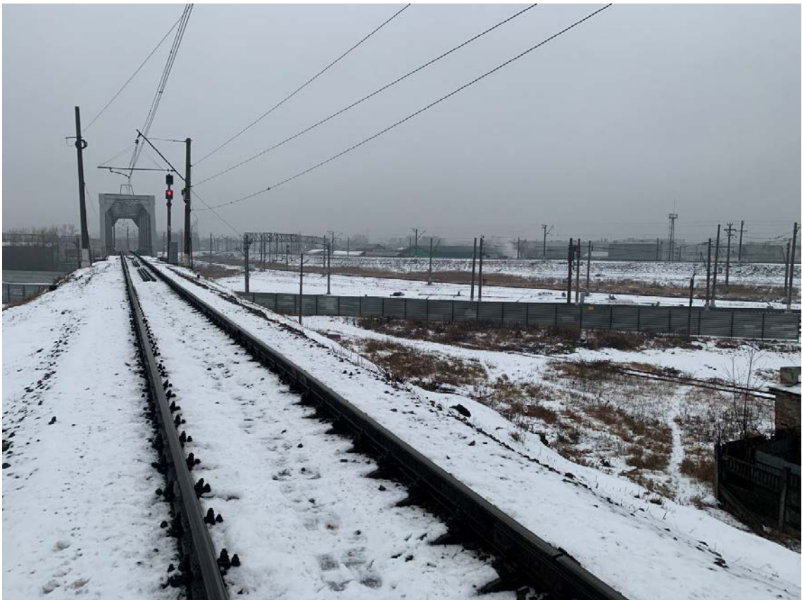
Рис. 37. Санкт-Петербург, Фрунзенский и Невский р-ны. Точка съёмки 4. Общий вид участка обследования. Вид на ССВ.
