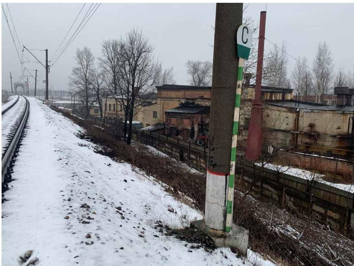
Рис. 31. Санкт-Петербург, Фрунзенский и Невский р-ны. Точка съёмки 3. Общий вид участка обследования. Вид на ССВ.
