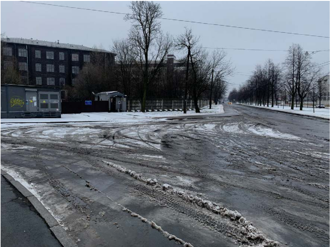
Рис. 104. Санкт-Петербург, Фрунзенский и Невский р-ны. Точка съемки 30. Общий вид участка обследования. Вид на ЮЗ.
