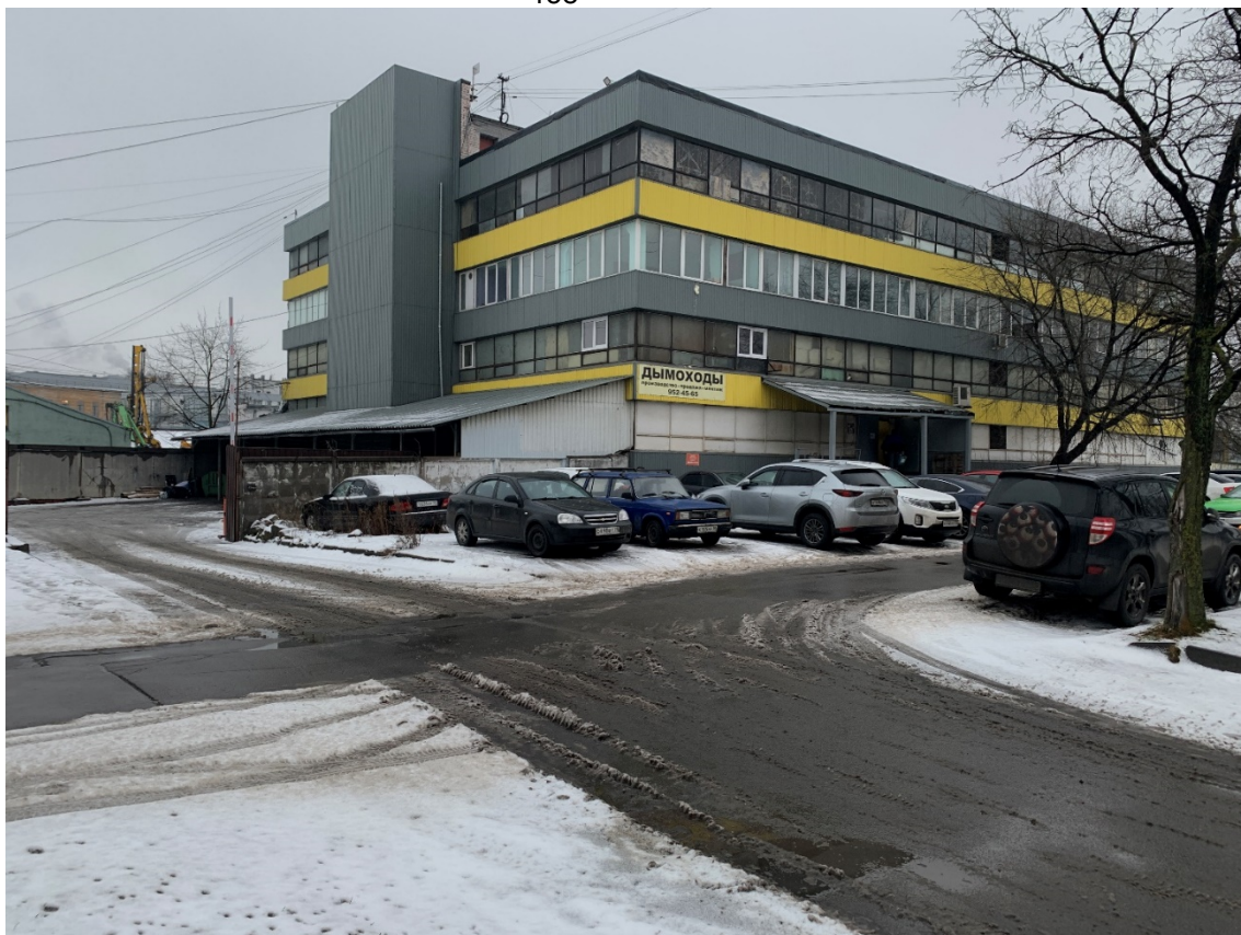
Рис. 94. Санкт-Петербург, Фрунзенский и Невский р-ны. Точка съемки 26. Общий вид участка обследования. Вид на ВЮВ.
