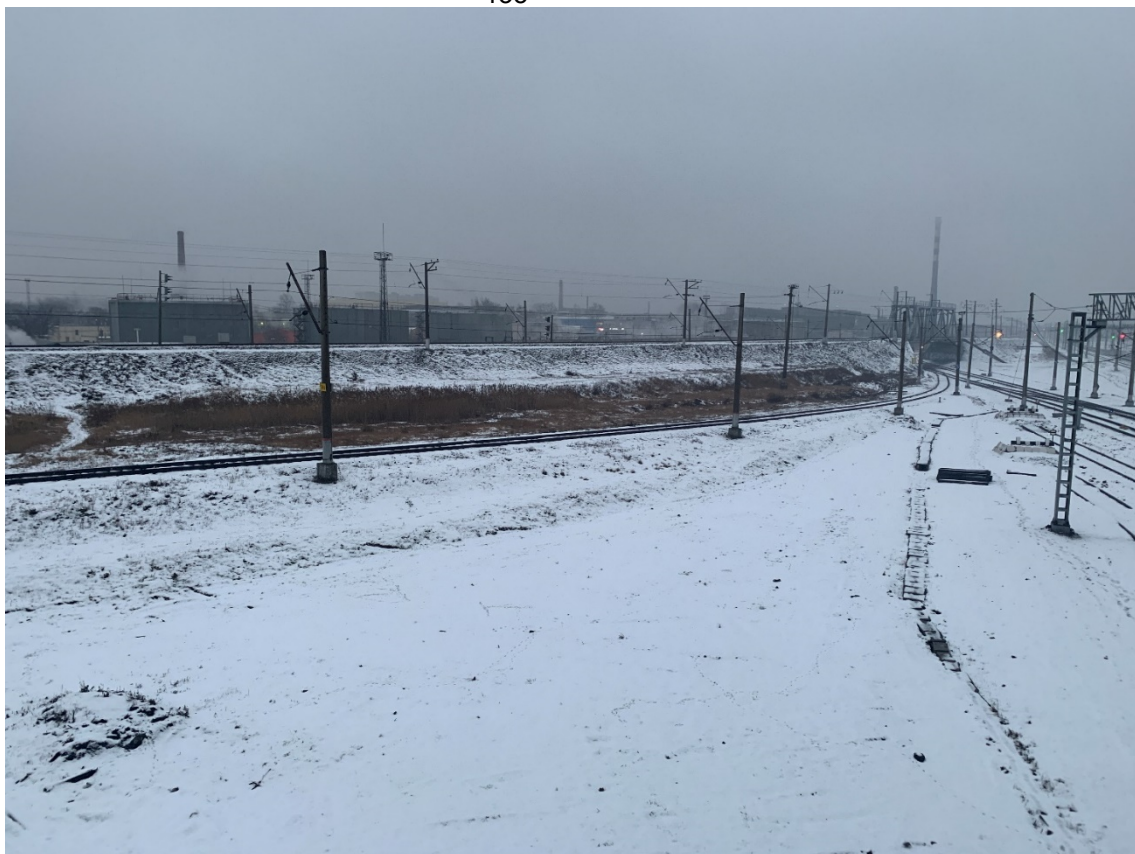
Рис. 48. Санкт-Петербург, Фрунзенский и Невский р-ны. Точка съёмки 7. Общий вид участка обследования. Вид на ВЮВ.
