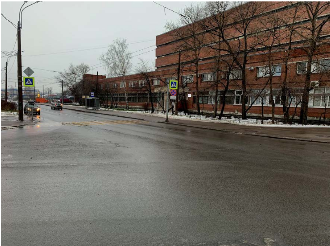
Рис. 87. Санкт-Петербург, Фрунзенский и Невский р-ны. Точка съемки 25. Общий вид участка обследования. Вид на З.
