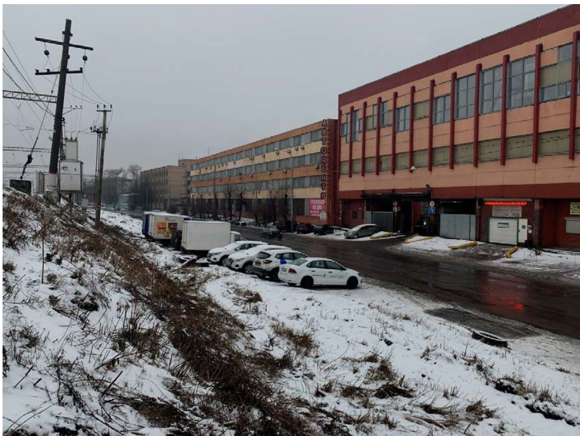
Рис. 81. Санкт-Петербург, Фрунзенский и Невский р-ны. Точка съемки 22. Общий вид участка обследования. Вид на ЮЗ.
