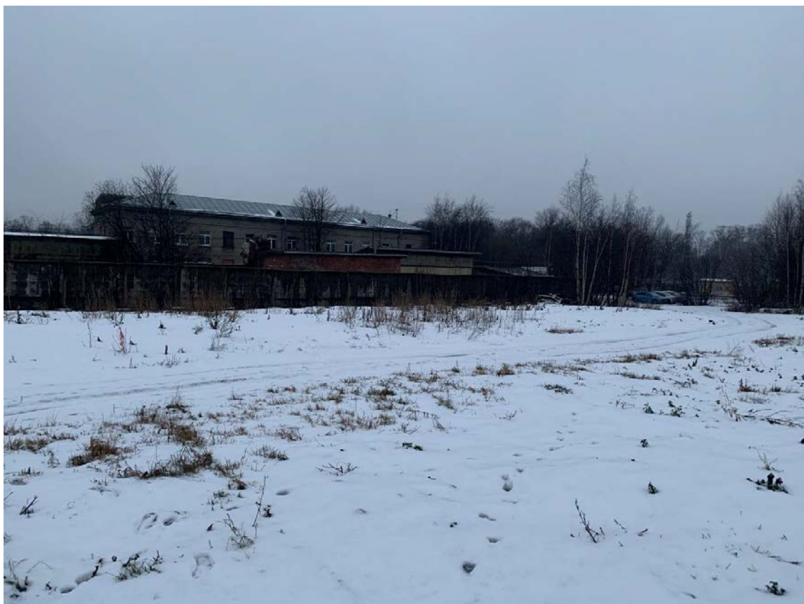
Рис. 55. Санкт-Петербург, Фрунзенский и Невский р-ны. Точка съёмки 9. Общий вид участка обследования. Вид на ЗСЗ.
