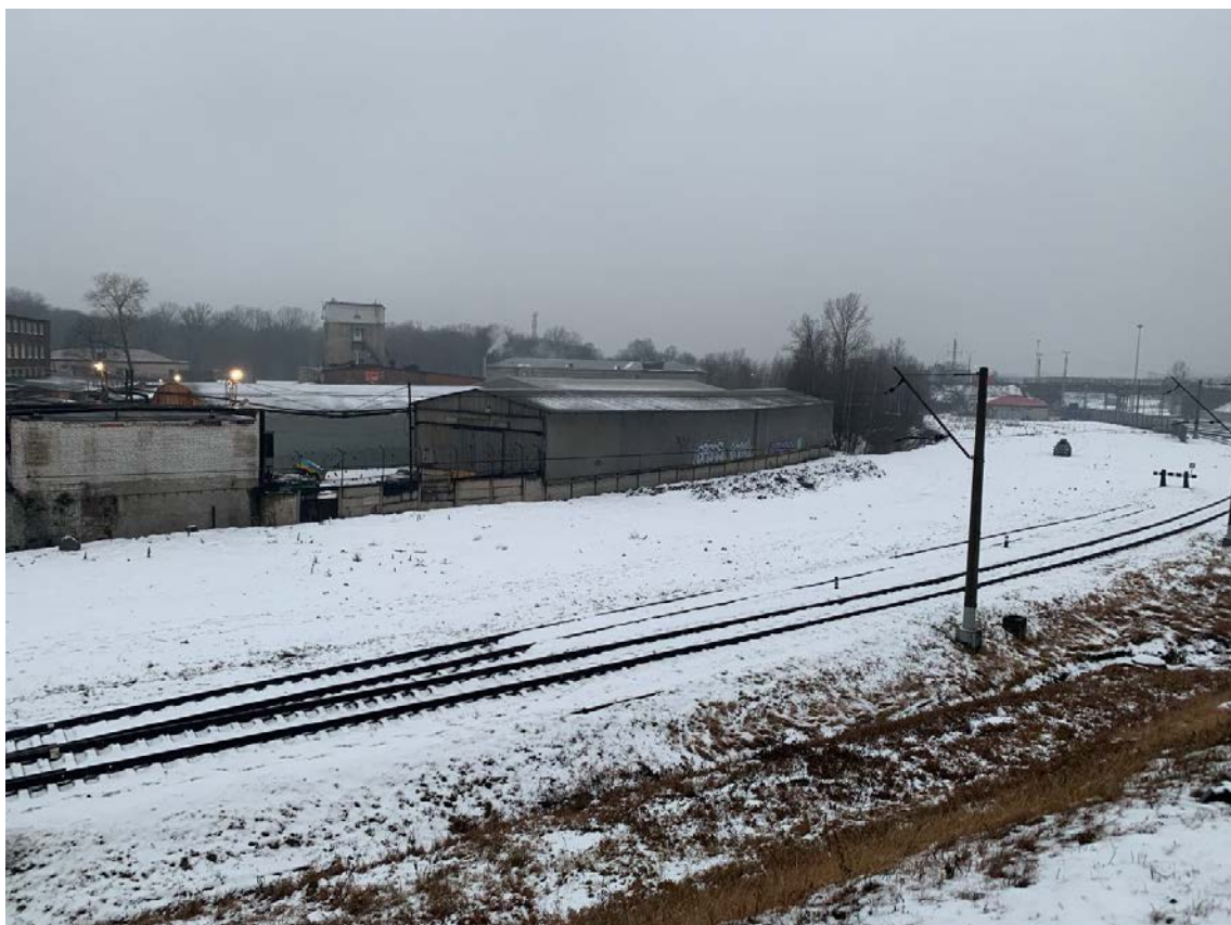
Рис. 39. Санкт-Петербург, Фрунзенский и Невский р-ны. Точка съёмки 4. Общий вид участка обследования. Вид на СЗ.
