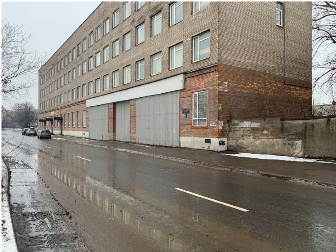
Рис. 68. Санкт-Петербург, Фрунзенский и Невский р-ны. Точка съемки 16. Общий вид участка обследования. Вид на ВСВ.
