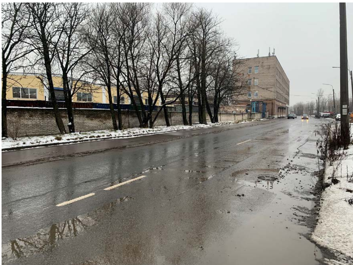
Рис. 69. Санкт-Петербург, Фрунзенский и Невский р-ны. Точка съемки 17. Общий вид участка обследования. Вид на ЮЗ.
