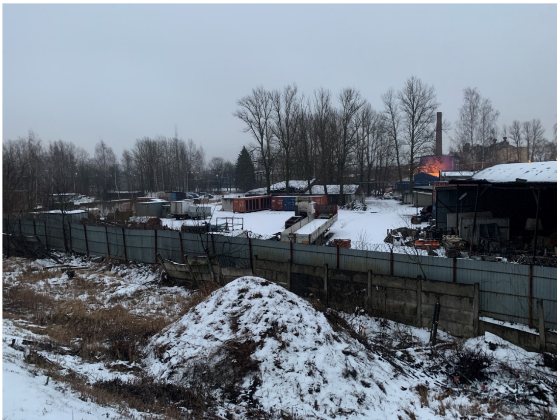
Рис. 21. Санкт-Петербург, Фрунзенский и Невский р-ны. Точка съемки 1. Общий вид участка обследования. Вид на ВЮВ.
