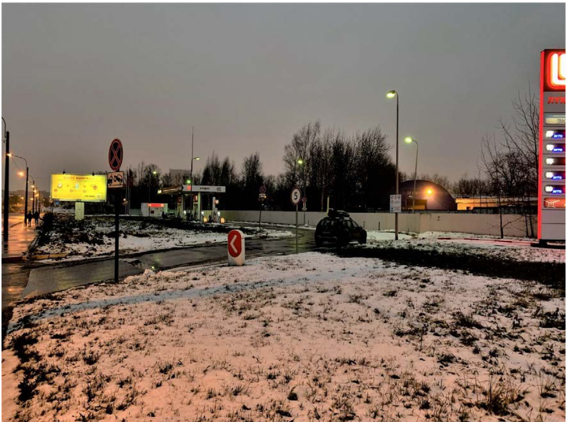
Рис. 61. Санкт-Петербург, Фрунзенский и Невский р-ны. Точка съёмки 12. Общий вид участка обследования. Вид на С.
