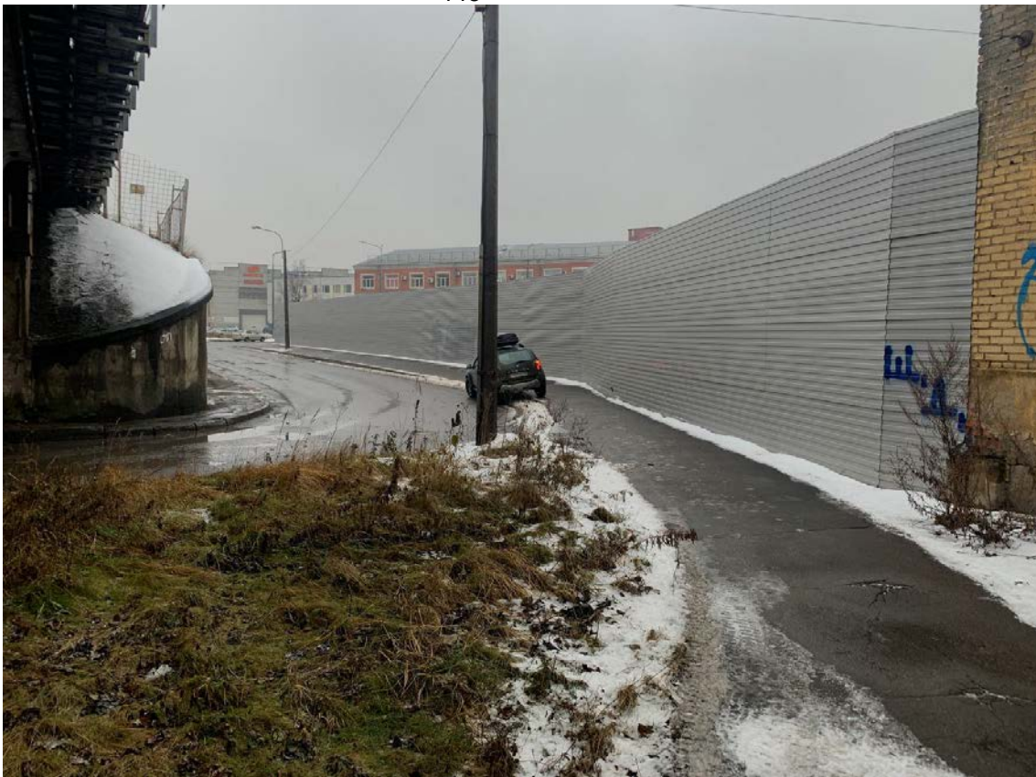
Рис. 74. Санкт-Петербург, Фрунзенский и Невский р-ны. Точка съемки 20. Общий вид участка обследования. Вид на З.
