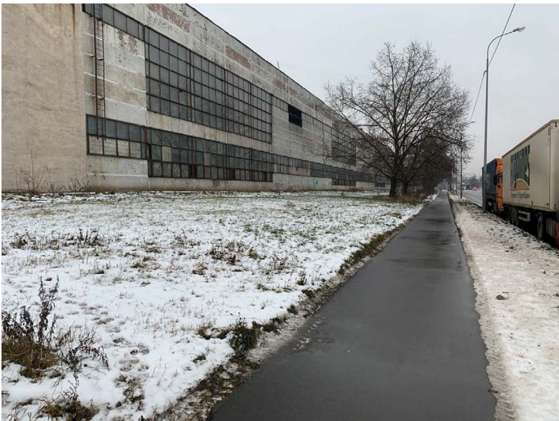
Рис. 65. Санкт-Петербург, Фрунзенский и Невский р-ны. Точка съемки 14. Общий вид участка обследования. Вид на ВЮВ.
