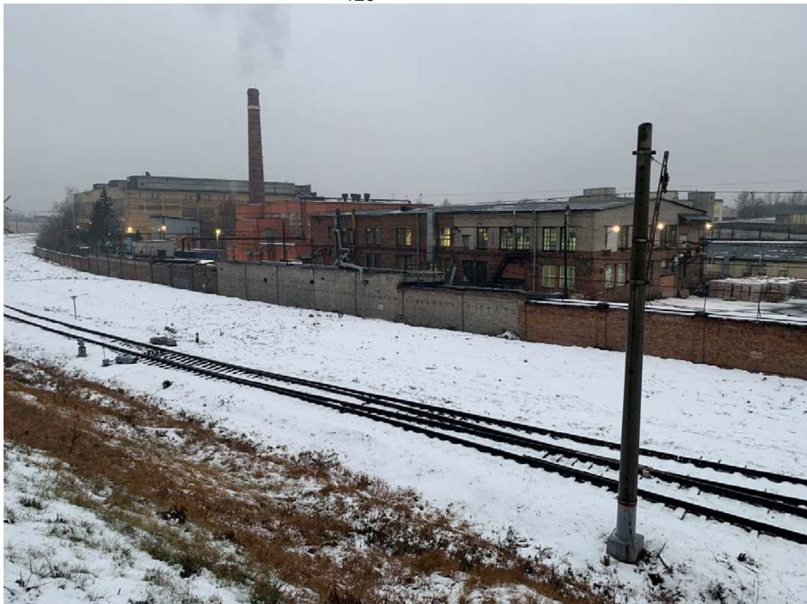
Рис. 34. Санкт-Петербург, Фрунзенский и Невский р-ны. Точка съёмки 3. Общий вид участка обследования. Вид на ЮЗ.
