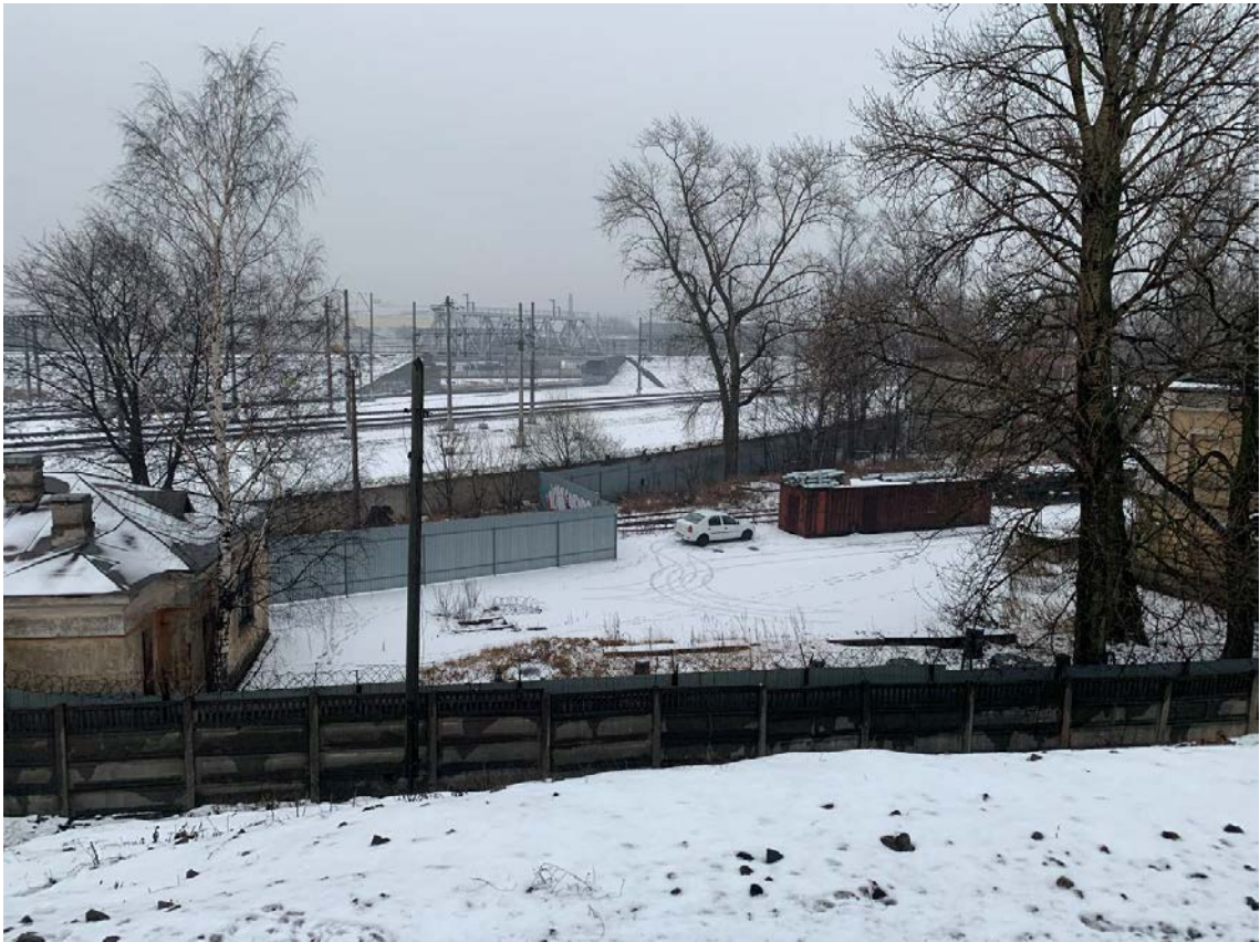
Рис. 36. Санкт-Петербург, Фрунзенский и Невский р-ны. Точка съёмки 4. Общий вид участка обследования. Вид на ВЮВ.
