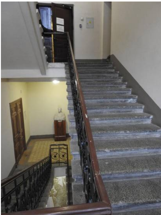
27. «Дом, где жили: в 1912-1936 гг. – путешественник Грум-Гржимайло Г.Е, в 1914-1922 гг. – певец Шаляпин Ф.И». Второй этаж. Помещение № 39. Фрагмент. Фото 12.03.2021 г.
