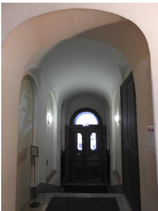
8. «Дом, где жили: в 1912-1936 гг. – путешественник Грум-Гржимайло Г.Е, в 1914-1922 гг. – певец Шаляпин Ф.И». Первый этаж. Помещение № 1. Общий вид. Фото 12.03.2021 г.
