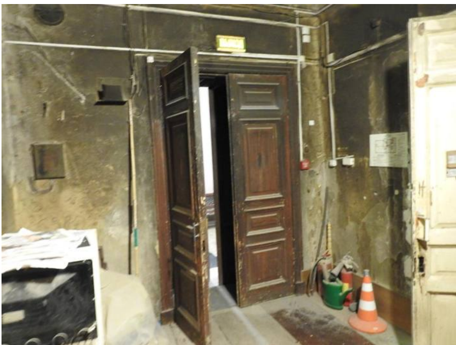
9. «Дом, где жили: в 1912-1936 гг. – путешественник Грум-Гржимайло Г.Е, в 1914-1922 гг. – певец Шаляпин Ф.И». Первый этаж. Помещение № 10. Общий вид. Фото 12.03.2021 г.
