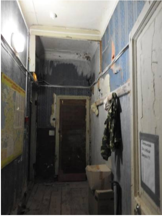
13. «Дом, где жили: в 1912-1936 гг. – путешественник Грум-Гржимайло Г.Е, в 1914-1922 гг. – певец Шаляпин Ф.И». Первый этаж. Помещение № 16. Общий вид. Фото 12.03.2021 г.
