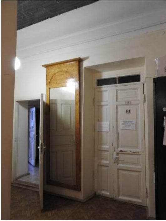
37. «Дом, где жили: в 1912-1936 гг. – путешественник Грум-Гржимайло Г.Е, в 1914-1922 гг. – певец Шаляпин Ф.И». Четвертый этаж. Помещение №80. Фрагмент. Фото 12.03.2021 г.
