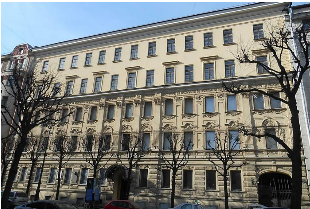
1. «Дом, где жили: в 1912-1936 гг. – путешественник Грум-Гржимайло Г.Е, в 1914-1922 гг. – певец Шаляпин Ф.И». Юго-восточный фасад. Общий вид. Фото 12.03.2021 г.
