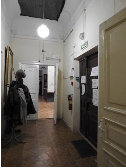
41. «Дом, где жили: в 1912-1936 гг. – путешественник Грум-Гржимайло Г.Е, в 1914-1922 гг. – певец Шаляпин Ф.И». Четвертый этаж. Помещение №80. Фрагмент. Фото 12.03.2021 г.
