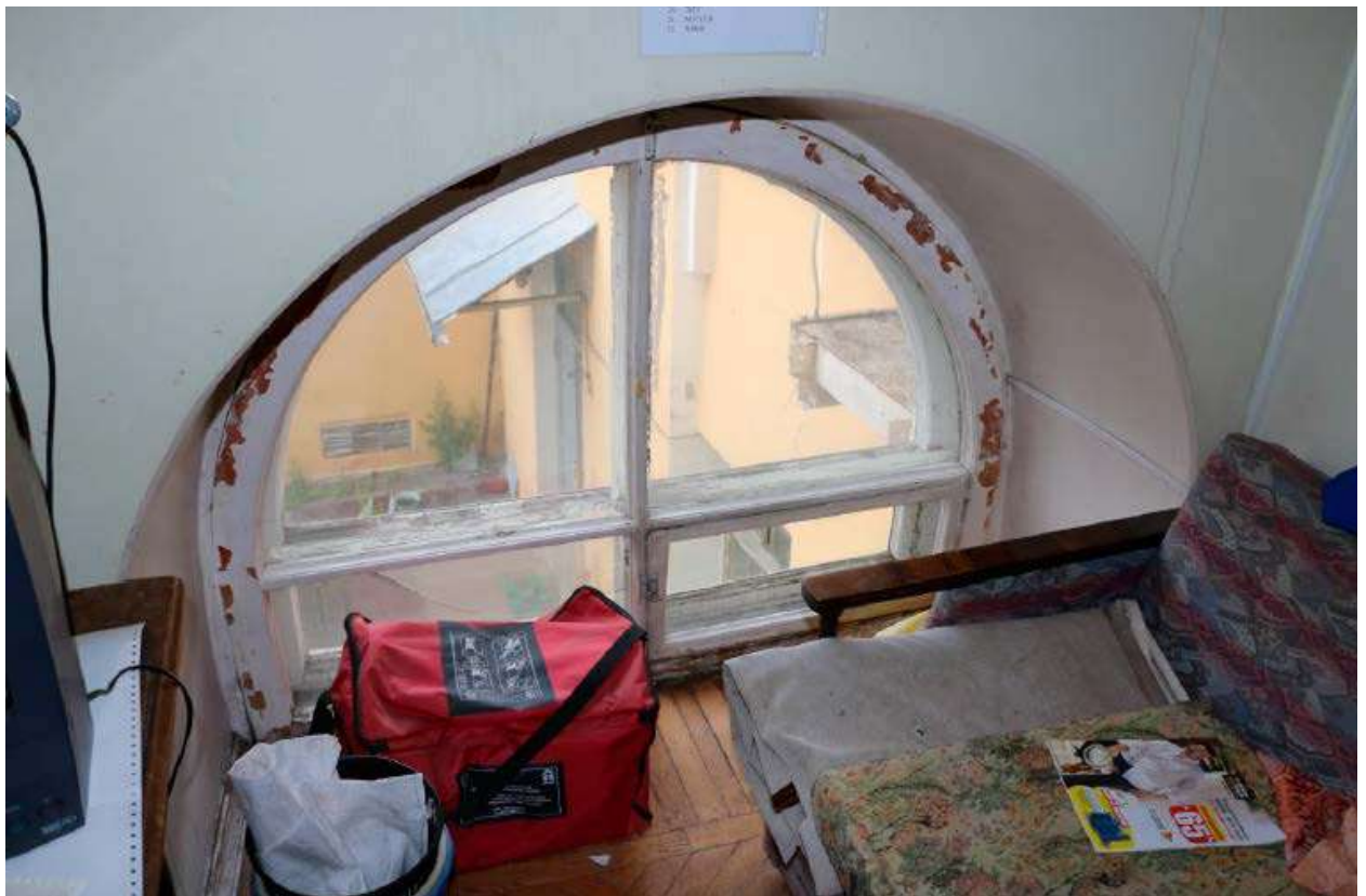
39. Помещение №334 в уровне 2-ого этажа объекта культурного наследия федерального значения «Дворец Таврический. Дворец». 01.12.2020
