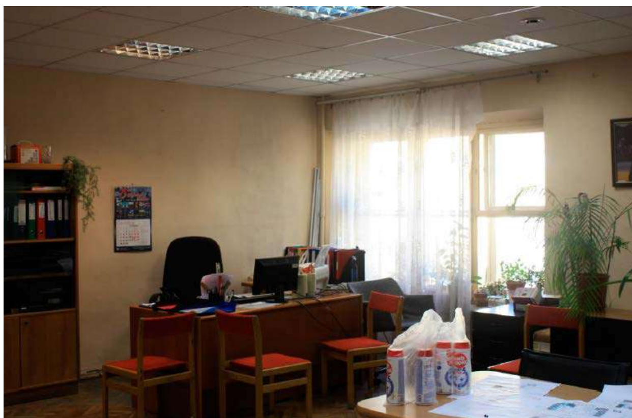
10. Помещение №322 в уровне 2-ого этажа объекта культурного наследия федерального значения «Дворец Таврический. Дворец». 01.12.2020
