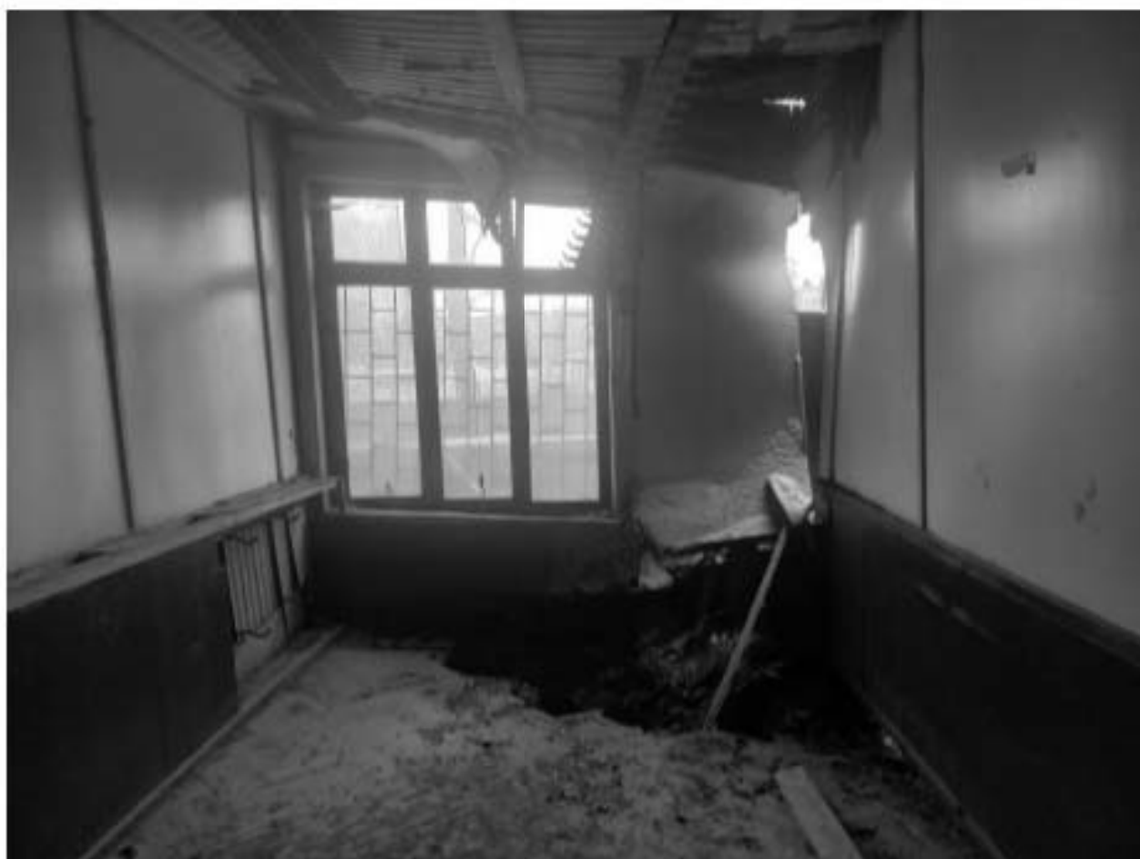
Фото 18. Внутренние помещения. 1 этаж.
