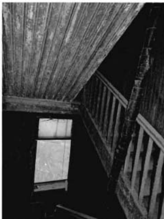
4. Лестница в северо-восточной части объекта культурного наследия.
