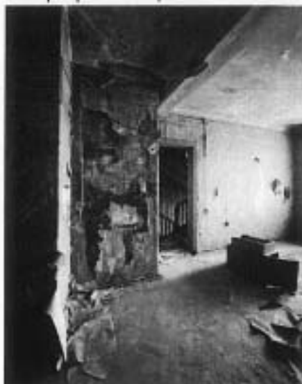
17. Интерьеры помещений 2-го этажа
