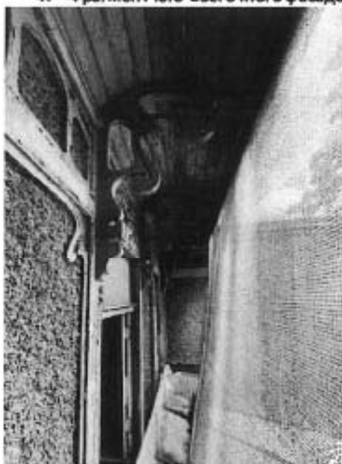
5. Декоративные элементы юго-восточного фасада.
