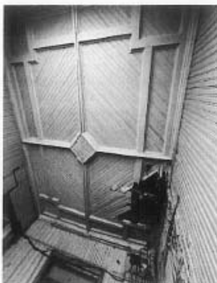
13. Интерьеры помещений 2-го этажа
