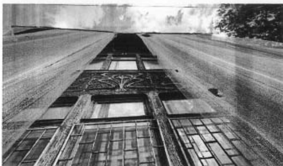
2. Фрагмент юго-западного фасада. Центральная часть.
