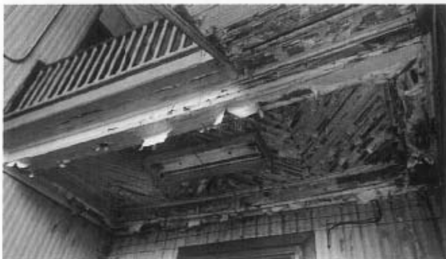
10. Интерьеры помещений 1-го этажа
