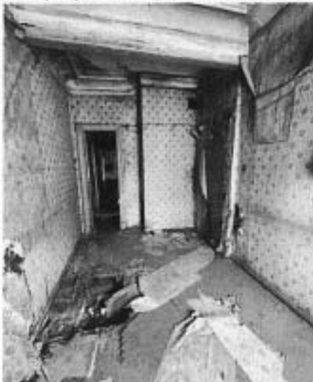
15. Интерьеры помещений 2-го этажа
