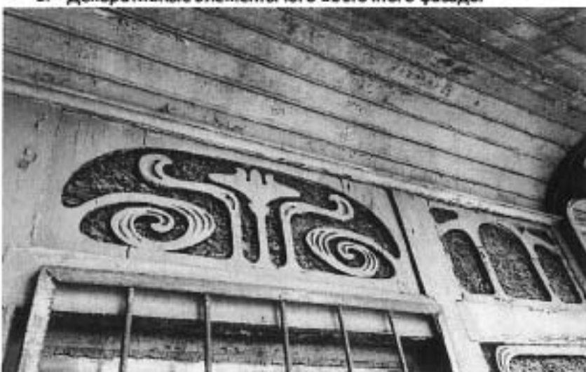
6. Декоративные элементы юго-восточного фасада.
