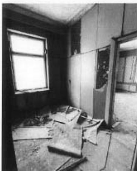
14. Интерьеры помещений 2-го этажа
