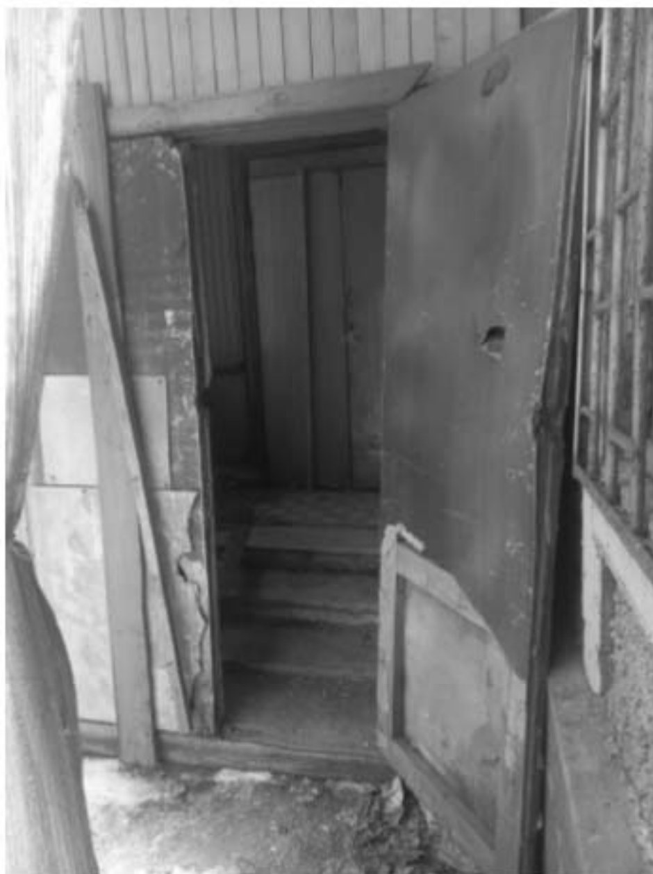
Фото 5. Главный вход в здание.
