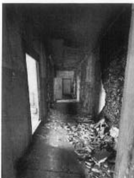
16. Интерьеры помещений 2-го этажа
