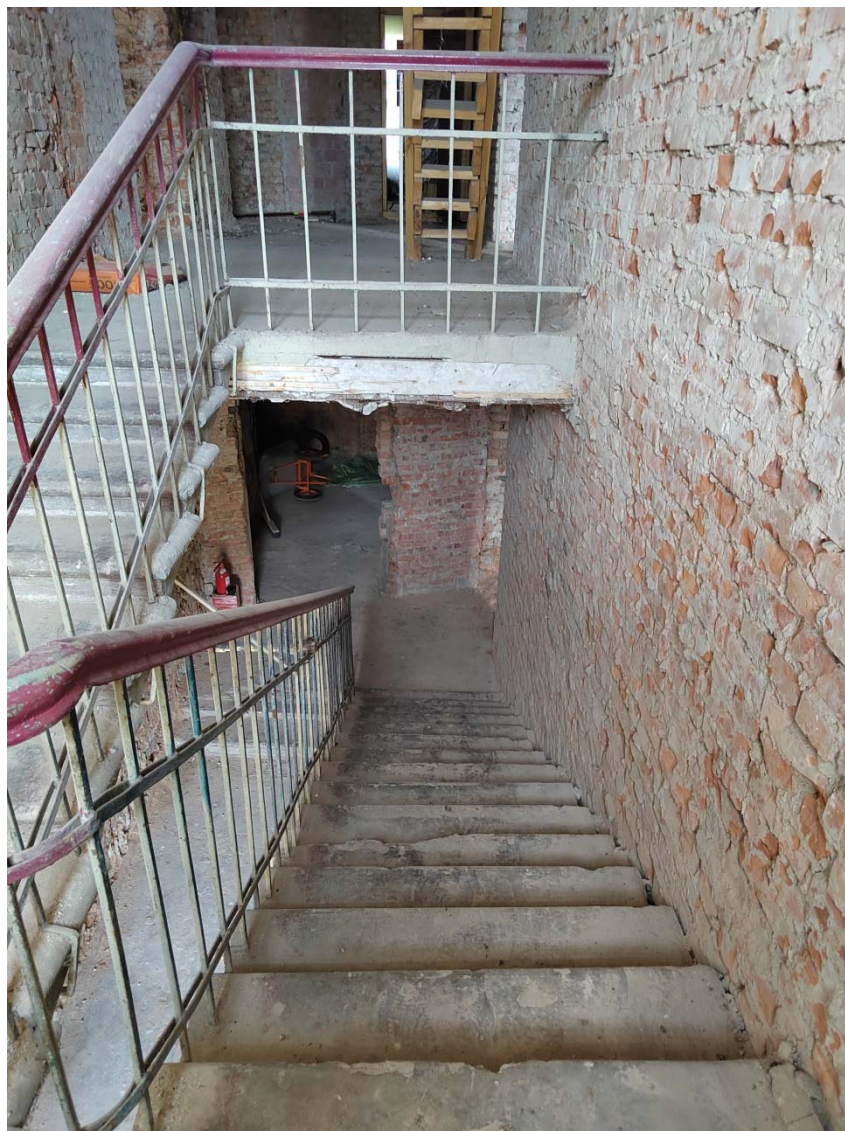
Фото 29. Лестница. Вид с площадки.
