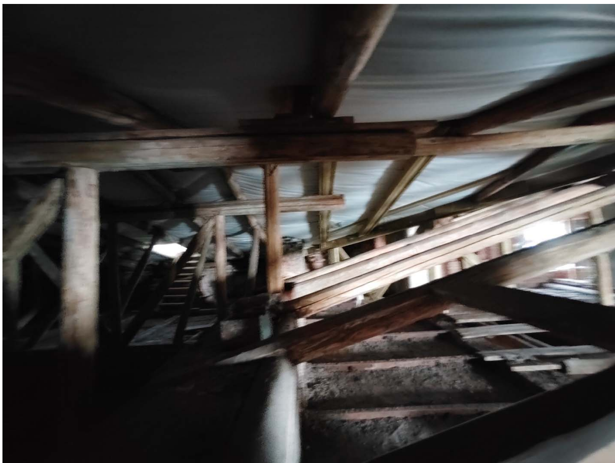
Фото 39. Чердак. Несущие конструкции крыши.
