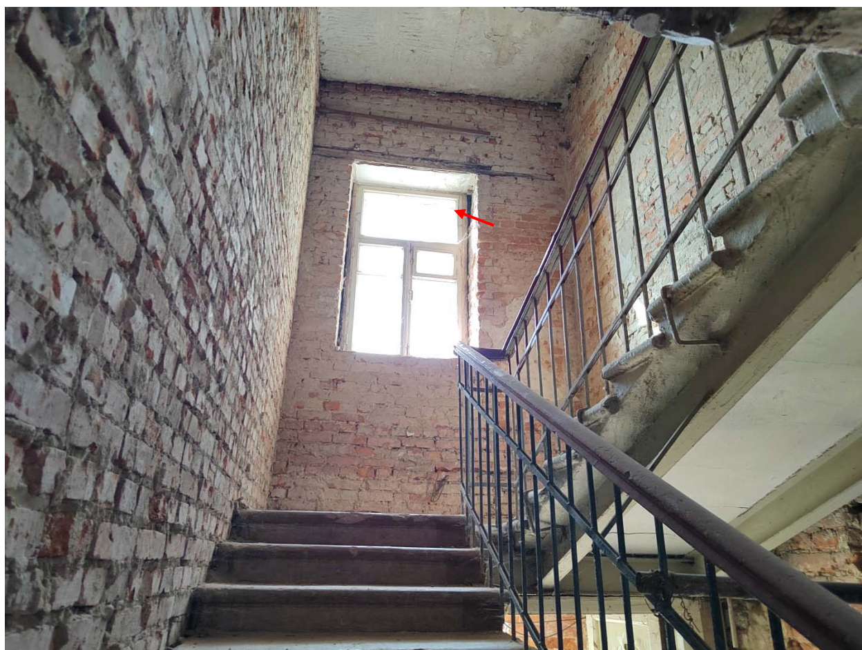
Фото 28. Площадка лестницы между этажами.
