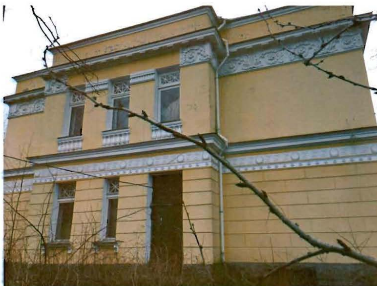
3. Северо-западный фасад здания.
