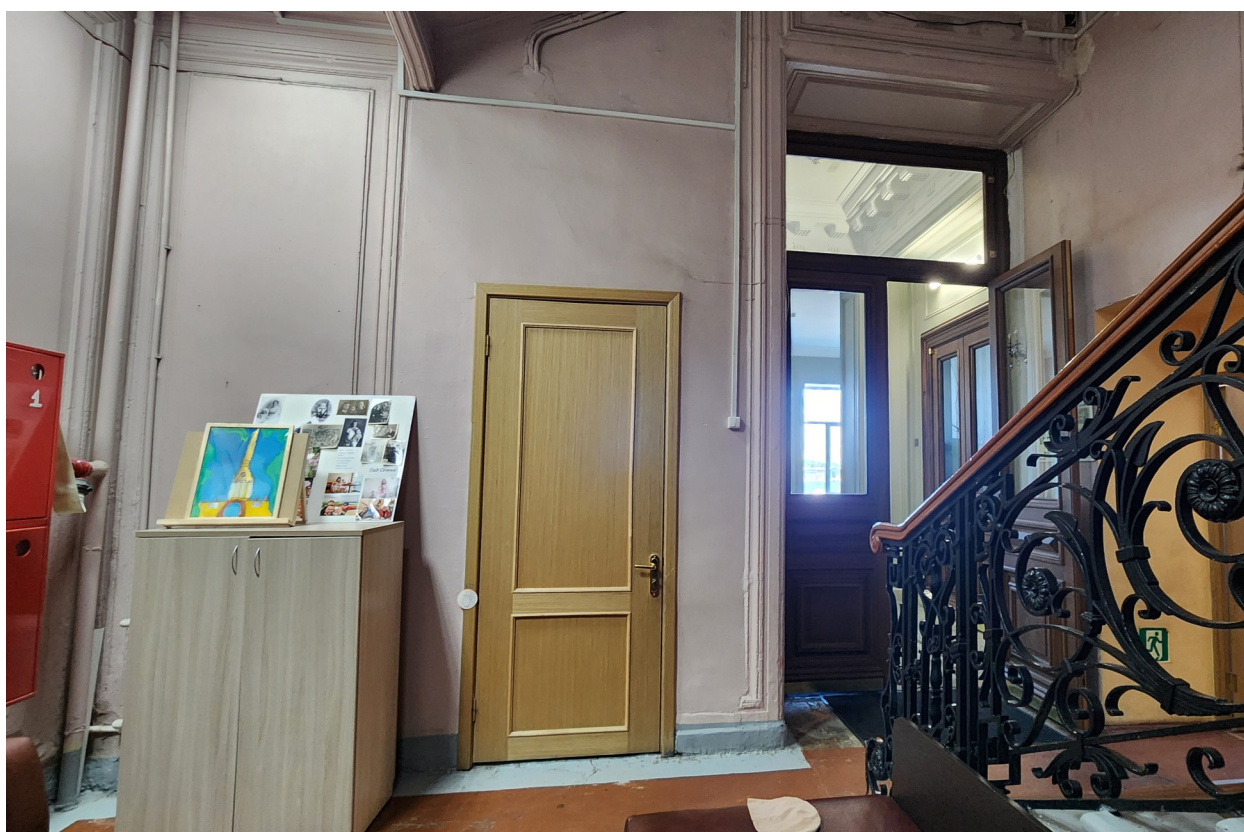
Фото 5. Лестница вестибюля. 1 этаж. Вид на север.
