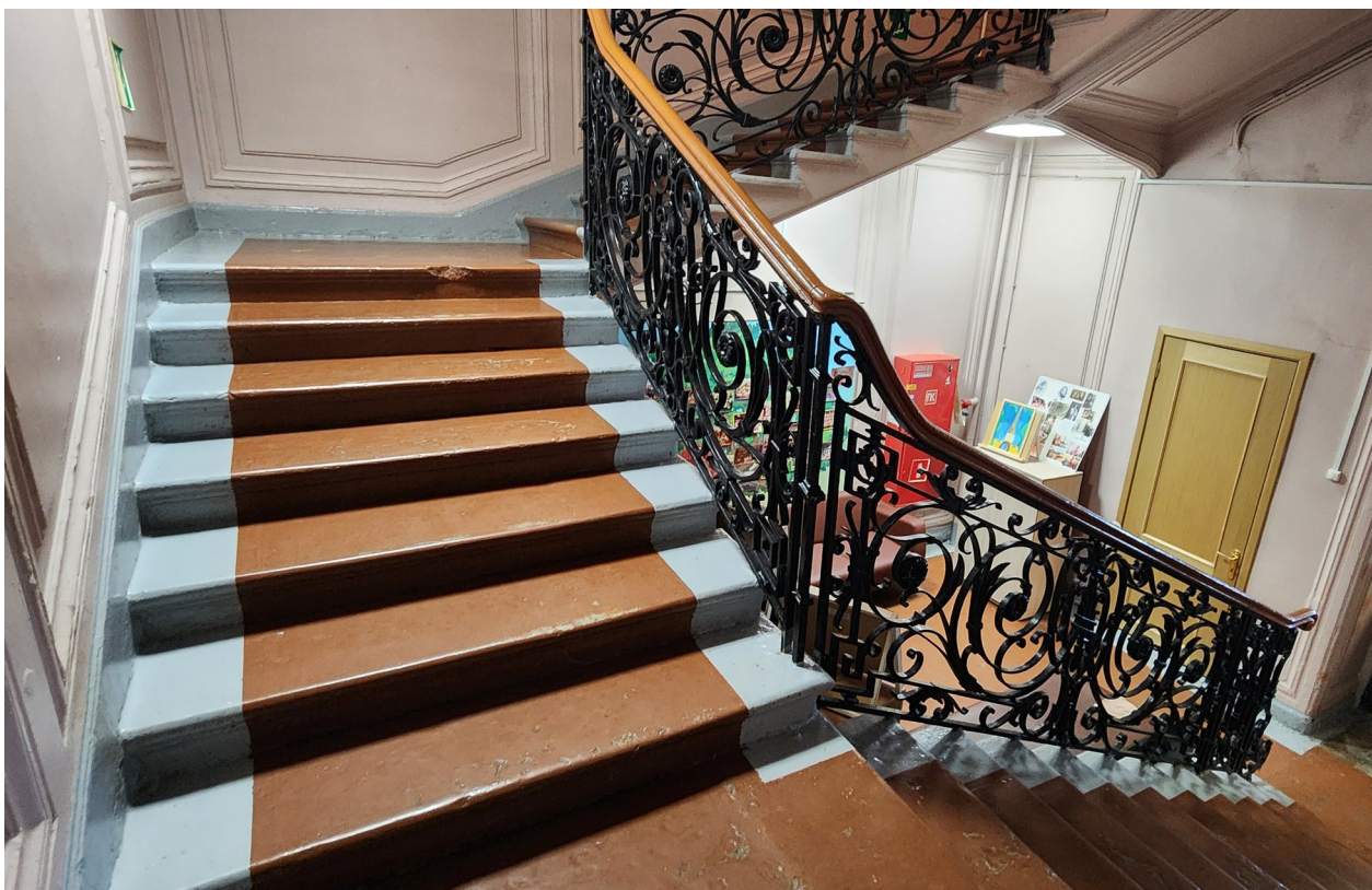
Фото 6. Лестница вестибюля. Вид на запад.
