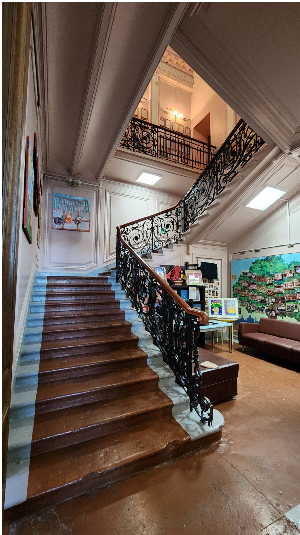
Фото 1. Лестница вестибюля. Помещение № 19-Н. Общий вид.
