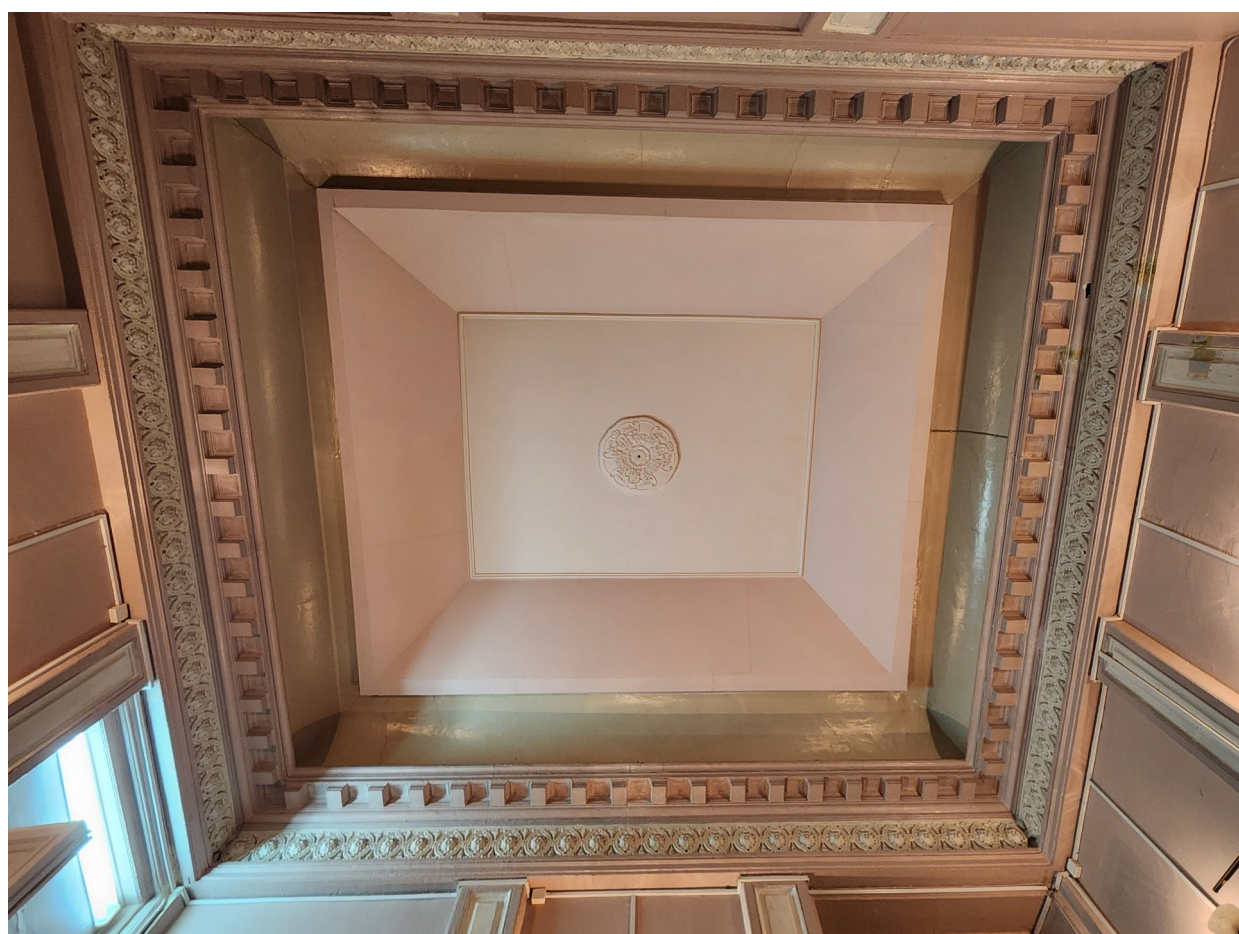
Фото 11. Лестница вестибюля. Потолок.
