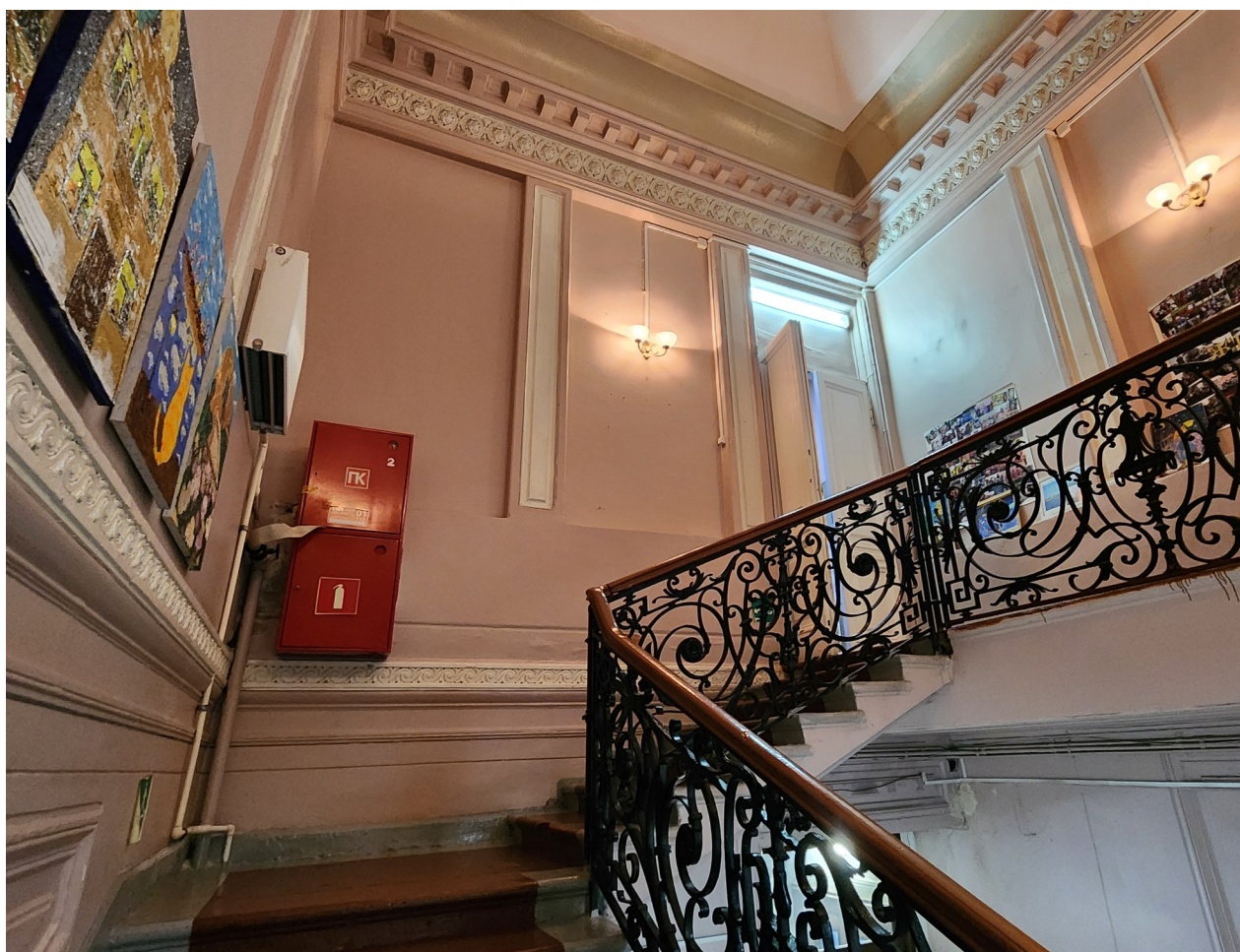
Фото 7. Лестница вестибюля. Вид на север.
