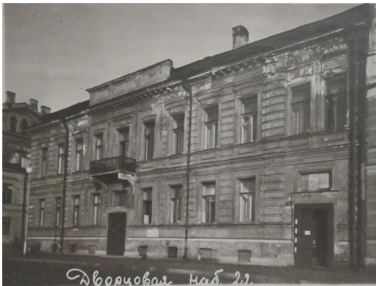
Рисунок 42. Дворцовая набережная. Дом №22. Фасад дома. После 1945 г. (год поступления снимка в Архив 1960 г.). Гр-744559.
