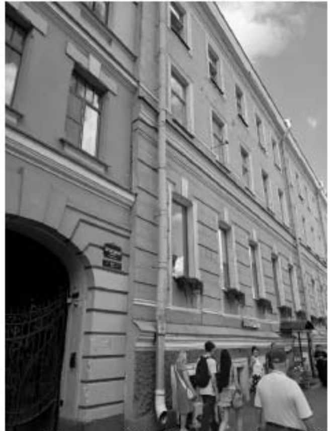
39. «Дом, в котором в 1908 -1915 гг. жил актер Варламов К.А.» (Загородный пр., д. 13, лит. А). Лицевой фасад по Загородному пр. (фрагмент). Фото мест установки оборудования и прокладки кабельных трасс. Штиглиц М.С. 05.08.2025.
