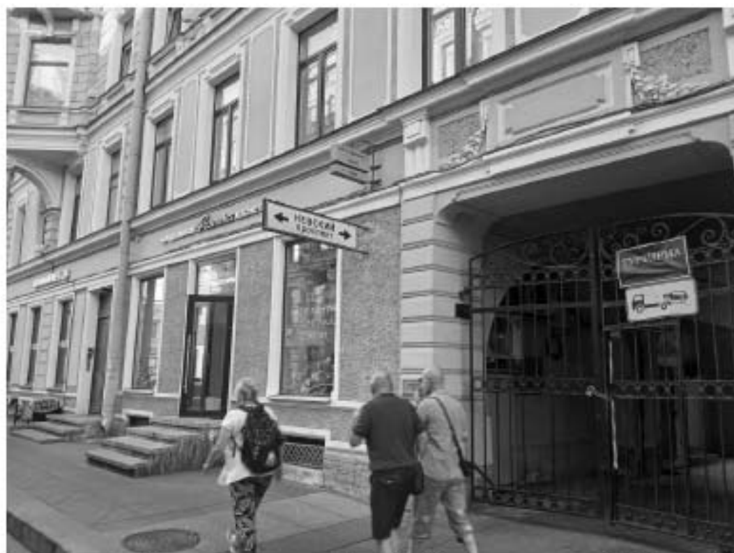
51. «Дом Меншиковых (Русско-Азиатского банка)» (Караванная ул., д. 11/64, лит. А). Лицевой фасад по ул. Караванная (фрагмент). Фото мест установки оборудования и прокладки кабельных трасс. Штиглиц М.С. 05.08.2025.
