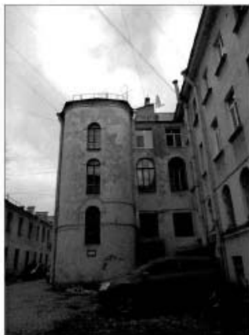
6. "Дом Кукановой А. (Кладов Л.М.)". Западный фасад южного дворового корпуса.
