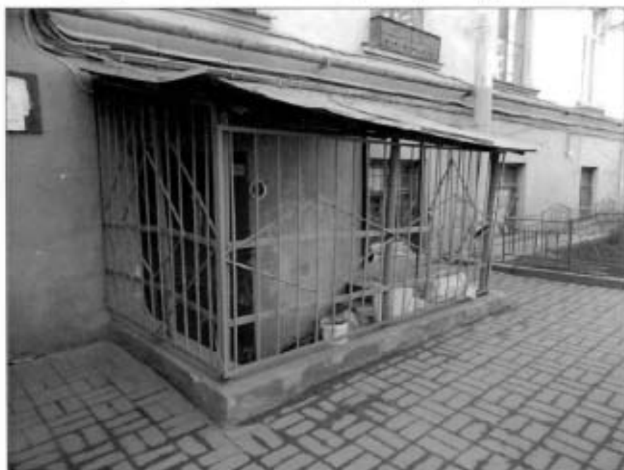
16. "Дом Кукиной А. (Клад ЛМ)". Дворовый фасад нижнего корпуса по Горьковской ул. Прямик.
