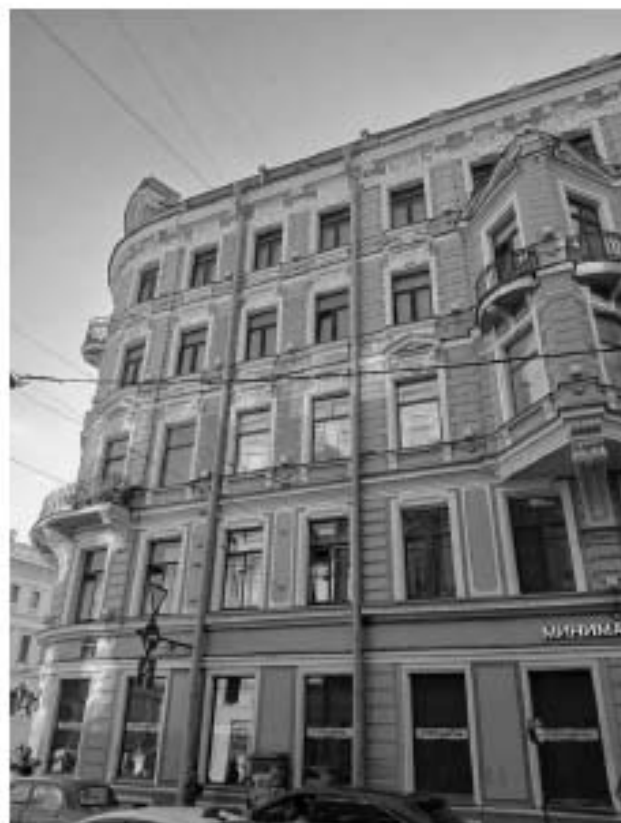
49. «Дом Меншиковых (Русско-Азиатского банка)» (Караванная ул., д. 11/64, лит. А). Лицевой фасад по ул. Караванная (фрагмент). Фото мест установки оборудования и прокладки кабельных трасс. Штиглиц М.С. 05.08.2025.
