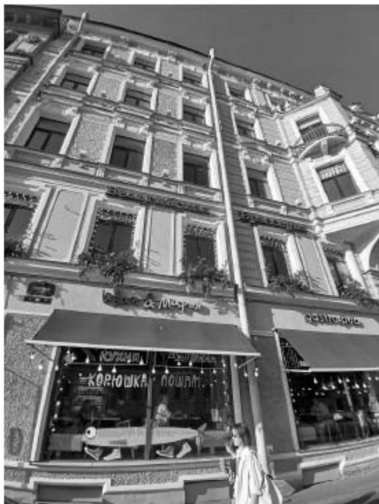
57. «Дом Меншиковых (Русско-Азиатского банка)» (Караванная ул., д. 11/64, лит. А). Лицевой фасад по Невскому пр. (фрагмент). Фото мест установки оборудования и прокладки кабельных трасс. Штиглиц М.С. 05.08.2025.
