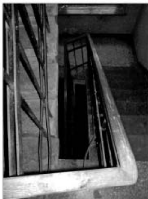
25. Двухмаршевая лестница (отдельностоящий дворовый флигель)
