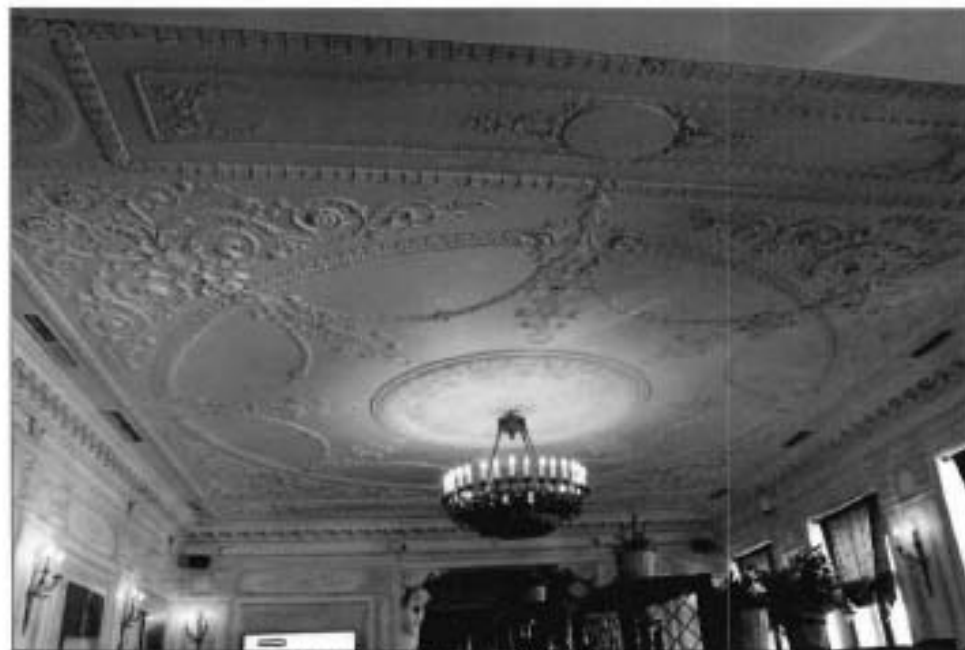
Фото №3, 4. Помещение 58-Н (1) 2-го этажа.
