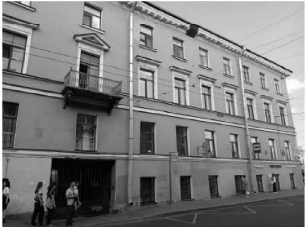
34. «Дом Куканой А. (Кладо Л.М.)» (Гороховая ул., д. 50, лит. А). Лицевой фасад по ул. Гороховая(фрагмент). Фото мест установки оборудования и прокладки кабельных трасс. Штиглиц М.С. 05.08.2025.
