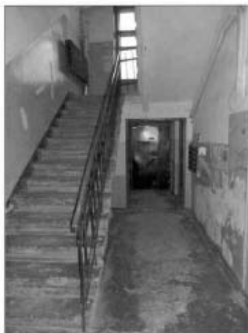
24. Двухмаршевая лестница (отдельностоящий дворовый флигель)
