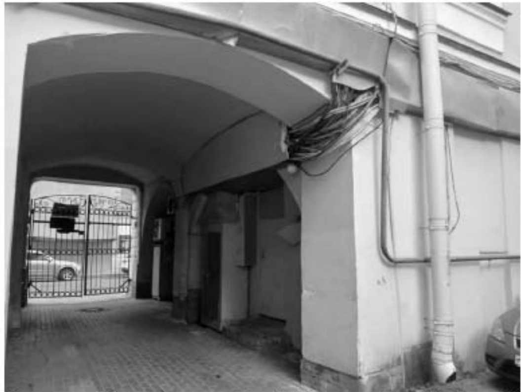
53. «Дом Меншиковых (Русско-Азиатского банка)» (Караванная ул., д. 11/64, лит. А). Дворовые фасады. Фото мест установки оборудования и прокладки кабельных трасс. Штиглиц М.С. 05.08.2025.
