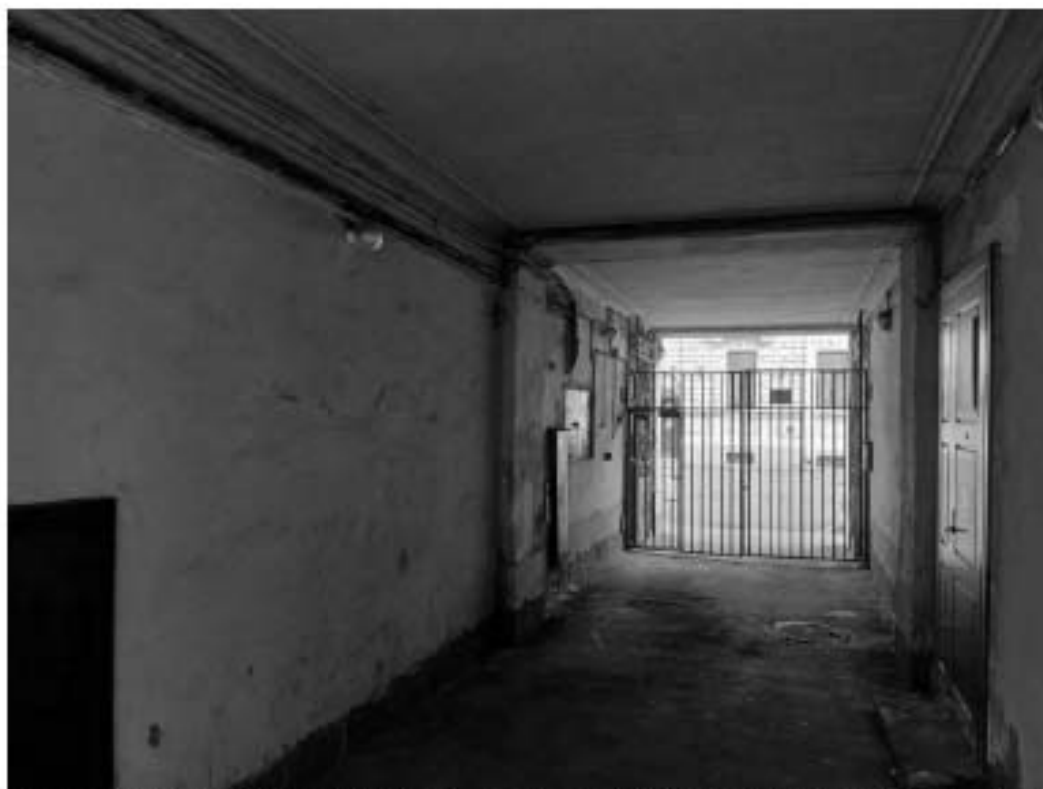
17. «Дом А.Г. Романова». (Виленский пер., д. 3, лит. А). Арочный проезд. Фото мест установки оборудования и прокладки кабельных трасс. Штиглиц М.С. 05.08.2025.
