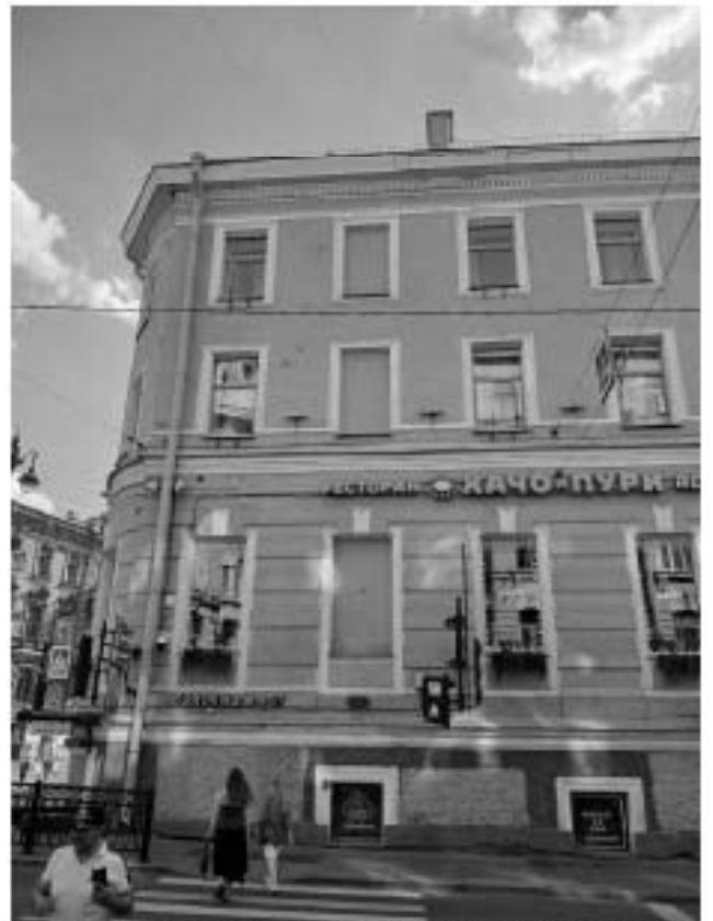
38. «Дом, в котором в 1908 -1915 гг. жил актер Варламов К.А.». (Загородный пр., д. 13, лит. А). Лицевой фасад по ул. Ломоносова (фрагмент). Фото мест установки оборудования и прокладки кабельных трасс. Штиглиц М.С. 05.08.2025.
