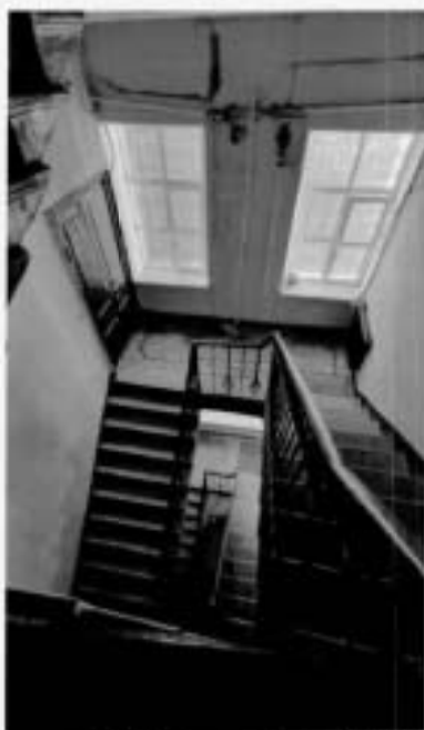
4. Лестница Л-1 (Фотография от 24.05.2024).
