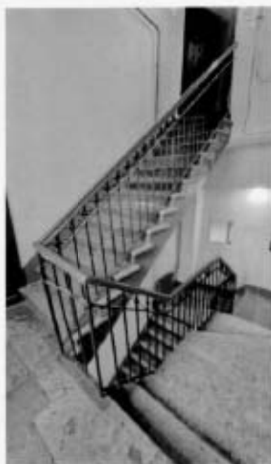
5. Лестница Л-2 (Фотография от 24.05.2024).
