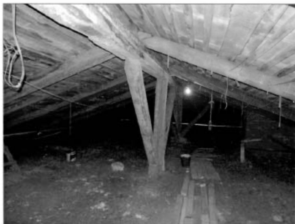
19. Отдельностоящий дворовый флигель. Стропильная система.
