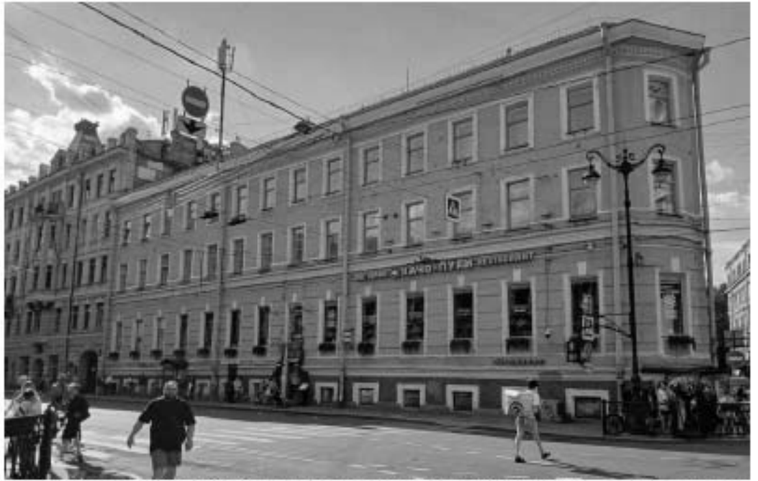
37. «Дом, в котором в 1908 -1915 гг. жил актер Варламов К.А.». (Загородный пр., д. 13, лит. А). Лицевой фасад по Загородному пр. Штиглиц М.С. 05.08.2025.
