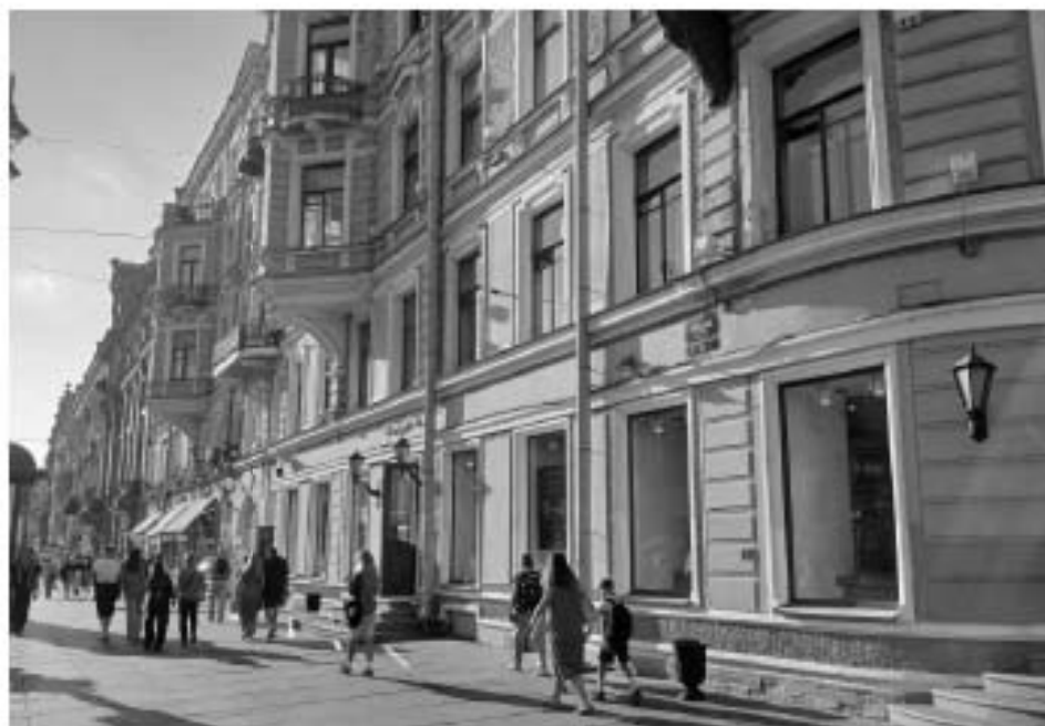
55. «Дом Меншиковых (Русско-Азиатского банка)» (Караванная ул., д. 11/64, лит. А). Лицевой фасад по Невскому пр. (фрагмент). Фото мест установки оборудования и прокладки кабельных трасс. Штиглиц М.С. 05.08.2025.
