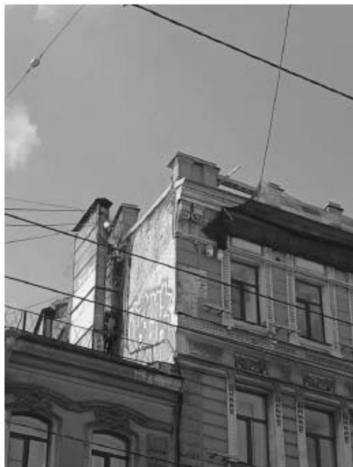
23. «Здание, где размещался ресторан "К.П.Паткин"» (Владимирский пр., д. 1/47, лит. Б). Лицевой фасад по Владимирскому пр. (фрагмент). Фото мест установки оборудования и прокладки кабельных трасс. Штиглиц М.С. 05.08.2025.
