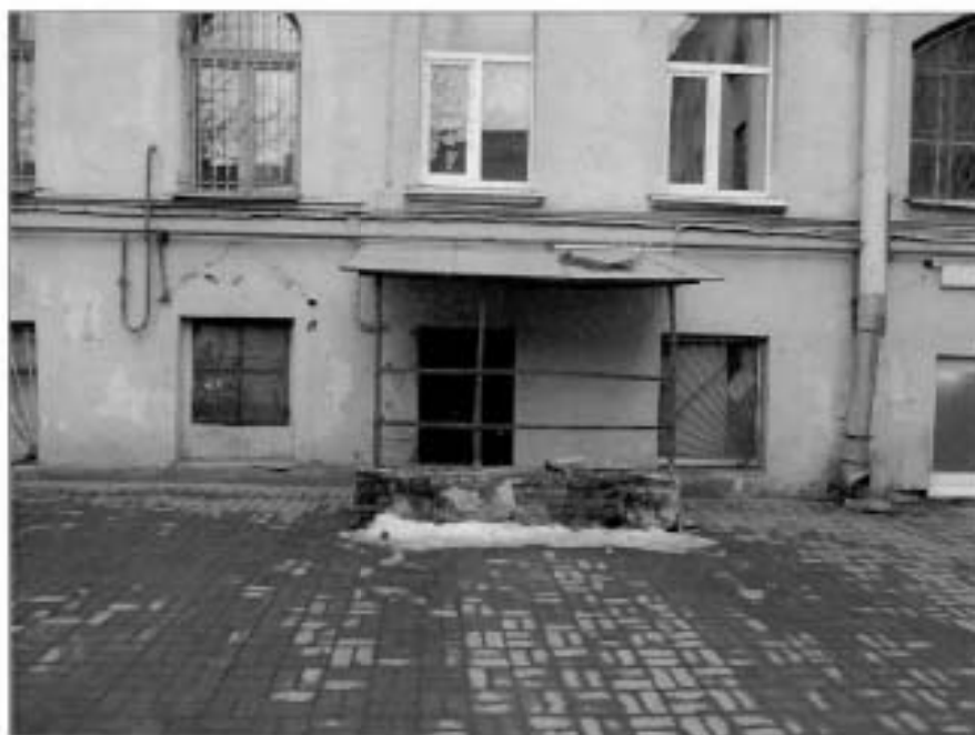
14. "Дом Кузановой А. (Клад Л.М.)". Дворовой фасад лицевого корпуса по наб. р. Фонтанки. Прямок.
