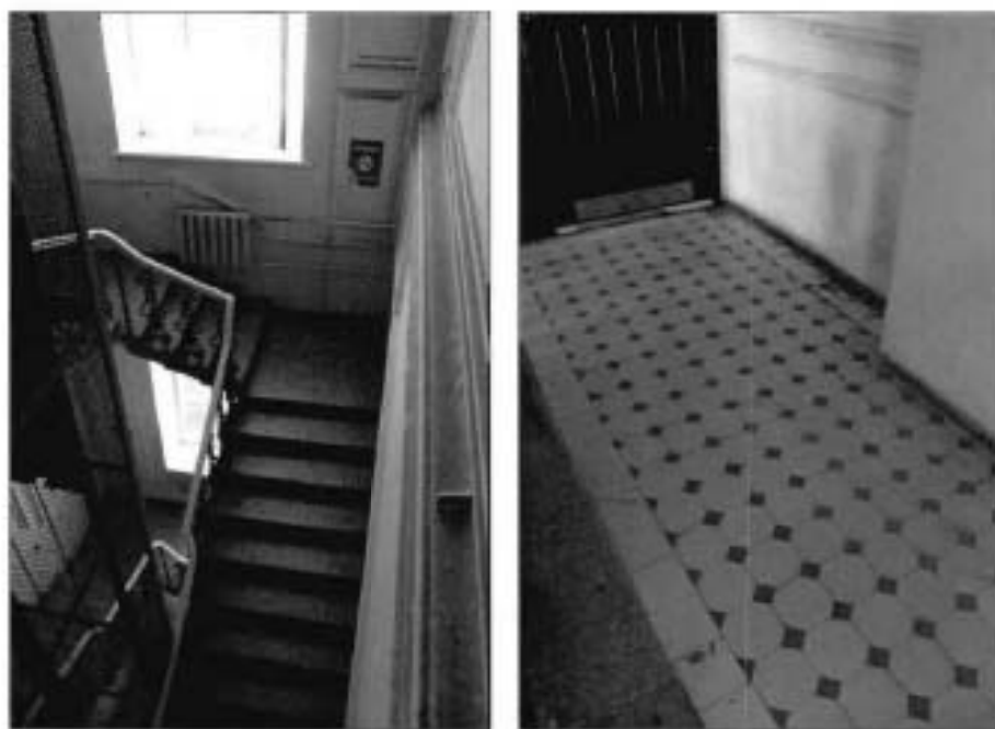
Фото №11, 12. Межэтажная трехмаршевая лестница (2ЛК).
