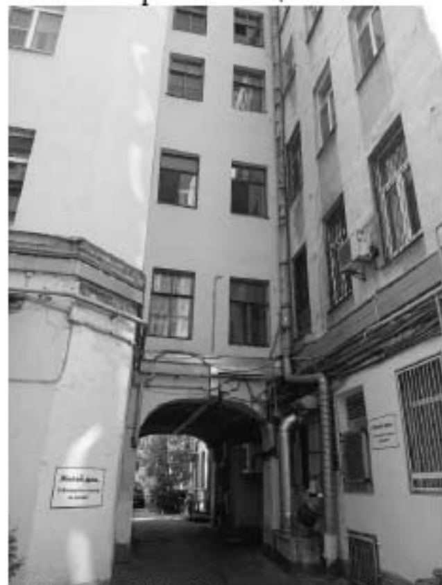
46. «Дом, где в 1865-1928 гг. жил композитор Глазунов А.К.» (Казанская ул., д. 8-10, лит. А). Дворовые фасады. Фото мест установки оборудования и прокладки кабельных трасс. Штиглиц М.С. 05.08.2025.
