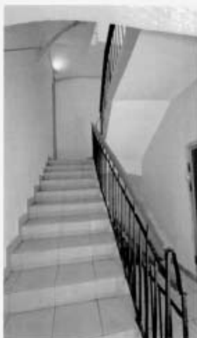
6. Лестница Л-3 (Фотография от 24.05.2024).
