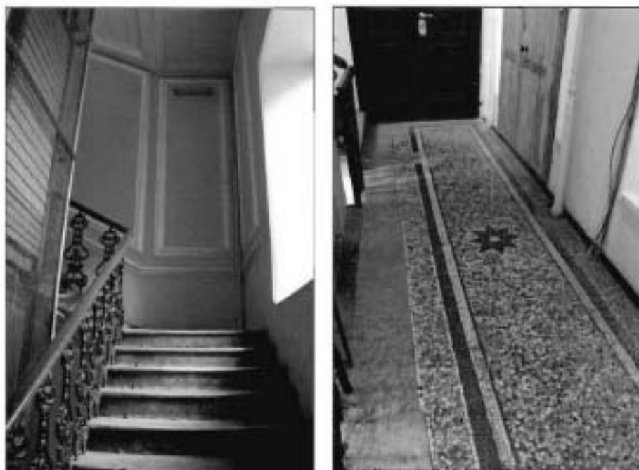
Фото №9, 10. Межэтажная трехмаршевая лестница (1ЛК).
