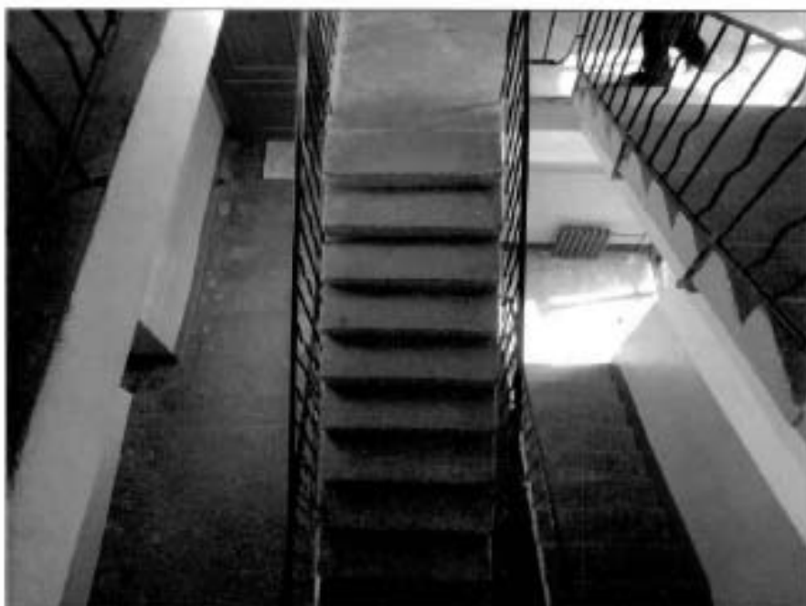
22. Двухмаршевая лестница (лицевой корпус по Гороховой улице).
