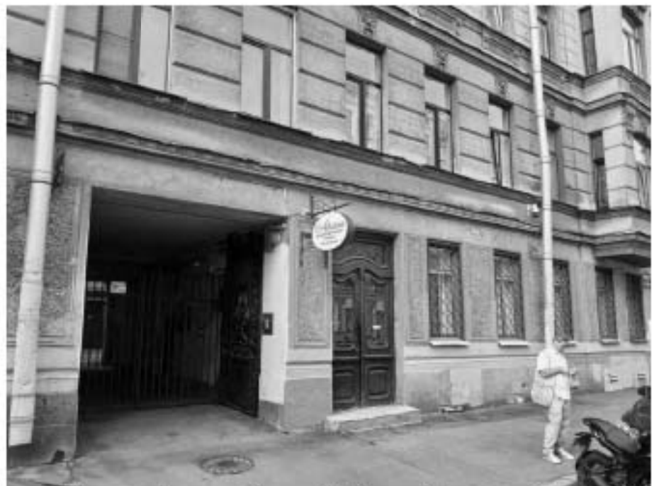
16. «Дом А.Г. Романова». (Виленский пер., д. 3, лит. А). Лицевой фасад по Виленскому пер. (фрагмент). Фото мест установки оборудования и прокладки кабельных трасс. Штиглиц М.С. 05.08.2025.
