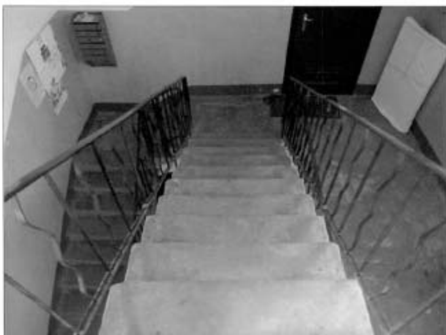
23. Двухмаршевая лестница (лицевой корпус по Гороховой улице).
