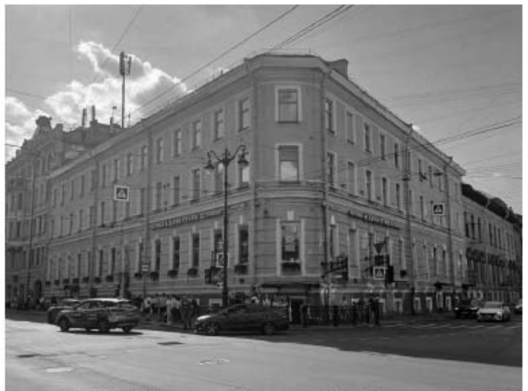
36. «Дом, в котором в 1908 -1915 гг. жил актер Варламов К.А.» (Загородный пр., д. 13, лит. А). Лицевой фасад по Загородному пр. Штиглиц М.С. 05.08.2025.
