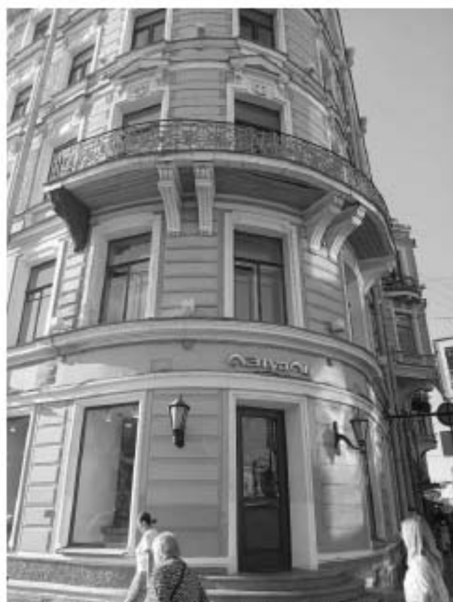
56. «Дом Меншиковых (Русско-Азиатского банка)» (Караванная ул., д. 11/64, лит. А). Лицевой фасад по Невскому пр. (фрагмент). Фото мест установки оборудования и прокладки кабельных трасс. Штиглиц М.С. 05.08.2025.
