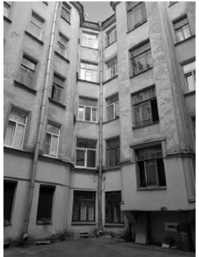
15. «Дом А.Г. Романова». (Виленский пер., д. 3, лит. А). Дворовые фасады. Фото мест установки оборудования и прокладки кабельных трасс. Штиглиц М.С. 05.08.2025.
