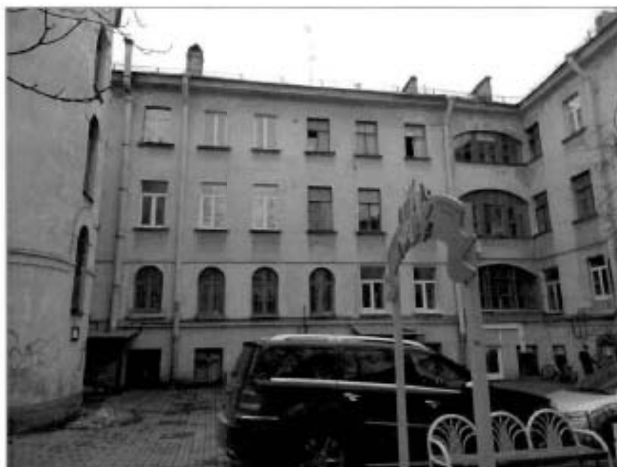
5. "Дом Кукановой А. (Кладов Л.М.)". Южный дворовый фасад. Фрагмент.
