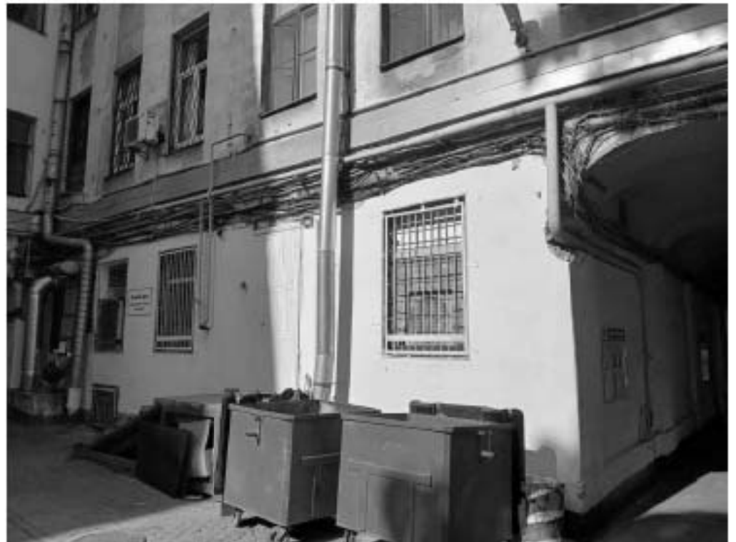
43. «Дом, где в 1865-1928 гг. жил композитор Глазунов А.К.» (Казанская ул., д. 8-10, лит. А). Дворовые фасады. Фото мест установки оборудования и прокладки кабельных трасс. Штиглиц М.С. 05.08.2025.
