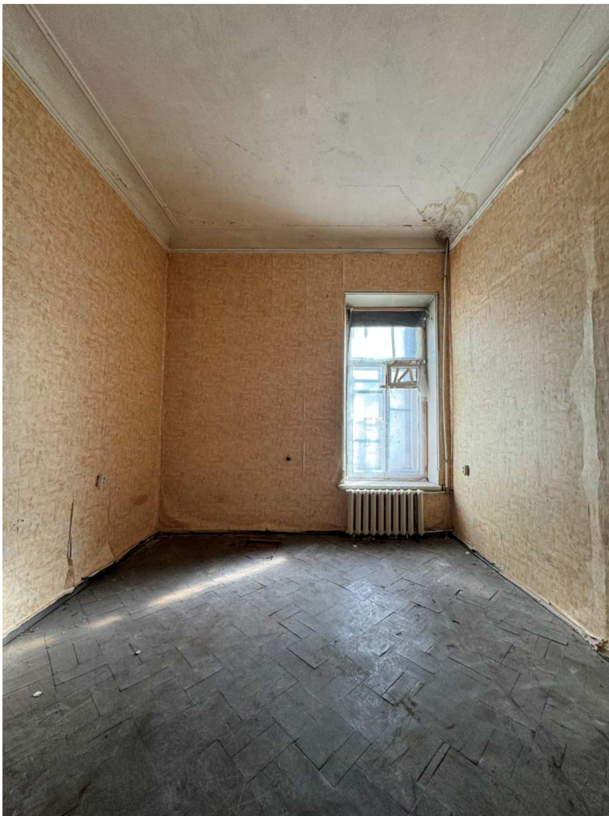
Фото 49. Вид на помещение квартиры № 17 объекта культурного наследия.
