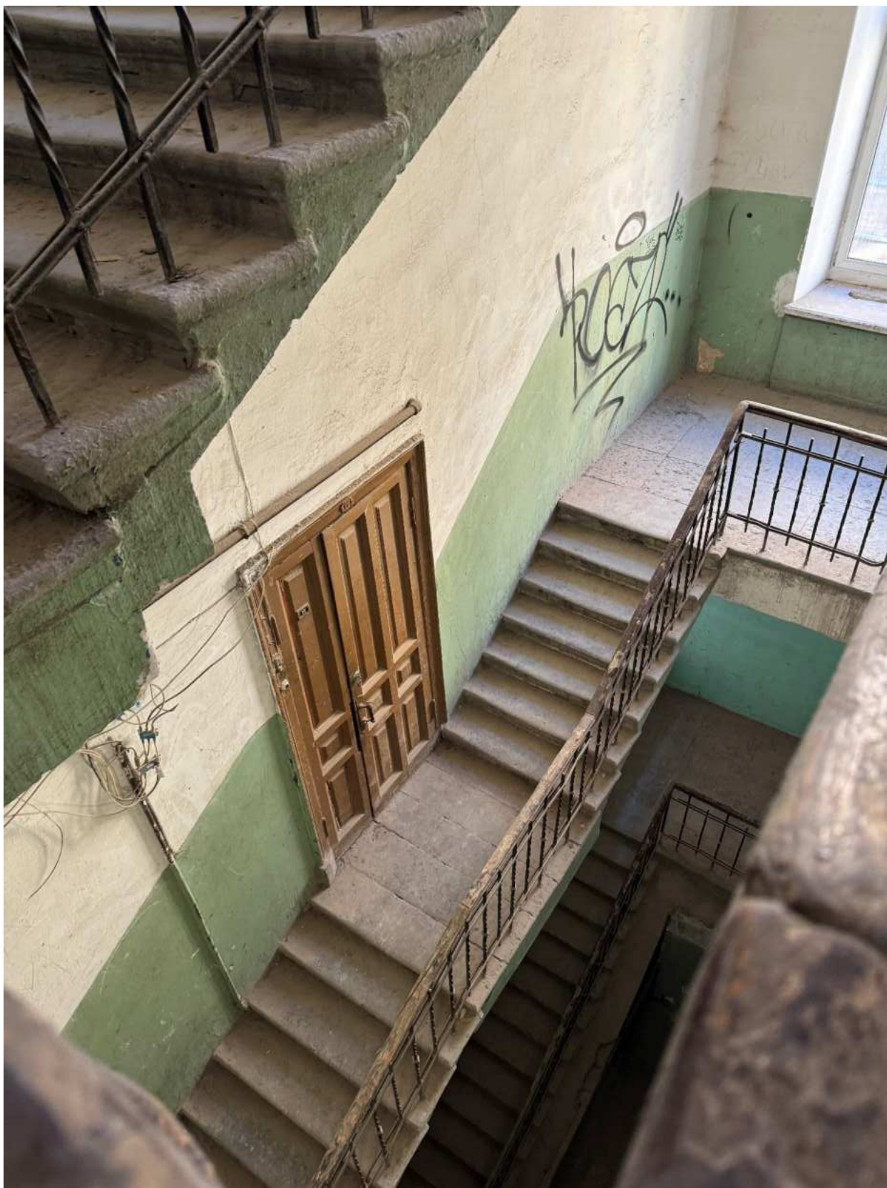
Фото 55. Вид на лестницу 5-ЛК объекта культурного наследия.
