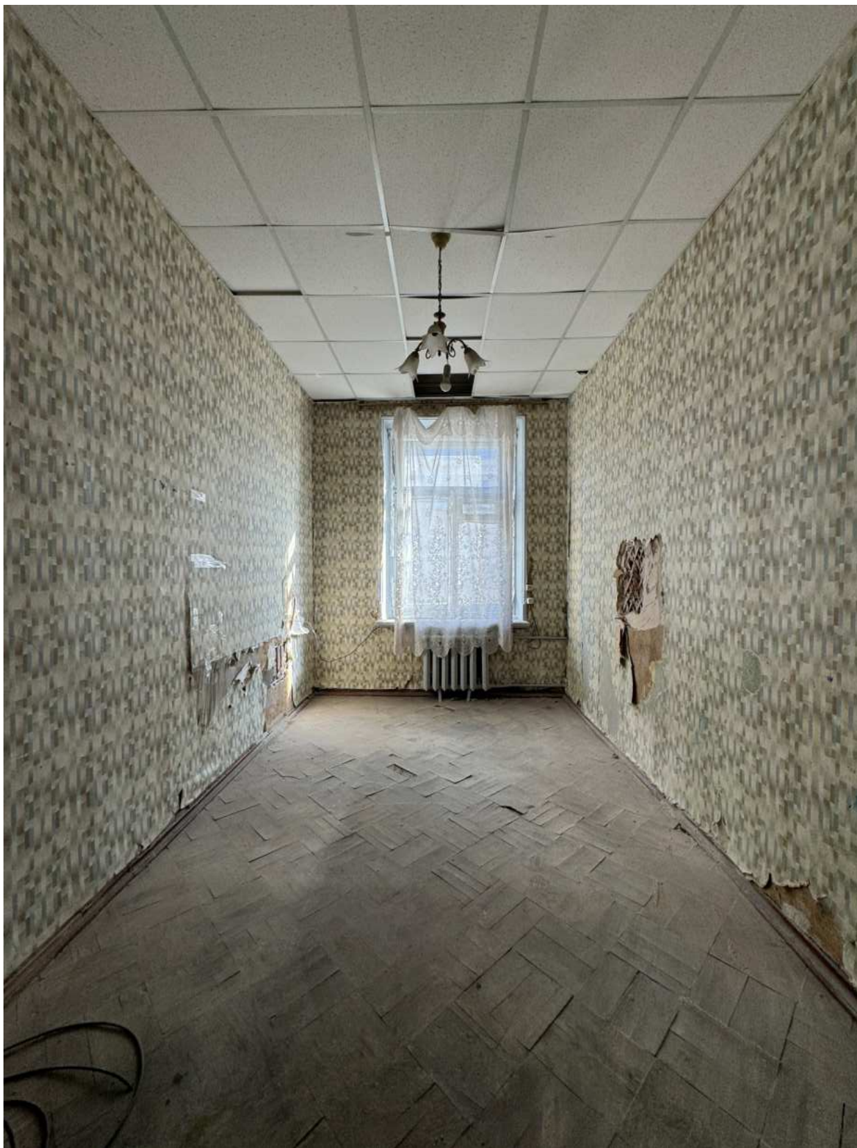
Фото 129. Вид на помещение квартиры № 16 объекта культурного наследия.
