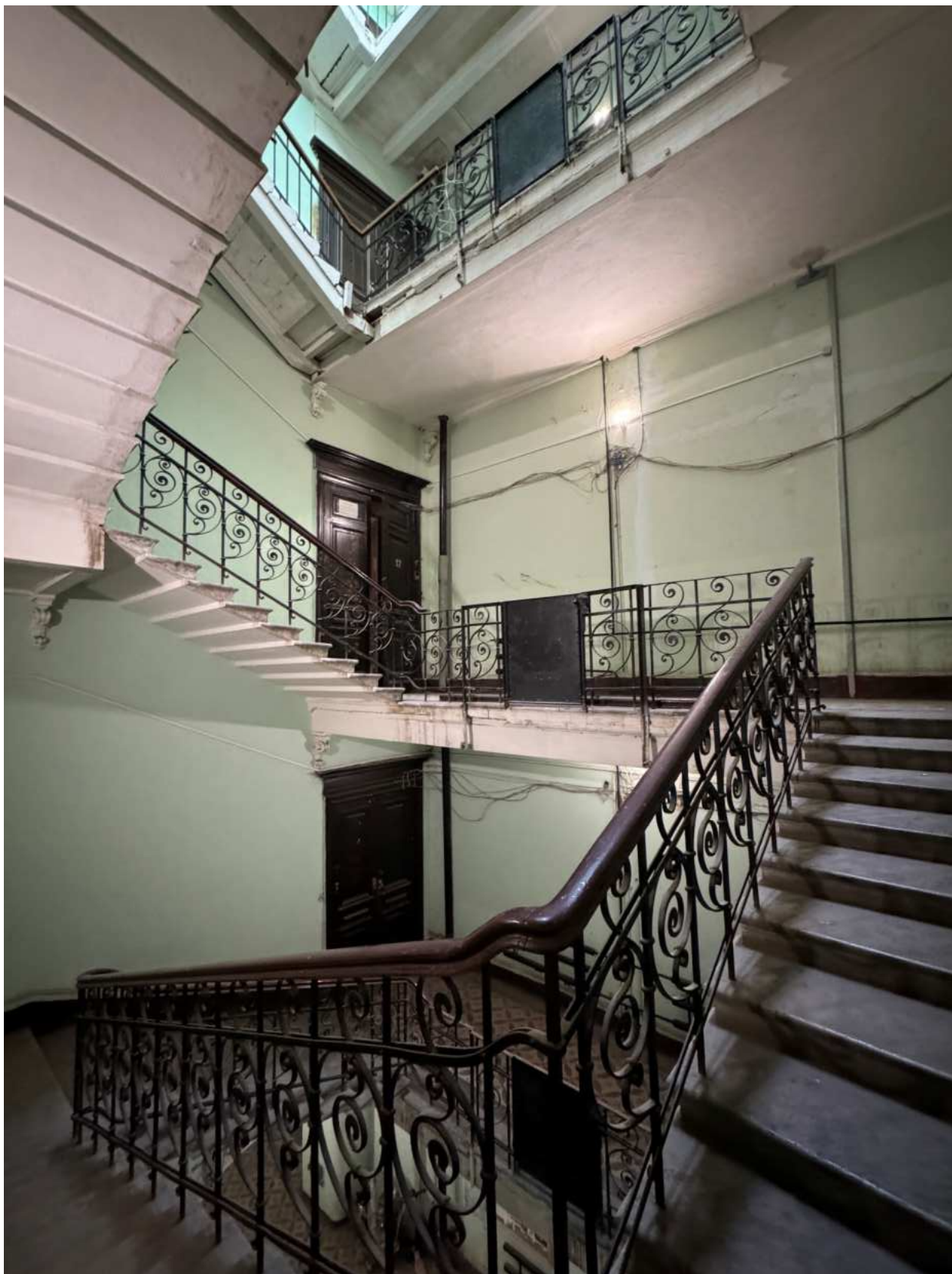
Фото 26. Вид на лестницу 1-ЛК объекта культурного наследия.
