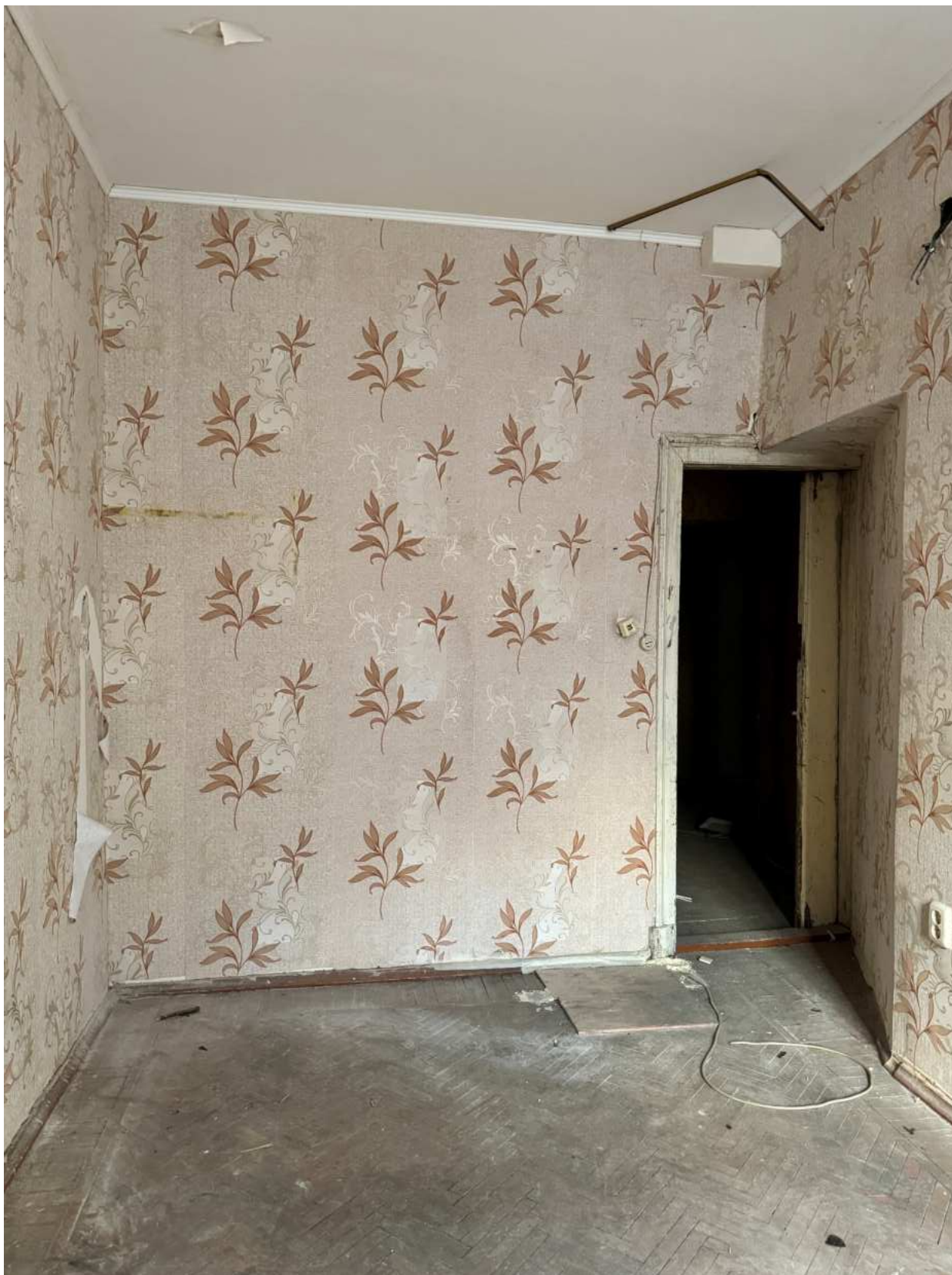
Фото 71. Вид на помещение квартиры № 11 объекта культурного наследия.
