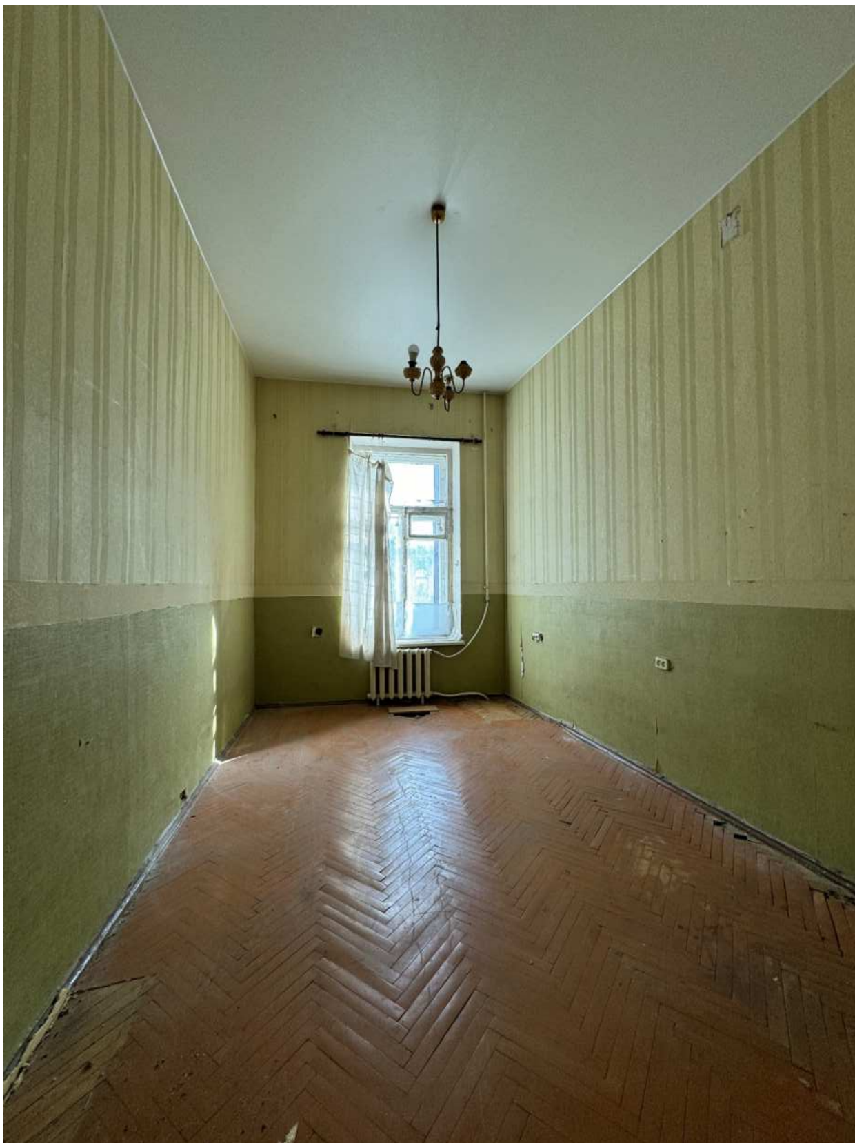
Фото 29. Вид на помещение квартиры № 17 объекта культурного наследия.
