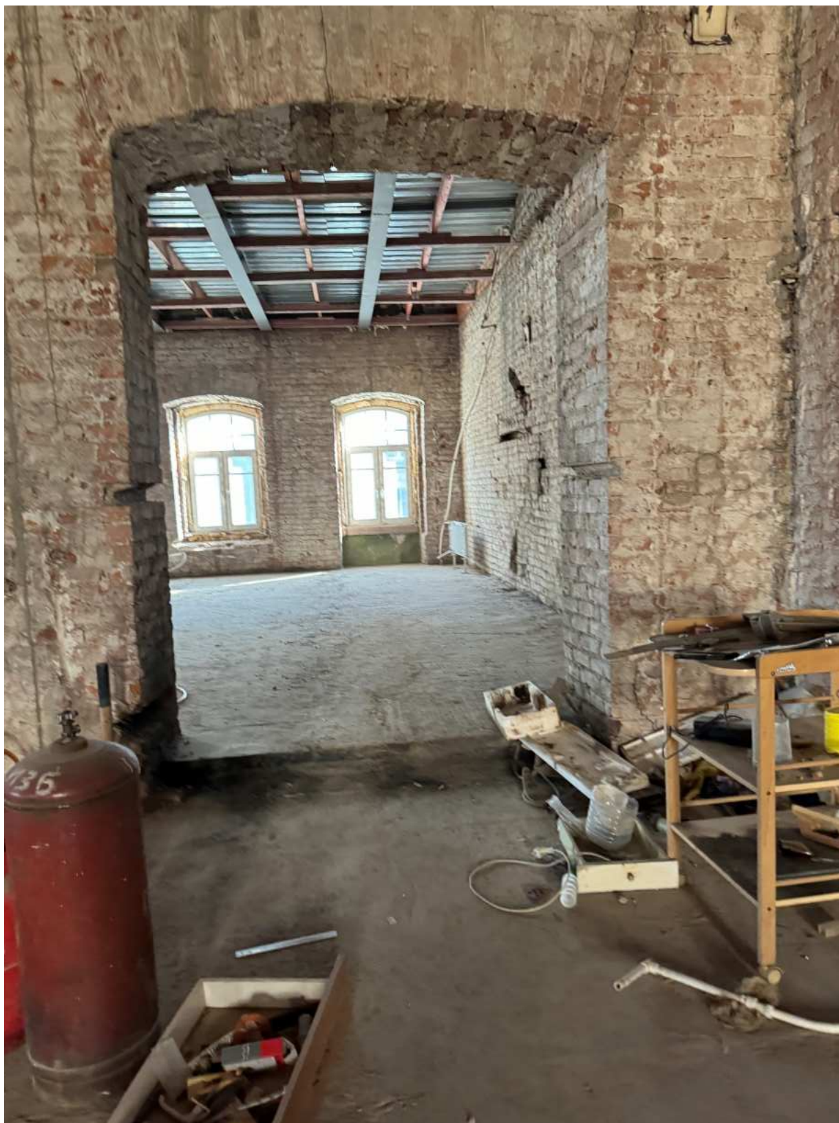
Фото 113. Вид на помещение квартиры № 15 объекта культурного наследия.
