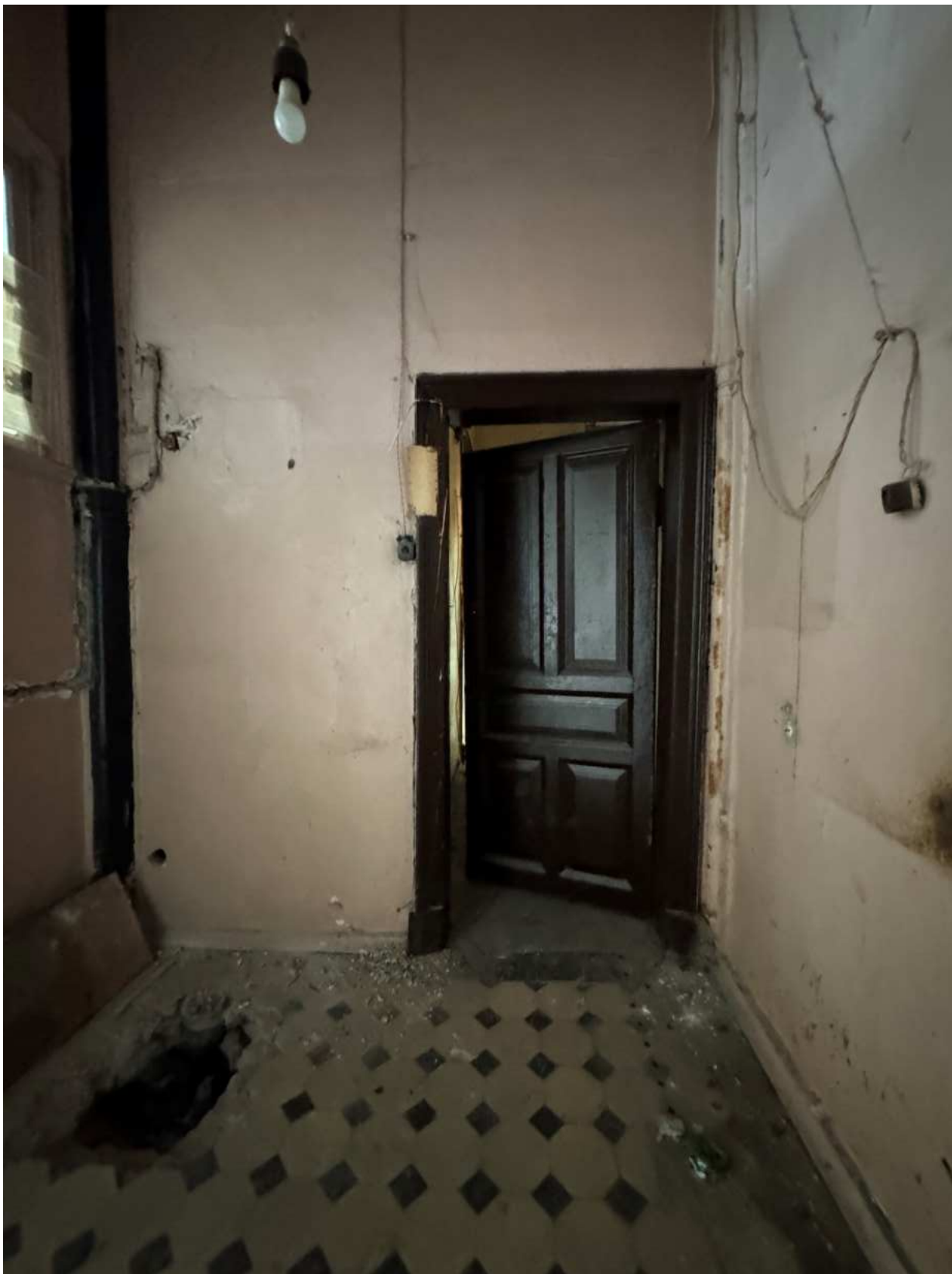
Фото 51. Вид на помещение квартиры № 17 объекта культурного наследия.
