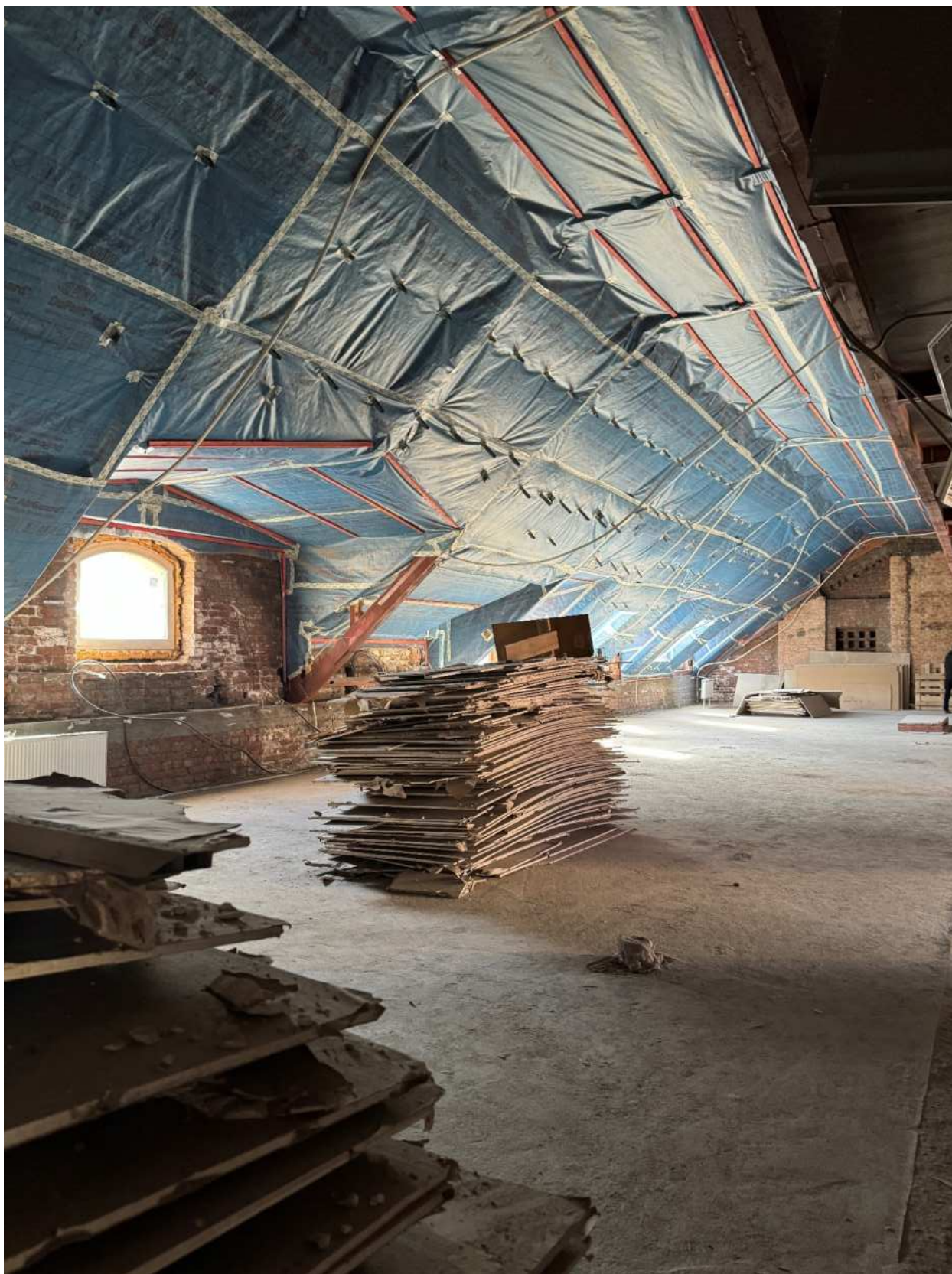
Фото 143. Вид на помещение квартиры № 56 объекта культурного наследия.
