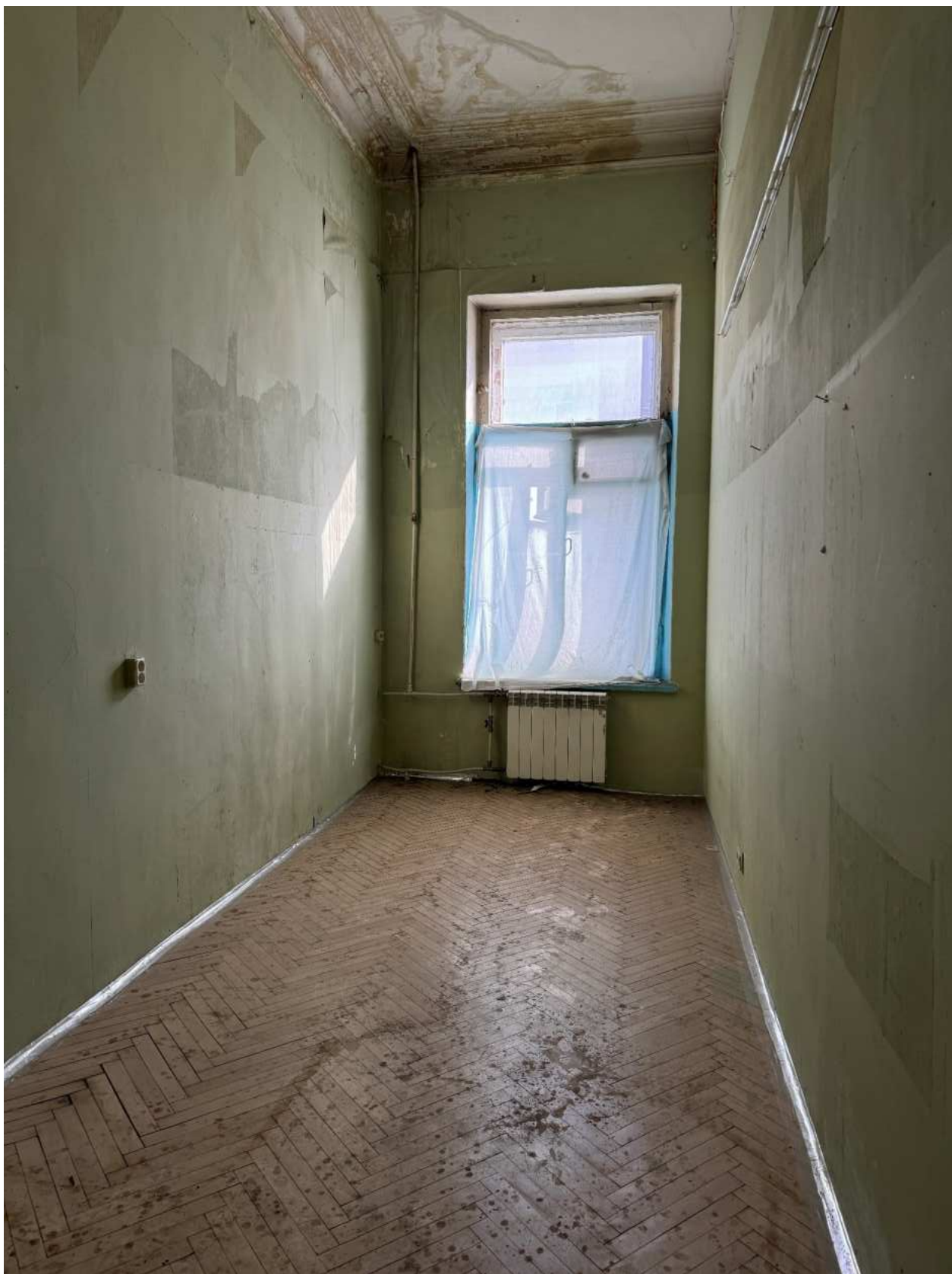
Фото 31. Вид на помещение квартиры № 17 объекта культурного наследия.
