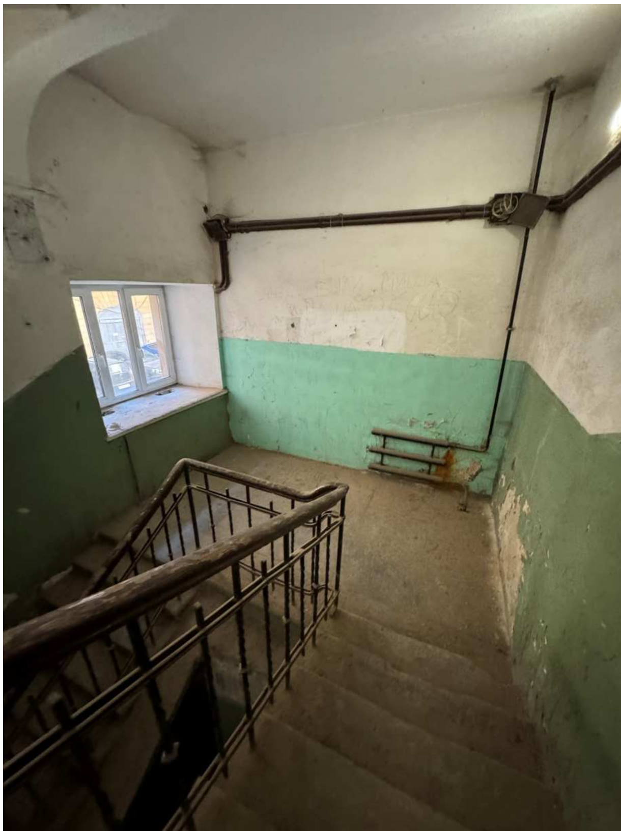
Фото 85. Вид на лестницу 5-ЛК объекта культурного наследия.
