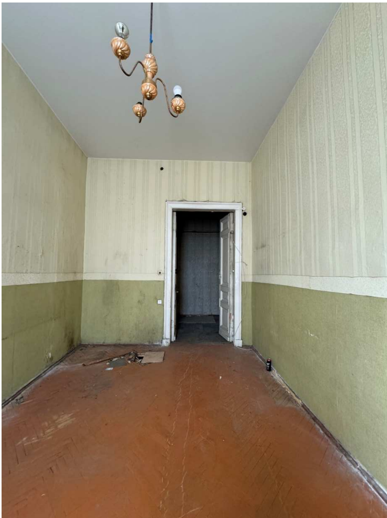
Фото 30. Вид на помещение квартиры № 17 объекта культурного наследия.
