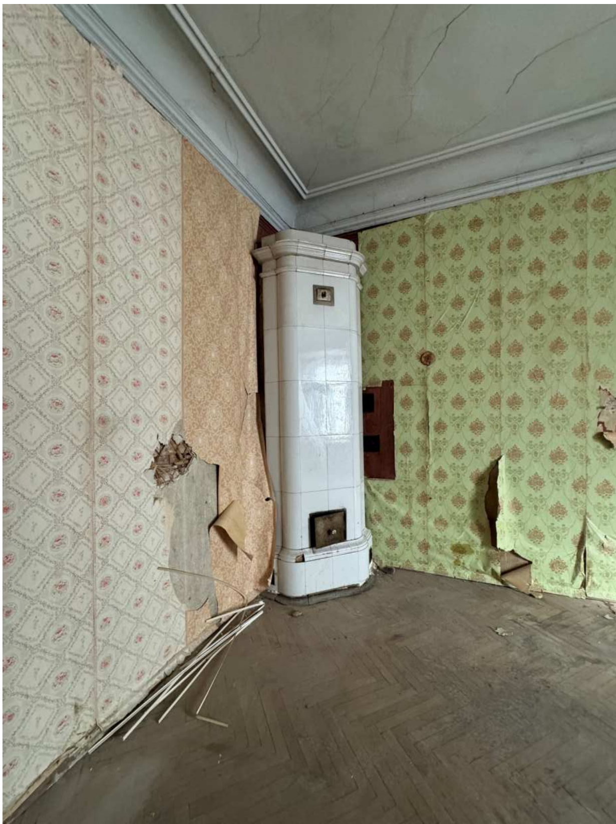
Фото 61. Вид на помещение квартиры № 11 объекта культурного наследия.
