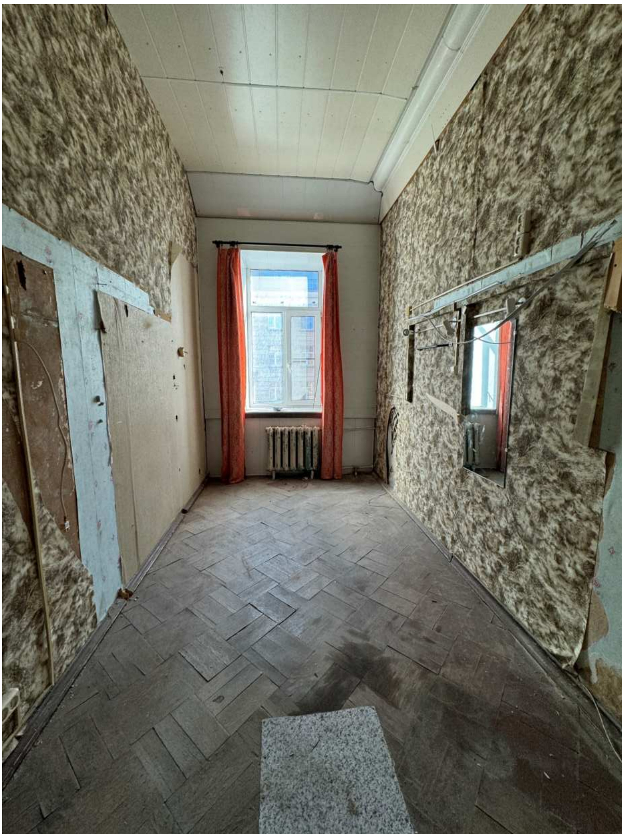
Фото 124. Вид на помещение квартиры № 16 объекта культурного наследия.
