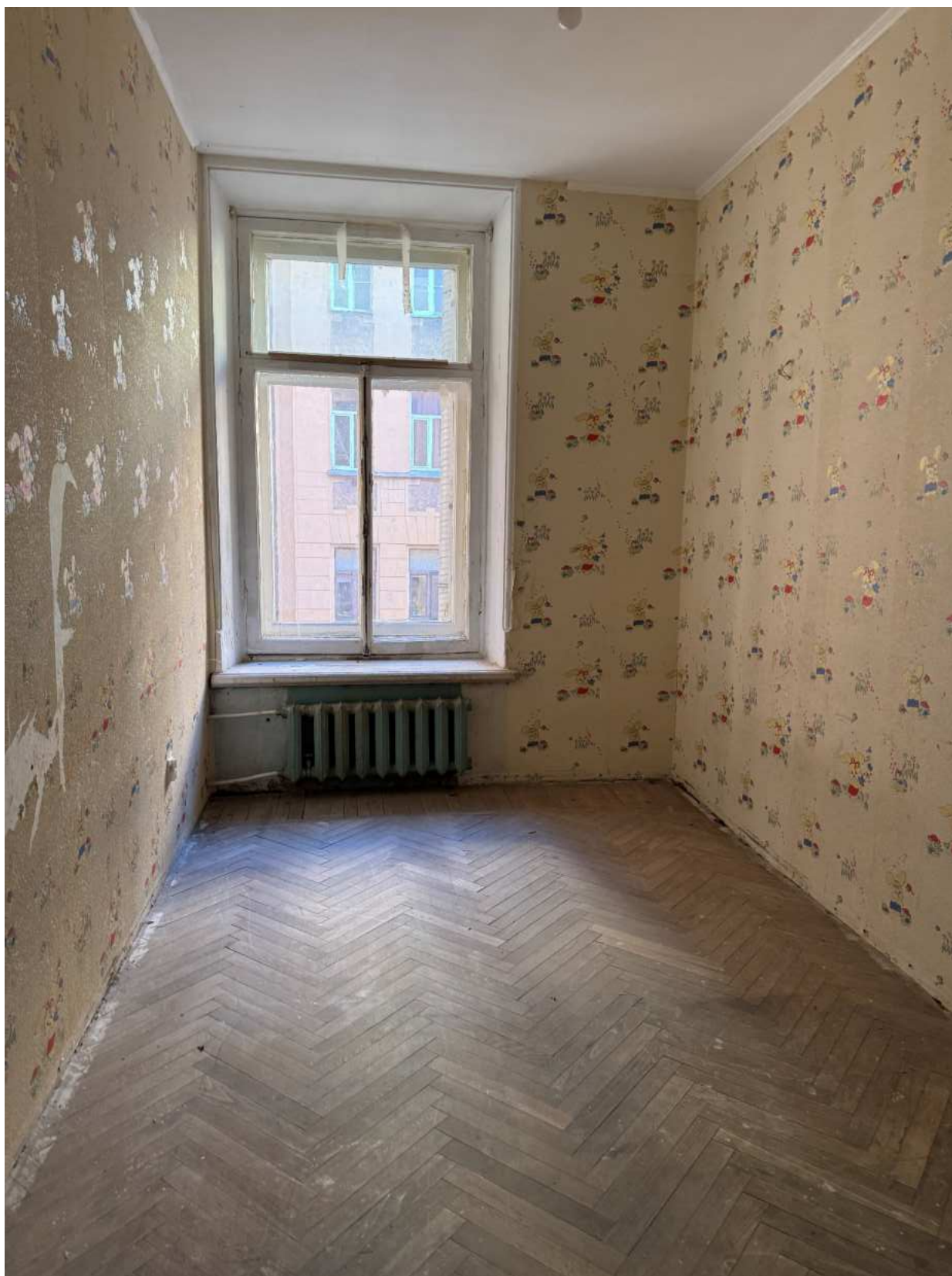
Фото 75. Вид на помещение квартиры № 11 объекта культурного наследия.
