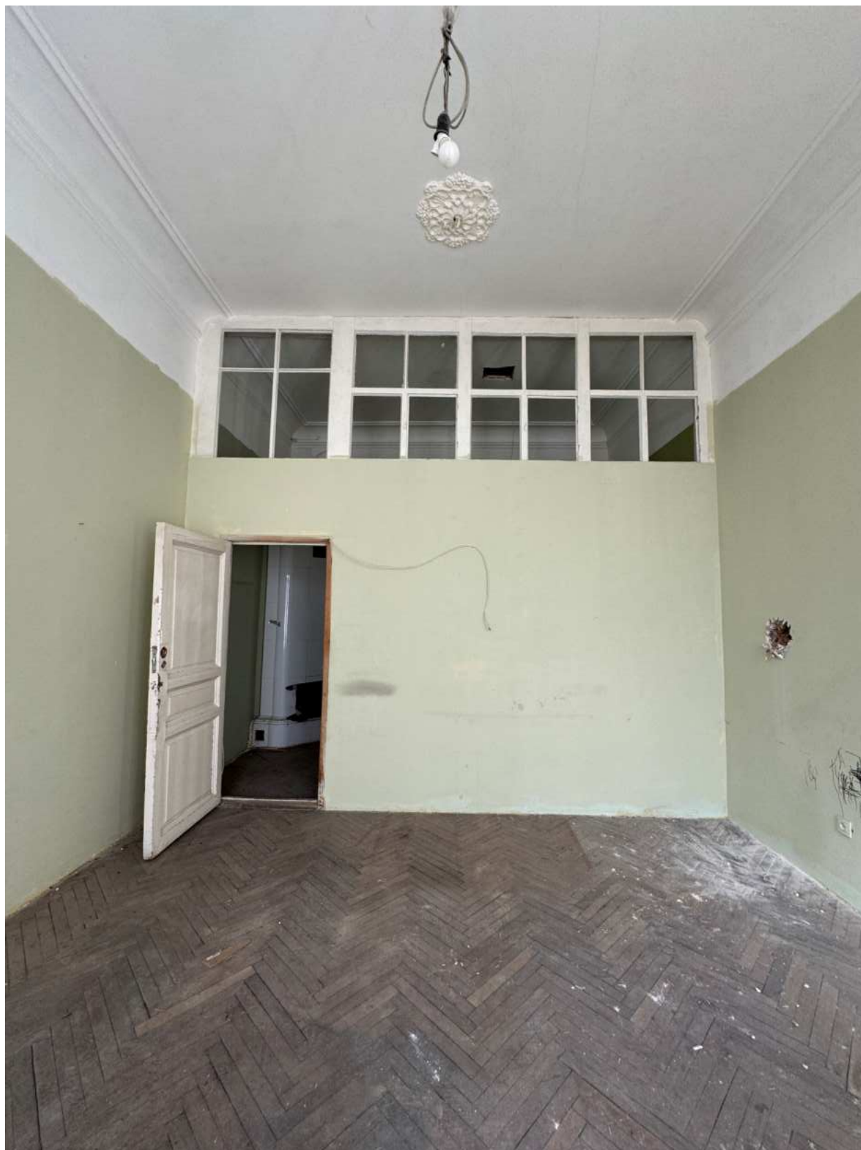
Фото 47. Вид на помещение квартиры № 17 объекта культурного наследия.
