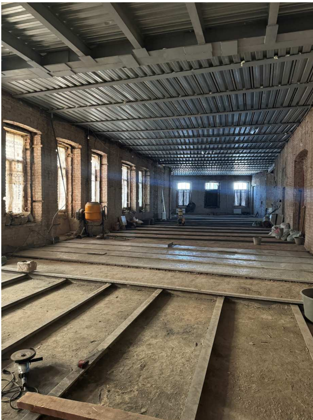
Фото 88. Вид на помещение 8-Н объекта культурного наследия.
