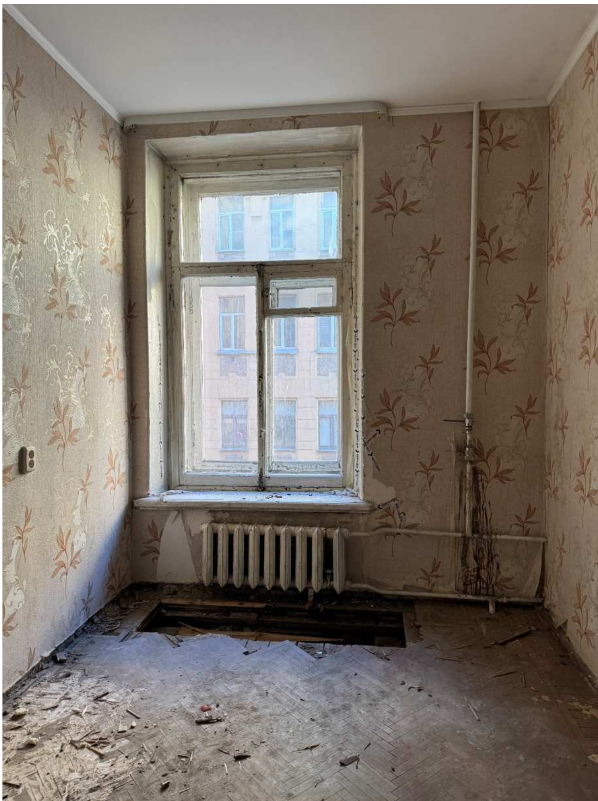
Фото 70. Вид на помещение квартиры № 11 объекта культурного наследия.
