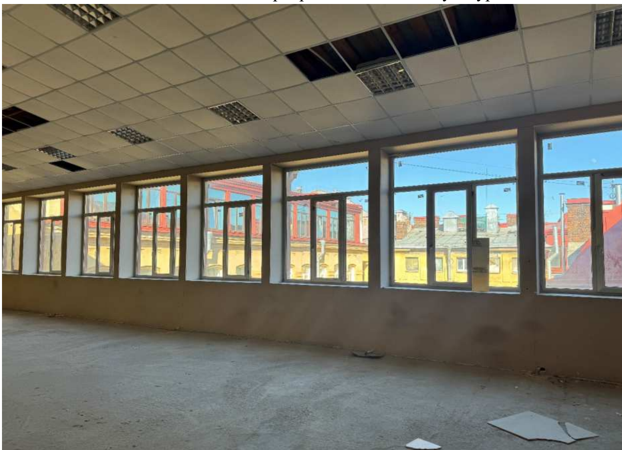
Фото 152. Вид на помещение квартиры № 57 объекта культурного наследия.
