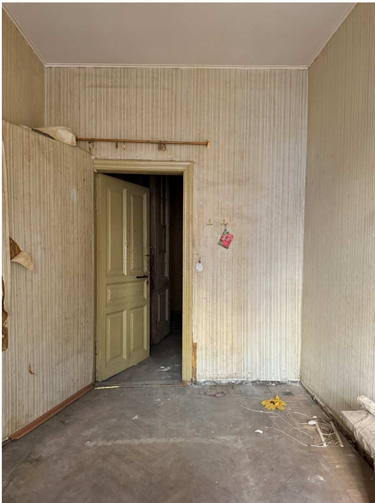
Фото 73. Вид на помещение квартиры № 11 объекта культурного наследия.
