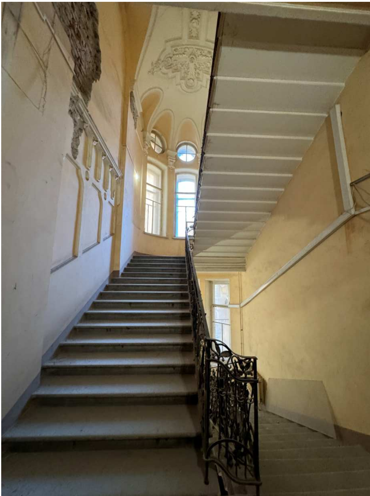
Фото 104. Вид на лестницу 4-ЛК объекта культурного наследия.
