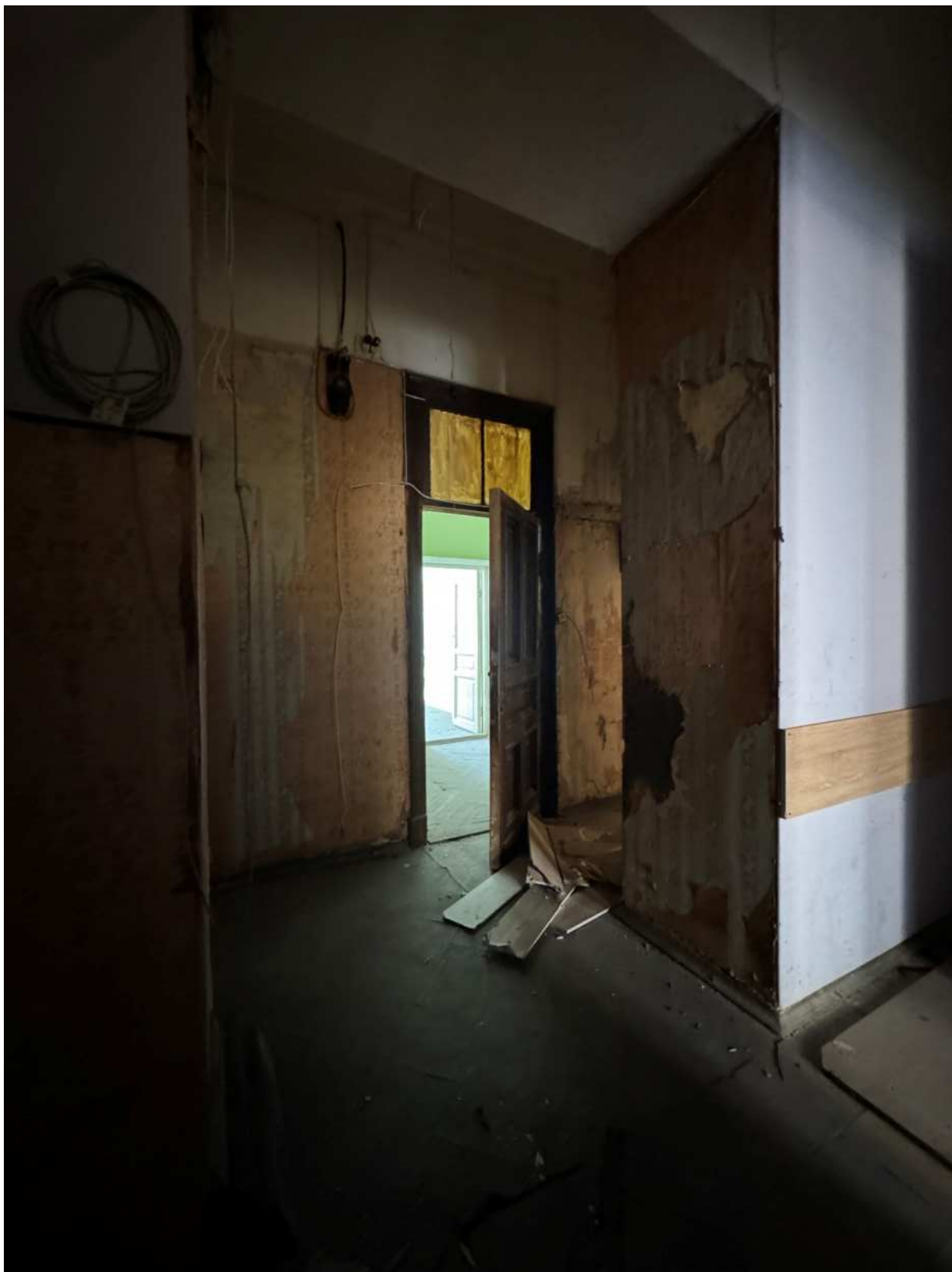
Фото 44. Вид на помещение квартиры № 17 объекта культурного наследия.
