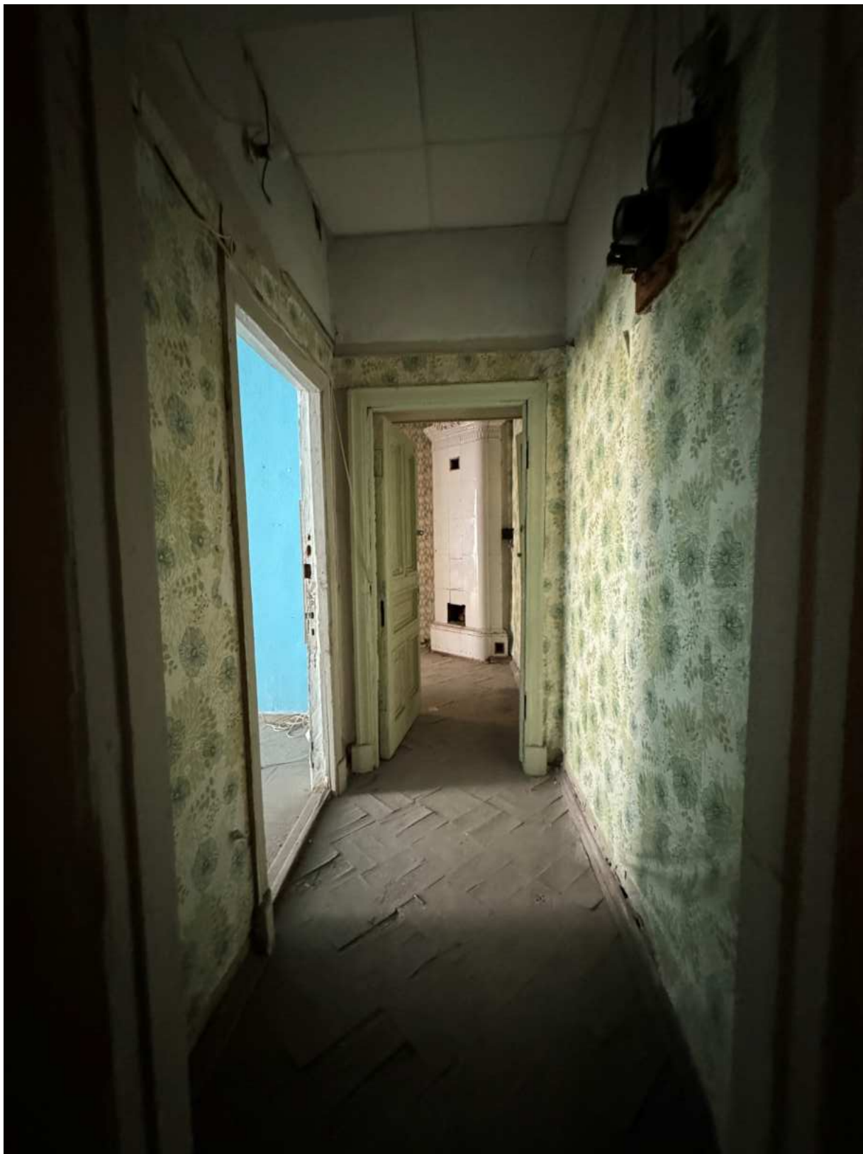
Фото 127. Вид на помещение квартиры № 16 объекта культурного наследия.
