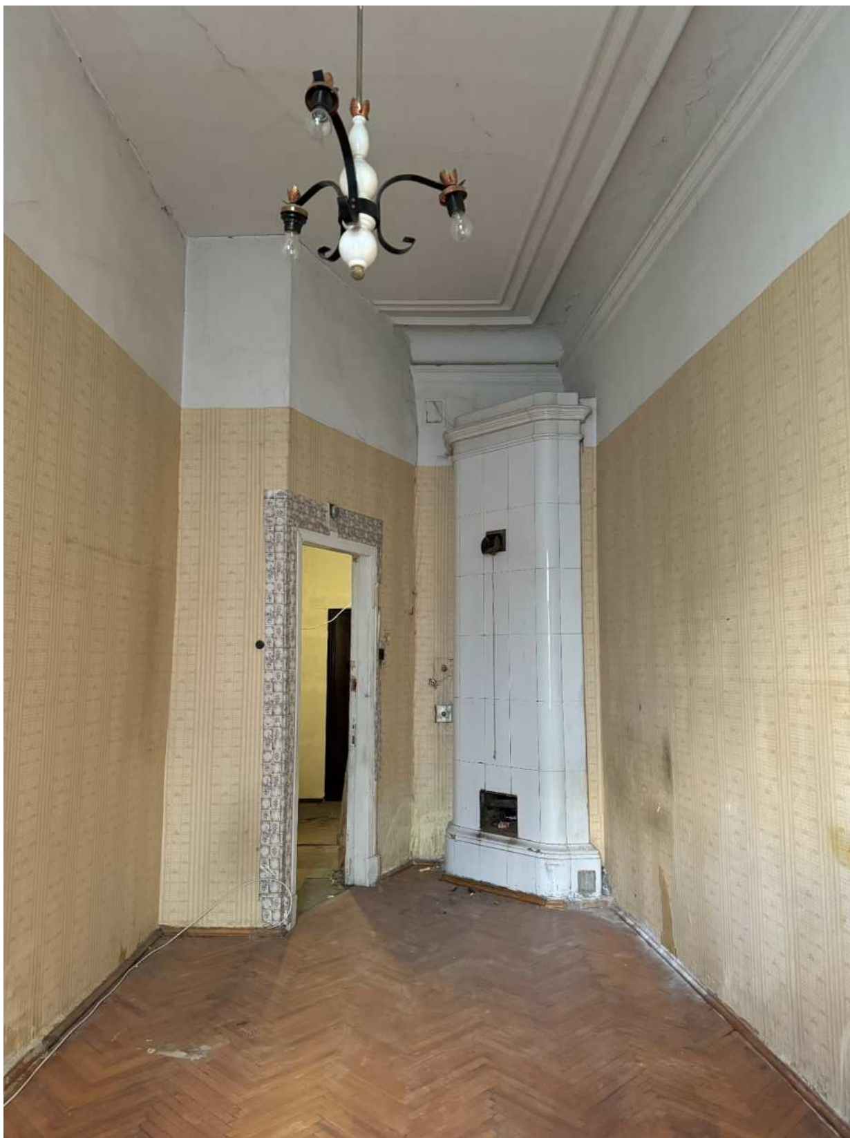
Фото 34. Вид на помещение квартиры № 17 объекта культурного наследия.
