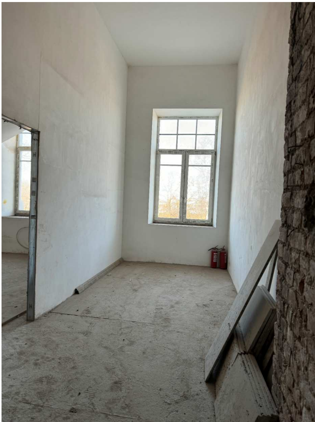
Фото 145. Вид на помещение квартиры № 58 объекта культурного наследия.
