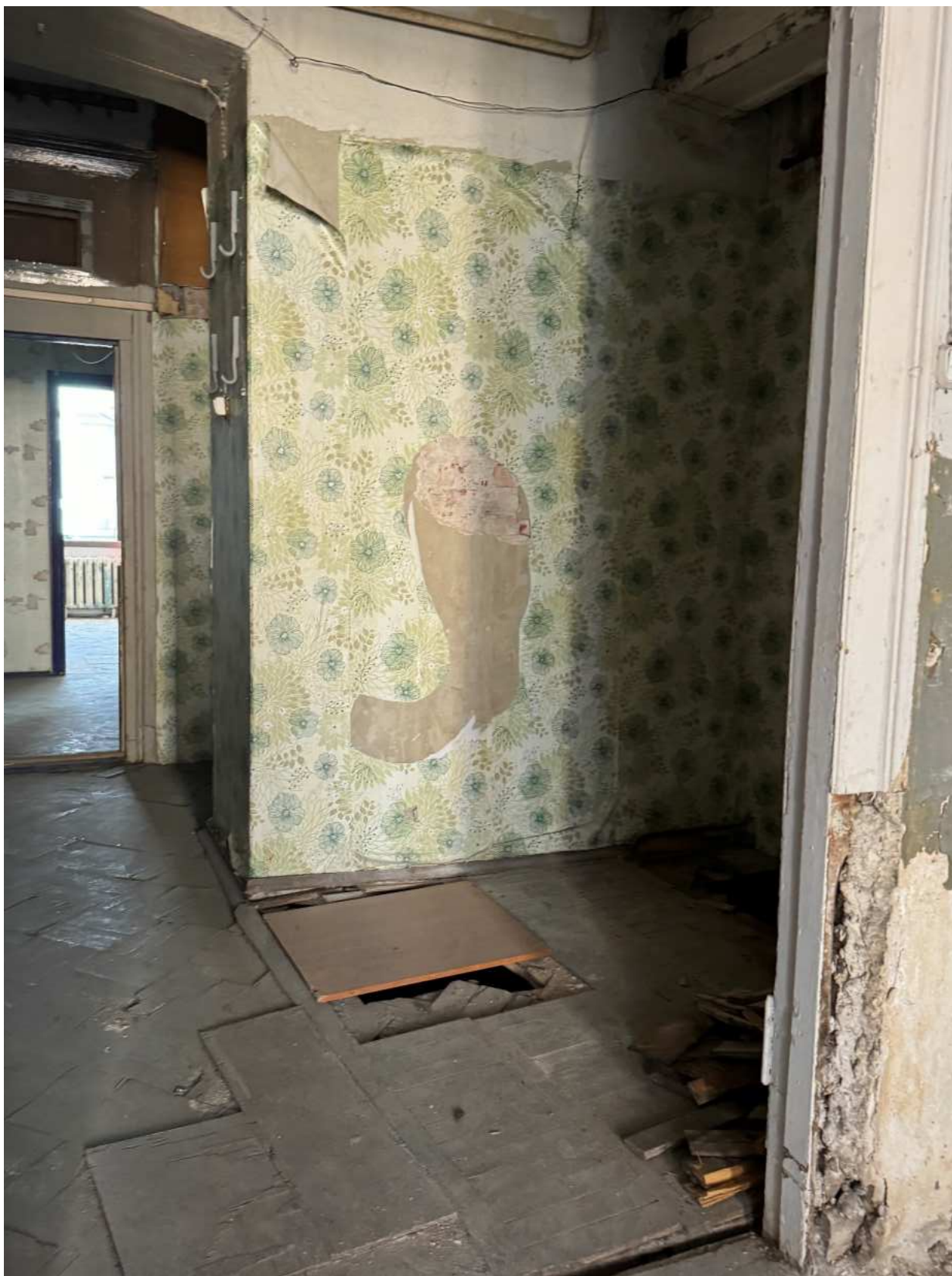
Фото 119. Вид на помещение квартиры № 16 объекта культурного наследия.
