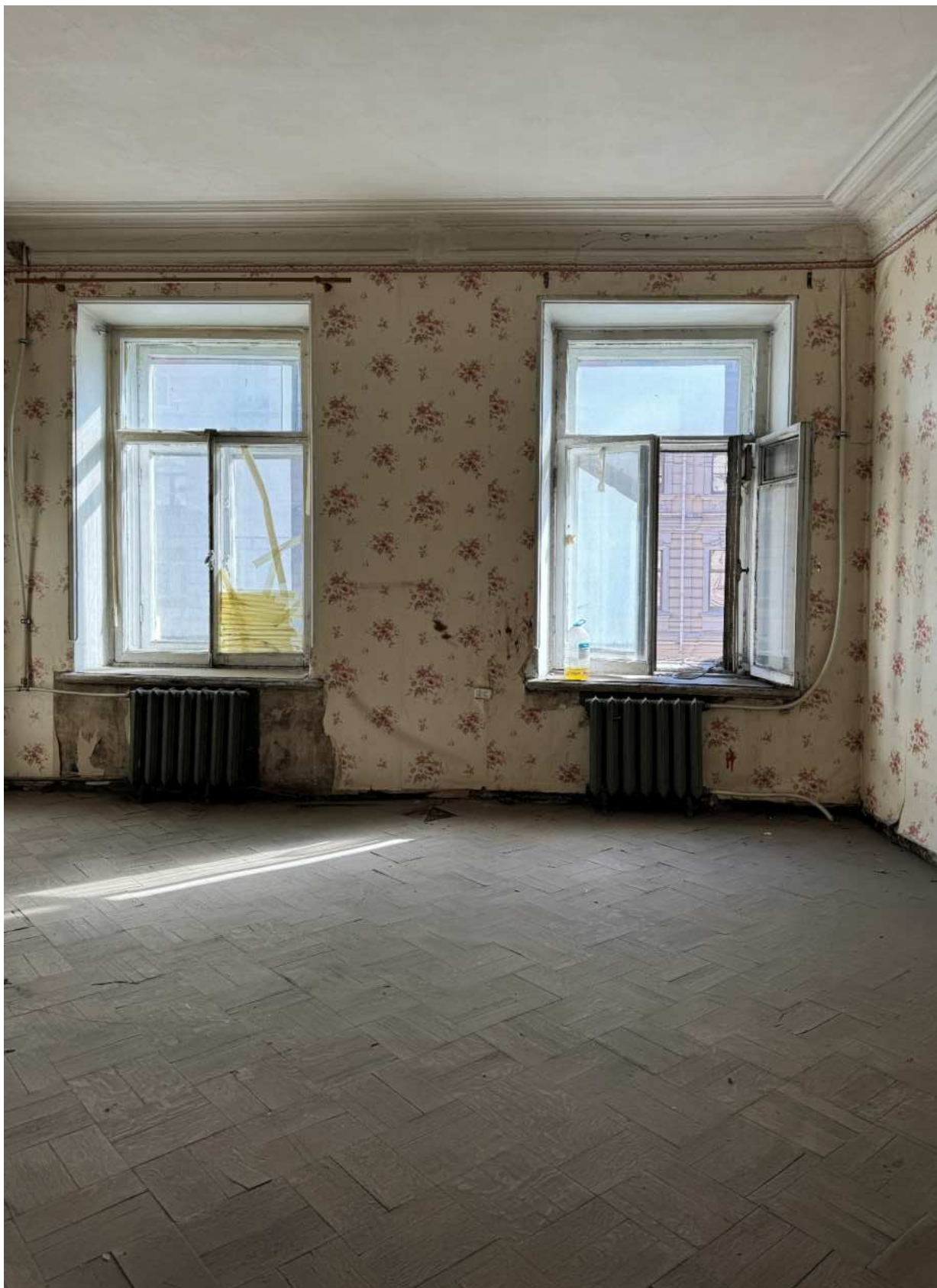
Фото 80. Вид на помещение квартиры № 11 объекта культурного наследия.
