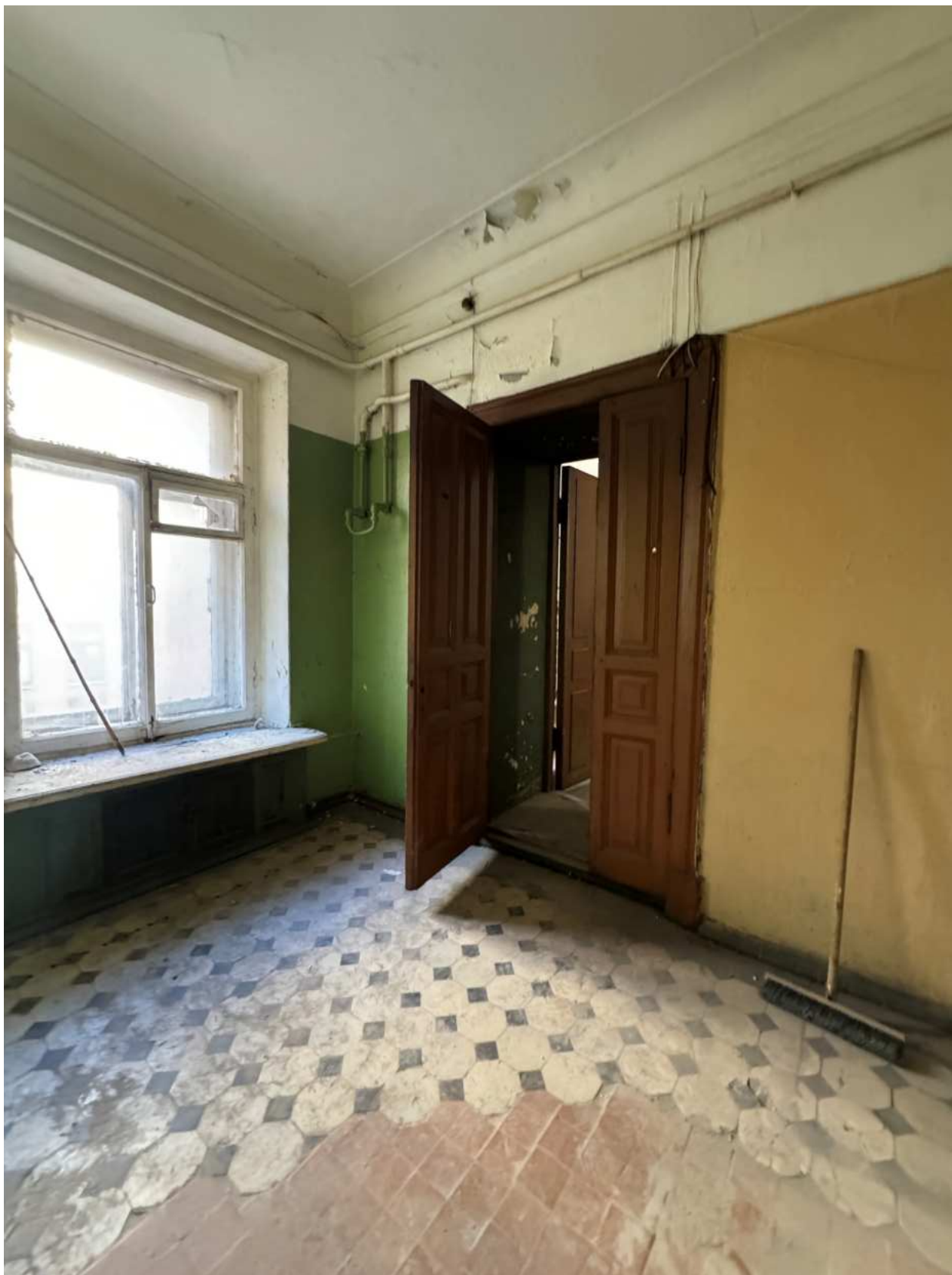
Фото 57. Вид на помещение квартиры № 11 объекта культурного наследия.
