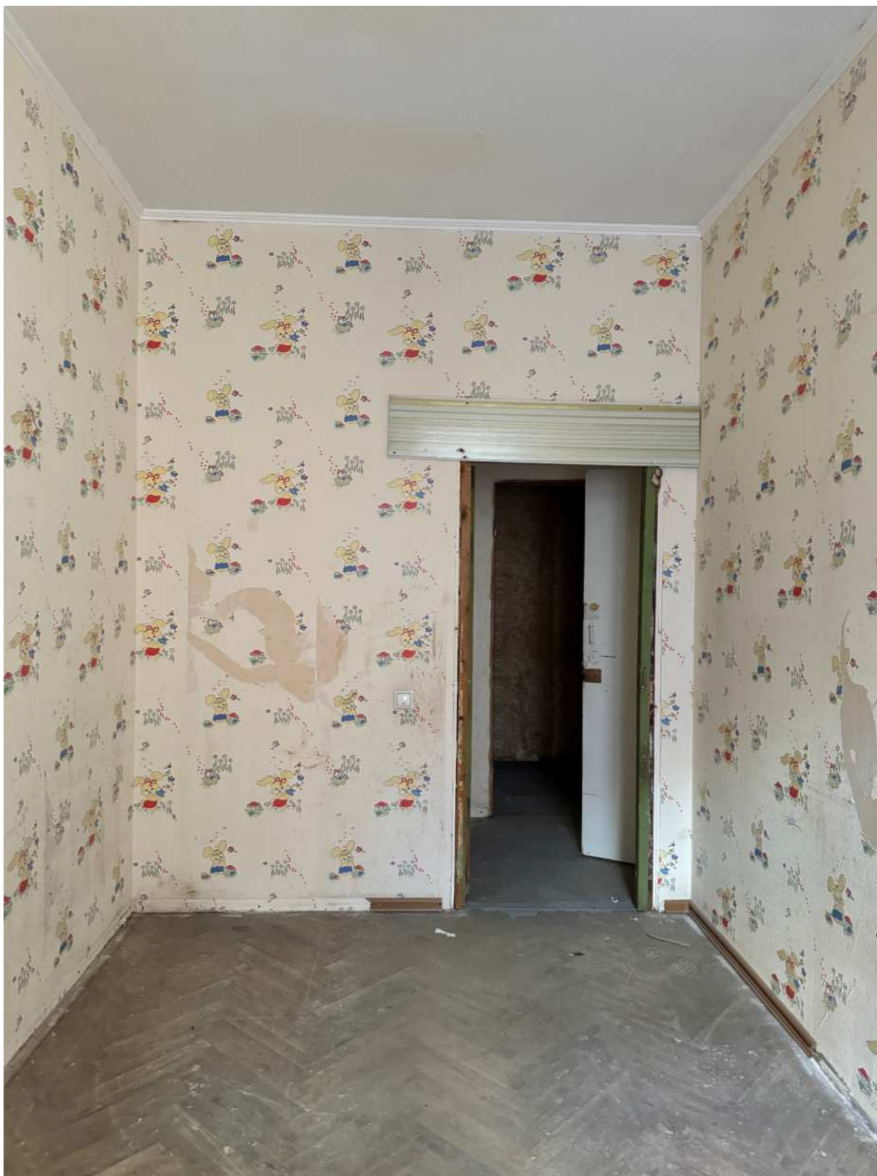
Фото 76. Вид на помещение квартиры № 11 объекта культурного наследия.
