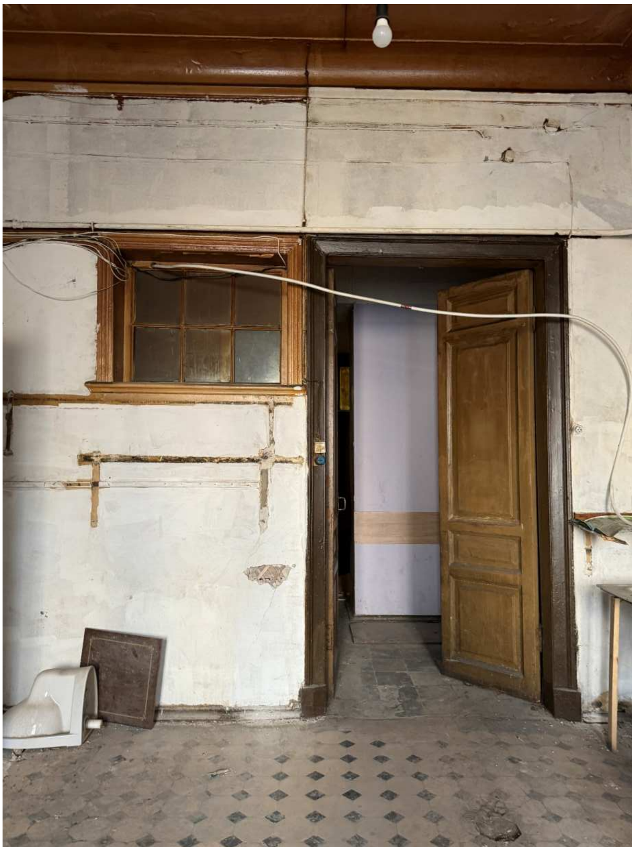
Фото 42. Вид на помещение квартиры № 17 объекта культурного наследия.
