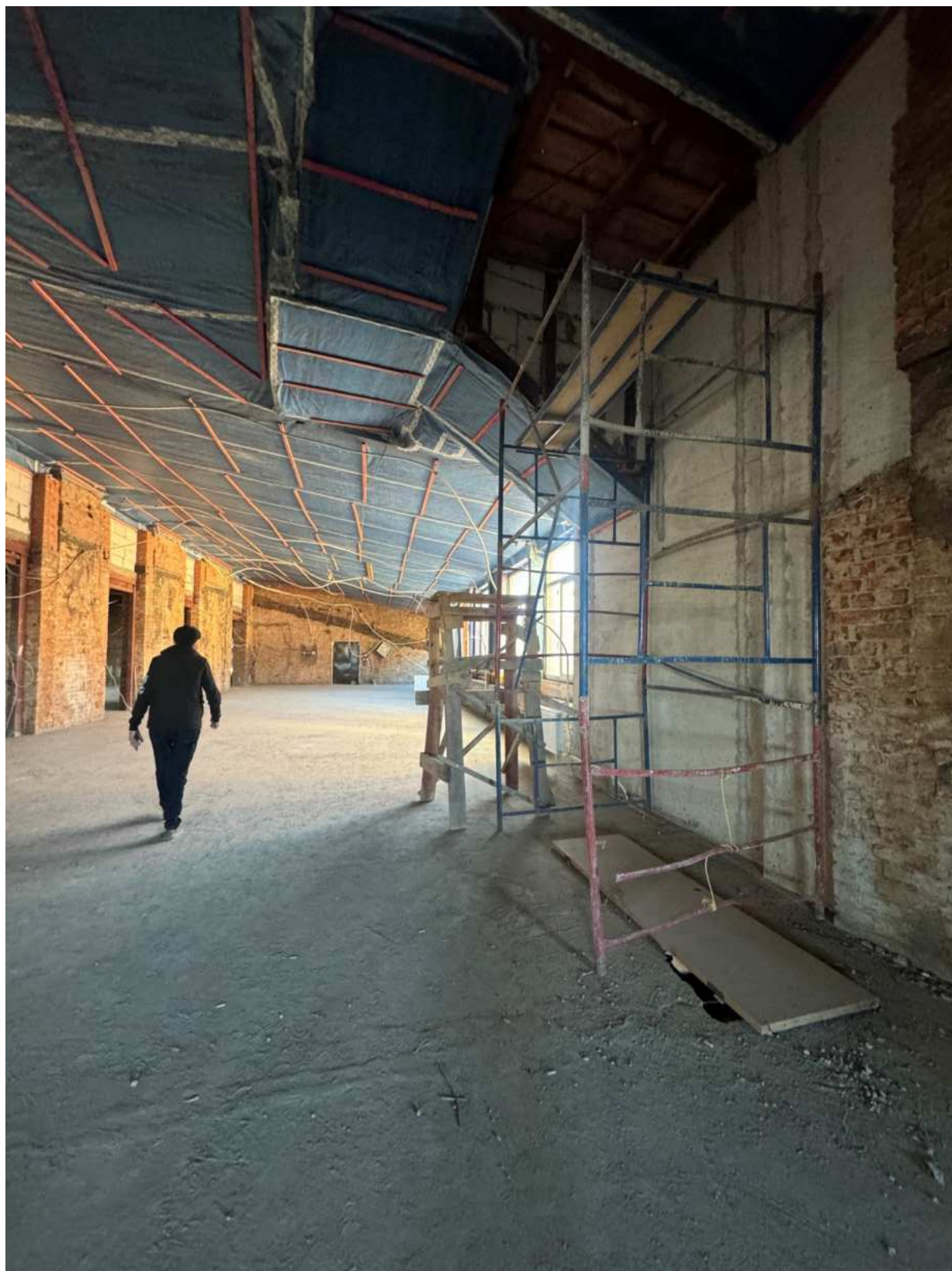
Фото 138. Вид на помещение квартиры № 58 объекта культурного наследия.
