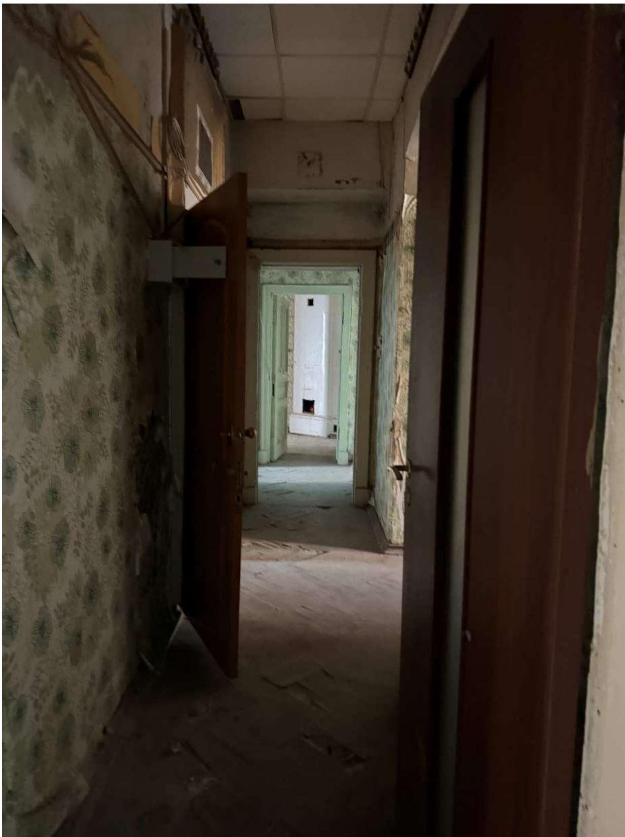
Фото 122. Вид на помещение квартиры № 16 объекта культурного наследия.
