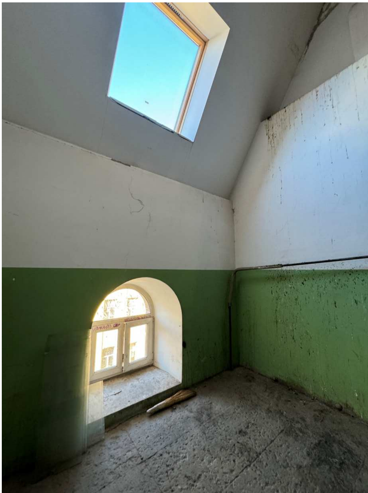
Фото 116. Вид на лестницу 5-ЛК объекта культурного наследия.
