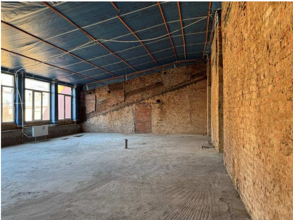
Фото 144. Вид на помещение квартиры № 56 объекта культурного наследия.
