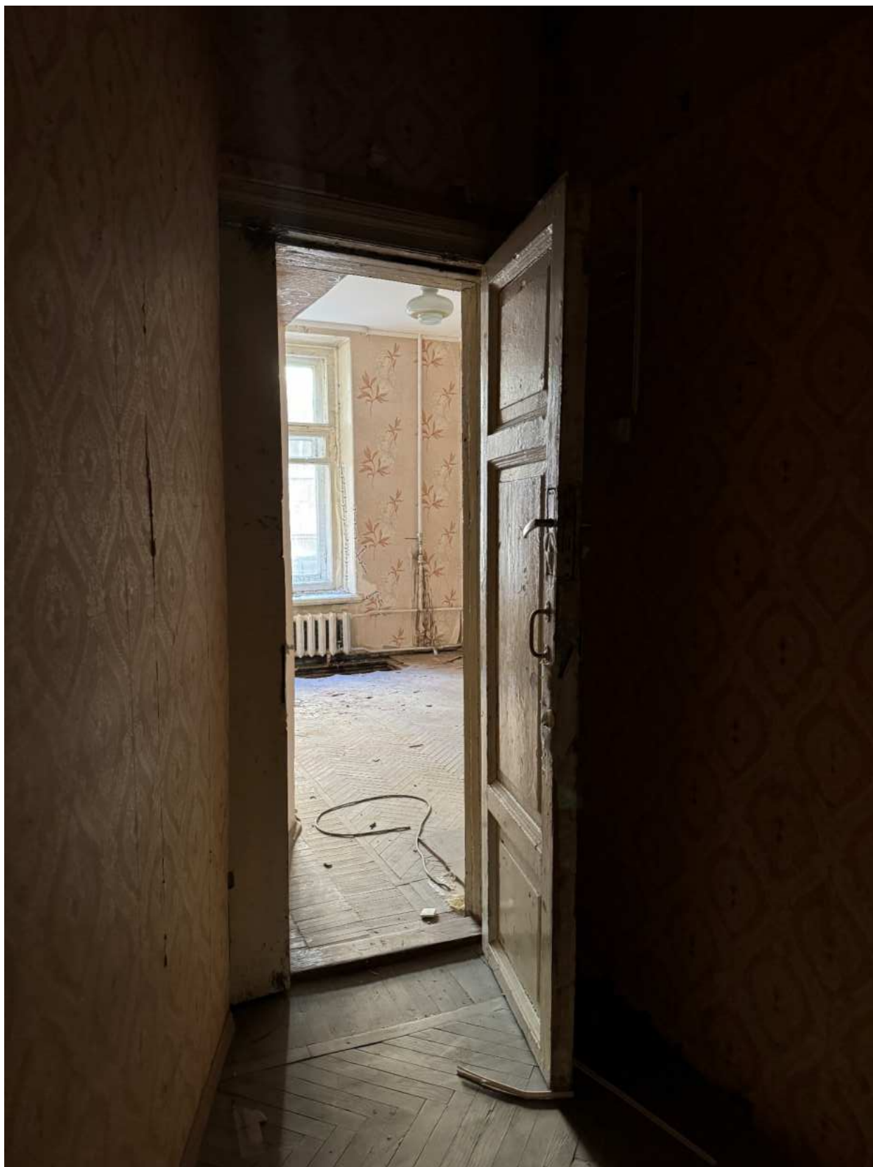
Фото 69. Вид на помещение квартиры № 11 объекта культурного наследия.
