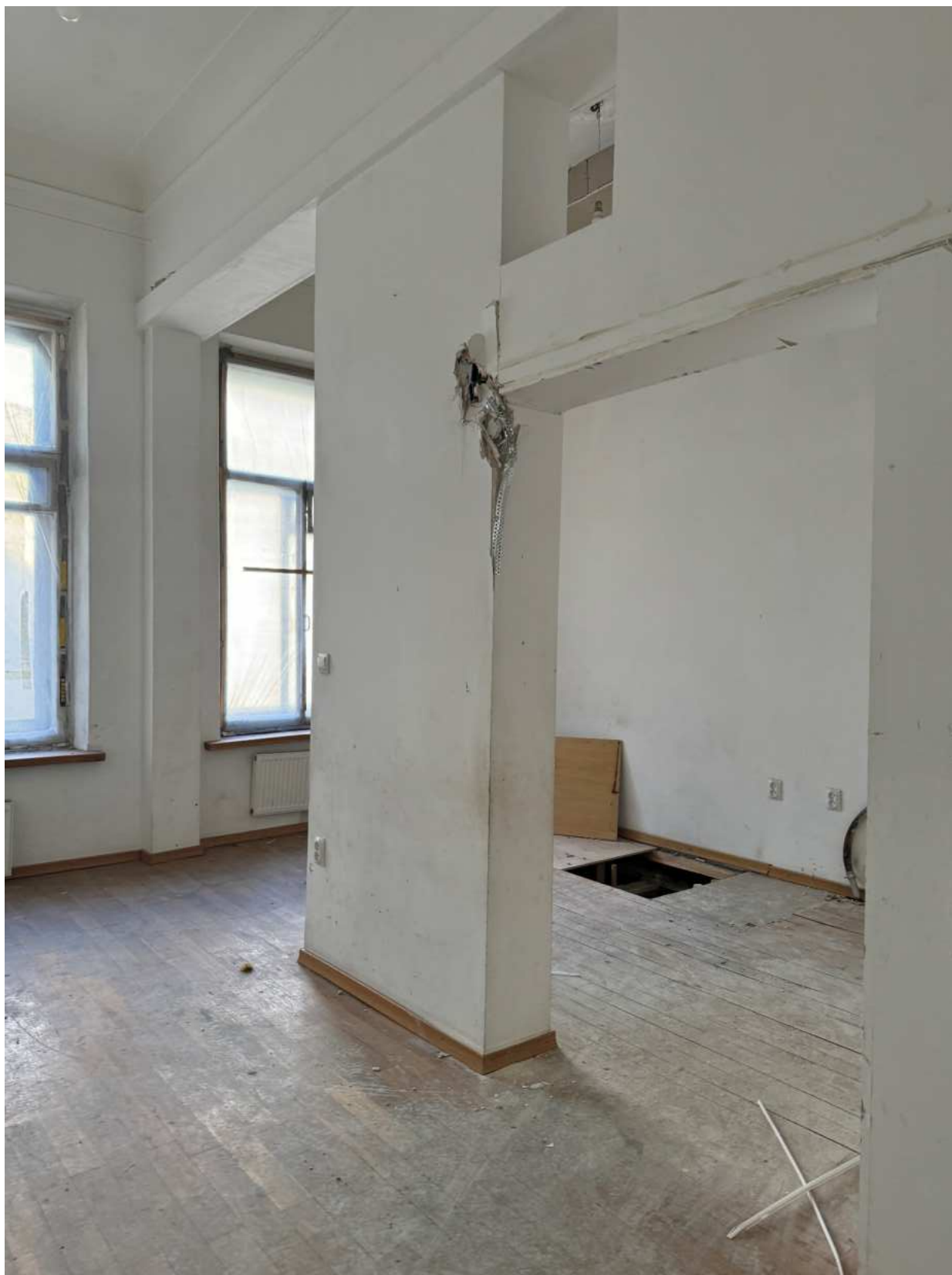
Фото 37. Вид на помещение квартиры № 17 объекта культурного наследия.
