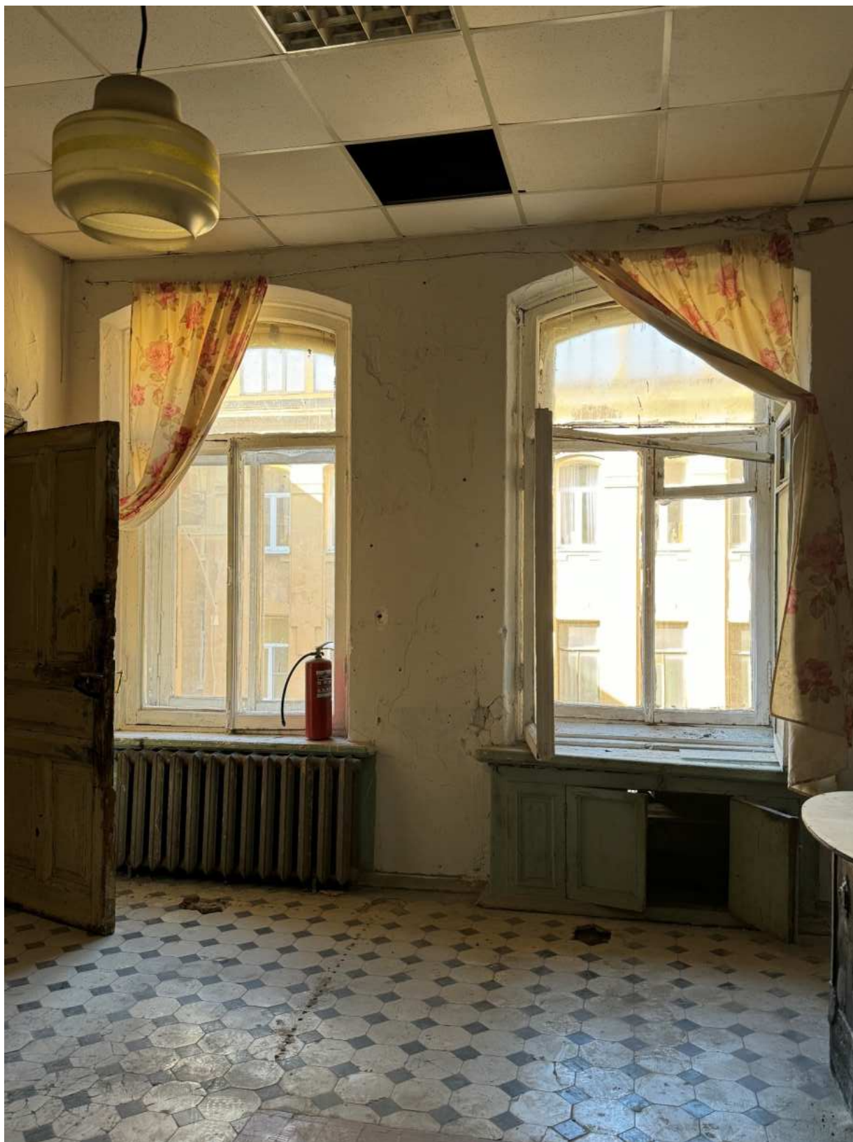
Фото 118. Вид на помещение квартиры № 16 объекта культурного наследия.
