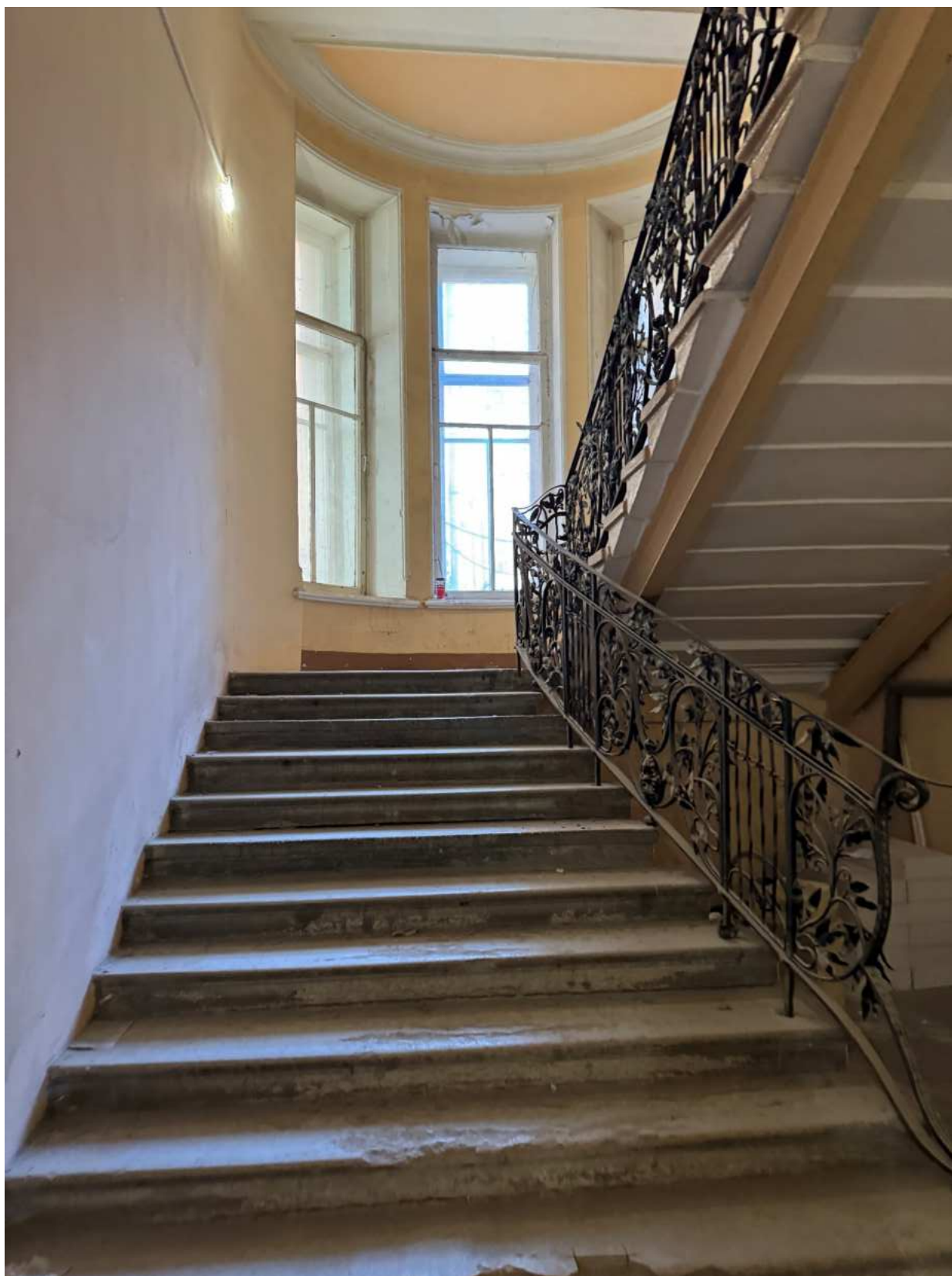
Фото 103. Вид на лестницу 4-ЛК объекта культурного наследия.
