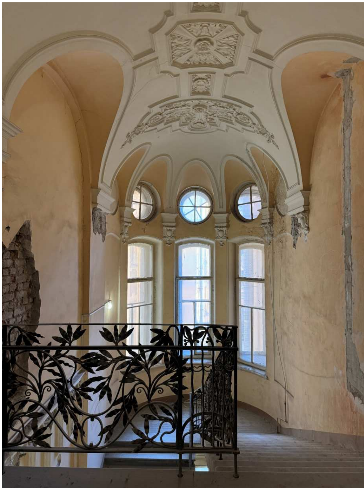
Фото 107. Вид на лестницу 4-ЛК объекта культурного наследия.
