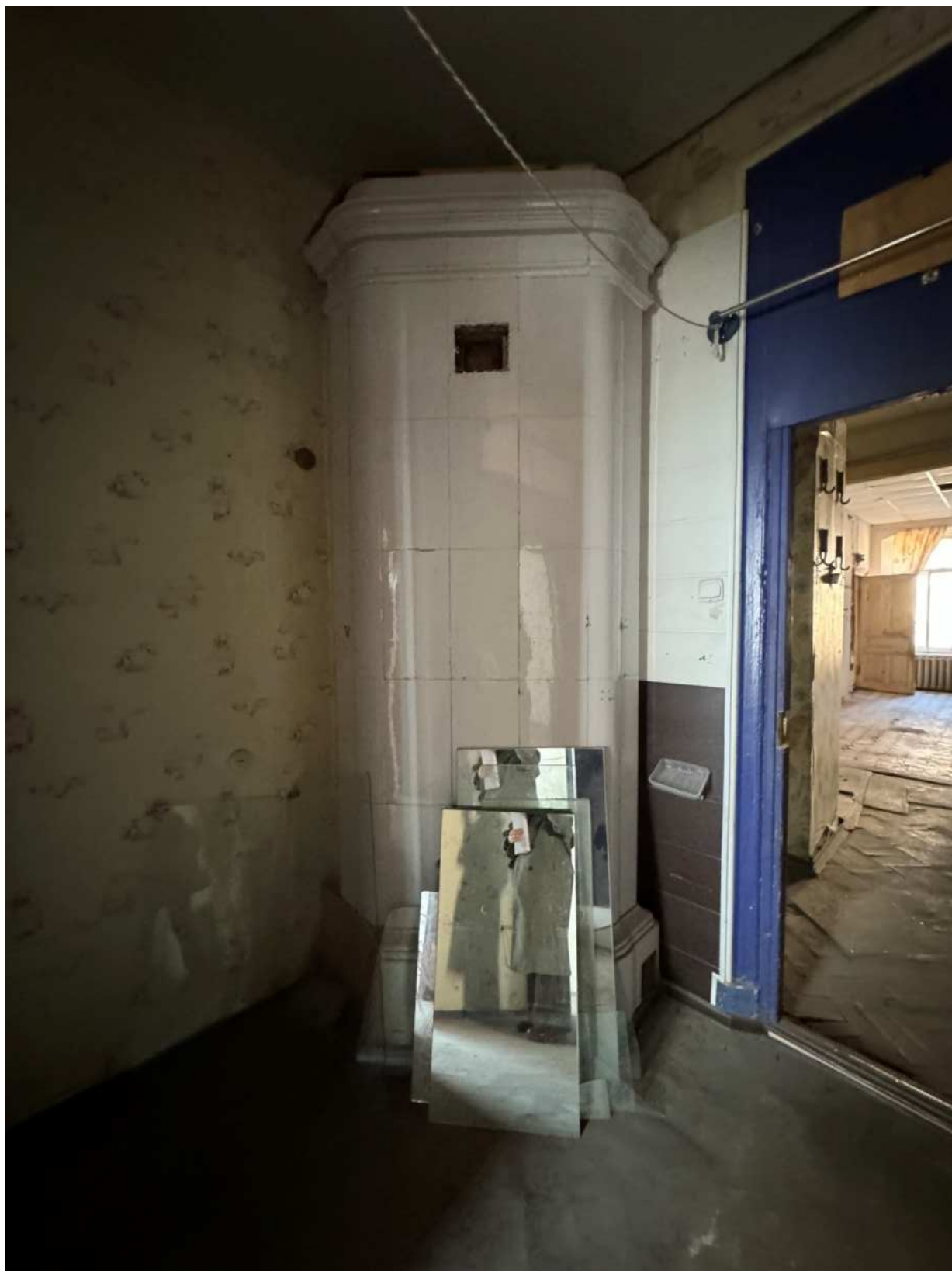
Фото 123. Вид на помещение квартиры № 16 объекта культурного наследия.
