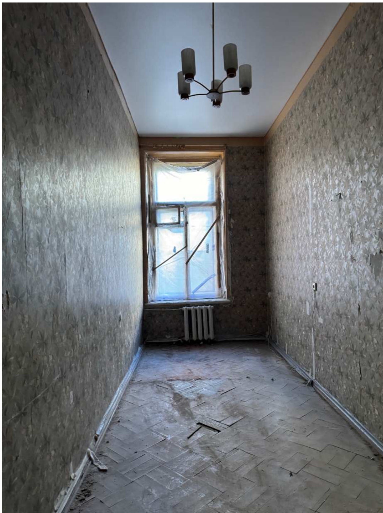
Фото 35. Вид на помещение квартиры № 17 объекта культурного наследия.
