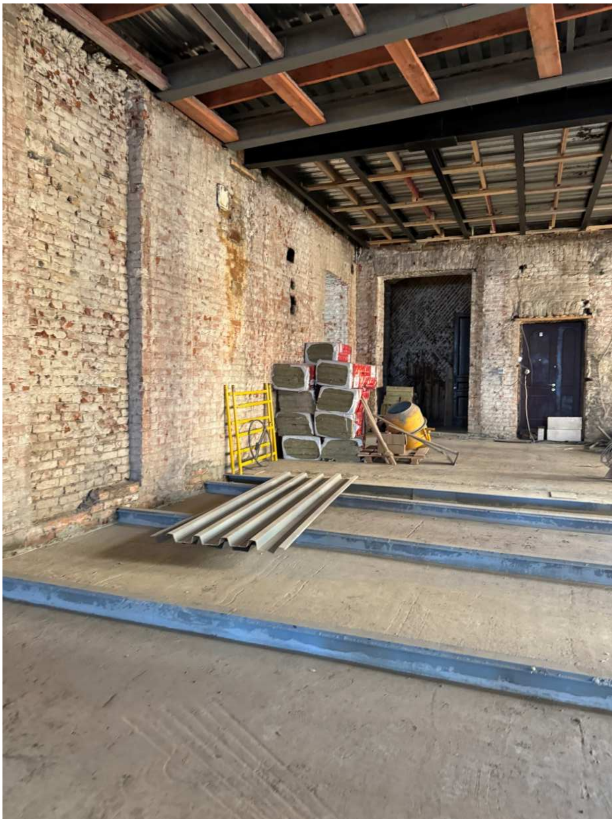
Фото 148. Вид на помещение квартиры № 52 объекта культурного наследия.
