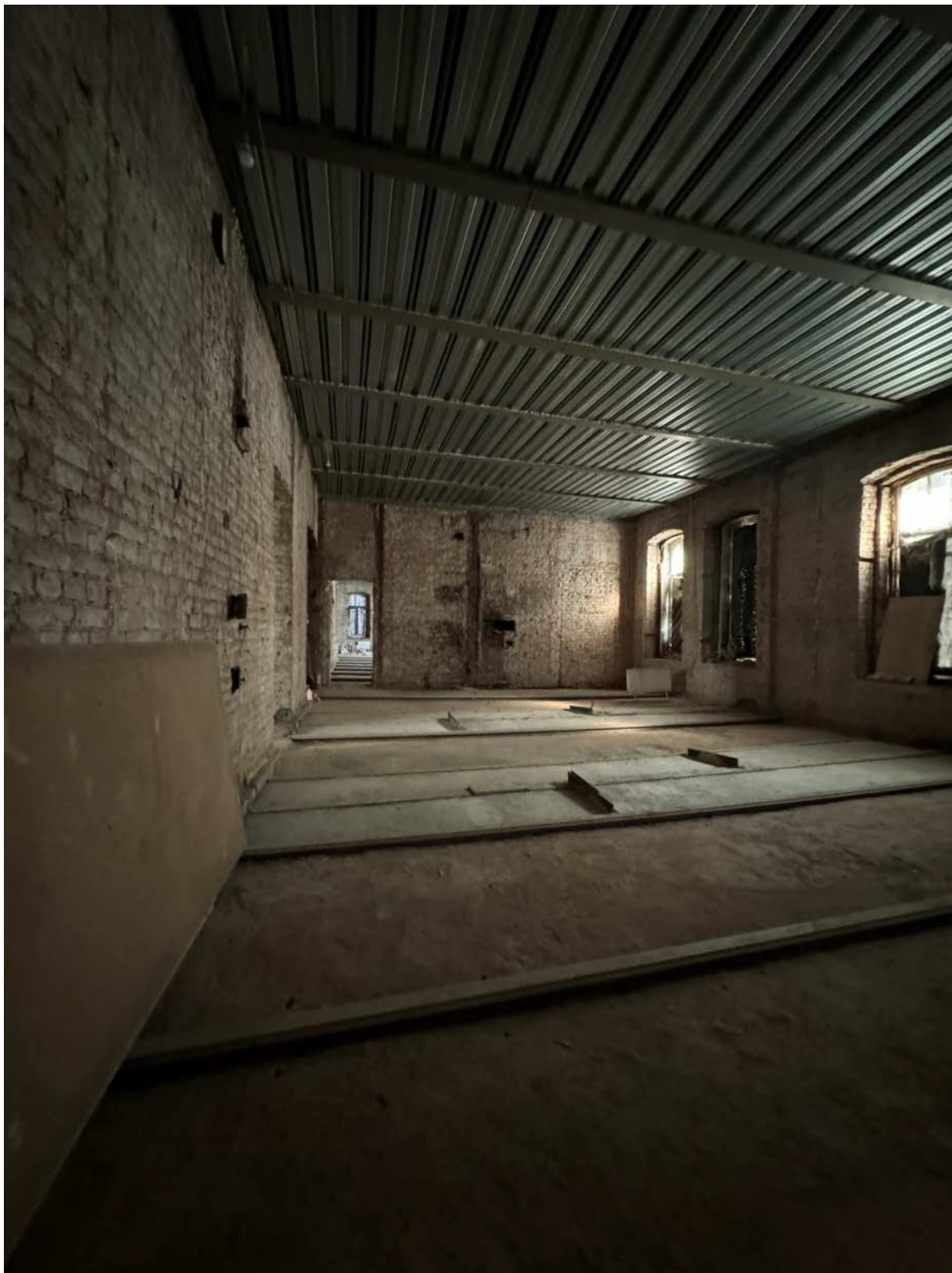
Фото 90. Вид на помещение квартиры № 10 объекта культурного наследия.
