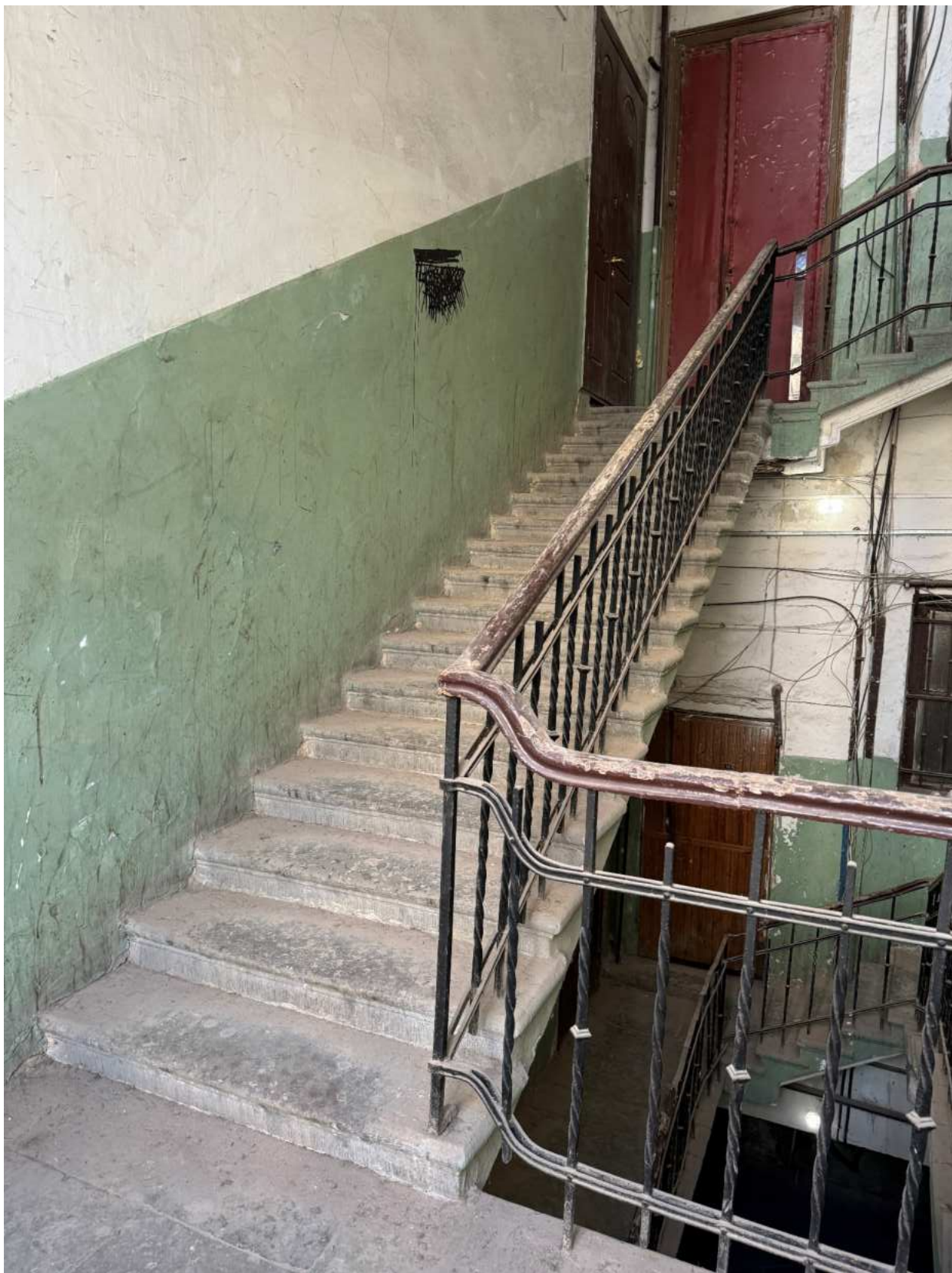
Фото 56. Вид на лестницу 5-ЛК объекта культурного наследия.
