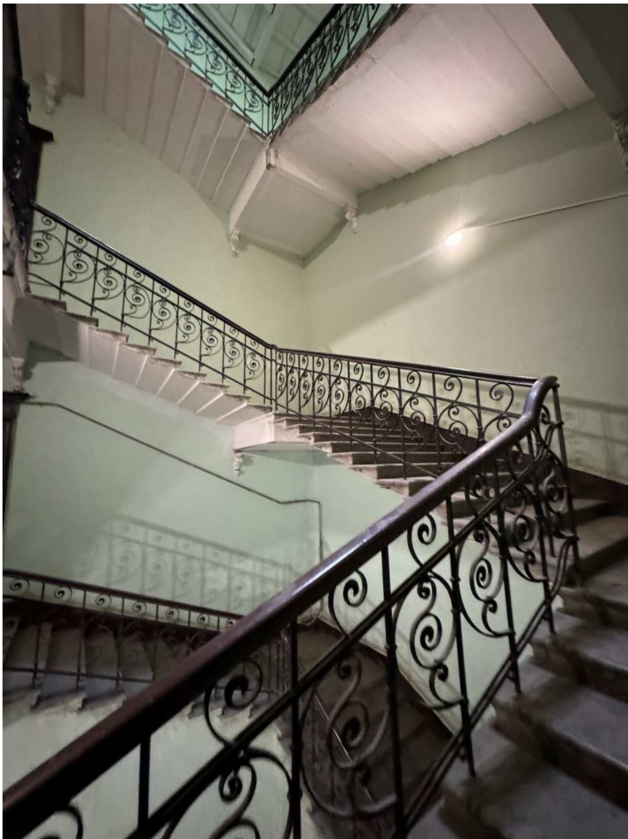
Фото 25. Вид на лестницу 1-ЛК объекта культурного наследия.
