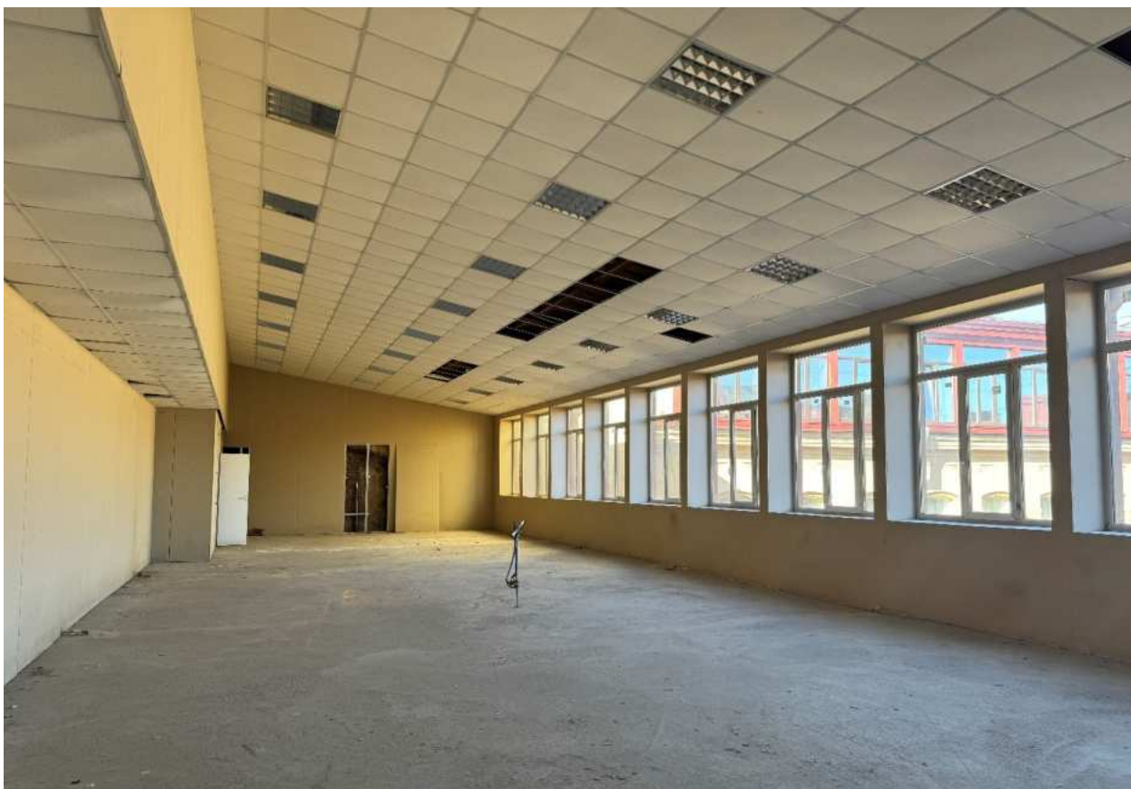
Фото 151. Вид на помещение квартиры № 57 объекта культурного наследия.
