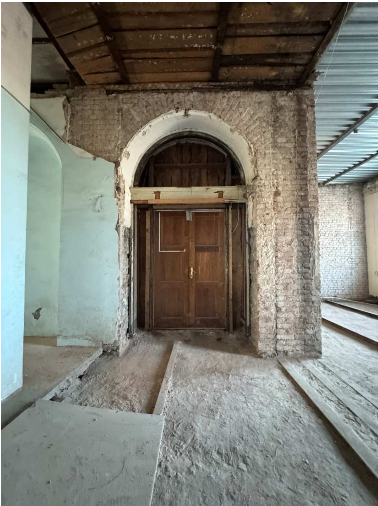
Фото 98. Вид на помещение 8-Н объекта культурного наследия.
