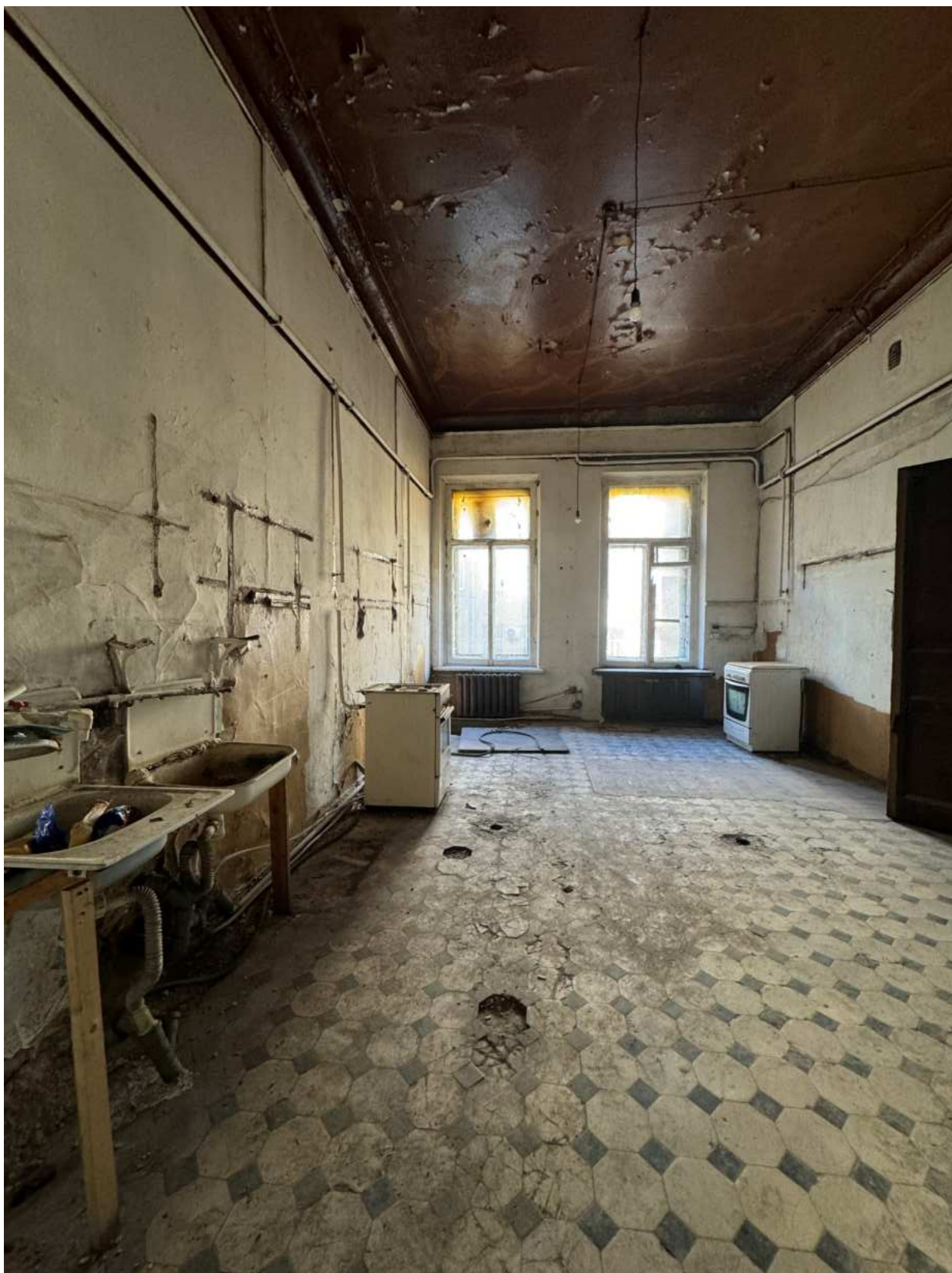
Фото 41. Вид на помещение квартиры № 17 объекта культурного наследия.
