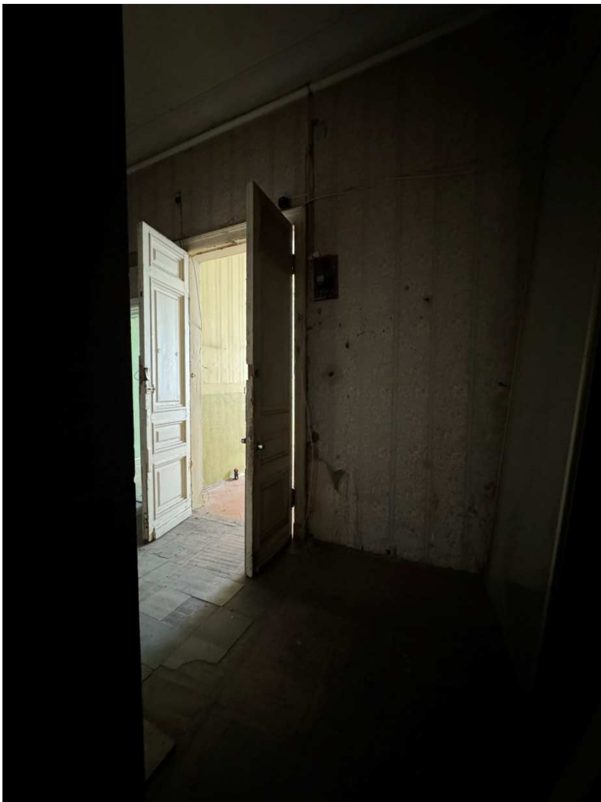
Фото 28. Вид на помещение квартиры № 17 объекта культурного наследия.
