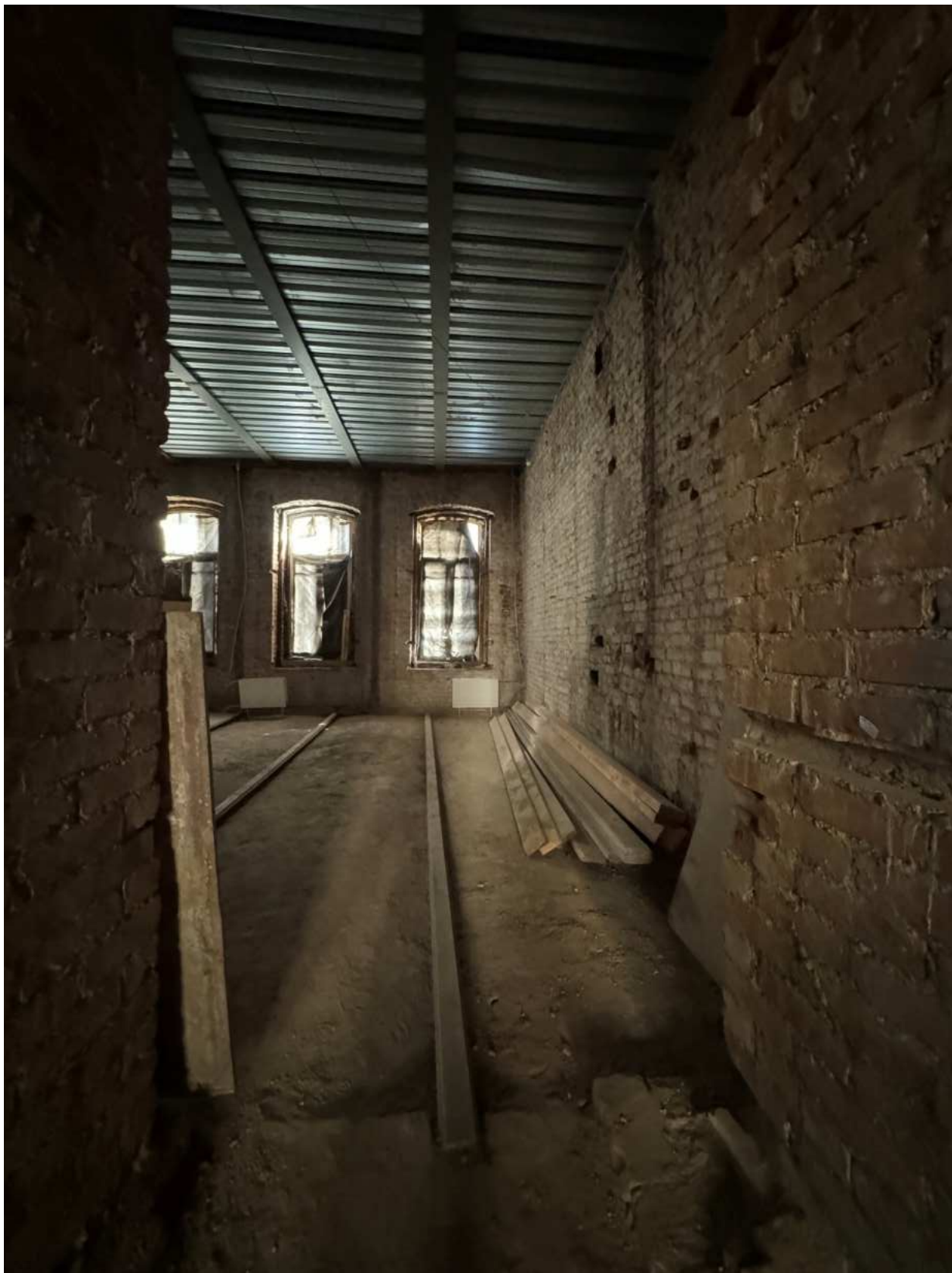
Фото 89. Вид на помещение квартиры № 10 объекта культурного наследия.
