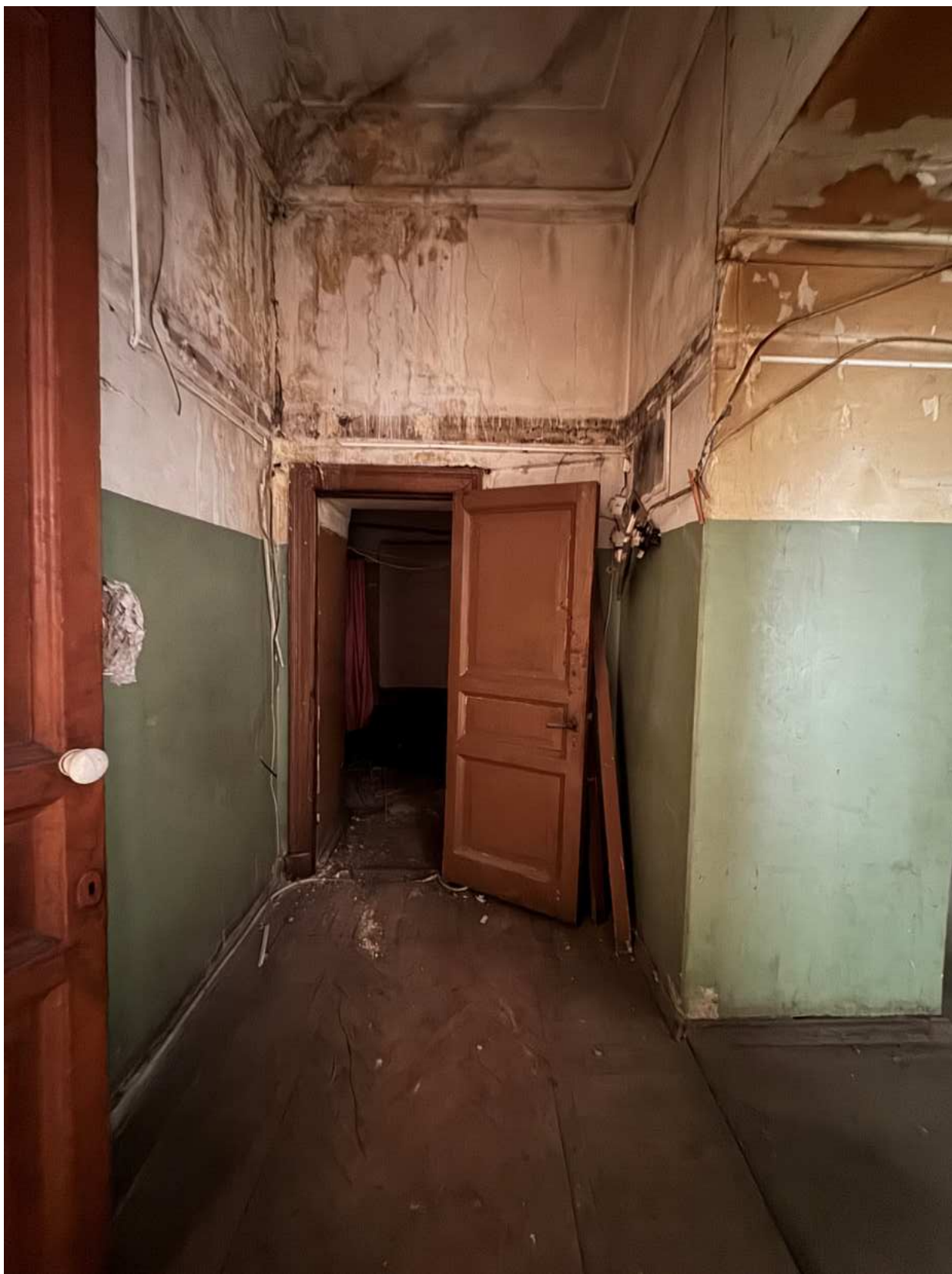
Фото 59. Вид на помещение квартиры № 11 объекта культурного наследия.
