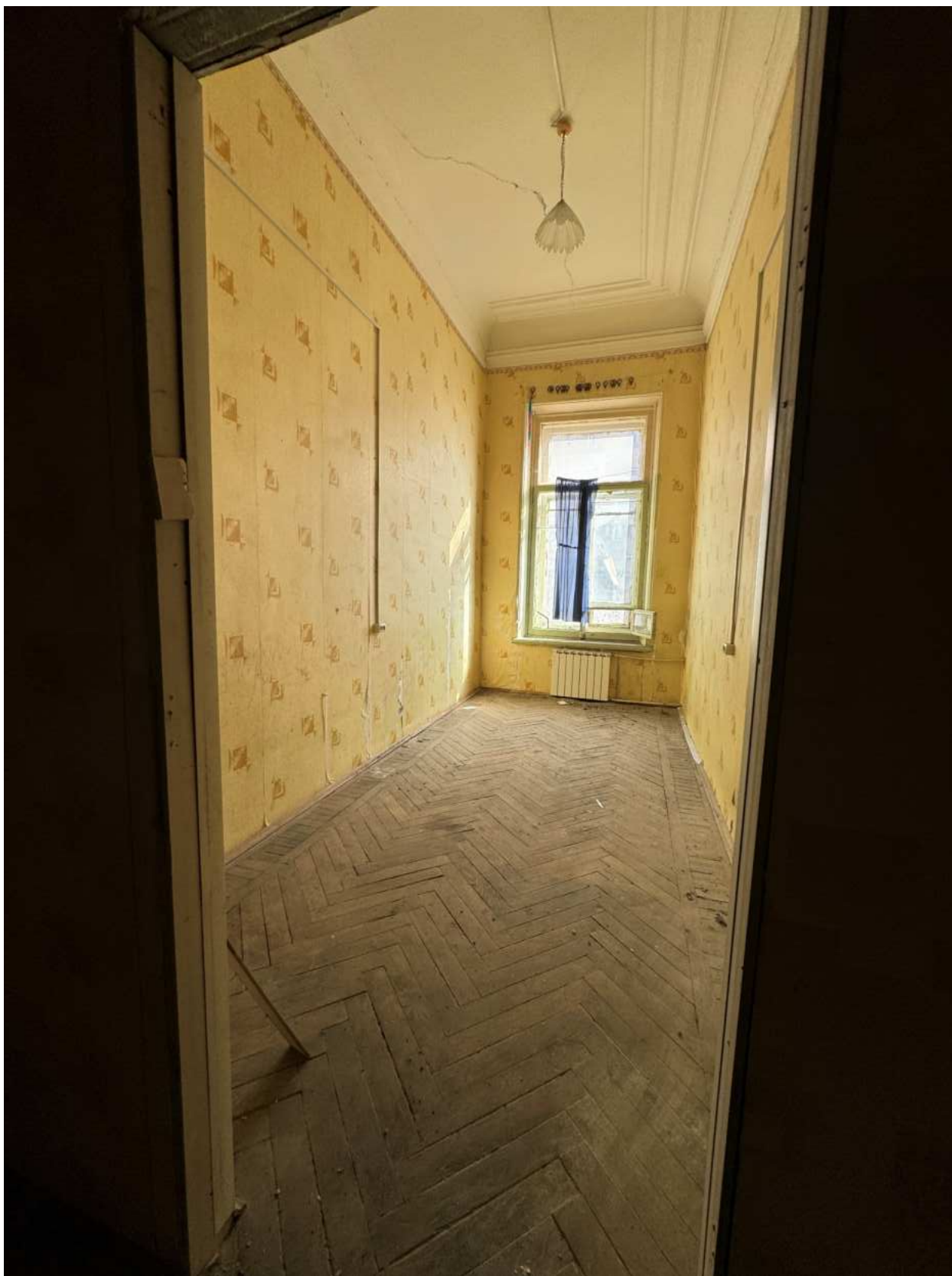
Фото 38. Вид на помещение квартиры № 17 объекта культурного наследия.
