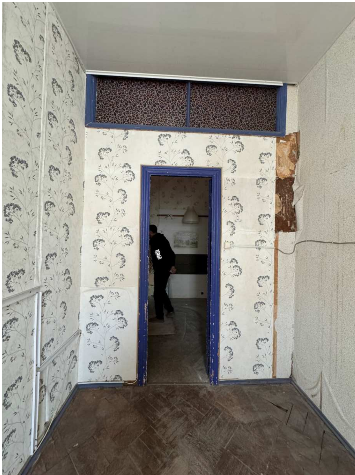
Фото 126. Вид на помещение квартиры № 16 объекта культурного наследия.
