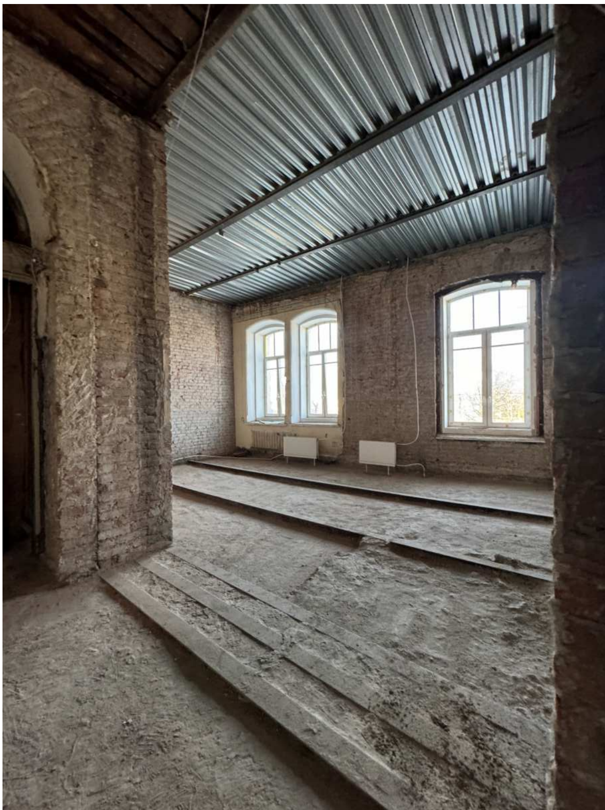
Фото 97. Вид на помещение 8-Н объекта культурного наследия.
