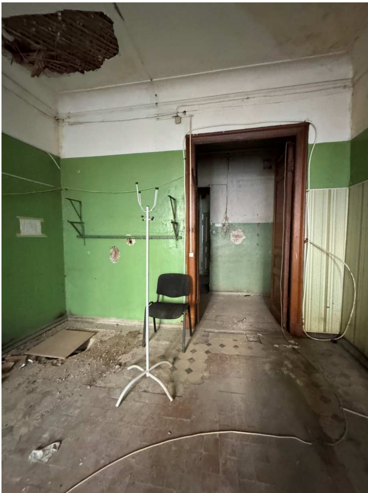
Фото 58. Вид на помещение квартиры № 11 объекта культурного наследия.
