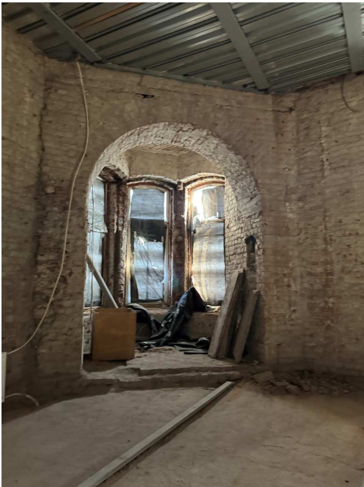
Фото 94. Вид на помещение 8-Н объекта культурного наследия.
