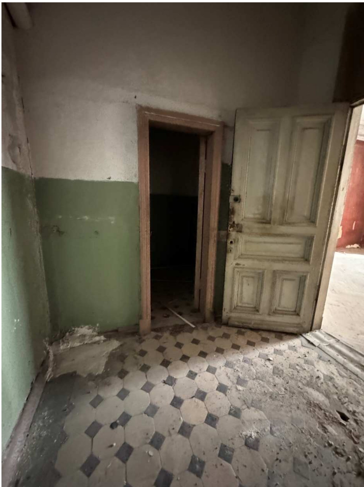
Фото 60. Вид на помещение квартиры № 11 объекта культурного наследия.
