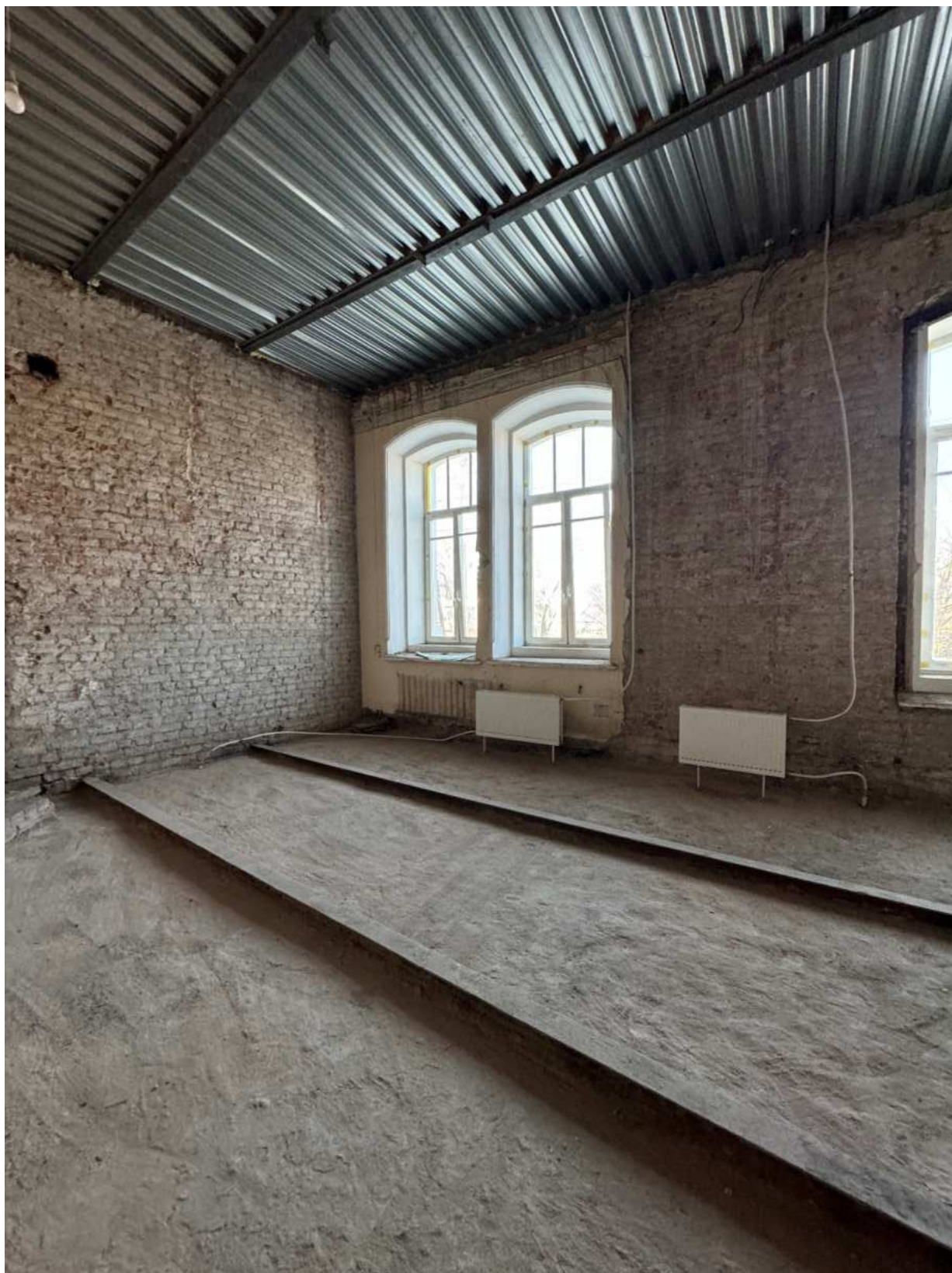
Фото 100. Вид на помещение 8-Н объекта культурного наследия.
