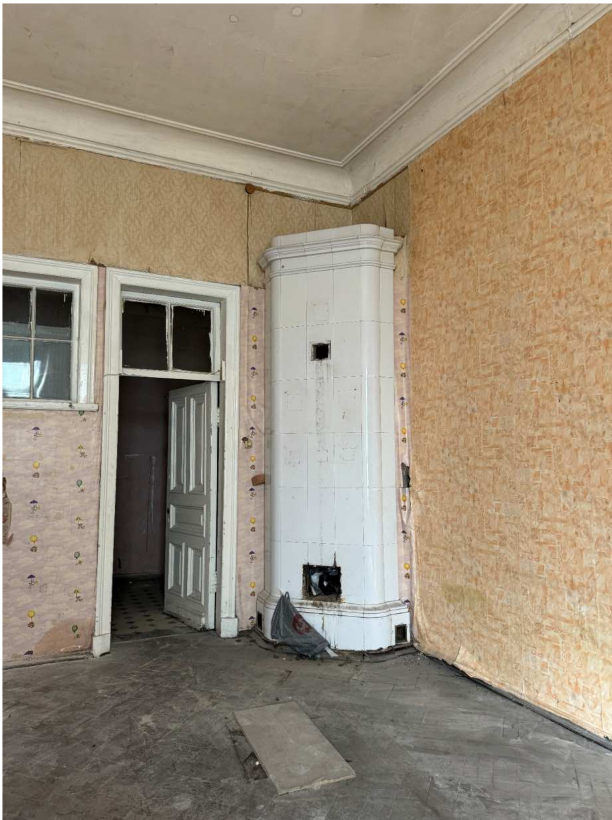
Фото 50. Вид на помещение квартиры № 17 объекта культурного наследия.
