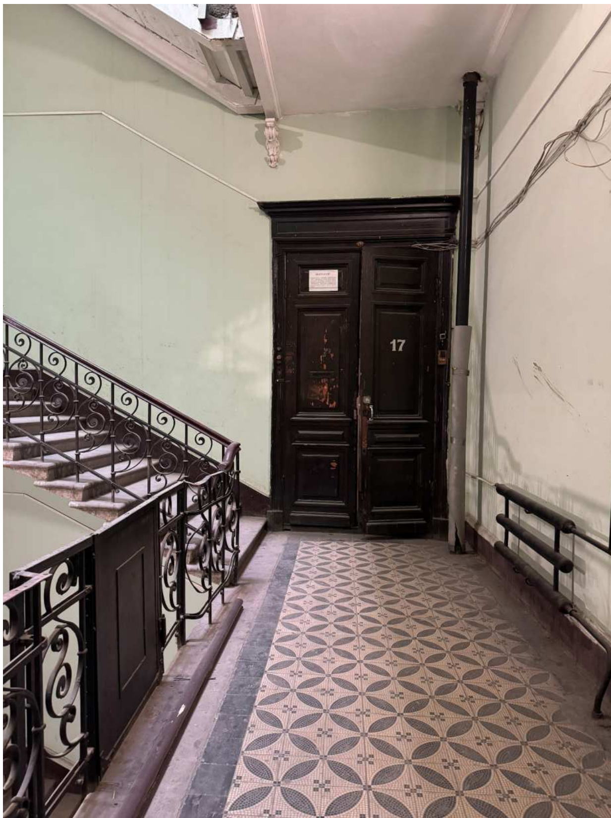
Фото 27. Вид на лестницу 1-ЛК объекта культурного наследия.
