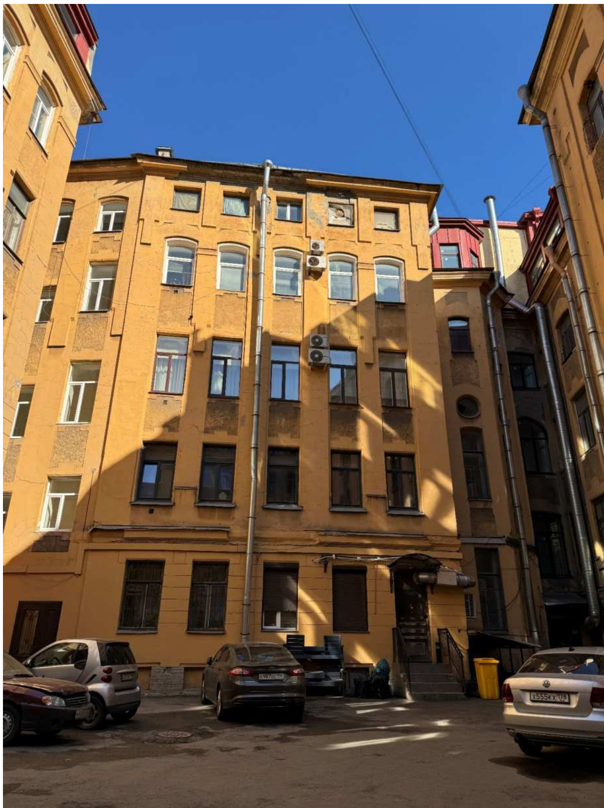
Фото 12. Общий вид дворовых фасадов объекта культурного наследия.
