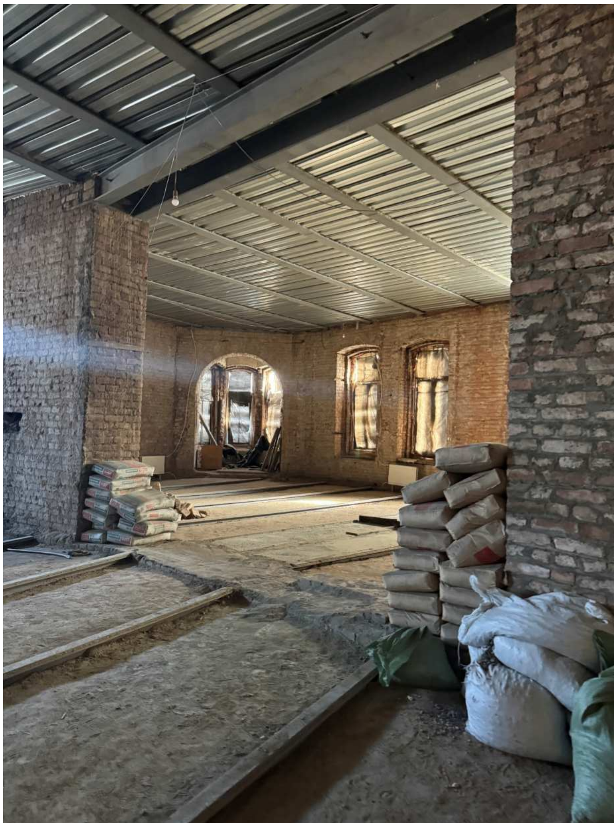
Фото 93. Вид на помещение 8-Н объекта культурного наследия.
