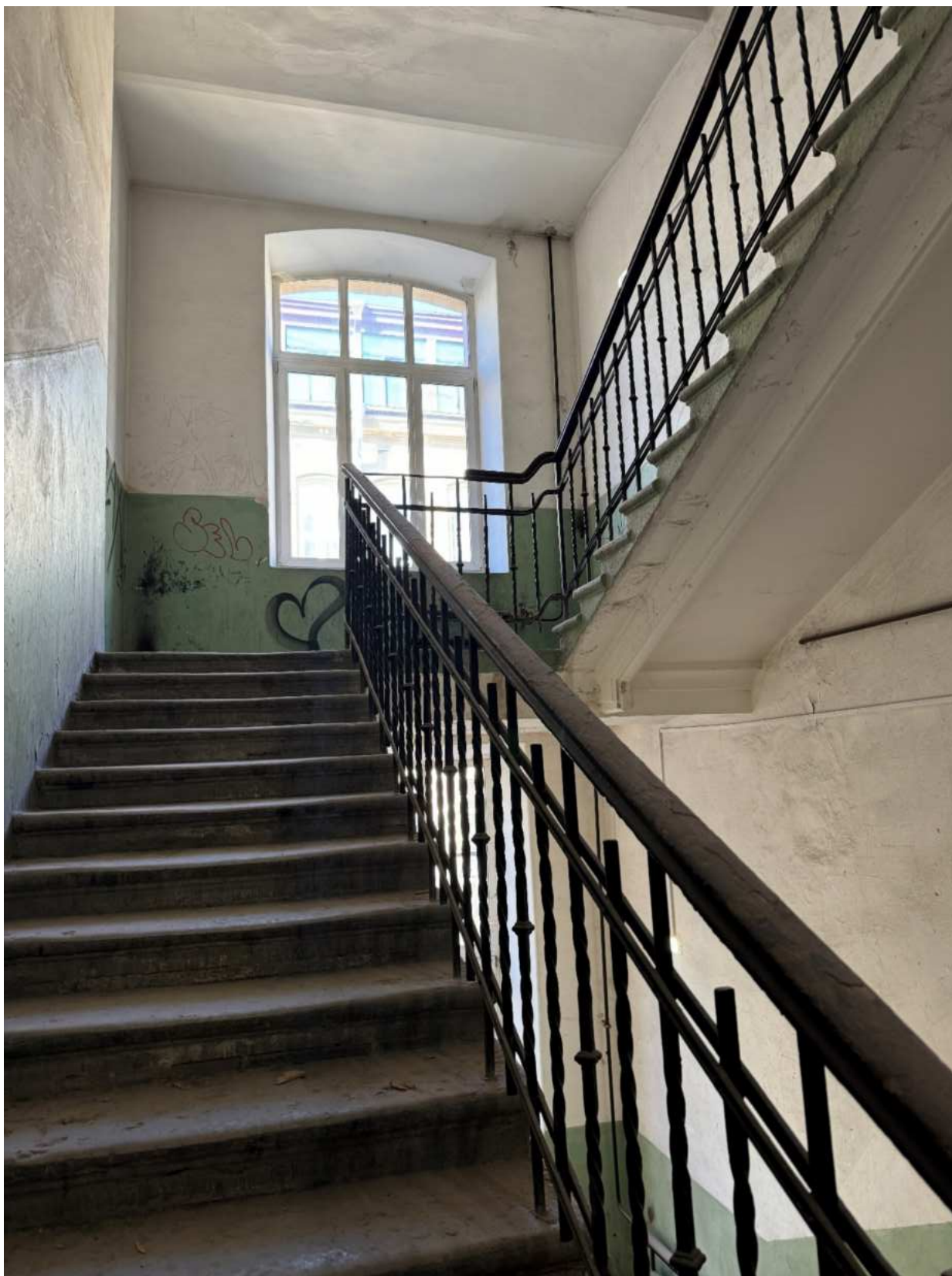
Фото 54. Вид на лестницу 5-ЛК объекта культурного наследия.
