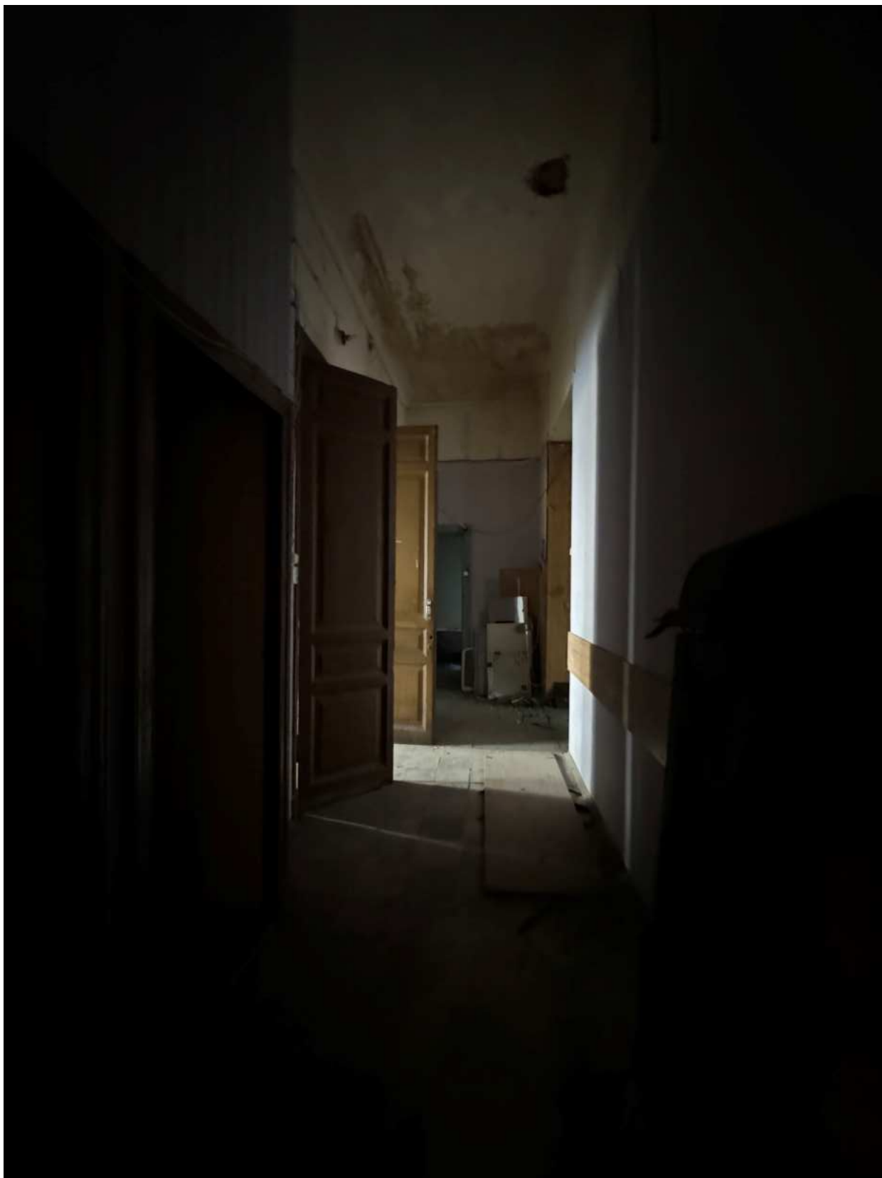
Фото 40. Вид на помещение квартиры № 17 объекта культурного наследия.
