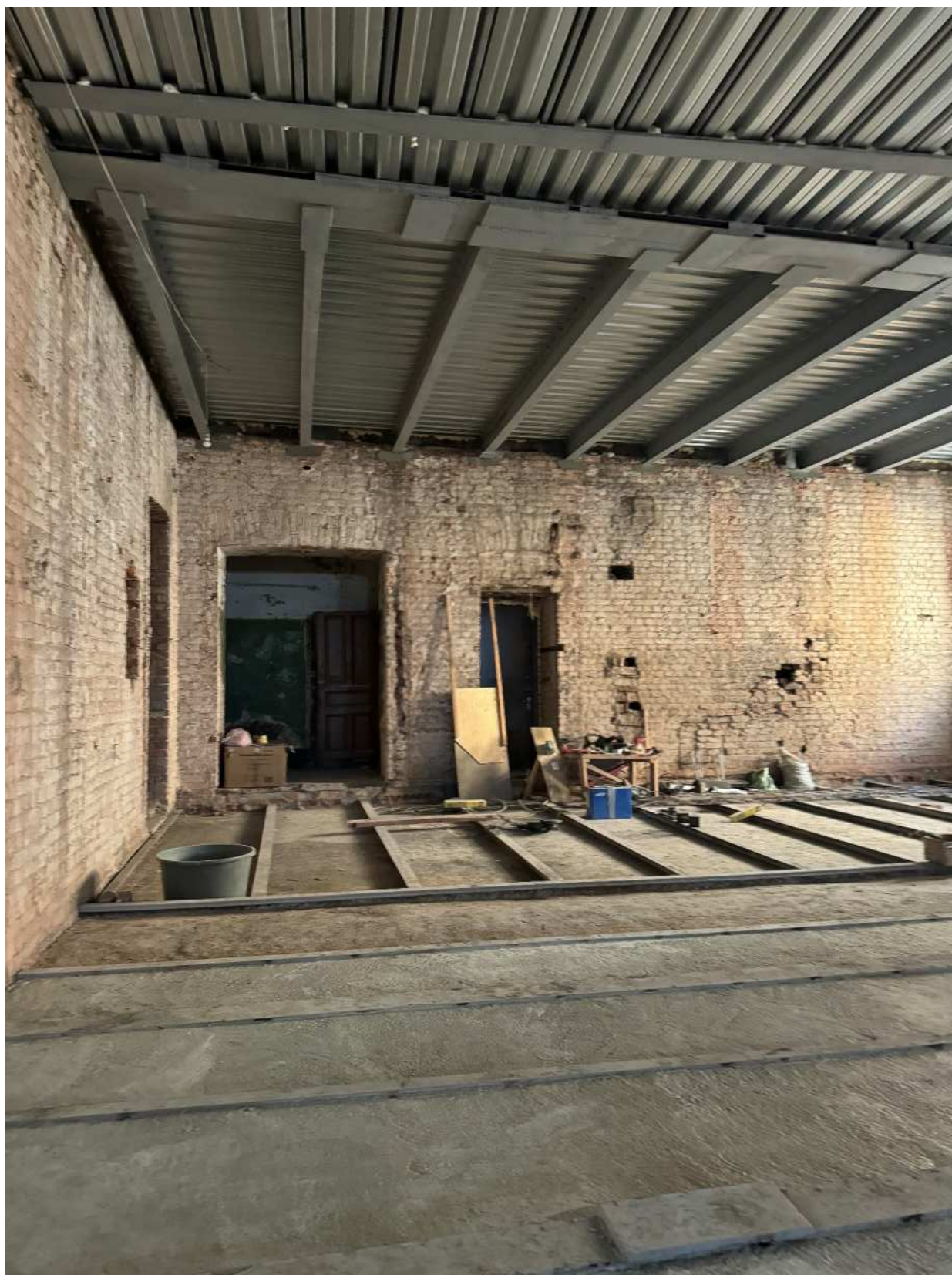
Фото 91. Вид на помещение 8-Н объекта культурного наследия.
