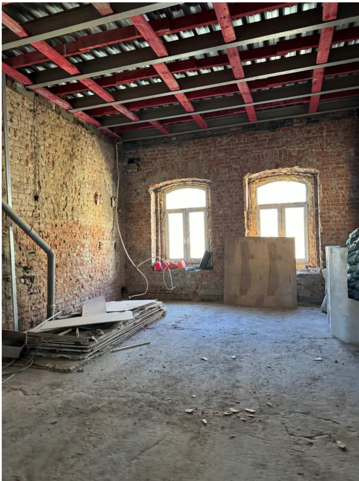
Фото 112. Вид на помещение квартиры № 15 объекта культурного наследия.
