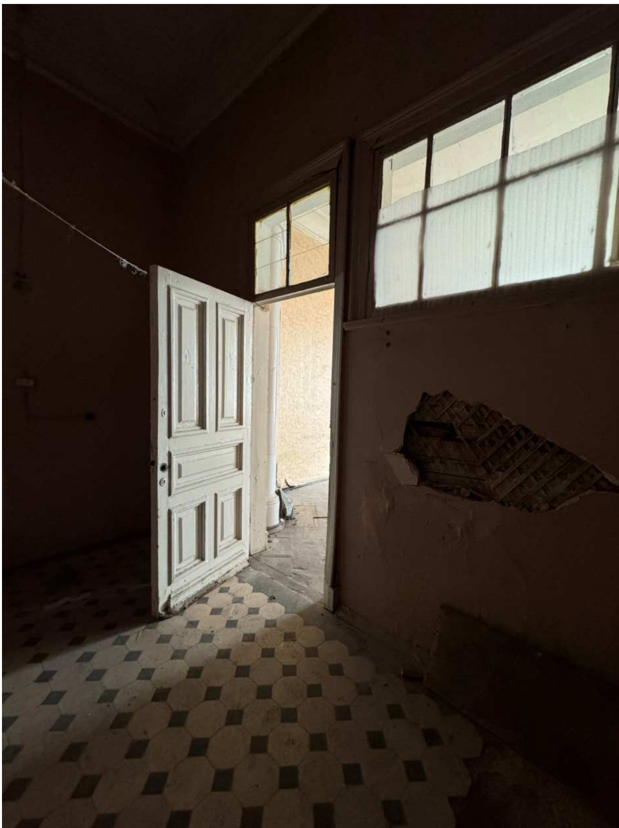
Фото 48. Вид на помещение квартиры № 17 объекта культурного наследия.
