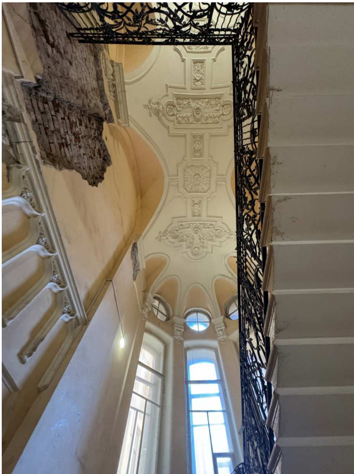
Фото 105. Вид на лестницу 4-ЛК объекта культурного наследия.
