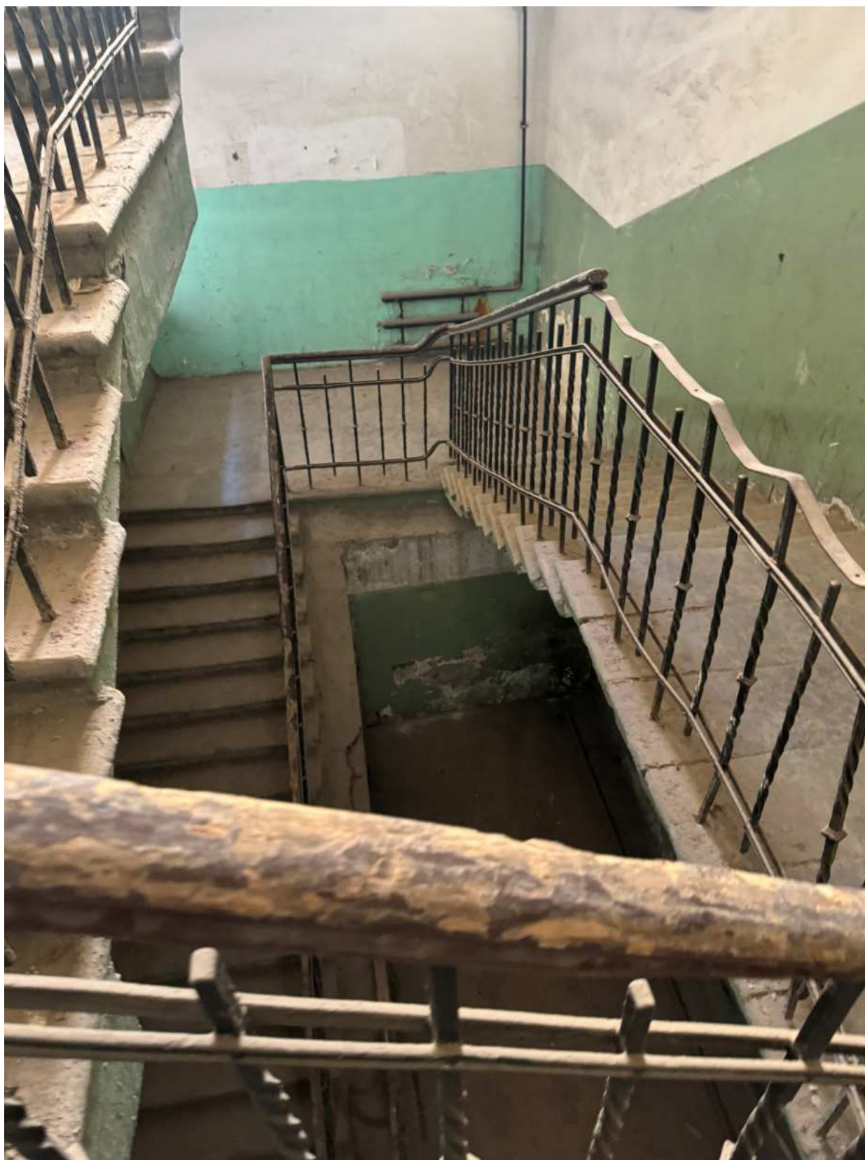
Фото 84. Вид на лестницу 5-ЛК объекта культурного наследия.
