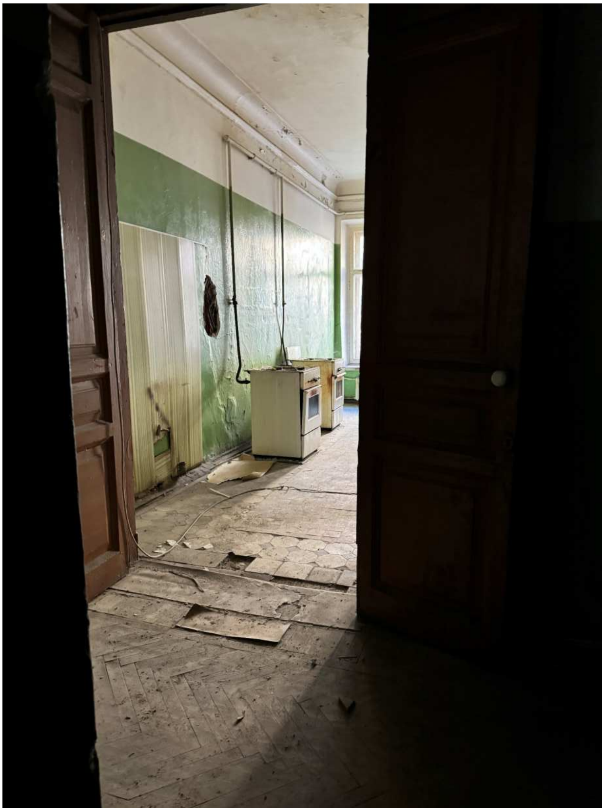
Фото 63. Вид на помещение квартиры № 11 объекта культурного наследия.
