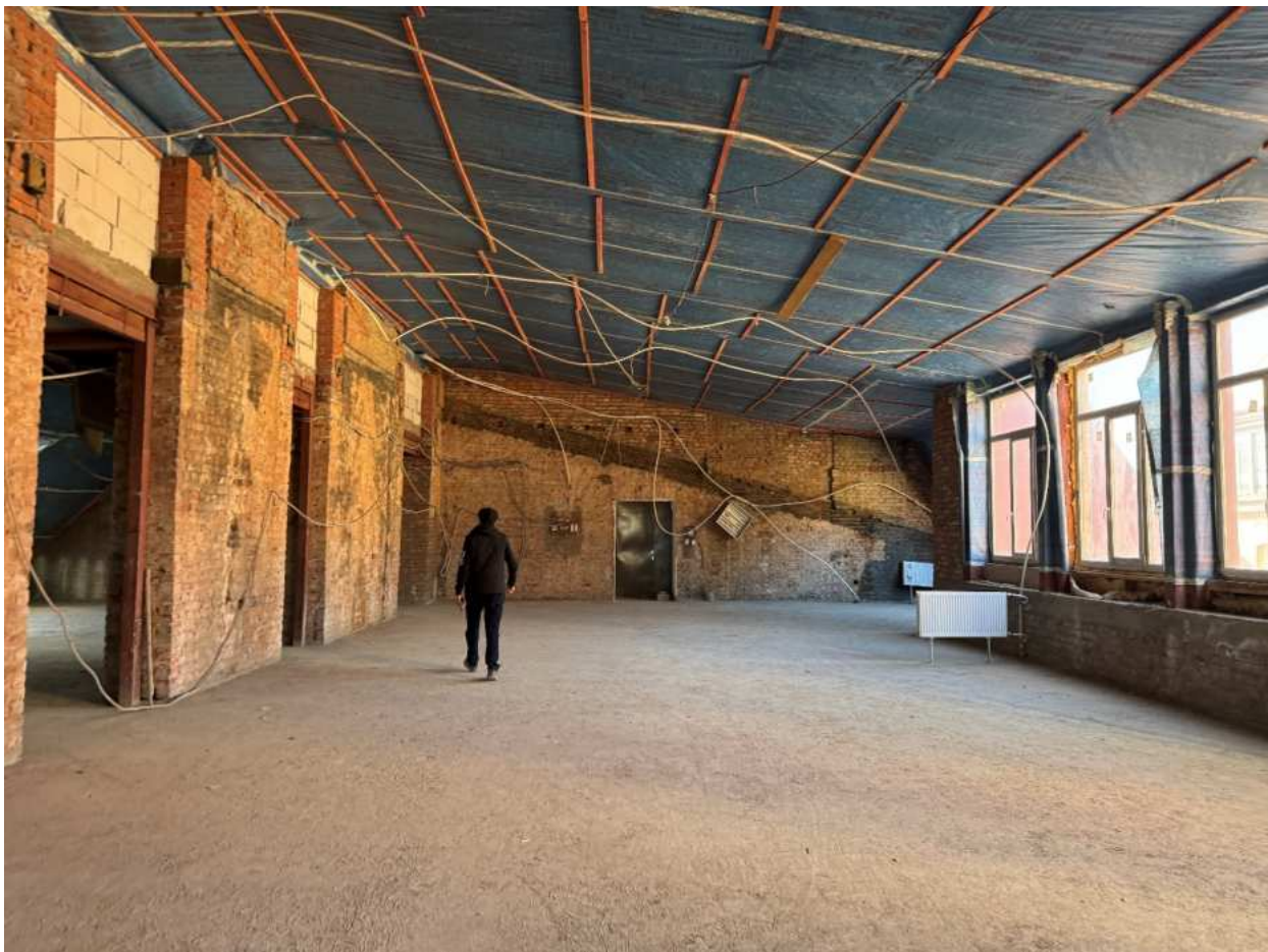
Фото 140. Вид на помещение квартиры № 58 объекта культурного наследия.
