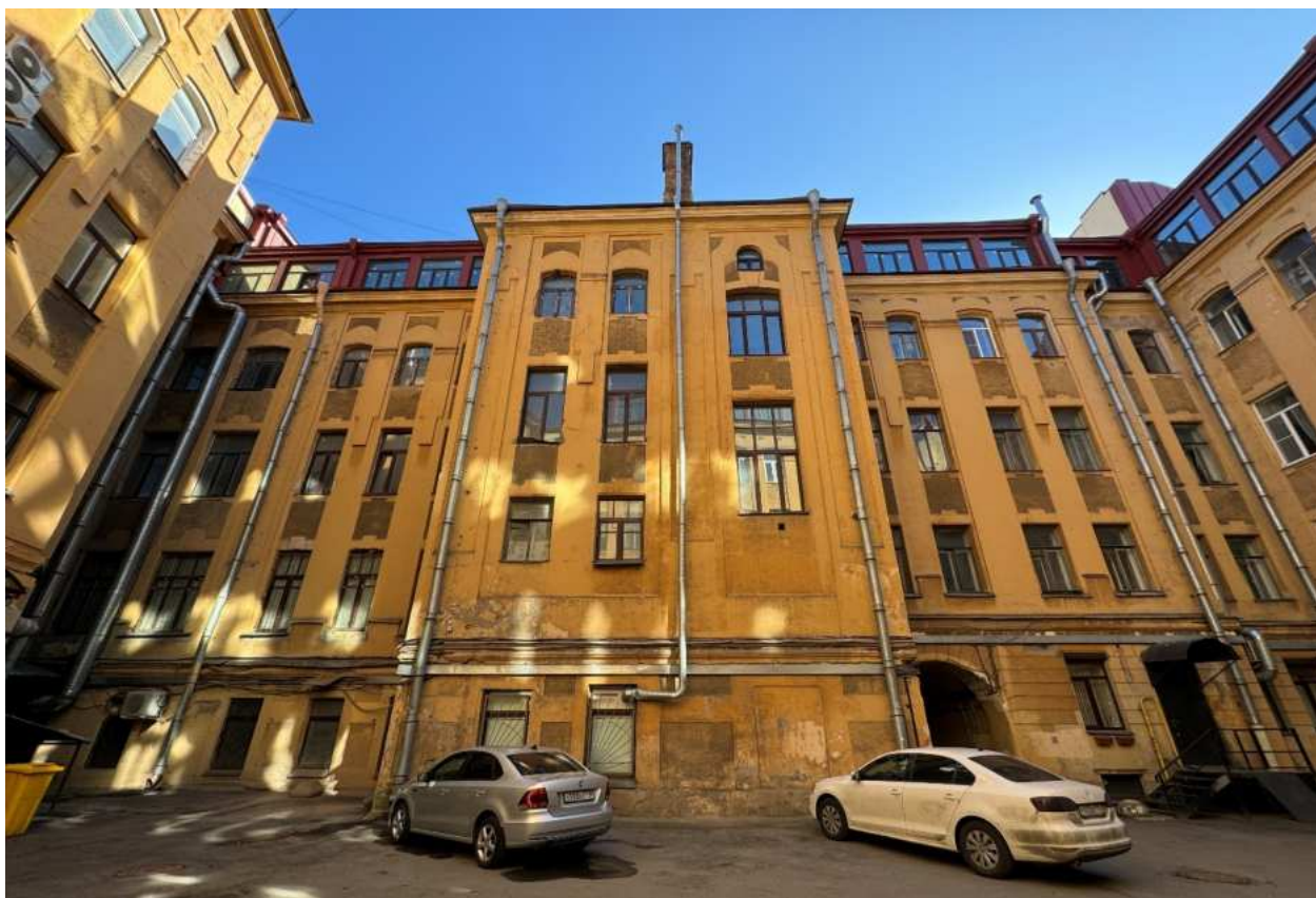
Фото 13. Общий вид дворовых фасадов объекта культурного наследия.
