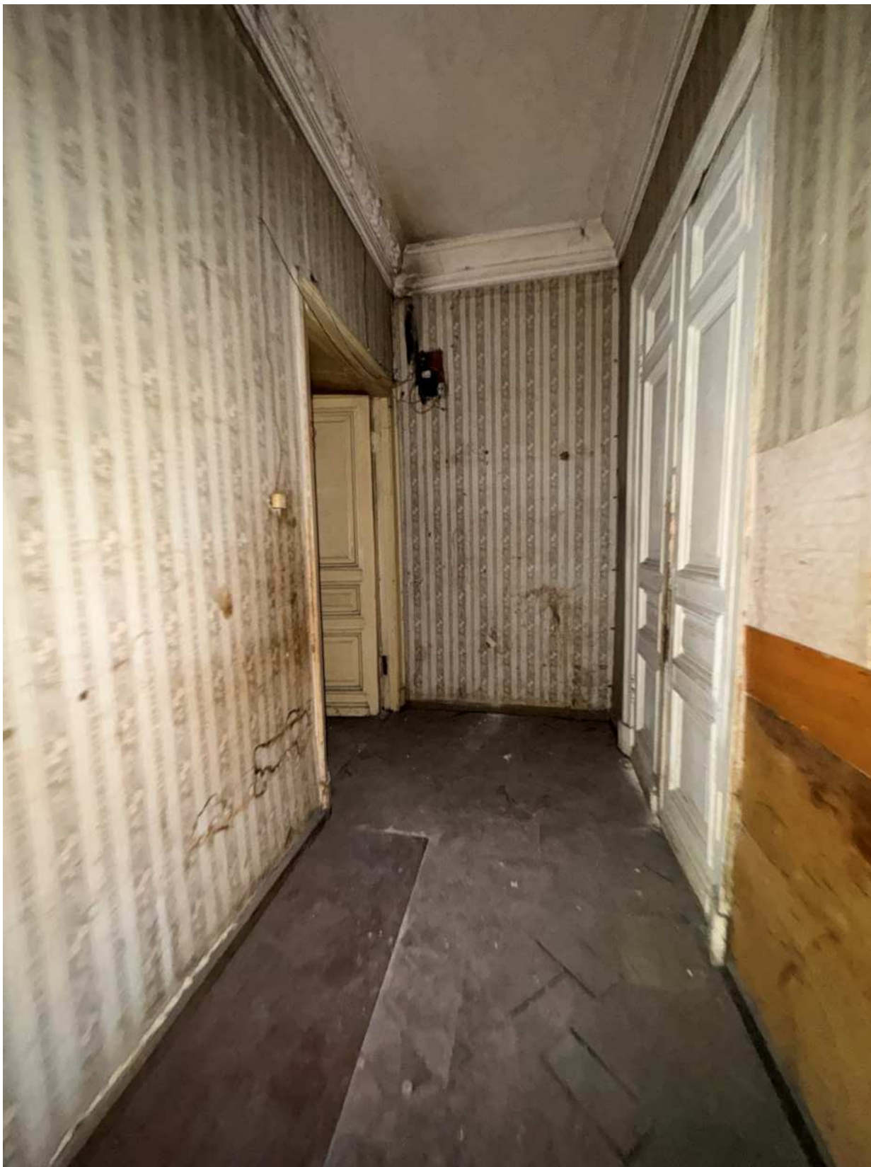
Фото 83. Вид на помещение квартиры № 11 объекта культурного наследия.
