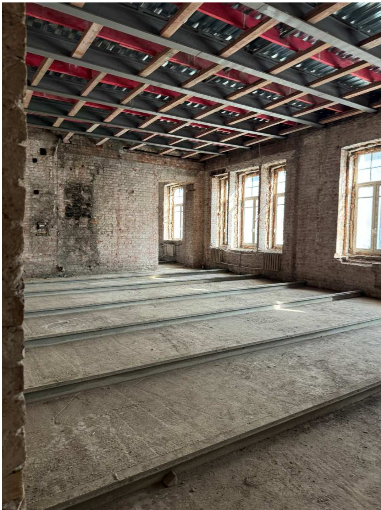
Фото 150. Вид на помещение квартиры № 50 объекта культурного наследия.
