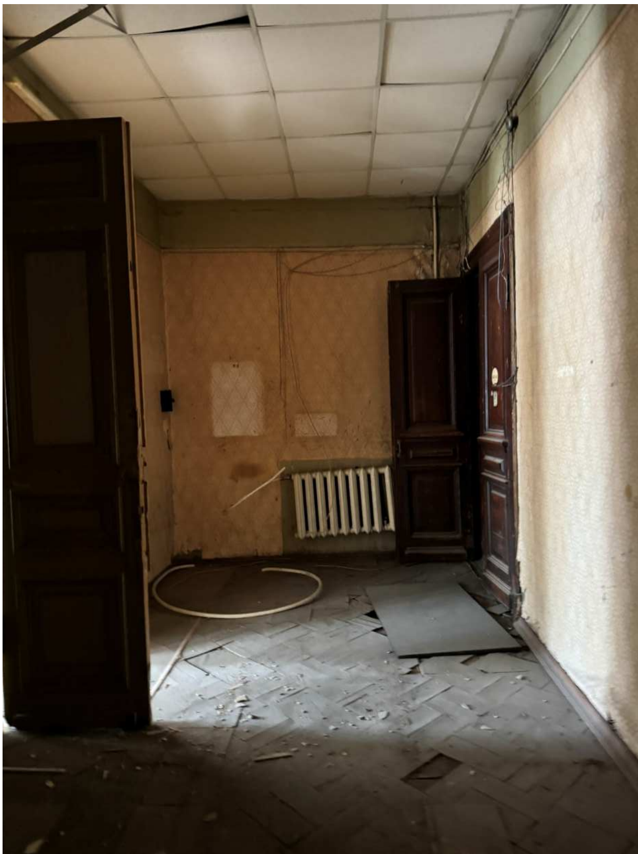
Фото 79. Вид на помещение квартиры № 11 объекта культурного наследия.
