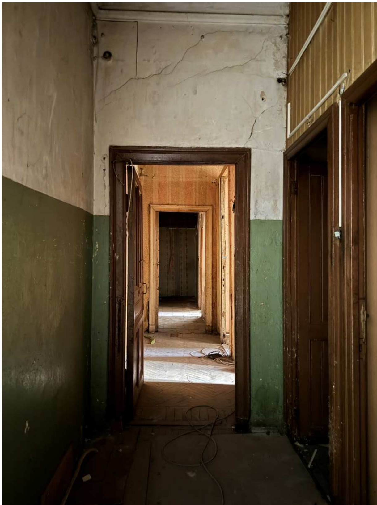
Фото 68. Вид на помещение квартиры № 11 объекта культурного наследия.
