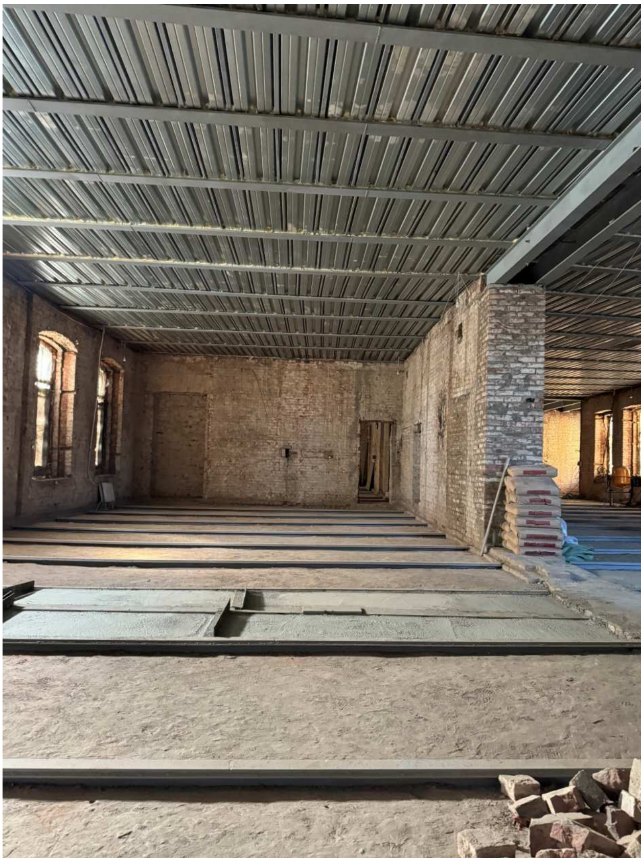
Фото 95. Вид на помещение 8-Н объекта культурного наследия.
