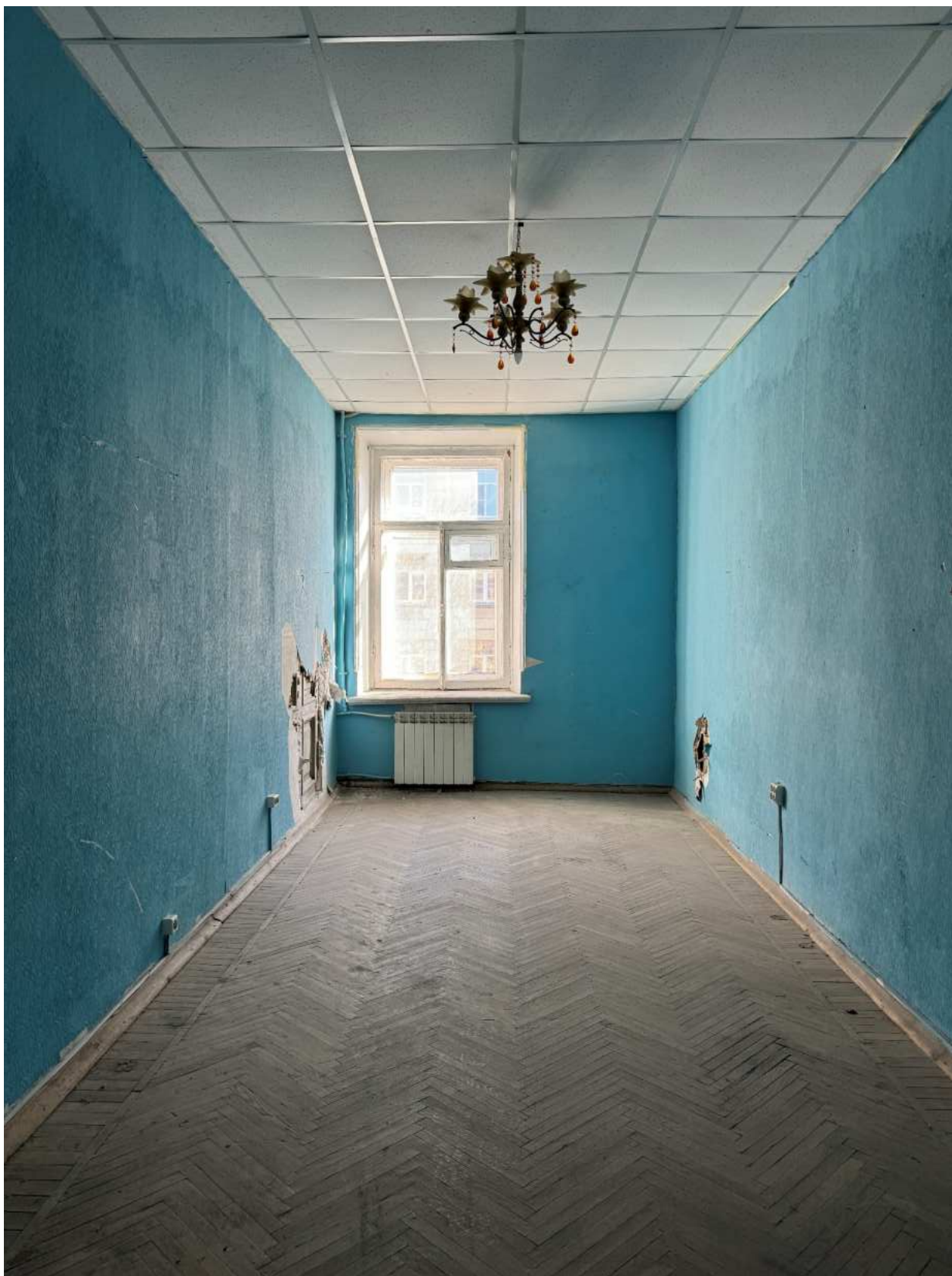
Фото 128. Вид на помещение квартиры № 16 объекта культурного наследия.
