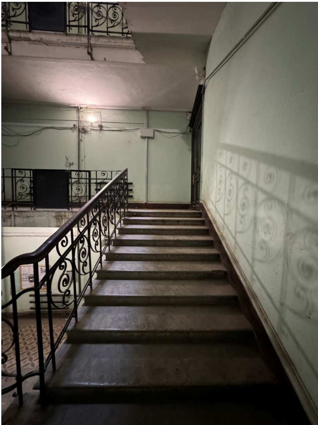
Фото 23. Вид на лестницу 1-ЛК объекта культурного наследия.
