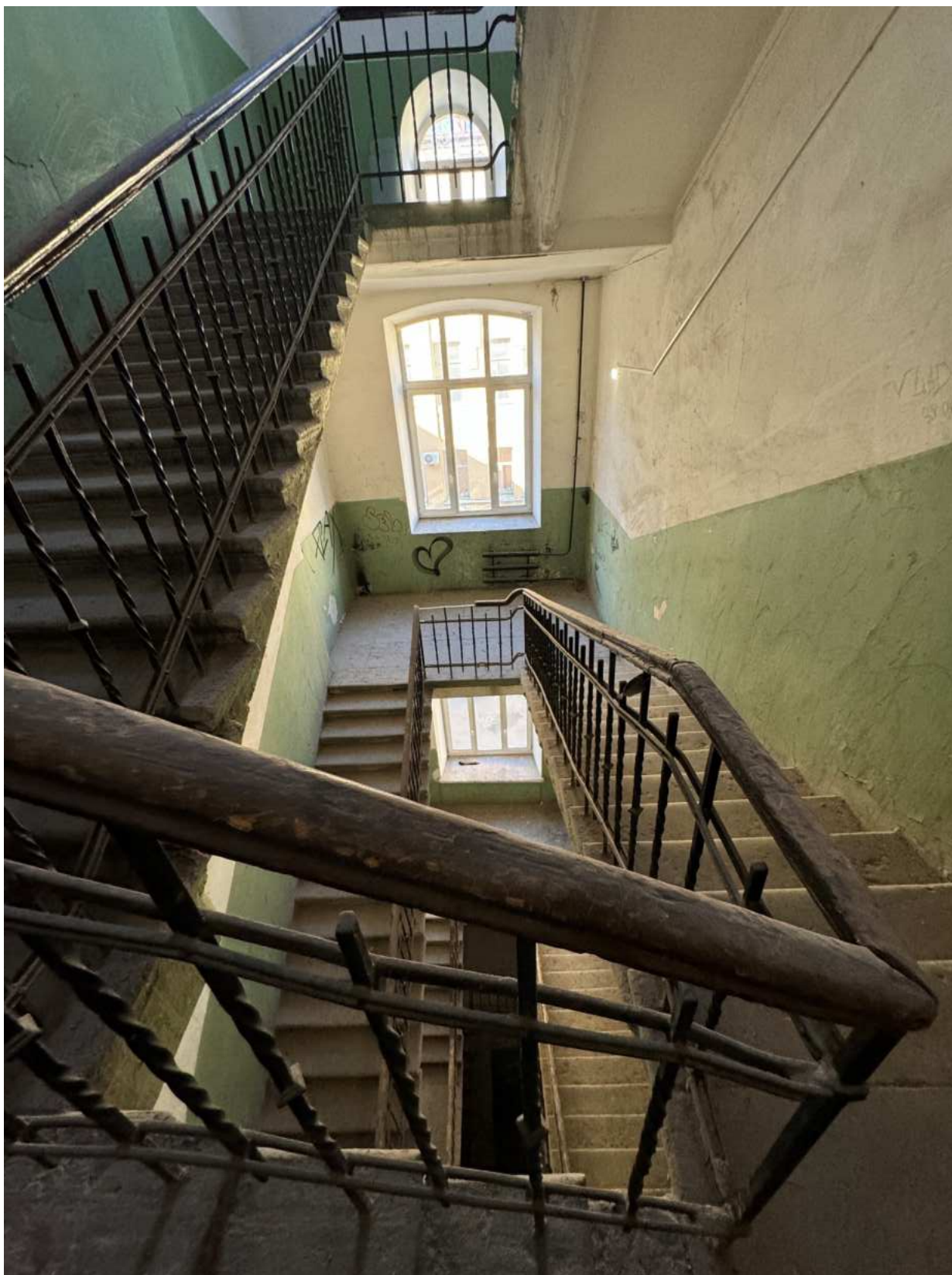
Фото 115. Вид на лестницу 5-ЛК объекта культурного наследия.
