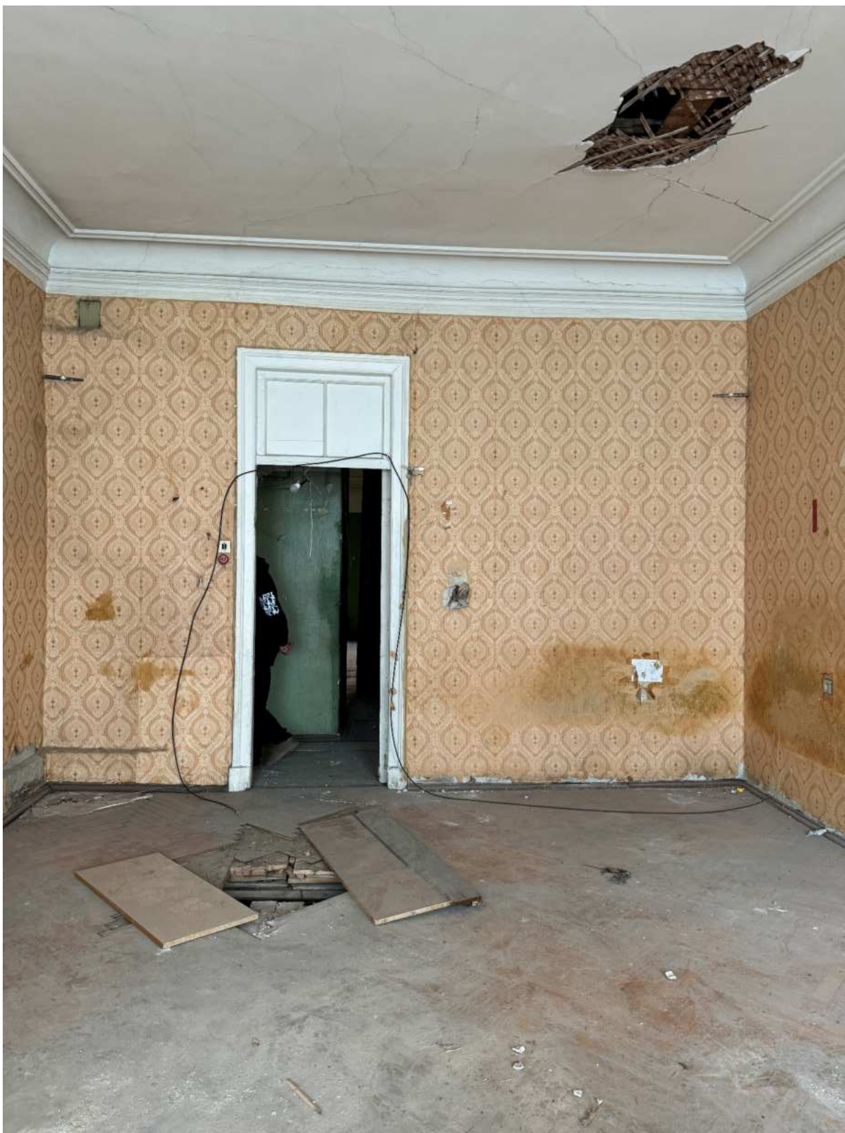
Фото 65. Вид на помещение квартиры № 11 объекта культурного наследия.
