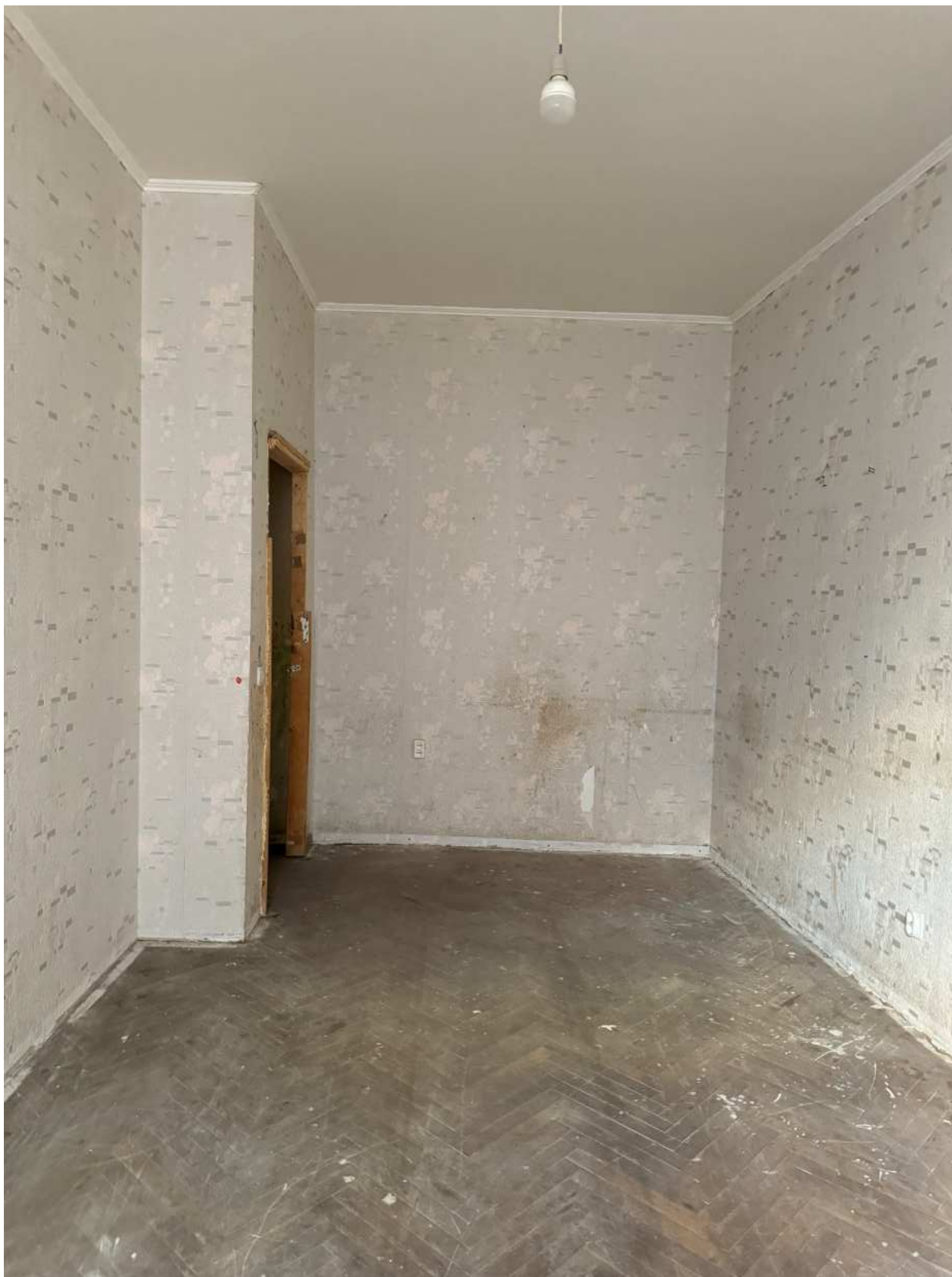
Фото 78. Вид на помещение квартиры № 11 объекта культурного наследия.
