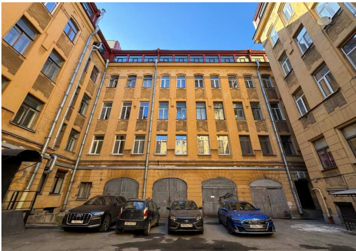
Фото 15. Общий вид дворовых фасадов объекта культурного наследия.
