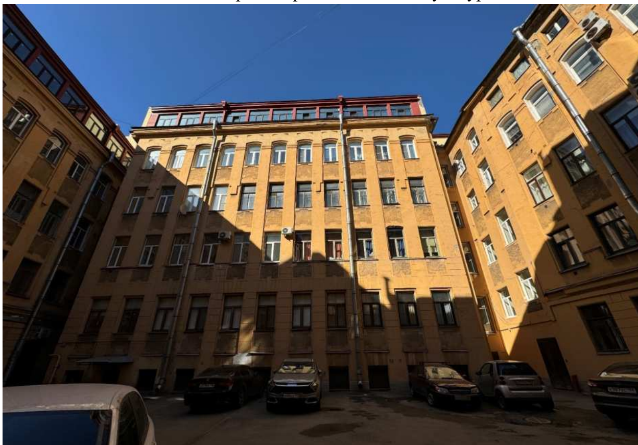
Фото 14. Общий вид дворовых фасадов объекта культурного наследия.
