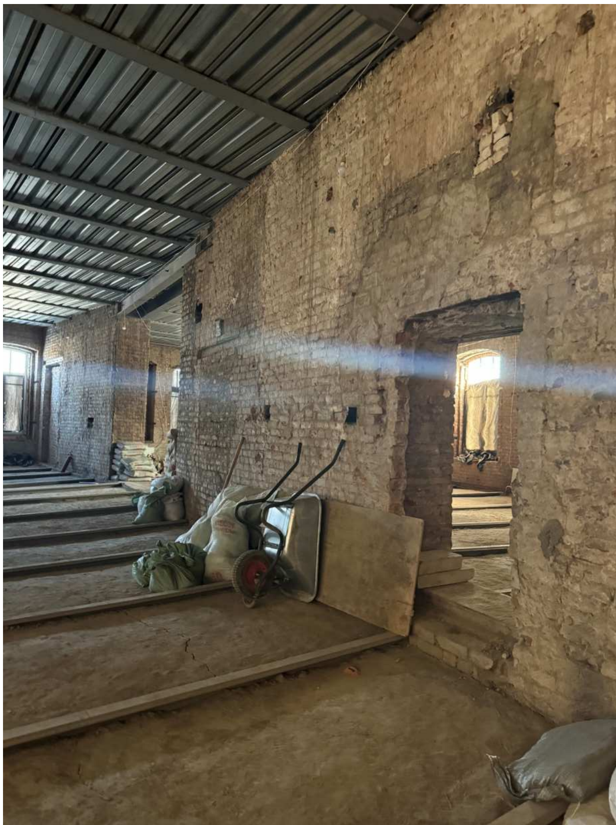
Фото 92. Вид на помещение 8-Н объекта культурного наследия.
