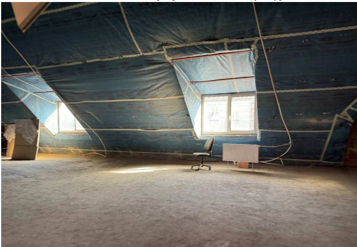
Фото 141. Вид на помещение квартиры № 58 объекта культурного наследия.
