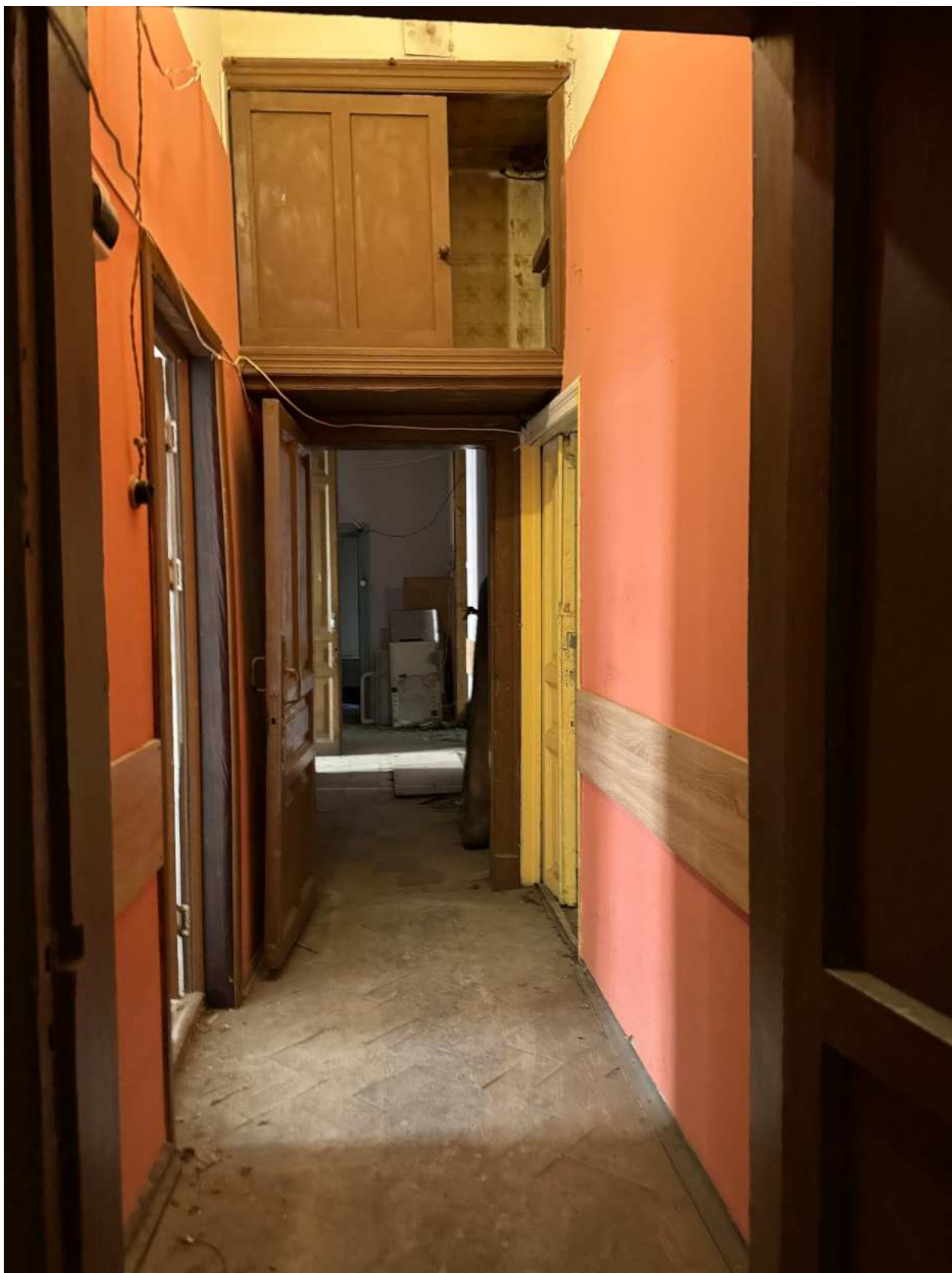
Фото 36. Вид на помещение квартиры № 17 объекта культурного наследия.
