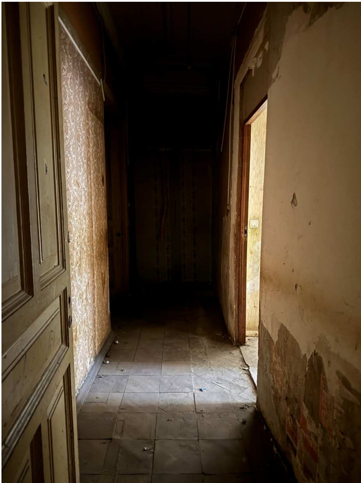
Фото 74. Вид на помещение квартиры № 11 объекта культурного наследия.
