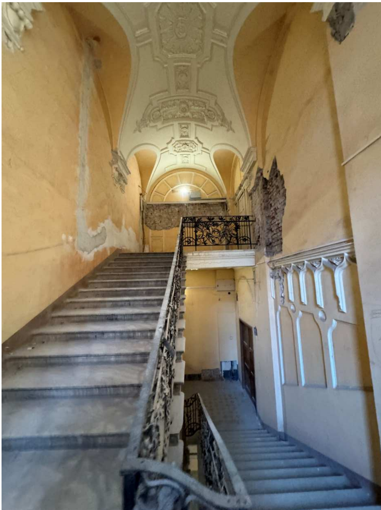
Фото 106. Вид на лестницу 4-ЛК объекта культурного наследия.
