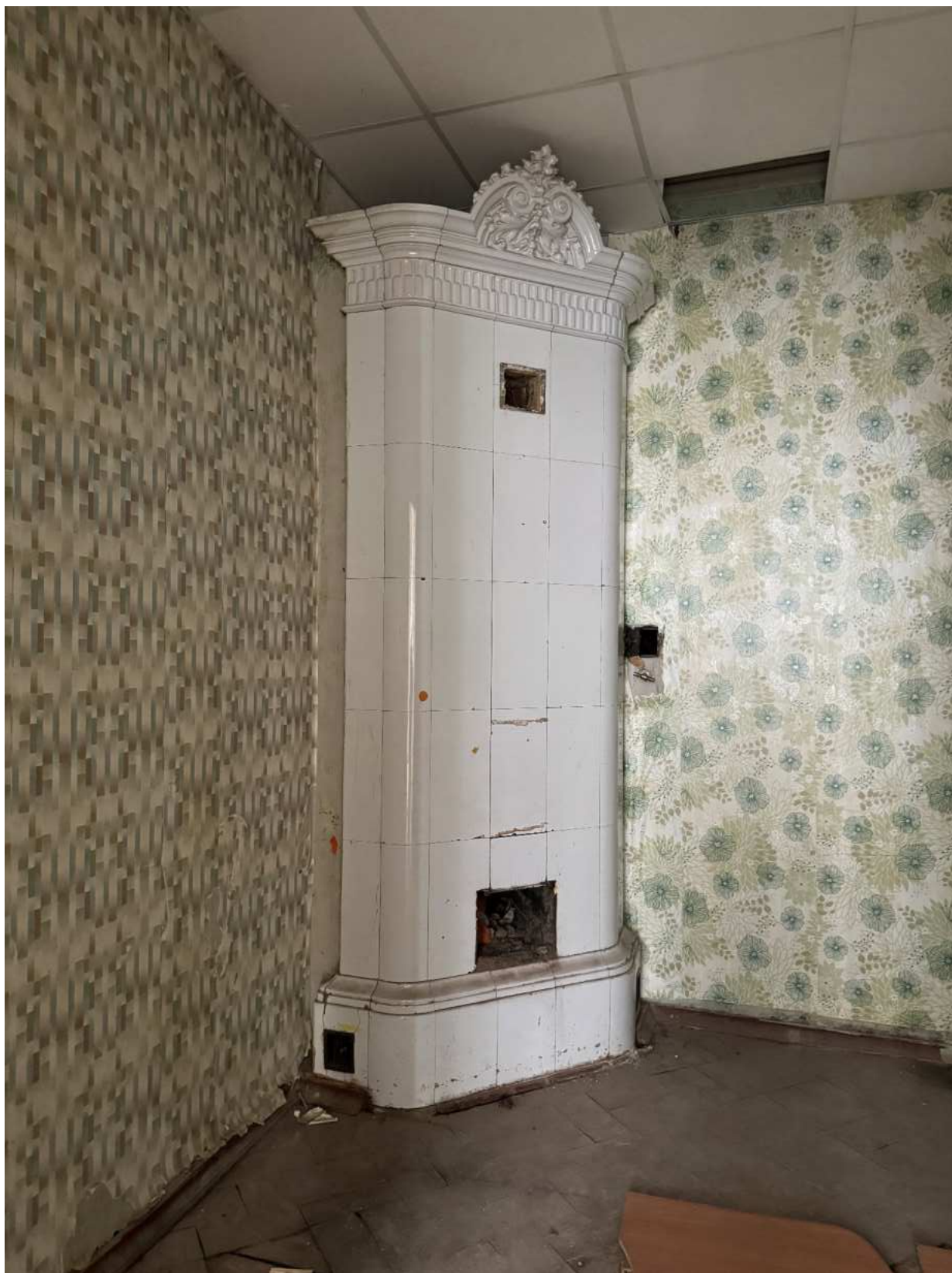
Фото 130. Вид печь квартиры № 16 объекта культурного наследия.
