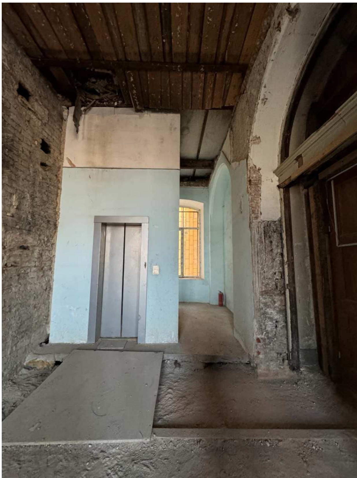
Фото 99. Вид на помещение 8-Н объекта культурного наследия.
