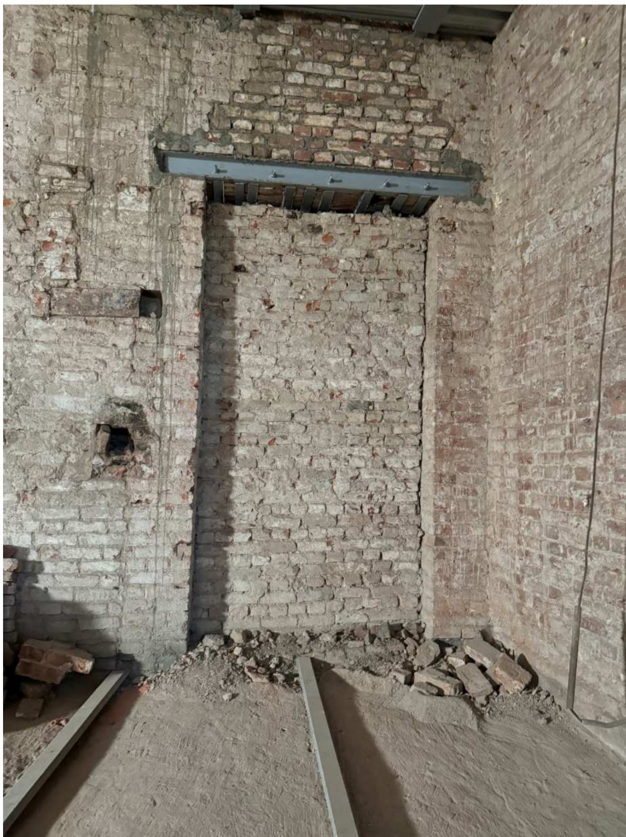
Фото 96. Вид на помещение 8-Н объекта культурного наследия.
