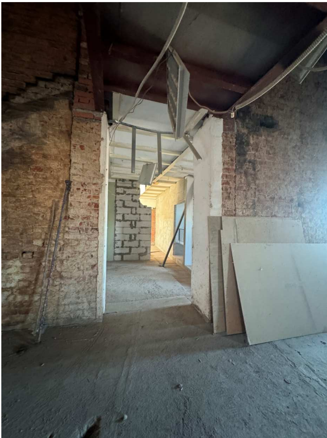
Фото 137. Вид на помещение квартиры № 58 объекта культурного наследия.
