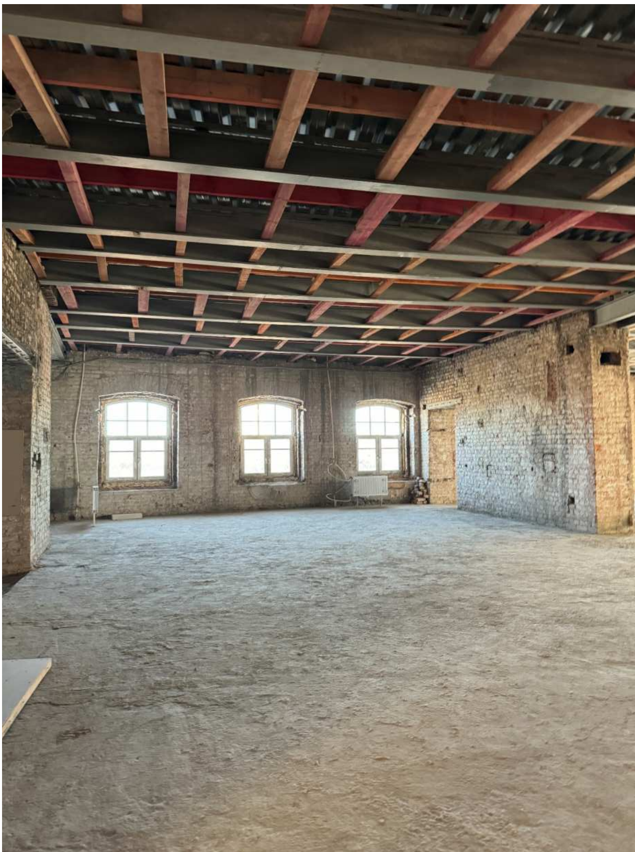
Фото 110. Вид на помещение квартиры № 53 объекта культурного наследия.
