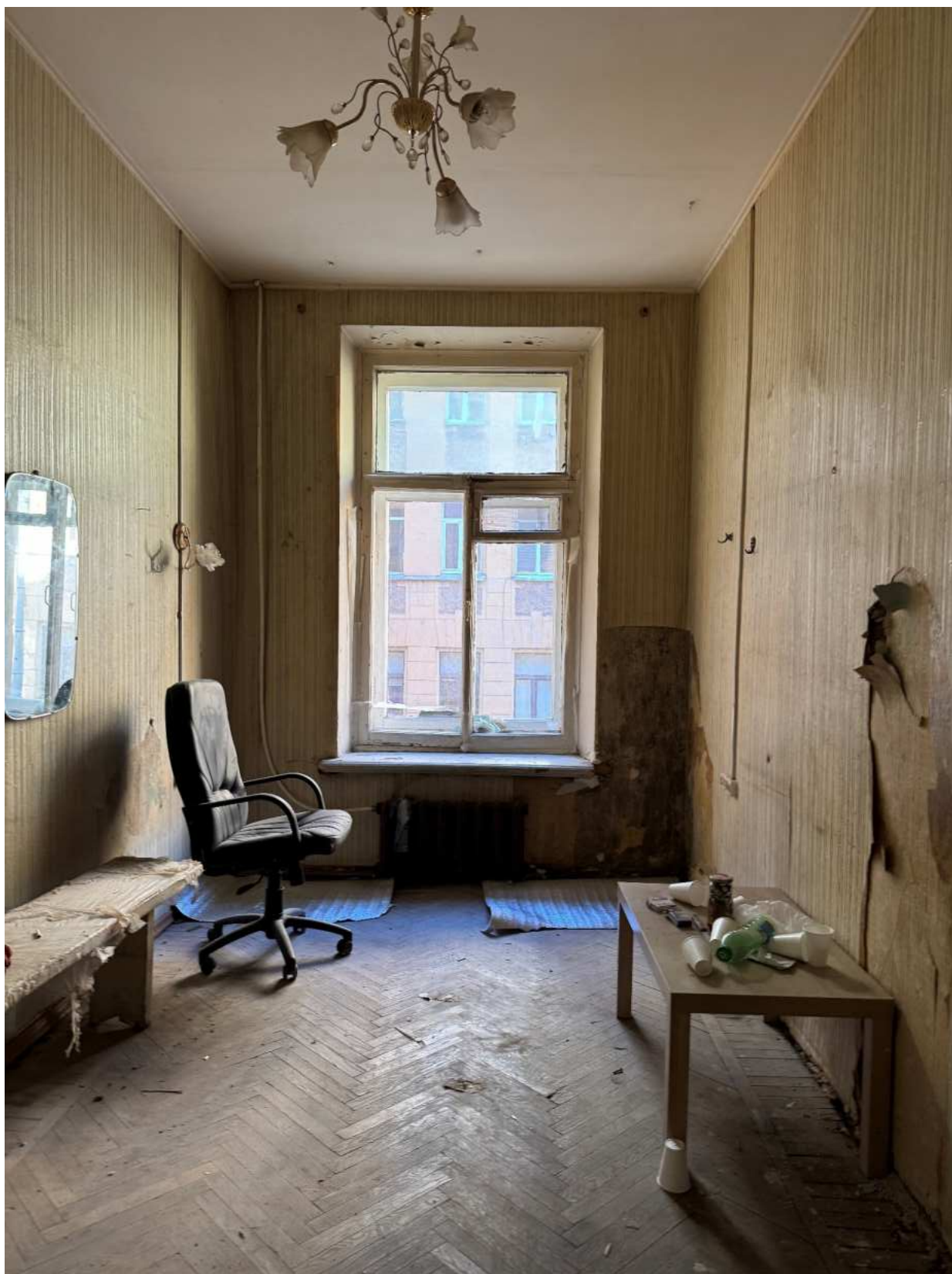
Фото 72. Вид на помещение квартиры № 11 объекта культурного наследия.
