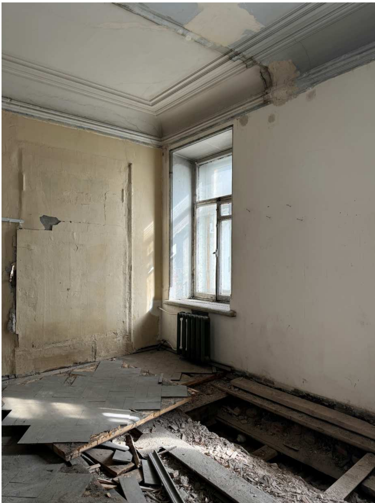
Фото 67. Вид на помещение квартиры № 11 объекта культурного наследия.
