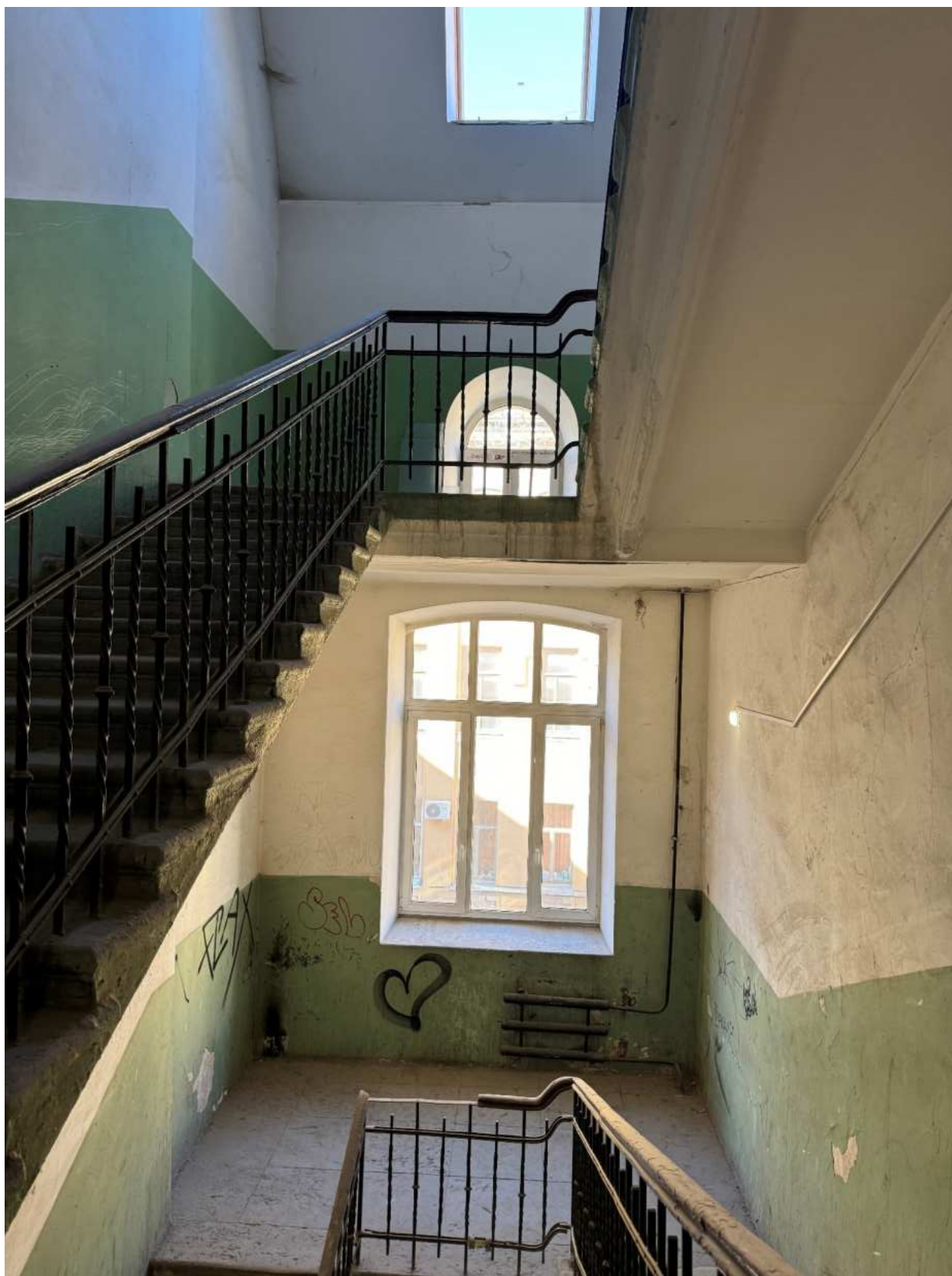
Фото 114. Вид на лестницу 5-ЛК объекта культурного наследия.
