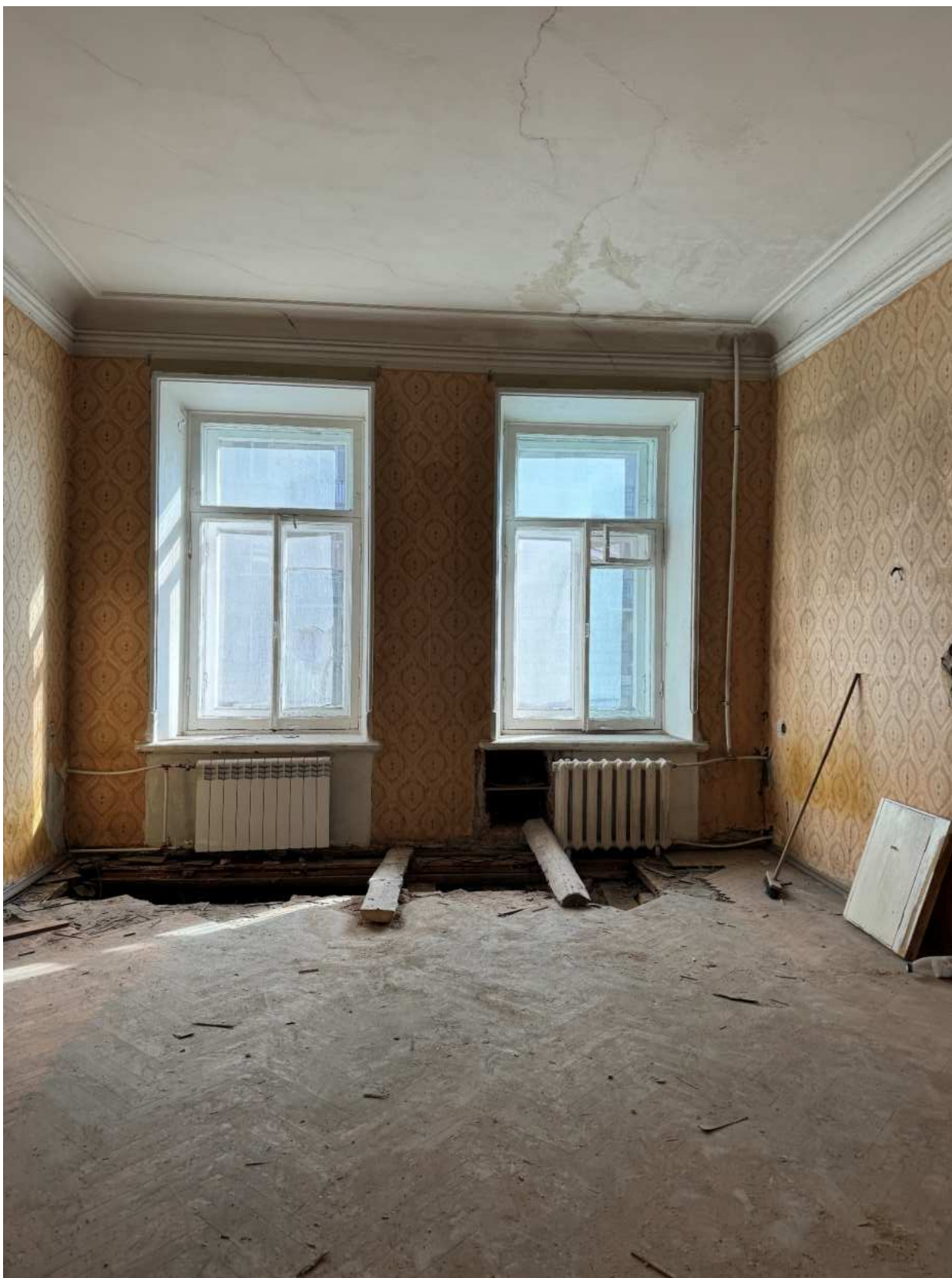
Фото 64. Вид на помещение квартиры № 11 объекта культурного наследия.
