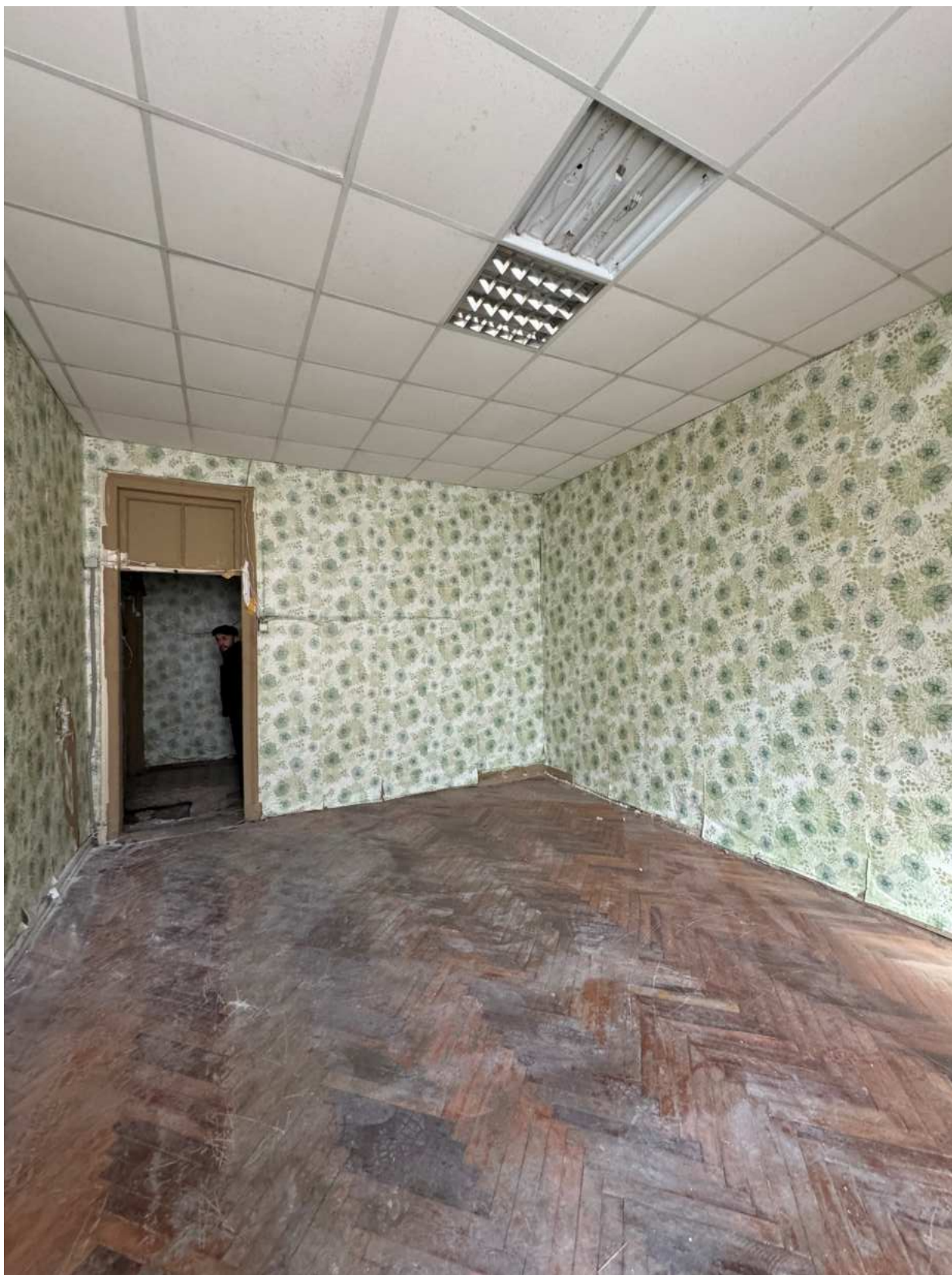
Фото 121. Вид на помещение квартиры № 16 объекта культурного наследия.
