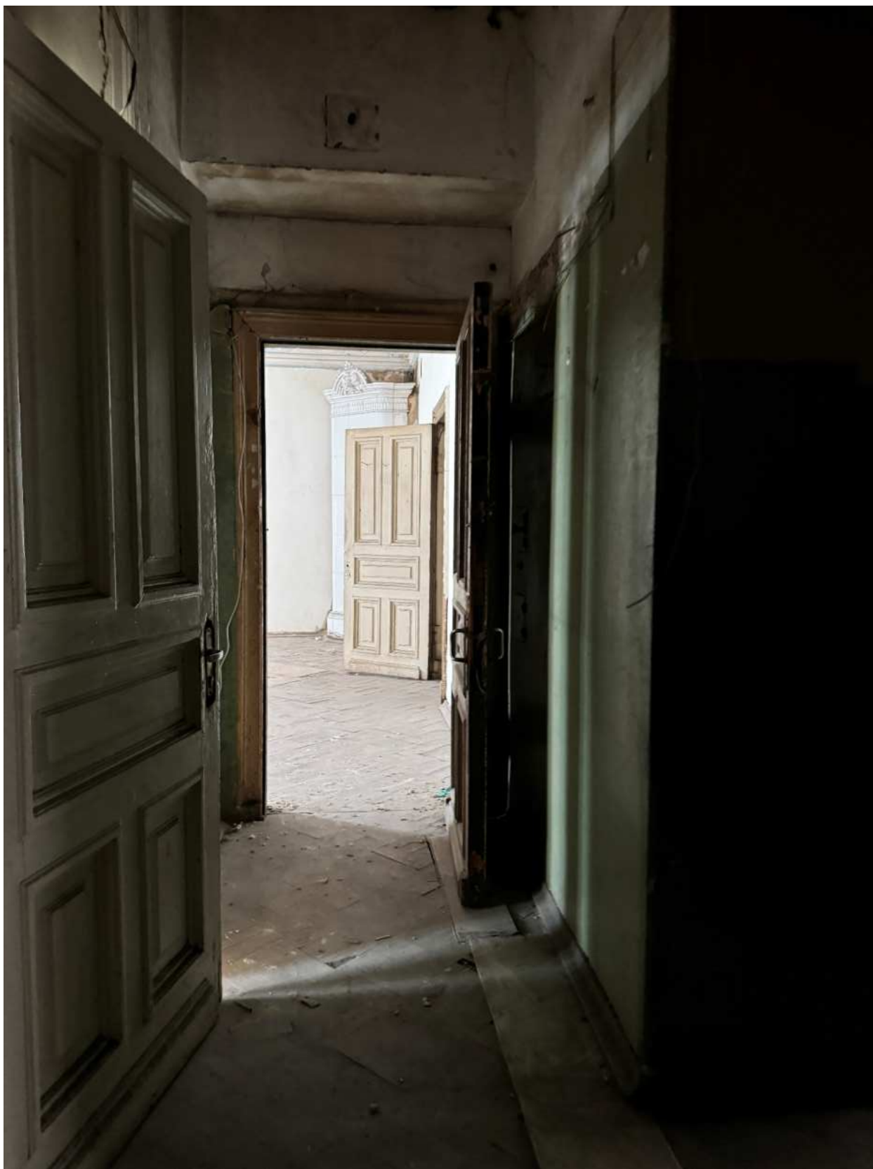
Фото 62. Вид на помещение квартиры № 11 объекта культурного наследия.
