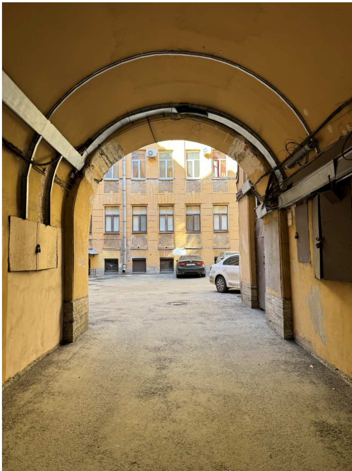
Фото 11. Вид на арку проезда объекта культурного наследия.
