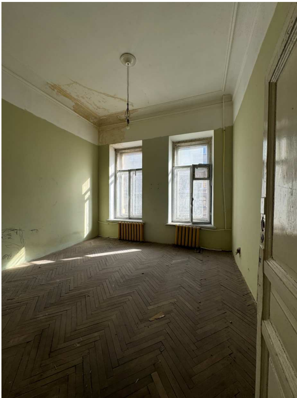
Фото 46. Вид на помещение квартиры № 17 объекта культурного наследия.
