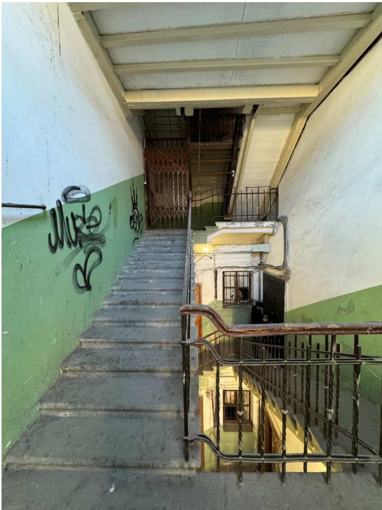
Фото 117. Вид на лестницу 5-ЛК объекта культурного наследия.
