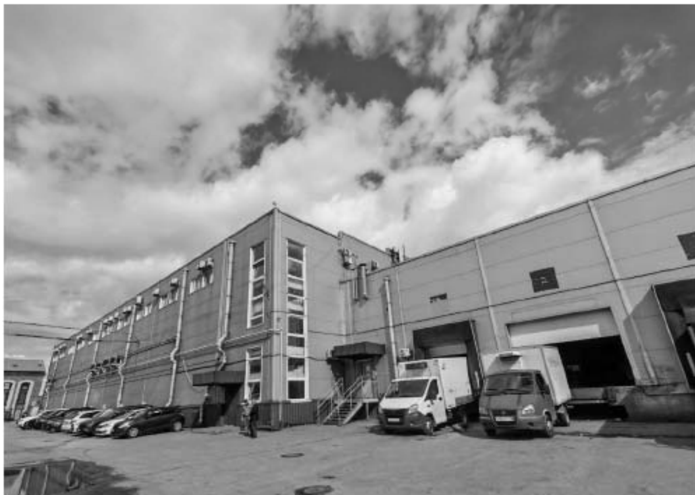
Илл. 6 - Объект демонтажа, расположенный по адресу: г. Санкт-Петербург, наб. Обводного канала, д. 118а, литера М.
