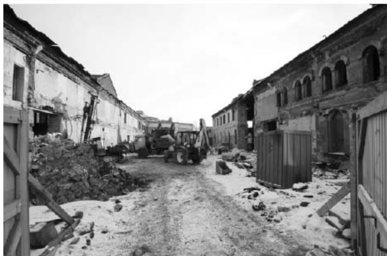
Илл. 166 - Двухэтажные западные корпуса бывших паровозных мастерских, построенные в комплексе с ОКН «Круглое производственное здание». Общий вид с запада. Фото Д. Ратникова. 2013 г. // URL: https://kanoner.com/2013/03/12/101635/depo2/
