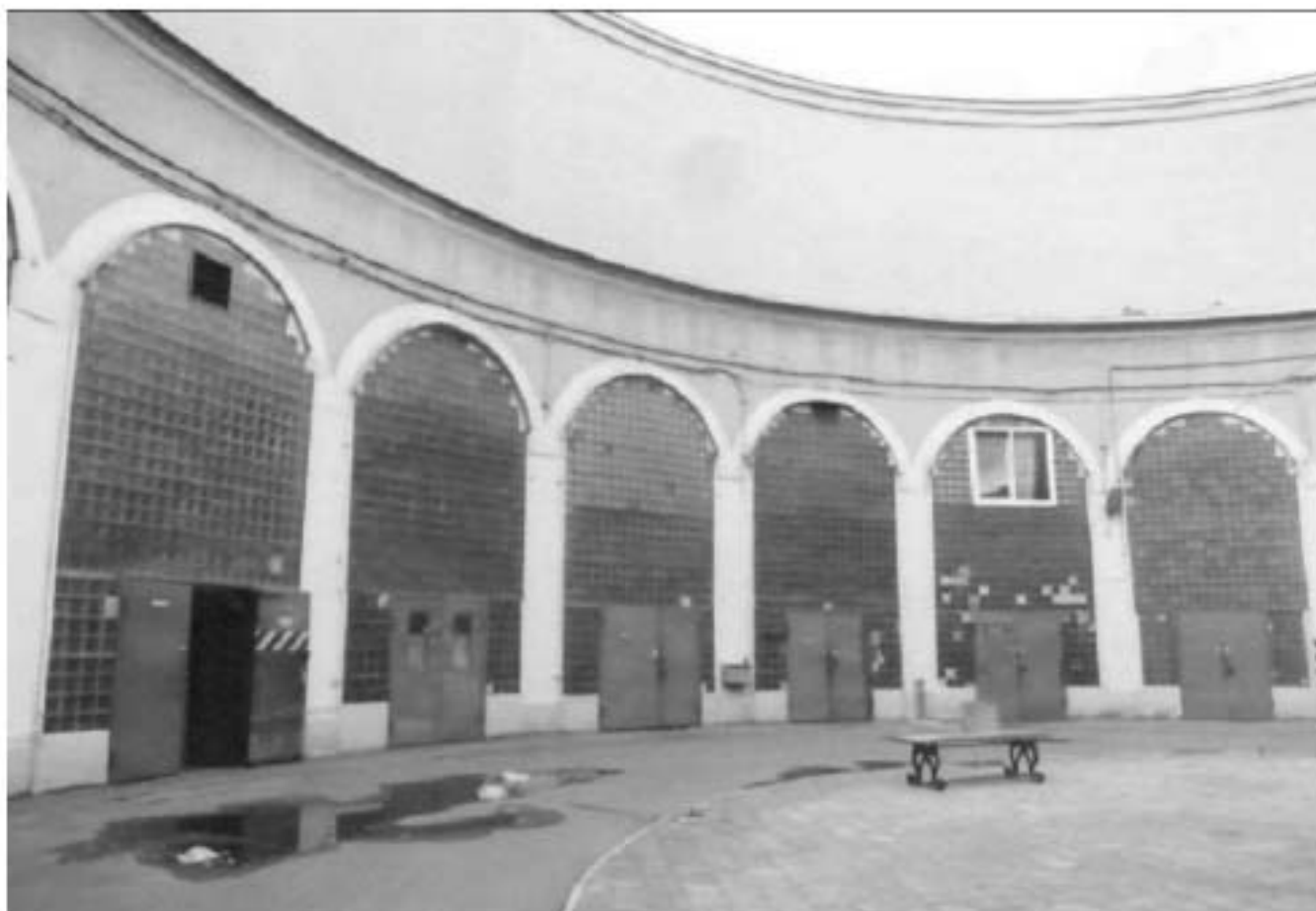
Илл. 128 - Круглое паровозное депо Николаевской железной дороги» (Невский пр., д. 85, лит. БО). Фрагмент интерьера. 2019 г. Здание-аналог рассматриваемого ОКН «Круглое производственное здание» // URL: https://kgior.gov.spb.ru/o-komitete/press-centr/news/50891/?page=131 .
