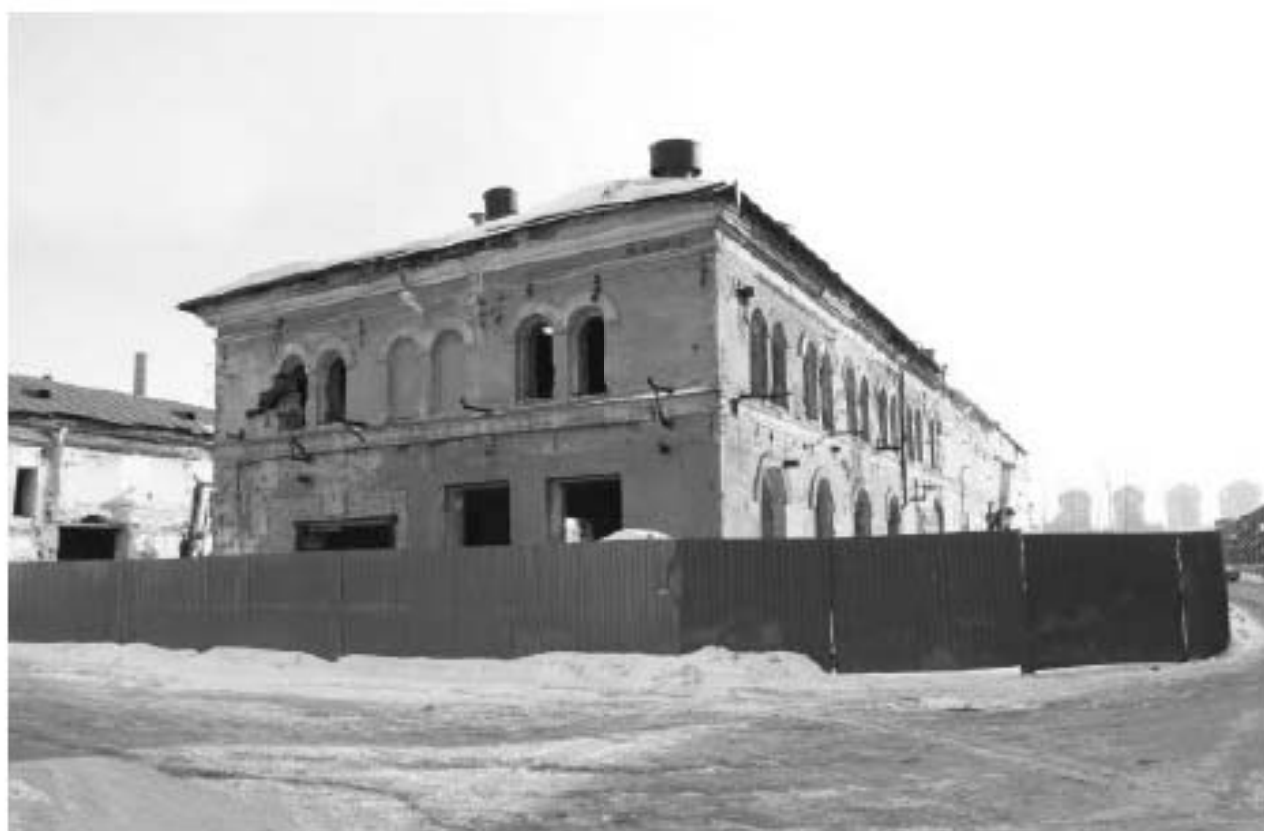
Илл. 164 - Двухэтажный южный корпус бывших паровозных мастерских, построенный в комплексе с ОКН «Круглое производственное здание» до реконструкции. Фото Д. Ратникова. 2013 г. // URL: https://kanoner.com/2013/03/12/101635/depo2/ .
