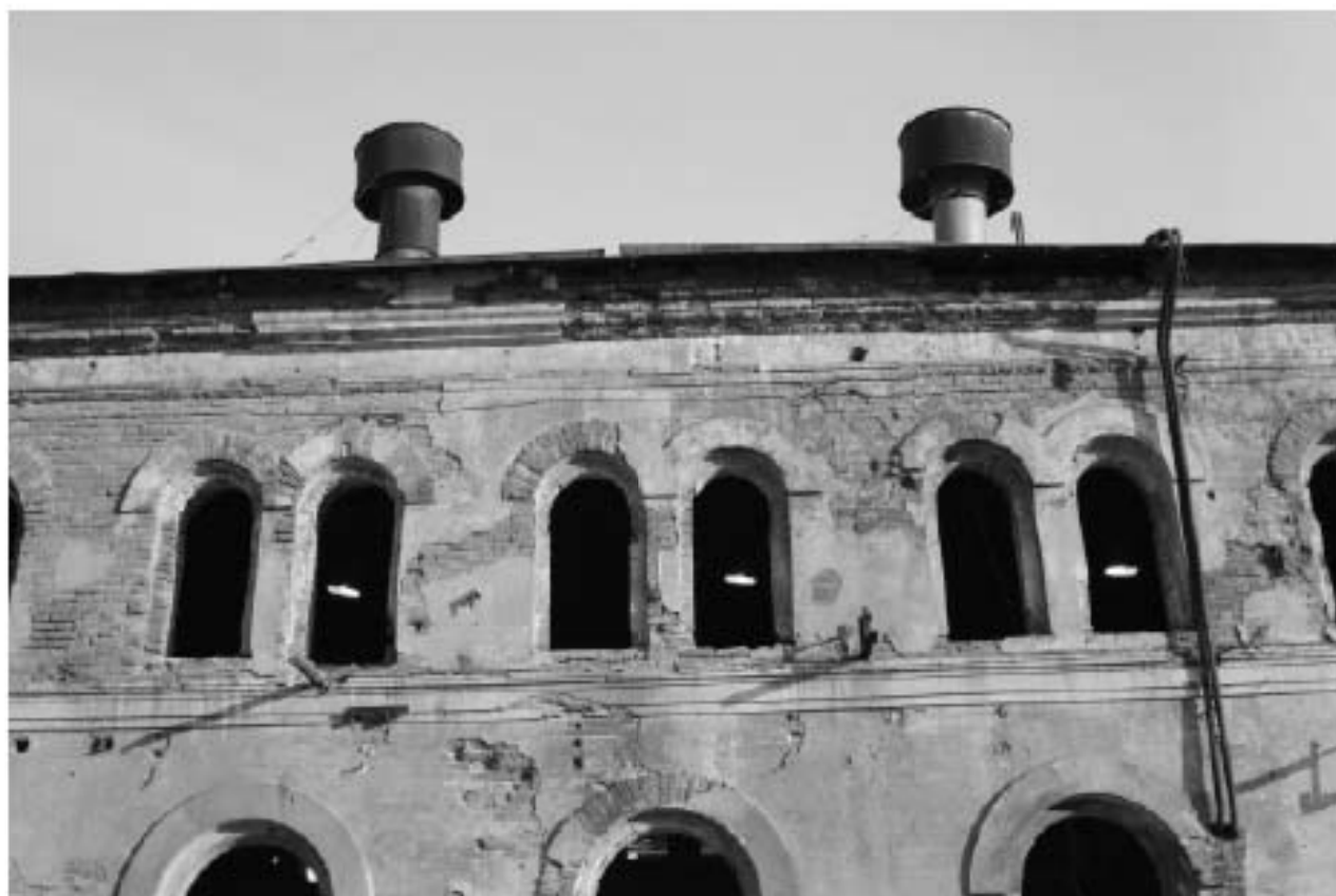
Илл. 163 - Двухэтажный южный корпус бывших паровозных мастерских, построенный в комплексе с ОКН «Круглое производственное здание». Окна второго этажа до реконструкции. Фото Д. Ратникова. 2013 г. // URL: https://kanoner.com/2013/03/12/101635/depo2/ .
