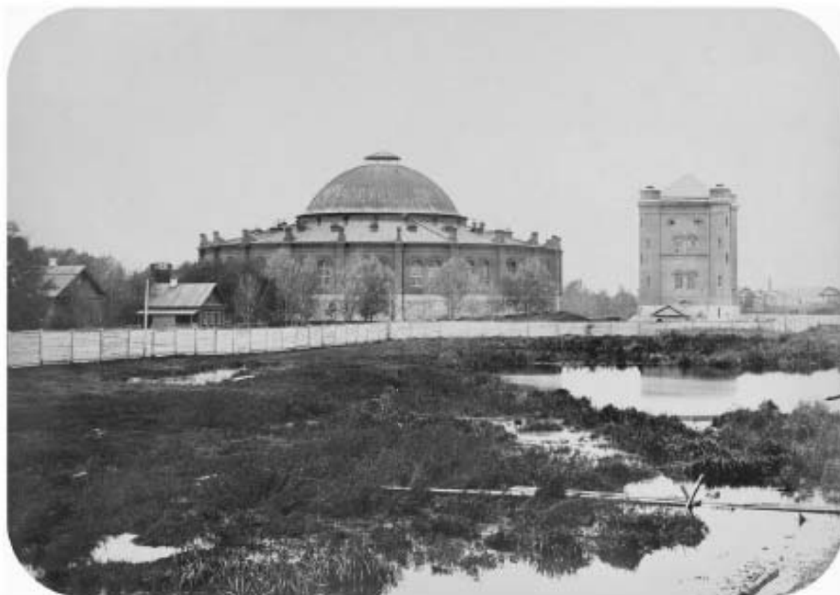
Илл. 130 - Паровозное депо и Водонапорная башня Николаевской железной дороги /в Москве/. Фотография 1860-х гг. Здание-аналог рассматриваемого ОКН «Круглое производственное здание» // URL: https://dzen.ru/a/YuTbtW_EWE_dNZ_ .
