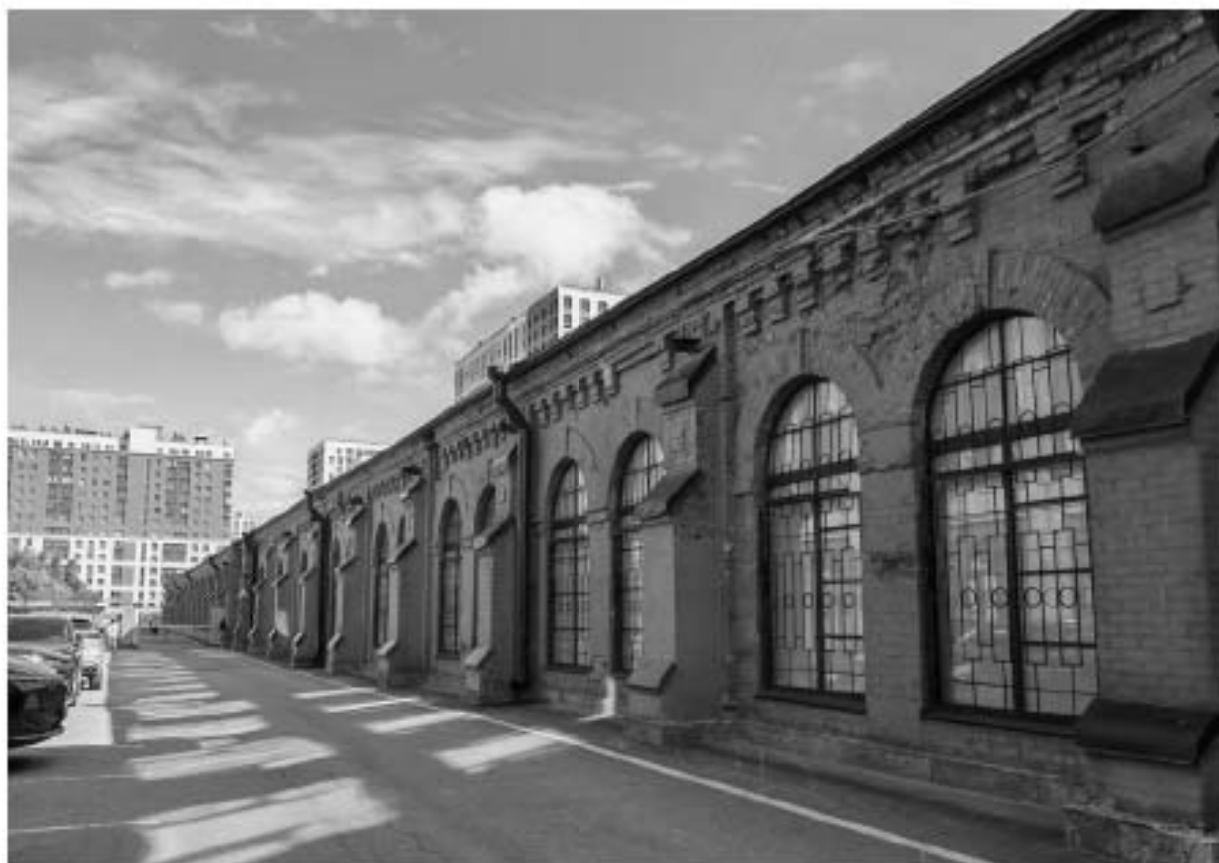
Илл. 174 - Общий вид здания – ОКН «Здание инструментального цеха», по адресу: г. Санкт-Петербург, набережная Обводного канала, дом 118а, литера Н», входящего в состав архитектурного ансамбля ОКН «Комплекс построек Варшавского вокзала».
