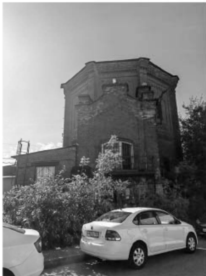
Илл. 172 - Общий вид здания – ОКН «Резервуар (водоёмное здание)» по адресу: наб. Обводного канала, д. 118а, лит. АВ, входящего в состав архитектурного ансамбля ОКН «Комплекс построек Варшавского вокзала».
