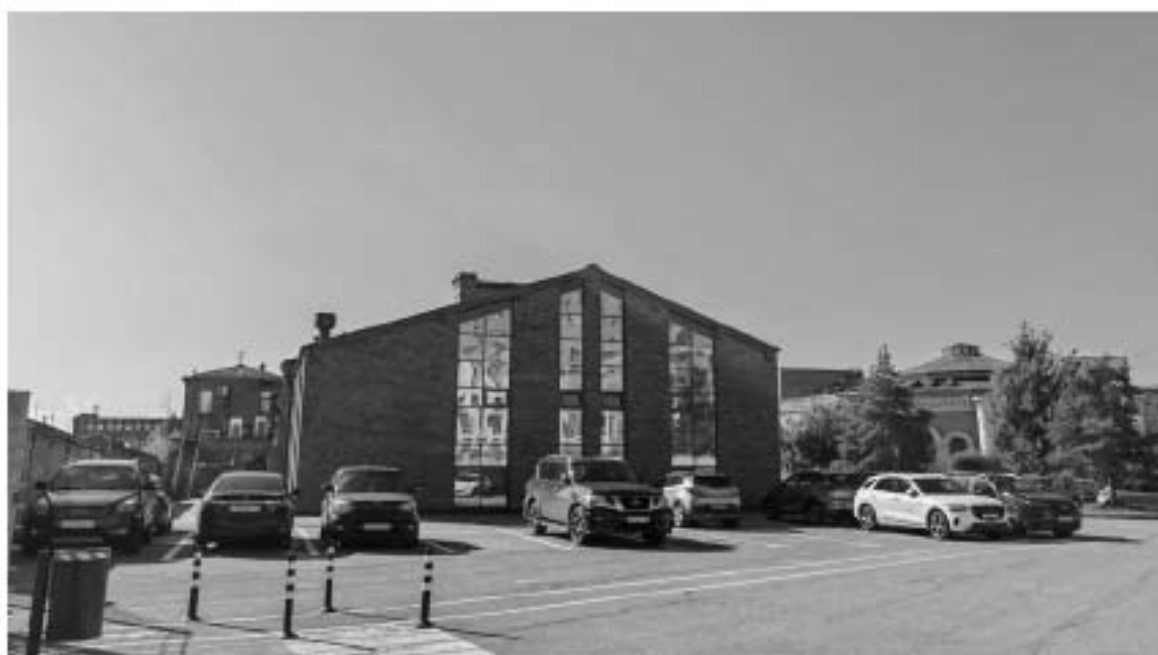
Илл. 105 - ОКН «Здание инструментального цеха». Восточный фасад. Общий вид с юго-востока. Фотография 2025 г.
