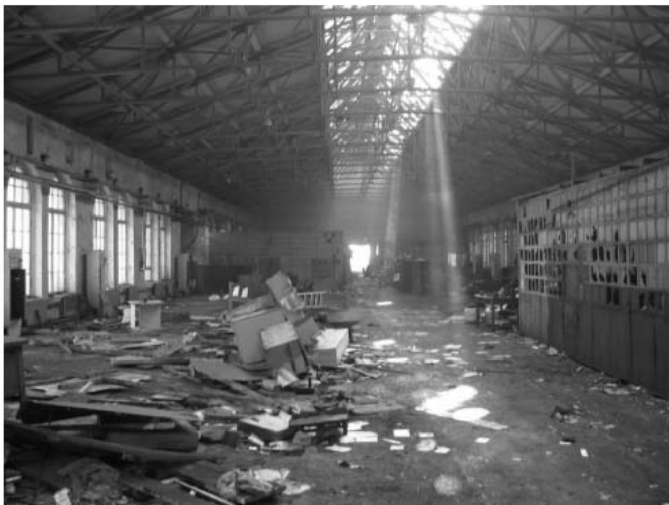
Илл. 96 - ОКН «Здание инструментального цеха». Интерьер основного здания литер Н. Фотография начала 2000-х гг.
