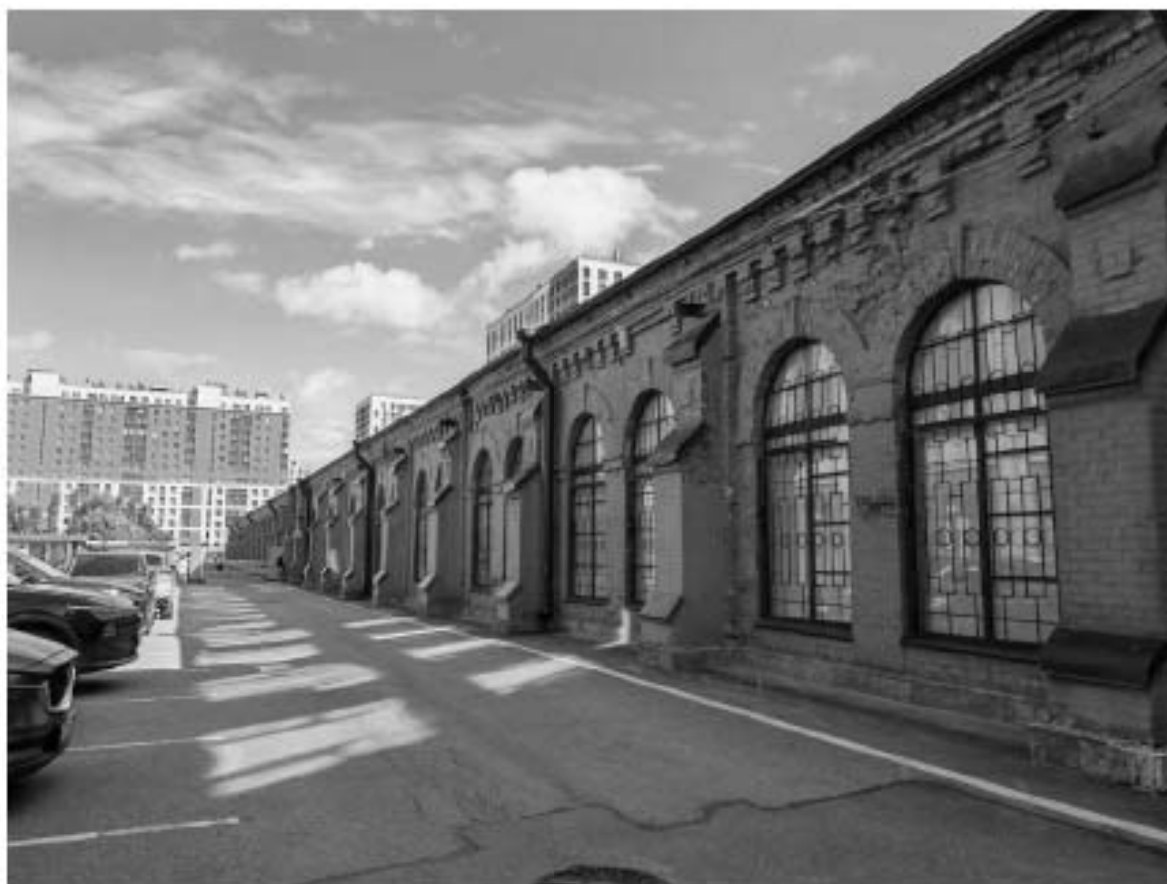
Илл. 104 - ОКН «Здание инструментального цеха». Северный фасад. Общий вид с северо-запада. Фотография 2025 г.
