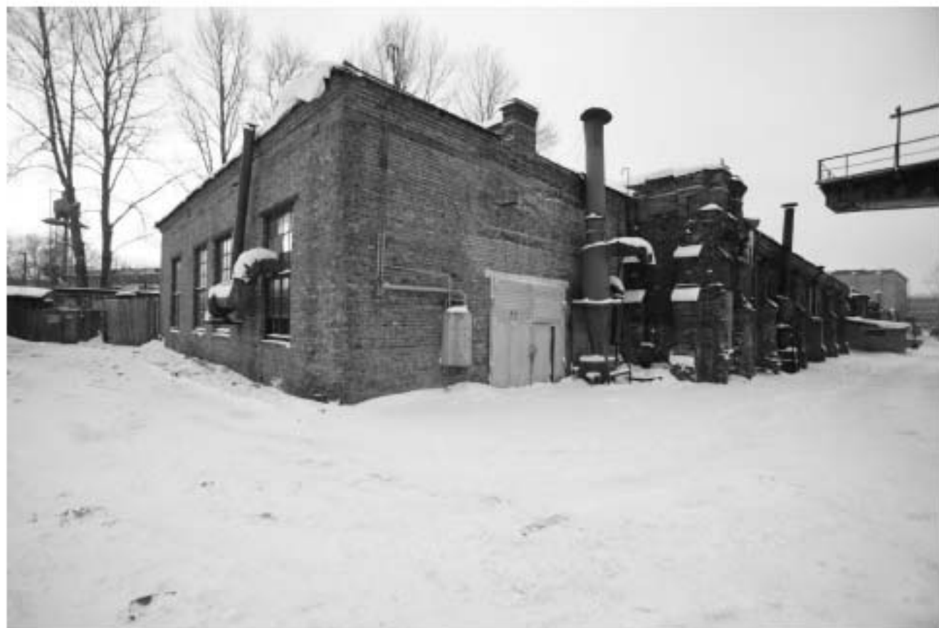
Илл. 92 - ОКН «Здание инструментального цеха». Восточная пристройка н-1 и основное здание Н. Вид с северо-востока. Фотография начала 2000-х гг.
