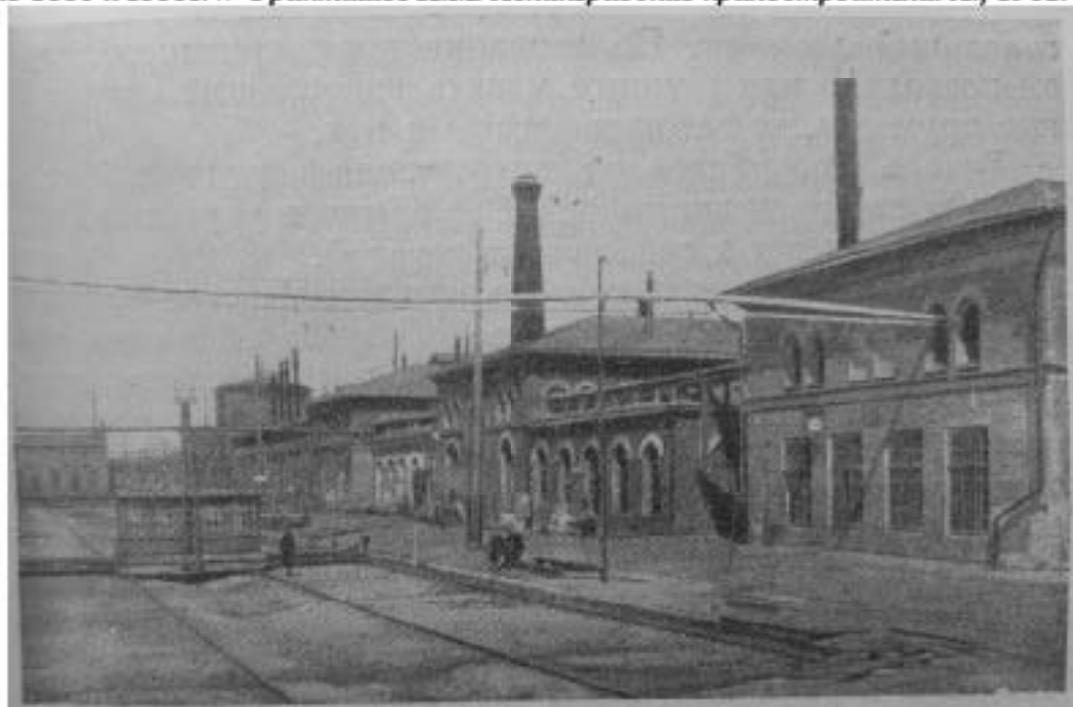
Илл. 39 - Корпуса мастерских паровозного депо. На заднем плане здание резервуара (ныне «Резервуар (водоемное здание)»). Вид с юга. Фото 1920-х годов. // Франтишев И.М. Ленинградские краностроители. Л., 1962. С. 117.
