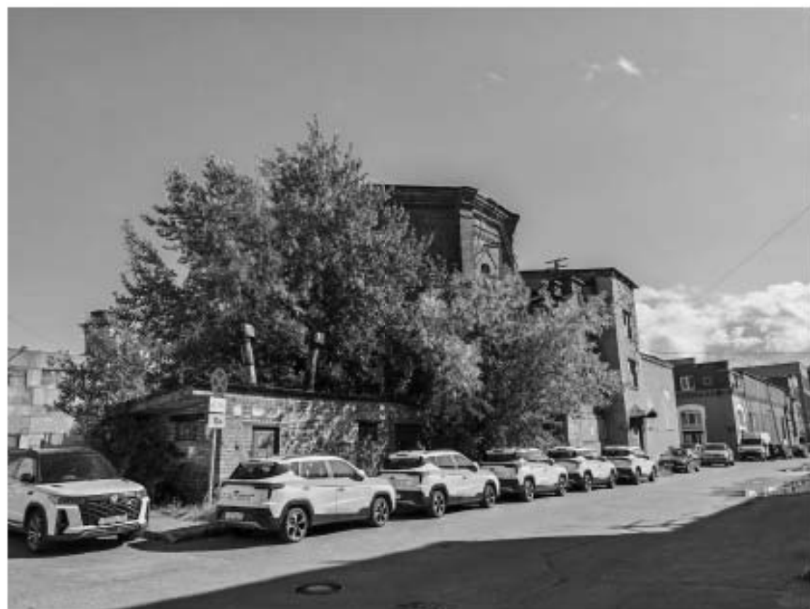
Илл. 66 - ОКН «Резервуар (водоёмное здание)». Общий вид с северо-запада. Фотография 2025 г.
